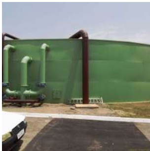
Foto 31 - Entrada do efluente no reator após tratamento preliminar.
