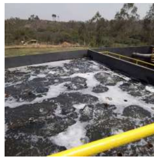
Foto 18 - Etapa aeróbica do tratamento.
