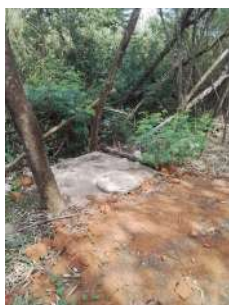
Foto 1 - PV do interceptor de esgoto no qual foi realizada interligação com a rede coletora.
