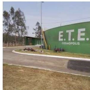
Foto 2 - Visão geral da ETE.
