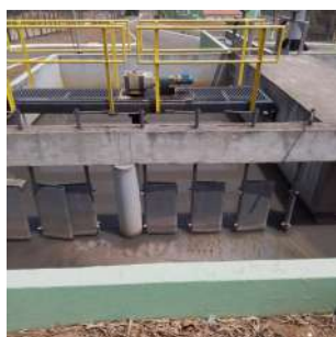
Foto 13 - Aletas de um dos desarenadores.
