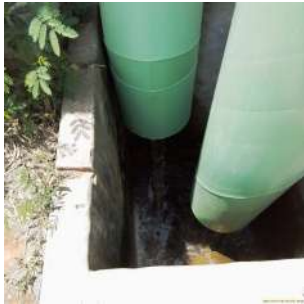
Foto 28 - Saída do efluente para posterior lançamento final.
