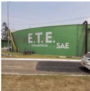
Foto 1 - ETE de Cosmópolis, composta pelas seguintes etapas: pré-tratamento, desarenador, reator anaeróbico de manta de lodo e fluxo ascendente (UASB), biofiltro aerado submerso, decantador secundário e desinfecção por raio ultravioleta (UV).
