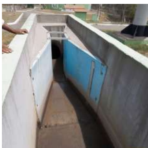
Foto 1 - Calha parshall após tratamento preliminar.
