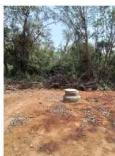
Foto 5 - PV do interceptor.
