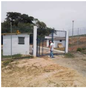
Foto 1 - Visão geral da elevatória.
