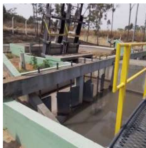
Foto 10 - Aletas de um dos desarenadores.
