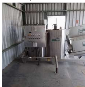
Foto 4 - Skid para adensamento e tratamento do lodo.
