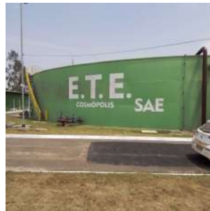
Foto 4 - ETE Jaguari, em operação.
