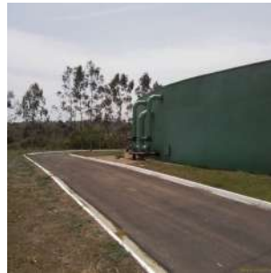
Foto 30 - Saída do efluente do reator.
