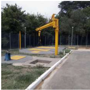
Foto 1 - ETEB Três Barras, que recebe o efluente antes de encaminhá-lo para a ETE.
