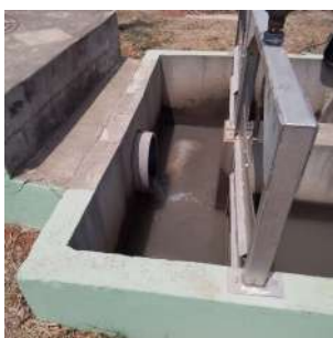
Foto 4 - Chegada do efluente ao tratamento preliminar.
