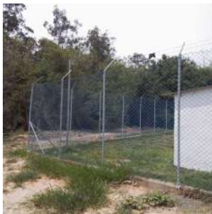
Foto 1 - Cerca no perímetro da área.
