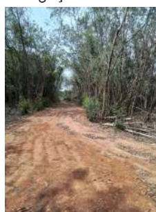
Foto 4 - Local onde foram realizadas as obras
