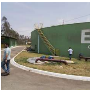
Foto 1 - Escada para acessar o reator.
