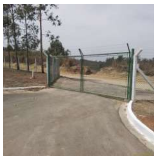
Foto 1 - Um dos portões de acesso à estação.
