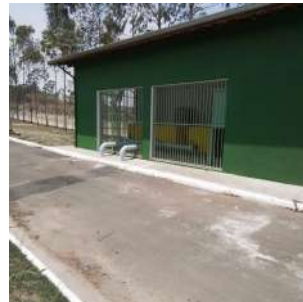
Foto 23 - Construção que abriga os sopradores e o sistema de desinfecção por ultravioleta.
