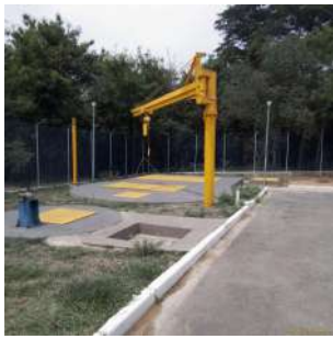
Foto 11 - Instalação para içamento das bombas.
