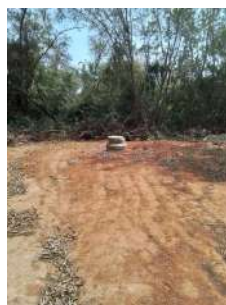
Foto 2 - PV do interceptor de esgoto no qual foi realizada interligação com a rede coletora.
