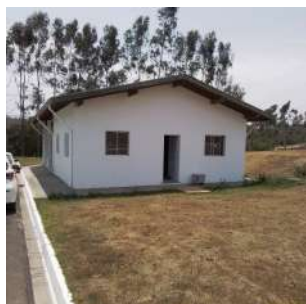
Foto 1 - Edificação que abrigará instalações do laboratório, além de dependências para operadores.
