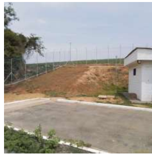
Foto 2 - Local limpo, sem detritos.
