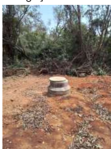
Foto 3 - PV do interceptor de esgoto no qual foi realizada interligação com a rede coletora.
