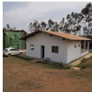
Foto 3 - Edificação que abrigará laboratório e dependências para os operadores.
