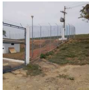
Foto 2 - Cerca no perímetro da área.
