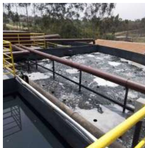
Foto 16 - Filtro aerado submerso no reator da ETE.
