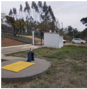
Foto 1 - Mato roçado na área da elevatória.
