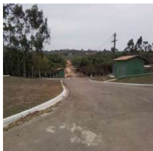
Foto 3 - Outro portão de acesso à estação.
