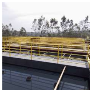
Foto 2 - Guarda-corpos no reator.
