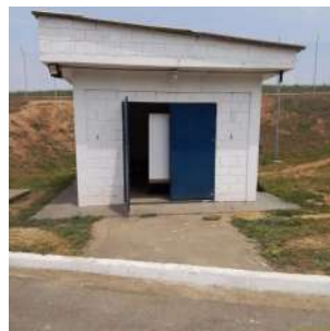
Foto 10 - Abrigo do gerador e painel elétrico.
