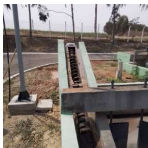
Foto 11 - Remoção de areia.
