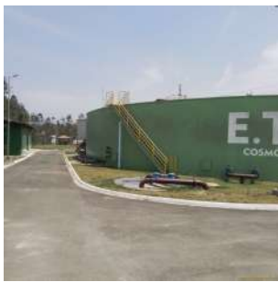
Foto 1 - Escada para acessar o reator.
