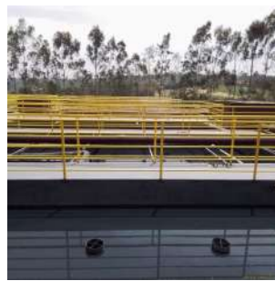
Foto 2 - Guarda-corpos no reator.
