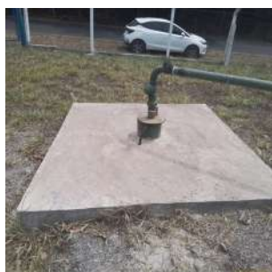
Foto 1 - Laje de proteção
