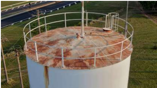
Foto 1 - Vista superior da cobertura do reservatório
