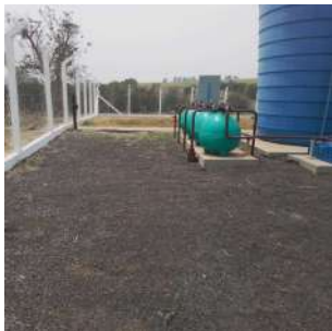
Foto 1 - Vista da área da ETE
