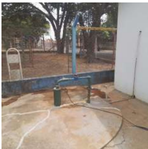
Foto 2 - Cavalete do poço de baixo Santa Cruz da Estrela
