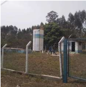
Foto 1 - Cercamento da área
