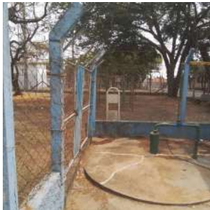
Foto 1 - Cercamento da área com alambrado
