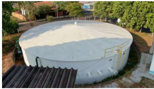
Foto 2 - Vista lateral do reservatório apoiado Bonanza
