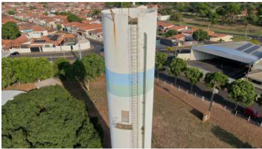
Foto 3 - Vista lateral do reservatório
