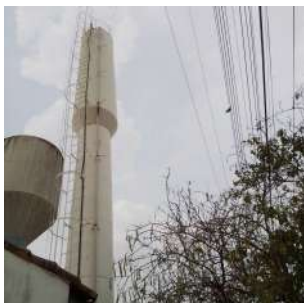
Foto 1 - Guarda-corpos e escada de acesso
