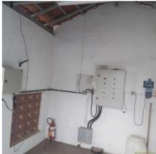
Foto 1 - Vista do interior da casa de dosagem de cloro e flúor
