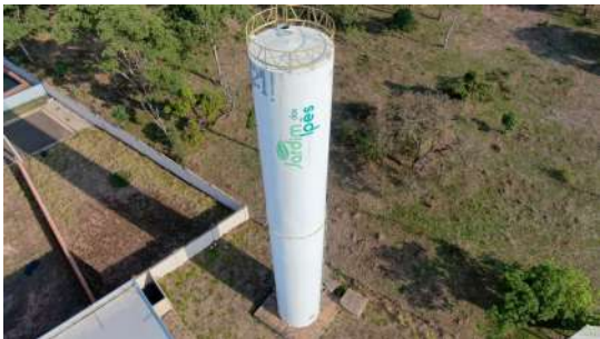
Foto 1 - Vista superior do reservatório Jardim dos Ipês
