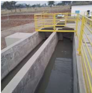
Foto 4 - Vista dos guarda-corpos no tratamento preliminar
