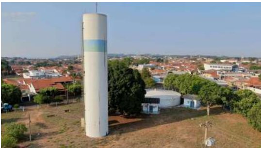
Foto 1 - Vistas do perímetro do reservatório.
