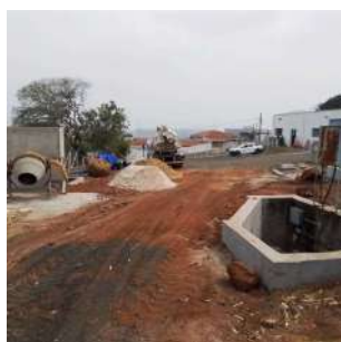
Foto 9 - Obras do sistema de desidratação de lodo
