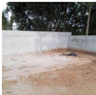
Foto 5 - Obras do sistema de desidratação de lodo
