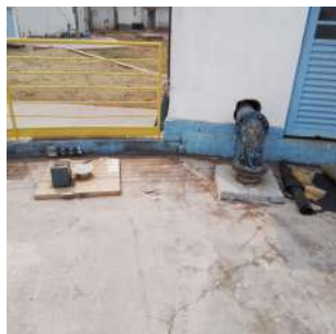
Foto 1 - Tampa de inspeção
