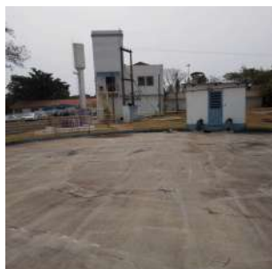
Foto 1 - Laje de cobertura do reservatório
