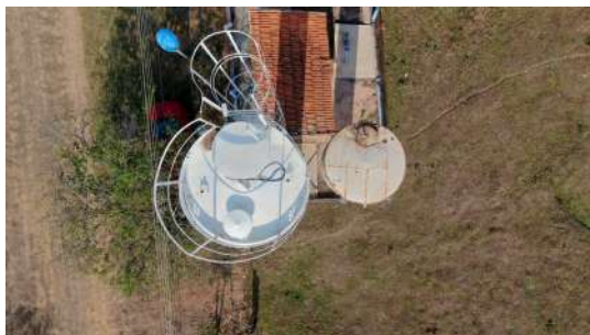
Foto 1 - Tampa de inspeção e saída para ventilação.
