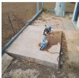
Foto 1 - Laje de proteção
