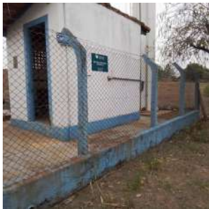
Foto 1 - Cercamento da área
