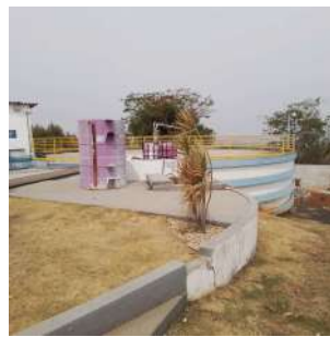
Foto 2 - Reservatório central ETA
