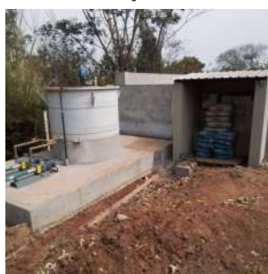
Foto 8 - Obras do sistema de desidratação de lodo
