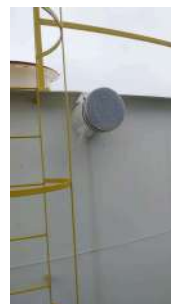
Foto 2 - Tela de proteção instalada
