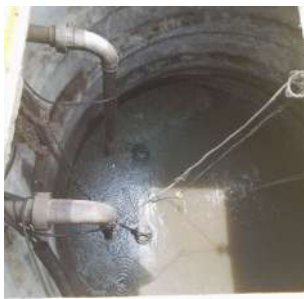
Foto 1 - Vista do interior do poço de sucção
