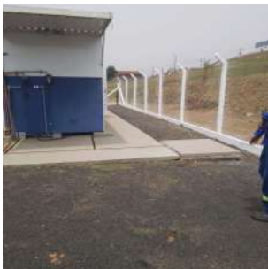
Foto 2 - Vista da área da ETE
