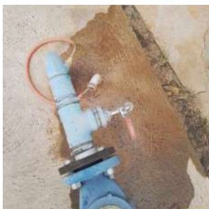
Foto 1 - Tomada de água
