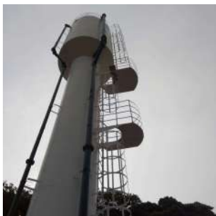
Foto 1 - Guarda-corpos na escada de acesso
