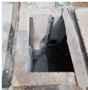
Foto 2 - Obras do sistema de desidratação de lodo
