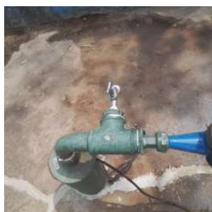
Foto 1 - Tomada de água
