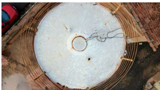
Foto 1 - Tampa de inspeção.
