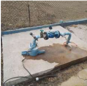
Foto 2 - Cavalete do poço Albinópolis
