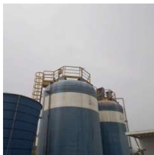
Foto 1 - Escadas e guarda-corpos
