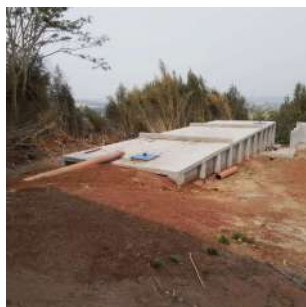
Foto 3 - Obras do sistema de desidratação de lodo
