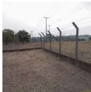
Foto 2 - Cercamento da área
