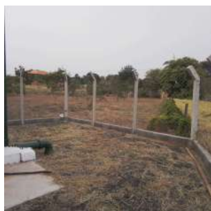
Foto 1 - Cercamento da área, com alambrado
