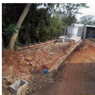
Foto 7 - Obras do sistema de desidratação de lodo
