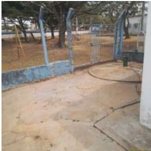
Foto 2 - Vista externa da área
