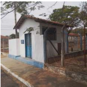
Foto 1 - Vista externa da área do poço
