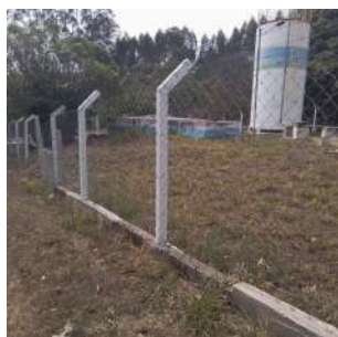
Foto 1 - Cercamento da área
