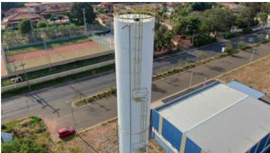
Foto 2 - Reservatório Jardim dos Ipês
