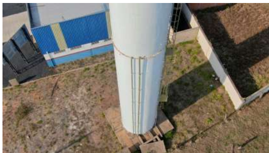
Foto 3 - Vista lateral do reservatório Jardim dos Ipês
