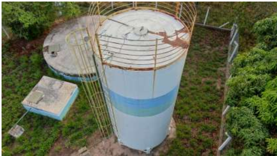
Foto 1 - Tampa de inspeção.
