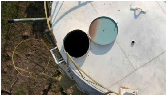
Foto 1 - Tampa de inspeção aberta na inspeção com drone
