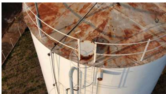
Foto 1 - Tampa de inspeção.
