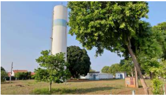
Foto 4 - Vistas do perímetro do reservatório.
