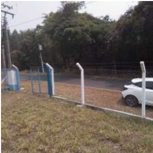
Foto 1 - Cercamento da área.
