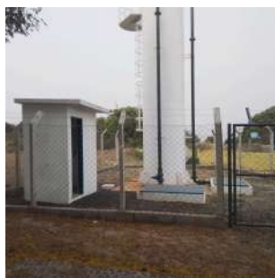
Foto 1 - Vista externa do reservatório Veneto
