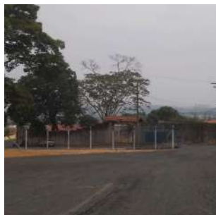
Foto 1 - Cercamento da área
