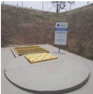
Foto 4 - Poço de sucção
