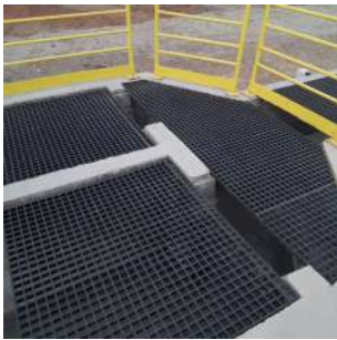
Foto 6 - Grades substituídas (PRFV)
