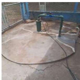
Foto 1 - Laje de proteção
