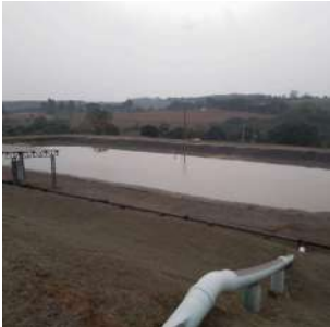
Foto 7 - Vista da lagoa de decantação
