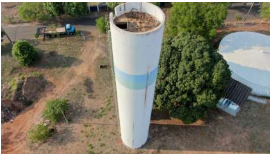
Foto 2 - Reservatório Jardim Bonanza
