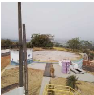
Foto 1 - Vista superior do reservatório central ETA
