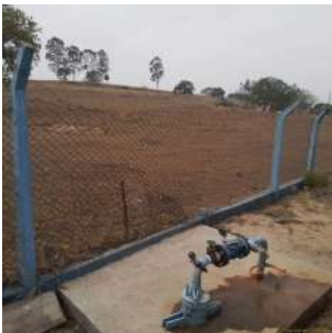
Foto 1 - Cercamento da área
