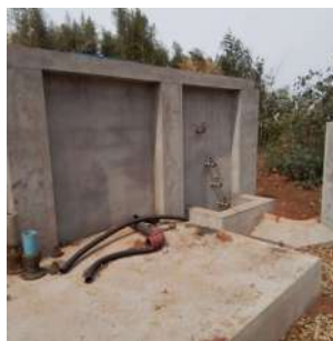
Foto 4 - Obras do sistema de desidratação de lodo
