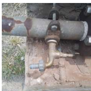
Foto 1 - Tomada de água
