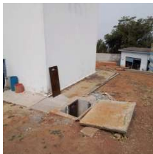
Foto 1 - Obras do sistema de desidratação de lodo
