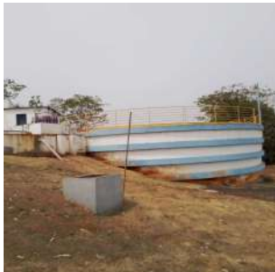
Foto 3 - Vista lateral do reservatório central ETA
