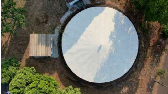
Foto 3 - Vista superior do reservatório apoiado Bonanza
