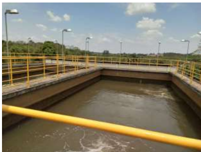
Foto 3 - Guarda corpo do reservatório de água bruta.
