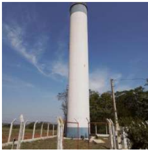
Foto 1 - Vista frontal do Reservatório.
