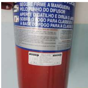
Foto 1 - Validade do extintor.
