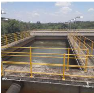
Foto 12 - Reservatório de água bruta.
