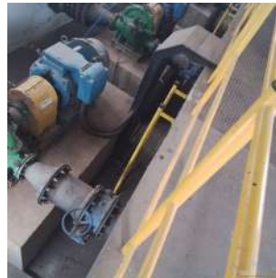
Foto 2 - Corrimãos da escada da E.E.A.B. 02
