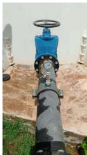
Foto 1 - Manômetro para medição de nível.
