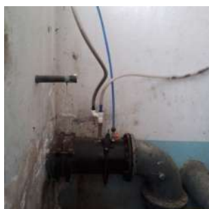
Foto 1 - Ponto de aplicação de flúor e hipoclorito de cálcio.
