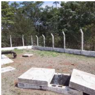
Foto 1 - A área encontra-se inteiramente fechada por alambrado.
