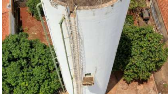
Foto 6 - Vista da escada de acesso e guarda-corpo
