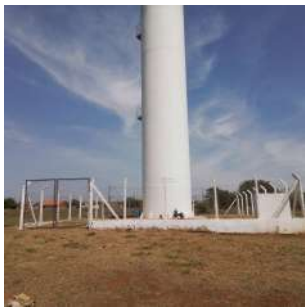
Foto 1 - Entrada do reservatório
