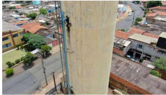
Foto 2 - Extravisor da célula intermediária.
