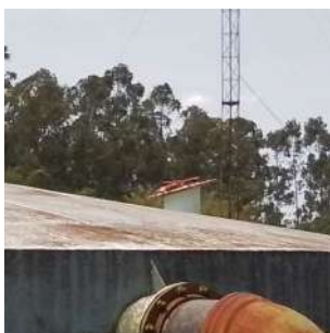
Foto 1 - Tela de proteção metálica.
