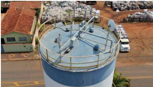
Foto 3 - Vista da cobertura.
