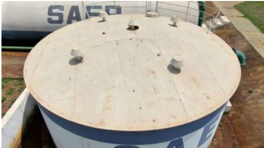
Foto 3 - Cobertura do reservatório de 100m³.
