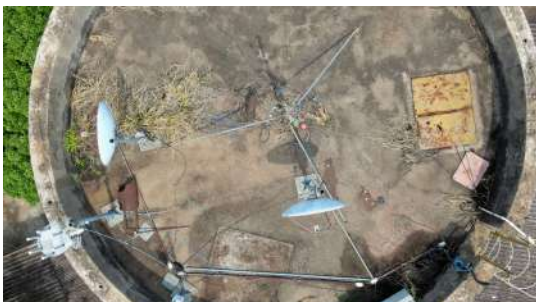
Foto 1 - Tampa de inspeção.
