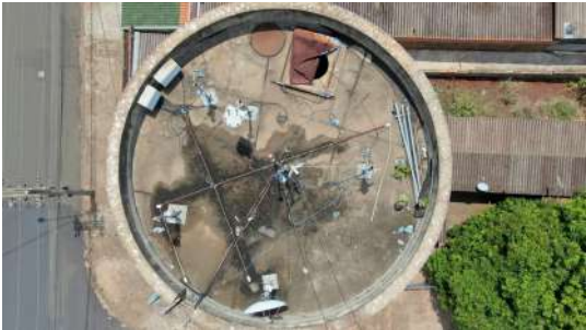
Foto 4 - Vista da cobertura.
