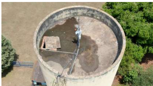
Foto 2 - Vista de laje de cobertura
