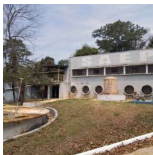
Foto 6 - Fachada da ETA I.
