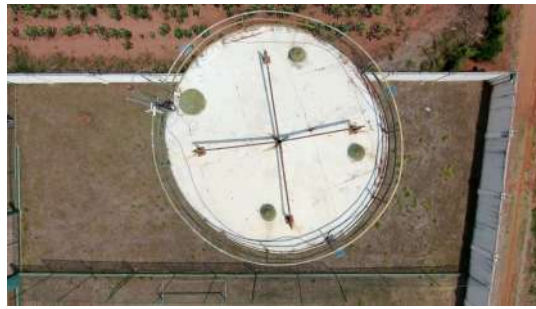
Foto 4 - Vista da cobertura
