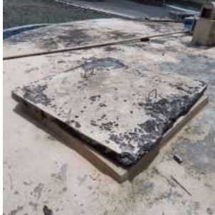
Foto 1 - Tampa de inspeção.
