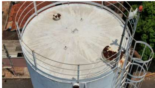
Foto 2 - Vista da cobertura do reservatório.
