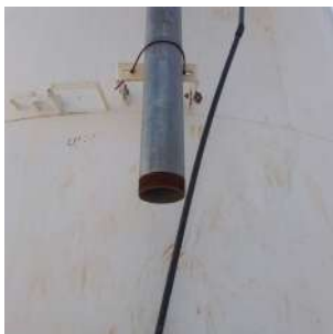
Foto 1 - Ponta do tubo extravasor.
