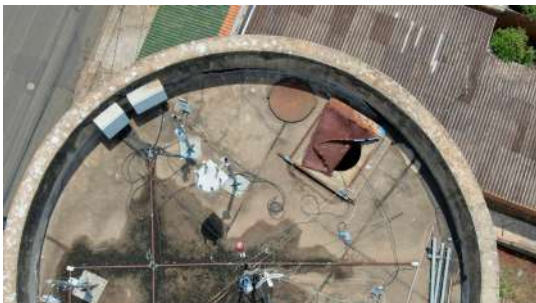
Foto 1 - Detalhe da tampa de inspeção.
