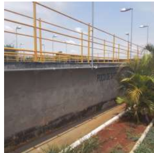
Foto 9 - Reservatório de água bruta
