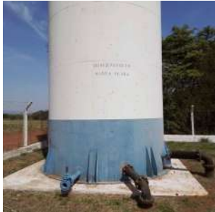
Foto 3 - Base do Reservatório.
