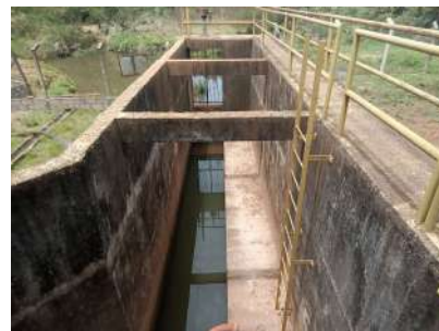
Foto 3 - Canal da captação reserva.
