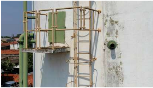
Foto 1 - Extravasador inferior.
