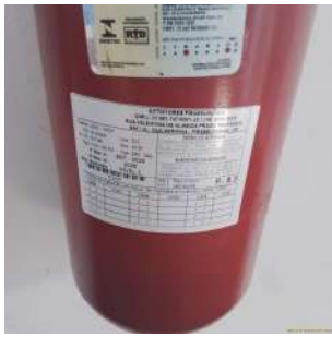
Foto 1 - Validade do extintor de incêndio.
