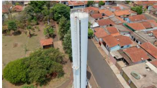
Foto 4 - Guarda-corpos na cobertura e escada de acesso
