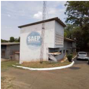
Foto 1 - Vista da fachada da captação.
