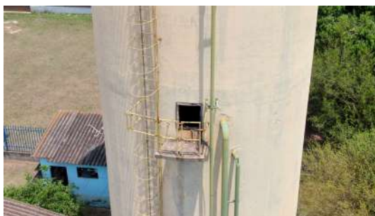
Foto 2 - Entrada sem porta e/ou tela de proteção.
