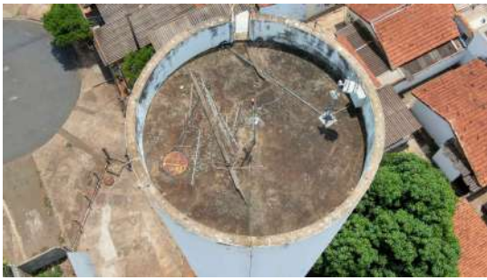
Foto 3 - Vista da laje de cobertura
