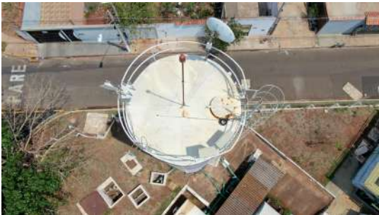
Foto 4 - Cobertura do reservatório.
