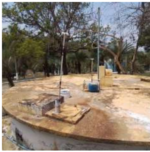
Foto 1 - A medição de nível corre por tubo, como régua, que flutua conforme variação do nível d'água.
