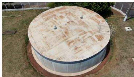
Foto 2 - Cobertura do reservatório.
