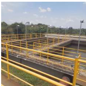
Foto 10 - Reservatório de água bruta.
