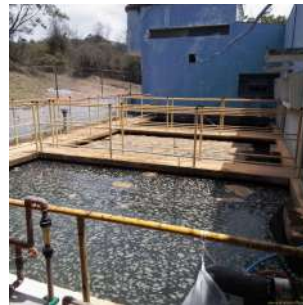
Foto 2 - Guarda-corpos dos filtros.
