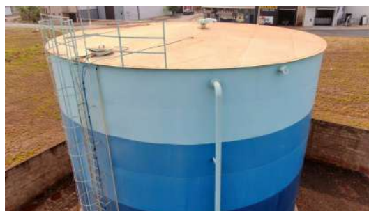
Foto 10 - Vista geral do reservatório.
