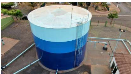
Foto 3 - Guarda-corpo do reservatório.
