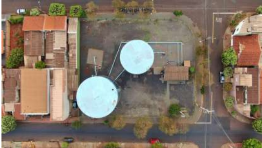
Foto 3 - Vista aérea do cercamento.
