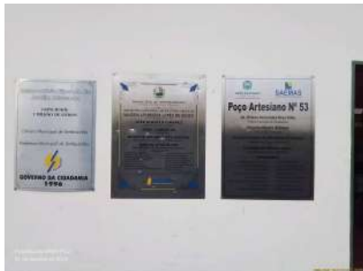
Foto 1 - Placas de identificação afixadas na edificação da EEA.
