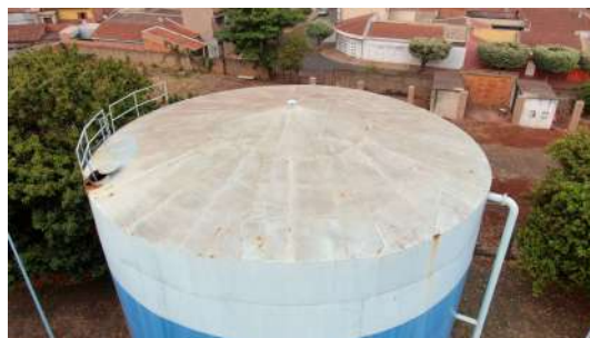
Foto 2 - Tubulação de ventilação no topo do reservatório.
