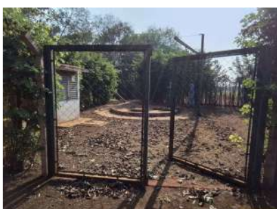
Foto 1 - Portão de acesso à EEE.
