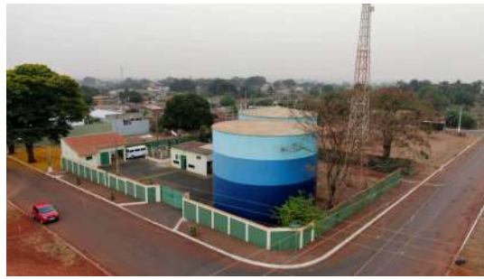
Foto 2 - Presença de para-raios em torre próxima ao reservatório.
