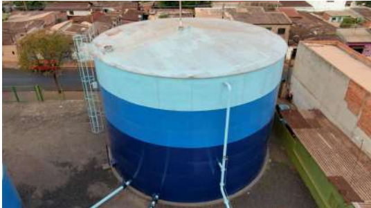
Foto 13 - Vista geral dos reservatórios.
