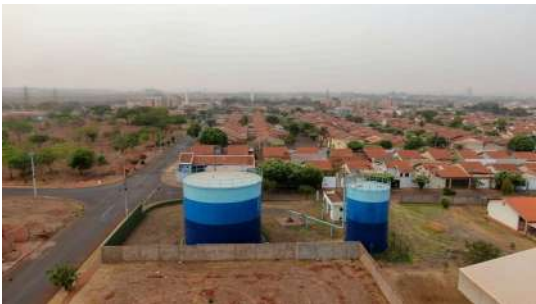
Foto 4 - Vista geral dos reservatórios.
