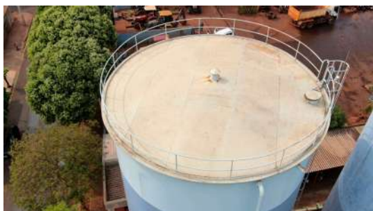
Foto 3 - Guarda-corpo no topo do reservatório metálico.
