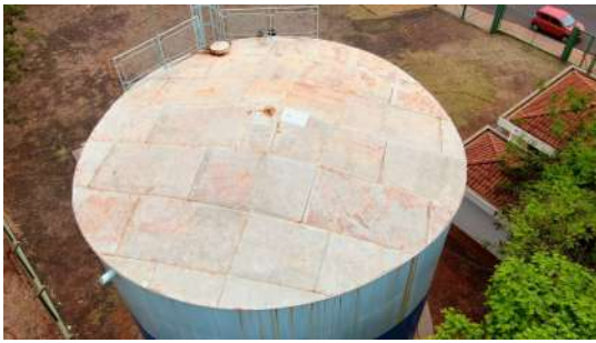
Foto 9 - Vista geral do reservatório.
