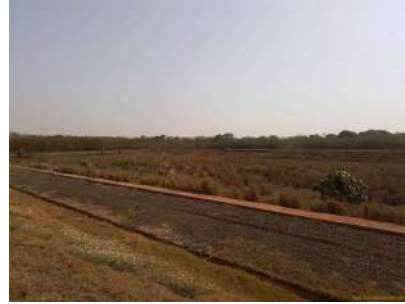
Foto 11 - Vista geral da lagoa facultativa 1 desativada.
