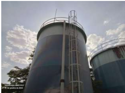
Foto 3 - Vista geral dos reservatórios.
