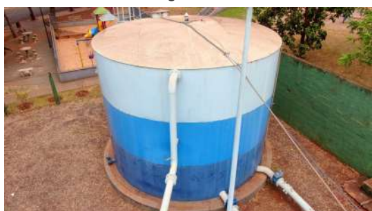
Foto 5 - Vista geral do reservatório.
