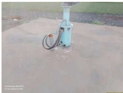
Foto 1 - Laje de proteção do poço.
