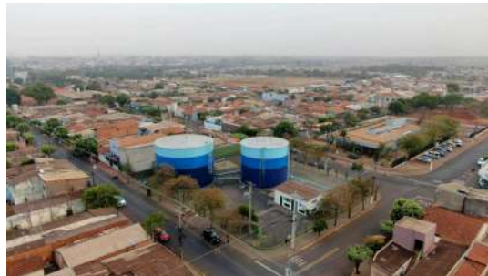
Foto 16 - Vista geral dos reservatórios.
