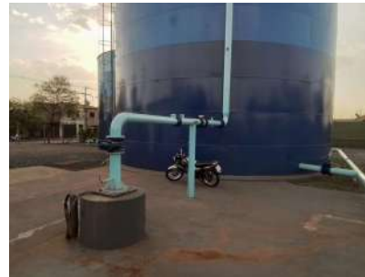
Foto 2 - Vista geral do poço de captação.
