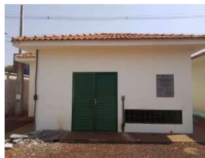
Foto 6 - Vista externa da edificação que abriga a EEA.
