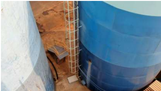
Foto 11 - Vista geral dos reservatórios.
