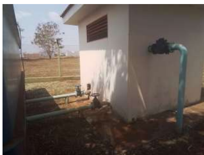
Foto 5 - Vista geral das tubulações externas da EEA.
