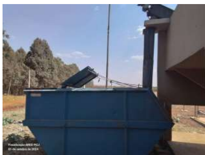
Foto 10 - Caçamba do desarenador.
