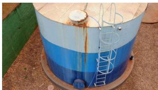
Foto 8 - Vista geral do reservatório.
