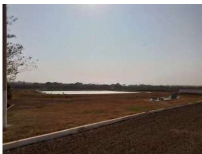
Foto 1 - Vista geral do local onde se situa a ETE.
