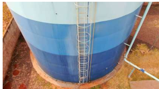
Foto 2 - Tubo para medição de nível.
