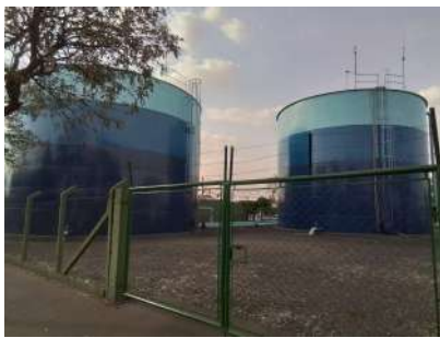
Foto 1 - Vista geral do local onde se situam os reservatórios.
