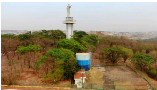
Foto 1 - Vista aérea do cercamento.
