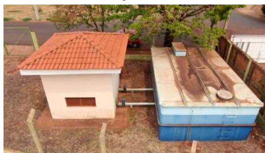
Foto 6 - Vista geral do reservatório.
