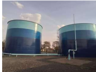
Foto 4 - Vista geral dos reservatórios.
