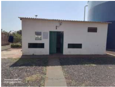
Foto 1 - Vista geral da edificação da EEA.
