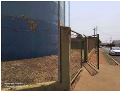
Foto 1 - Local cercado com alambrado.
