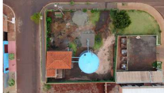
Foto 6 - Vista aérea do poço.
