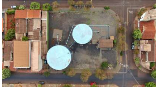
Foto 14 - Vista geral dos reservatórios.
