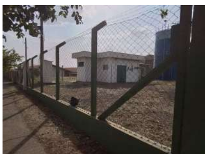
Foto 1 - Cercamento do local da EEA com alambrado.
