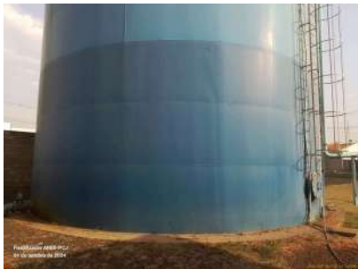
Foto 1 - Vista da parte inferior da estrutura do reservatório.
