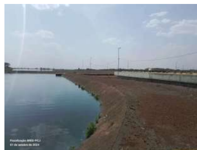
Foto 15 - Terceira entrada lateral da lagoa anaeróbia.
