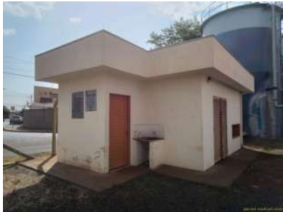
Foto 2 - Vista geral da edificação da EEA.
