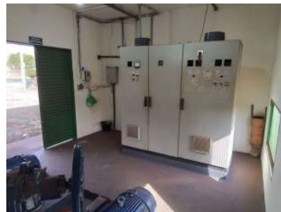
Foto 4 - Vista do interior da edificação da EEA.
