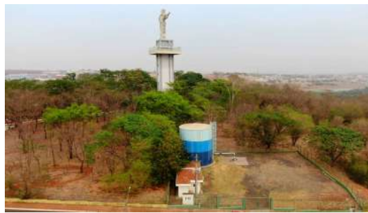
Foto 2 - Vista aérea do cercamento.
