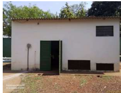
Foto 4 - Vista geral da edificação da EEA.
