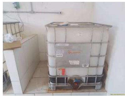
Foto 18 - Tnauwe reserva de produto para desinfecção final.
