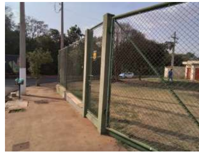
Foto 2 - Cercamento com alambrado.
