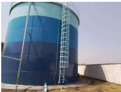
Foto 1 - Tubo para medição de nível.
