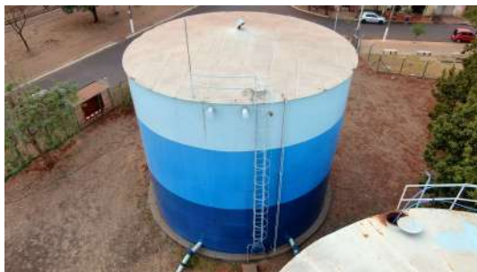
Foto 10 - Vista geral dos reservatórios.
