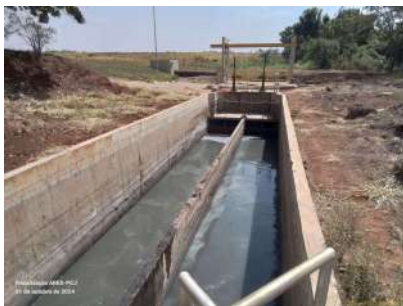
Foto 4 - Sistema desarenador.
