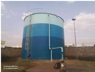
Foto 2 - Vista geral do reservatório.
