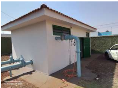
Foto 1 - Vista externa da edificação da EEA e suas tubulações.
