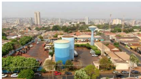
Foto 14 - Vista geral dos reservatórios.
