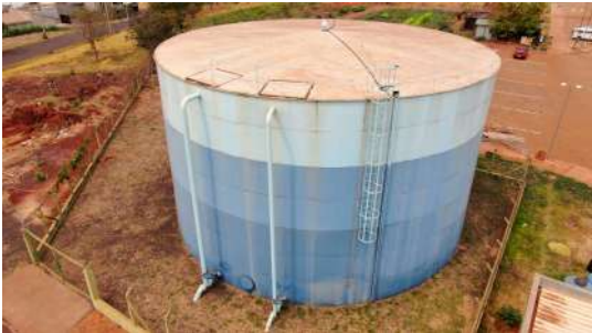
Foto 2 - Vista geral do reservatório.
