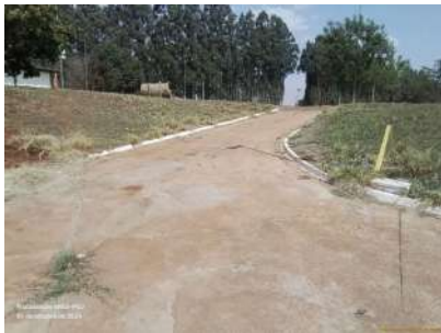
Foto 1 - Acesso para a elevatória.
