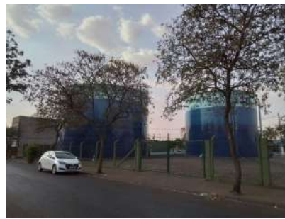
Foto 2 - Vista geral do local onde se situam os reservatórios.
