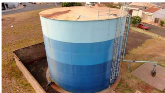
Foto 11 - Vista geral do reservatório.
