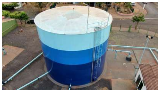
Foto 8 - Vista geral dos reservatórios.
