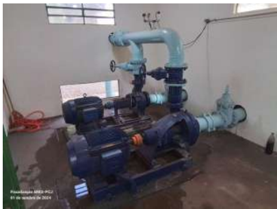
Foto 5 - Vista do interior da edificação da EEA.
