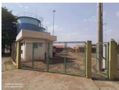
Foto 1 - Vista geral do local onde se situa o poço.
