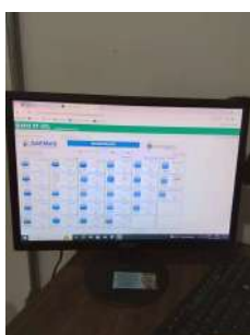
Foto 3 - Sistema de medição de nível dos reservatórios por telemetria.
