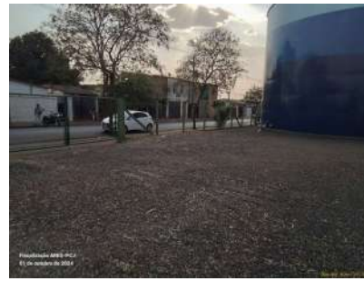
Foto 2 - Local onde se situa a EEA cercado com alambrado.
