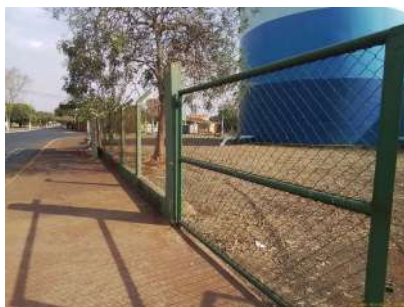
Foto 1 - Local cercado com alambrado.
