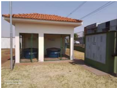
Foto 4 - Vista geral da casa de química.
