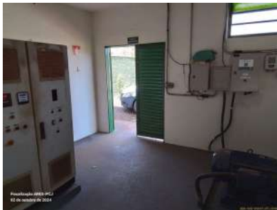
Foto 1 - Porta de acesso à EEA.
