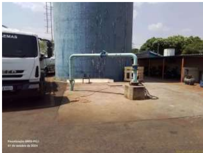
Foto 1 - Vista geral do poço.
