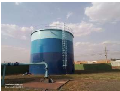
Foto 1 - Guarda-corpos na escada e em todo perímetro do topo do reservatório.
