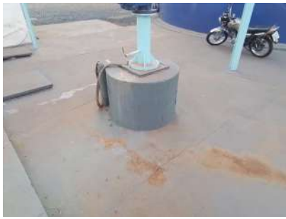
Foto 1 - Laje de proteção do poço.
