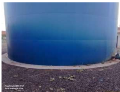
Foto 4 - Vista da base do reservatório.
