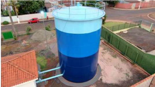
Foto 5 - Vista geral do reservatório.
