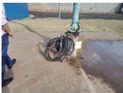
Foto 1 - Laje de proteção do poço.
