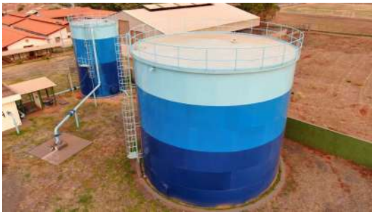
Foto 5 - Vista geral dos reservatórios.
