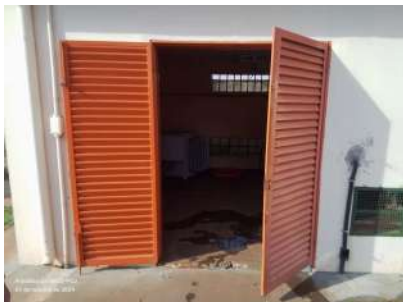
Foto 1 - Porta de acesso à EEA.
