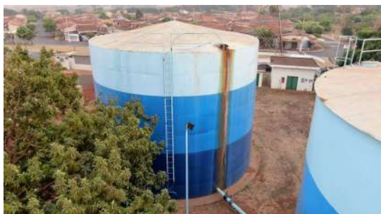
Foto 7 - Vista geral dos reservatórios.
