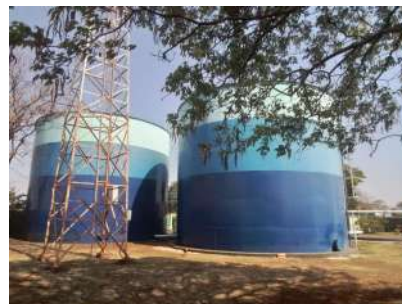
Foto 2 - Vista dos reservatórios.
