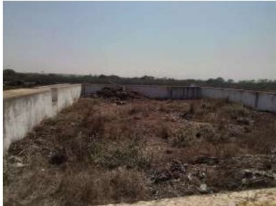
Foto 5 - Vista do interior do tanque de lodo 02.
