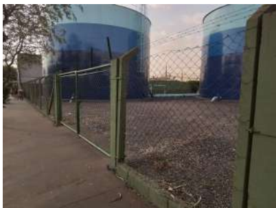
Foto 1 - Local cercado com alambrado.
