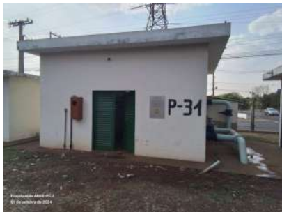
Foto 1 - Vista geral da edificação da EEA.
