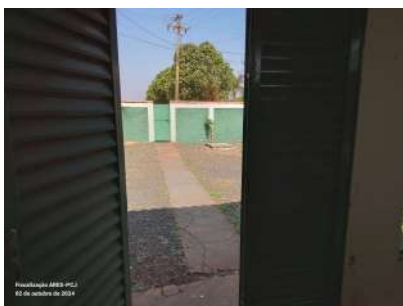
Foto 1 - EEA situa-se em edificação de alvenaria em local cercado por muro.
