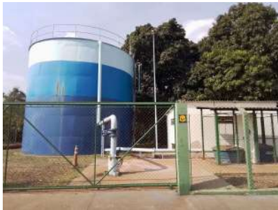
Foto 1 - Vista geral do local onde se situa o poço para captação subterrânea.
