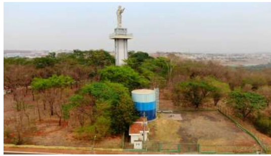
Foto 10 - Vista geral do reservatório.
