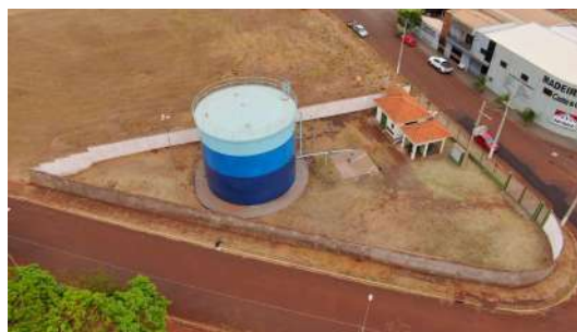
Foto 2 - Vista aérea do cercamento.
