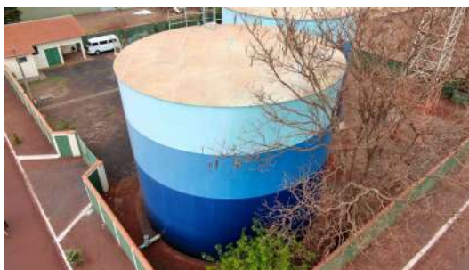
Foto 5 - Vista dos reservatórios.
