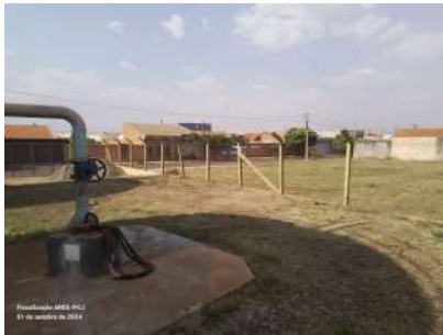
Foto 1 - Local cercado com alambrado.
