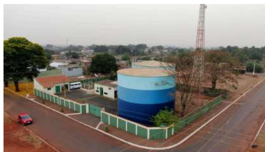
Foto 2 - Vista aérea do cercamento.
