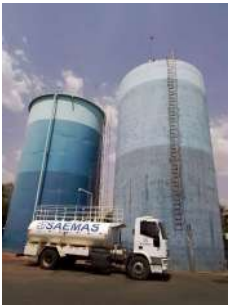
Foto 1 - Vista geral dos reservatórios.
