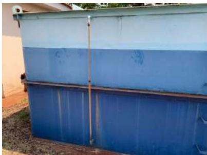
Foto 1 - Tubo para medição de nível.
