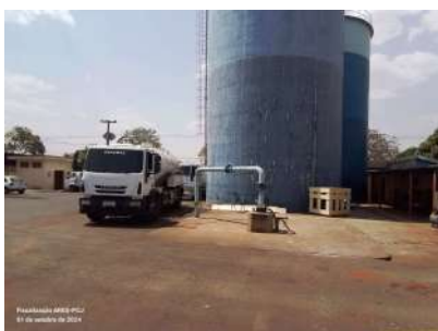
Foto 1 - Local cercado com muro de alvenaria.
