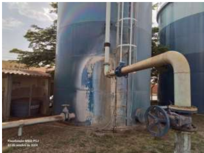
Foto 2 - Detalhe da estrutura metálica.
