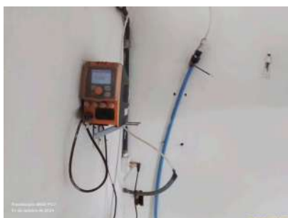
Foto 5 - Equipamento para dosagem de Ácido Fluossilícico.
