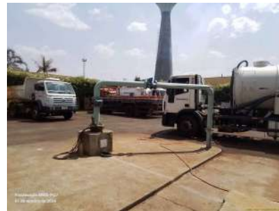
Foto 2 - Vista geral do poço.
