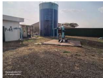
Foto 2 - Local cercado por muro de alvenaria e alambrado.
