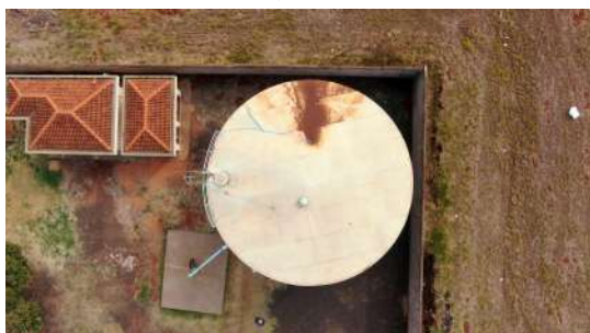
Foto 15 - Vista geral do reservatório.
