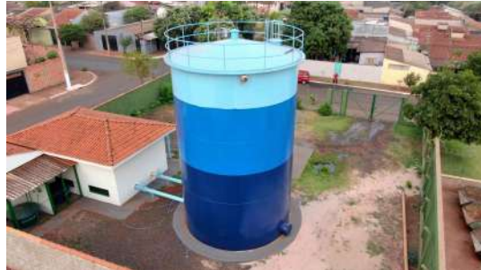
Foto 6 - Vista geral do reservatório.
