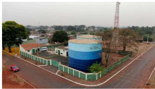
Foto 2 - Vista aérea do cercamento.
