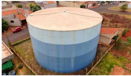
Foto 4 - Vista geral do reservatório.
