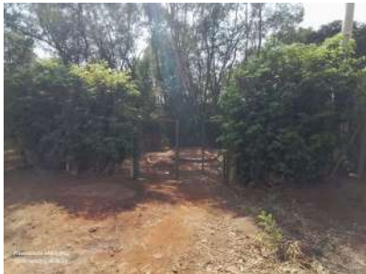
Foto 1 - Vista geral da EEEB.
