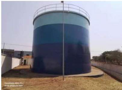
Foto 2 - Vista geral do reservatório.
