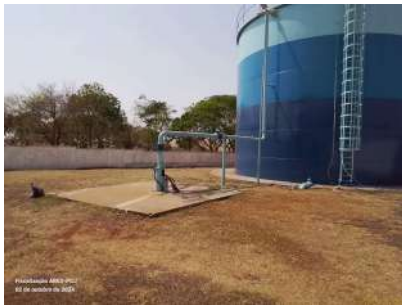
Foto 1 - Local cercado com muro de alvenaria.
