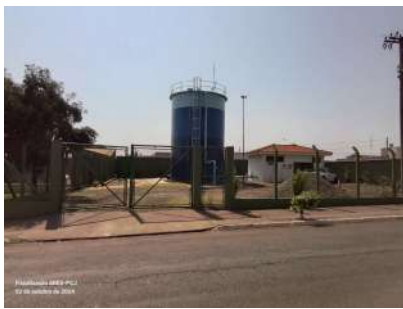
Foto 1 - Local cercado com muro de alvenaria e alambrado.
