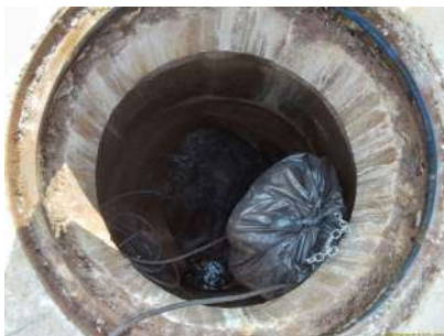
Foto 3 - Sensor de medição de vazão, segundo o operador.
