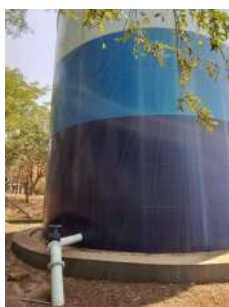
Foto 3 - Vista detalhada do reservatório.
