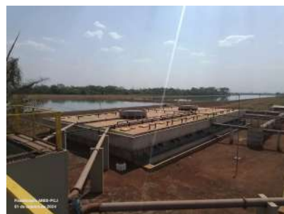
Foto 9 - Vista dos reatores UASB 3 e 4.
