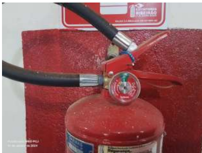
Foto 3 - Extintor despressurizado.
