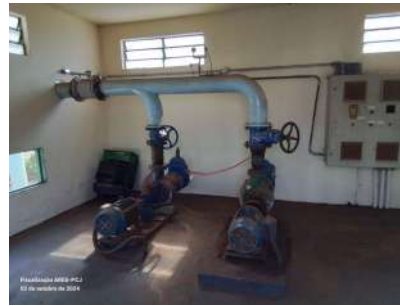
Foto 2 - Vista geral do interior da EEA.
