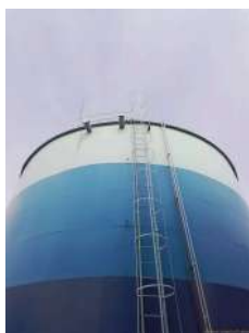
Foto 1 - Tubo extravasor de um dos reservatório.
