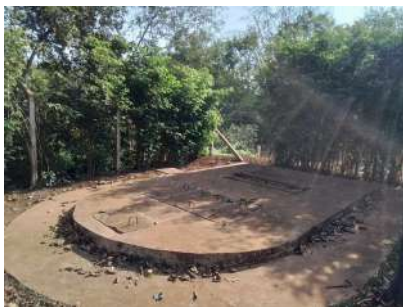
Foto 3 - Laje do poço de bombeamento.
