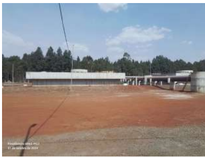
Foto 1 - Vista dos reatores UASB 1 e 2.
