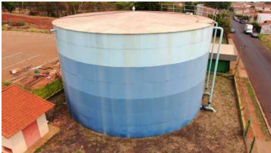
Foto 7 - Vista geral do reservatório.
