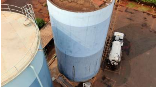
Foto 7 - Vista geral dos reservatórios.
