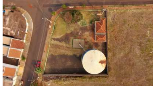
Foto 3 - Vista aérea do cercamento.
