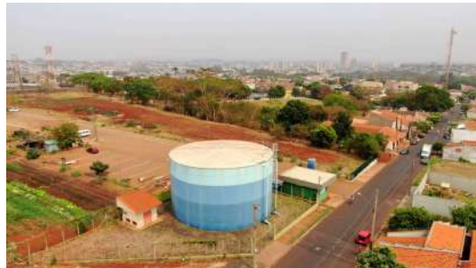
Foto 10 - Vista geral do reservatório.
