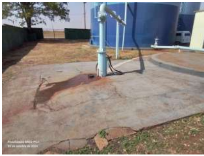
Foto 1 - Laje do poço.
