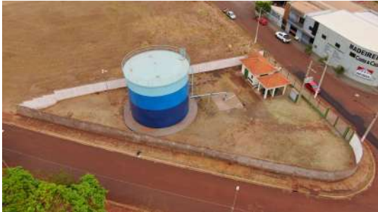
Foto 9 - Vista geral do reservatório.
