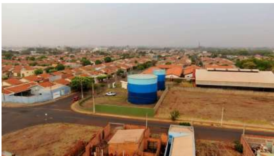
Foto 3 - Local cercado por muro de alvenaria e alambrado.
