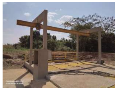
Foto 7 - Trilho, trole e talha da EEE.
