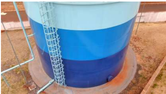
Foto 5 - Vista geral do reservatório.
