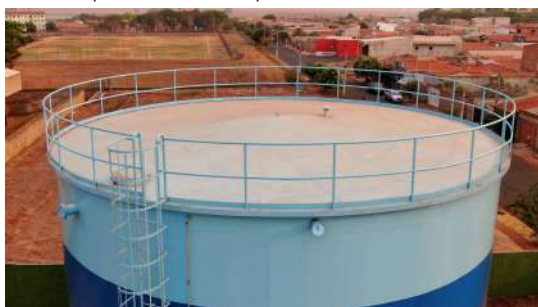
Foto 3 - Guarda-corpo superior do reservatório.
