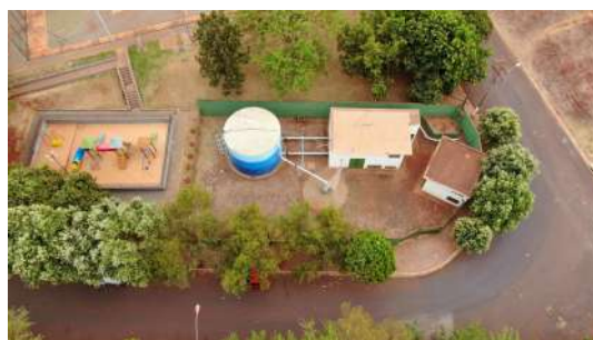
Foto 2 - Vista aérea do cercamento.
