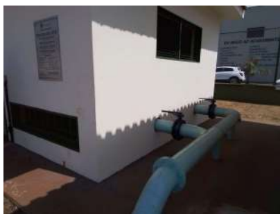
Foto 5 - Vista geral das tubulações externas da EEA.
