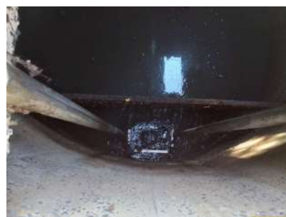
Foto 2 - Gradeamento e cesto para retirada dos resíduos.
