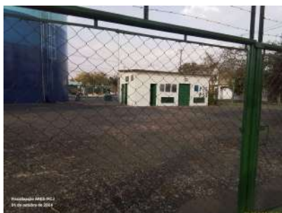
Foto 1 - Vista geral do local onde se situa a EEA.
