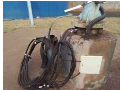
Foto 2 - Medidor de nível por sonda.
