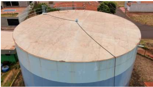
Foto 1 - Tubulação de ventilação.
