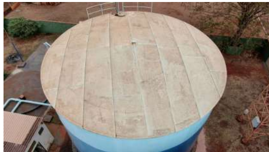
Foto 3 - Tubulação de ventilação no topo.
