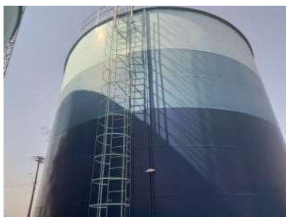
Foto 1 - Guarda-corpos em boas condições em um dos reservatórios.
