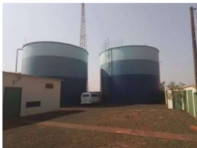
Foto 1 - Vista geral do interior do local onde situam-se os reservatórios
