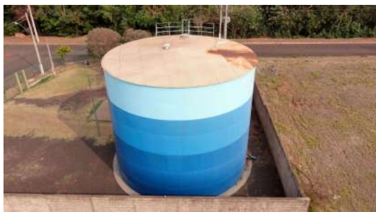
Foto 13 - Vista geral do reservatório.
