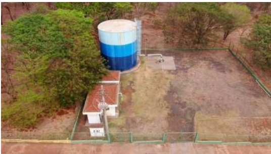
Foto 4 - Vista aérea do poço.
