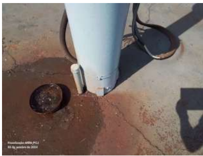
Foto 1 - Tubo para medição de nível, a qual é realizada por sonda.
