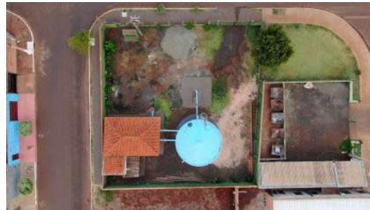
Foto 2 - Vista aérea do cercamento.
