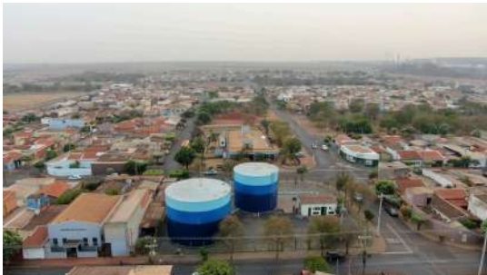
Foto 15 - Vista geral dos reservatórios.
