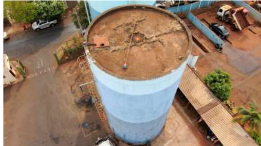
Foto 8 - Vista geral dos reservatórios.
