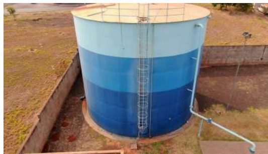
Foto 2 - Guarda-corpos na escada e topo do reservatório.
