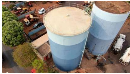
Foto 6 - Vista geral dos reservatórios.
