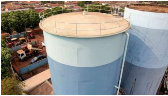
Foto 5 - Vista geral dos reservatórios.
