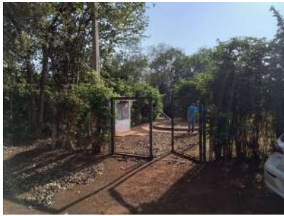
Foto 1 - Acesso ao local onde se situa a EEE.
