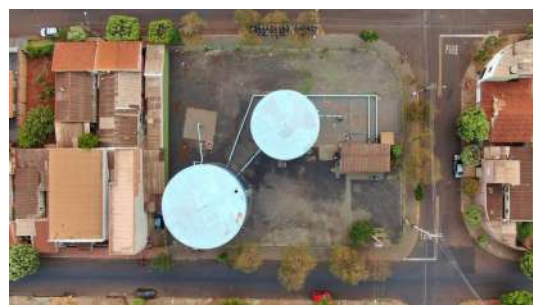
Foto 2 - Vista aérea do cercamento.
