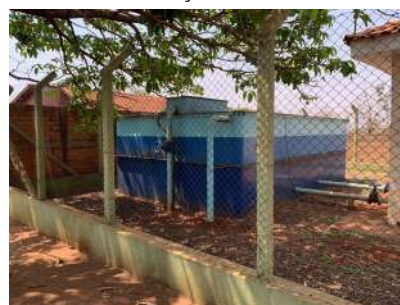
Foto 4 - Vista geral do reservatório.
