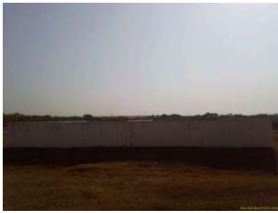
Foto 3 - Vista geral dos tanques de lodo.
