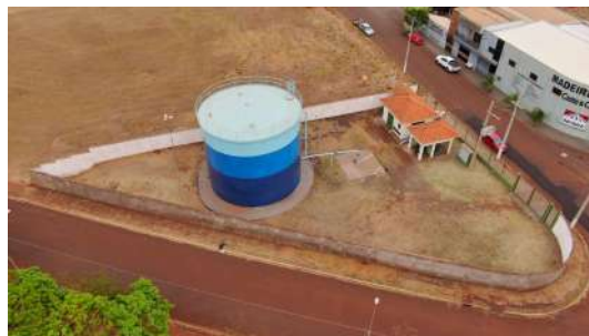
Foto 2 - Vista aérea do cercamento.
