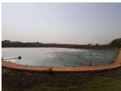
Foto 5 - Vista geral da lagoa anaeróbia 01 com tubulação de saída de esgoto.
