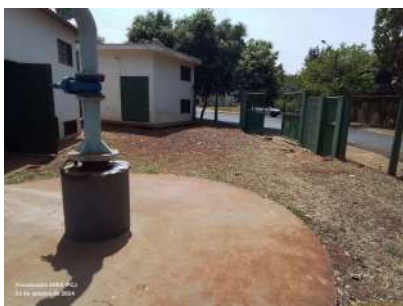
Foto 1 - Local cercado com alambrado.
