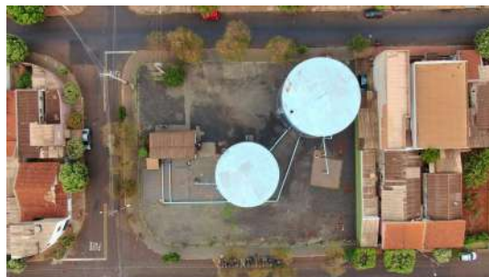
Foto 2 - Vista aérea do cercamento.
