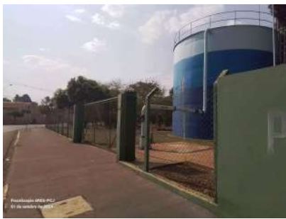
Foto 1 - Local cercado com alambrado.
