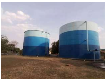
Foto 5 - Vista geral dos reservatórios.
