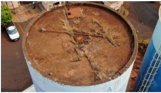
Foto 1 - Topo do reservatório de concreto.
