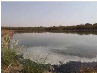
Foto 15 - Vista geral da lagoa facultativa 2.
