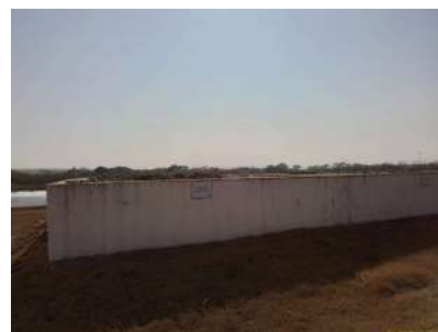
Foto 2 - Vista geral dos tanques de lodo.
