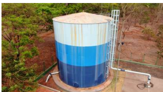
Foto 5 - Vista geral do reservatório.
