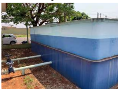
Foto 3 - Vista geral do reservatório.
