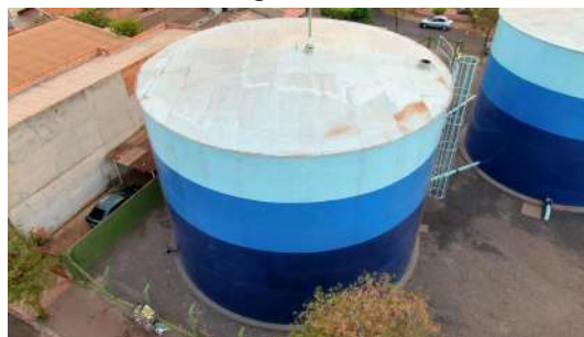
Foto 6 - Vista geral dos reservatórios.
