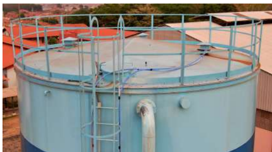
Foto 1 - Tampa de inspeção.
