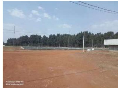
Foto 4 - Vista do leito de secagem do lodo.
