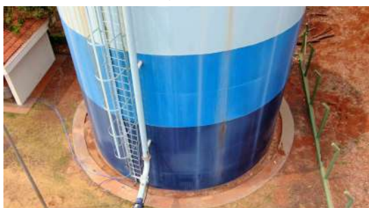
Foto 7 - Vista geral do reservatório.
