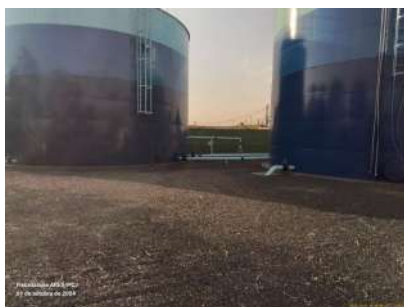
Foto 1 - Vista geral do local onde se situa o poço.
