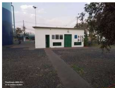
Foto 2 - Vista geral da edificação da EEA.
