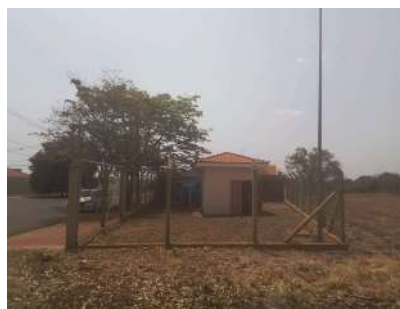
Foto 2 - Vista lateral da EEA com edificação que abriga a EEA ao fundo.
