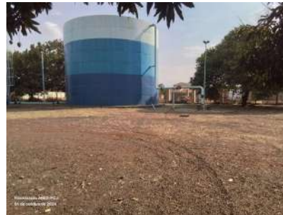
Foto 2 - Vista geral do poço.
