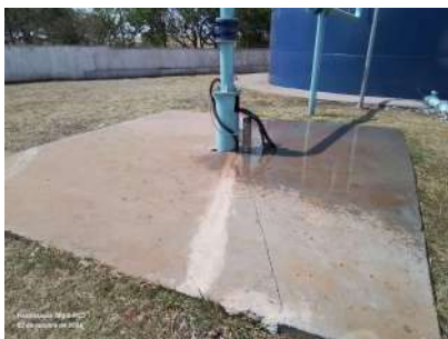
Foto 1 - Laje de proteção do poço.
