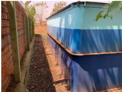
Foto 1 - Local cercado com alambrado.
