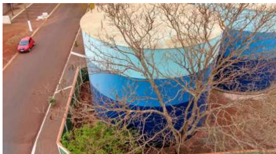
Foto 6 - Vista dos reservatórios.
