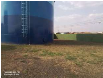
Foto 1 - Local cercado por muro de alvenaria e alambrado.
