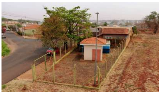
Foto 8 - Vista geral da EEA.
