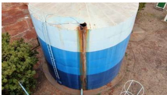
Foto 3 - Ausência de guarda-corpo no perímetro próximo às tampas de inspeção.
