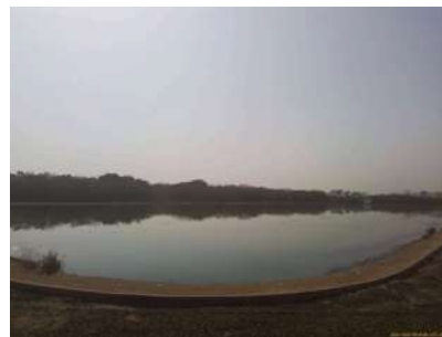
Foto 22 - Vista geral da lagoa facultativa 2.
