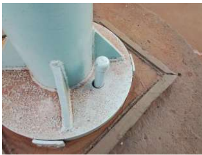
Foto 1 - Medidor de nível no cavalete do poço; a medição é realizada por meio de sonda.
