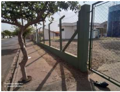
Foto 1 - Cercamento com alambrado.
