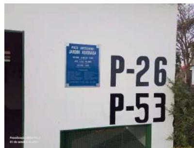
Foto 2 - Placa de identificação do local afixada na edificação da EEA.
