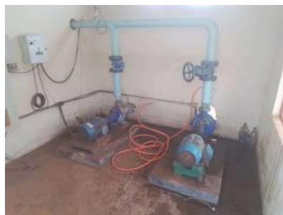
Foto 4 - Vista geral do interior da casa de bombas.
