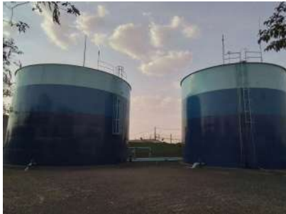
Foto 3 - Vista geral dos reservatórios.
