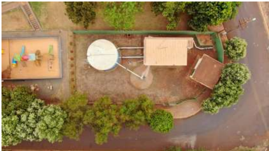
Foto 3 - Vista geral da captação subterrânea.
