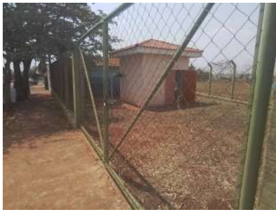
Foto 1 - Cercamento com alambrado no local onde se localiza a EEA.
