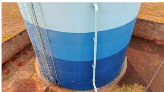
Foto 9 - Vista geral do reservatório.
