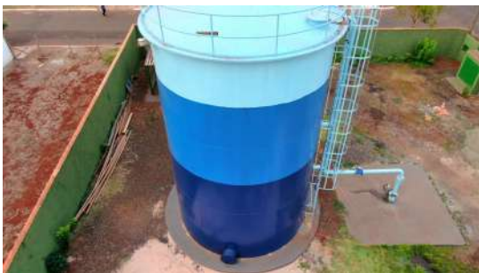
Foto 7 - Vista geral do reservatório.
