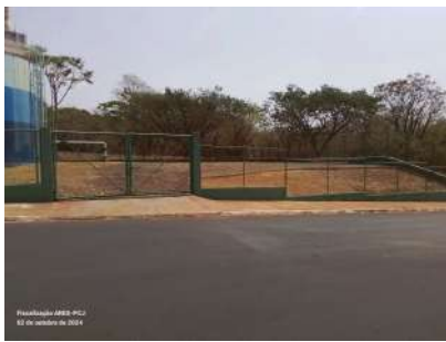
Foto 1 - Local cercado com alambrado.
