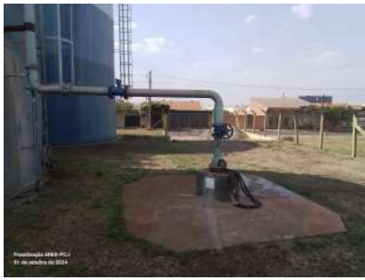
Foto 3 - Vista geral do poço.
