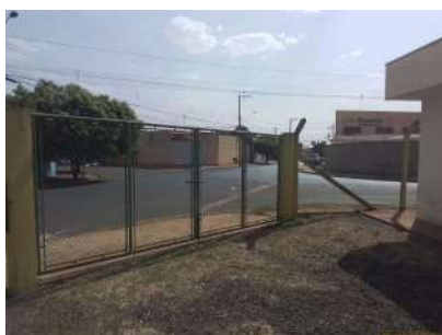
Foto 1 - Local cercado com alambrado.
