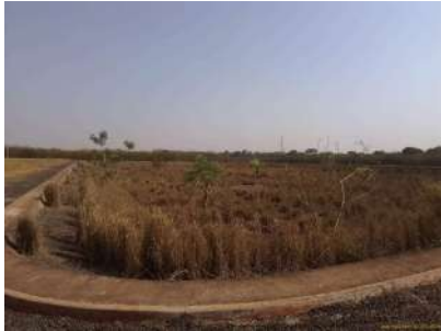
Foto 12 - Vista geral da lagoa facultativa 1 desativada.
