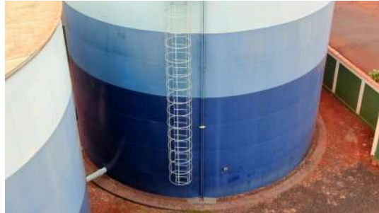
Foto 11 - Vista dos reservatórios.
