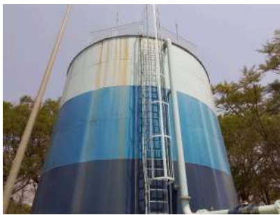
Foto 1 - Guarda-corpos do reservatório.
