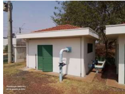
Foto 2 - Vista geral da EEA.
