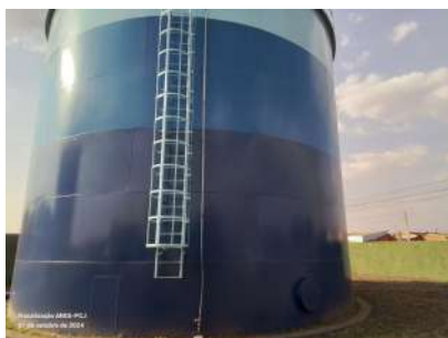
Foto 1 - Tubo de medição de nível.
