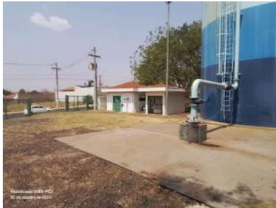
Foto 1 - Vista geral da EEA.
