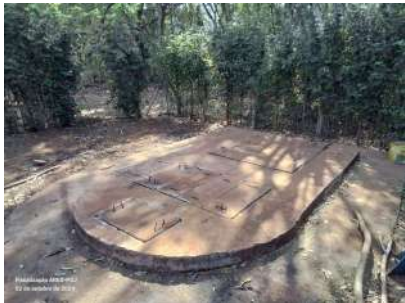
Foto 2 - Vista geral da EEEB.
