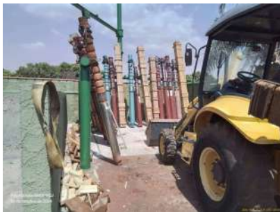
Foto 1 - Bombas reservas da SAEMAS.
