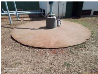
Foto 1 - Laje de proteção do poço.
