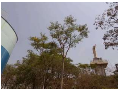
Foto 1 - Existência de para-raio em estrutura próxima ao reservatório.
