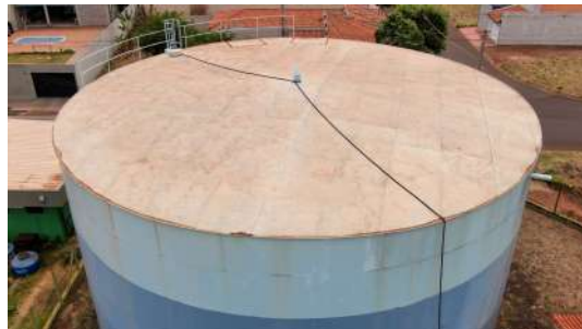
Foto 2 - Tubulação de ventilação no topo.
