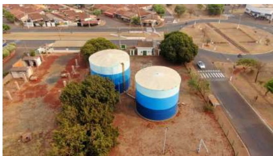
Foto 15 - Vista geral dos reservatórios.
