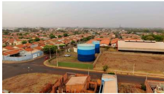
Foto 6 - Vista geral dos reservatórios.
