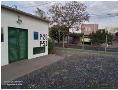
Foto 1 - EEA encontra-se no interior de edificação de alvenaria.
