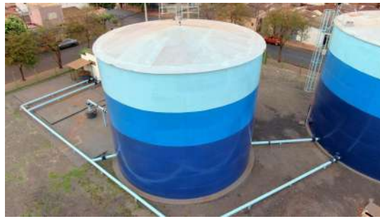
Foto 12 - Vista geral dos reservatórios.
