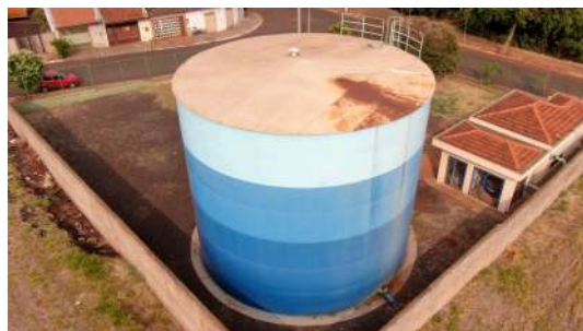
Foto 14 - Vista geral do reservatório.
