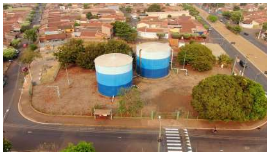
Foto 14 - Vista geral dos reservatórios.
