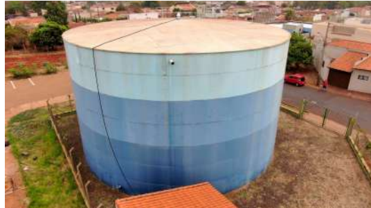
Foto 6 - Vista geral do reservatório.
