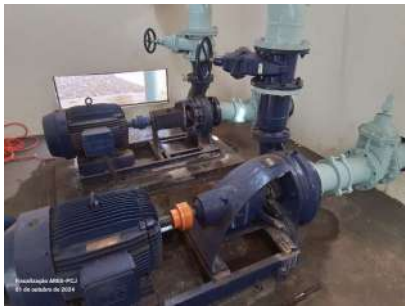
Foto 2 - Vista do interior da edificação da EEA.
