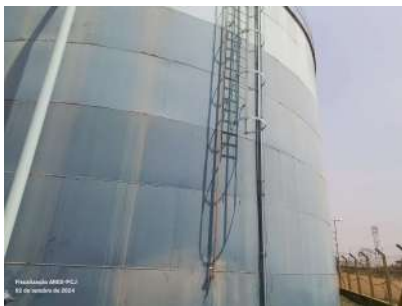
Foto 1 - Tubo para medição de nível.
