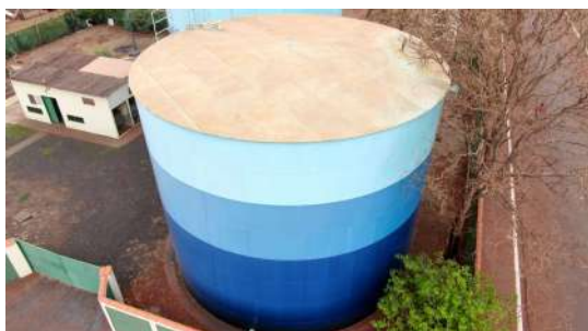
Foto 4 - Vista dos reservatórios.
