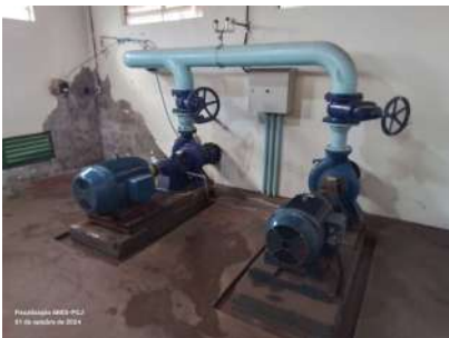
Foto 2 - Vista do interior da edificação da EEA.
