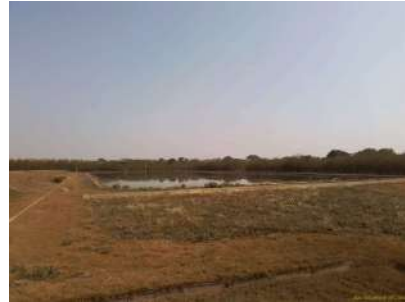
Foto 13 - Vista geral da lagoa facultativa 2.
