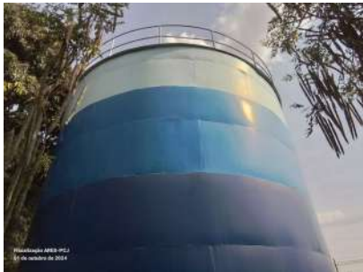
Foto 2 - Vista do reservatório.
