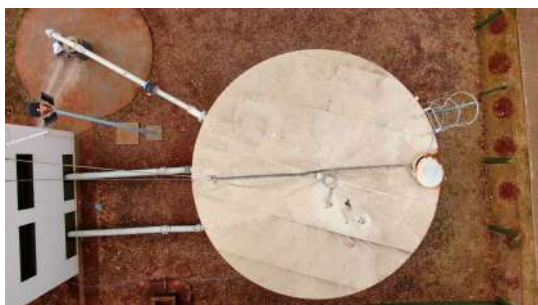
Foto 9 - Vista geral do reservatório.
