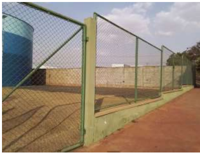
Foto 1 - Cercamento do local com alambrado e muro de alvenaria.
