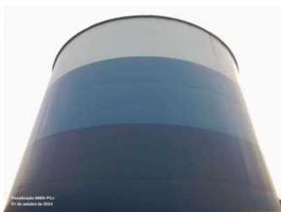
Foto 3 - Vista da parte superior da estrutura do reservatório.
