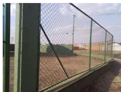
Foto 2 - Cercamento do local da EEA com alambrado.
