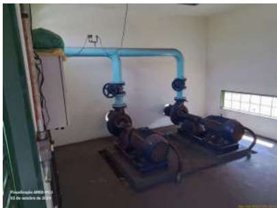
Foto 4 - Vista do interior da edificação da EEA.
