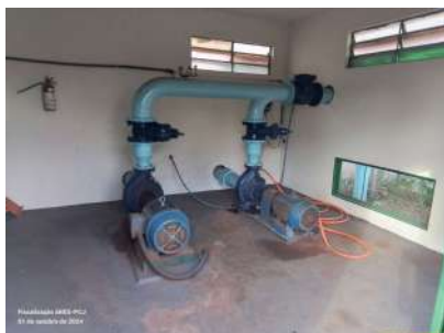
Foto 3 - Vista do interior da edificação da EEA.
