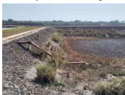
Foto 8 - Detalhe da lagoa anaeróbia 02 desativada com a tubulação de chegada de esgoto
