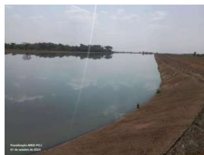
Foto 19 - Vista do talude da lagoa facultativa protegido com concreto.
