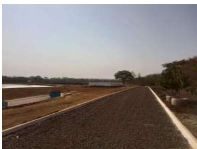
Foto 1 - Vista geral da ETE com os tanques de lodo ao fundo.
