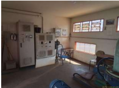
Foto 4 - Vista geral do interior da edificação da EEA.
