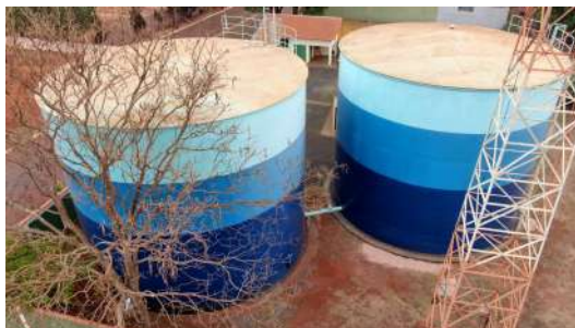
Foto 7 - Vista dos reservatórios.
