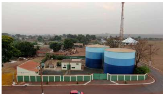
Foto 3 - Vista dos reservatórios.
