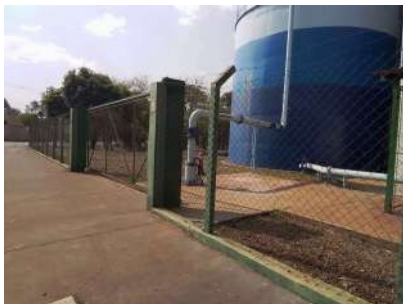
Foto 1 - Local cercado com alambrado.
