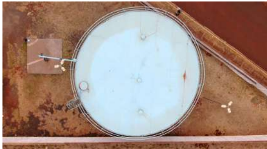
Foto 3 - Vista aérea do poço.
