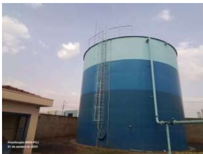
Foto 1 - Guarda-corpos na escada e topo do reservatório.
