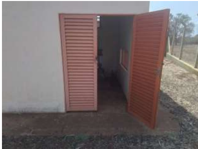
Foto 1 - Porta de acesso à EEA.
