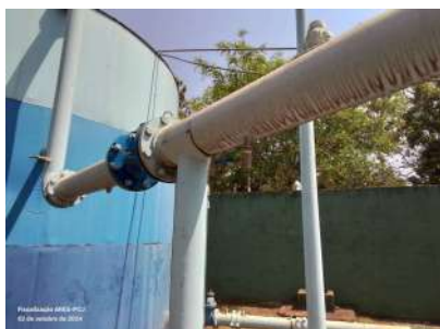
Foto 1 - Torneira para tomada de água bruta.
