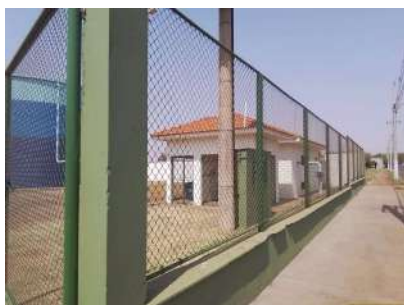
Foto 1 - Cercamento com alambrado no local onde se localiza a EEA.
