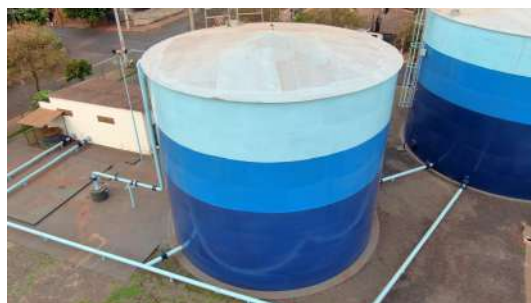
Foto 10 - Vista geral dos reservatórios.
