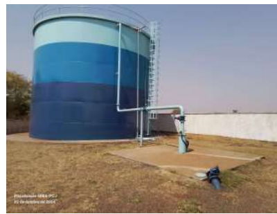
Foto 2 - Vista geral do poço.
