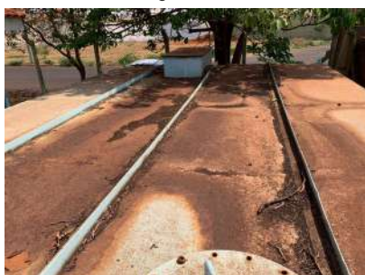
Foto 5 - Vista superior do reservatório.
