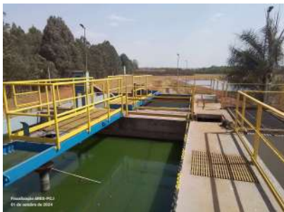
Foto 6 - Vista do desarenador 2.
