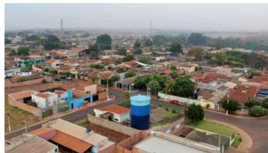
Foto 2 - Vista aérea do cercamento.
