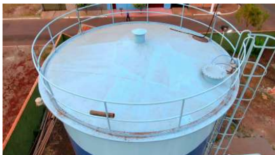
Foto 1 - Tubulação de ventilação.
