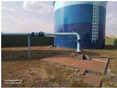
Foto 2 - Vista geral do poço.
