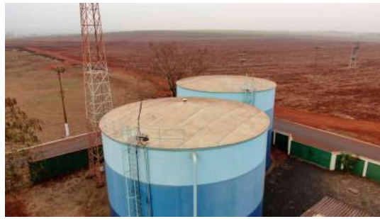
Foto 9 - Vista dos reservatórios.
