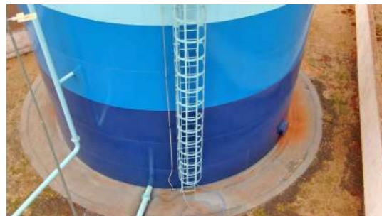
Foto 2 - Tubo para medição de nível.
