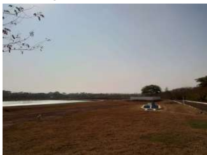
Foto 3 - Vista geral da ETE.
