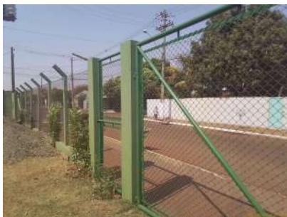
Foto 1 - Cercamento com alambrado e muro de alvenaria no local onde se situa a captação subterrânea.
