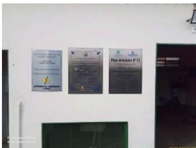
Foto 1 - Placas de identificação do local afixadas na edificação da EEA.
