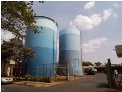
Foto 4 - Vista geral do local onde se situam os reservatórios.
