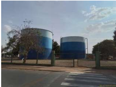
Foto 1 - Vista geral do local onde se situam os reservatórios.
