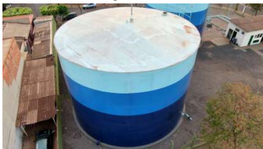
Foto 5 - Vista geral dos reservatórios.
