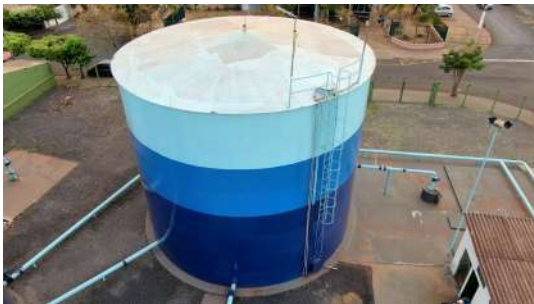
Foto 3 - Vista geral do poço de captação.
