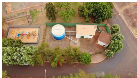
Foto 2 - Vista aérea do cercamento.
