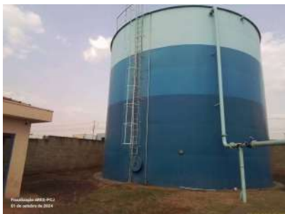
Foto 1 - Tubo para medição de nível.
