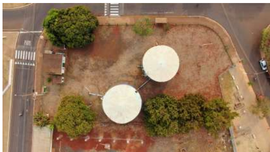
Foto 13 - Vista geral dos reservatórios.
