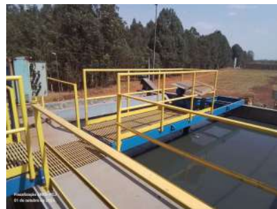
Foto 5 - Vista do desarenador 1.
