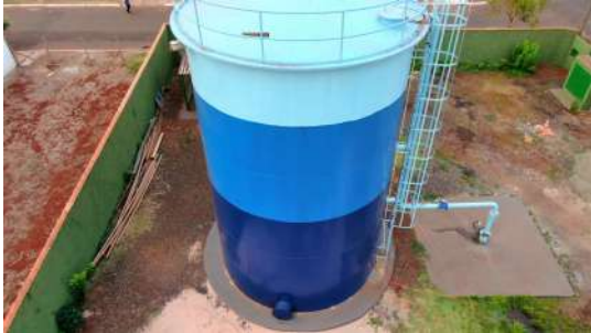
Foto 5 - Vista aérea do poço.
