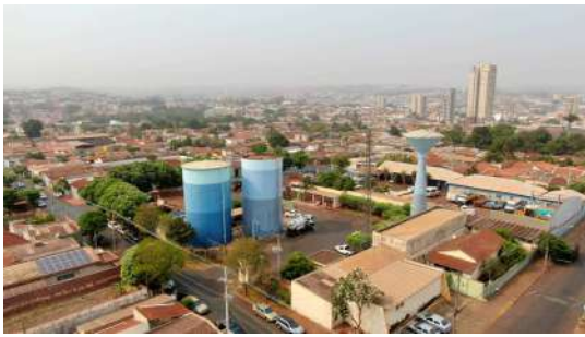
Foto 15 - Vista geral dos reservatórios.
