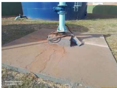
Foto 1 - Laje de proteção do poço.
