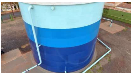
Foto 9 - Vista geral dos reservatórios.
