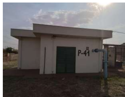
Foto 2 - Vista geral da edificação da EEA.
