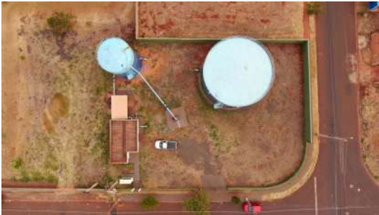
Foto 2 - Vista superior dos reservatórios.
