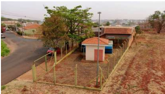
Foto 3 - Vista aérea do cercamento.
