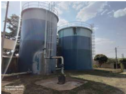
Foto 1 - Vista geral dos reservatórios.
