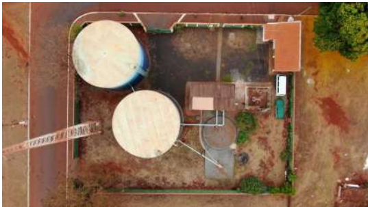
Foto 12 - Vista dos reservatórios.
