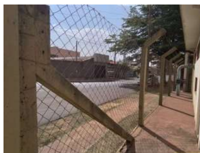
Foto 2 - Local cercado com alambrado.
