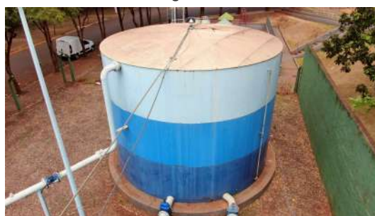
Foto 6 - Vista geral do reservatório.
