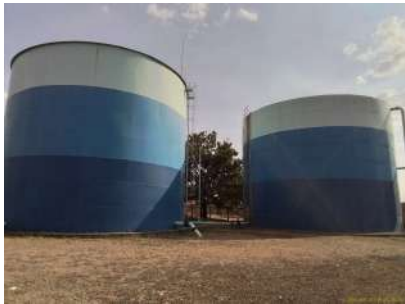
Foto 3 - Vista geral dos reservatórios.
