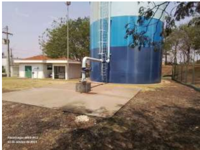
Foto 2 - Vista geral do poço.
