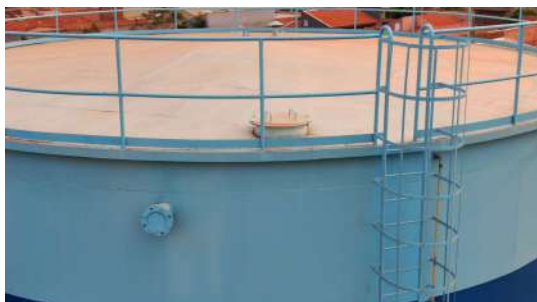
Foto 2 - Tampa de inspeção.
