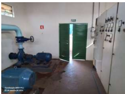
Foto 1 - Porta de acesso à EEA.
