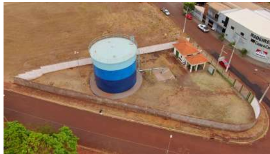
Foto 2 - Vista aérea do cercamento.
