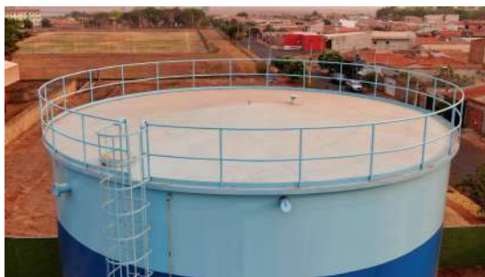
Foto 6 - Tubulações de ventilação.
