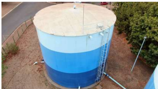
Foto 9 - Vista geral dos reservatórios.
