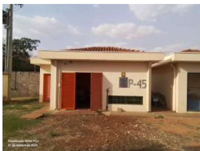
Foto 1 - Vista geral da edificação da EEA.
