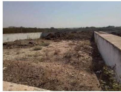
Foto 4 - Vista do interior do tanque de lodo 01.
