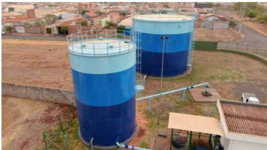
Foto 3 - Vista geral dos reservatórios.
