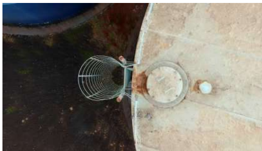
Foto 2 - Tampa de inspeção.
