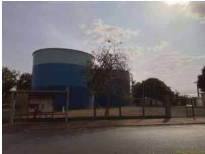
Foto 2 - Vista geral do local onde se situam os reservatórios.
