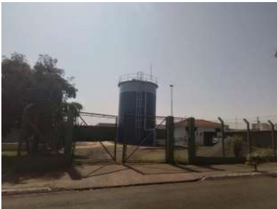
Foto 1 - Vista geral onde localiza-se a captação subterrânea de água.
