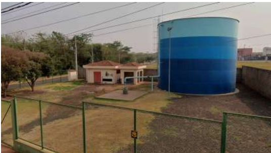
Foto 4 - Vista geral do poço.
