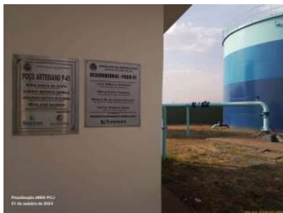
Foto 1 - Placas de identificação do local.
