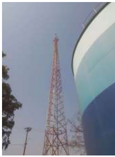
Foto 1 - Presença de para-raios em torre próxima ao reservatório.
