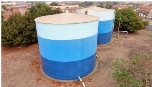
Foto 12 - Vista geral dos reservatórios.
