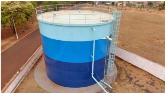
Foto 4 - Vista geral do reservatório.
