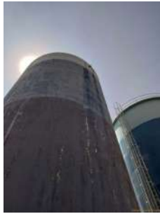
Foto 1 - Tubo extravasor do reservatório de concreto.
