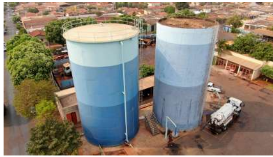
Foto 16 - Vista geral dos reservatórios.
