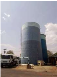
Foto 3 - Vista geral dos reservatórios.
