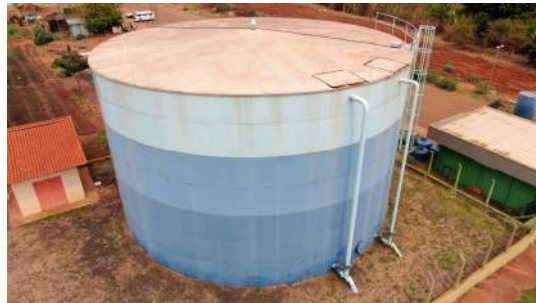
Foto 8 - Vista geral do reservatório.
