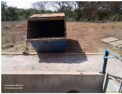
Foto 1 - Caçamba para disposição dos rejeitos da grade.
