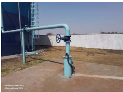
Foto 1 - Local cercado com muro de alvenaria (lateral e fundo) e alambrado (frente).
