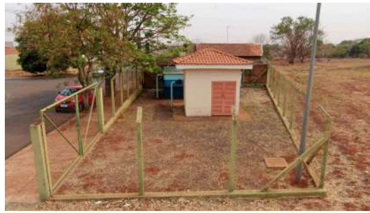
Foto 2 - Vista aérea do cercamento.
