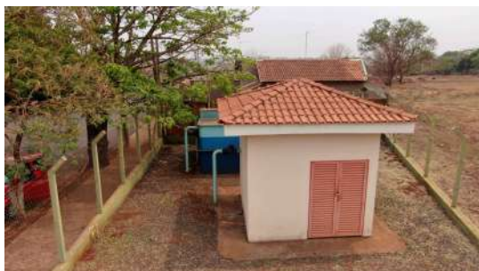
Foto 7 - Vista geral da EEA.
