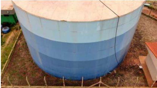
Foto 5 - Vista geral do reservatório.
