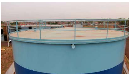
Foto 2 - Tubo extravasor do reservatório.
