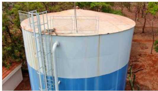
Foto 2 - Guarda-corpos do reservatório.
