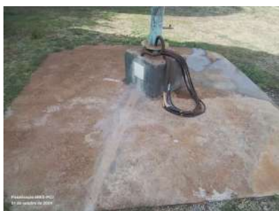
Foto 1 - Laje de proteção do poço.
