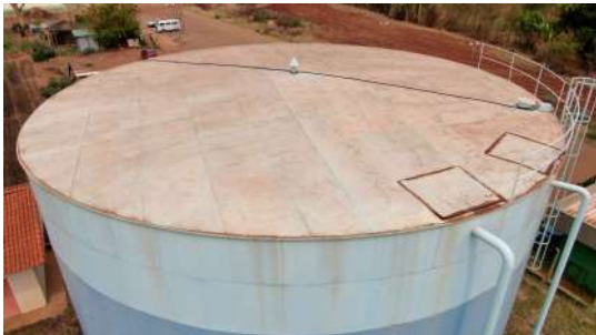
Foto 9 - Vista geral do reservatório.
