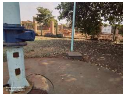
Foto 2 - Local cercado com alambrado.
