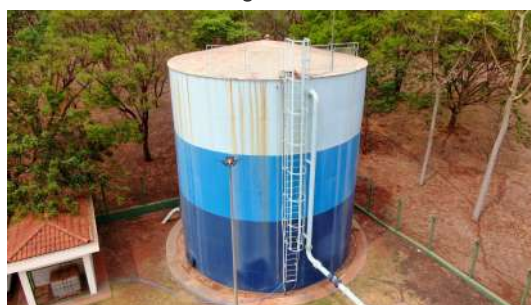
Foto 6 - Vista geral do reservatório.
