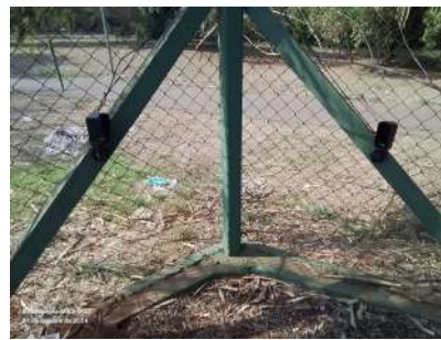
Foto 2 - Local com sensores de presença.
