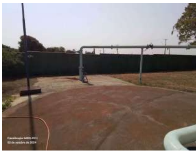
Foto 1 - Local cercado com muro de alvenaria.
