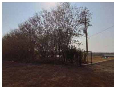
Foto 2 - Vista da entrada da ETE.
