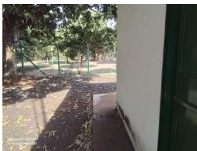
Foto 1 - EEA situa-se em edificação de alvenaria em local cercado por alambrado.
