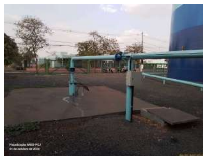
Foto 2 - Vista geral do poço.
