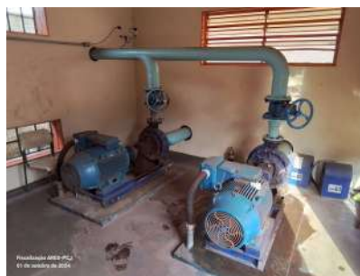
Foto 2 - Vista do interior da edificação da EEA.
