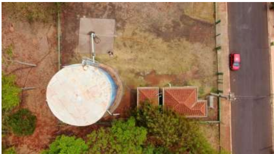
Foto 3 - Vista aérea do poço.
