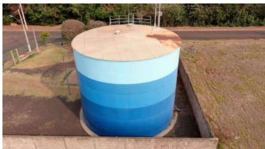
Foto 3 - Guarda-corpos no topo do reservatório.
