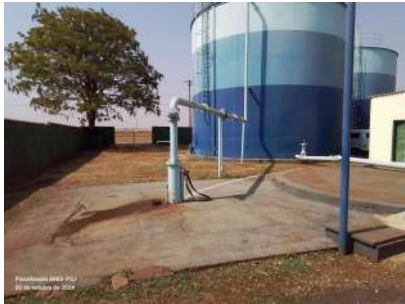
Foto 2 - Vista geral do poço.
