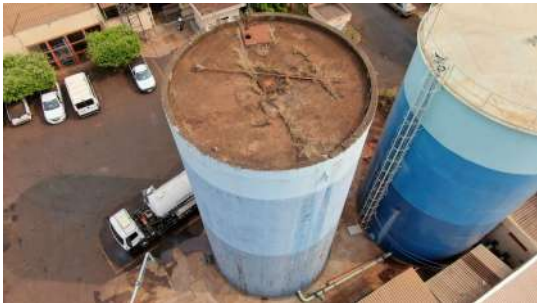
Foto 9 - Vista geral dos reservatórios.
