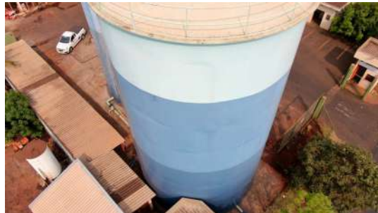
Foto 12 - Vista geral dos reservatórios.
