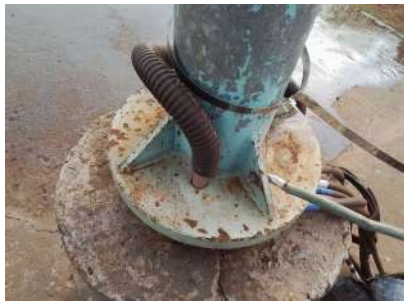
Foto 1 - Medidor de nível por sonda.
