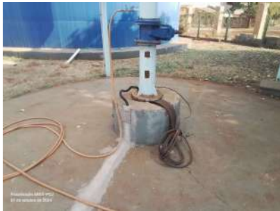
Foto 1 - Laje de proteção do poço.
