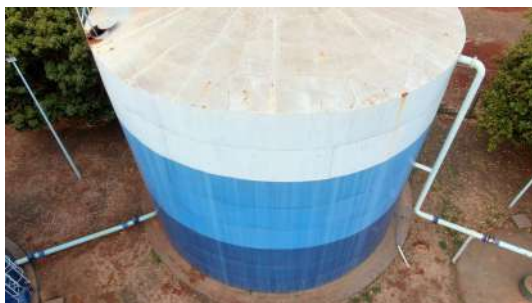
Foto 8 - Vista geral dos reservatórios.
