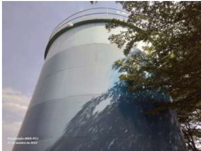
Foto 7 - Vista geral do reservatório.
