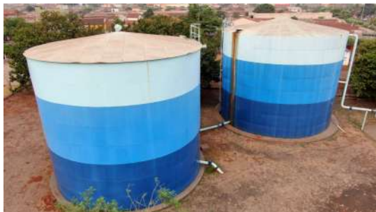
Foto 11 - Vista geral dos reservatórios.
