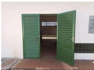
Foto 1 - Porta de acesso à EEA.
