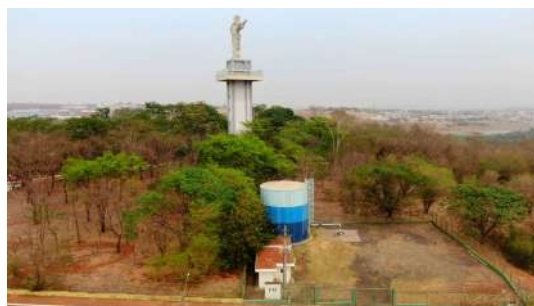
Foto 2 - Existência de para-raio em estrutura próxima ao reservatório.
