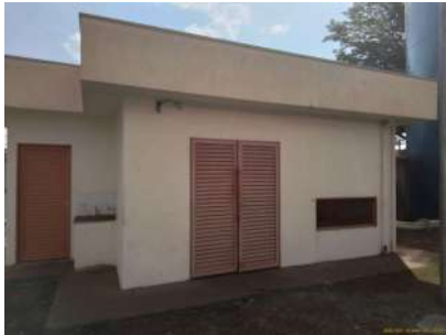
Foto 1 - Vista geral da edificação da EEA.
