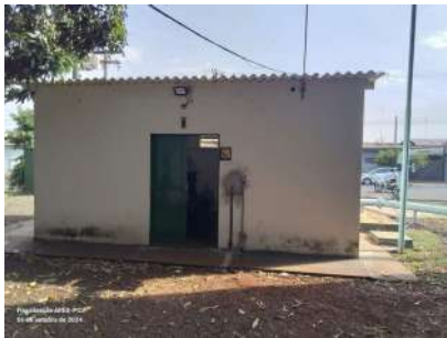
Foto 1 - Vista geral da edificação da EEA.
