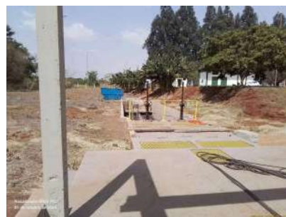
Foto 9 - Vista geral da EEE.
