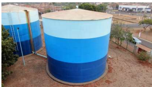
Foto 6 - Vista geral dos reservatórios.
