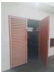
Foto 1 - Porta de acesso à EEA.
