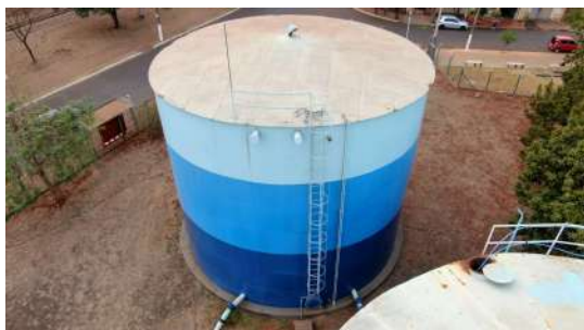
Foto 1 - Tubulação de ventilação no topo do reservatório.
