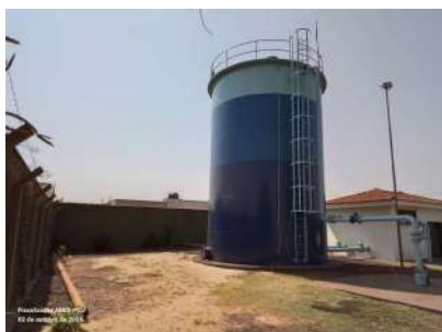
Foto 1 - Tubo para medição de nível.
