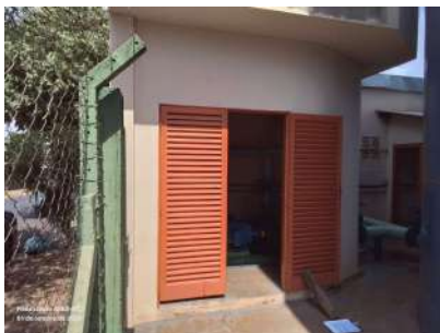
Foto 1 - Porta de acesso à EEA.
