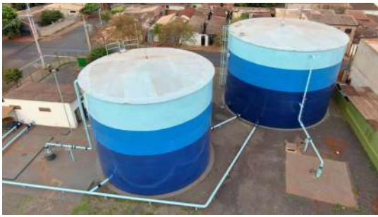
Foto 11 - Vista geral dos reservatórios.
