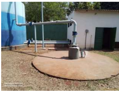
Foto 1 - Vista geral da captação subterrânea.
