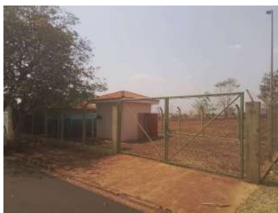
Foto 1 - Vista geral do local que abriga a EEA.
