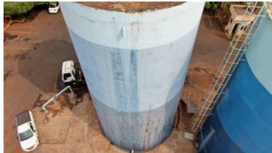
Foto 10 - Vista geral dos reservatórios.
