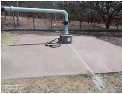
Foto 1 - Laje de proteção do poço.
