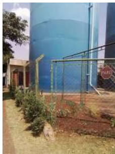
Foto 1 - Local cercado com alambrado.
