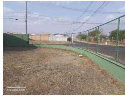
Foto 2 - Cercamento com alambrado.
