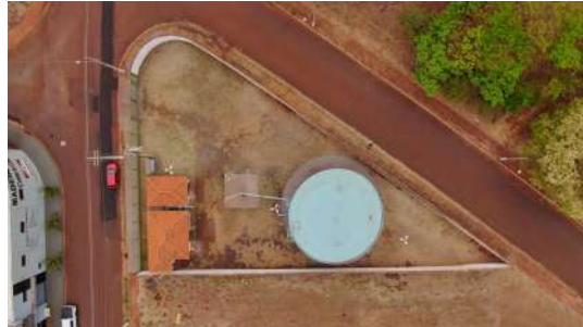
Foto 10 - Vista geral do reservatório.
