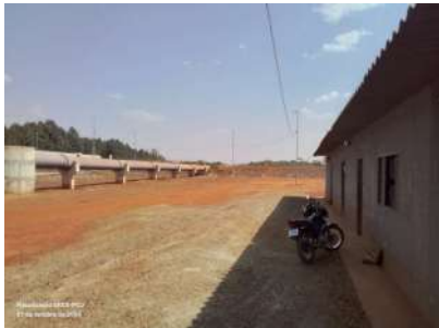
Foto 3 - Vista da tubulação que liga os UASBs à lagoa anaeróbia.
