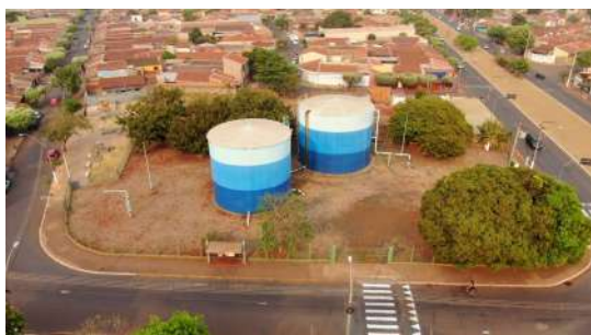
Foto 3 - Vista aérea do cercamento.
