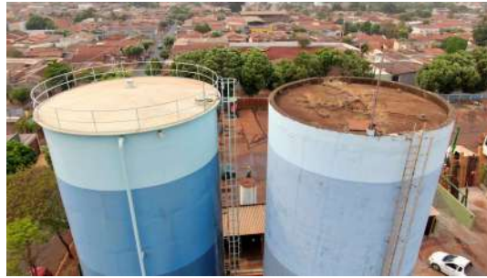
Foto 2 - Tubo extravasor do reservatório metálico.
