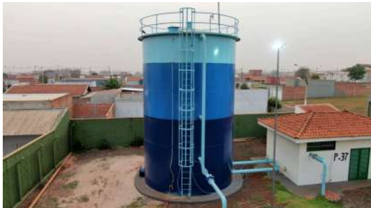
Foto 2 - Vista geral do reservatório.
