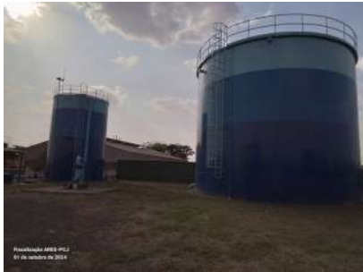
Foto 1 - Vista geral dos reservatórios.
