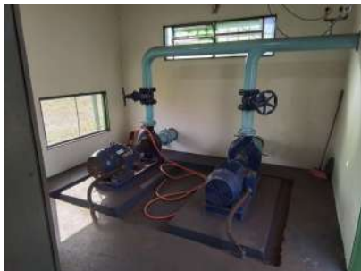
Foto 3 - Vista do interior da edificação da EEA.
