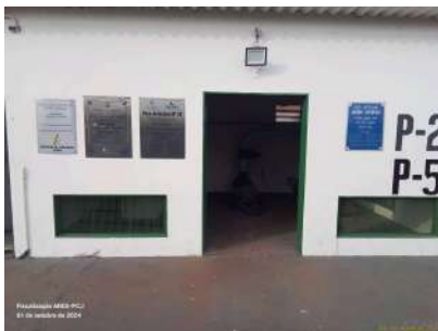
Foto 1 - Porta de acesso à EEA.
