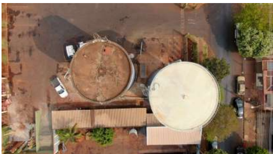
Foto 13 - Vista geral dos reservatórios.
