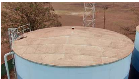
Foto 4 - Tubulação de ventilação no topo.
