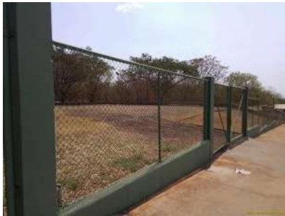
Foto 1 - Cercamento com alambrado no local onde se situa o reservatório.
