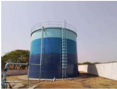
Foto 1 - Presença de guarda-corpos na escada e no topo do reservatório.
