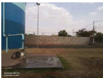
Foto 1 - Cercamento do local com muro de alvenaria e alambrado.
