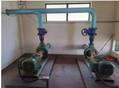
Foto 4 - Vista do interior da edificação da EEA.
