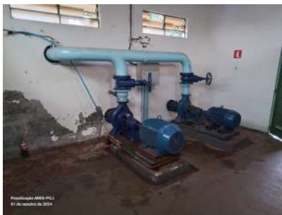
Foto 3 - Vista do interior da edificação da EEA.
