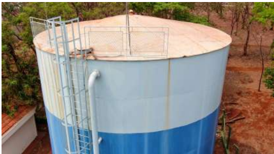
Foto 1 - Tubulação de ventilação.
