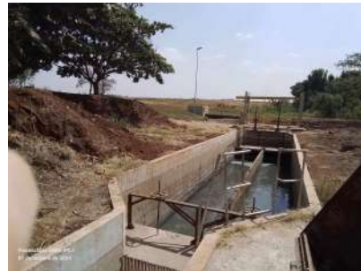
Foto 3 - Sistema desarenador.
