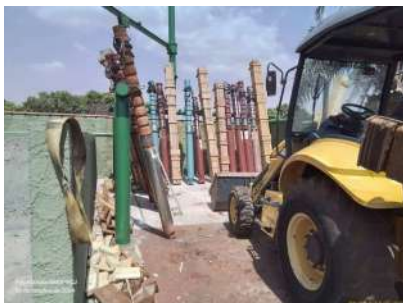
Foto 1 - No setor operacional encontram-se armazenadas 24 bombas reservas para a captação de água subterrânea.
