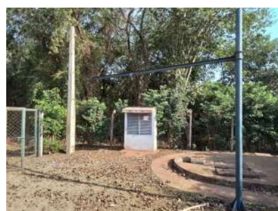
Foto 2 - Estrutura para içamento da bomba.
