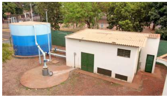
Foto 2 - Vista geral da captação subterrânea.
