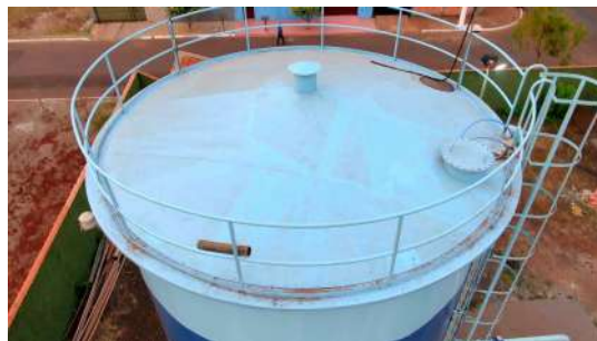
Foto 8 - Vista geral do reservatório.
