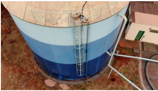
Foto 8 - Vista dos reservatórios.
