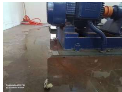
Foto 2 - Detalhe do ralo entupido.
