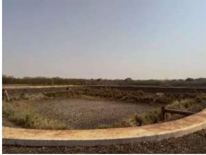
Foto 10 - Vista geral da lagoa anaeróbia 02 desativada com a tubulação de saída de esgoto.
