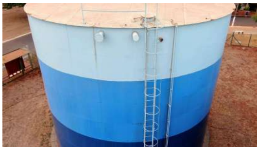
Foto 2 - Tampa de inspeção fechada.
