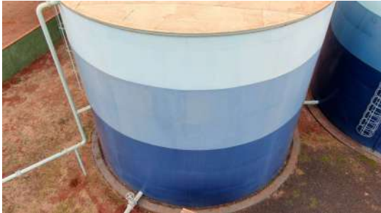
Foto 10 - Vista dos reservatórios.
