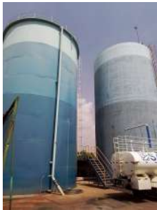
Foto 2 - Vista geral dos reservatórios.
