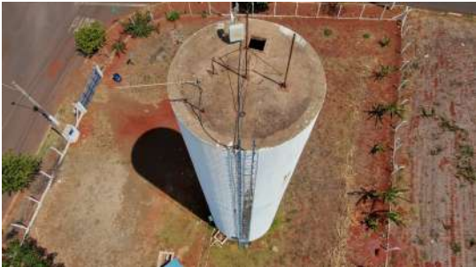
Foto 5 - Vista por drone do Reservatório elevado do Jardim Módolo em Cordeirópolis
