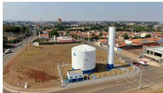
Foto 8 - Vista por drone do Reservatório Elevado Jardim Paraty em Cordeirópolis
