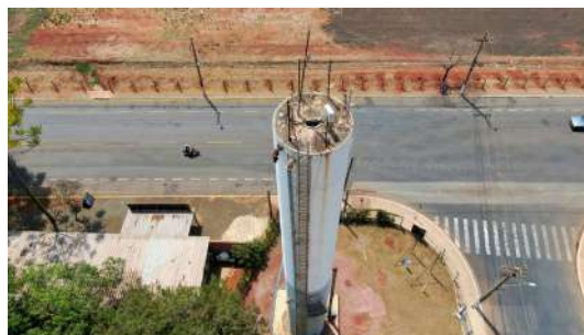
Foto 4 - Vista por drone do Reservatório elevado Jardim Cordeiro em Cordeirópolis
