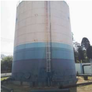
Foto 1 - Guarda-corpo do Reservatório Apoiado Centro de distribuição de água em Cordeirópolis
