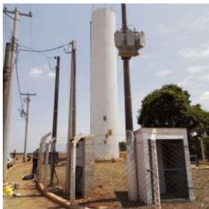
Foto 3 - Entrada do Reservatório Elevado Jardim Eldorado em Cordeirópolis
