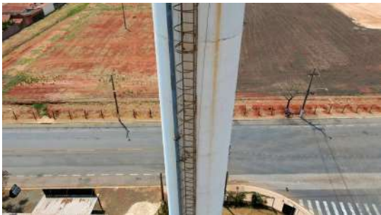
Foto 3 - Guarda-corpo do Reservatório elevado Jardim Cordeiro em Cordeirópolis
