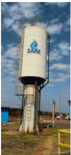
Foto 1 - Vista do Reservatório elevado da ETA em Cordeirópolis
