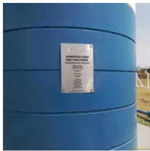
Foto 3 - Placa de identificação do Reservatório Elevado Jardim Paraty em Cordeirópolis
