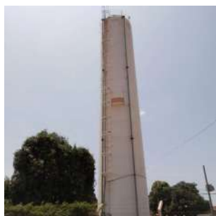
Foto 1 - Guarda-corpo do Reservatório Elevado Jardim Eldorado em Cordeirópolis
