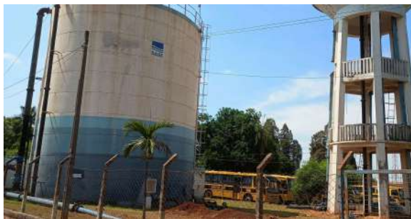
Foto 1 - Vista do Centro de distribuição de água em Cordeirópolis
