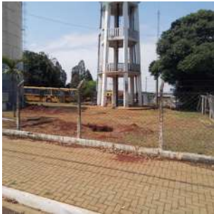
Foto 2 - Vista da entrada do Reservatório Elevado Centro de distribuição em Cordeirópolis
