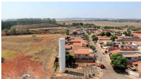
Foto 5 - Vista por drone do Reservatório Elevado Jardim Eldorado em Cordeirópolis
