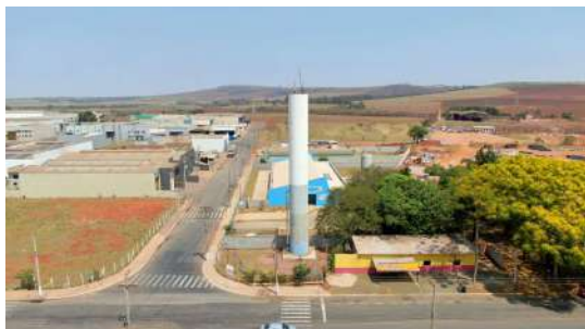
Foto 5 - Vista por drone do Reservatório elevado Jardim Cordeiro em Cordeirópolis
