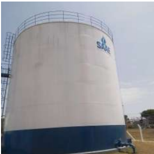
Foto 1 - Vista do Reservatório Apoiado Jardim Paraty em Cordeirópolis
