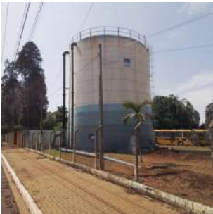
Foto 3 - Em primeiro plano, a vista do cercamento do Reservatório Elevado Centro de distribuição em Cordeirópolis
