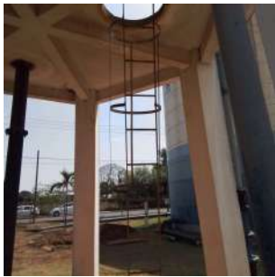
Foto 1 - Escada de entrada ao Reservatório Elevado Centro de distribuição em Cordeirópolis
