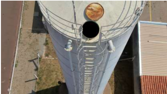
Foto 1 - Tampa de inspeção aberta do Reservatório elevado Jardim Lise em Cordeirópolis
