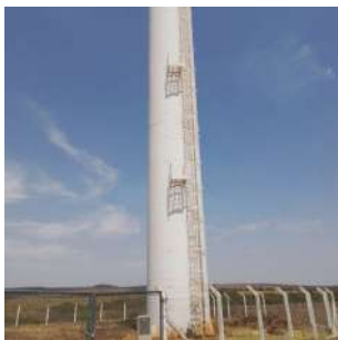
Foto 1 - Vista do Reservatório elevado Jardim São Luiz em Cordeirópolis
