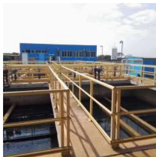
Foto 1 - Guarda-corpos da ETA de Cordeirópolis
