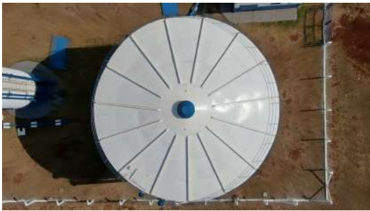
Foto 1 - Tampa de inspeção do Reservatório Apoiado Jardim Paraty em Cordeirópolis
