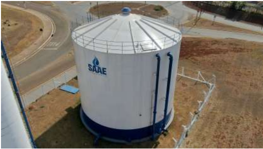
Foto 5 - Vista por drone do Reservatório Apoiado Jardim Paraty em Cordeirópolis
