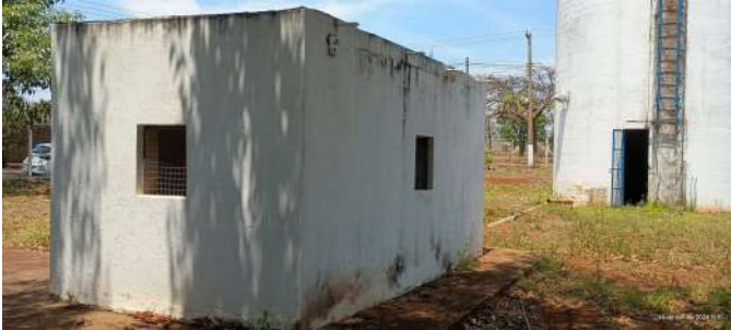
Foto 5 - Vista externa da Elevatória de água tratada do Jardim Módulo em Cordeirópolis
