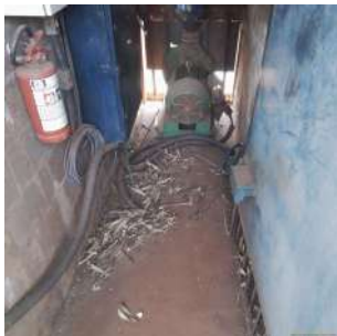
Foto 1 - Ausência de limpeza na Captação Santa Marina em Cordeirópolis
