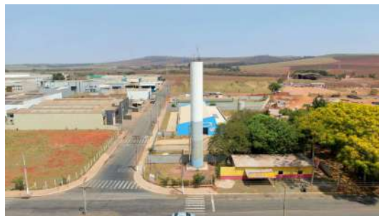
Foto 6 - Vista por drone do Reservatório elevado Jardim Cordeiro em Cordeirópolis
