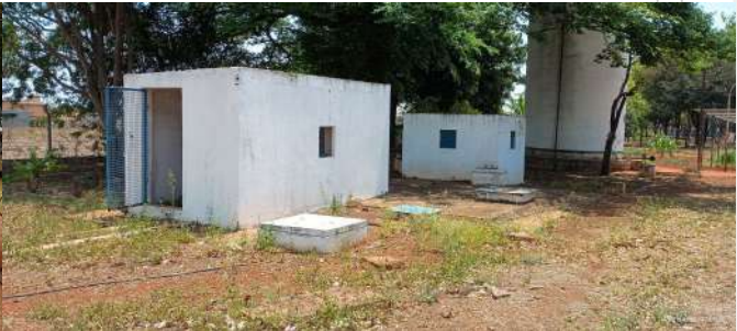
Foto 2 - Vista externa da Elevatória de água tratada do Jardim MÓDOLO em Cordeirópolis
