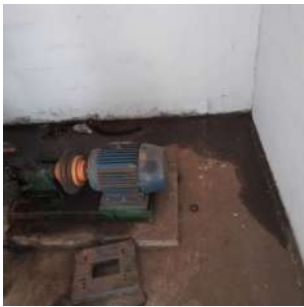
Foto 2 - Drenagem inadequada da água de lubrificação de gaxeta das bombas da Elevatória de água tratada do Jardim Paraty Apoiado em Cordeirópolis
