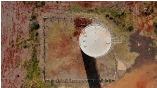
Foto 1 - Tampa de inspeção do Reservatório elevado Jardim São Luiz em Cordeirópolis
