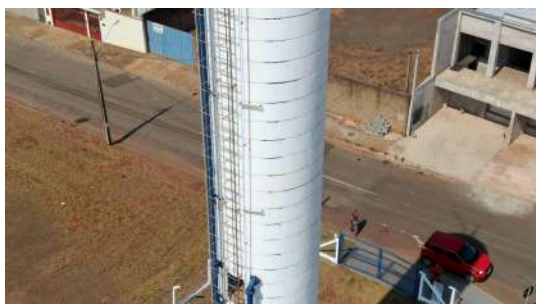
Foto 1 - Guarda-corpo do Reservatório Elevado Jardim Paraty em Cordeirópolis
