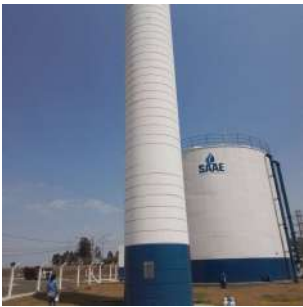
Foto 1 - Vista do Reservatório Elevado Jardim Paraty em Cordeirópolis
