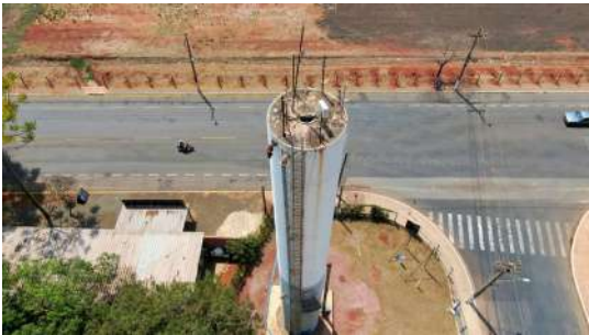
Foto 2 - Guarda-corpo do Reservatório elevado Jardim Cordeiro em Cordeirópolis
