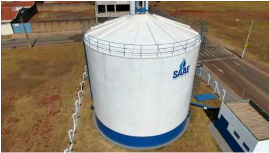
Foto 6 - Vista por drone do Reservatório Apoiado Jardim Paraty em Cordeirópolis
