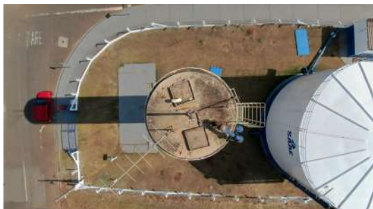
Foto 1 - Tampa de inspeção do Reservatório Elevado Jardim Paraty em Cordeirópolis
