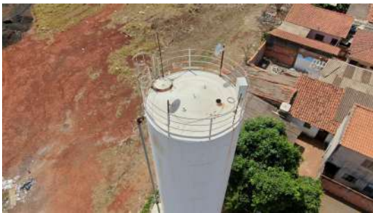
Foto 1 - Tampa de inspeção do Reservatório Elevado Jardim Eldorado em Cordeirópolis
