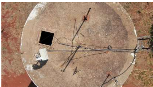
Foto 1 - Tampa de inspeção aberta do Reservatório elevado do Jardim Módolo em Cordeirópolis
