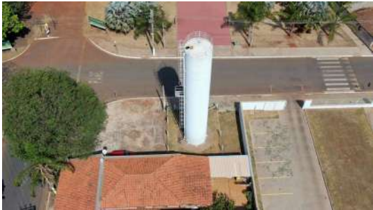
Foto 7 - Vista por drone do Reservatório elevado Jardim Lise em Cordeirópolis
