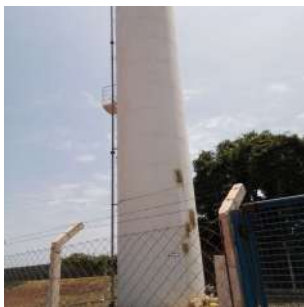
Foto 1 - Vista do Reservatório Elevado Jardim Eldorado em Cordeirópolis
