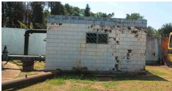
Foto 3 - Vista externa da Elevatória de água tratada do Centro de distribuição de água em Cordeirópolis
