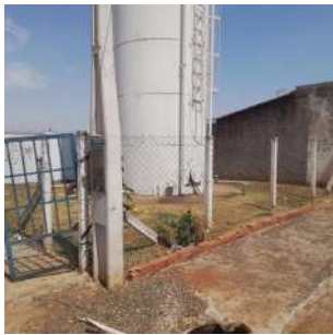
Foto 5 - Entrada do Reservatório elevado Jardim Lise em Cordeirópolis
