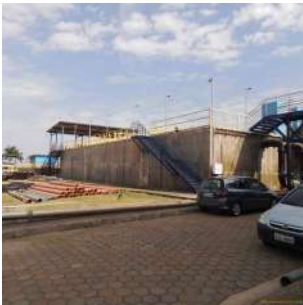
Foto 1 - Vista geral da ETA de Cordeirópolis
