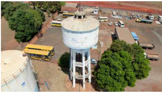
Foto 5 - Vista por drone do Reservatório Elevado Centro de distribuição em Cordeirópolis
