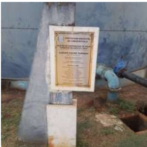
Foto 1 - Placa de identificação do Reservatório Elevado Centro de distribuição em Cordeirópolis
