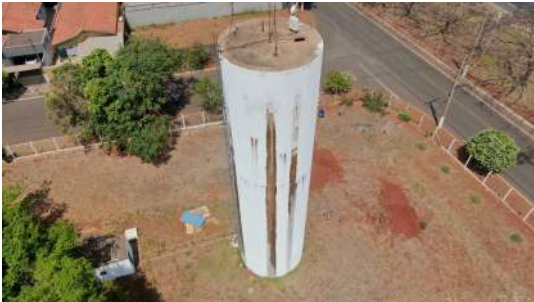
Foto 6 - Vista por drone do Reservatório elevado do Jardim Módolo em Cordeirópolis
