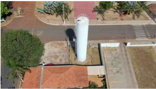
Foto 6 - Vista por drone do Reservatório elevado Jardim Lise em Cordeirópolis
