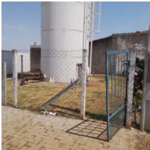
Foto 2 - Entrada do Reservatório elevado Jardim Lise em Cordeirópolis
