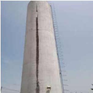
Foto 3 - Vista do Reservatório elevado do Jardim Módolo em Cordeirópolis
