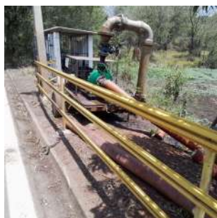
Foto 1 - Guarda-corpo da Captação Barro Preto em Cordeirópolis
