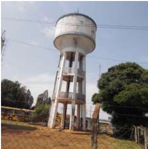
Foto 1 - Vista Geral do Reservatório Elevado Centro de distribuição em Cordeirópolis
