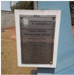
Foto 1 - Placa de identificação do Reservatório elevado Jardim Cordeiro em Cordeirópolis
