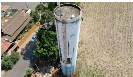
Foto 2 - Guarda-corpo do Reservatório elevado Jardim Juventude em Cordeirópolis
