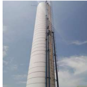
Foto 6 - Guarda-corpo do Reservatório Elevado Jardim Paraty em Cordeirópolis
