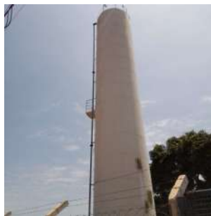
Foto 2 - Vista do Reservatório Elevado Jardim Eldorado em Cordeirópolis
