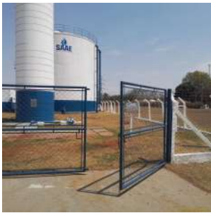
Foto 2 - Entrada do Reservatório Elevado Jardim Paraty em Cordeirópolis
