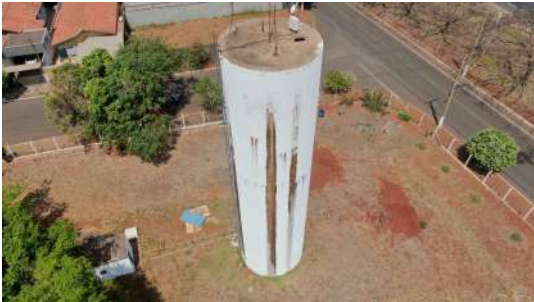
Foto 4 - Vista por drone do Reservatório elevado do Jardim Módolo em Cordeirópolis
