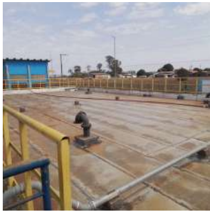
Foto 1 - Vista Geral do reservatório semi-enterrado da ETA em Cordeirópolis
