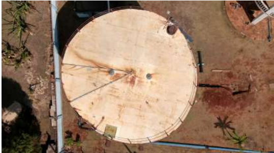
Foto 1 - Tampa de inspeção aberta no Reservatório Apoiado Centro de distribuição de água em Cordeirópolis
