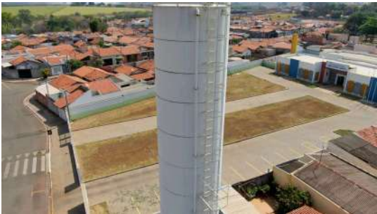
Foto 2 - Guarda-corpo do Reservatório elevado Jardim Lise em Cordeirópolis
