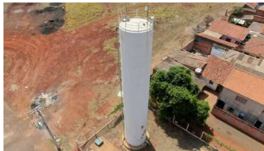
Foto 4 - Vista por drone do Reservatório Elevado Jardim Eldorado em Cordeirópolis
