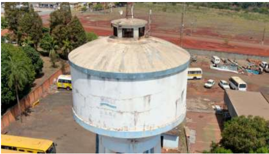
Foto 6 - Telas de proteção do Reservatório Elevado Centro de distribuição em Cordeirópolis
