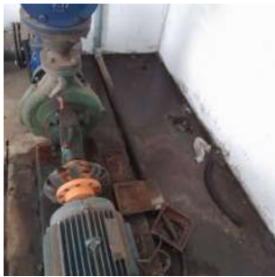
Foto 1 - Drenagem inadequada da água de lubrificação de gaxeta das bombas da Elevatória de água tratada do Jardim Paraty Apoiado em Cordeirópolis
