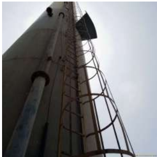
Foto 1 - Guarda-corpo do Reservatório elevado Jardim Cordeiro em Cordeirópolis
