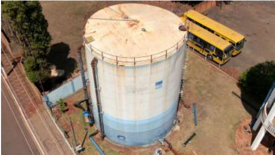
Foto 7 - Vista das tubulações de entrada, saída e extravasamento do Reservatório Apoiado Centro de distribuição de água em Cordeirópolis
