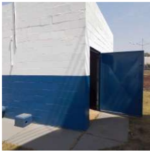
Foto 1 - Vista externa da Elevatória de água tratada do Jardim Paraty Apoiado em Cordeirópolis
