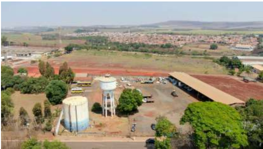
Foto 4 - Vista por drone do Reservatório Elevado Centro de distribuição em Cordeirópolis
