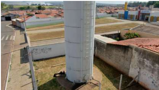
Foto 1 - Guarda-corpo do Reservatório elevado Jardim Lise em Cordeirópolis
