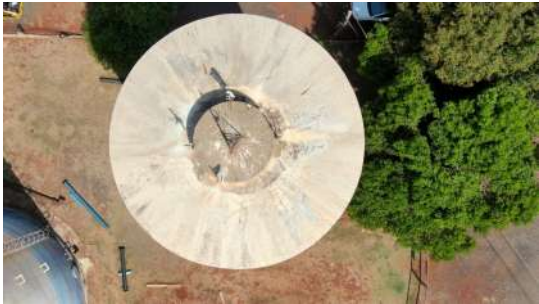
Foto 7 - Para-raios do Reservatório Elevado Centro de distribuição em Cordeirópolis
