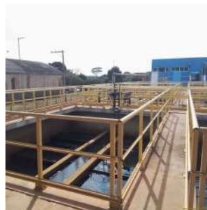
Foto 2 - Guarda-corpos da ETA de Cordeirópolis
