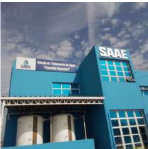
Foto 4 - Entrada da ETA de Cordeirópolis
