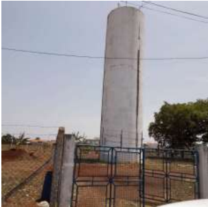
Foto 1 - Entrada do Reservatório elevado do Jardim Módolo em Cordeirópolis
