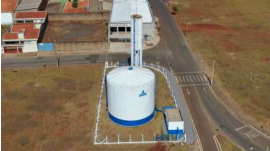
Foto 7 - Vista por drone do Reservatório Apoiado Jardim Paraty em Cordeirópolis
