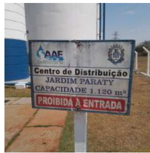
Foto 4 - Placa de identificação do Reservatório Elevado Jardim Paraty em Cordeirópolis
