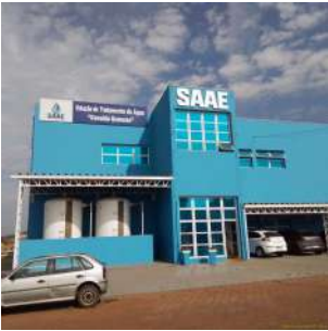
Foto 5 - Entrada da ETA de Cordeirópolis
