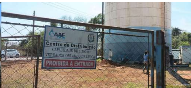
Foto 2 - Placa de distribuição do Centro de distribuição de água em Cordeirópolis
