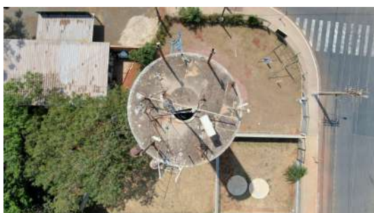
Foto 1 - Tampa de inspeção aberta do Reservatório elevado Jardim Cordeiro em Cordeirópolis
