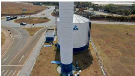
Foto 7 - Vista por drone do Reservatório Elevado Jardim Paraty em Cordeirópolis
