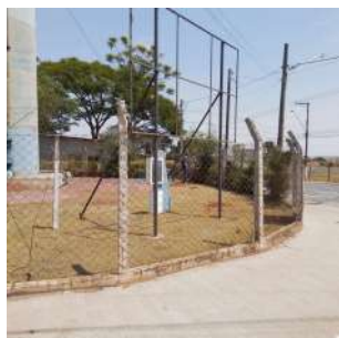
Foto 3 - Cerca do Reservatório elevado Jardim Cordeiro em Cordeirópolis
