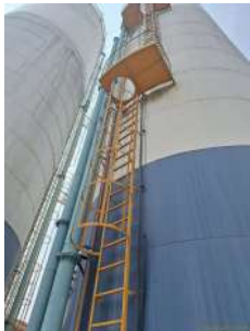
Foto 1 - Escada com guarda-corpos e área de descanso - Reservatórios São Bento do Recreio
