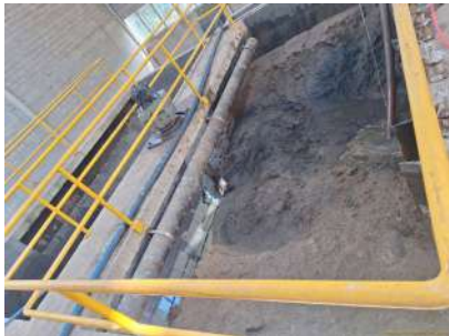
Foto 13 - Desarenador em limpeza
