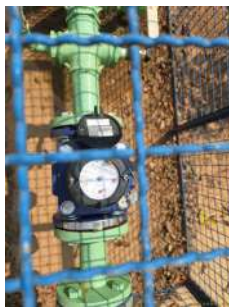
Foto 1 - Macromedidor do Poço São Bento do Recreio 5
