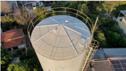
Foto 1 - Reservatório Vale Verde 1 - cobertura
