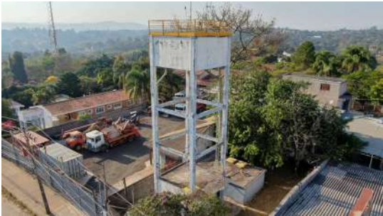
Foto 1 - Reservatório San Fernando - Visão Geral
