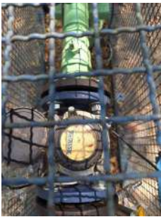
Foto 1 - Macromedidor do Poço P8 - Vale Verde
