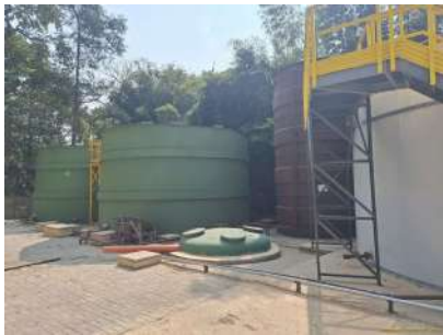
Foto 1 - Visão geral - ETE São Bento do Recreio
