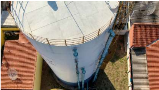
Foto 1 - Reservatório Morada do Sol - entrada e extravasor
