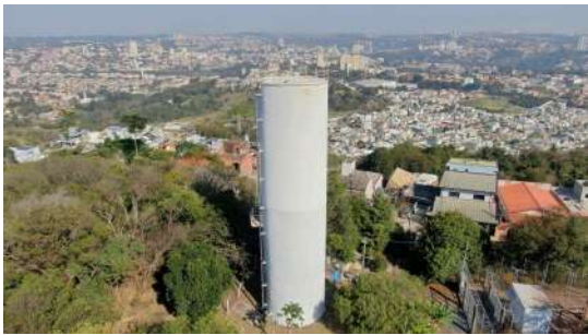
Foto 1 - Reservatório Colina dos Pinheiros - Visão geral
