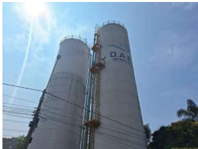
Foto 1 - Visão geral - Reservatórios - São Bento do Recreio
