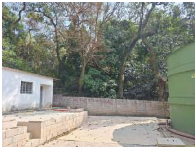
Foto 1 - Área cercada por muro de alvenaria e cerca
