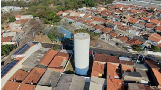
Foto 1 - Reservatório Morada do Sol - visão geral
