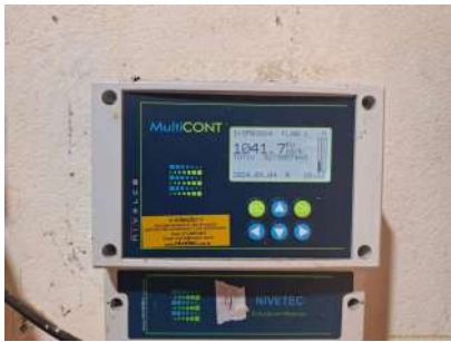
Foto 1 - Macro medidor na saída do tratamento
