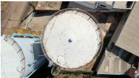
Foto 1 - Reservatório São Bento do Recreio - unidade mais antiga - cobertura e tampa regular
