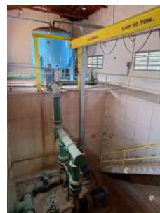
Foto 8 - Câmara de saturação de ar dissolvido
