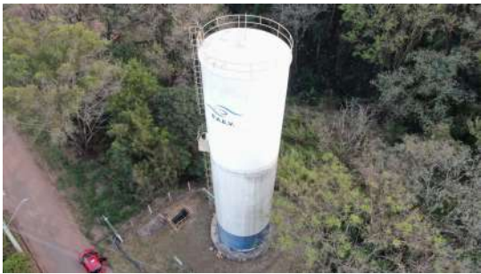
Foto 1 - Reservatório Vale Verde 2 - Visão Geral
