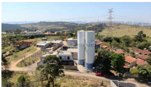
Foto 4 - Fotografia aérea - Reservatório São Bento do Recreio
