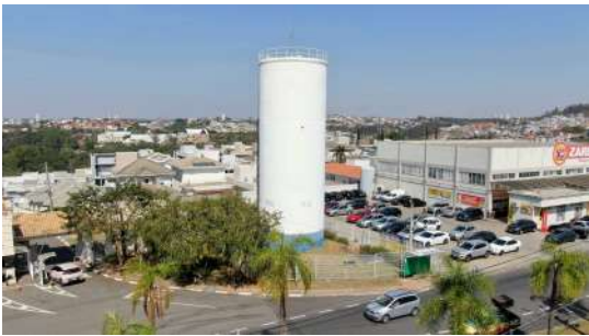
Foto 1 - Reservatório Le Village - Visão Geral
