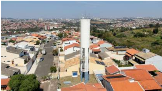
Foto 1 - Reservatório Nova Espírito Santo - Visão geral
