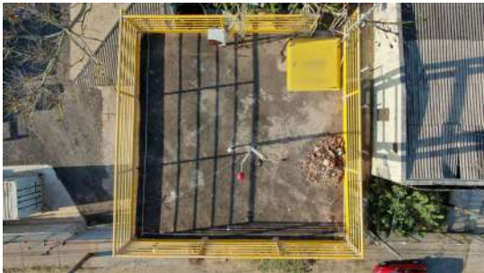
Foto 1 - Reservatório San Fernando - tampa de inspeção
