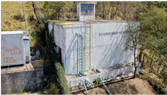
Foto 1 - Visão geral - Reservatório Parque Portugal 2
