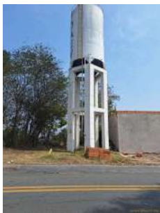
Foto 1 - Área sem cercamento, junto à rodovia
