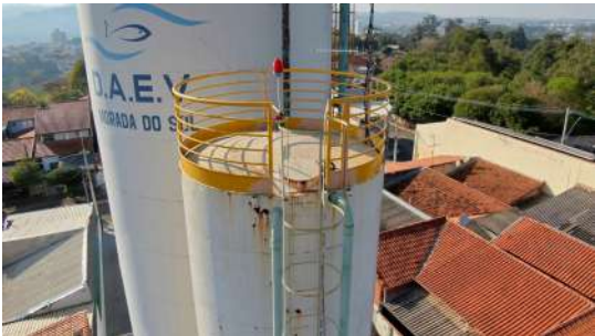
Foto 1 - Reservatório Morada do Sol - tampa de inspeção
