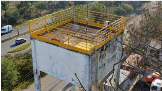
Foto 1 - Reservatório San Fernando - extravasor
