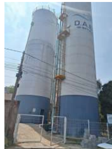
Foto 2 - Visão geral - Reservatórios - São Bento do Recreio
