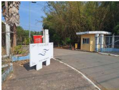
Foto 1 - Entrada da ETE com identificação
