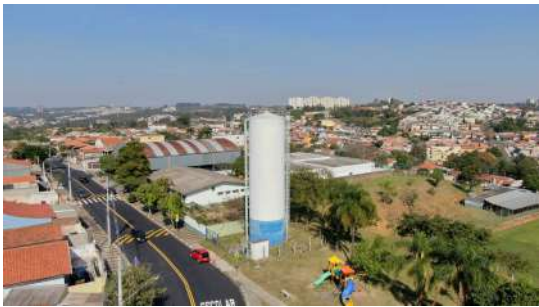
Foto 1 - Reservatório Cerejeiras - visão geral
