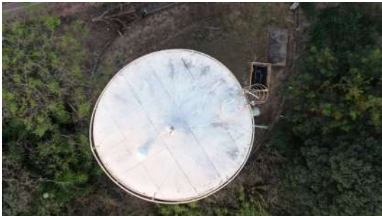
Foto 1 - Reservatório Vale Verde 2 - Cobertura
