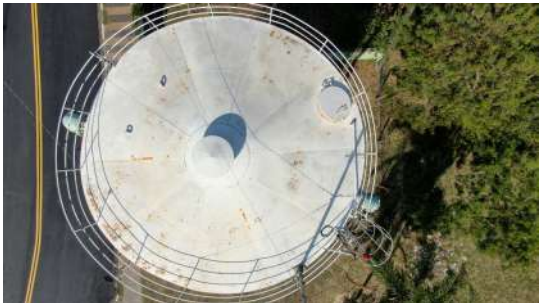
Foto 1 - Reservatório Cerejeiras - cobertura e tampa
