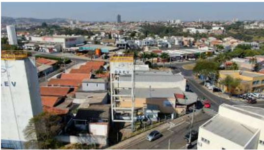
Foto 1 - Reservatório Santa Maria Elevado - visão geral
