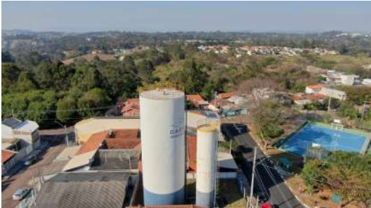
Foto 2 - Reservatório Morada do Sol - visão geral (2)
