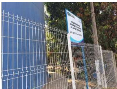
Foto 1 - Cercamento da área - Reservatório São Bento do Recreio
