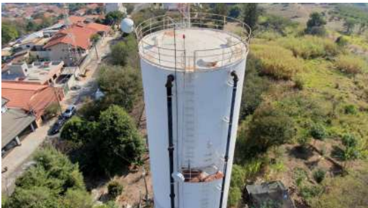
Foto 2 - Reservatório Colina dos Pinheiros - descida do para-raios
