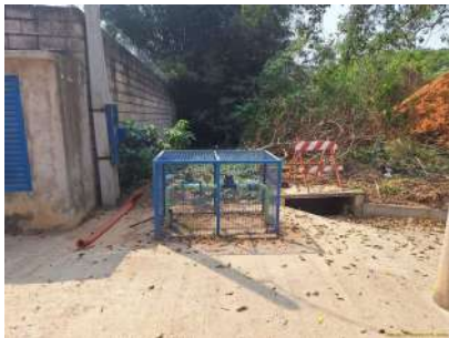
Foto 2 - Poço São Bento do Recreio 5 - Visão geral
