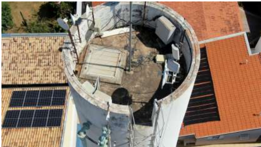
Foto 1 - Tampa de inspeção do Reservatório Nova Espírito Santo
