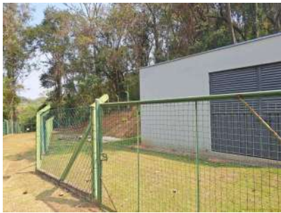
Foto 1 - Área da Estação Elevatória de Esgoto sem identificação
