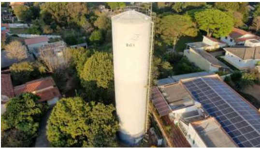
Foto 1 - Reservatório Vale Verde 1 - visão geral
