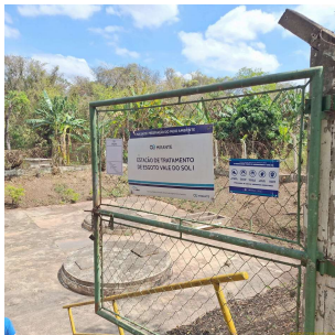
Foto 1 - Identificação da área - ETE Vale do Sol 1
