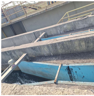
Foto 3 - Entrada de esgoto (Parshall abaixo) e recirculação de lodo (Parshall acima) - com registradores de vazão
