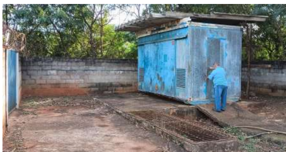
Foto 3 - Vista interna da EEE.
