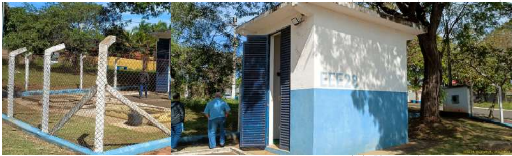
Foto 1 - Vista geral externa da EEE.
