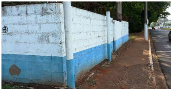
Foto 1 - Vista externa da lateral da EEE.
