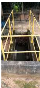
Foto 4 - Chegada do esgoto e gradeamento.
