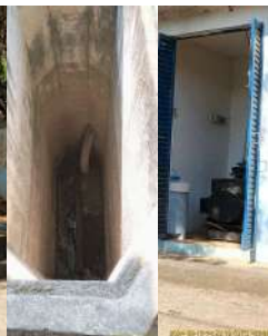
Foto 5 - Poço/canal de chegada do esgoto.
