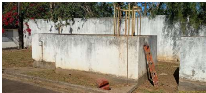
Foto 3 - Vista do muro no entorno do poço de acesso ao gradeamento do esgoto.
