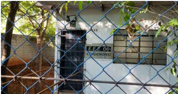
Foto 3 - Vista da entrada da EEE.
