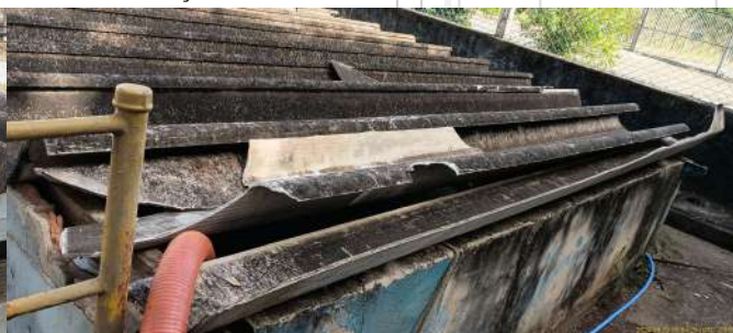
Foto 6 - Telhas quebradas.
