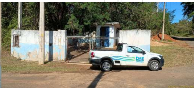
Foto 2 - Vista geral externa da EEE.
