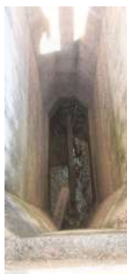
Foto 6 - Poço/canal de chegada do esgoto.
