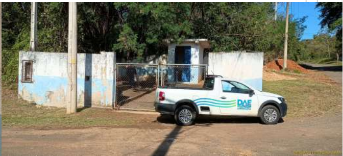
Foto 2 - Vista geral externa da EEE.
