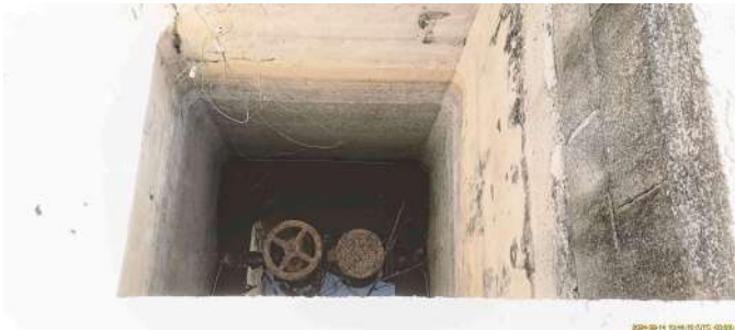
Foto 3 - Vista interna da caixa de registros da tubulação.
