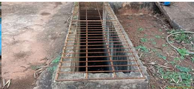
Foto 4 - Canal de chegada do esgoto.
