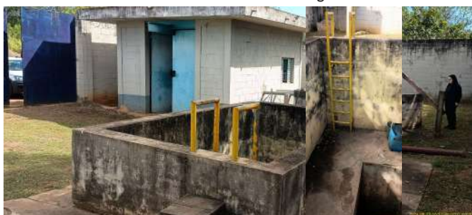
Foto 5 - Acesso ao gradeamento para remoção de materiais retidos.
