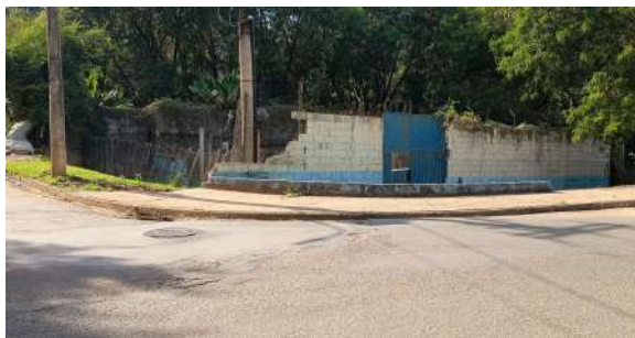
Foto 3 - Vista geral externa da EEE.
