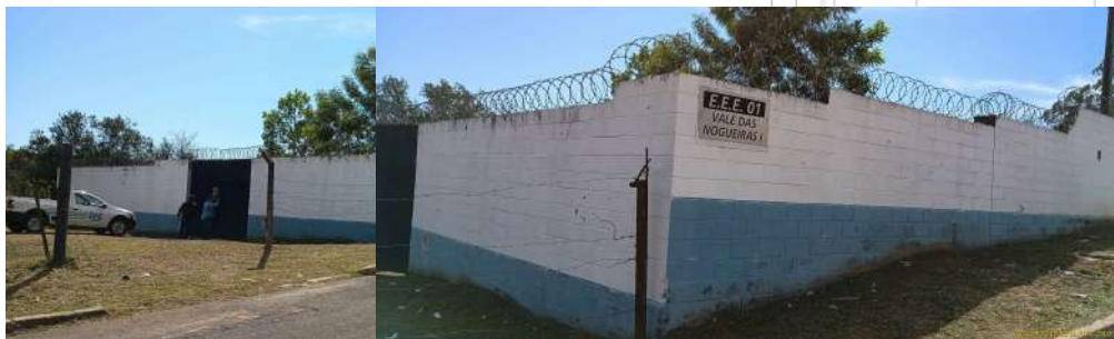
Foto 1 - Vista geral externa da EEE.
