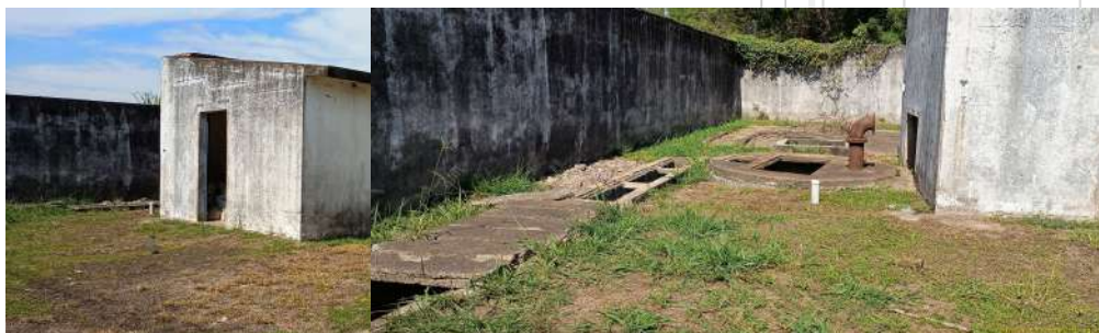
Foto 3 - Vista geral interna da EEE.
