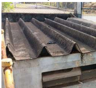
Foto 5 - Telhas quebradas.
