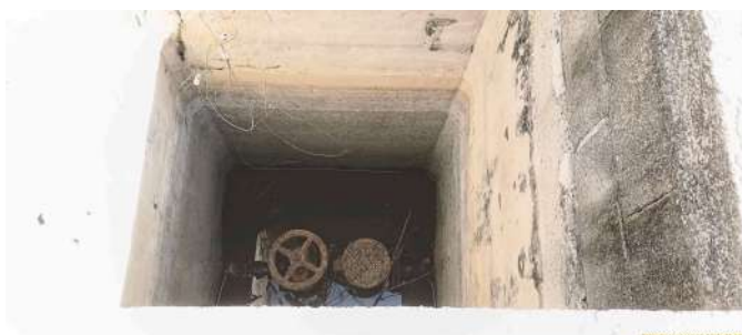
Foto 7 - Vista interna da caixa de registros da tubulação.
