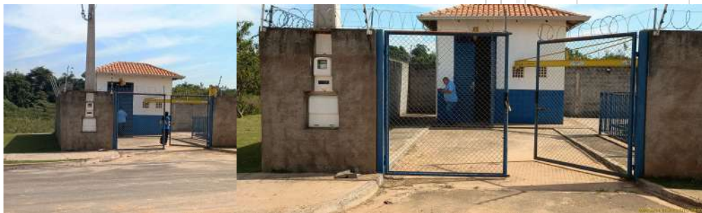
Foto 1 - Vista geral externa da EEE.
