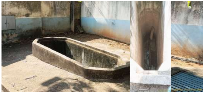
Foto 1 - Vista externa do poço de chegada do esgoto.
