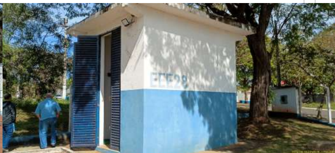
Foto 2 - Abrigo do gerador de energia a diesel.
