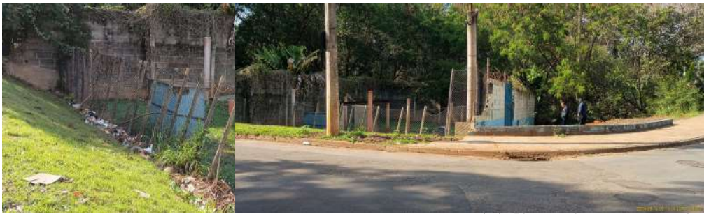
Foto 1 - Situação do alambrado da EEE.
