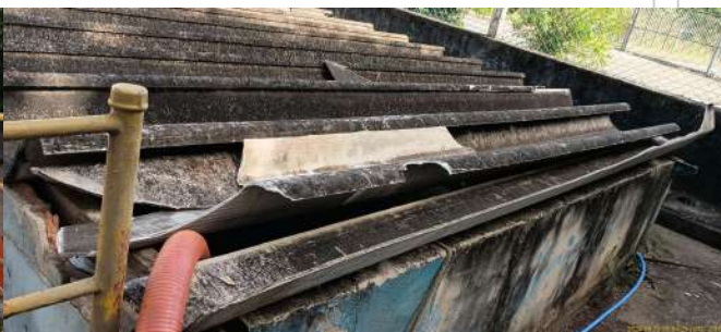
Foto 6 - Telhas quebradas.
