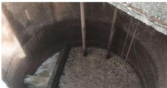
Foto 9 - Vista interna do poço de sucção.
