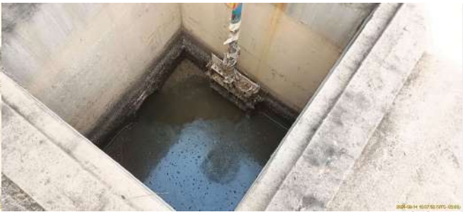
Foto 2 - Detalhe da profundidade do poço de chegada do esgoto, antes do gradeamento.
