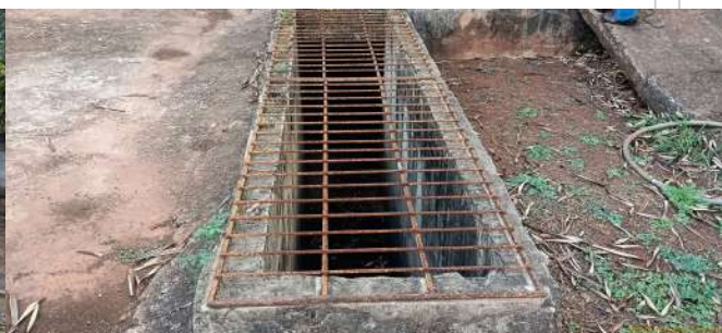
Foto 4 - Canal de chegada do esgoto.
