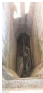
Foto 6 - Poço/canal de chegada do esgoto.
