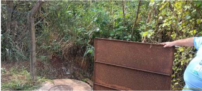
Foto 1 - Local de cercamento na EEE.
