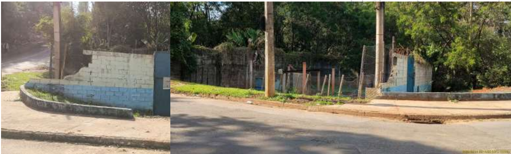
Foto 1 - Vista geral da entrada da EEE.
