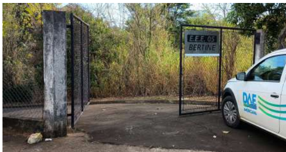
Foto 1 - Vista da entrada da EEE e placa de identificação.
