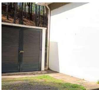
Foto 3 - Vista do abrigo dos painéis elétricos e de comando e do gerador de energia a diesel.
