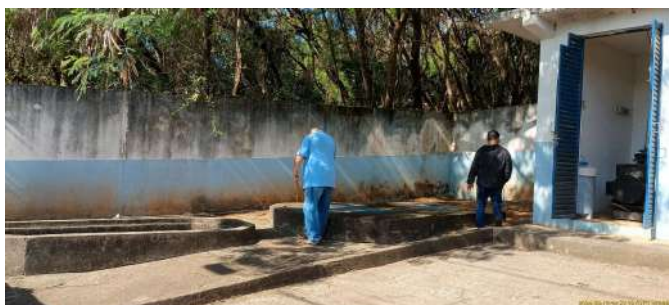
Foto 4 - Vista geral interna da EEE.
