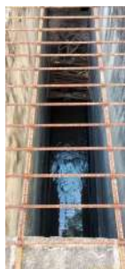
Foto 5 - Canal de chegada do esgoto.
