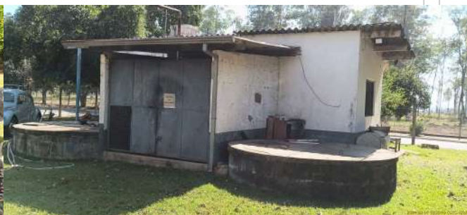
Foto 6 - Vista geral do poço de sucção e da casa de bombas.
