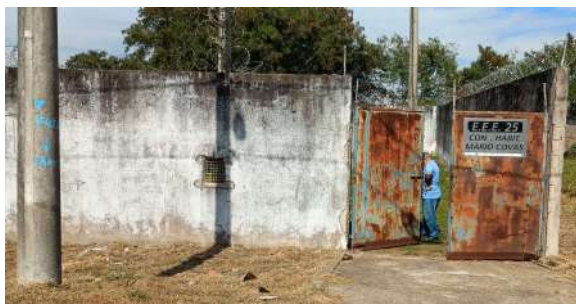
Foto 1 - Vista externa da EEE.
