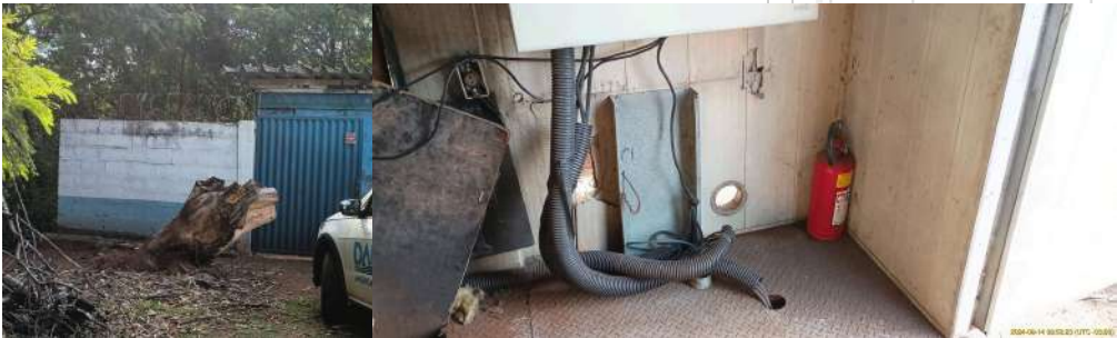
Foto 7 - Vista externa da EEE.
