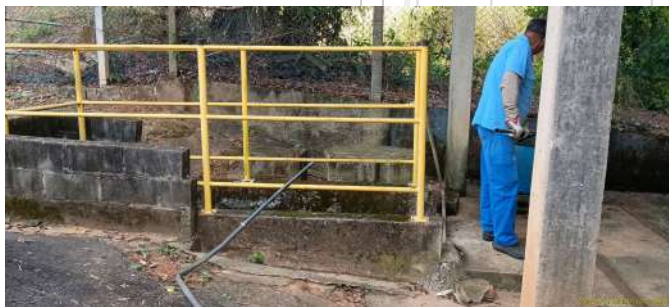
Foto 15 - Remoção do material retido nas grades.
