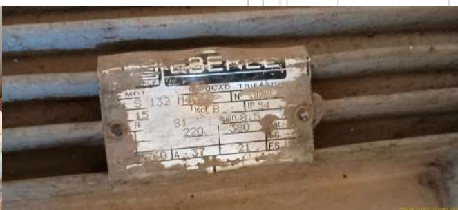
Foto 11 - Placa de especificações técnicas do motor do segundo conjunto motobomba.
