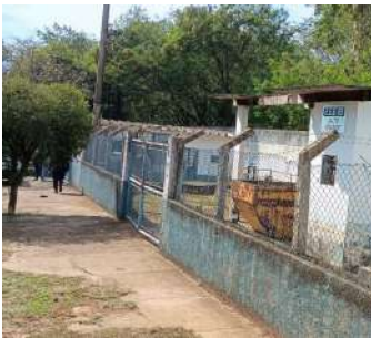
Foto 1 - Vista geral externa da EEE.
