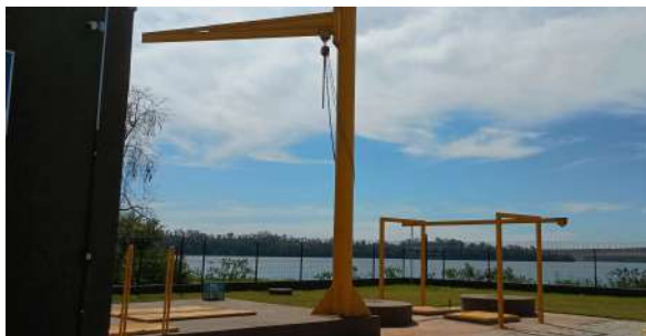
Foto 15 - Suporte para içamento dos conjuntos motobomba.
