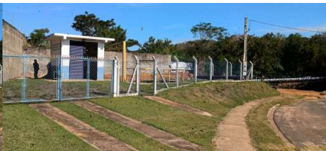
Foto 2 - Vista geral externa da EEE.
