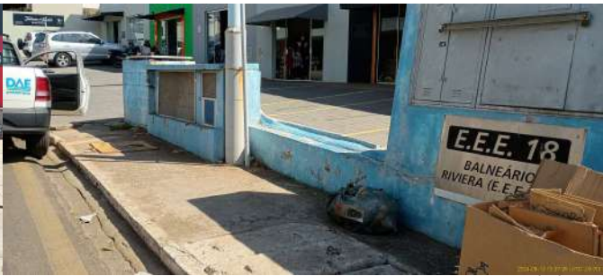
Foto 2 - Vista geral externa da EEE.
