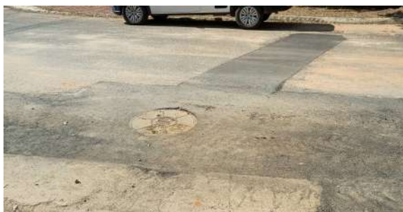
Foto 13 - Detalhes do recapeamento no asfalto após a interligação da rede coletora com o novo coletor do sistema Balsa.
