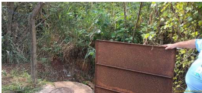
Foto 1 - Local de cercamento na EEE.
