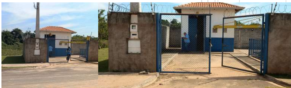
Foto 1 - Vista geral externa da EEE.
