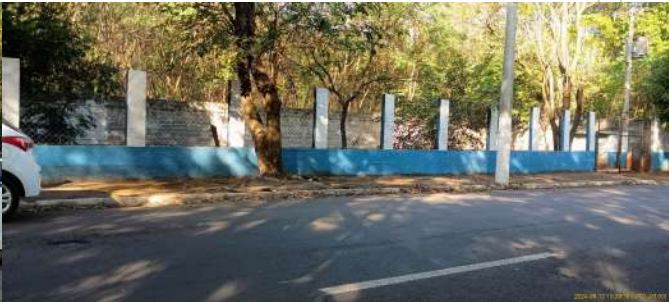
Foto 2 - Vista externa da EEE.
