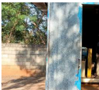
Foto 7 - Vista interna do abrigo.
