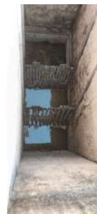
Foto 4 - Gradeamento da EEE.
