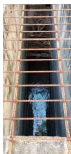
Foto 5 - Canal de chegada do esgoto.
