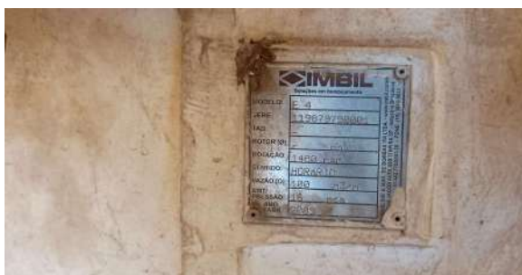
Foto 15 - Placa de especificações técnicas da bomba do segundo conjunto motobomba (B2).
