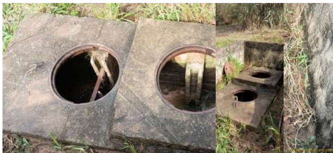
Foto 3 - Poços de chegada e Foto 4 - Poços de chegada e gradeamento da EEE. gradeamento da EEE.
