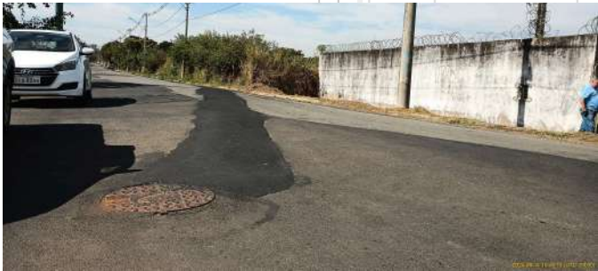
Foto 9 - Detalhe do trecho onde o PV na frente da EEE foi interligado com a nova tubulação coletora, possibilitando a desativação da EEE.
