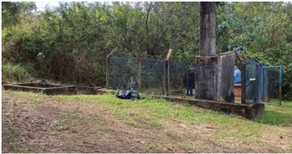
Foto 1 - Vista geral externa da EEE.
