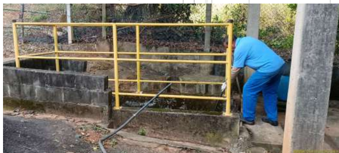
Foto 16 - Remoção do material retido nas grades.
