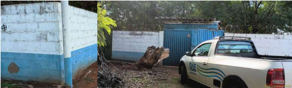
Foto 1 - Vista externa da lateral da EEE. Foto 2 - Vista da entrada da EEE.
