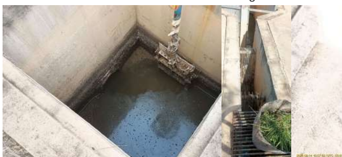
Foto 5 - Poço de chegada do
