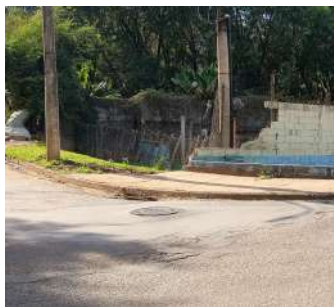
Foto 3 - Vista geral externa da EEE.
