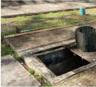
Foto 7 - Poço de chegada do esgoto e gradeamento.
