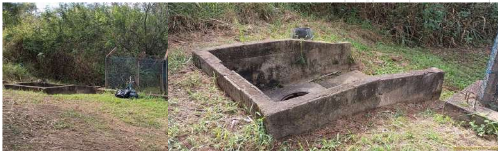
Foto 1 - Vista geral externa da EEE.
