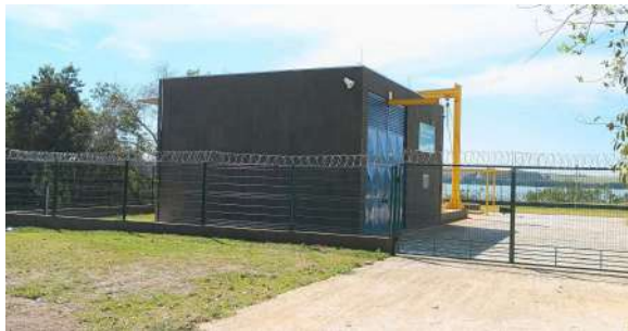
Foto 1 - Vista externa e da entrada da nova EEE.
