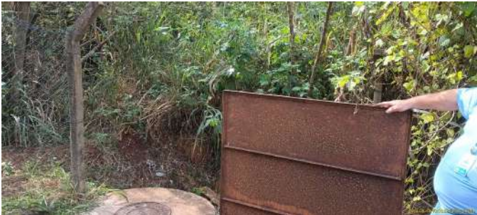
Foto 1 - Local de cercamento na EEE.
