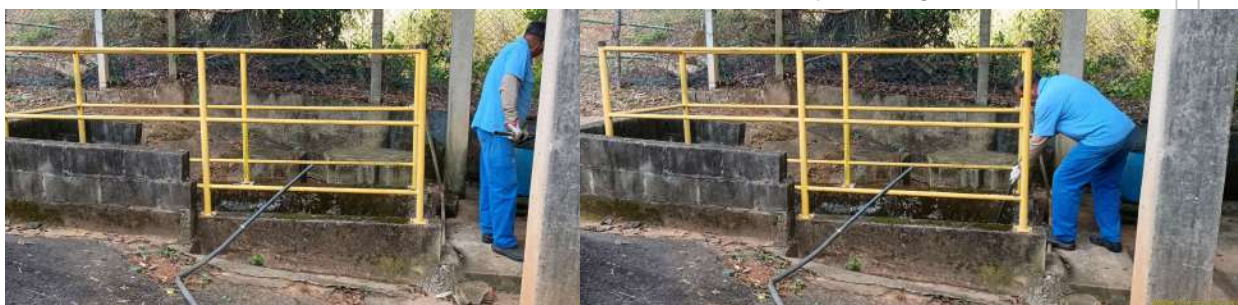
Foto 15 - Remoção do material retido nas grades.
