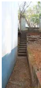
Foto 5 - Escada de acesso do nível da rua até o piso inferior.
