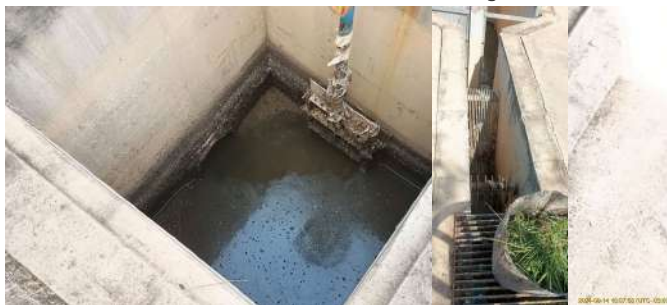
Foto 5 - Poço de chegada do esgoto.
