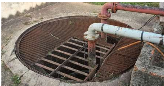
Foto 7 - Poço de sucção.
