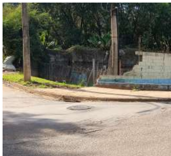
Foto 3 - Vista geral externa da EEE.
