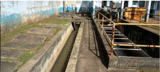
Foto 2 - Cana de chegada do esgoto.
