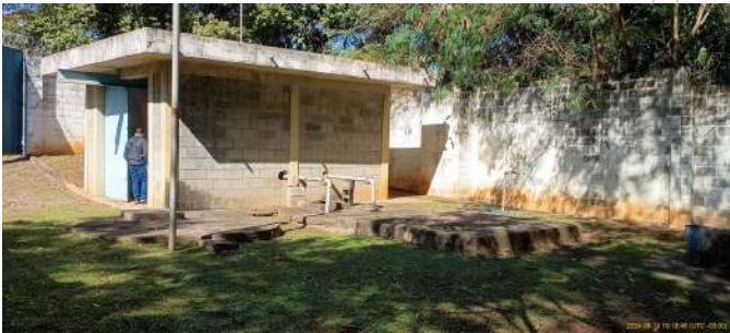
Foto 3 - Vista geral interna da EEE.
