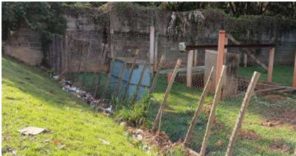
Foto 1 - Situação do alambrado da EEE.
