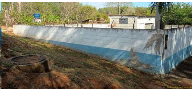
Foto 2 - Vista geral externa da EEE.
