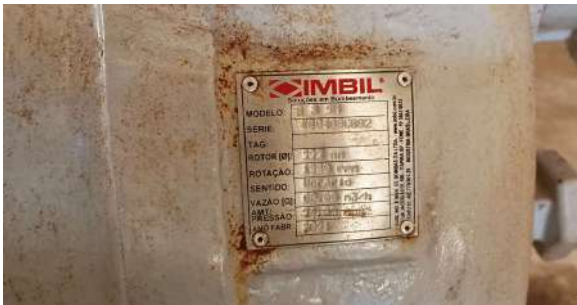
Foto 12 - Placa de especificações técnicas da bomba do segundo conjunto motobomba.
