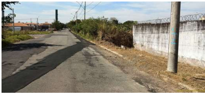
Foto 10 - Detalhe do trecho onde o PV na frente da EEE foi interligado com a nova tubulação coletora, possibilitando a desativação da EEE.
