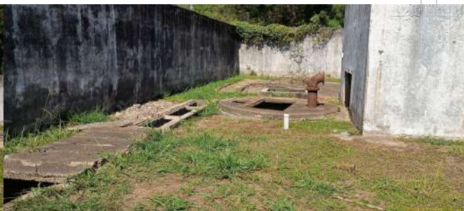
Foto 4 - Vista geral interna da EEE, com o cana de chegada do esgoto (à esquerda) e do poço de sucção (à frente).
