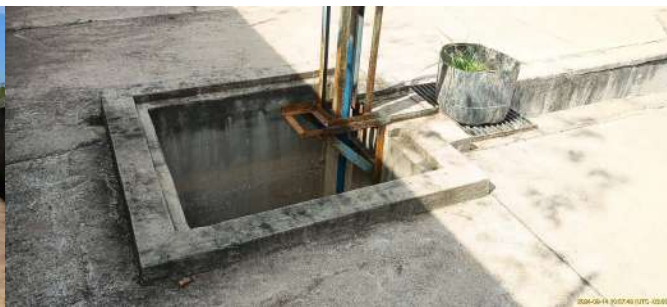
Foto 4 - Poço de chegada do esgoto.
