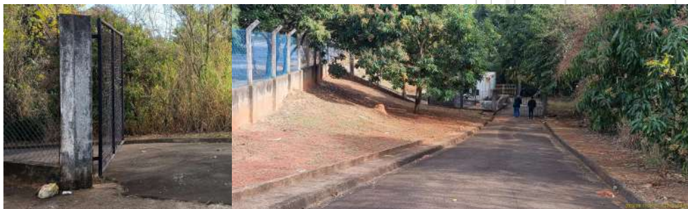
Foto 1 - Vista da entrada da EEE e placa de identificação.
