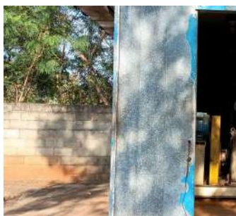
Foto 7 - Vista interna do abrigo.
