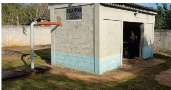
Foto 9 - Abrigo dos conjuntos motobomba e do gerador de energia a diesel.
