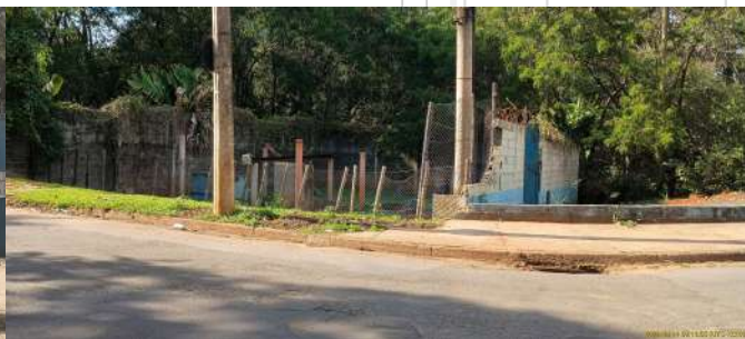
Foto 2 - Vista geral externa da EEE.
