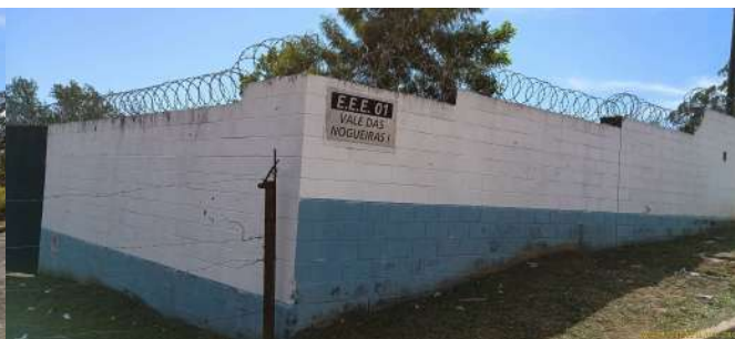
Foto 2 - Vista geral externa da EEE e placa de identificação.
