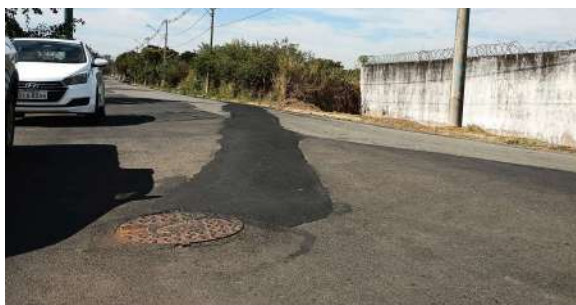
Foto 9 - Detalhe do trecho onde o PV na frente da EEE foi interligado com a nova tubulação coletora, possibilitando a desativação da EEE.
