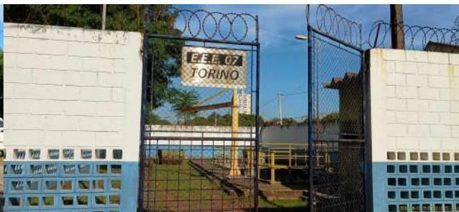
Foto 2 - Entrada e placa de identificação da EEE.
