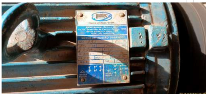
Foto 15 - Placa de especificações técnicas do segundo conjunto motobomba.
