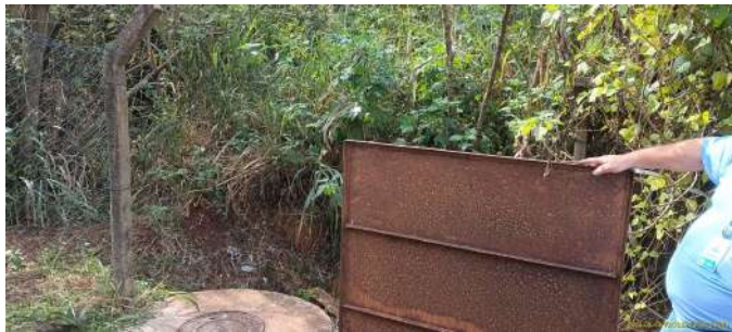
Foto 1 - Local de cercamento na EEE.
