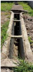
Foto 1 - Canal de chegada do esgoto bruto.
