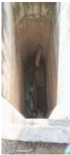
Foto 2 - Vista do fundo do poço/canal de chegada do esgoto (detalhe para a sua profundidade).
