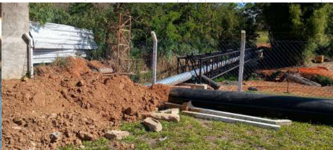
Foto 11 - Vista geral das obras na tubulação de recalque do esgoto (travessia do curso d'água).
