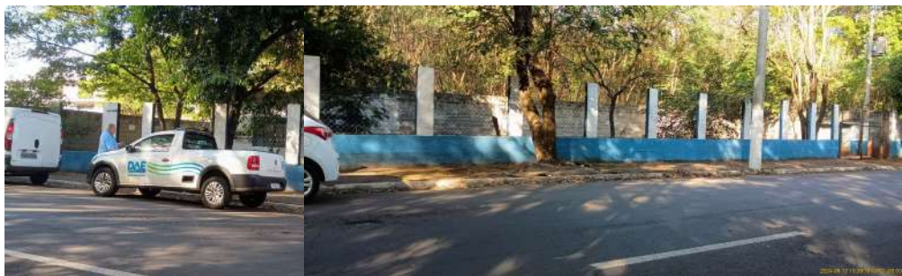
Foto 1 - Vista externa da EEE.
