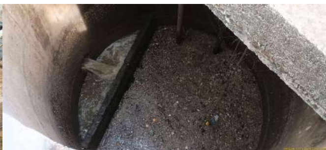
Foto 8 - Vista interna do poço de sucção.
