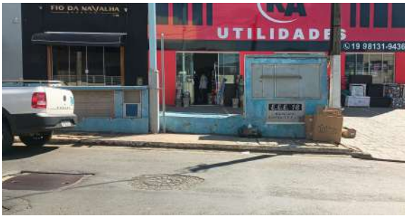
Foto 1 - Vista externa da EEE.
