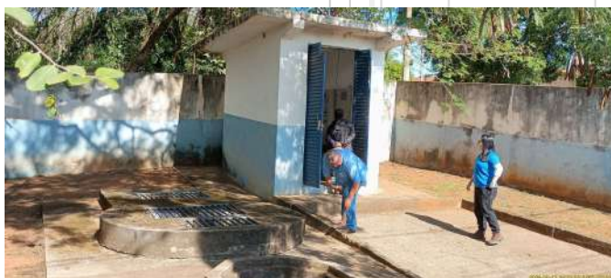
Foto 3 - Vista geral interna da EEE.
