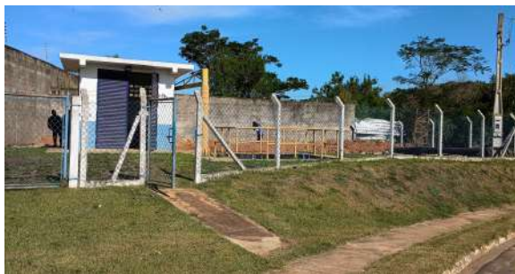
Foto 1 - Vista geral externa da EEE.
