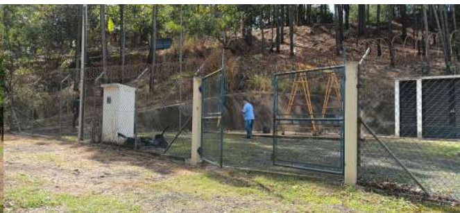
Foto 2 - Vista geral da EEE.
