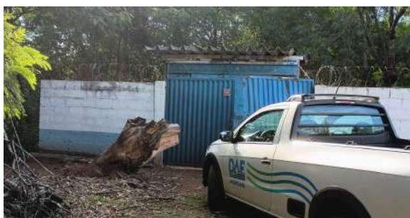
Foto 7 - Vista externa da EEE.
