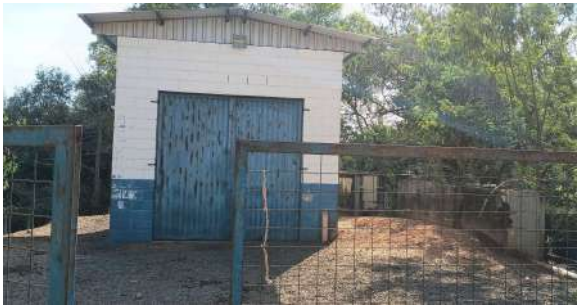
Foto 1 - Vista externa da EEE.
