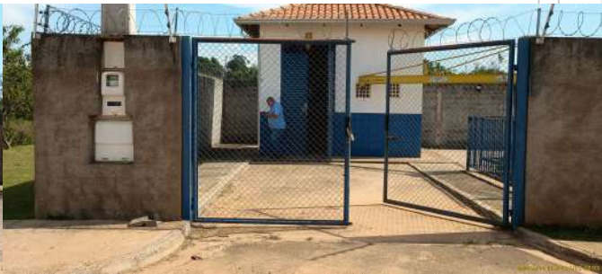
Foto 2 - Vista da entrada da EEE.
