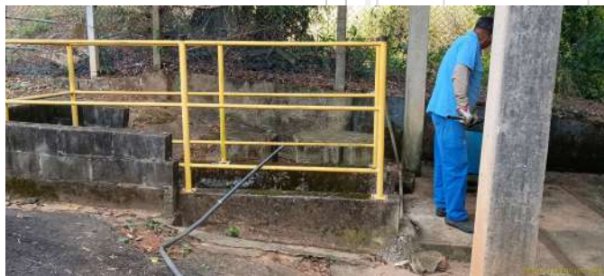
Foto 15 - Remoção do material retido nas grades.
