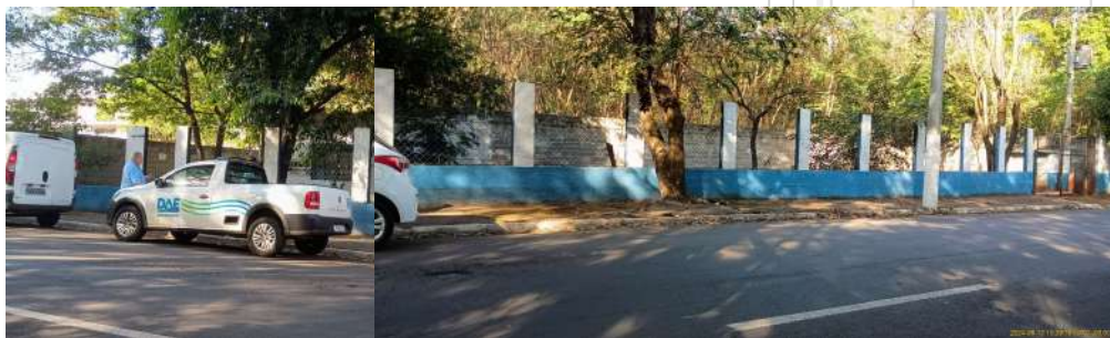
Foto 1 - Vista externa da EEE.
