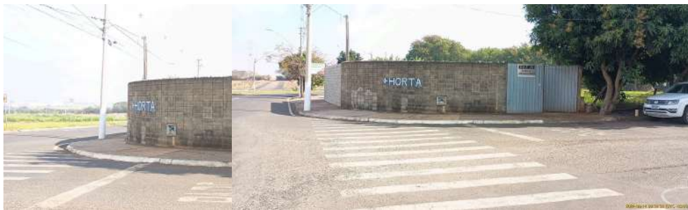
Foto 1 - Vista geral externa da EEE.
