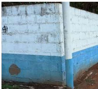
Foto 1 - Vista externa da lateral da EEE.
