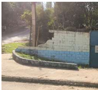
Foto 1 - Vista geral da entrada da EEE.
