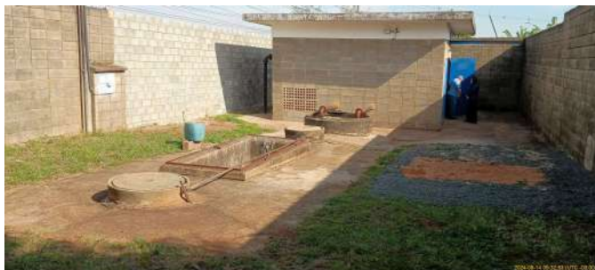
Foto 3 - Vista interna da EEE.
