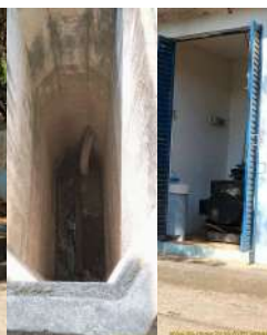
Foto 5 - Poço/canal de chegada do esgoto.
