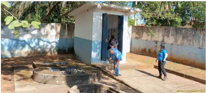
Foto 3 - Vista geral interna da EEE.
