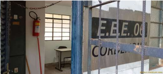
Foto 8 - Vista interna do painel elétrico e de comando.
