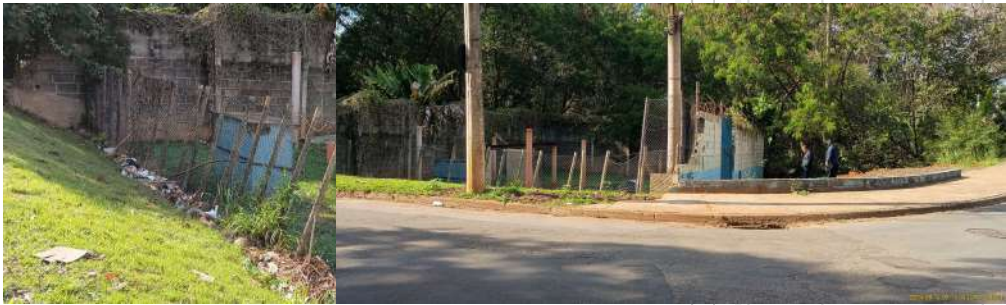
Foto 1 - Situação do alambrado da EEE.
