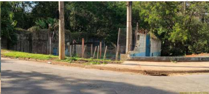
Foto 2 - Vista geral externa da EEE.
