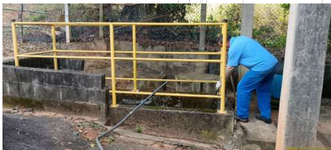
Foto 16 - Remoção do material retido nas grades.
