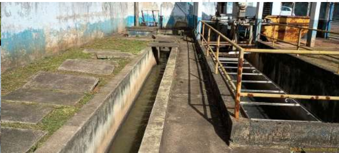
Foto 2 - Cana de chegada do esgoto.
