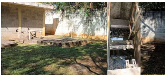
Foto 4 - Vista geral interna da EEE.
