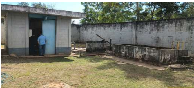
Foto 3 - Vista geral interna da EEE.
