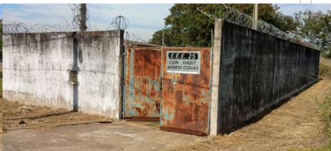
Foto 2 - Vista externa da EEE.
