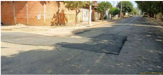
Foto 15 - Detalhes do recapeamento no asfalto após a interligação da rede coletora com o novo coletor do sistema Balsa.
