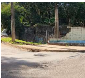
Foto 3 - Vista geral externa da EEE.
