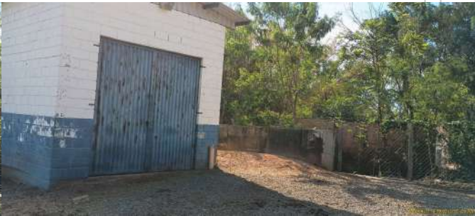
Foto 2 - Vista externa da EEE.
