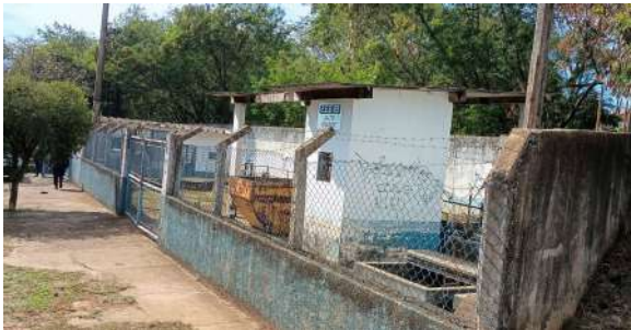
Foto 1 - Vista geral externa da EEE.
