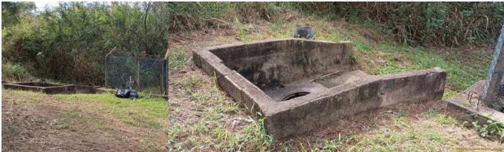
Foto 1 - Vista geral externa da EEE.
