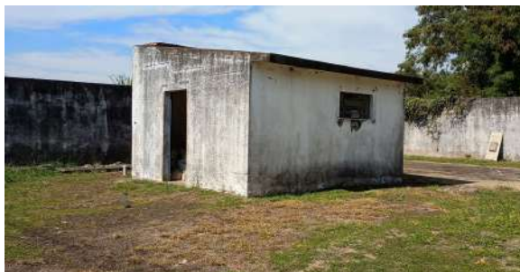
Foto 3 - Vista geral interna da EEE.
