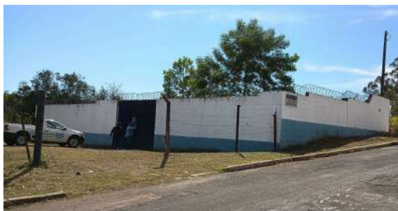
Foto 1 - Vista geral externa da EEE.
