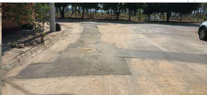
Foto 14 - Detalhes do recapeamento no asfalto após a interligação da rede coletora com o novo coletor do sistema Balsa.
