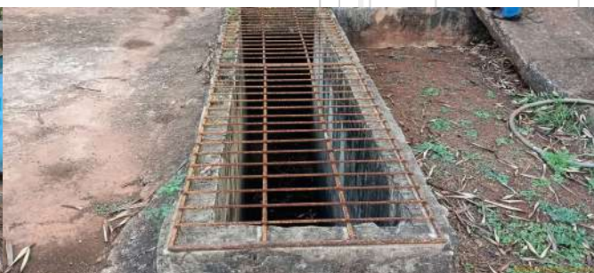
Foto 4 - Canal de chegada do esgoto.
