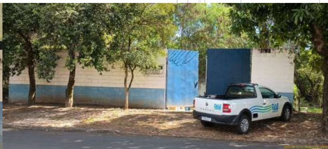
Foto 2 - Vista geral da entrada da EEE.
