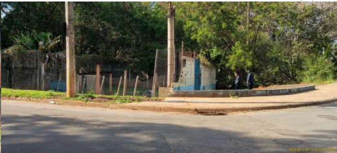
Foto 2 - Situação geral do cercamento da EEE.
