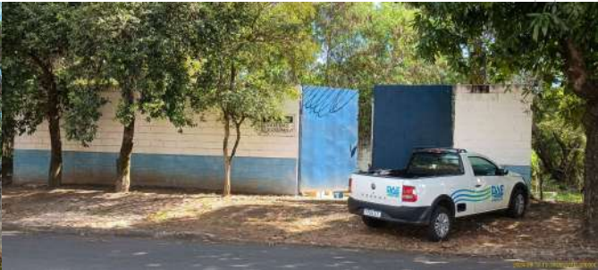
Foto 2 - Vista geral da entrada da EEE.
