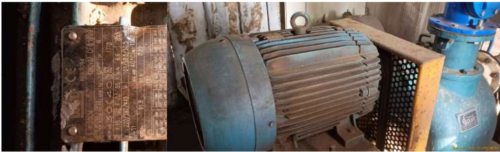
Foto 12 - Placa de especificações técnicas do motor de um dos conjuntos motobomba.
