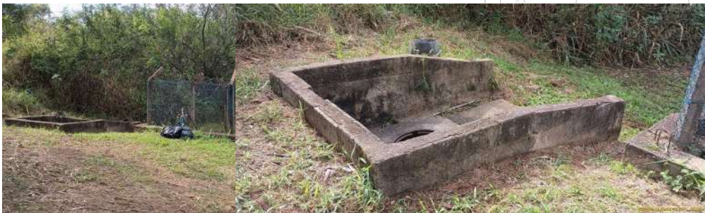
Foto 1 - Vista geral externa da EEE.
