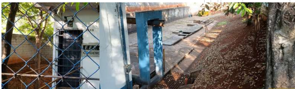
Foto 3 - Vista da entrada da EEE.
