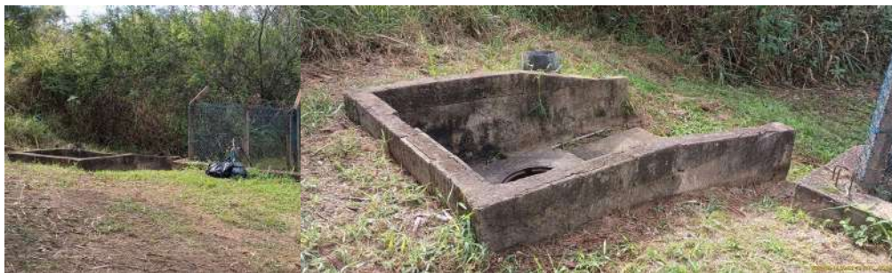
Foto 1 - Vista geral externa da EEE.
