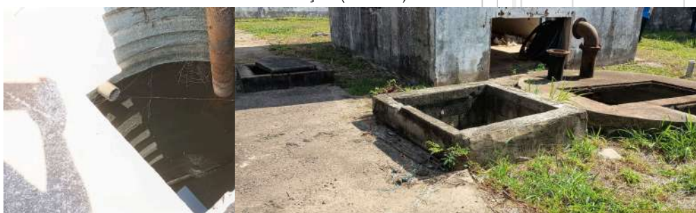
Foto 5 - Poço de sucção, onde ficavam as bombas submersas.
