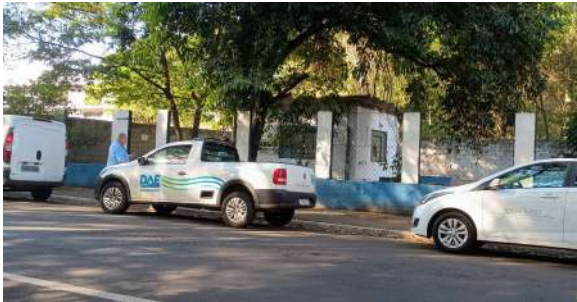
Foto 1 - Vista externa da EEE.
