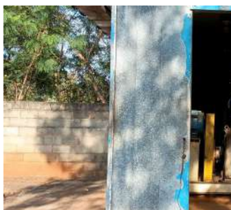
Foto 7 - Vista interna do abrigo.
