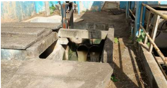
Foto 3 - Chegada do esgoto.
