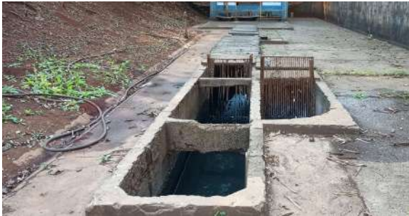
Foto 7 - Vista do canal de chegada do esgoto e gradeamento.
