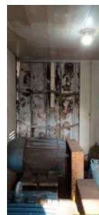
Foto 4 - Situação interna do abrigo dos conjuntos motobomba.
