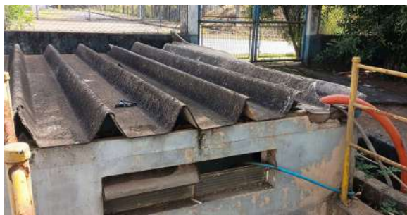
Foto 5 - Telhas quebradas.
