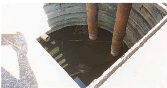
Foto 5 - Poço de sucção, onde ficavam as bombas submersas.
