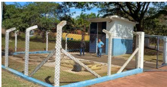
Foto 1 - Vista geral externa da EEE.
