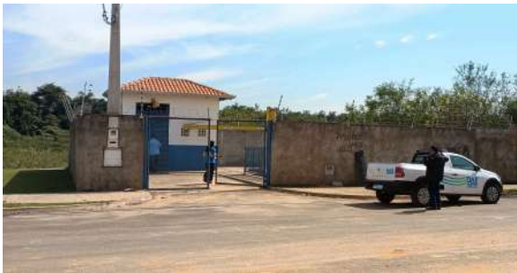
Foto 1 - Vista geral externa da EEE.
