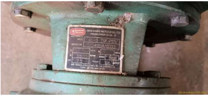
Foto 11 - Placa de especificações técnicas do primeiro conjunto motobomba.
