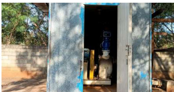
Foto 7 - Vista interna do abrigo.
