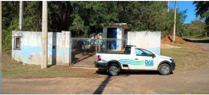
Foto 2 - Vista geral externa da EEE.
