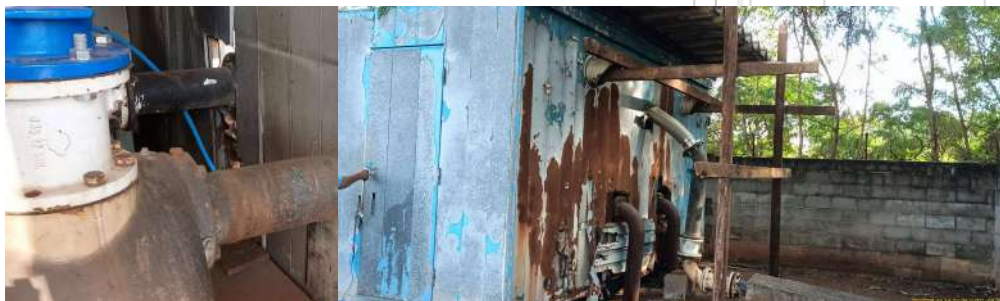
Foto 5 - Situação interna do abrigo dos conjuntos motobomba.
