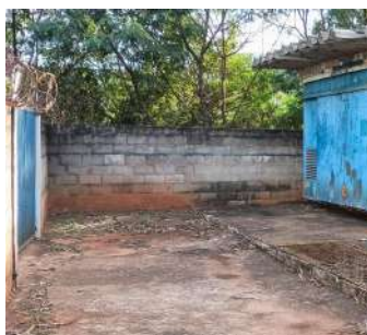
Foto 3 - Vista interna da EEE.
