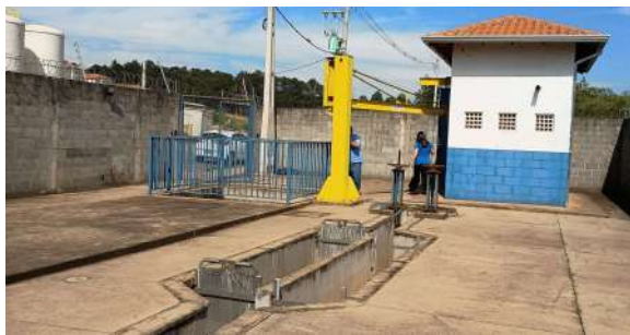
Foto 3 - Vista geral interna da EEE.
