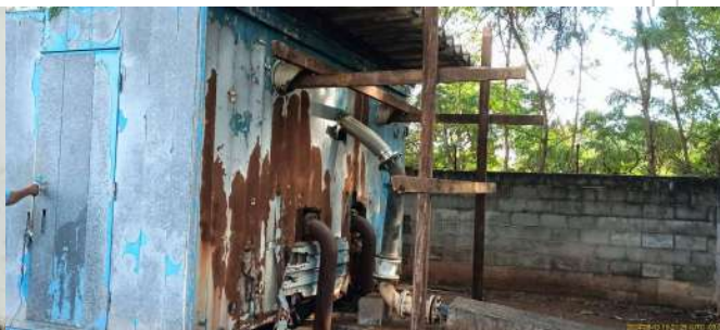
Foto 6 - Situação externa do abrigo dos conjuntos motobomba.
