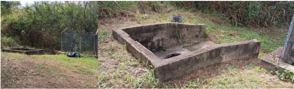
Foto 1 - Vista geral externa da EEE.
