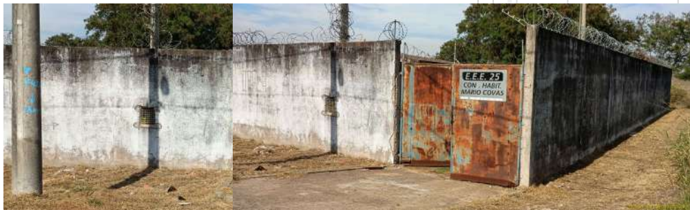
Foto 1 - Vista externa da EEE.
