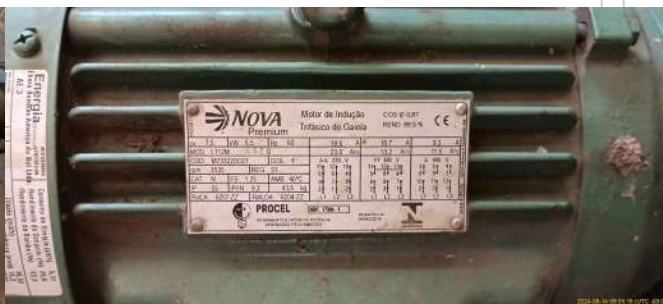
Foto 10 - Placa de especificações técnicas do motor do primeiro conjunto motobomba da EEE.
