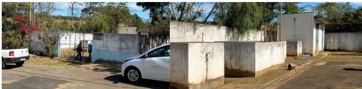
Foto 1 - Vista geral externa da EEE.
