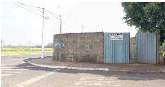
Foto 1 - Vista geral externa da EEE.
