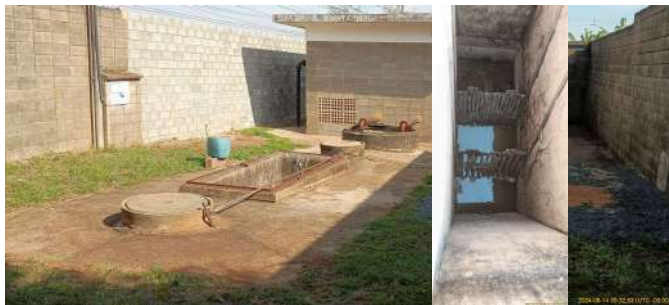
Foto 3 - Vista interna da EEE.
