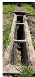
Foto 8 - Canal de chegada do esgoto bruto.
