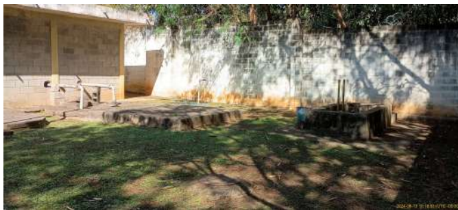
Foto 4 - Vista geral interna da EEE.
