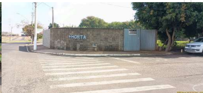
Foto 2 - Vista geral externa da EEE.
