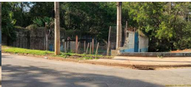
Foto 2 - Vista geral externa da EEE.
