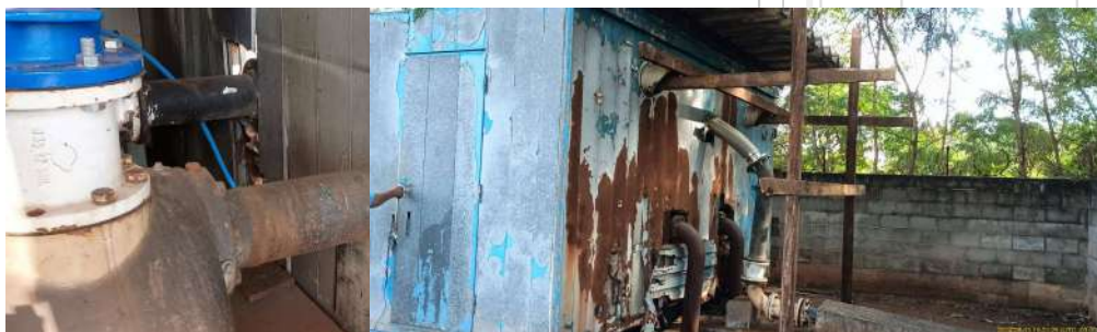
Foto 5 - Situação interna do abrigo dos conjuntos motobomba.
