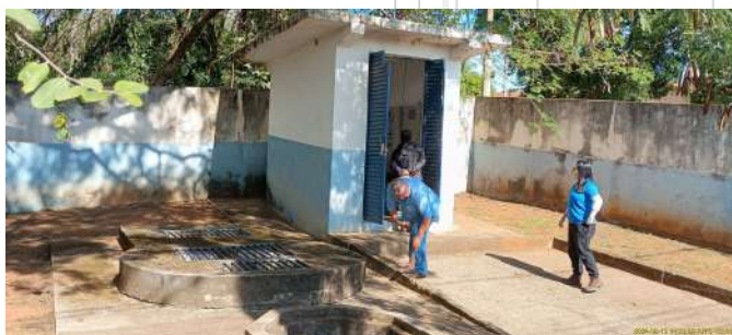
Foto 3 - Vista geral interna da EEE.
