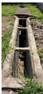
Foto 1 - Canal de chegada do esgoto bruto.
