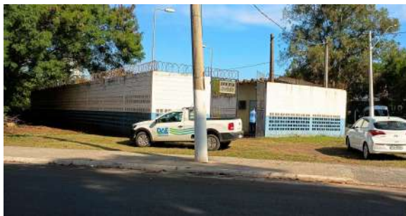
Foto 1 - Vista geral externa da EEE.
