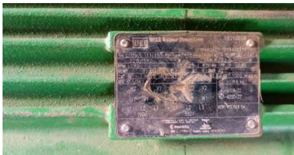
Foto 10 - Placa de especificações técnicas do motor do primeiro conjunto motobomba da EEE.
