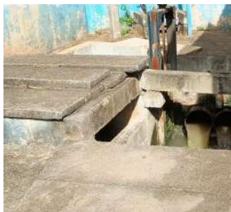
Foto 3 - Chegada do esgoto.
