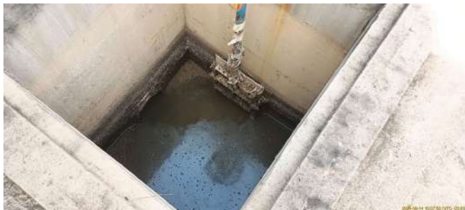
Foto 5 - Poço de chegada do esgoto.
