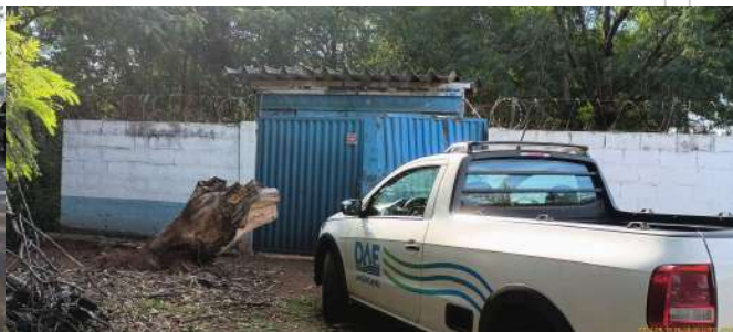
Foto 2 - Vista da entrada da EEE.
