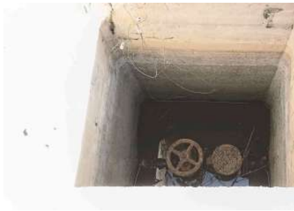
Foto 7 - Vista interna da caixa de registros da tubulação.
