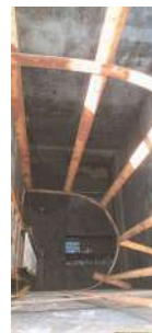
Foto 4 - Vista interna do poço de acesso ao gradeamento do esgoto.
