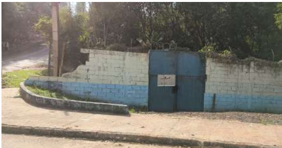
Foto 1 - Vista geral da entrada da EEE.
