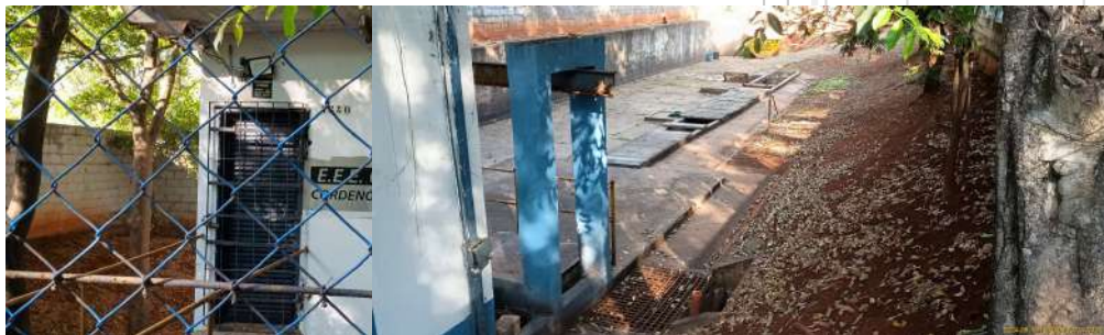
Foto 3 - Vista da entrada da EEE.
