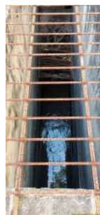
Foto 5 - Canal de chegada do esgoto.
