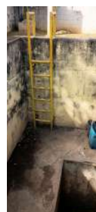
Foto 6 - Acesso ao gradeamento para remoção de materiais retidos.
