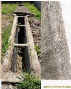
Foto 8 - Canal de chegada do esgoto bruto.
