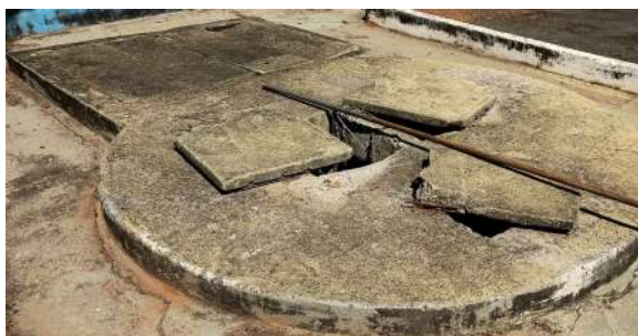
Foto 6 - Poço de sucção com motobombas submersas.
