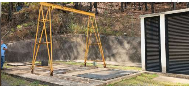
Foto 6 - Poços de chegada e sucção de esgoto e pórtilo para içamento das bombas da elevatória.
