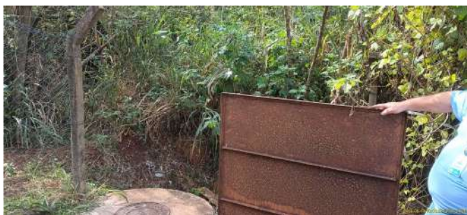
Foto 1 - Local de cercamento na EEE.
