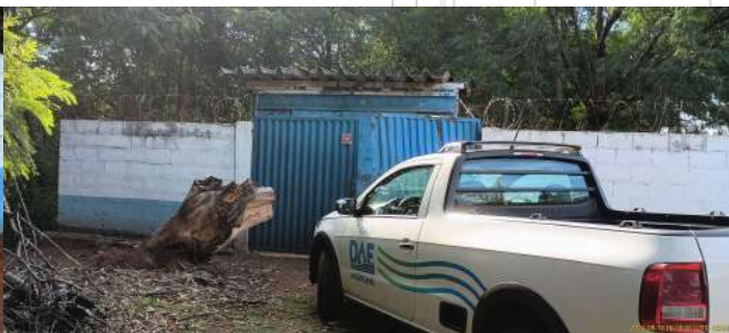
Foto 2 - Vista da entrada da EEE.
