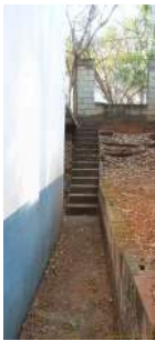
Foto 5 - Escada de acesso do nível da rua até o piso inferior.
