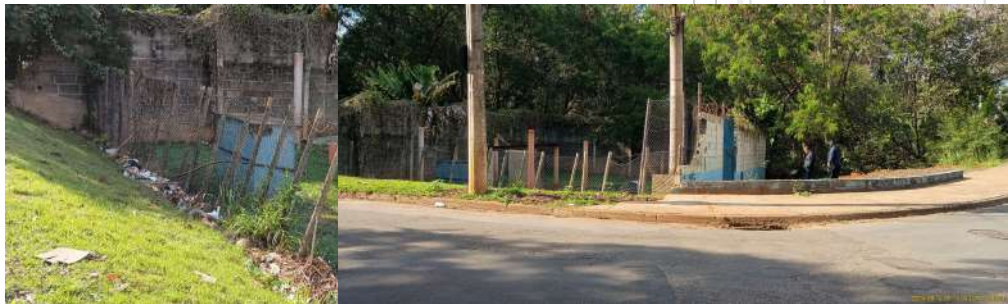
Foto 1 - Situação do alambrado da EEE.
