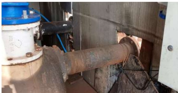
Foto 5 - Situação interna do abrigo dos conjuntos motobomba.
