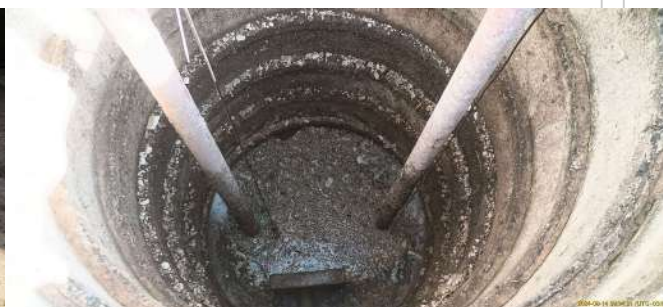
Foto 6 - Vista interna do poço de sucção.
