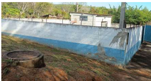
Foto 1 - Vista geral externa da EEE.
