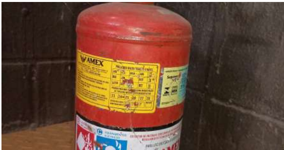
Foto 1 - Validade do extintor de incêndio dentro do prazo adequado.
