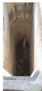
Foto 5 - Poço/canal de chegada do esgoto.
