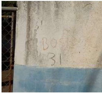
Foto 1 - Nome da EEE escrito de maneira inadequada na muro externo.
