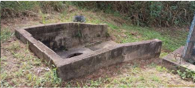
Foto 2 - Estrutura de chegada do esgoto.
