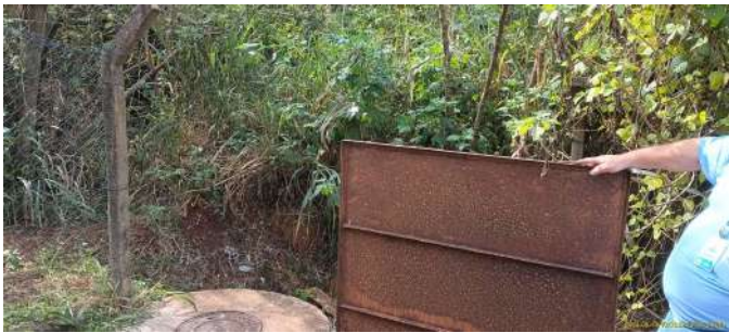
Foto 1 - Local de cercamento na EEE.
