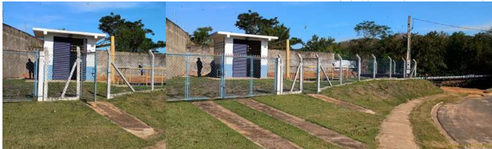
Foto 1 - Vista geral externa da EEE.
