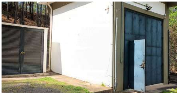
Foto 3 - Vista do abrigo dos painéis elétricos e de comando e do gerador de energia a diesel.
