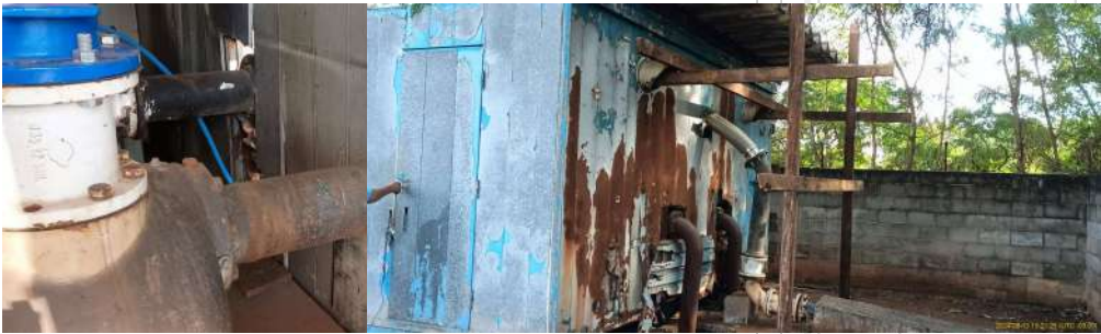
Foto 5 - Situação interna do abrigo dos conjuntos motobomba.
