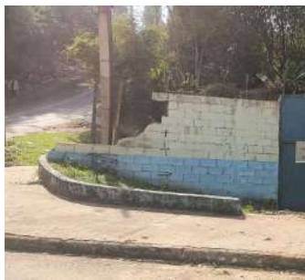
Foto 1 - Vista geral da entrada da EEE.
