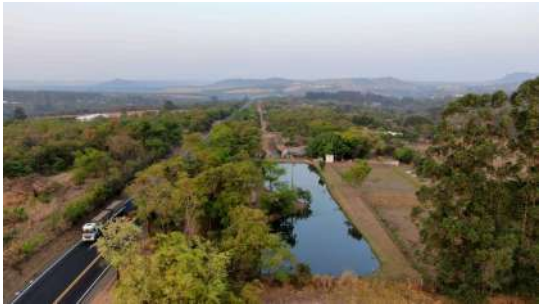
Foto 1 - Visão geral dos reservatórios situados na área onde havia uma ETA experimental com sistema wetland. Atualmente, os reservatórios são abastecidos pelo Poço 7, instalado no mesmo local.
