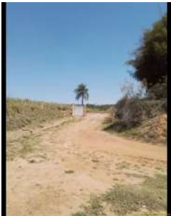
Foto 1 - Portão de acesso à ETE.
