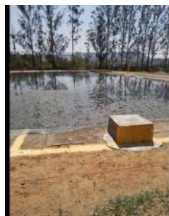
Foto 2 - Escuma e sobrenadante acumulados na lagoa anaeróbia, próximo à entrada do efluente na lagoa.
