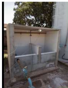
Foto 2 - Novo abrigo para os produtos químicos.
