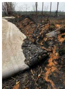
Foto 16 - Foto registrada após incêndio que aintgiu áreas da ETE, incluindo o local onde estavam as BAGs com lodo (enviado pelo prestador).
