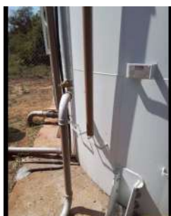
Foto 1 - Extravasor do reservatório.
