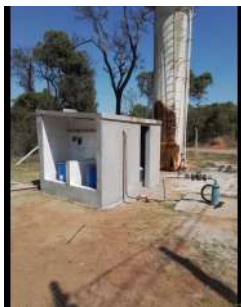
Foto 3 - Visão geral do poço 6 e do novo abrigo de produtos químicos e do painel de comando da bomba.
