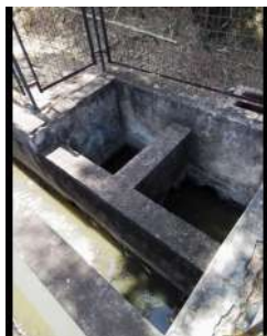
Foto 23 - Saída do tanque de chicanas.
