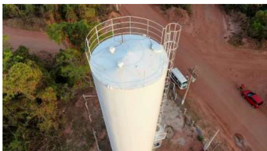
Foto 1 - Tampa de inspeção na cobertura do reservatório elevado.
