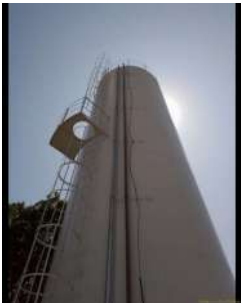
Foto 1 - Novo reservatório do poço 5, já em operação.
