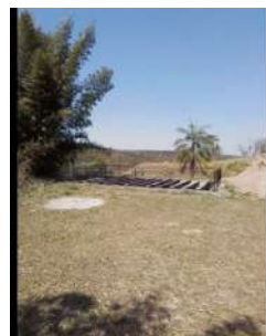
Foto 26 - Vista do tanque de chicanas para desinfecção - etapa que não estava sendo realizada.
