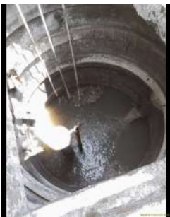
Foto 3 - Nesta imagem pode-se observar a presença de sólidos no poço de sucção, material que deveria ter sido removido no gradeamento e limpeza.
