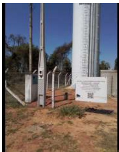
Foto 1 - Cercamento da área.
