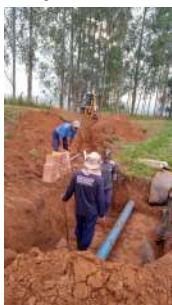
Foto 7 - Foto do serviço de remoção de lodo sendo executado, enviada pelo prestador. Datada de julho/2023.
