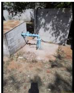
Foto 1 - Laje de concreto.
