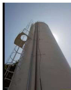
Foto 2 - Descida do extravasor.
