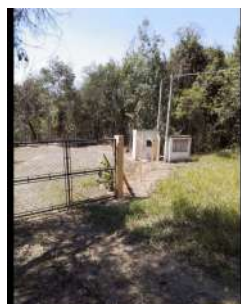
Foto 4 - Portão de acesso.
