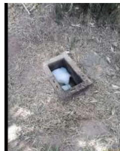
Foto 24 - Lançamento final, após as chicanas. Havia bastante espuma.
