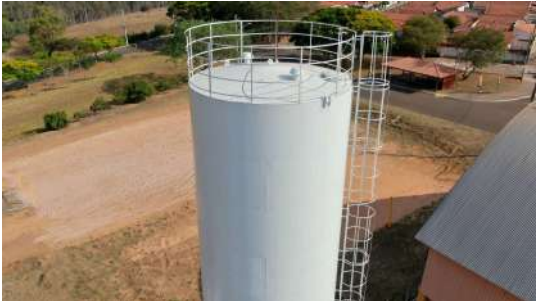
Foto 2 - Guarda-corpo na cobertura.
