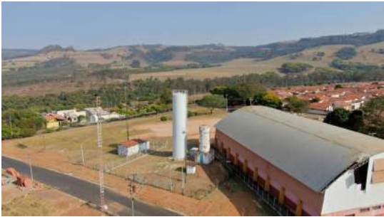
Foto 1 - Cerca em todo o perímetro da área.
