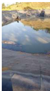
Foto 10 - Foto do serviço de remoção de lodo sendo executado, enviada pelo prestador. Datada de julho/2023.
