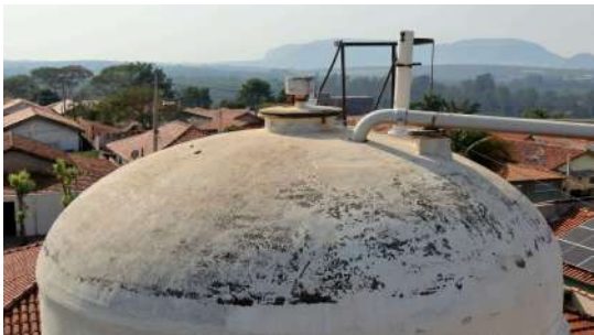
Foto 1 - Tampa de inspeção do reservatório elevado.
