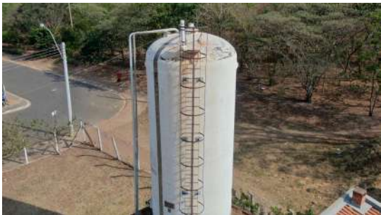
Foto 1 - Escada do reservatório.
