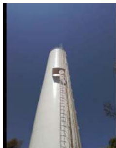
Foto 5 - Visão geral do reservatório.
