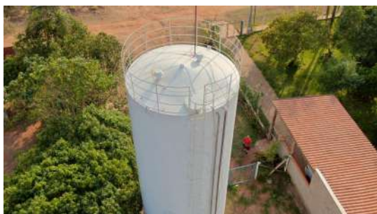
Foto 3 - Escada e guarda-corpo.
