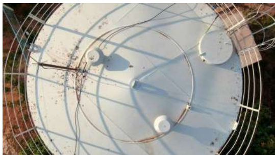
Foto 1 - Tampa de inspeção em boas condições.
