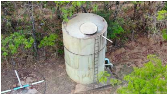
Foto 1 - Escada sem proteção adequada e ausência de guarda-corpo.
