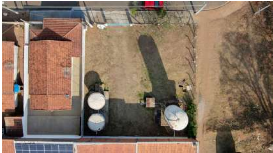
Foto 1 - Cerca em todo o perímetro da área.
