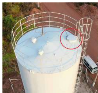
Foto 2 - Tampa de inspeção na cobertura do reservatório elevado.
