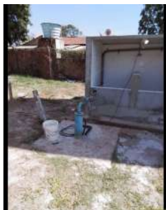
Foto 1 - Poço 5 e nova casa de química, que está em fase final de execução e em breve abrigará os produtos químicos.
