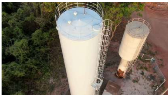
Foto 3 - Escada e guarda-corpo no reservatório novo.
