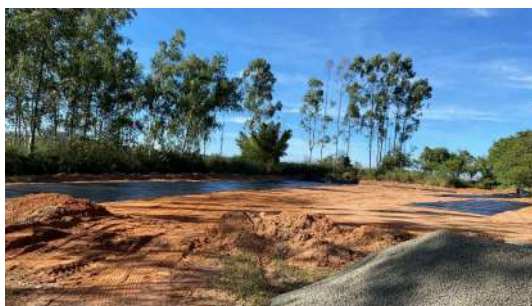
Foto 12 - Área para acondicionamento das BAGs (enviado pelo prestador).
