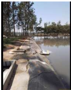
Foto 12 - Entrada do efluente na lagoa facultativa, após passar pela anaeróbia.
