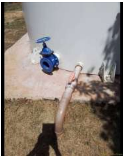
Foto 3 - Saída do reservatório.
