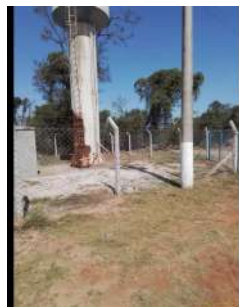
Foto 2 - Cercamento da área.
