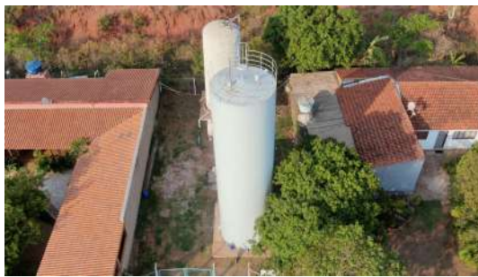
Foto 6 - Imagem aérea do reservatório do poço 5: à frente, novo reservatório; atrás, reservatório antigo que foi desativado.
