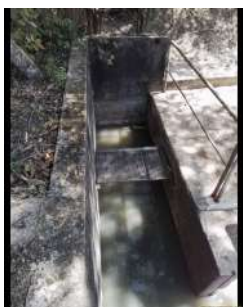
Foto 1 - Gradeamento na entrada da elevatória.
