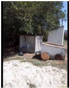
Foto 1 - Novo abrigo para os produtos químicos sendo finalizado.
