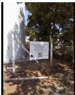
Foto 1 - Placa de identificação do reservatório e poço.
