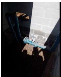
Foto 1 - Medidor de vazão do poço.
