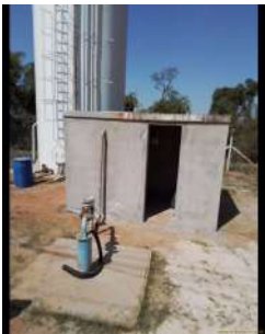
Foto 2 - Novo abrigo do painel de comando da bomba, em fase final de execução. Será realizado acabamento e instalada porta.
