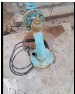
Foto 1 - Tubo para medição do nível.
