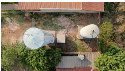
Foto 2 - Cerca em todo o perímetro da área.
