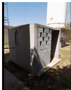
Foto 6 - Novo abrigo do painel de comando sa bomba, recém construído. Será instalada porta.
