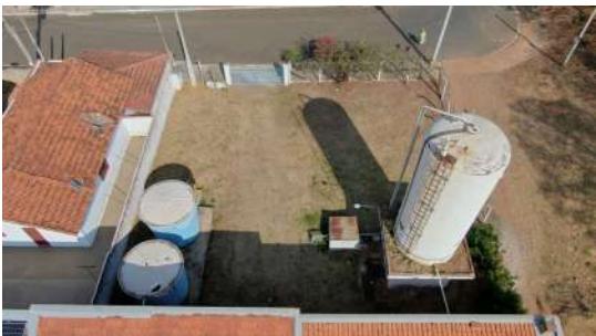
Foto 1 - Visão geral dos reservatórios.
