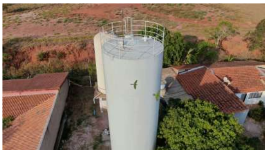
Foto 7 - Visão geral do reservatório.
