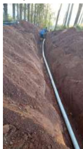
Foto 8 - Foto do serviço de remoção de lodo sendo executado, enviada pelo prestador. Datada de julho/2023.
