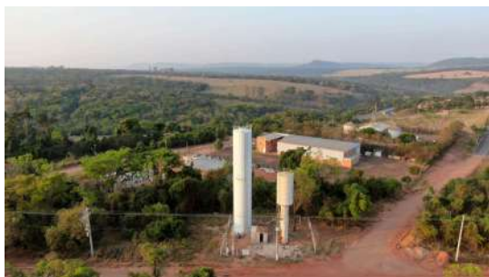
Foto 6 - Foto aérea dos reservatórios (novo e desativado) e do poço 6.
