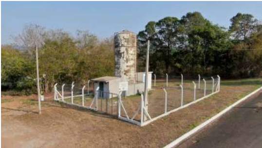
Foto 1 - Visão geral do reservatório abastecido pelo poço 2, situado em local próximo.
