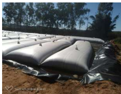
Foto 14 - BAGs com lodo removido das lagoas (enviada pelo prestador).
