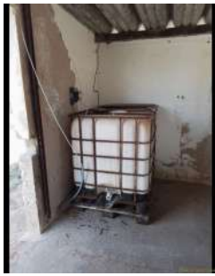
Foto 1 - Tanque para armazenamento de hipoclorito estava vazio.
