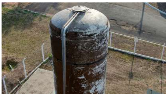
Foto 1 - Tampa de inspeção do reservatório.
