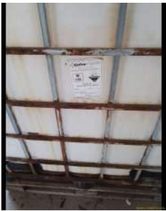
Foto 11 - Identificação do tanque de hipoclorito.
