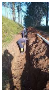
Foto 6 - Foto do serviço de remoção de lodo sendo executado, enviada pelo prestador. Datada de julho/2023.
