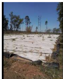
Foto 2 - BAGs com lodo ressecado, removido das lagoas. Situação verificada no dia da Fiscalização (12/09/2024).
