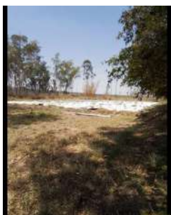
Foto 1 - BAGs com lodo ressecado, removido das lagoas. Situação verificada no dia da Fiscalização (12/09/2024).
