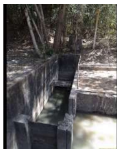
Foto 2 - Gradeamento na entrada da elevatória.
