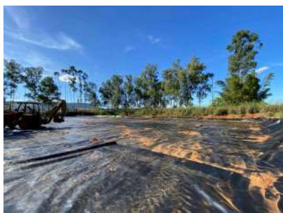
Foto 11 - Foto do serviço de remoção de lodo sendo executado, enviada pelo prestador. Área para acondicionamento das BAGs (enviada pelo prestador).
