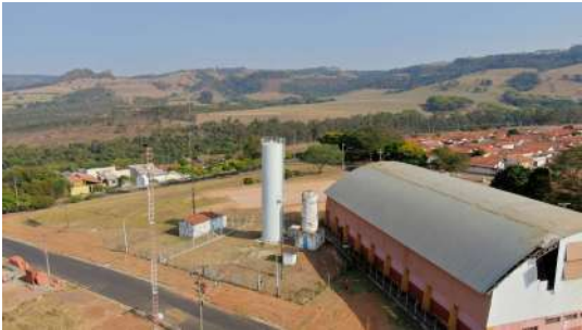
Foto 2 - Visão geral do reservatório, situado junto ao poço 1.
