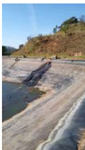
Foto 9 - Foto do serviço de remoção de lodo sendo executado, enviada pelo prestador. Datada de julho/2023.
