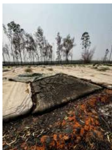
Foto 17 - Foto registrada após incêndio que aintgiu áreas da ETE, incluindo o local onde estavam as BAGs com lodo (enviado pelo prestador).
