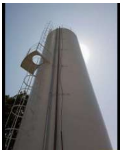
Foto 1 - Descida do aterramento.
