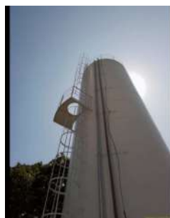
Foto 2 - Escada com proteção.
