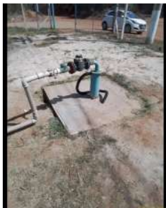
Foto 1 - Laje de concreto.
