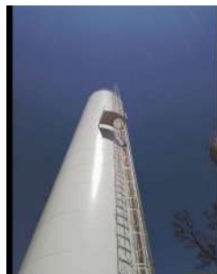
Foto 2 - Escada e plataforma de descanso.
