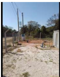
Foto 1 - Cercamento da área.
