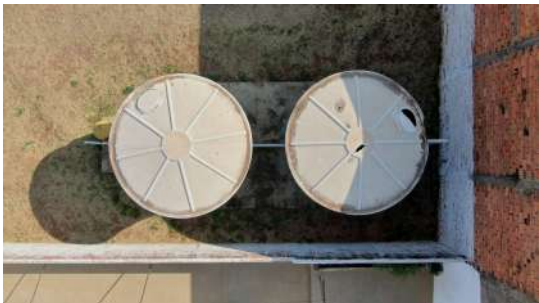
Foto 1 - Imagem aérea dos reservatórios de fibra apoiados instalados no local. Um deles possui aberturas na cobertura.
