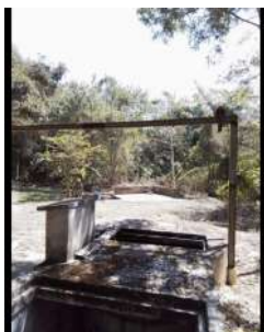
Foto 1 - Estrutura para içamento da bomba.
