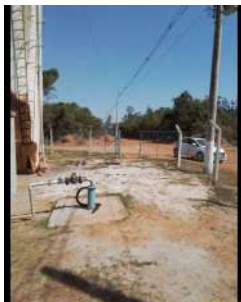
Foto 3 - Cercamento da área.
