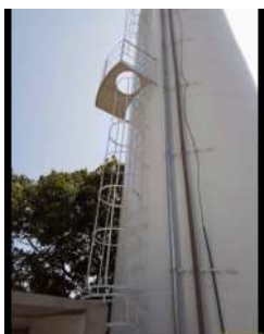
Foto 1 - Escada e plataforma de descanso.
