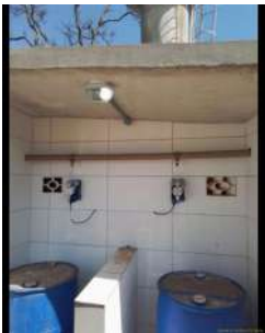
Foto 4 - Aplicação de produtos químicos na tubulação que abastece o reservatório 6.
