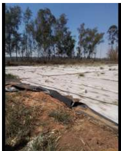
Foto 3 - BAGs com lodo ressecado, removido das lagoas. Situação verificada no dia da Fiscalização (12/09/2024).
