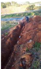
Foto 5 - Foto do serviço de remoção de lodo sendo executado, enviada pelo prestador. Datada de julho/2023.
