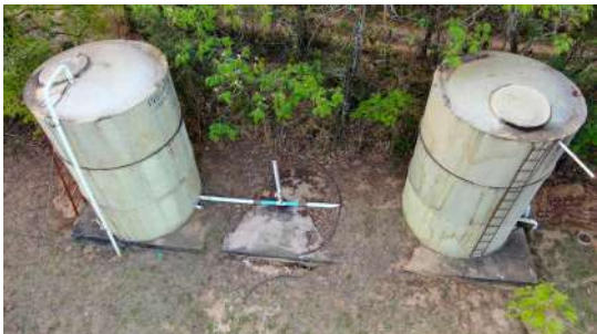
Foto 1 - Tampas de inspeção em boas condições.
