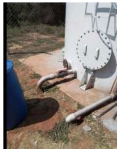
Foto 4 - Saída do reservatório.
