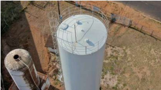
Foto 1 - Para-raios do reservatório elevado.
