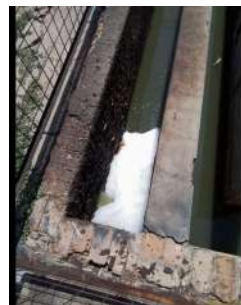
Foto 22 - Entrada do efluente nas chicanas.
