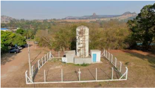
Foto 1 - Cerca em todo o perímetro da área.
