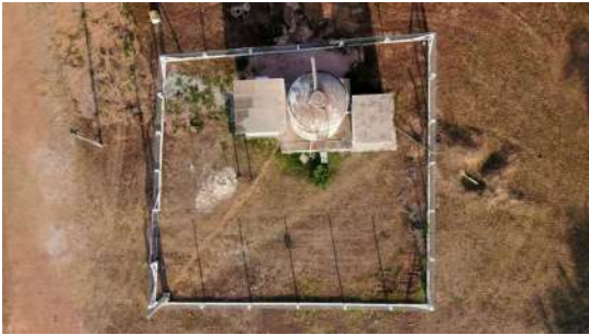
Foto 2 - Cerca em todo o perímetro da área.
