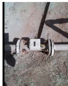
Foto 4 - Medidor de vazão do poço.
