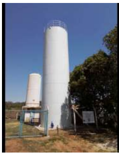
Foto 5 - Visão geral do reservatório novo do poço 5. Atrás, reservatório antigo, desativado.
