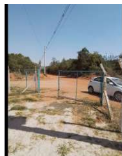
Foto 2 - Cercamento da área.
