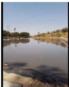
Foto 14 - Vista da lagoa facultativa.
