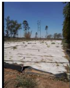
Foto 4 - BAGs com lodo ressecado, removido das lagoas. Situação verificada no dia da Fiscalização (12/09/2024).
