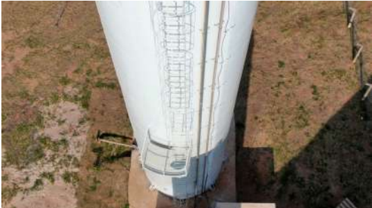
Foto 1 - Escada com proteção
