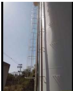
Foto 1 - Escada externa do reservatório.
