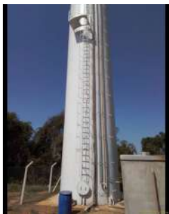
Foto 1 - Visão geral do reservatório.
