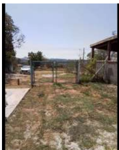
Foto 1 - Cerca e portão.
