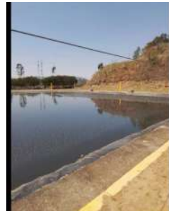
Foto 11 - No perímetro da lagoa anaeróbia foi instalada linha de vida para manutenção.
