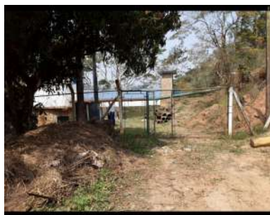
Foto 1 - Detalhe da cerca de alambrado e portão de acesso à captação.
