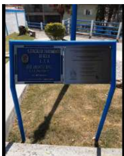
Foto 1 - Placa de identificação instalada próximo à entrada do prédio de atendimento ao público.
