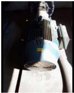
Foto 5 - Tag de uma das bombas.
