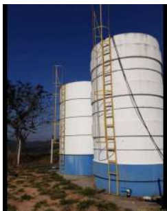
Foto 3 - Escada e guarda-corpos dos reservatórios apoiados.
