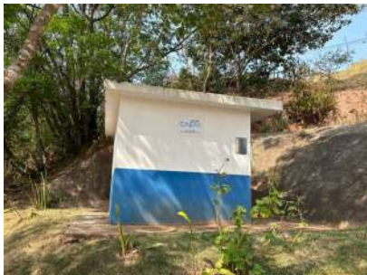
Foto 1 - Vista externa da edificação que abriga a estação elevatória.
