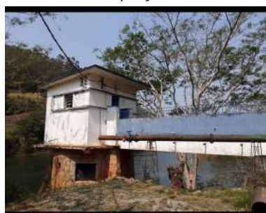
Foto 5 - Vista geral das edificações - casa de bombas e passarela de acesso.
