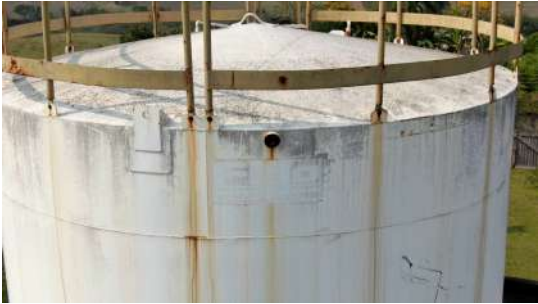
Foto 1 - Extravasor localizado próximo ao topo do reservatório (orifício no centro da imagem).
