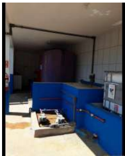
Foto 12 - Área de estocagem de produtos químicos.
