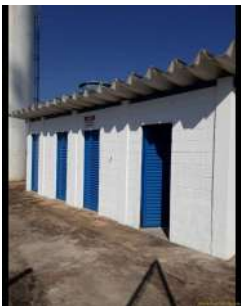
Foto 5 - Vista geral da edificação de apoio ao sistema, atualmente sem uso.
