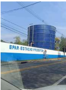
Foto 1 - Identificação da área passando por adequações.
