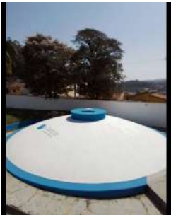
Foto 1 - Tampa de inspeção no topo do reservatório.
