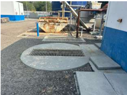
Foto 1 - Poço da elevatória.
