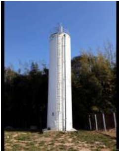
Foto 2 - Vista geral do reservatório elevado.
