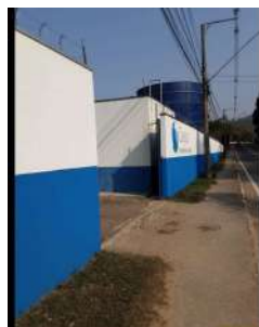
Foto 2 - Portão de acesso à ETE.
