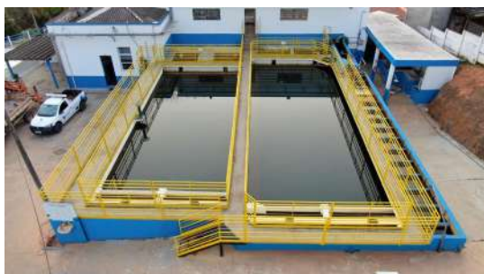
Foto 1 - Vista geral dos guarda-corpos da ETA.
