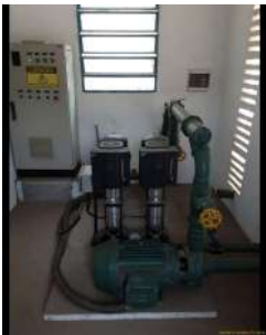
Foto 3 - Vista geral do interior da edificação.
