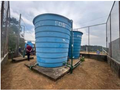
Foto 2 - Vista geral do reservatório.
