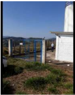
Foto 2 - Detalhe do portão de acesso à área.
