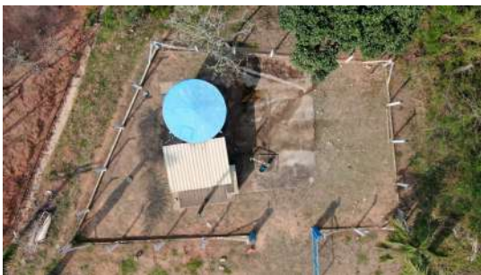
Foto 1 - Vista aérea do cercamento do terreno.
