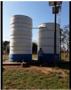
Foto 6 - Vista geral atrás dos reservatórios apoiados.
