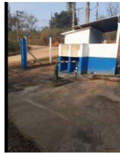
Foto 2 - Vista geral das instalações do poço e estruturas de apoio.
