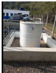
Foto 2 - Dique de contenção do tanque de polímero (usado no tratamento de lodo).
