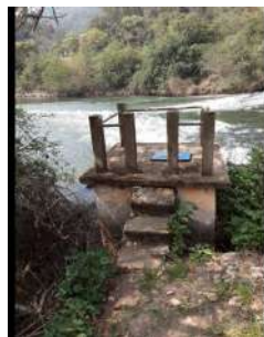
Foto 11 - Antiga estrutura para abrigo das bombas - sem uso atualmente.
