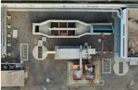
Foto 2 - Vista aérea das estruturas do tratamento preliminar - remoção de resíduos, areia e gorduras do efluente bruto.
