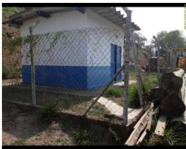
Foto 1 - A edificação está inteiramente cercada por alambrados.
