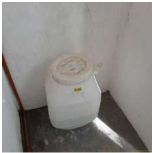
Foto 2 - Tanque de armazenamento de Ácido Fluossilícico.
