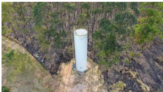
Foto 1 - Vista aérea do reservatório.
