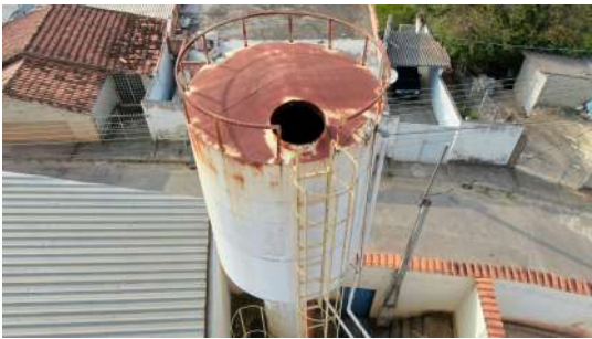
Foto 2 - Detalhe do guarda-corpos no topo do reservatório.
