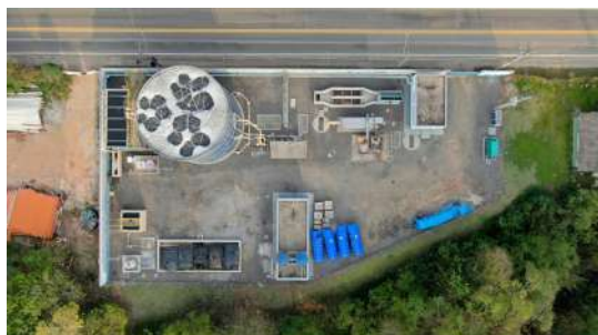
Foto 1 - Vista aérea do cercamento da ETE.
