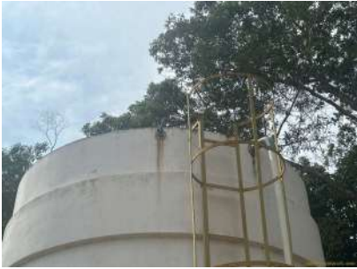
Foto 3 - Buzinote para saída de água de chuva do topo do reservatório.
