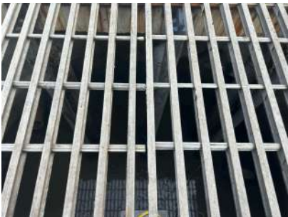
Foto 2 - Três bombas submersas que recalcam o efluente para o tratamento preliminar.
