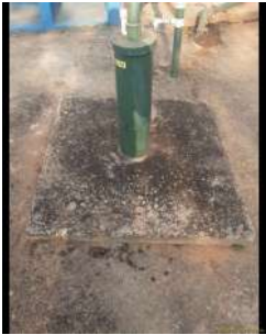
Foto 1 - Detalhe da laje de proteção do poço.
