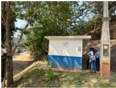
Foto 1 - A edificação está em área sem cercamento.
