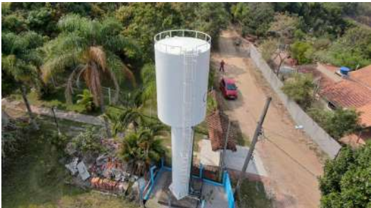
Foto 1 - Vista geral da escada e guarda-corpos do reservatório.
