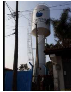
Foto 2 - Vista geral do reservatório a partir da via de acesso.
