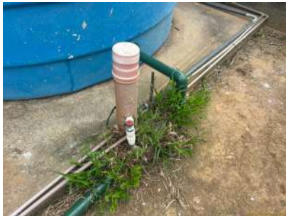
Foto 1 - Sensor de nível do sistema de telemetria.
