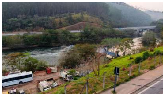
Foto 2 - Vista área do Rio Paraibuna à montante da captação.
