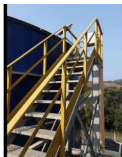
Foto 2 - Detalhe da escada e guarda-corpos próximo ao topo do reator biológico.
