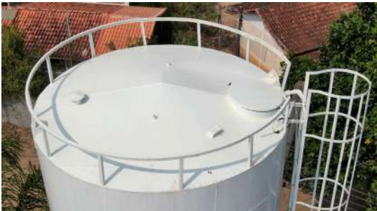
Foto 1 - Detalhe da tampa do reservatório.
