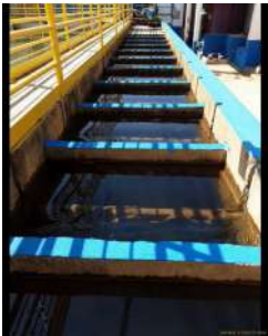
Foto 4 - Floculador hidráulico.
