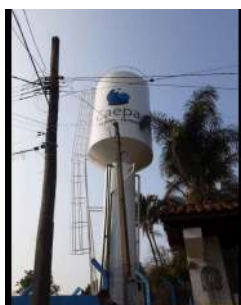
Foto 1 - O reservatório está identificado com o logo da empresa em ponto visível a partir da via de acesso.
