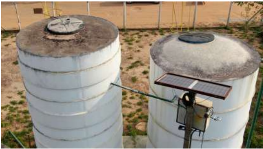
Foto 2 - Tampas de inspeção no topo dos reservatórios apoiados.
