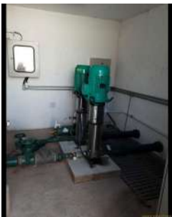
Foto 3 - Vista geral do interior da edificação.
