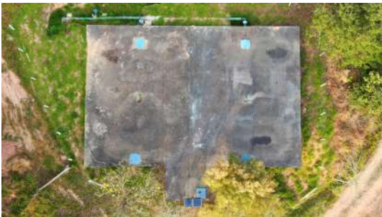
Foto 2 - Vista aérea do reservatório.
