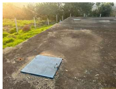
Foto 2 - Tampa de inspeção em boas condições.
