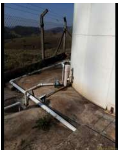
Foto 3 - Detalhe da tubulação do reservatório.
