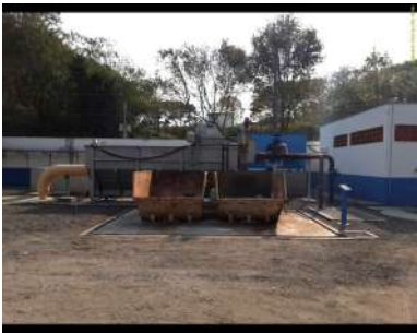
Foto 3 - Vista geral das estruturas do tratamento preliminar - destaque para caçambas de armazenamento de resíduos instaladas sobre pátio com canaletas de drenagem.
