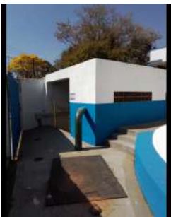
Foto 2 - Visão da elevatória e reservatório da ETA central, à direita.
