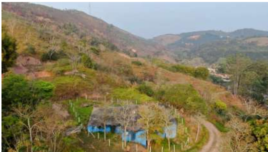
Foto 1 - Vista aérea do reservatório e entorno.
