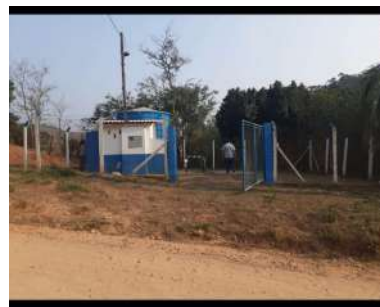
Foto 2 - Detalhe do portão de acesso à área.
