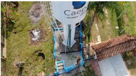
Foto 1 - Vista aérea do cercamento.
