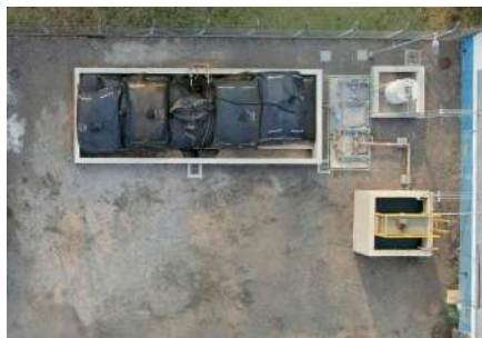
Foto 1 - Vista aérea das estruturas de tratamento de lodo.
