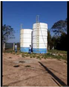
Foto 5 - Vista geral dos reservatórios apoiados.
