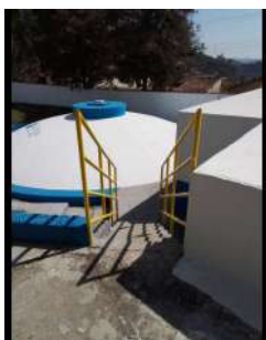
Foto 1 - Escada para acessar o reservatório.
