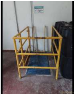
Foto 1 - Detalhe do guarda-corpos instalado ao redor da tampa do poço das bombas.
