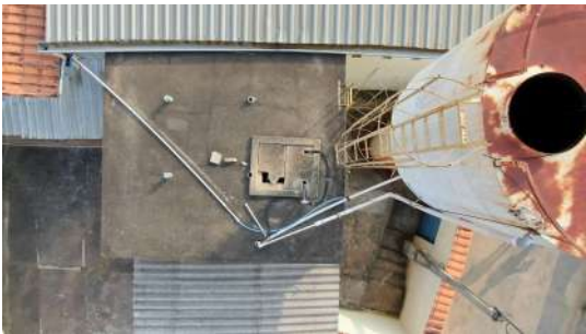
Foto 2 - Vista aérea do reservatório.
