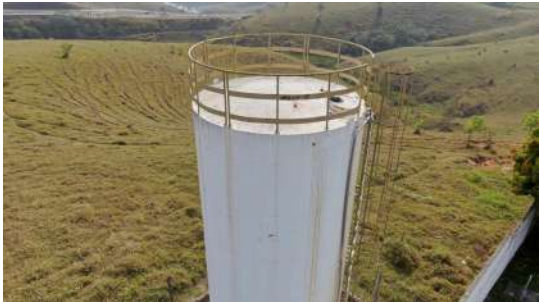
Foto 1 - Detalhe da escada e guarda-corpos no topo do reservatório.
