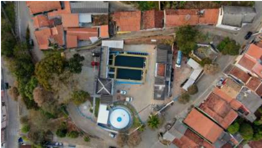
Foto 1 - Vista aérea do local e entorno evidenciando o cercamento da área da ETA e demais sistemas.
