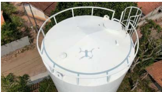
Foto 1 - Detalhe do tudo de ventilação no topo do reservatório (à esquerda na imagem).
