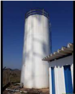
Foto 2 - Vista geral do reservatório.
