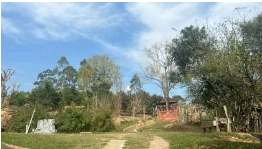
Foto 6 - Local onde está instalado o reservatório taça do Cedro (-23.5485573811411, -45.59794666518451).
