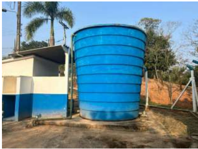
Foto 1 - Vista geral do reservatório.
