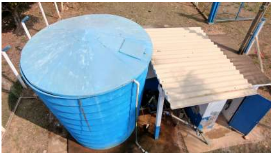
Foto 1 - Detalhe da tampa sem encaixe nas bordas do reservatório.
