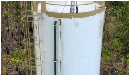
Foto 1 - Extravasor localizado próximo ao topo do reservatório.
