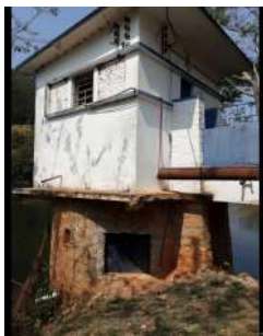
Foto 1 - O acesso às bombas para manutenção se dá através da abertura existente no piso inferior da casa de bombas.
