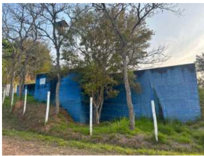
Foto 3 - Vista geral do reservatório.
