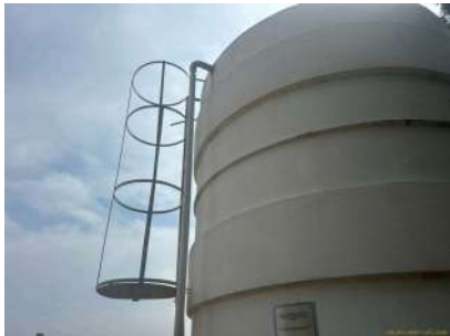
Foto 1 - Guarda-corpo para acesso ao topo do reservatório.
