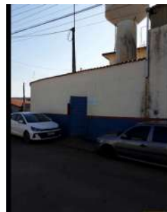
Foto 2 - Toda a área está cercada por muros.
