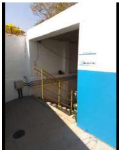
Foto 1 - Vista externa da elevatória.
