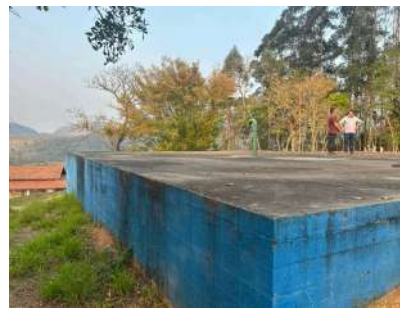
Foto 4 - Vista geral do reservatório.
