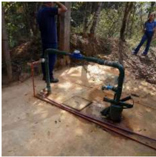
Foto 2 - Detalhe do cavalete do poço.
