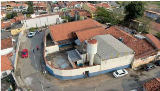
Foto 2 - Vista aérea do reservatório e entorno.
