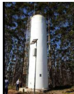
Foto 2 - Vista geral do reservatório.
