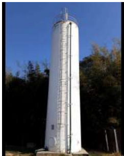
Foto 1 - Escada e guarda-corpos do reservatório elevado.
