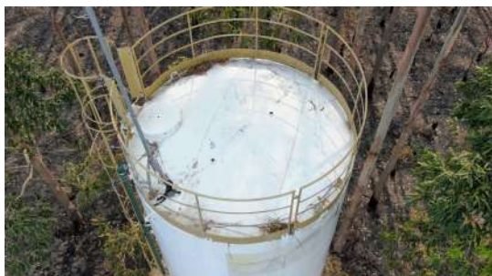
Foto 1 - Detalhe da tampa de inspeção no topo do reservatório.
