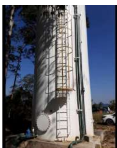
Foto 1 - Detalhe da escada e guarda-corpos próximo ao solo.
