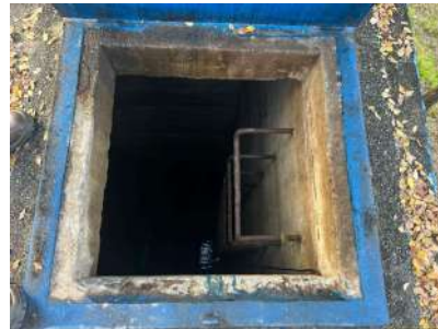
Foto 6 - Tampa de inspeção que dá acesso à câmara de válvulas e registros do reservatório.
