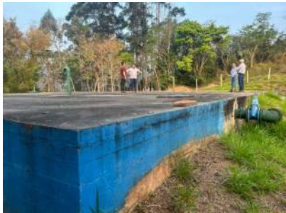
Foto 5 - Vista geral do reservatório.
