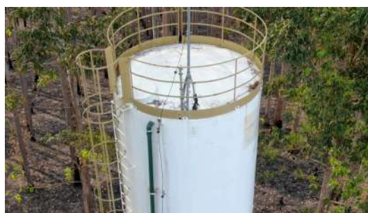
Foto 2 - Detalhe da escada e guarda-corpos próximo ao topo do reservatório.
