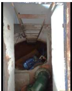
Foto 8 - Detalhe do interior do poço das bombas - piso inferior da casa de bombas.
