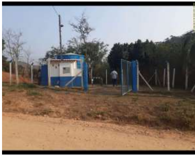
Foto 2 - Detalhe do portão de acesso à área.
