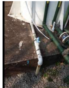
Foto 2 - Detalhe da saída do tubo extravasor próximo ao solo.
