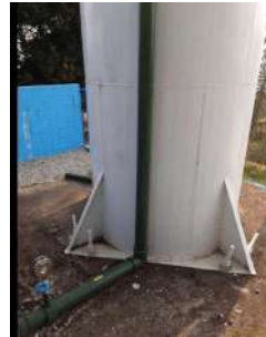
Foto 4 - Detalhe do dreno do reservatório.
