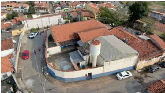
Foto 1 - Vista área do terreno onde está localizada a edificação que abriga a estação elevatória.
