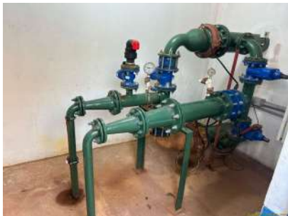
Foto 2 - Vista geral da estação elevatória.
