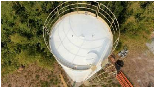
Foto 1 - Tampa de inspeção no topo do reservatório elevado.
