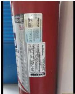
Foto 1 - Detalhe da etiqueta de controle de manutenções do extintor - dentro da validade.
