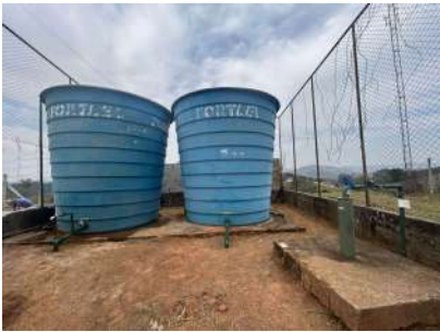
Foto 1 - Vista geral do reservatório.
