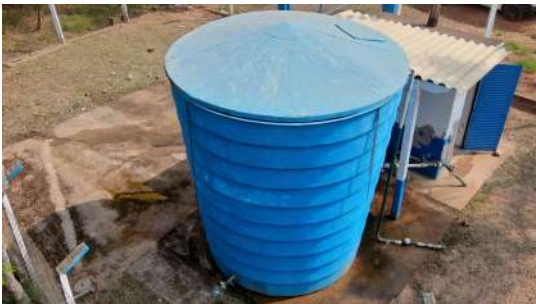
Foto 2 - Detalhe da tampa sem encaixe nas bordas do reservatório.
