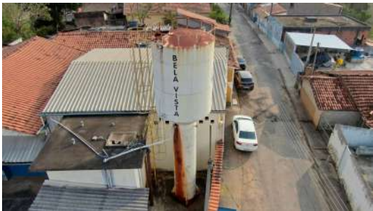
Foto 1 - Vista aérea do reservatório.
