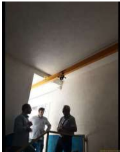
Foto 1 - Trilho utilizado para içamento das bombas para manutenção.
