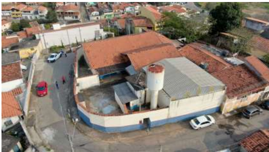
Foto 1 - Vista aérea da área do reservatório e entorno.
