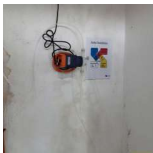
Foto 1 - Bomba dosadora de Ácido Fluossilícico.
