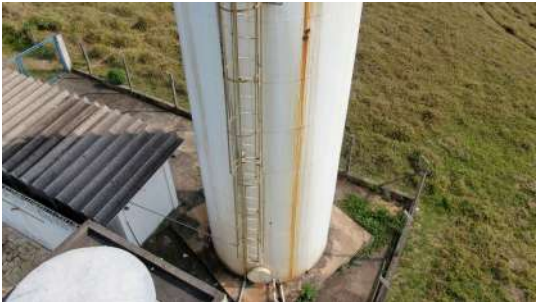
Foto 2 - Detalhe da escada e guarda-corpos no ponto médio do reservatório e próximo ao solo..
