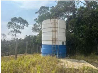
Foto 1 - Vista geral do reservatório. À direita, a base para alocar o reservatório taça do Cedro.
