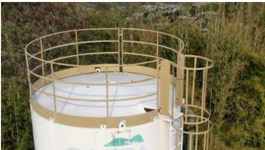
Foto 2 - Detalhe do guarda-corpos no topo do reservatório elevado.
