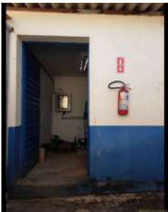
Foto 2 - Vista geral da edificação que abriga a elevatória.
