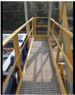
Foto 3 - Detalhe do guarda-corpos adjacente ao tanque de polimento.
