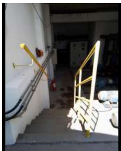
Foto 1 - Escada de acesso para a elevatória.
