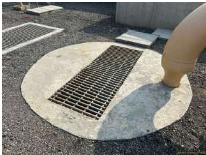
Foto 1 - Poço da elevatória.
