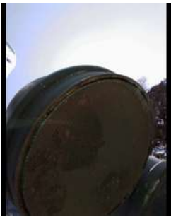
Foto 1 - Detalhe da tela de proteção no tubo de ventilação.
