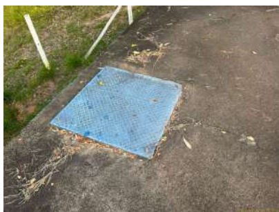
Foto 1 - Tampa de inspeção em boas condições.
