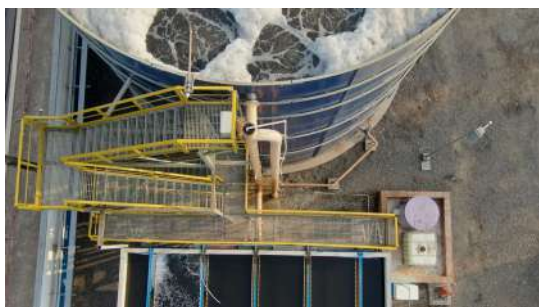
Foto 1 - Vista aérea das escadas e guarda-corpos no acesso ao reator biológico e tanque de polimento.
