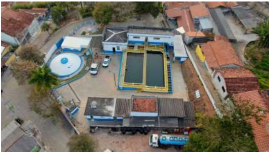
Foto 1 - Vista aérea dos sistemas e edificações.
