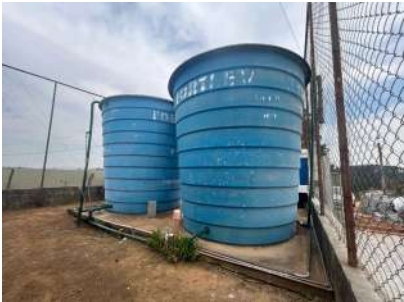
Foto 3 - Vista geral do reservatório.
