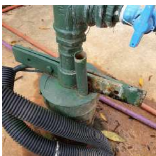
Foto 1 - Detalhe do tudo de medição de nível.
