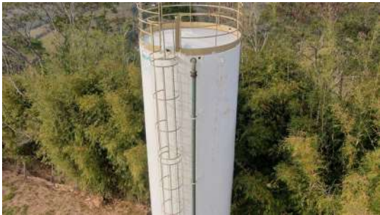
Foto 1 - Extravasor localizado próximo ao topo do reservatório.
