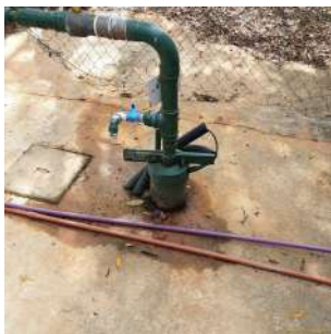
Foto 1 - Detalhe da laje de concreto.
