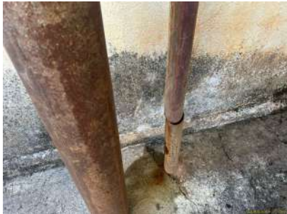
Foto 1 - Extravasor à direita, e entrada de água à esquerda
