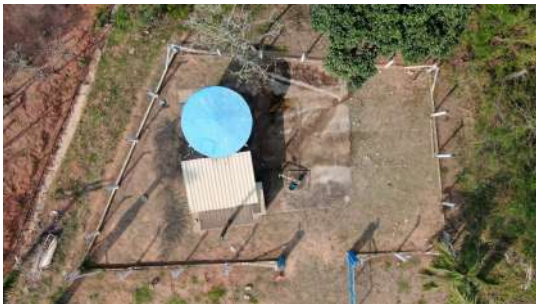
Foto 1 - Vista aérea do cercamento do terreno.
