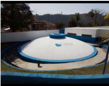
Foto 3 - Vista geral do reservatório.
