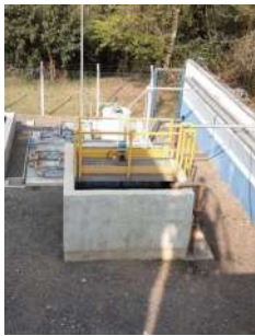
Foto 4 - Detalhe da escada e guarda-corpos no tanque de tratamento de lodo.
