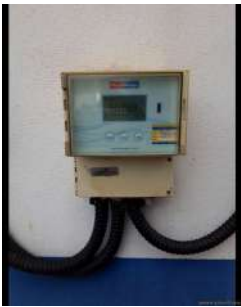
Foto 2 - Macromedidor de saída do efluente tratado.
