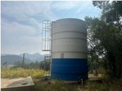
Foto 2 - Vista geral do reservatório.
