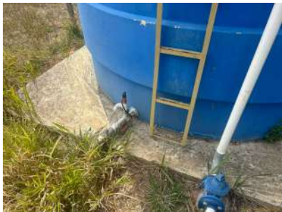
Foto 1 - Sensor de nível do sistema de telemetria.
