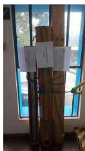
Foto 1 - Bomba reserva armazenada na ETA.
