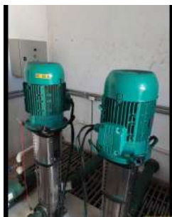
Foto 1 - Há duas bombas na estação, uma em funcionamento e a segunda como reserva.
