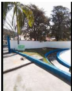
Foto 1 - Muro no perímetro da área da ETA e portão de acesso.
