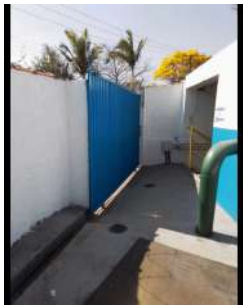
Foto 1 - Portão e muro próximo à elevatória.
