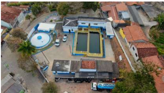
Foto 1 - Vista aérea dos sistemas e edificações.
