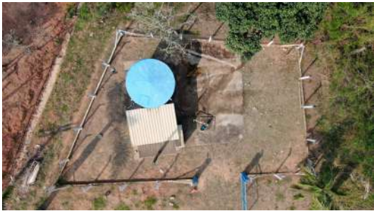
Foto 1 - Vista aérea do cercamento do terreno.
