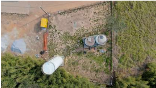
Foto 1 - Vista aérea do terreno evidenciando o cercamento de todo o perímetro da área.
