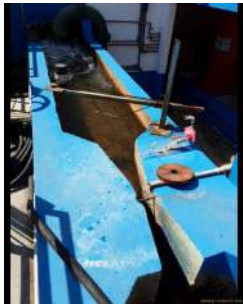
Foto 3 - Calha Parshall de entrada da água bruta. Próximo à tubulação de água bruta é realizada a pré-cloração. No centro da imagem está o macromedidor de entrada.
