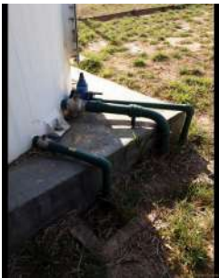
Foto 4 - Detalhe da tubulação de saída e dreno do reservatório elevado.
