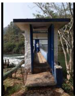
Foto 6 - Portão de acesso à casa de bombas.
