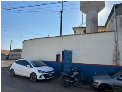
Foto 2 - Toda a área está cercada por muros.
