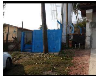
Foto 2 - Detalhe do portão de acesso para a área do reservatório.
