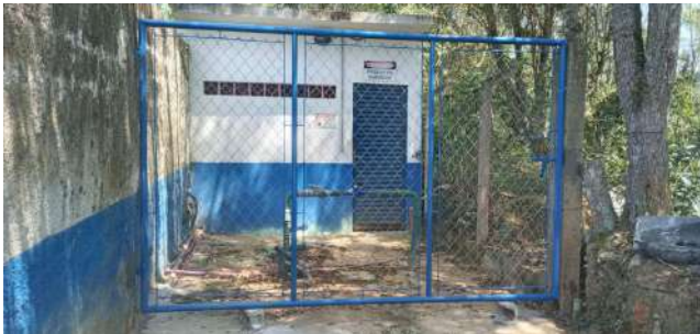
Foto 1 - As estruturas do poço e a edificação estão cercadas com alambrado.
