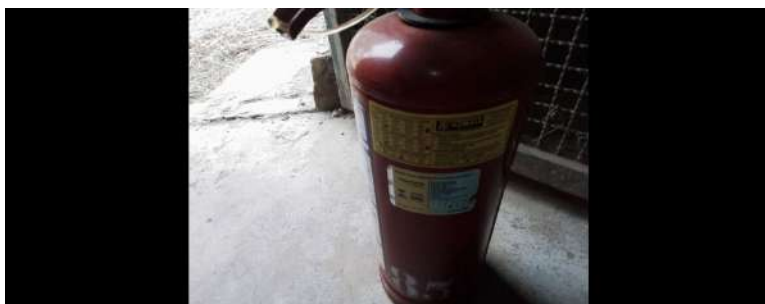
Foto 9 - Extintor de incêndio da Elevatória Estância Parque em Atibaia
