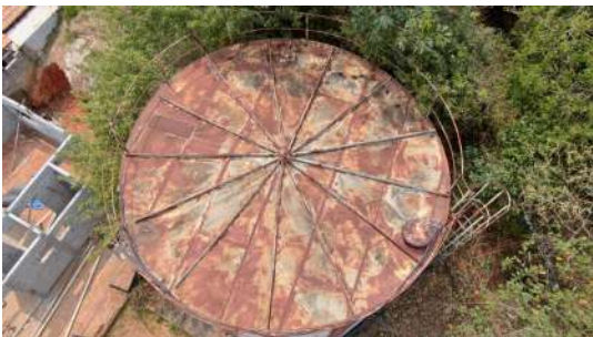
Foto 5 - Tampa de inspeção do Reservatório Bairro do Portão em Atibaia
