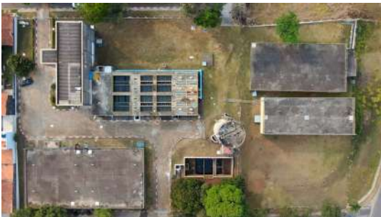
Foto 1 - Vista por drone do Reservatório Apoiado da ETA Cerejeiras em Atibaia
