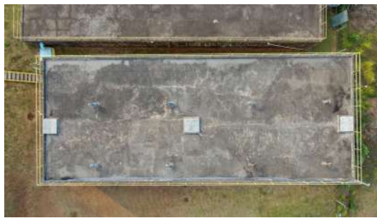
Foto 4 - Vista por drone do Reservatório Apoiado da ETA Cerejeiras em Atibaia
