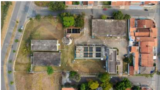
Foto 2 - Vista por drone do Reservatório Apoiado da ETA Cerejeiras em Atibaia
