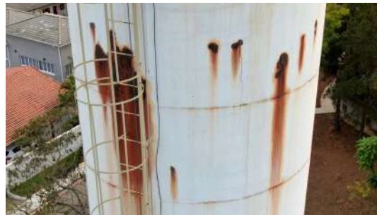
Foto 8 - Guarda-corpo do Reservatório Elevado São Felipe em Atibaia
