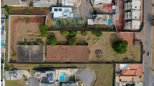
Foto 4 - Vista por drone do Reservatório Alvinópolis em Atibaia
