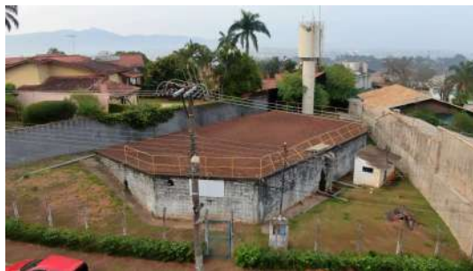
Foto 8 - Vista por drone do Reservatório elevado Maranguape (metálico) em Atibaia
