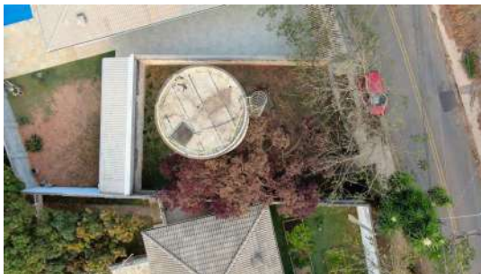
Foto 3 - Vista por drone do Reservatório Vale das Flores em Atibaia
