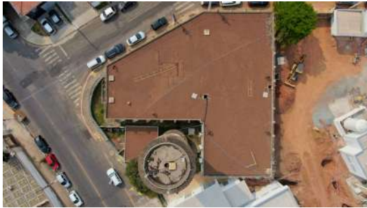
Foto 1 - Tampas de inspeção abertas do Reservatório Central da ETA I em Atibaia
