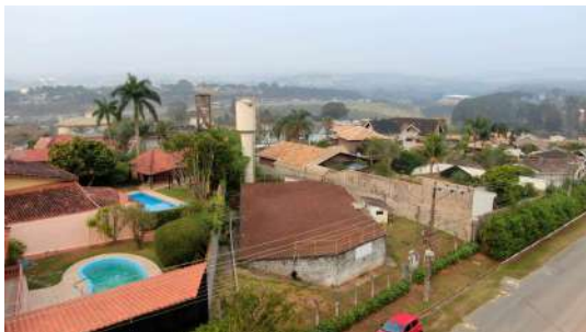
Foto 6 - À esquerda, vista por drone do Reservatório elevado Maranguape (concreto) em Atibaia
