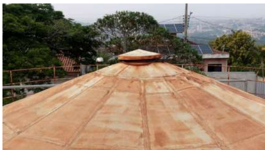
Foto 12 - Tubulação de ventilação do Reservatório Apoiado São Felipe em Atibaia
