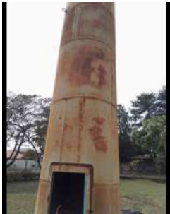
Foto 1 - Vista do Reservatório Elevado São Felipe em Atibaia
