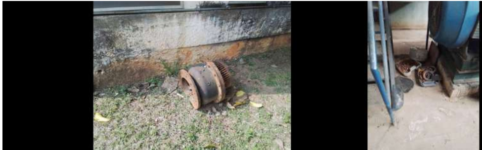
Foto 1 - Materiais dispersos na Captação Rio Atibaia (NOVA) em Atibaia
