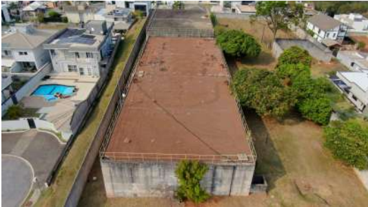
Foto 1 - Vista por drone do Reservatório Alvinópolis em Atibaia
