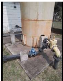
Foto 5 - Reservatório Elevado São Felipe em Atibaia
