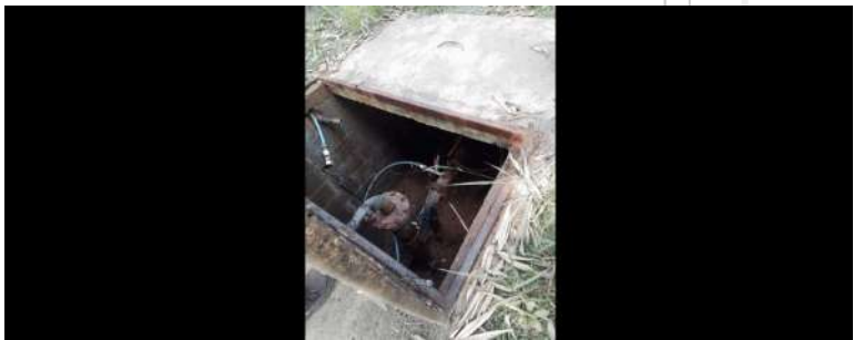
Foto 5 - Elevatória de água Brogotá em Atibaia
