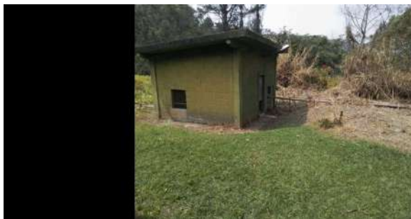
Foto 1 - Vista da Elevatória Estância Parque em Atibaia
