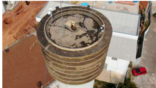
Foto 4 - Tampa de inspeção do Reservatório Central da ETA I em Atibaia
