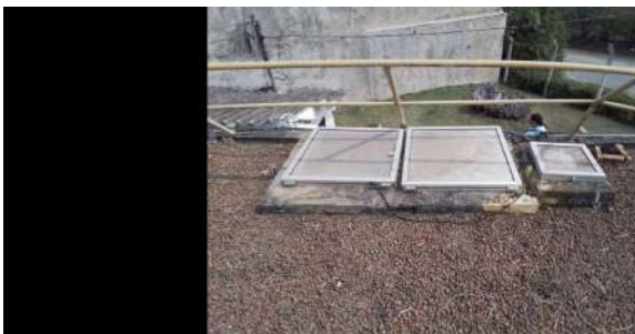
Foto 5 - Tampas de inspeção do Reservatório Semienterrado Maranguape em Atibaia
