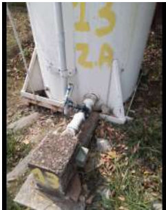
Foto 3 - Reservatório elevado Maranguape (metálico) em Atibaia
