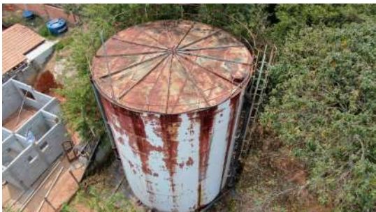
Foto 6 - Guarda-corpos do Reservatório Bairro do Portão em Atibaia
