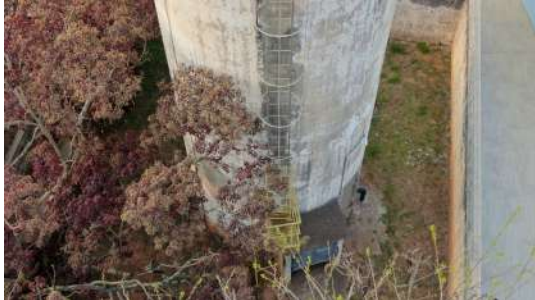
Foto 1 - Vista por drone do Reservatório Vale das Flores em Atibaia
