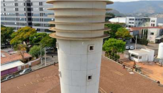
Foto 1 - Vista por drone do Reservatório Central da ETA I em Atibaia
