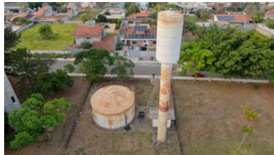
Foto 10 - Vista por drone do Reservatório Elevado São Felipe em Atibaia
