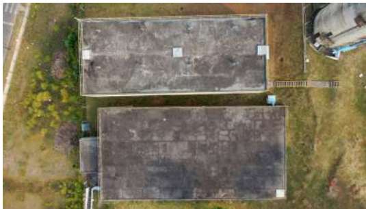
Foto 5 - Tampas de inspeção do Reservatório Apoiado da ETA Cerejeiras em Atibaia
