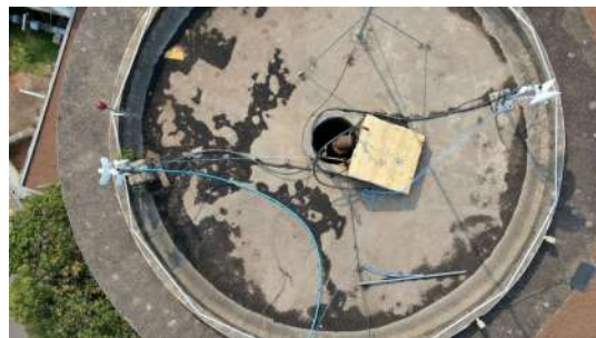
Foto 6 - Tampa de inspeção do Reservatório Central da ETA I em Atibaia
