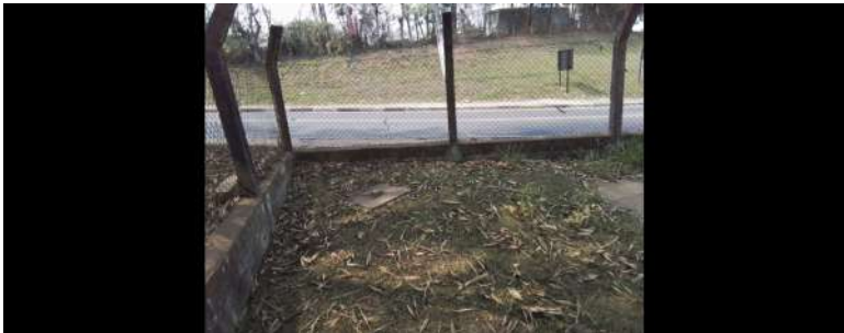
Foto 1 - Ausência de limpeza na Elevatória de água Brogotá em Atibaia
