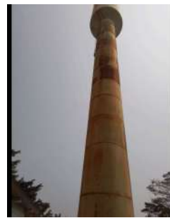
Foto 6 - Vista do Reservatório Elevado São Felipe em Atibaia
