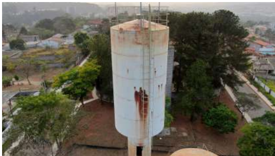
Foto 9 - Guarda-corpo do Reservatório Elevado São Felipe em Atibaia
