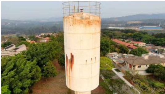
Foto 7 - Vista por drone do Reservatório Elevado São Felipe em Atibaia
