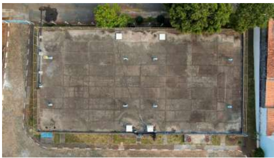
Foto 3 - Vista por drone do Reservatório Apoiado da ETA Cerejeiras em Atibaia
