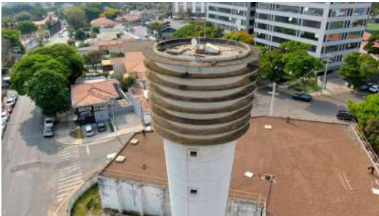
Foto 3 - Vista por drone do Reservatório Central da ETA I em Atibaia
