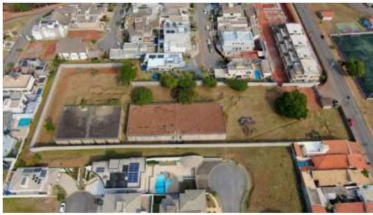
Foto 5 - Vista por drone do Reservatório Alvinópolis em Atibaia
