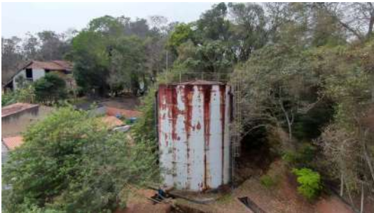
Foto 1 - Vista por drone do Reservatório Bairro do Portão em Atibaia
