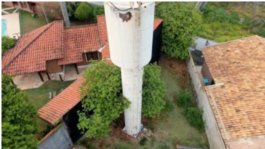
Foto 6 - Guarda-corpo do Reservatório elevado Maranguape (metálico) em Atibaia
