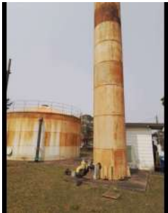
Foto 4 - Vista do Reservatório Elevado São Felipe em Atibaia
