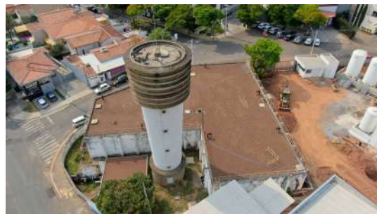
Foto 8 - Vista por drone do Reservatório Central da ETA I em Atibaia
