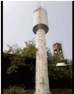
Foto 1 - Reservatório elevado Maranguape (metálico) em Atibaia
