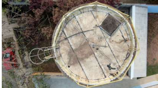
Foto 2 - Vista por drone do Reservatório Vale das Flores em Atibaia
