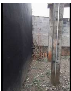
Foto 4 - Reservatório elevado Maranguape (concreto) em Atibaia
