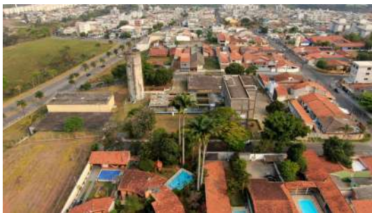
Foto 8 - Vista por drone do Reservatório Elevado da ETA Cerejeiras em Atibaia
