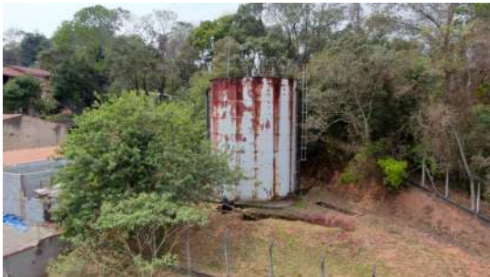
Foto 4 - Vista por drone do Reservatório Bairro do Portão em Atibaia
