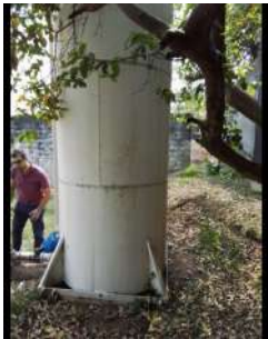
Foto 4 - Reservatório elevado Maranguape (metálico) em Atibaia
