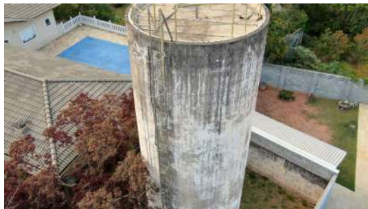
Foto 4 - Vista por drone do Reservatório Vale das Flores em Atibaia
