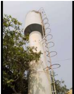
Foto 5 - Guarda-corpo do Reservatório elevado Maranguape (metálico) em Atibaia
