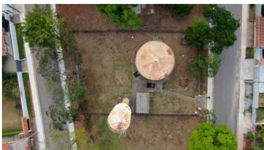
Foto 11 - Vista por drone do Reservatório Elevado São Felipe em Atibaia
