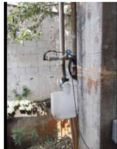
Foto 2 - Medição de nível no Reservatório elevado Maranguape (concreto) em Atibaia
