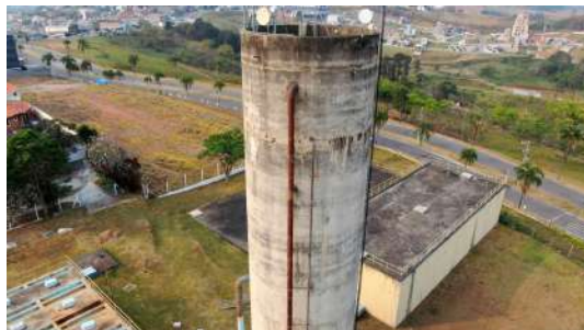
Foto 2 - Vista por drone do Reservatório Elevado da ETA Cerejeiras em Atibaia
