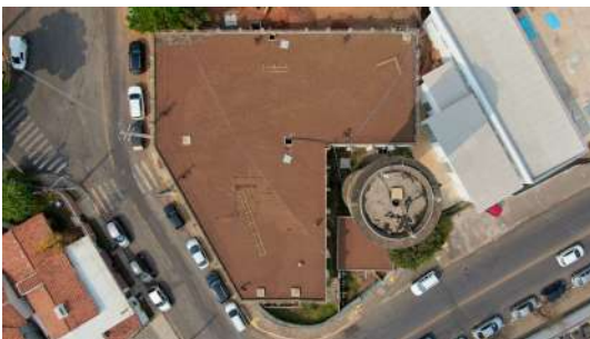
Foto 7 - Vista por drone do Reservatório Central da ETA I em Atibaia
