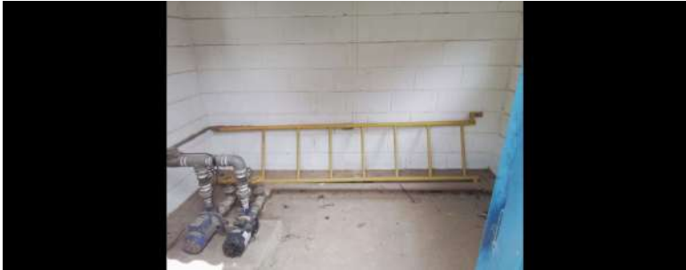
Foto 1 - Escada armazenada no local da Elevatória de Água Maranguape em Atibaia
