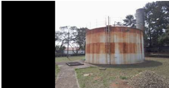
Foto 3 - Vista do Reservatório Apoiado São Felipe em Atibaia
