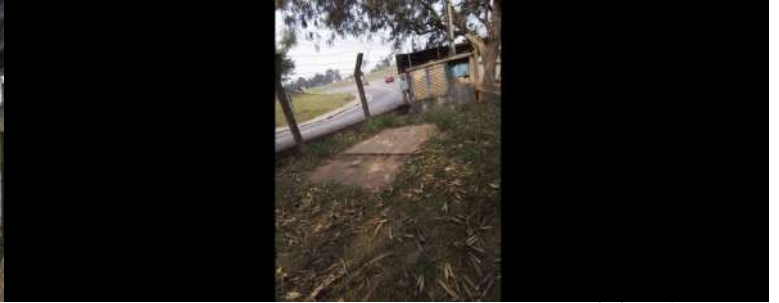
Foto 2 - Elevatória de água Brogotá em Atibaia
