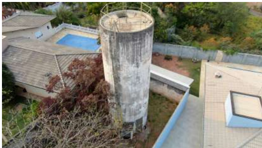
Foto 5 - Vista por drone do Reservatório Vale das Flores em Atibaia
