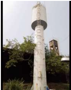
Foto 2 - Reservatório elevado Maranguape (metálico) em Atibaia
