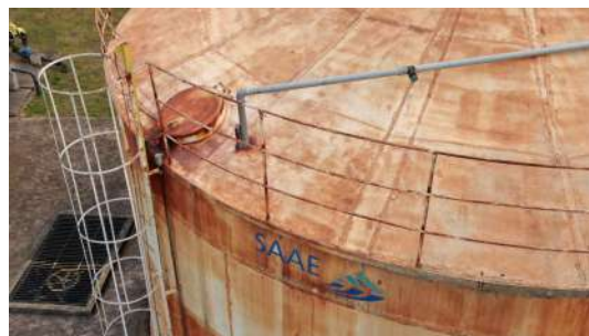
Foto 13 - Tampa de inspeção do Reservatório Apoiado São Felipe em Atibaia
