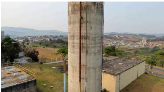
Foto 1 - Vista por drone do Reservatório Elevado da ETA Cerejeiras em Atibaia
