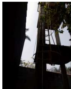
Foto 3 - Reservatório elevado Maranguape (concreto) em Atibaia
