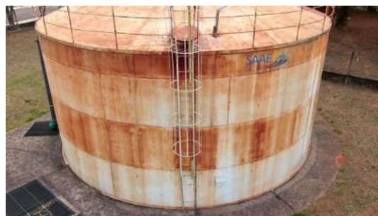
Foto 11 - Guarda-corpo do Reservatório Apoiado São Felipe em Atibaia
