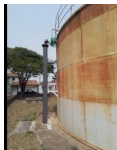
Foto 7 - Reservatório Apoiado São Felipe em Atibaia
