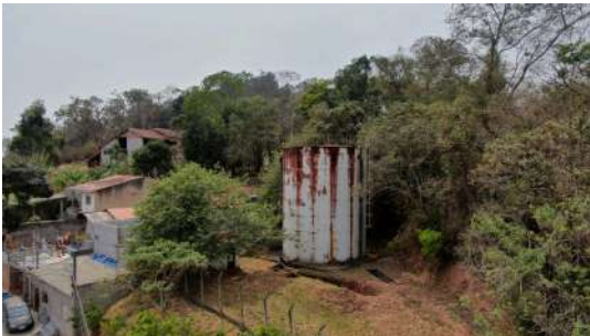
Foto 3 - Vista por drone do Reservatório Bairro do Portão em Atibaia
