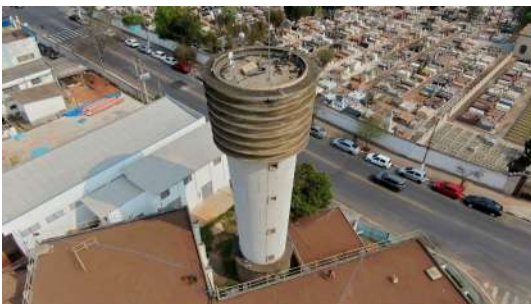
Foto 5 - Vista por drone do Reservatório Central da ETA I em Atibaia
