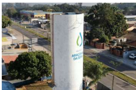
Foto 1 - Tubo extravasor instalado ao lado da escada.
