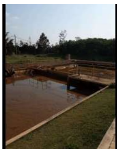
Foto 1 - Tanques que recebem a água proveniente das descargas dos decantadores e lavagem dos filtros.
