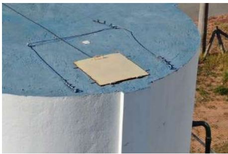
Foto 1 - Detalhe da tampa de inspeção no topo do reservatório.
