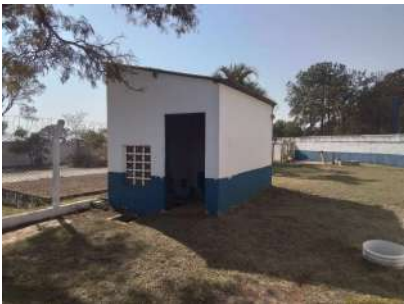
Foto 3 - Vista geral da edificação que abriga a elevatória.
