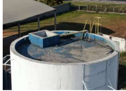
Foto 2 - Detalhe do topo do reservatório sem a haste do para-raios.
