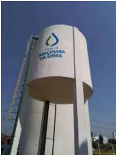
Foto 2 - Vista geral do reservatório elevado.
