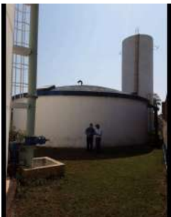
Foto 3 - Vista geral do reservatório semi enterrado.
