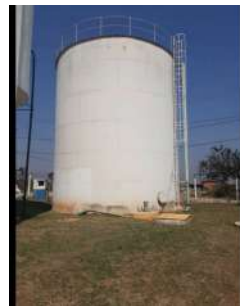
Foto 2 - Vista geral do reservatório.
