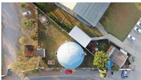
Foto 1 - Vista aérea do cercamento do terreno.
