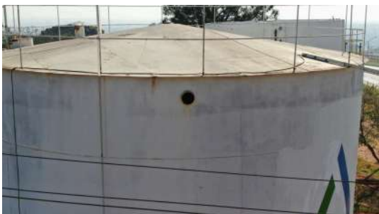
Foto 1 - Detalhe do extravasor próximo ao topo do reservatório.
