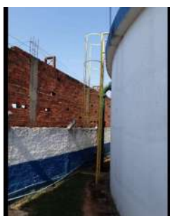
Foto 1 - Escada e guarda-corpos do reservatório semi enterrado.
