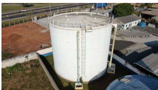
Foto 3 - Escada e guarda-corpos do reservatório apoiado.
