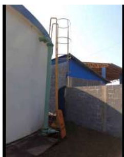
Foto 1 - Detalhe da escada com guarda-corpos.
