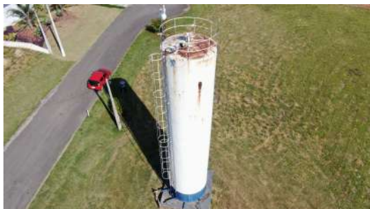
Foto 1 - Vista geral da escada e guarda-corpos do reservatório.
