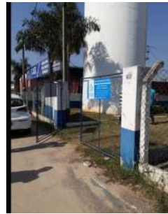
Foto 2 - Detalhe do portão de acesso à área.
