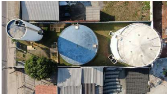
Foto 1 - Vista aérea do sistema mostrando o cercamento da área por muros.
