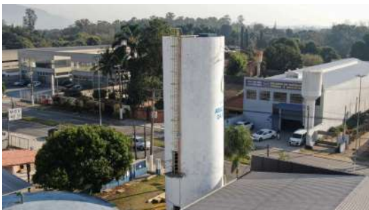
Foto 1 - Escada e guarda-corpos para acesso ao topo do reservatório.
