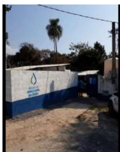
Foto 1 - Cercamento da captação por muros.
