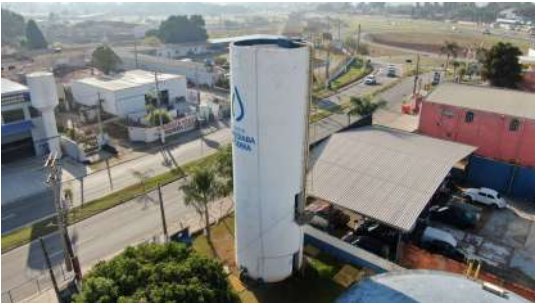
Foto 2 - Vista geral do Reservatório Tonelli Elevado.
