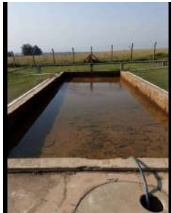
Foto 9 - Detalhe do leito de secagem 3.
