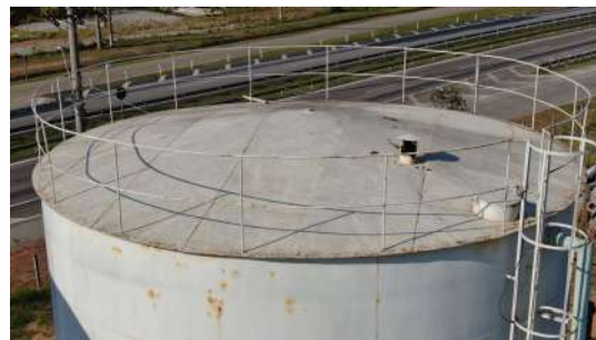
Foto 2 - Detalhe do guarda-corpos no topo do reservatório.
