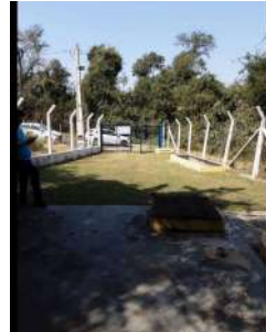
Foto 4 - Vista geral da estação elevatória.
