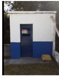
Foto 2 - Edificação que abriga o painel elétrico.
