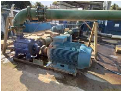
Foto 1 - Vista geral da estação elevatória de água bruta.
