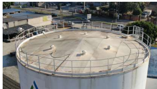
Foto 2 - Tubos de ventilação no topo do reservatório apoiado.
