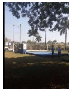
Foto 2 - Vista geral da estação elevatória.
