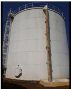
Foto 4 - Vista geral do reservatório apoiado.
