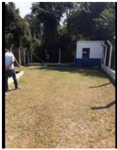
Foto 1 - Vista geral da estação elevatória.
