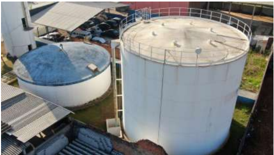
Foto 2 - Vista geral dos reservatórios.
