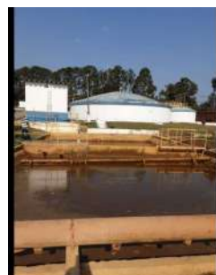
Foto 2 - Tanques que recebem a água proveniente das descargas dos decantadores e lavagem dos filtros.
