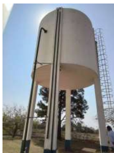
Foto 1 - Detalhe do tubo extravasor.
