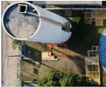
Foto 1 - Localização do ponto onde se encontra o vazamento (em vermelho).
