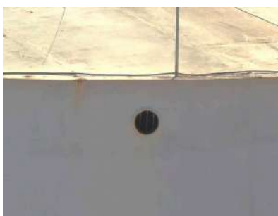
Foto 1 - Proteção na abertura do extravasor.
