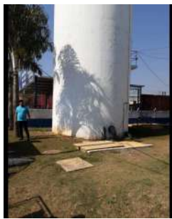
Foto 3 - Base e entorno do reservatório.
