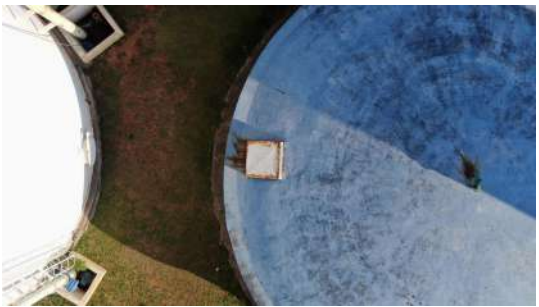
Foto 2 - Detalhe da segunda tampa de inspeção do reservatório semi enterrado.
