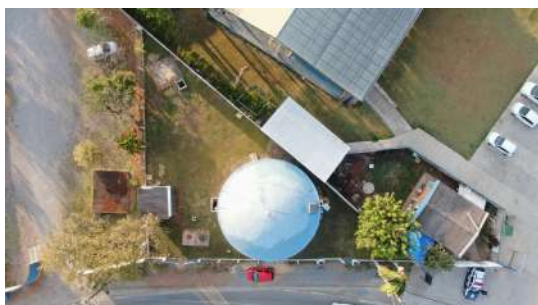
Foto 1 - Vista aérea do cercamento do terreno.
