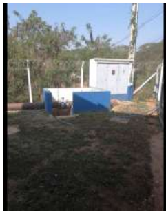
Foto 4 - Vista geral do pátio da elevatória, no centro, muretas de proteção da tubulação de saída do efluente.
