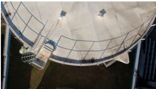
Foto 3 - Detalhe da tampa de inspeção do reservatório apoiado.
