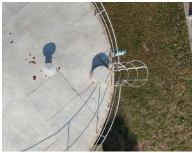
Foto 1 - Detalhe da tampa de inspeção no topo do reservatório.
