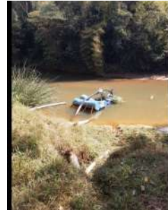
Foto 4 - Detalhe da estrutura de bombeamento da captação.
