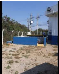
Foto 2 - Vista geral do pátio da elevatória, no centro, muretas de proteção da tubulação de saída das bombas.
