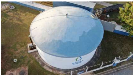
Foto 1 - Vista geral do tubo de ventilação no centro do reservatório.
