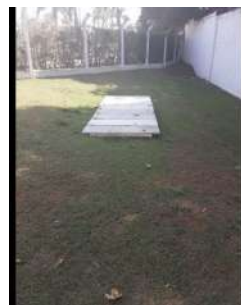
Foto 4 - Detalhe do ponto de chegada do esgoto bruto, protegido com placas de concreto.
