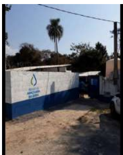
Foto 1 - Cercamento da captação por muros.
