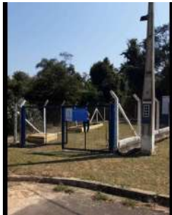
Foto 1 - Vista do portão de acesso à estação elevatória a partir da Rua Toiojiro Koyama.
