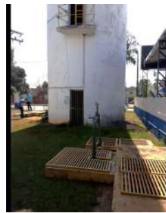
Foto 4 - Base e entorno do reservatório.
