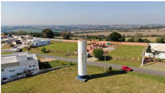
Foto 1 - Vista geral do reservatório e entorno.
