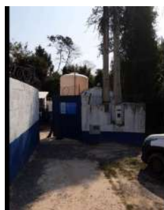
Foto 2 - Portão de acesso à área.
