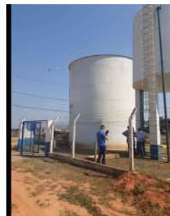
Foto 2 - Detalhe do cercamento e portão de acesso à área.
