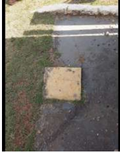
Foto 1 - Detalhe da caixa de concreto indicada como o ponto de aterramento do para-raios.
