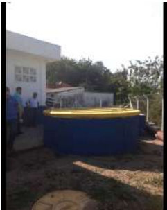
Foto 1 - Vista geral do pátio da elevatória, no centro, o poço de bombeamento do efluente, à esquerda, a edificação que abriga o gerador e os painéis elétricos da estação.
