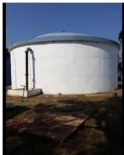
Foto 3 - Vista geral do Reservatório Araçoiabinha.
