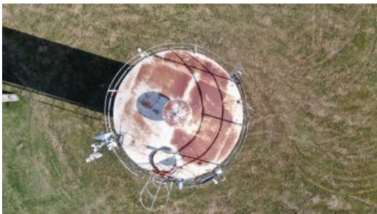
Foto 1 - Detalhe da tampa de inspeção do reservatório.
