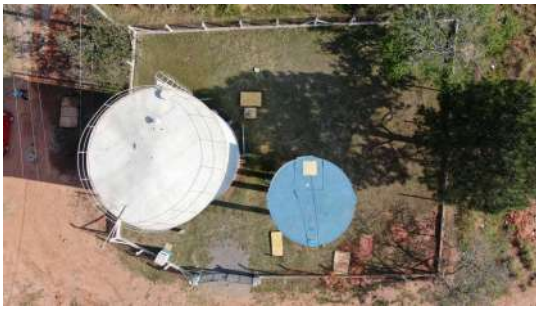
Foto 1 - Vista aérea do sistema mostrando o cercamento da área por alambrados.
