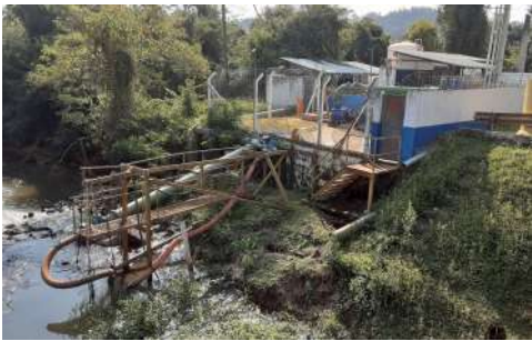
Foto 1 - Vista geral da Captação Piraporão.
