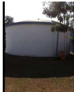
Foto 4 - Vista geral do Reservatório Araçoiabinha.
