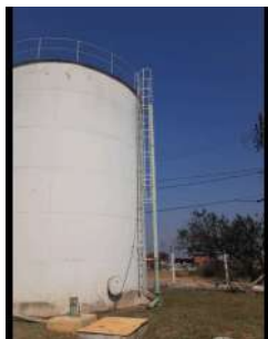
Foto 1 - Escada e guarda-corpos.
