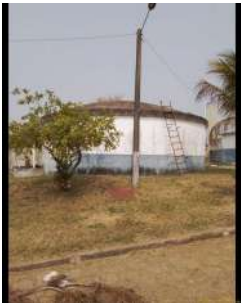
Foto 1 - Visão geral do reservatório.
