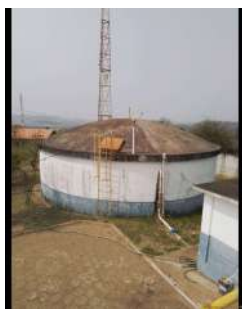
Foto 5 - Visão do reservatório circular a partir do reservatório apoiado.
