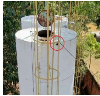
Foto 2 - Extravasor em destaque.
