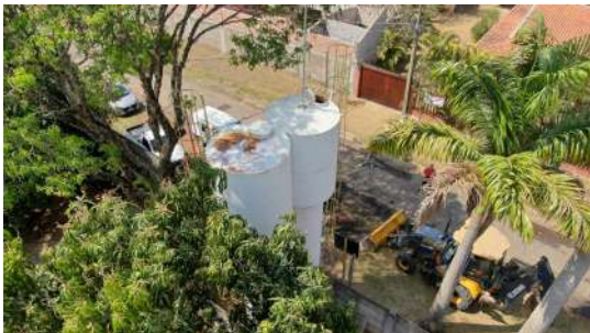
Foto 1 - Manutenção sendo realizada no local.
