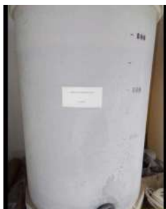
Foto 1 - Tanque para armazenamento de flúor.
