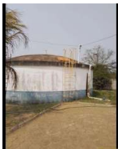
Foto 1 - Escada de acesso para inspeção.
