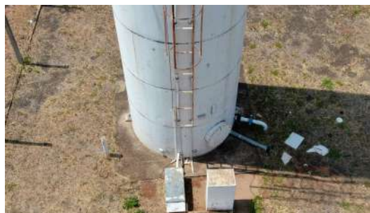
Foto 4 - Aterramento do para-raios.
