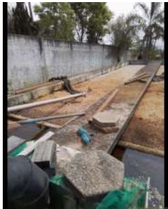
Foto 2 - Filtro dinâmico utilizado para pré-filtração.
