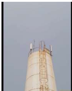
Foto 1 - Para-raios do reservatório elevado.
