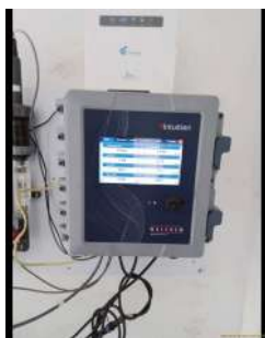
Foto 7 - Equipamento para leitura dos dados coletados pelos sensores.
