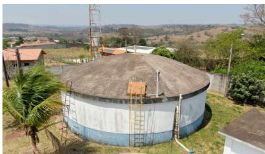
Foto 6 - Imagem aérea do reservatório, obtida por drone.
