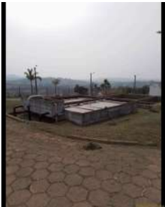
Foto 1 - Visão dos filtros da ETA.
