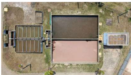
Foto 15 - Imagem aérea da ETA exibindo os filtros ascendentes, os filtros lentos e a construção que abriga a casa de química e e elevatória.
