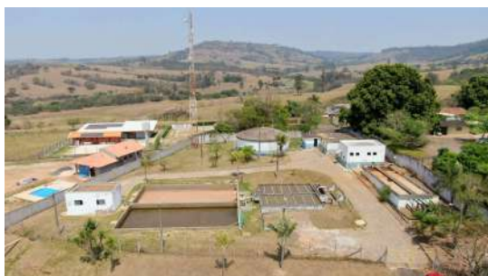
Foto 14 - Imagem aérea da ETA obtida com drone.
