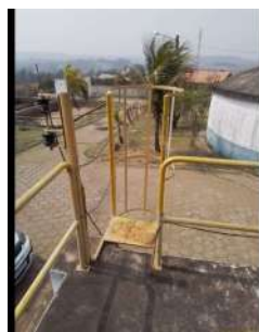
Foto 2 - Escada com guarda-corpo.
