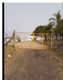
Foto 2 - Cercamento da área.
