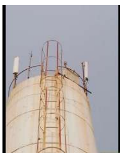
Foto 1 - Extravasor no topo do reservatório.
