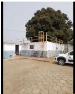
Foto 1 - Visão geral do reservatório.
