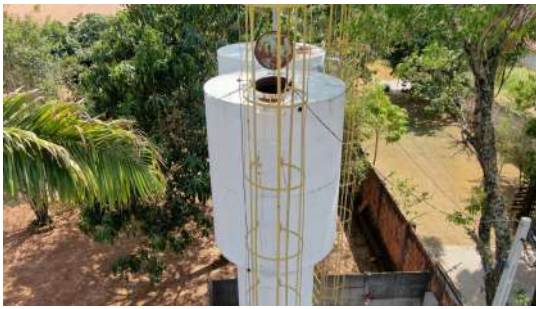
Foto 1 - Escada de um dos reservatórios.
