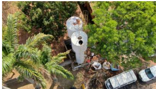
Foto 2 - Manutenção sendo realizada no local.
