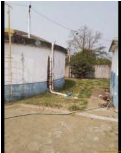
Foto 4 - Extravasor do reservatório circular ligado ao reservatório retangular apoiado.
