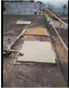
Foto 1 - Tampas de inspeção do reservatório.
