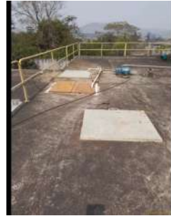
Foto 2 - Tampas de inspeção do reservatório.
