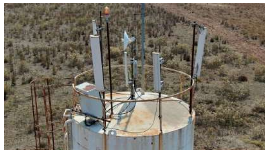
Foto 2 - Guarda-corpo na cobertura do reservatório.
