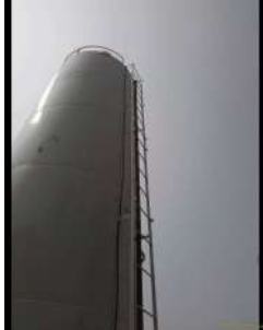
Foto 5 - Visão geral do reservatório.
