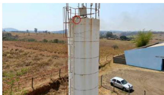
Foto 2 - Extravasor em destaque na imagem.
