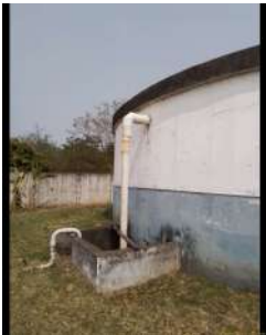
Foto 2 - Alimentação do reservatório.
