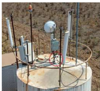
Foto 1 - Ventilação na cobertura do reservatório.
