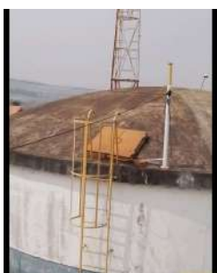
Foto 1 - Tampa de inspeção em boas condições.
