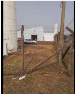
Foto 1 - Cerca no perímetro da área.
