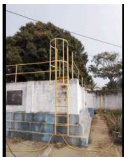
Foto 1 - Escada com guarda-corpo.
