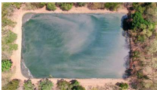
Foto 5 - Imagem aérea da ETE obtida com drone.
