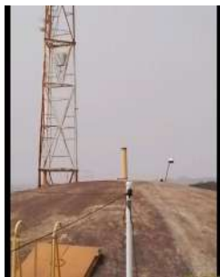
Foto 1 - Tubo de ventilação.
