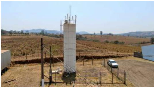
Foto 3 - Imagem do reservatório obtida com drone.
