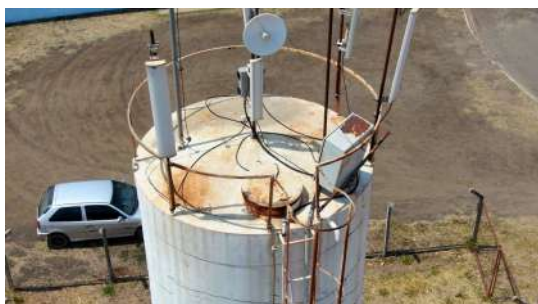
Foto 1 - Tampa de inspeção na cobertura.
