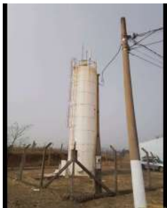
Foto 1 - Visão geral do reservatório.
