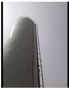
Foto 1 - Escada com guarda-corpos.
