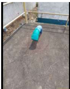
Foto 1 - Tubo de ventilação na cobertura.
