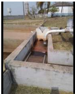
Foto 7 - Saída do filtro ascendente para entrar no filtro lento.
