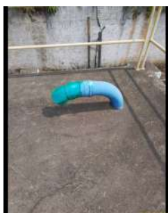
Foto 1 - Tela de proteção no tubo de ventilação.
