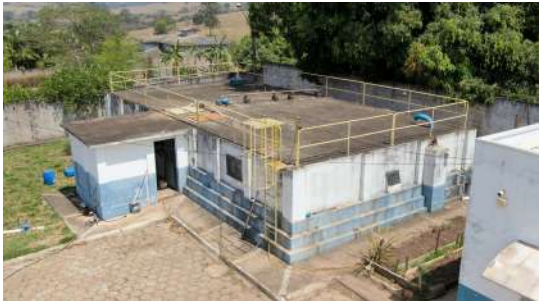
Foto 3 - Imagem do reservatório obtida com drone.
