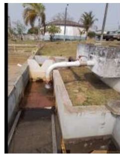
Foto 6 - Saída do filtro ascendente para entrar no filtro lento.
