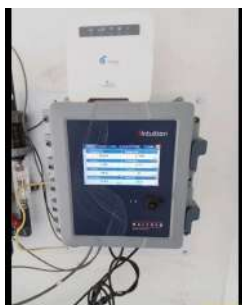
Foto 11 - Equipamento para leitura dos dados coletados pelos sensores.
