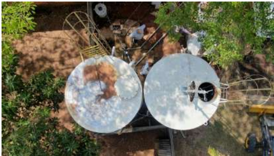
Foto 1 - Para-raios no reservatório da direita.
