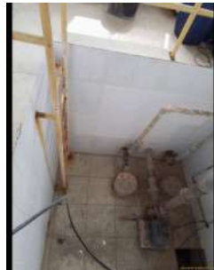
Foto 2 - Escada para acessar a bomba.
