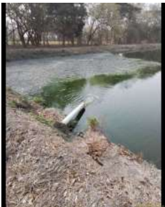
Foto 3 - Entrada do efluente na lagoa de estabilização.
