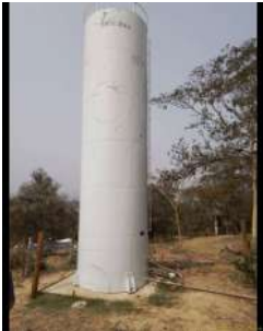
Foto 1 - Visão geral do reservatório.
