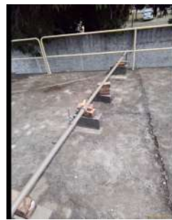
Foto 2 - Tubulação de recalque.
