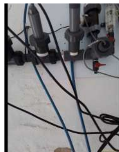
Foto 10 - Sensores que analisam os parâmetros de qualidade da água.
