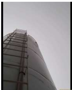
Foto 1 - Extravasor do reservatório.
