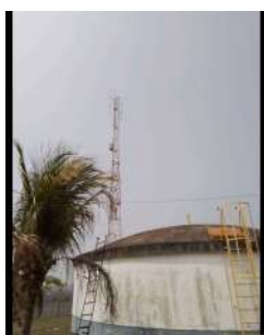
Foto 1 - Antena de telefonia ao lado na área da ETA.
