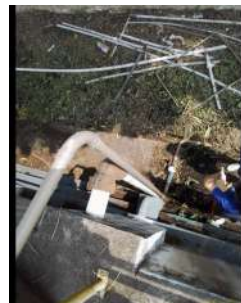
Foto 3 - Tubulação de recalque.
