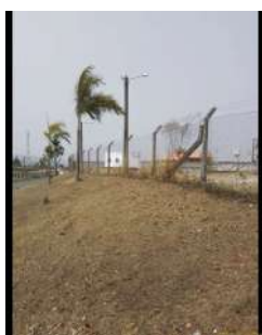
Foto 1 - Cercamento da área.
