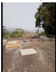
Foto 3 - Guarda-corpo na cobertura do reservatório.
