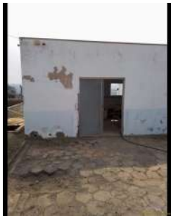
Foto 2 - Construção que abriga a casa de química e a elevatória.
