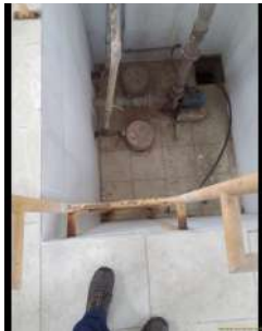
Foto 1 - Escada para acessar a bomba.
