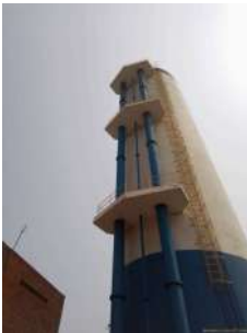
Foto 2 - Descida do extravasor.
