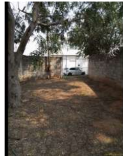
Foto 2 - Muro no perímetro do terreno.
