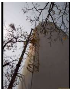
Foto 1 - Escada externa do reservatório.
