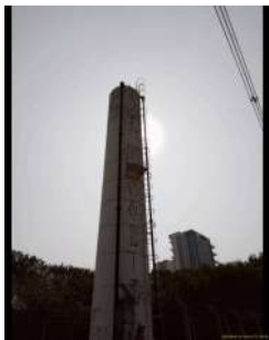
Foto 1 - Escada externa do reservatório.
