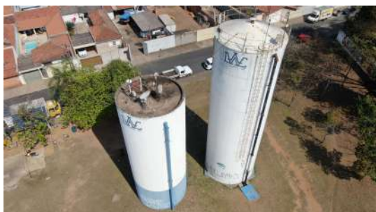
Foto 5 - Imagem aérea dos reservatório Jardim Palmeiras: elevado de concreto à esquerda e elevado metálico à direita.
