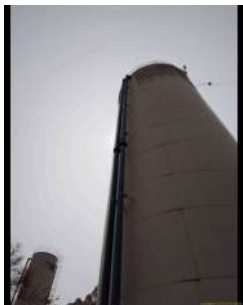
Foto 1 - Descida do extravasor.
