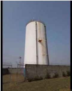
Foto 1 - Visão geral do reservatório.
