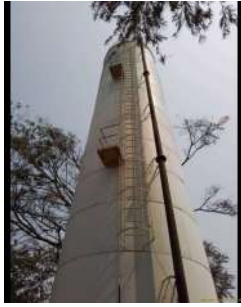
Foto 1 - Escada externa do reservatório.
