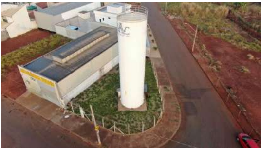
Foto 4 - Imagem aérea do reservatório obtida com drone.
