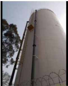
Foto 3 - Alimentação do reservatório.
