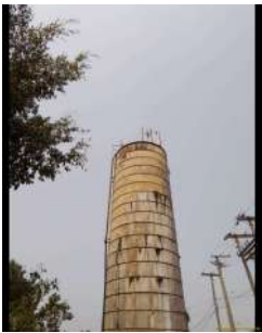
Foto 1 - Para-raios na cobertura do reservatório.
