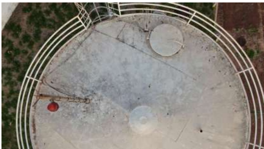
Foto 1 - Tampa de inspeção em boas condições.
