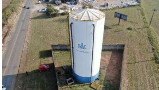
Foto 7 - Imagem aérea do reservatório obtida com drone.
