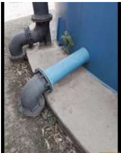
Foto 5 - Saída do reservatório.
