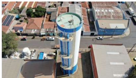
Foto 2 - Escada externa do reservatório.
