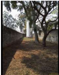
Foto 1 - Muro no perímetro do terreno.
