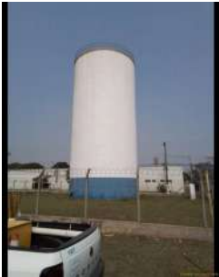
Foto 1 - Visão geral do reservatório.
