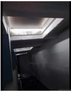
Foto 2 - Alçapão para içamento das bombas.
