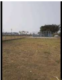
Foto 2 - Cerca no perímetro da área.
