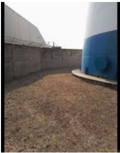
Foto 2 - Muro no perímetro do terreno.
