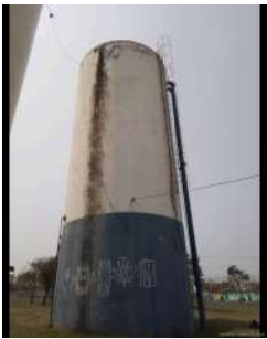
Foto 1 - Visão geral do reservatório.
