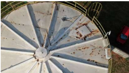
Foto 1 - Tampa de inspeção da cobertura do reservatório. Apesar de haver pontos de corrosão na cobertura, a tampa está íntegra.
