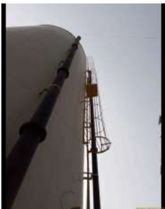
Foto 1 - Escada externa do reservatório.
