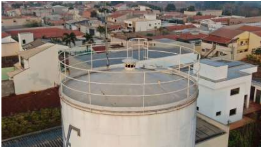
Foto 1 - Chaminé de ventilação na cobertura.
