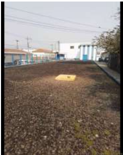
Foto 1 - Tampa de inspeção de concreto em boas condições.
