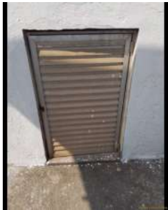
Foto 1 - Porta para inspeção interna de um dos reservatórios.
