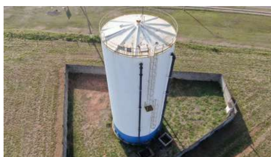
Foto 2 - Escada externa do reservatório.
