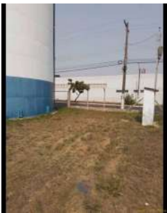
Foto 1 - Cerca no perímetro da área.
