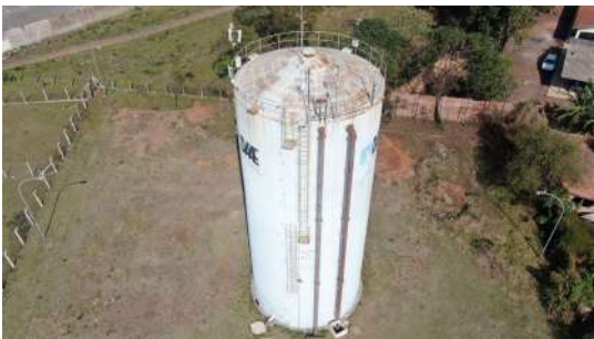
Foto 2 - Escada externa do reservatório.
