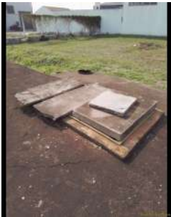
Foto 1 - Tampas de concreto no reservatório.
