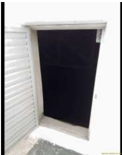
Foto 4 - Abertura para acesso ao interior do reservatório.
