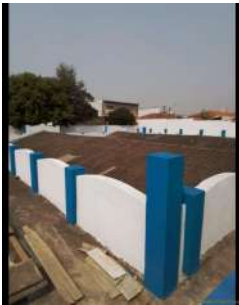
Foto 2 - Visão geral dos reservatórios semienterrados.
