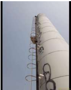
Foto 3 - Alimentação do reservatório.
