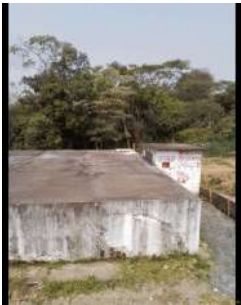
Foto 1 - Tampa de inspeção em boas condições.
