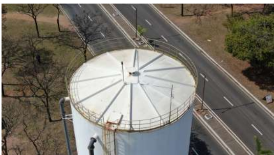
Foto 1 - Tampa de inspeção em boas condições.
