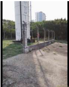
Foto 2 - Ausência de cerca ou muro.
