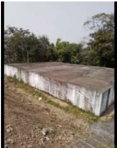
Foto 3 - Visão geral do reservatório.
