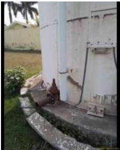
Foto 1 - Extravasor do reservatório.
