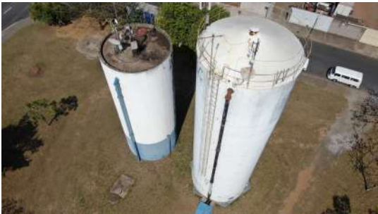
Foto 2 - Escada externa do reservatório.
