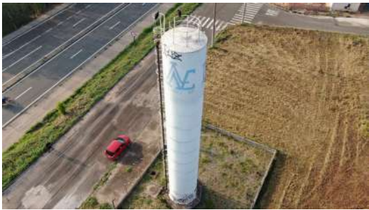
Foto 5 - Imagem aérea do reservatório obtida com drone.
