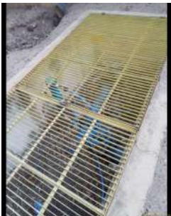
Foto 4 - Saída do reservatório.
