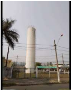
Foto 1 - Visão geral do reservatório.
