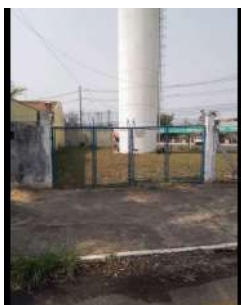
Foto 1 - Portão de acesso à área.
