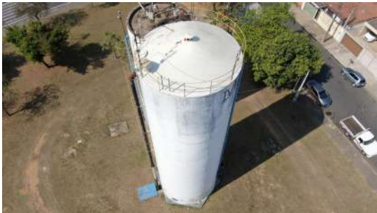
Foto 1 - Tampa de inspeção em boas condições.
