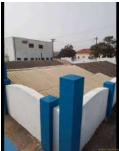
Foto 3 - Visão geral dos reservatórios semienterrados.
