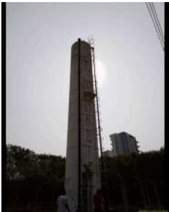
Foto 1 - Visão geral do reservatório.
