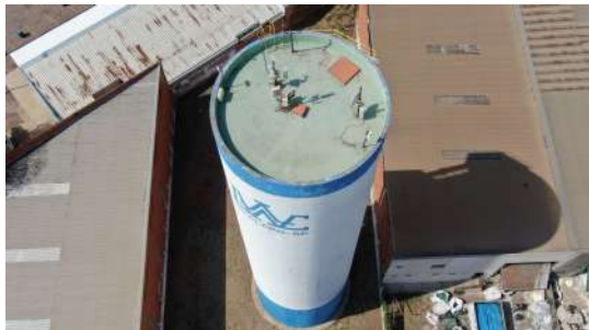
Foto 7 - Imagem aérea do reservatório elevado.
