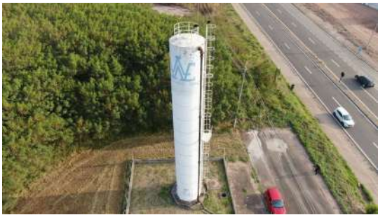
Foto 3 - Escada e guarda-corpo na cobertura.
