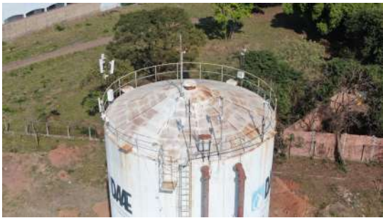
Foto 1 - Chaminé de ventilação na cobertura do reservatório.
