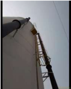
Foto 1 - Escada externa do reservatório.
