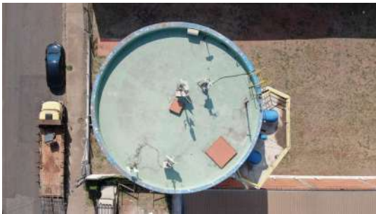
Foto 1 - Tampa de inspeção em boas condições.
