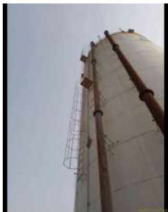
Foto 1 - Escada externa do reservatório.
