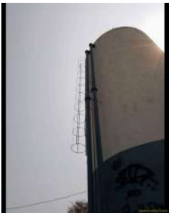
Foto 1 - Escada externa do reservatório.
