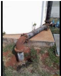
Foto 1 - Saída do tubo extravasor.
