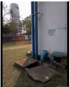
Foto 2 - Descida do extravasor.
