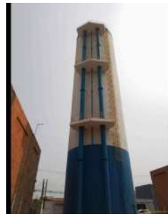
Foto 2 - Visão geral do reservatório.
