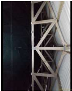
Foto 5 - Estrutura da cobertura de um dos reservatórios.
