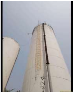
Foto 1 - Escada externa do reservatório.
