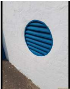
Foto 1 - Abertura para ventilação.
