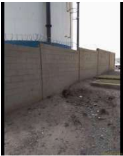
Foto 1 - Muro no perímetro do terreno.
