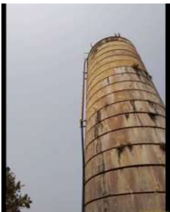
Foto 2 - Mangueira acoplada para extravasar o reservatório.
