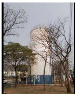
Foto 5 - Visão geral do reservatório.
