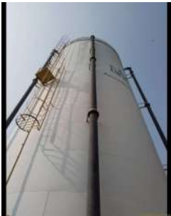
Foto 2 - Descida do extravasor.
