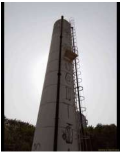
Foto 3 - Descida do extravasor.
