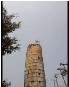
Foto 1 - Escada externa do reservatório.
