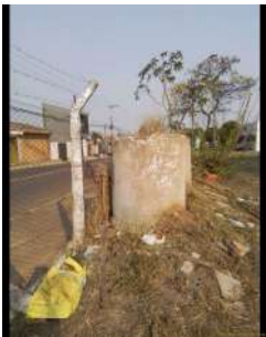
Foto 2 - Trecho com cerca vandalizada e resíduos no terreno.
