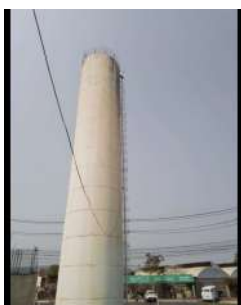
Foto 3 - Escada externa do reservatório e guarda-corpo na cobertura.
