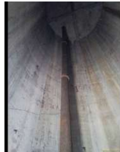
Foto 6 - Descida da tubulação de saída.
