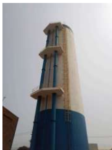
Foto 1 - Escada externa do reservatório.
