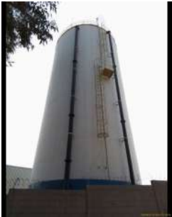
Foto 1 - Visão geral do reservatório.
