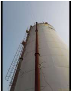
Foto 2 - Descida do tubo extravasor.
