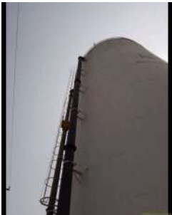
Foto 3 - Descida do extravasor.
