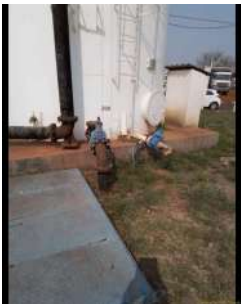
Foto 3 - Saída do reservatório.
