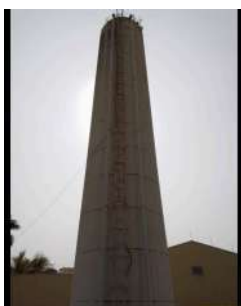
Foto 1 - Escada externa do reservatório.
