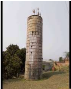
Foto 2 - Visão geral do reservatório.
