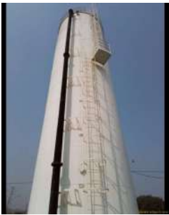
Foto 2 - Marcações do nível (e consequentemente, do volume) do reservatório.
