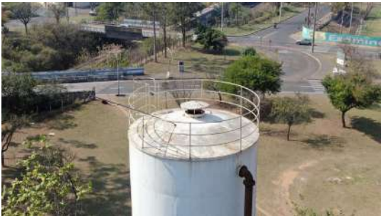
Foto 2 - Chaminé de ventilação na cobertura do reservatório.
