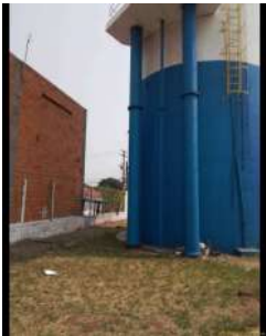
Foto 1 - Descida do extravasor.
