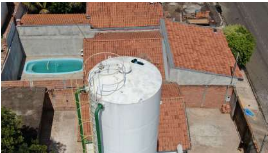
Foto 1 - Tampa de inspeção na cobertura do reservatório, na chegada da escada.
