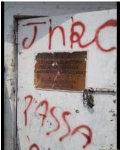
Foto 1 - Placa de identificação da elevatória.
