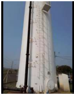
Foto 1 - Medidor de nível por contrapeso.
