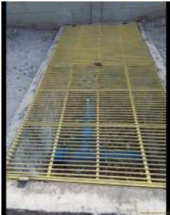
Foto 2 - Entrada do reservatório.
