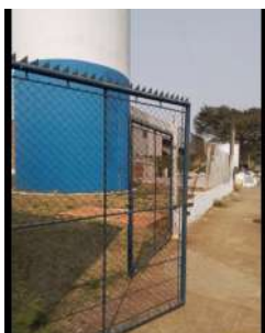
Foto 1 - Cerca e portão de acesso.
