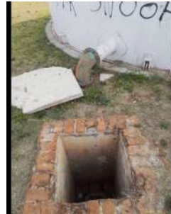
Foto 4 - Saída do reservatório.
