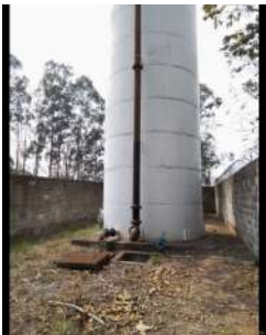
Foto 4 - Descida do extravasor.
