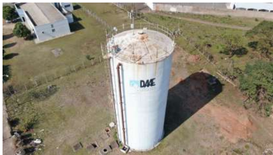
Foto 5 - Imagem aérea do reservatório, obtida por drone.
