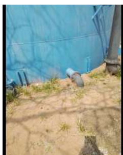
Foto 3 - Saída do reservatório.
