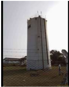
Foto 1 - Visão geral do reservatório
