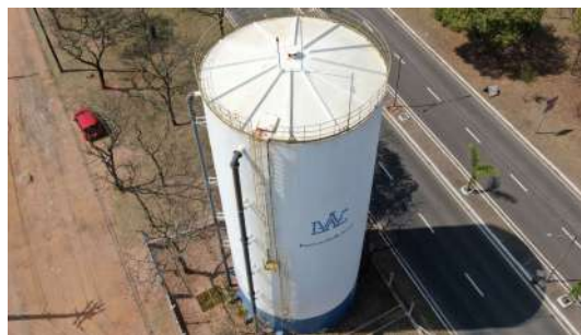
Foto 2 - Escada externa do reservatório e guarda-corpo na cobertura.
