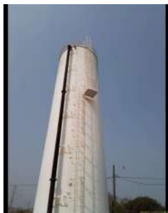
Foto 1 - Escada externa do reservatório.
