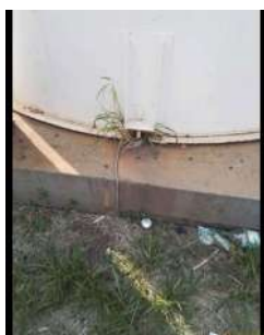
Foto 1 - Aterramento do reservatório.
