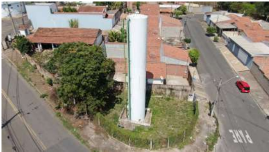
Foto 1 - Cerca no perímetro da área.
