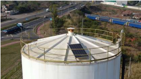
Foto 1 - Chaminé de ventilação na cobertura.
