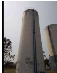
Foto 2 - Visão geral do reservatório elevado metálico Jardim Palmeiras
