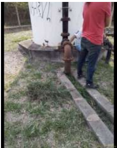
Foto 1 - Extravasor do reservatório.
