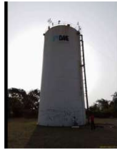
Foto 2 - Visão geral do reservatório
