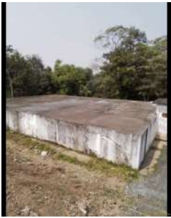
Foto 1 - Visão geral do reservatório.
