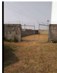
Foto 2 - Portão de acesso.
