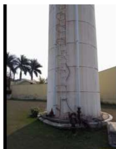
Foto 2 - Escada externa do reservatório.
