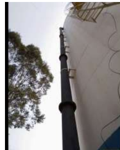
Foto 2 - Descida do tubo extravasor.
