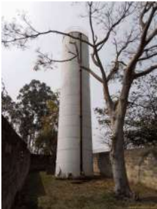
Foto 1 - Visão geral do reservatório.
