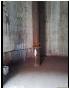
Foto 5 - Saída do reservatório.
