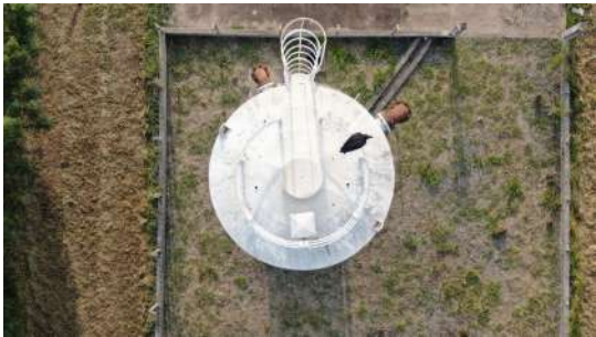
Foto 1 - Chaminé de ventilação na cobertura.
