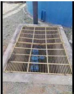
Foto 3 - Entrada do reservatório.
