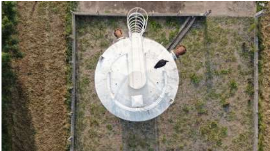
Foto 1 - Tampa de inspeção na cobertura do reservatório.
