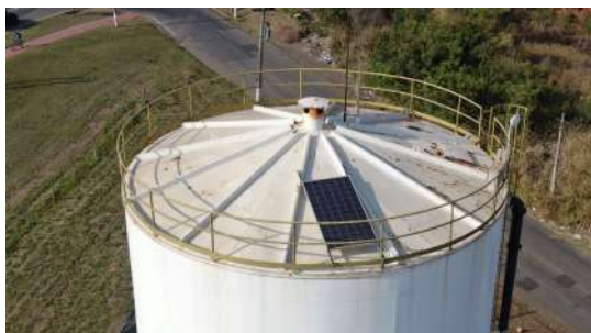
Foto 3 - Guarda-corpo da cobertura.
