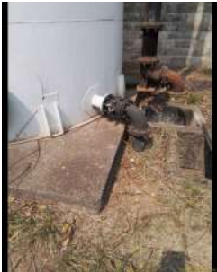
Foto 2 - Saída do reservatório.
