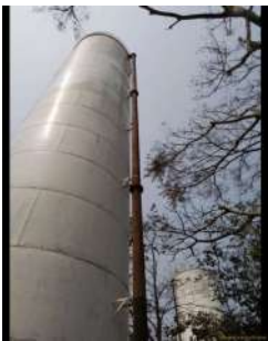
Foto 2 - Descida do extravasor.
