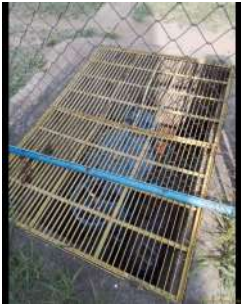
Foto 2 - Válvula controladora de nível.
