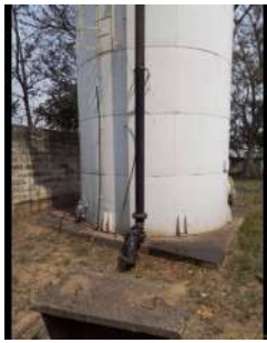
Foto 3 - Alimentação do reservatório.
