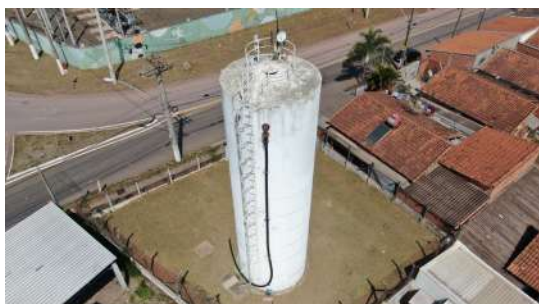
Foto 1 - Extravasador do reservatório.
