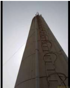
Foto 2 - Descida do extravasor.
