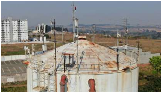
Foto 1 - Tampa de inspeção em boas condições na cobertura do reservatório, na chegada da escada.
