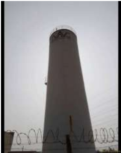
Foto 1 - Visão geral do reservatório.
