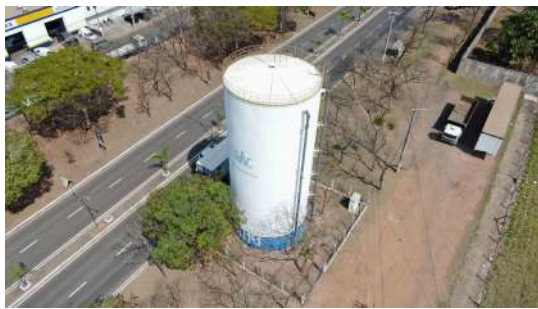
Foto 3 - Imagem aérea exibindo a cerca.
