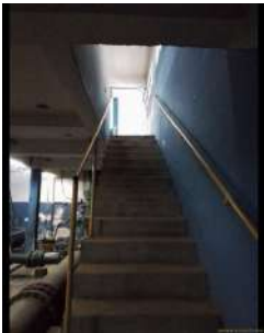
Foto 6 - Escada de acesso à casa de bombas.
