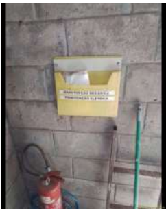
Foto 1 - Local para guarda de ficha de manutenção.
