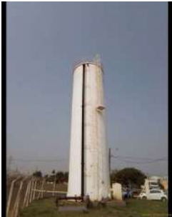
Foto 2 - Visão geral do reservatório.
