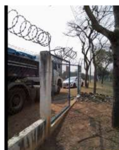
Foto 2 - Cerca em todo o perímetro da área.
