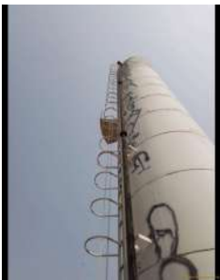
Foto 2 - Escada externa do reservatório.
