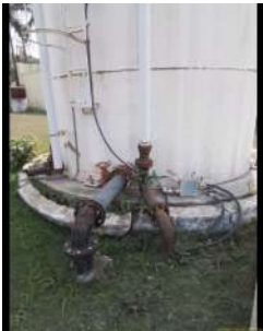
Foto 2 - Saída do reservatório.
