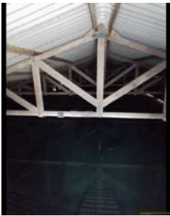
Foto 6 - Estrutura da cobertura de um dos reservatórios.
