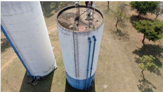
Foto 2 - Escada externa do reservatório.
