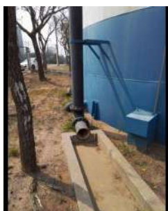
Foto 1 - Saída do tubo extravasor.
