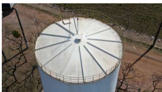
Foto 1 - Chaminé de ventilação na cobertura.
