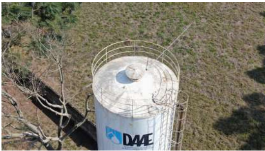
Foto 1 - Tampa de inspeção em boas condições.
