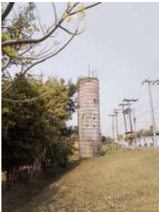
Foto 2 - Escada externa do reservatório.
