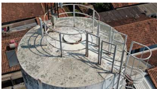
Foto 1 - Tampa de inspeção na cobertura do reservatório.
