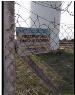
Foto 1 - Placa de identificação do reservatório.
