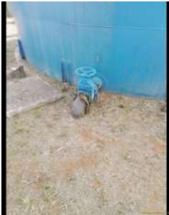
Foto 2 - Saída do reservatório.
