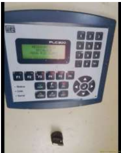
Foto 2 - Display do sistema de telemetria, situado no EEAT Nova Rio Claro, exibindo o nível do reservatório apoiado (semienterrado).
