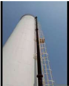
Foto 2 - Descida do tubo extravasor.
