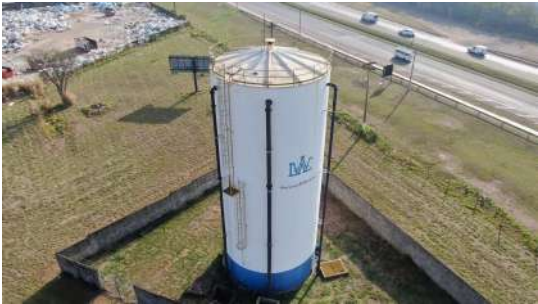
Foto 3 - Descida do extravasor.
