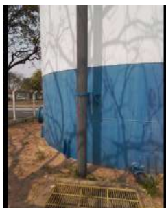
Foto 1 - Tubulação de alimentação do reservatório.
