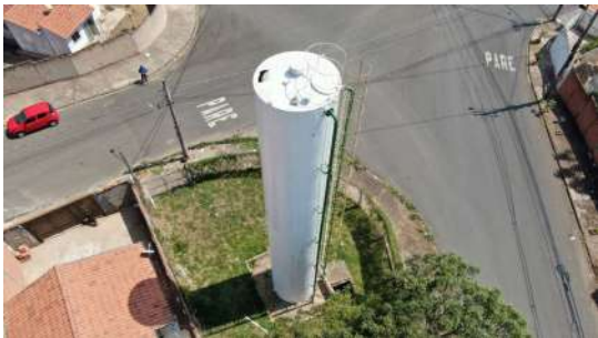
Foto 1 - Escada e guarda-corpo.
