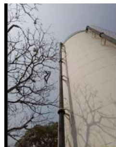
Foto 2 - Tubulação de alimentação do reservatório.
