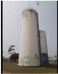
Foto 1 - Visão geral do reservatório elevado metálico Jardim Palmeiras
