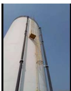
Foto 1 - Escada externa do reservatório.
