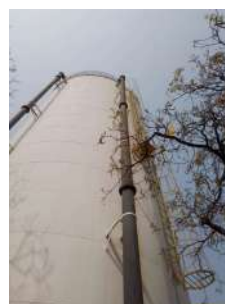
Foto 2 - Descida do tubo extravasor.
