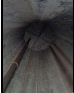
Foto 3 - Interior do reservatório, sob a laje de sustentação.
