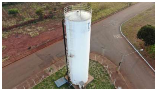
Foto 2 - Escada e guarda-corpo do reservatório.
