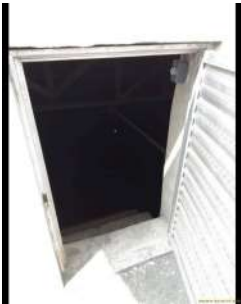
Foto 2 - Porta para inspeção interna de um dos reservatórios.
