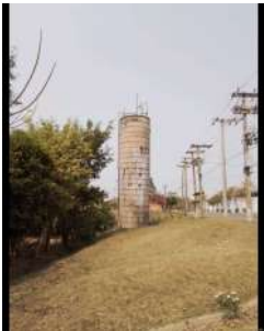
Foto 1 - Visão geral do reservatório.
