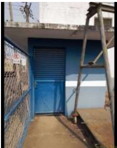
Foto 8 - Porta de acesso à elevatória.
