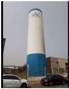
Foto 1 - Visão geral do reservatório.
