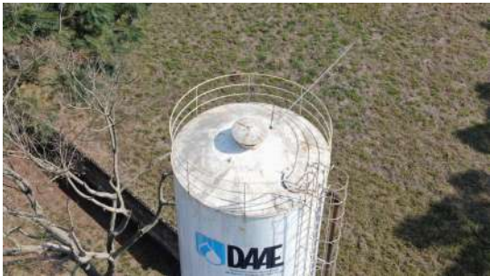
Foto 1 - Chaminé de ventilação na cobertura do reservatório.
