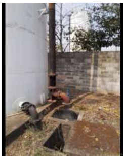
Foto 1 - Descida do extravasor.
