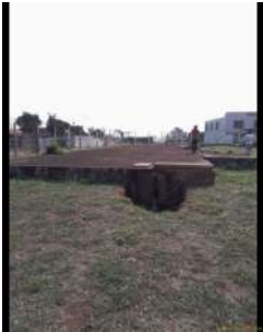
Foto 1 - Visão geral do reservatório.
