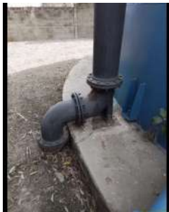
Foto 1 - Descida do tubo extravasor.
