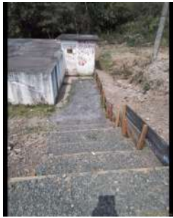
Foto 2 - Escada para acessar o reservatório e a EEAT.
