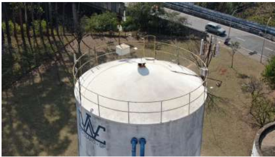
Foto 1 - Chaminé de ventilação na cobertura.
