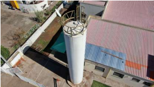
Foto 6 - Vista aérea do reservatório
