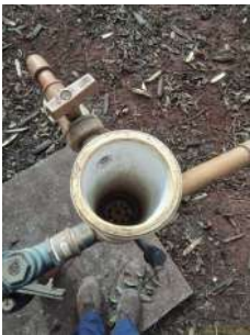
Foto 2 - Suporte para equipamento de cloração/fluoretação.
