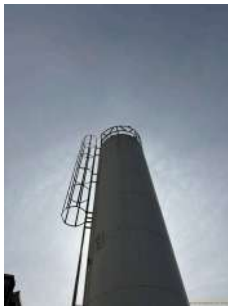
Foto 3 - Guarda-corpo do reservatório
