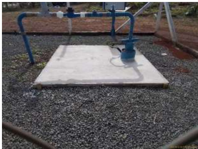
Foto 3 - Laje de proteção
