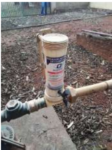
Foto 1 - Suporte para equipamento de cloração/fluoretação.
