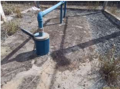
Foto 2 - Laje de proteção
