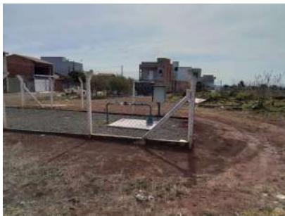
Foto 1 - Cercamento da área
