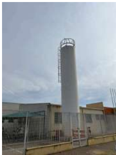
Foto 2 - Cercamento da área
