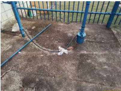
Foto 2 - Laje de proteção
