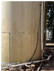
Foto 3 - Descida do sistema de SPDA
