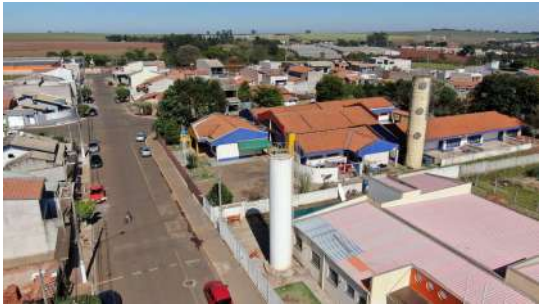
Foto 5 - Vista aérea do reservatório
