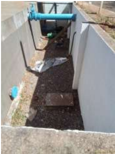
Foto 2 - Vala em que está localizada a elevatória
