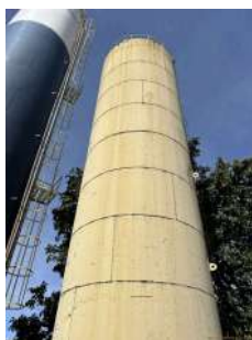
Foto 1 - Vista geral do reservatório
