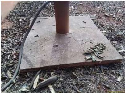
Foto 3 - Laje de proteção
