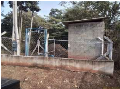
Foto 1 - Cercamento da área
