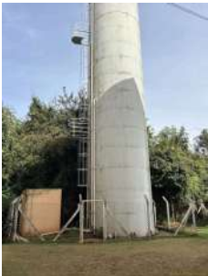
Foto 2 - Cercamento da área
