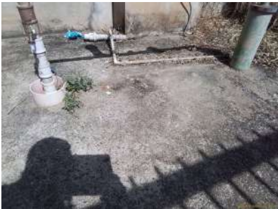
Foto 2 - Laje de proteção
