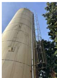
Foto 2 - Vista geral do reservatório
