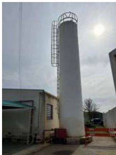
Foto 1 - Vista geral do reservatório
