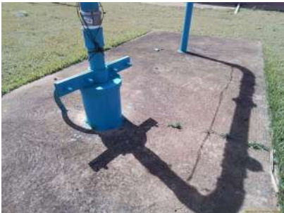
Foto 2 - Laje de proteção
