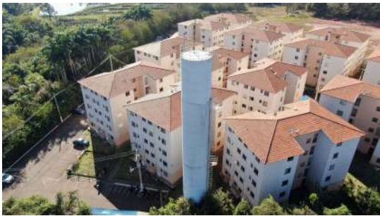
Foto 5 - Vista aérea do reservatório
