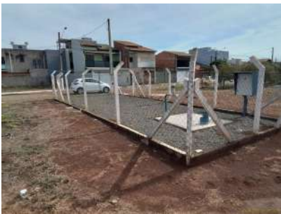
Foto 2 - Cercamento da área
