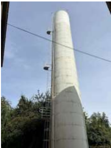
Foto 1 - Vista geral do reservatório
