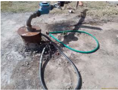
Foto 6 - Laje de proteção
