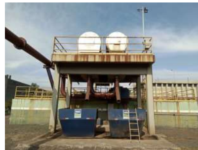
Foto 2 - Gradeamento fino com peneiras rotativas
