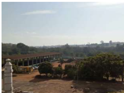
Foto 12 - Vista superior da usina de compostagem
