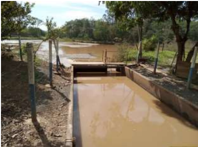
Foto 2 - Tomada d água da captação Lopes
