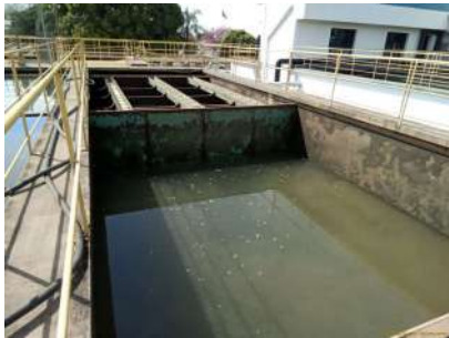
Foto 5 - Limpeza do decantador
