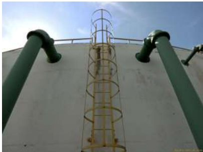
Foto 1 - Guarda-corpos na escada de acesso e cobertura
