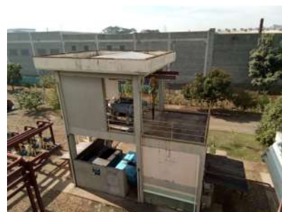
Foto 8 - Casa desidratação de lodo
