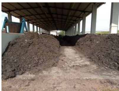
Foto 17 - Vista interna do sistema de processamento do lodo e podas
