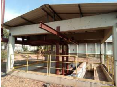
Foto 4 - Vista da casa de bombas
