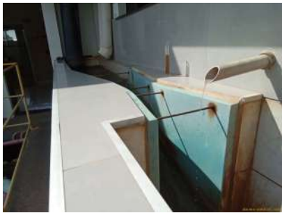
Foto 2 - Chegada de água bruta
