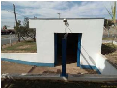
Foto 1 - Vista externa da estação elevatória
