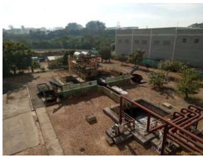
Foto 9 - Vista superior EEEB1, Tratamento preliminar e EEEB2
