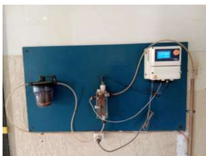
Foto 1 - Medição on line de flúor
