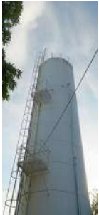
Foto 3 - Vista geral do reservatório.
