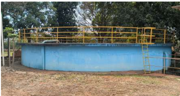
Foto 1 - Vista geral do reservatório.
