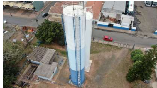
Foto 4 - Vista aérea da haste de captação e sistema de descida do SPDA.
