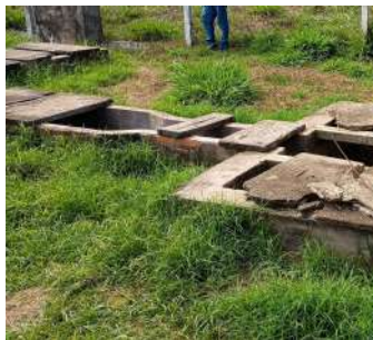
Foto 8 - Poço de sucção da EEE.
