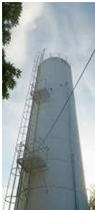
Foto 3 - Vista geral do reservatório.
