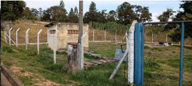
Foto 2 - Vista geral externa da EEE.
