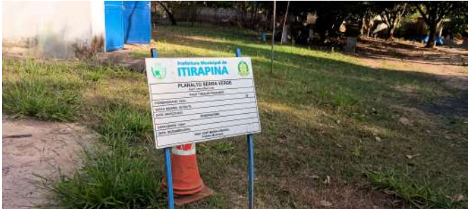
Foto 1 - Identificação do poço ao lado da EEAT.
