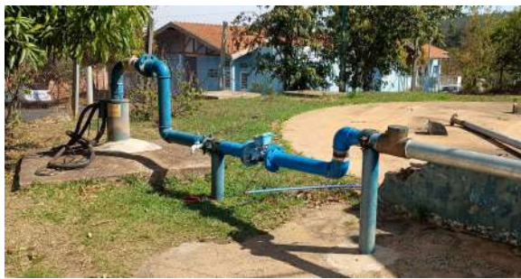
Foto 3 - Vista geral do poço e do cavalete.
