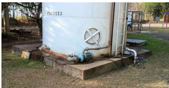
Foto 5 - Vista geral da base do reservatório.
