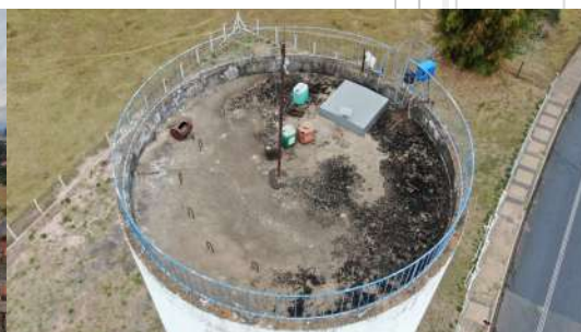
Foto 9 - Vista aérea do reservatório.
