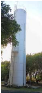
Foto 2 - Vista geral do reservatório.
