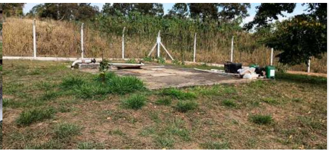
Foto 4 - Vista do reservatório de acumulação (pulmão)
