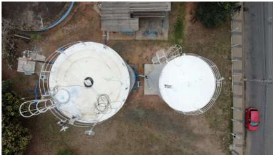
Foto 1 - Vista aérea da cobertura do reservatório, com detalhe para as estruturas de ventilação.
