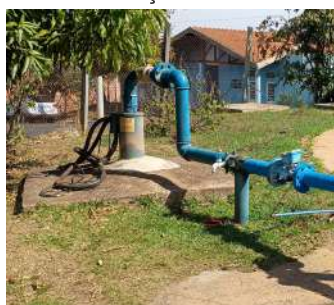
Foto 3 - Vista geral do poço e do cavalete.
