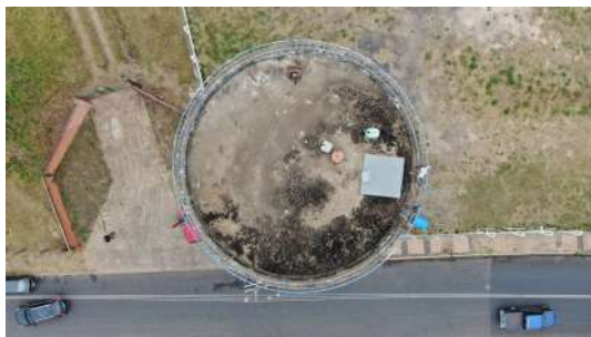
Foto 1 - Tampa de inspeção do reservatório.
