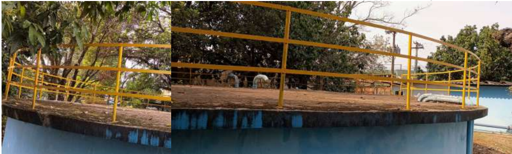
Foto 3 - Vista parcial da laje do reservatório.
