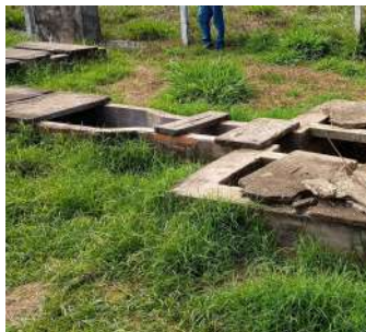
Foto 8 - Poço de sucção da EEE.
