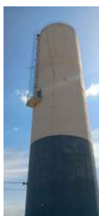
Foto 1 - Vista lateral do reservatório com guarda-corpos.
