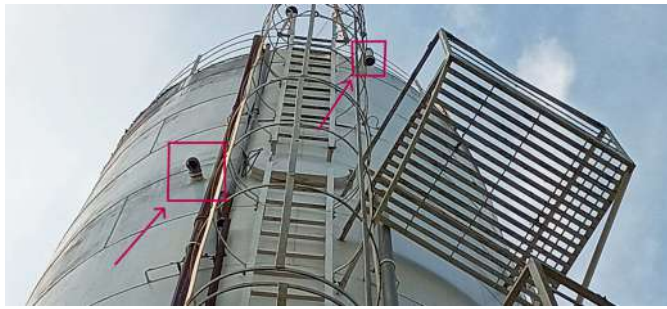
Foto 3 - Indicação dos tubos extravasores.
