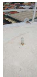
Foto 2 - Tampa instalada no vão da cobertura do reservatório (Fonte: DAE/Prefeitura Itirapina, ago/2024).
