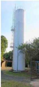
Foto 1 - Vista geral do reservatório.
