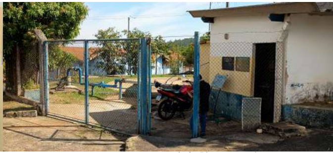
Foto 2 - Vista geral externa do local.
