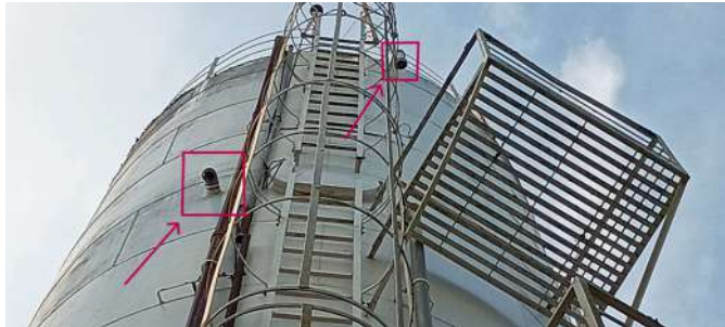
Foto 3 - Indicação dos tubos extravasores.
