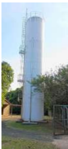
Foto 1 - Vista geral do reservatório.
