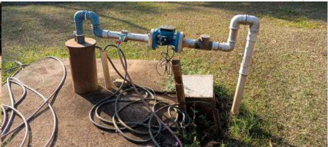
Foto 4 - Vista geral do poço.
