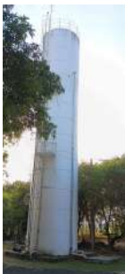
Foto 2 - Vista geral do reservatório.
