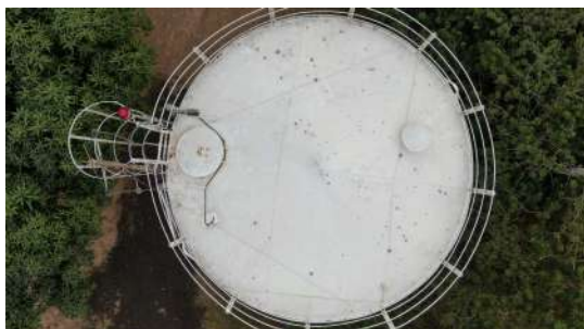
Foto 7 - Vista aérea da cobertura do reservatório.
