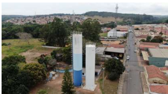
Foto 10 - Vista aérea dos dois reservatórios.
