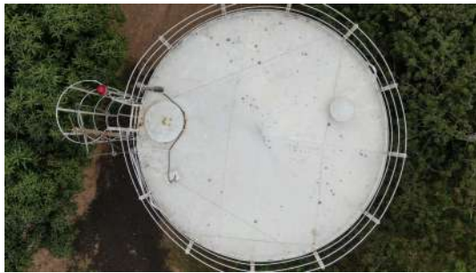
Foto 3 - Haste de captação do SPDA.
