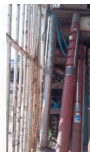
Foto 1 - Conjunto motobomba submersa (inox) reserva.
