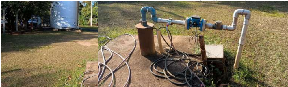
Foto 3 - Vista geral do poço Foto 4 - Vista geral do poço.
