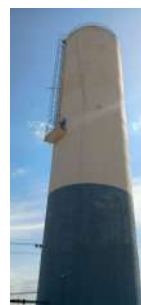
Foto 4 - Vista geral do reservatório.
