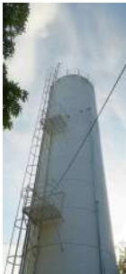
Foto 3 - Vista geral do reservatório.
