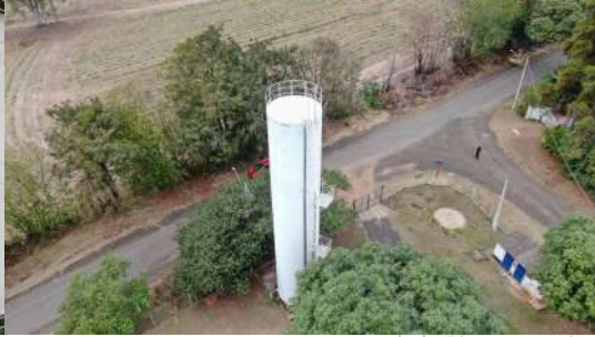
Foto 8 - Vista aérea do reservatório.
