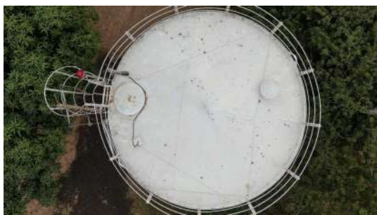
Foto 3 - Haste de captação do SPDA.
