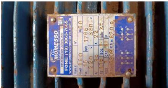
Foto 7 - Placa de especificações técnicas do primeiro conjunto motobomba.
