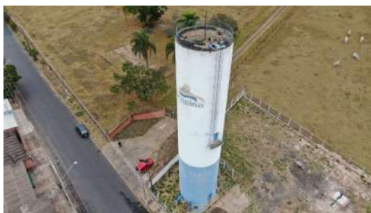
Foto 10 - Vista aérea do reservatório.
