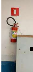
Foto 3 - Extintor de incêndio com validade expirada. Foto 4 - Extintor de incêndio com validade expirada.
