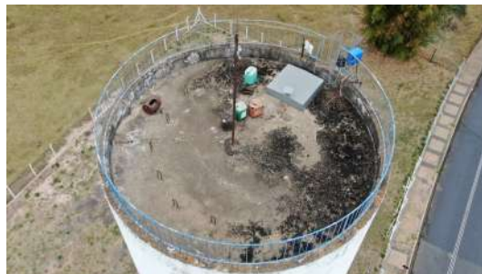
Foto 9 - Vista aérea do reservatório.
