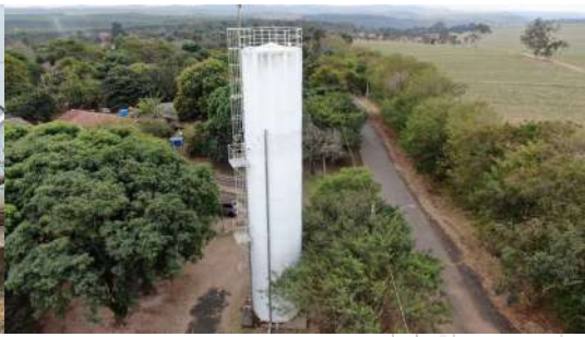
Foto 6 - Vista aérea do reservatório.
