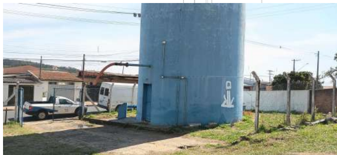
Foto 5 - Vista geral do reservatório.
