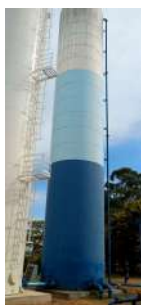
Foto 6 - Vista geral do reservatório.
