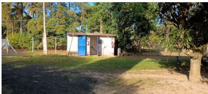
Foto 1 - Extintores de incêndio situados no abrigo do painel elétrico e dos tanques de produtos químicos.
