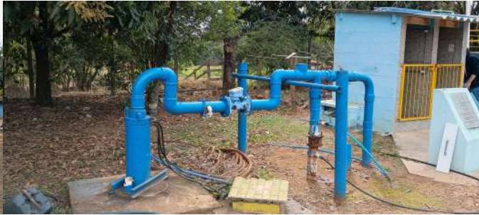
Foto 2 - Vista geral do poço.
