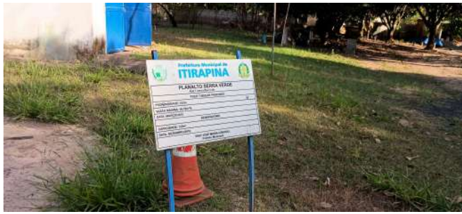
Foto 1 - Identificação do poço ao lado da EEAT.
