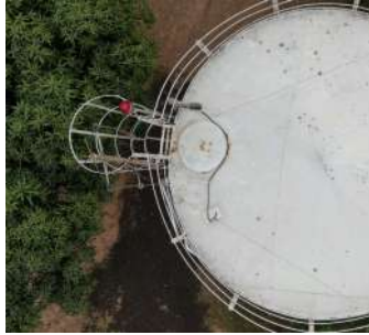
Foto 7 - Vista aérea da cobertura do reservatório.
