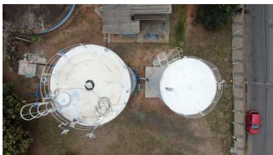
Foto 1 - Tampa instalada no vão da cobertura do reservatório.
