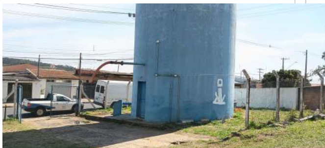
Foto 5 - Vista geral do reservatório.
