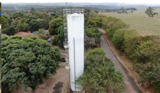
Foto 6 - Vista aérea do reservatório.
