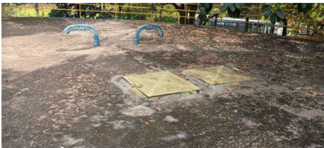
Foto 5 - Vista da laje do reservatório.
