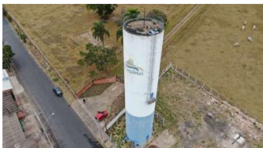
Foto 10 - Vista aérea do reservatório.
