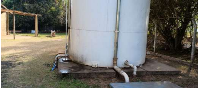
Foto 4 - Vista geral da base do reservatório.
