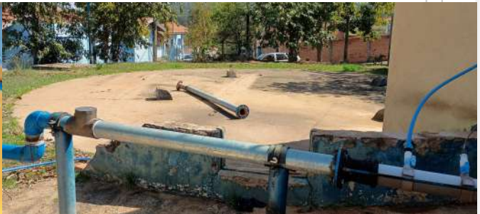
Foto 2 - Antigo reservatório da EEAT, também desativado.
