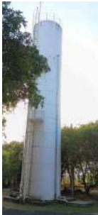
Foto 2 - Vista geral do reservatório.
