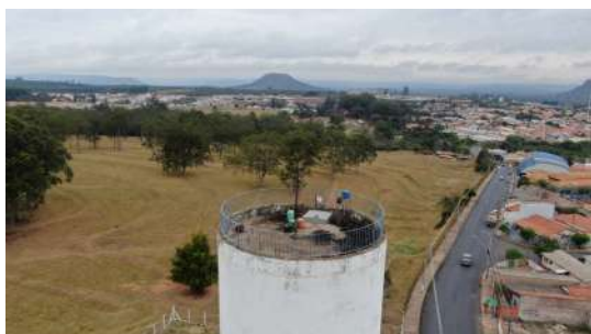
Foto 3 - Haste de captação do SPDA.
