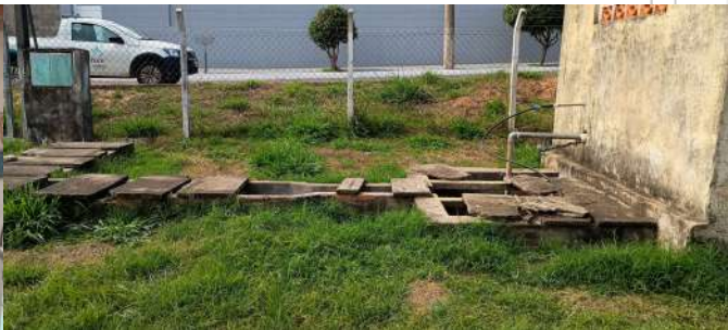
Foto 2 - Situação do canal de chegada do esgoto e do poço de sucção.
