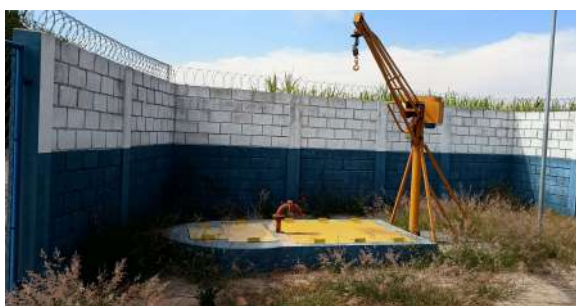
Foto 6 - Poço de chegada do esgoto e de sucção.
