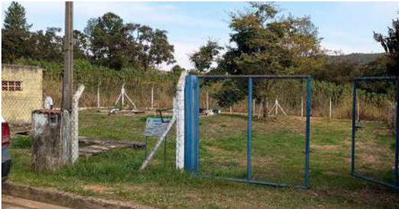
Foto 1 - Vista geral externa da EEE.
