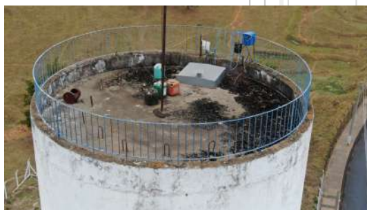
Foto 2 - Laje do reservatório com guarda-corpos.
