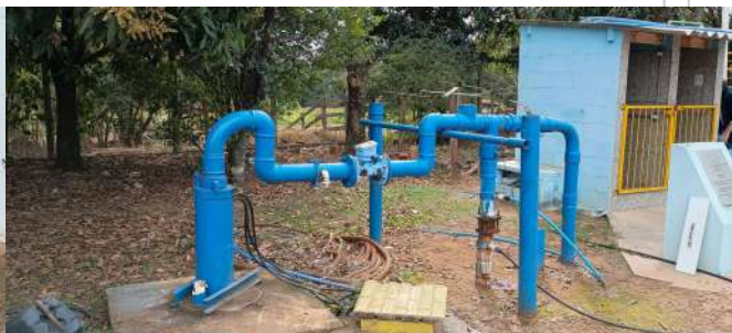
Foto 2 - Vista geral do poço.
