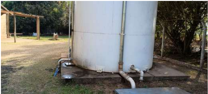
Foto 4 - Vista geral da base do reservatório.
