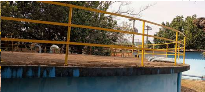
Foto 4 - Vista parcial da laje do reservatório.
