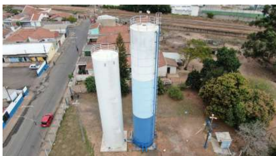
Foto 8 - Vista aérea dos dois reservatórios.
