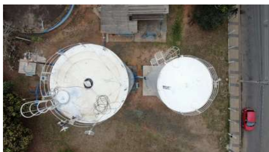
Foto 1 - Vista aérea da cobertura do reservatório.
