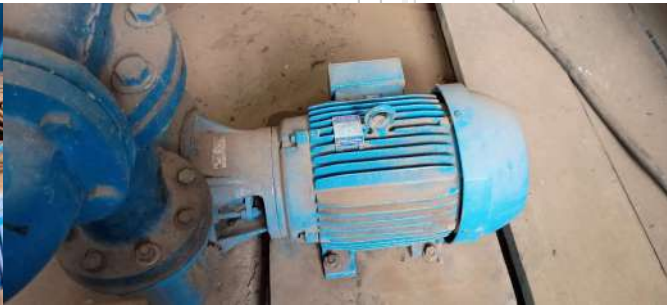
Foto 6 - Primeiro conjunto motobomba.
