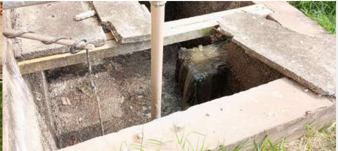
Foto 6 - Poço de sucção da EEE.
