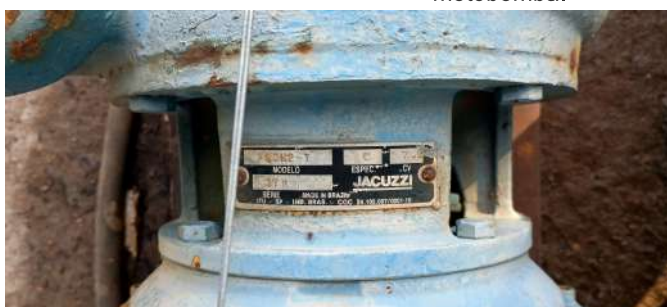
Foto 5 - Placa de especificações gerais do conjunto motobomba.
