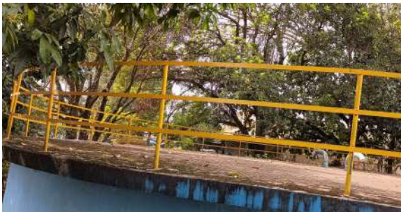
Foto 3 - Vista parcial da laje do reservatório.
