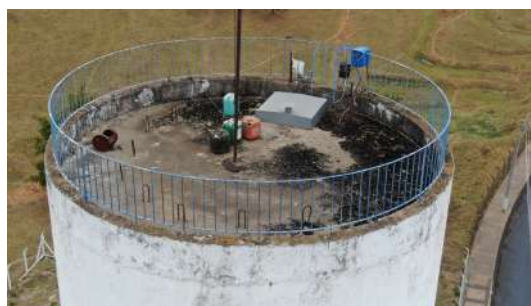
Foto 2 - Laje do reservatório com guarda-corpos.
