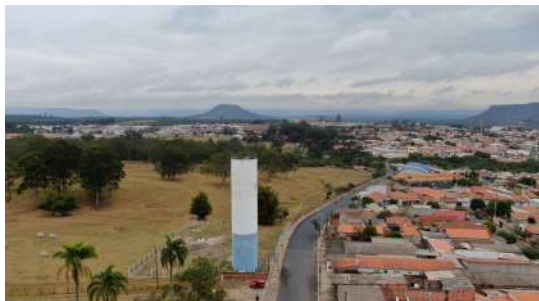
Foto 8 - Vista aérea do reservatório.
