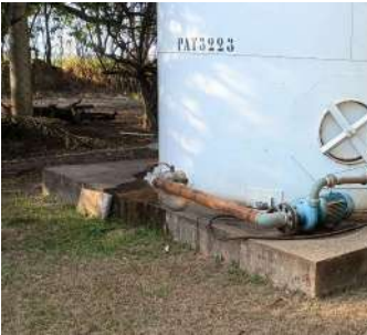
Foto 5 - Vista geral da base do reservatório.
