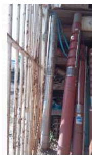
Foto 1 - Conjunto motobomba submersa (inox) reserva.
