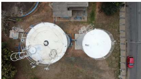
Foto 5 - Vista aérea da cobertura dos dois reservatórios.
