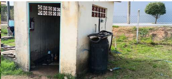
Foto 9 - Casa de bombas.
