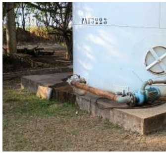
Foto 5 - Vista geral da base do reservatório.
