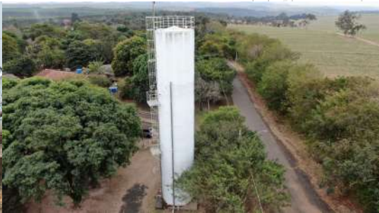
Foto 6 - Vista aérea do reservatório.
