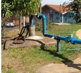
Foto 3 - Vista geral do poço e do cavalete.
