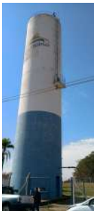
Foto 1 - Vista geral do reservatório.
