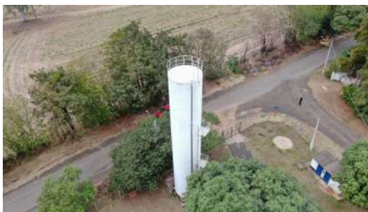
Foto 8 - Vista aérea do reservatório.
