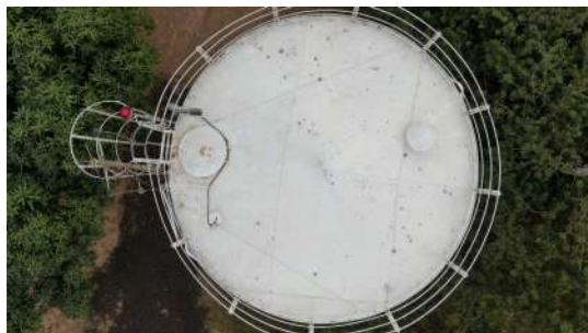
Foto 3 - Haste de captação do SPDA.
