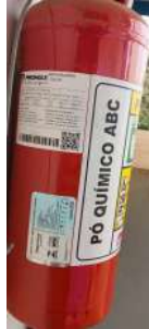
Foto 3 - Extintor de incêndio com validade expirada. Foto 4 - Extintor de incêndio com validade expirada.
