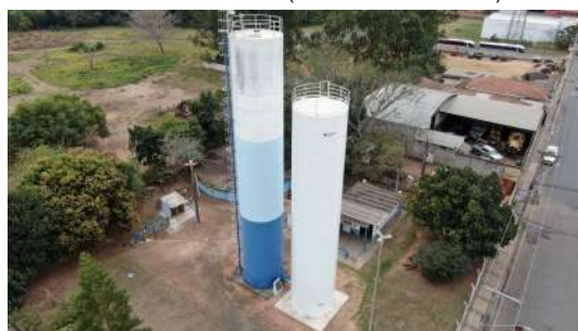
Foto 9 - Vista aérea dos dois reservatórios.
