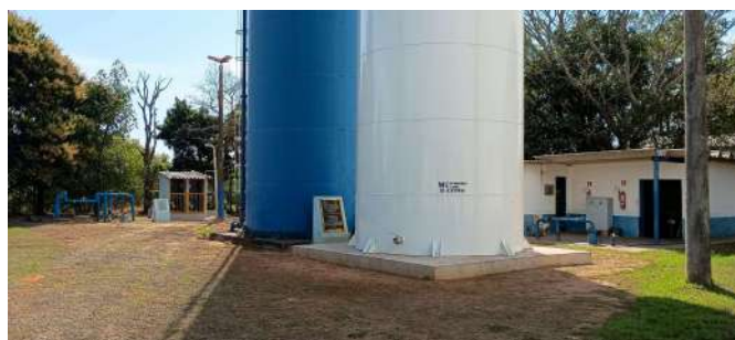
Foto 2 - Vista geral dos dois reservatório elevados da Rua 5, sendo o objeto desta ficha o reservatório na cor branca.
