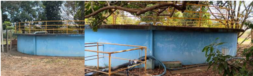
Foto 1 - Vista geral do reservatório.
