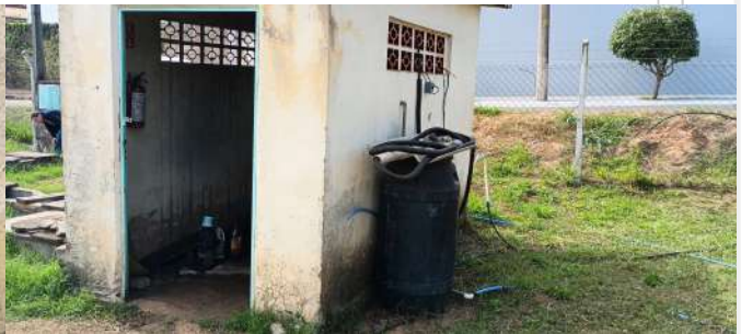
Foto 9 - Casa de bombas.
