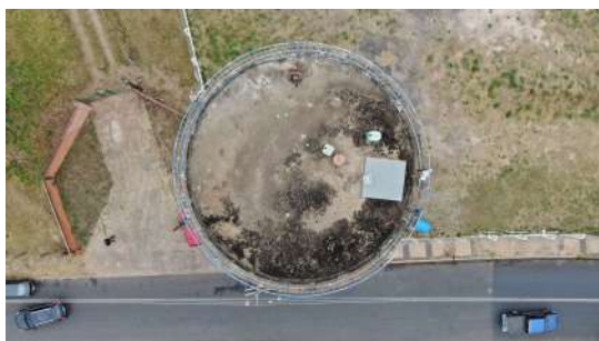
Foto 1 - Tampa de inspeção do reservatório.
