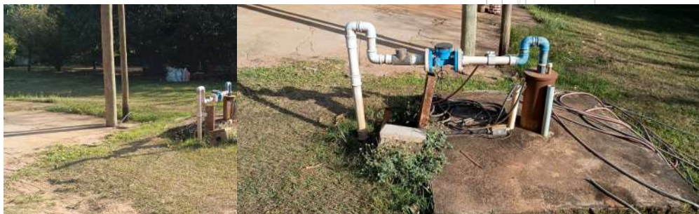
Foto 1 - Vista geral do poço. Foto 2 - Vista geral do poço.
