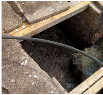
Foto 1 - Situação atual do gradeamento grosseiro.
