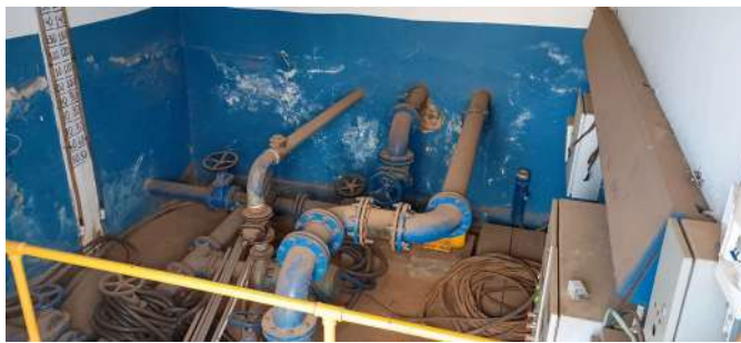
Foto 1 - Medidor de nível.
