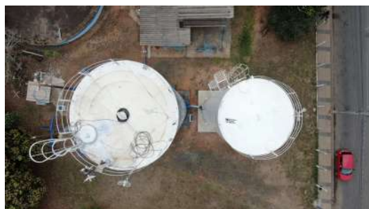
Foto 11 - Vista aérea dos dois reservatórios.
