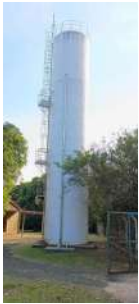
Foto 1 - Vista geral do reservatório.
