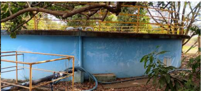
Foto 2 - Vista geral do reservatório.
