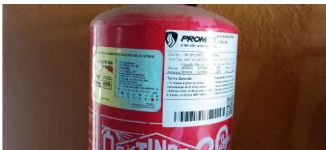
Foto 4 - Validade expirada do extintor de incêndio.
