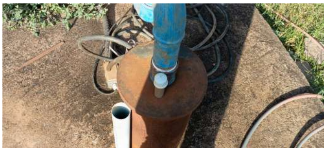
Foto 1 - Tubo para medição de nível.
