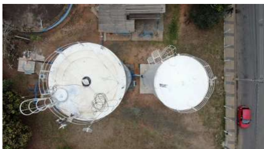
Foto 1 - Vista aérea da cobertura dos reservatórios.
