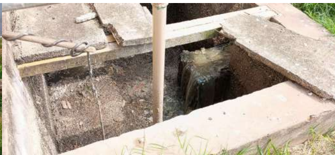
Foto 6 - Poço de sucção da EEE.
