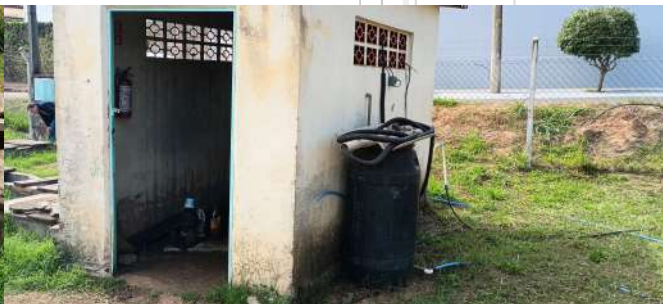
Foto 9 - Casa de bombas.
