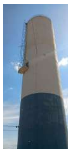
Foto 1 - Vista lateral do reservatório com guarda-corpos.
