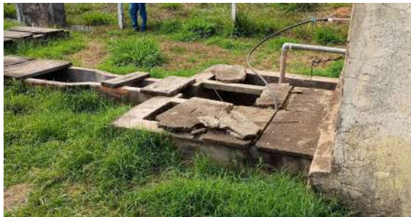
Foto 8 - Poço de sucção da EEE.
