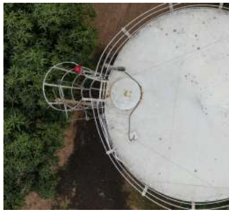
Foto 7 - Vista aérea da cobertura do reservatório.
