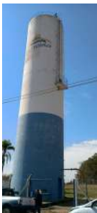
Foto 1 - Vista geral do reservatório.
