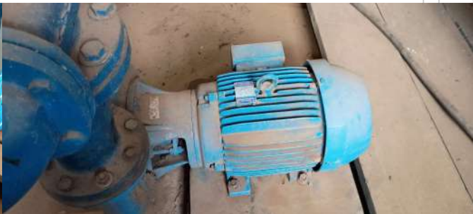
Foto 6 - Primeiro conjunto motobomba.
