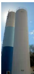
Foto 1 - Vista geral dos dois reservatório elevados da Rua 5, sendo o objeto desta ficha o reservatório na cor branca.
