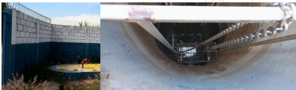
Foto 6 - Poço de chegada do esgoto e de sucção.
