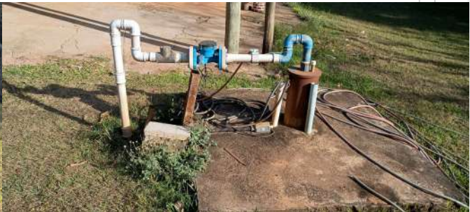
Foto 2 - Vista geral do poço.
