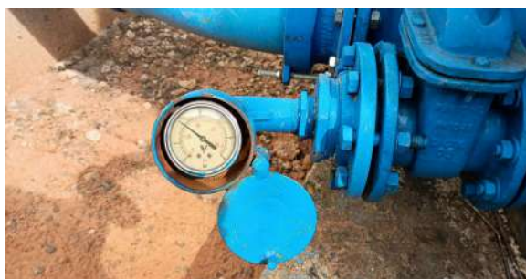
Foto 1 - Manômetro na saída do reservatório.
