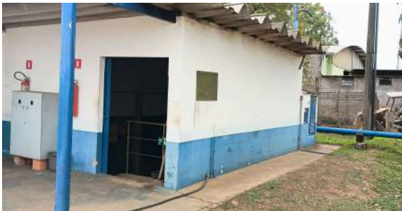
Foto 1 - Vista externa da EEAT.
