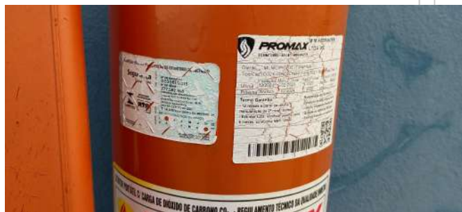
Foto 1 - Validade do extintor de incêndio expirada. Foto 2 - Validade do extintor de incêndio expirada.
