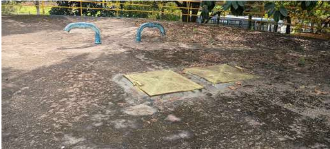
Foto 5 - Vista da laje do reservatório.
