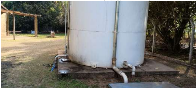
Foto 4 - Vista geral da base do reservatório.
