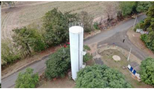
Foto 8 - Vista aérea do reservatório.
