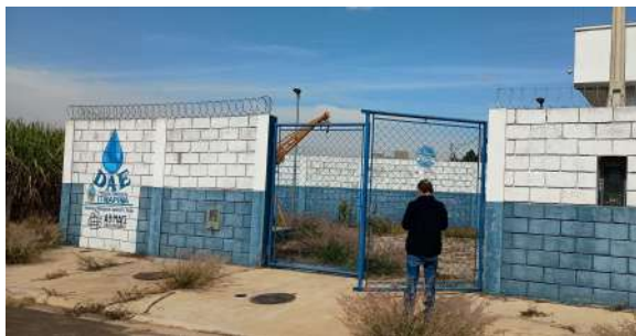
Foto 1 - Vista geral da entrada da EEE.
