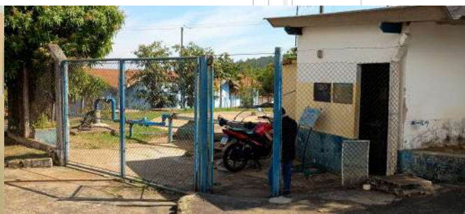
Foto 2 - Vista geral externa do local.
