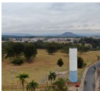
Foto 8 - Vista aérea do reservatório.
