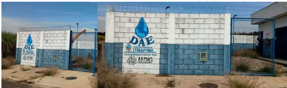
Foto 1 - Vista geral da entrada da EEE.
