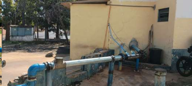
Foto 4 - Aplicação de cloro e flúor na tubulação de recalque para o reservatório elevado Nova Itirapina.
