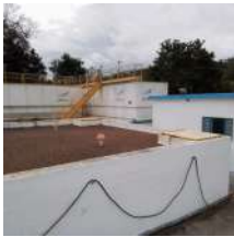
Foto 2 - Tampas de inspeção na cobertura.
