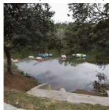
Foto 12 - Captação que abastece a ETA metálica.
