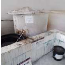
Foto 1 - Dosagem de ácido fluossilícico.
