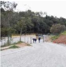
Foto 1 - Um dos portões de acesso à elevatória.
