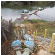
Foto 25 - Captação superficial que abastece a ETA compacta.
