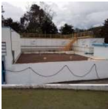
Foto 2 - Visão geral do reservatório. Atrás, a ETA compacta metálica.
