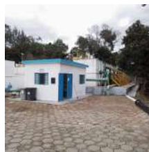
Foto 10 - Visão da ETA compacta metálica, que está em operação.
