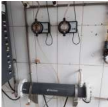
Foto 6 - Dispositivo que realiza eletrólise.
