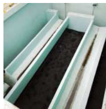
Foto 8 - Filtro em retrofit. Material filtrante foi trocado: areia, brita, e antracito.
