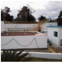
Foto 1 - Tampas de inspeção na cobertura.
