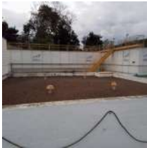
Foto 2 - Chaminés para ventilação.
