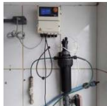
Foto 14 - Analisador de turbidez do decantador.
