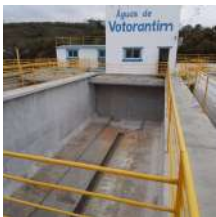
Foto 3 - Decantador após retrofit.
