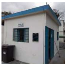
Foto 11 - Casa de química da ETA compacta.
