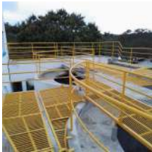
Foto 4 - 2 floculadores passando por retrofit.
