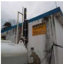
Foto 11 - Identificação da geração de hidrogênio, subproduto do processo de geração de cloro.
