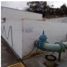
Foto 1 - Identificação na entrada do reservatório.
