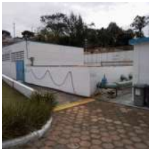
Foto 1 - Visão do reservatório.
