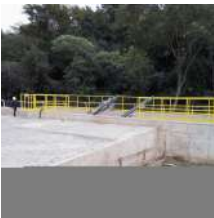
Foto 5 - Vista da estrutura da nova elevatória, que substituirá a unidade ainda em operação. De acordo com o prestador, a opção por modernizar a estação foi devido à maior facilidade na operação, visto que muitos procedimentos serão automatizados e mecanizados.
