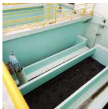
Foto 7 - 2 filtros da EAT convencional, que passaram por retrofit e tiveram o material filtrante substituído.
