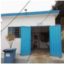
Foto 1 - Unidade geradora de hipoclorito de cloro.
