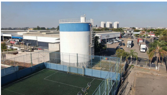
Foto 1 - Aspecto geral do reservatório
