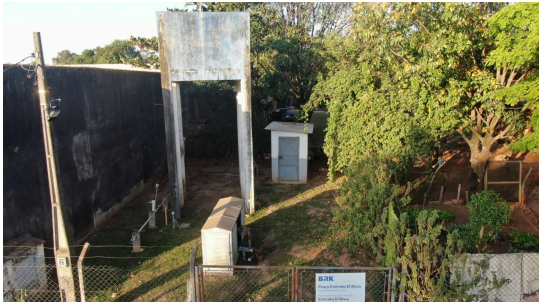
Foto 1 - Aspecto geral do reservatório
