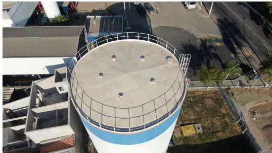
Foto 1 - Reservatório com tampa de inspeção em boas condições
