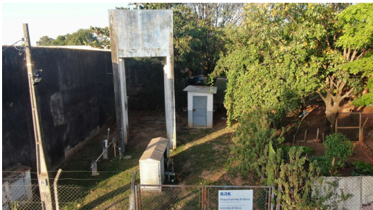
Foto 1 - Cercamento do reservatório
