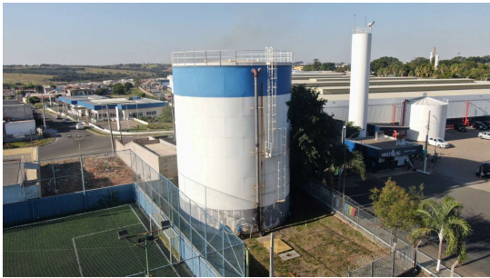
Foto 1 - Guarda-corpo na cobertura e no acesso à escada
