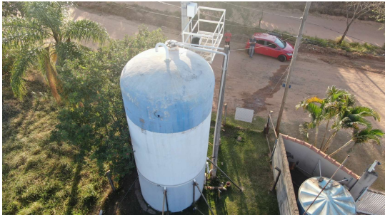
Foto 1 - Aspecto geral do reservatório
