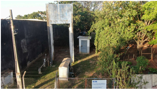
Foto 1 - Placa de identificação do reservatório
