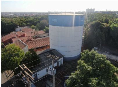
Foto 1 - Aspecto geral do reservatório
