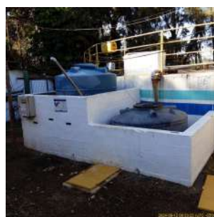
Foto 2 - Contenção ao redor dos tanques de cloro e flúor
