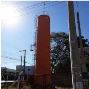
Foto 2 - Detalhamento do reservatório
