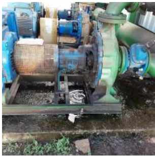
Foto 1 - Drenagem inadequada da água de lubrificação das gaxetas
