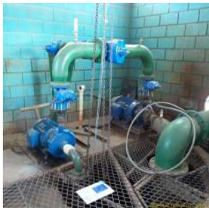
Foto 1 - Local possui acesso para manutenção
