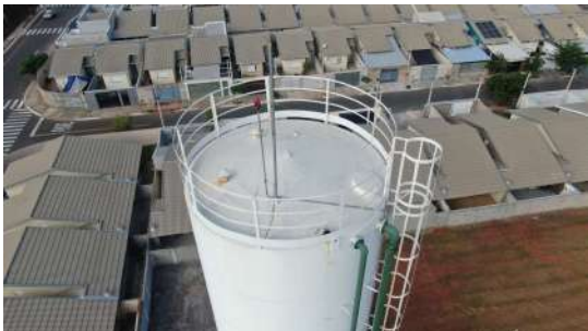
Foto 1 - Detalhamento da tampa de inspeção
