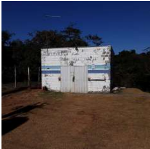
Foto 2 - Casa de bombas da captação do Camanducaia
