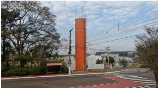
Foto 1 - Aspecto geral do reservatório
