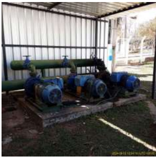
Foto 2 - Motobombas instaladas
