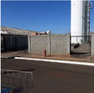
Foto 1 - Cercamento ao redor do reservatório
