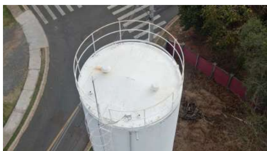
Foto 1 - Tampa de inspeção do reservatório
