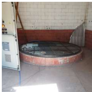
Foto 1 - Acesso para manutenção na estação Elevatória
