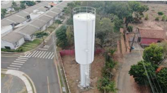
Foto 1 - Aspecto geral do reservatório
