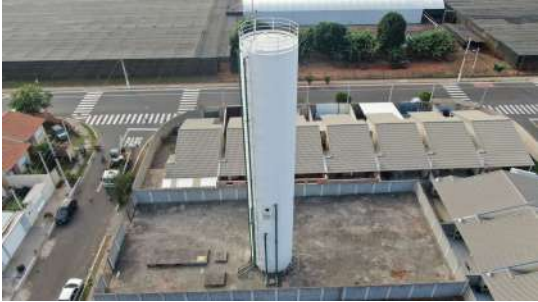
Foto 1 - Aspecto geral do reservatório
