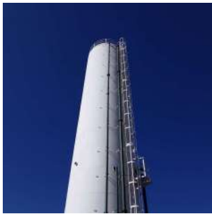
Foto 1 - Detalhamento do tubo extravasor
