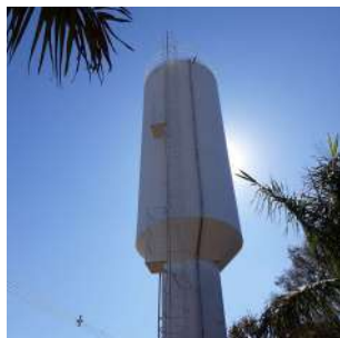
Foto 1 - Guarda-corpo instalado na cobertura do reservatório
