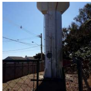
Foto 2 - Guarda-corpo instalado na escada de acesso ao reservatório
