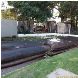
Foto 1 - Tratamento de lodo com uso de bag
