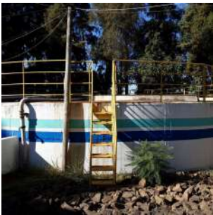
Foto 1 - Aspecto geral do reservatório
