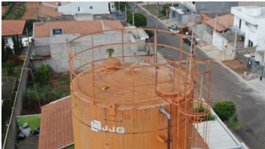
Foto 1 - Tampa de inspeção
