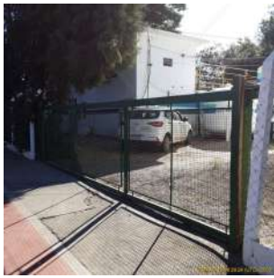
Foto 1 - Portão de acesso à ETA
