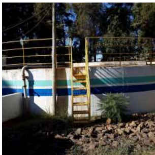
Foto 1 - Guarda-corpo instalado na escada e na cobertura do reservatório
