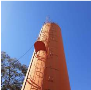
Foto 1 - Guarda-corpo instalado em escada de acesso e cobertura do reservatório
