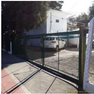
Foto 1 - Portão de acesso à ETA CPH, Booster Centro e Reservatório Semienterrado Centro
