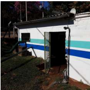
Foto 1 - Portão de acesso à elevatória de água
