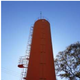
Foto 3 - Detalhamento do reservatório
