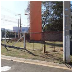
Foto 1 - Cercamento ao redor do reservatório
