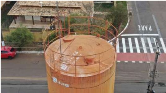
Foto 2 - Guarda-corpo instalado na cobertura
