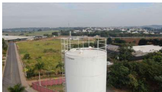
Foto 2 - Detalhamento do pára-raio
