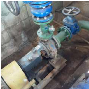
Foto 1 - Drenagem inadequada da água de lubrificação da gaxeta
