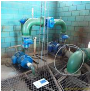
Foto 1 - Motobombas instaladas
