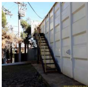
Foto 1 - Guarda-corpo na escada de acesso
