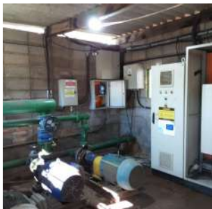
Foto 1 - Local possui acesso para manutenção
