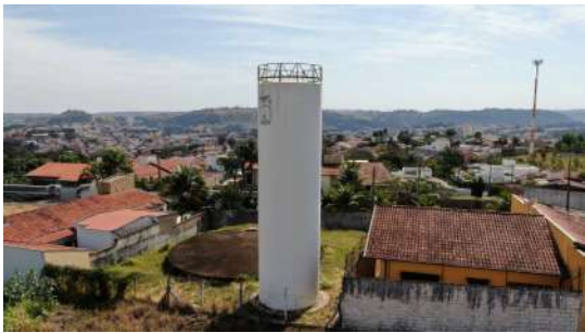
Foto 1 - Área cercada no Reservatório São Roque 2 em São José do Rio Pardo
