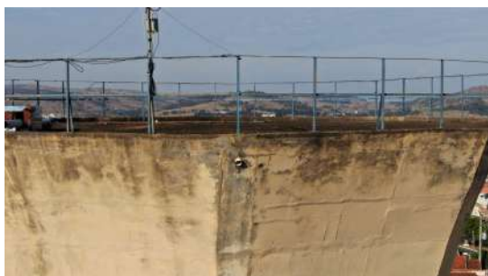
Foto 1 - Tubulação de ventilação no Reservatório Chuveirão em São José do Rio Pardo
