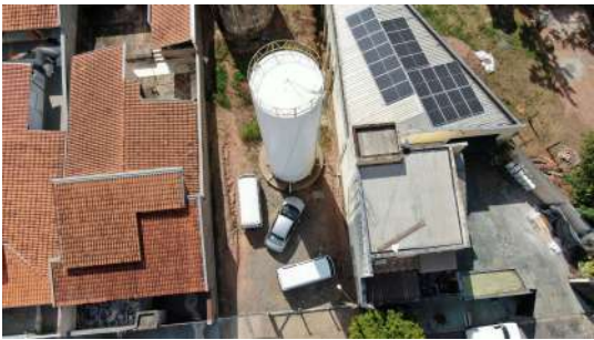
Foto 2 - Vista geral do Reservatório São domingos 2 em São José do Rio Pardo
