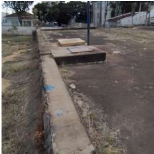
Foto 2 - Reservatório da ETA Central 2 em São José do Rio Pardo
