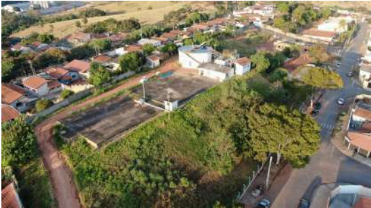
Foto 5 - Reservatório Cassucci II em São José do Rio Pardo
