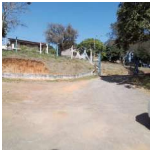
Foto 1 - Entrada da ETA João de Souza em São José do Rio Pardo
