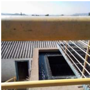
Foto 11 - ETA Cassucci em São José do Rio Pardo
