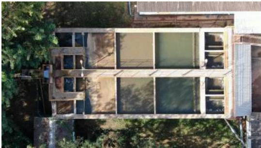
Foto 21 - ETA Santo Antônio em São José do Rio Pardo
