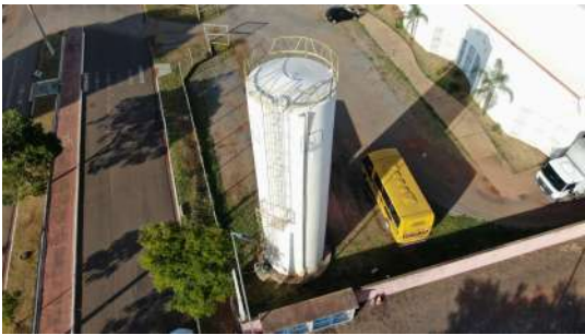
Foto 2 - Reservatório da ETEC em São José do Rio Pardo
