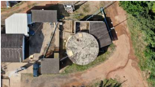
Foto 3 - Reservatório ETA Santo Antônio em São José do Rio Pardo
