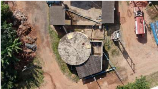
Foto 2 - Reservatório ETA Santo Antônio em São José do Rio Pardo
