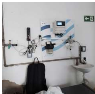
Foto 13 - ETA Santo Antônio em São José do Rio Pardo
