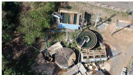
Foto 22 - ETA João de Souza em São José do Rio Pardo
