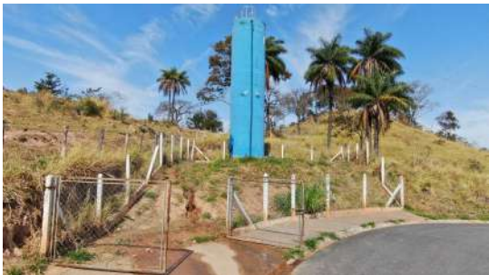
Foto 1 - Ausência de identificação no Reservatório Mano Merli em São José do Rio Pardo
