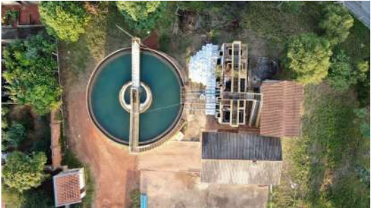
Foto 18 - ETA Cassucci em São José do Rio Pardo
