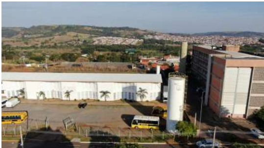
Foto 1 - Vista Geral do Reservatório da ETEC em São José do Rio Pardo
