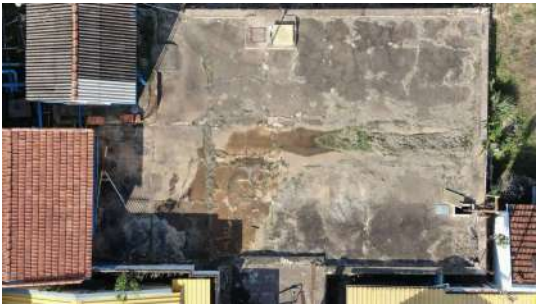
Foto 4 - Reservatório da ETA Central 2 em São José do Rio Pardo
