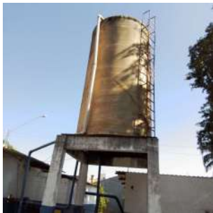
Foto 3 - Vista do Reservatório da ETA Domingos de Syllos em São José do Rio Pardo
