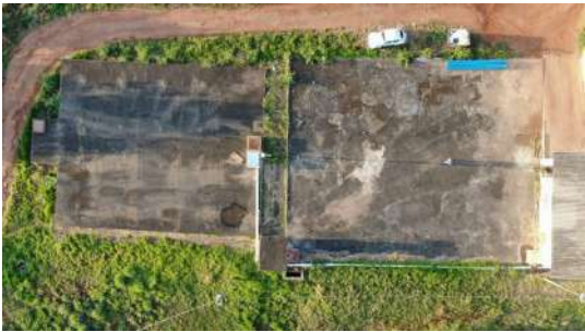
Foto 8 - Reservatório Cassucci II em São José do Rio Pardo
