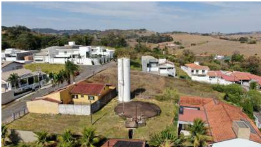
Foto 1 - Vista Geral do Reservatório São Roque 2 em São José do Rio Pardo
