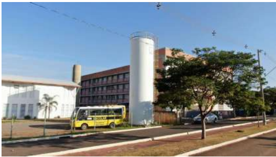
Foto 1 - Ausência de identificação no Reservatório da ETEC em São José do Rio Pardo
