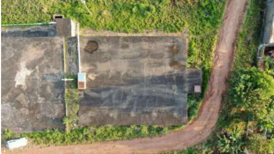
Foto 4 - Reservatório Cassucci II em São José do Rio Pardo
