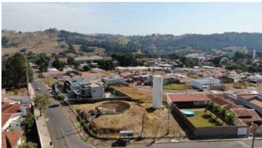
Foto 1 - Vista Geral do Reservatório Vila Formoso 2 em São José do Rio Pardo
