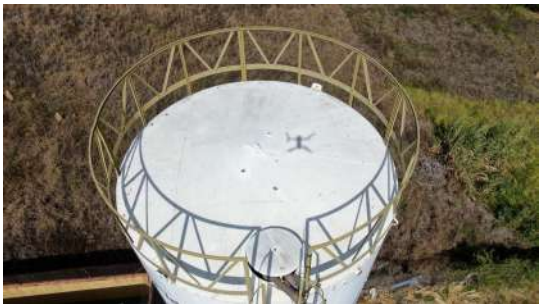
Foto 1 - Reservatório São Roque 1 em São José do Rio Pardo
