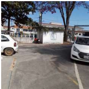
Foto 1 - ETA Central em São José do Rio Pardo
