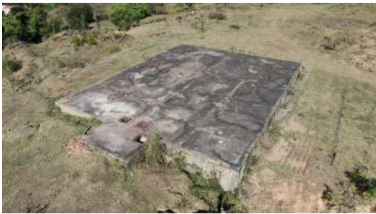
Foto 1 - Reservatório Maria Boaro em São José do Rio Pardo
