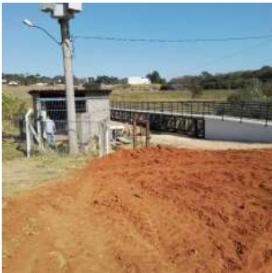
Foto 1 - Vista da Captação Sylos em São José do Rio Pardo
