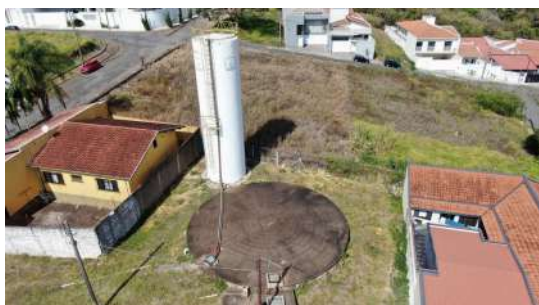
Foto 1 - Guarda-corpos no Reservatório São Roque 1 em São José do Rio Pardo
