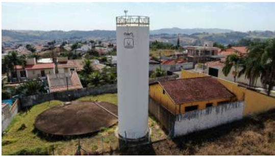
Foto 1 - Ausência de identificação no Reservatório São Roque 2 em São José do Rio Pardo
