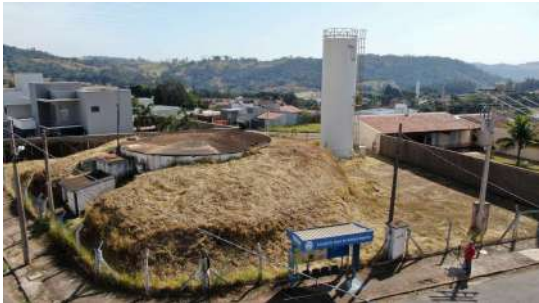
Foto 1 - Ausência de placa de identificação no Reservatório Vila Formoso 2 em São José do Rio Pardo
