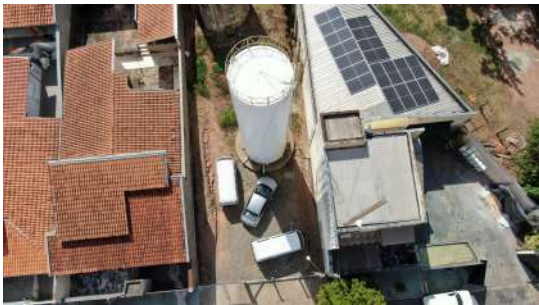
Foto 1 - Reservatório São Domingos 1 em São José do Rio Pardo
