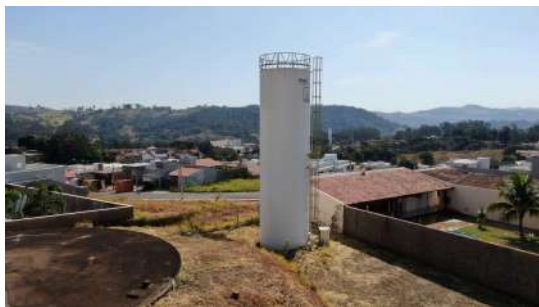
Foto 1 - Vista Geral do Reservatório Vila Formosa 1 em São José do Rio Pardo
