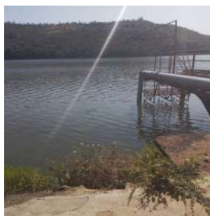
Foto 2 - Captação represa em São José do Rio Pardo
