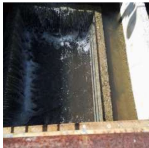
Foto 7 - ETA Santo Antônio em São José do Rio Pardo
