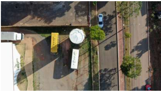
Foto 1 - Reservatório da ETEC em São José do Rio Pardo
