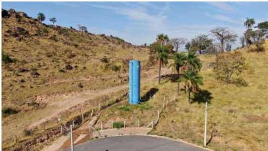
Foto 1 - Vista geral do Reservatório Mano Merli em São José do Rio Pardo
