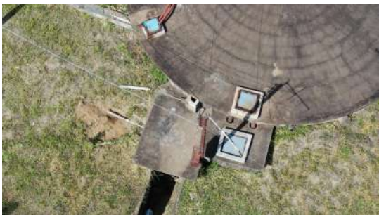
Foto 1 - Tampas de inspeção no Reservatório São Roque 2 em São José do Rio Pardo
