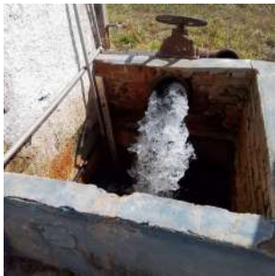
Foto 5 - Reservatório Cassucci II em São José do Rio Pardo
