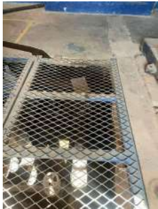
Foto 3 - Vazamento no registro da Captação Central em São José do Rio Pardo
