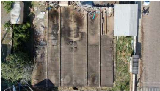
Foto 1 - Reservatório da ETA Central I em São José do Rio Pardo
