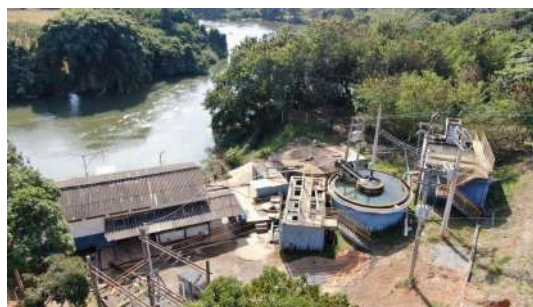
Foto 20 - ETA João de Souza em São José do Rio Pardo
