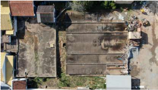
Foto 2 - Reservatório da ETA Central I em São José do Rio Pardo
