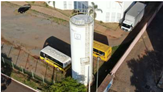
Foto 1 - Guarda-corpo do Reservatório da ETEC em São José do Rio Pardo
