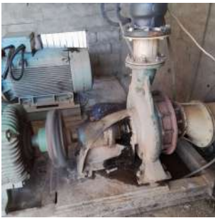
Foto 1 - Drenagem inadequada da água de lubrificação de gaxetas na Captação Sylos em São José do Rio Pardo
