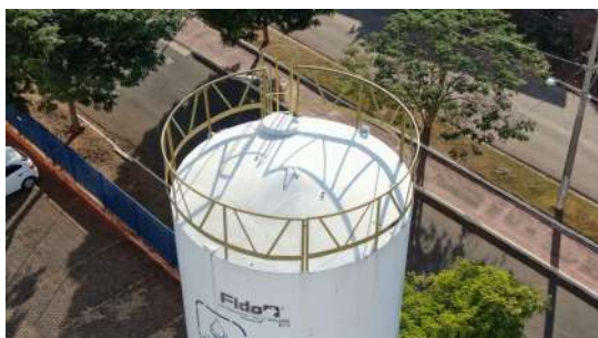
Foto 1 - Tampa de inspeção do Reservatório da ETEC em São José do Rio Pardo
