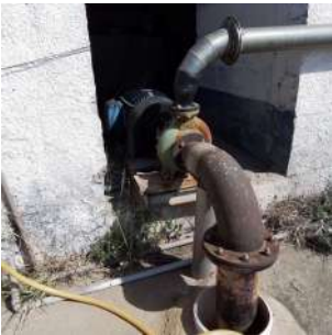
Foto 2 - Reservatório Cassucci II em São José do Rio Pardo
