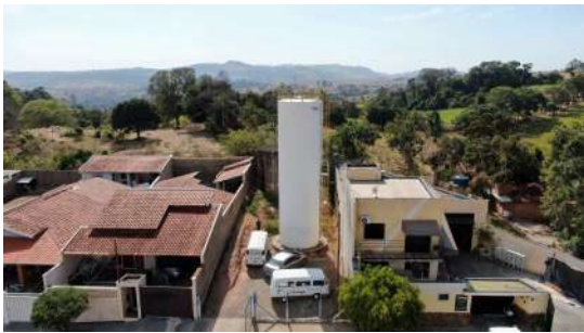
Foto 1 - Vista geral do Reservatório São domingos 2 em São José do Rio Pardo
