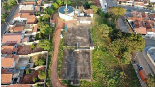
Foto 3 - Reservatório Cassucci II em São José do Rio Pardo
