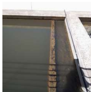
Foto 10 - ETA Santo Antônio em São José do Rio Pardo
