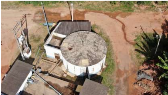
Foto 1 - Reservatório ETA Santo Antônio em São José do Rio Pardo
