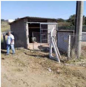
Foto 2 - Vista da Captação Sylos em São José do Rio Pardo
