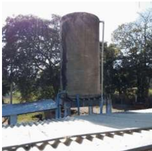
Foto 1 - Vista do Reservatório da ETA Domingos de Syllos em São José do Rio Pardo
