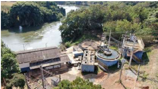
Foto 1 - Reservatório da ETA João de Souza em São José do Rio Pardo
