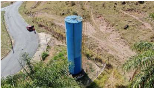
Foto 2 - Vista geral do Reservatório Mano Merli em São José do Rio Pardo
