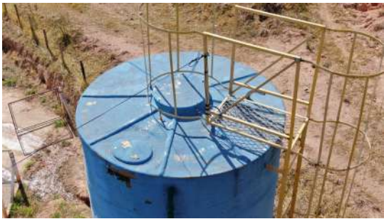
Foto 1 - Tampas de inspeção no Reservatório Mano Merli em São José do Rio Pardo
