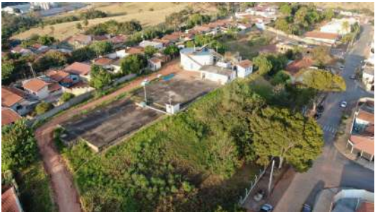
Foto 20 - ETA Cassucci em São José do Rio Pardo
