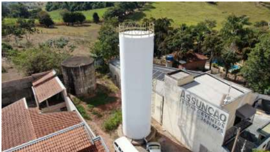
Foto 1 - Vista geral do Reservatório São Domingos 1 do Reservatório São Domingos 1 em São José do Rio Pardo
