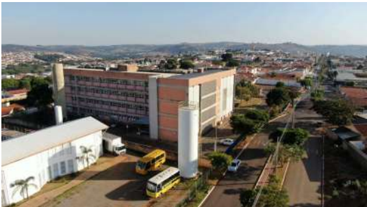
Foto 2 - Vista Geral do Reservatório da ETEC em São José do Rio Pardo
