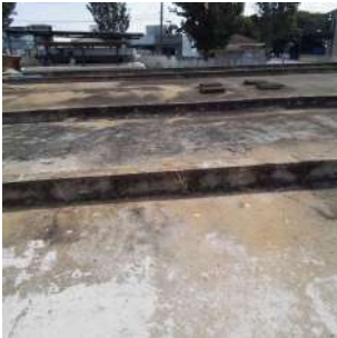
Foto 3 - Reservatório da ETA Central I em São José do Rio Pardo
