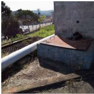
Foto 3 - Reservatório Cassucci II em São José do Rio Pardo
