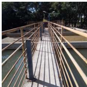
Foto 9 - ETA Santo Antônio em São José do Rio Pardo
