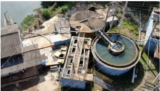
Foto 2 - Reservatório da ETA João de Souza em São José do Rio Pardo
