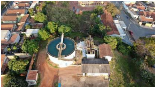
Foto 19 - ETA Cassucci em São José do Rio Pardo
