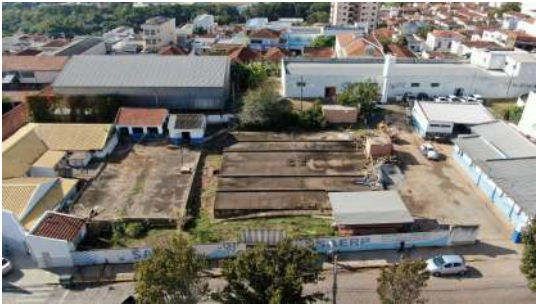
Foto 4 - Reservatório da ETA Central I em São José do Rio Pardo
