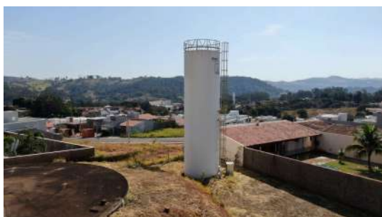
Foto 1 - Guarda-corpo no Reservatório Vila Formosa 1 em São José do Rio Pardo
