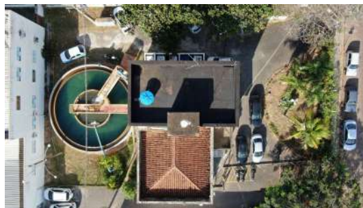
Foto 23 - ETA Central em São José do Rio Pardo
