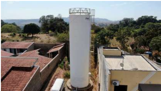
Foto 1 - Reservatório São domingos 2 em São José do Rio Pardo
