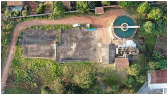
Foto 7 - Reservatório Cassucci II em São José do Rio Pardo
