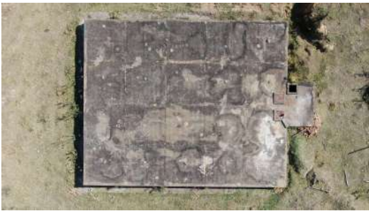
Foto 2 - Reservatório Maria Boaro em São José do Rio Pardo
