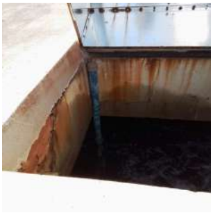
Foto 2 - Medidor de nível do Reservatório Cassucci II em São José do Rio Pardo
