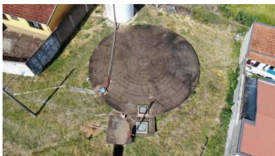
Foto 1 - Reservatório São Roque 2 em São José do Rio Pardo
