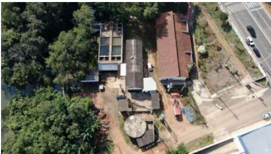
Foto 4 - Captação Santo Antônio em São José do Rio Pardo
