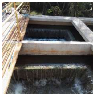
Foto 8 - ETA Santo Antônio em São José do Rio Pardo
