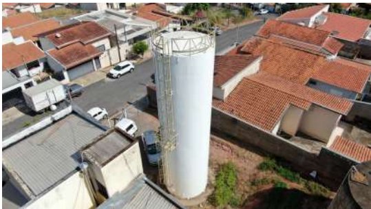
Foto 1 - Guarda-corpo do Reservatório São domingos 2 em São José do Rio Pardo
