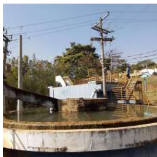
Foto 5 - ETA João de Souza em São José do Rio Pardo
