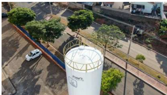
Foto 1 - Inexistência de para-raios do Reservatório da ETEC em São José do Rio Pardo
