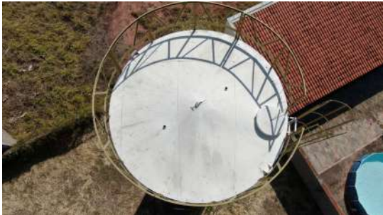
Foto 1 - Tampas de inspeção no Reservatório Vila Formosa 1 em São José do Rio Pardo
