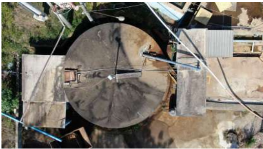
Foto 3 - Reservatório da ETA João de Souza em São José do Rio Pardo
