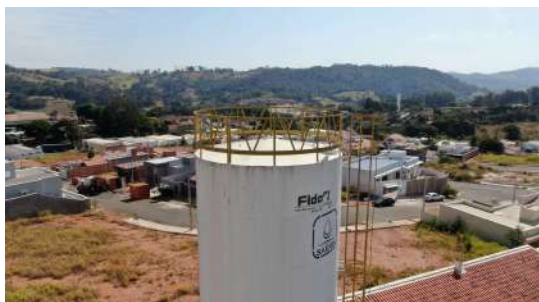
Foto 1 - Inexistência de para-raios no Reservatório Vila Formosa 1 em São José do Rio
