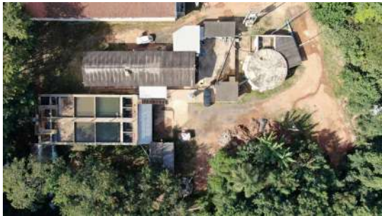
Foto 22 - ETA Santo Antônio em São José do Rio Pardo
