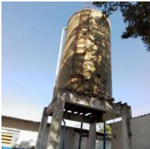
Foto 2 - Vista do Reservatório da ETA Domingos de Syllos em São José do Rio Pardo
