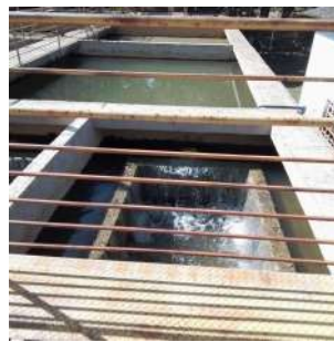
Foto 6 - ETA Santo Antônio em São José do Rio Pardo
