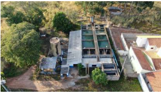
Foto 6 - Vista do Reservatório da ETA Domingos de Syllos em São José do Rio Pardo
