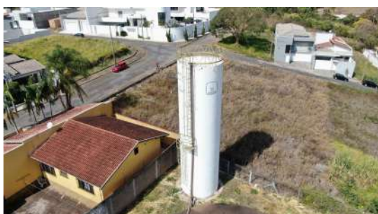
Foto 1 - Inexistência de para-raios no Reservatório São Roque 1 em São José do Rio Pardo
