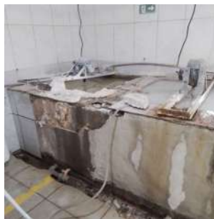
Foto 8 - Produtos químicos utilizados na ETA Central em São José do Rio Pardo
