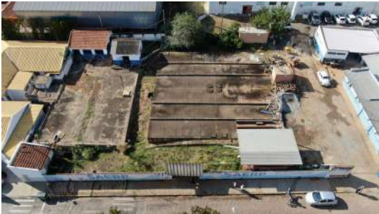
Foto 1 - Reservatório da ETA Central 2 em São José do Rio Pardo
