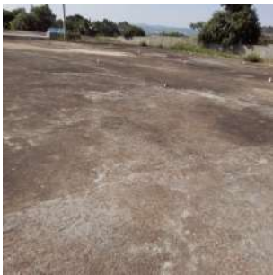
Foto 6 - Reservatório Cassucci II em São José do Rio Pardo
