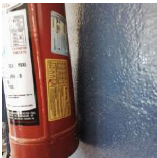
Foto 1 - Extintor de incêndio com validade expirada na Captação Central em São José do Rio Pardo
