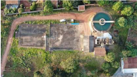
Foto 17 - ETA Cassucci em São José do Rio Pardo
