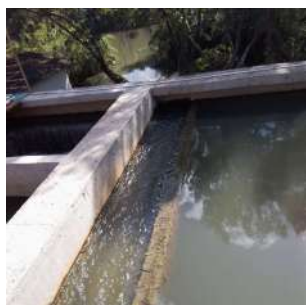
Foto 11 - ETA Santo Antônio em São José do Rio Pardo
