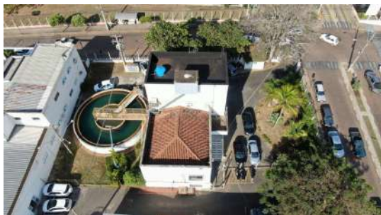
Foto 22 - ETA Central em São José do Rio Pardo
