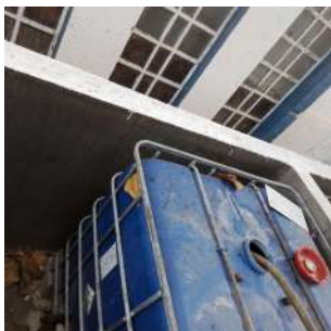
Foto 3 - Produtos químicos em tanque sem tampa e na parte externa. Materiais estranhos a operação da ETA Central em São José do Rio Pardo
