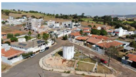
Foto 1 - Ausência de identificação no Reservatório Margarida em São José do Rio Pardo
