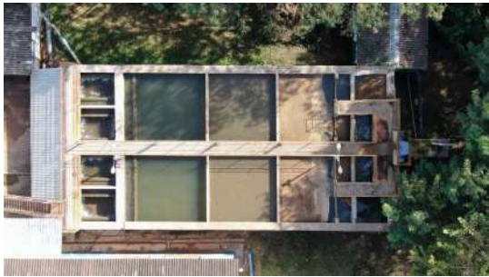
Foto 20 - ETA Santo Antônio em São José do Rio Pardo
