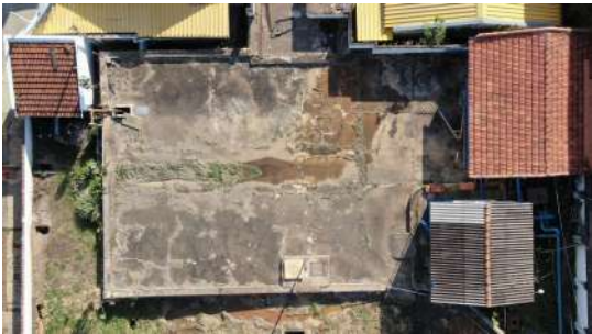
Foto 3 - Reservatório da ETA Central 2 em São José do Rio Pardo
