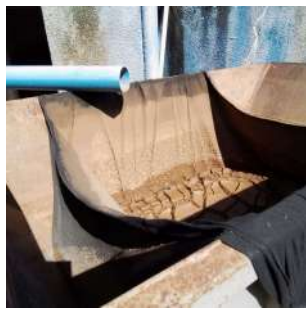
Foto 13 - Tratamento de lodo da ETA João de Souza em São José do Rio Pardo
