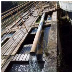
Foto 3 - ETA João de Souza em São José do Rio Pardo
