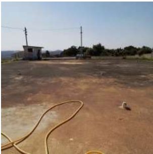
Foto 1 - Reservatório Cassucci II em São José do Rio Pardo
