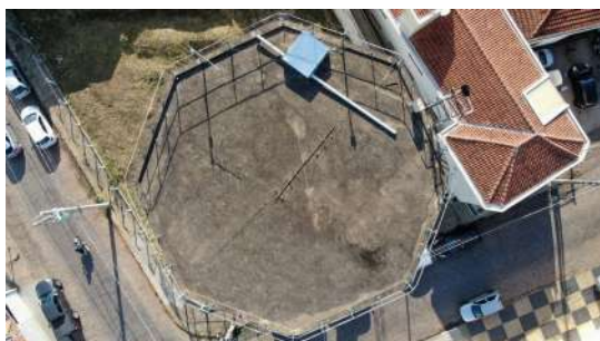
Foto 1 - Tampas de inspeção no Reservatório Chuveirão em São José do Rio Pardo
