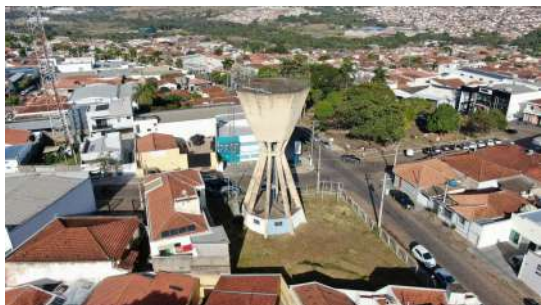
Foto 1 - Área cercada no Reservatório Chuveirão em São José do Rio Pardo
