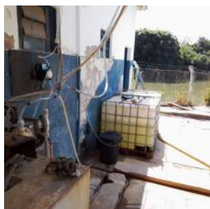
Foto 1 - Tanque de armazenamento de produto químico exposto ao ambiente externo na ETA João de Souza em São José do Rio Pardo
