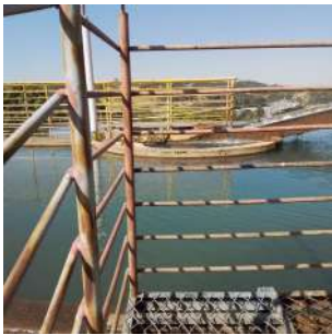
Foto 14 - ETA Cassucci em São José do Rio Pardo
