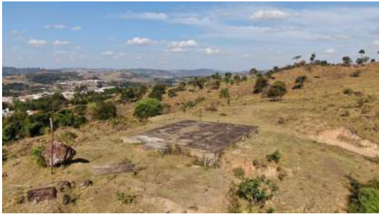
Foto 1 - Ausência de cerca no Reservatório Maria Boaro em São José do Rio Pardo
