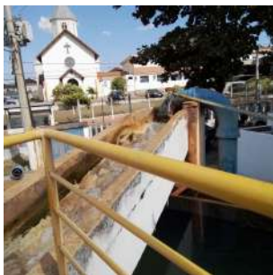
Foto 14 - ETA Central em São José do Rio Pardo
