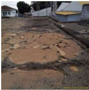
Foto 3 - Trincas na estrutura do Reservatório da ETA Central 2 em São José do Rio Pardo
