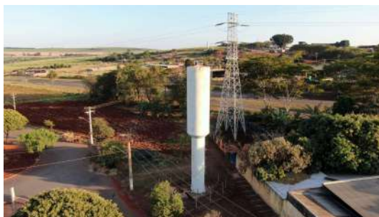
Foto 2 - Abertura do extravasor no topo.
