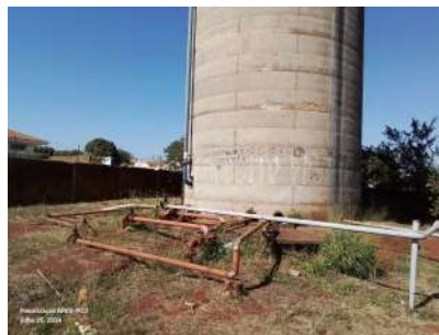
Foto 2 - Vista geral do reservatório.
