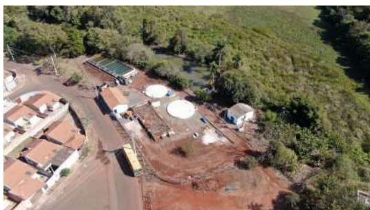
Foto 14 - Vista superior da ETA.
