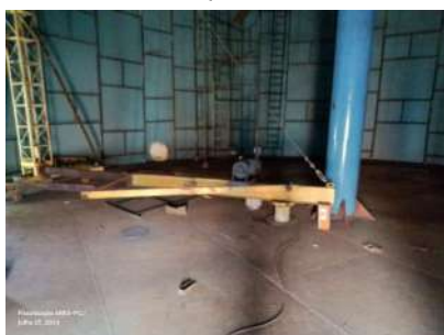
Foto 5 - Vista interna do reservatório com andaimes para reforma.
