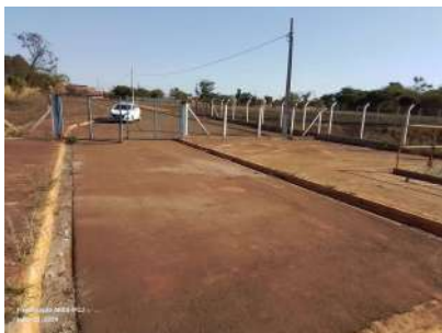
Foto 1 - Acesso para manutenção.
