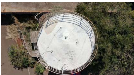
Foto 1 - Tampa de inspeção.
