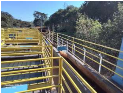
Foto 2 - Guarda-corpos da parte superior da ETA.
