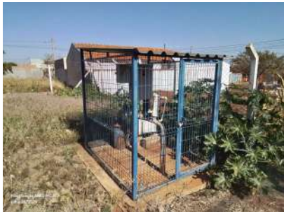
Foto 3 - Vista geral do poço.
