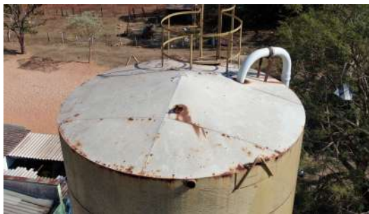
Foto 2 - Respiro sem tela de proteção.
