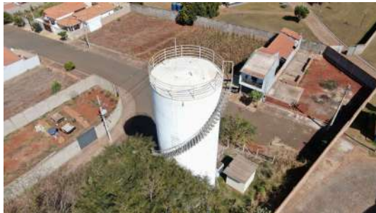
Foto 4 - Vista geral do reservatório.
