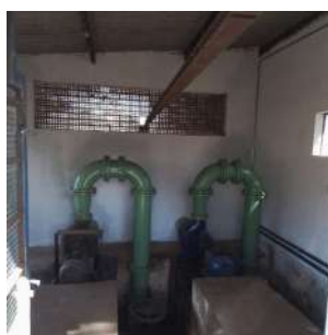
Foto 2 - Interior e estrutura para manutenção.
