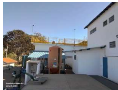
Foto 2 - Vista externa na lateral do laboratório da ETA.
