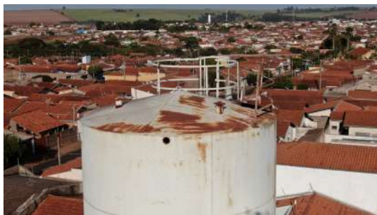
Foto 1 - Tubos de ventilação.
