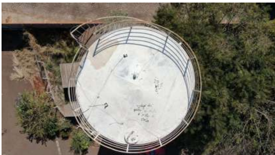
Foto 7 - Vista geral do reservatório.
