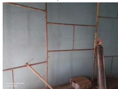
Foto 4 - Proteção das paredes do interior com tinta epoxi.
