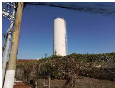
Foto 2 - Vista geral do reservatório.
