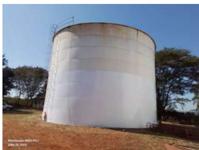
Foto 7 - Vista do reservatório Talamoni I.
