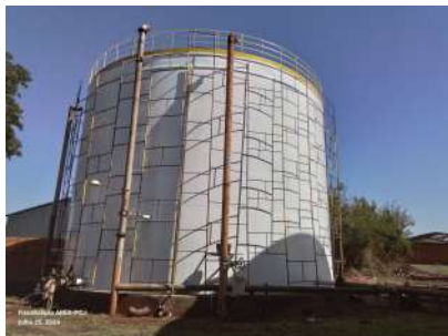
Foto 1 - Vista externa do reservatório com andaimes para reforma.
