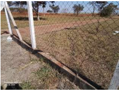
Foto 4 - Abertura 2 no cercamento.
