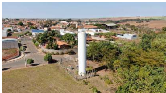
Foto 1 - Extravasor no topo do reservatório.
