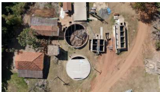
Foto 10 - Vista superior da ETA.
