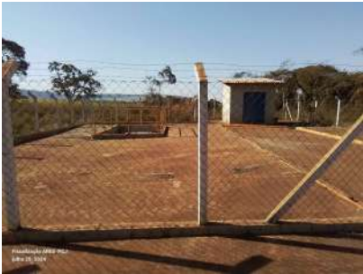
Foto 1 - Vista geral da elevatória.
