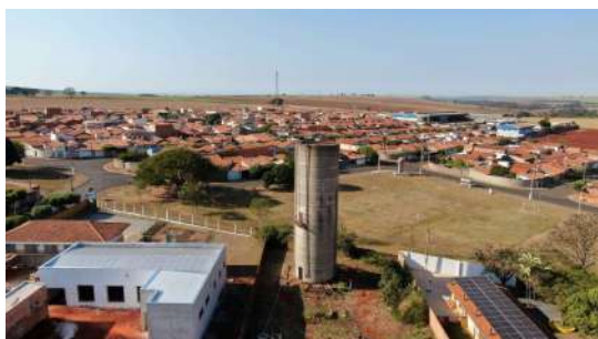
Foto 1 - Captor Franklin do reservatório.
