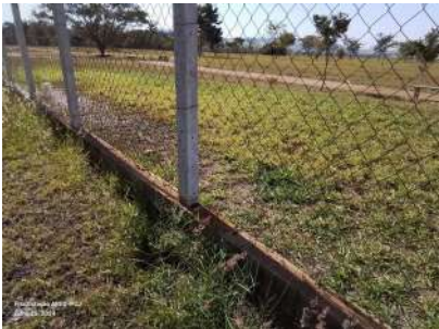
Foto 6 - Abertura 4 no cercamento.
