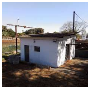
Foto 5 - Vista da elevatória de água bruta (captação do córrego Pessegueiro), situada na área da ETA Davi.
