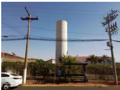
Foto 1 - Vista geral do reservatório.
