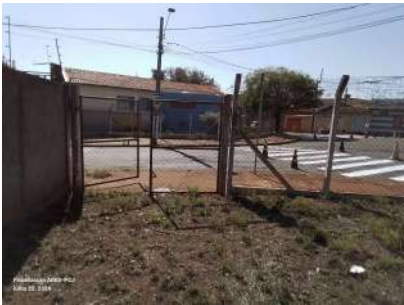
Foto 1 - Portão de acesso.
