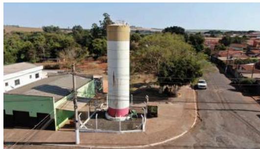
Foto 2 - Vista geral do reservatório.
