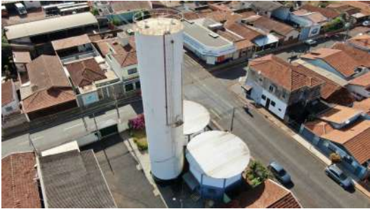
Foto 5 - Vista geral do reservatório.
