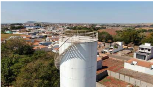
Foto 2 - Ausência de SPDA.
