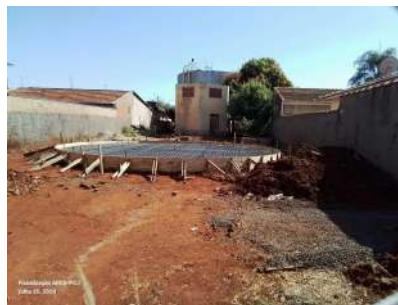
Foto 2 - Vista geral da área do novo reservatório.
