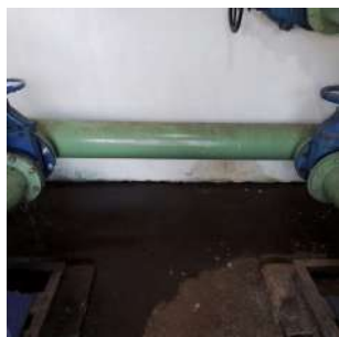
Foto 3 - Canaleta para escoamento da água.
