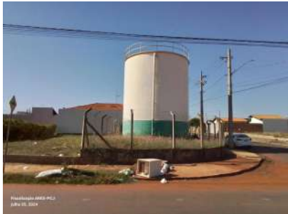
Foto 2 - Vista geral do reservatório.
