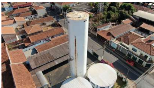
Foto 2 - Guarda-corpo do reservatório.
