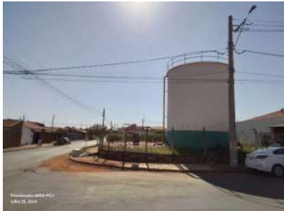
Foto 1 - Vista geral do reservatório.
