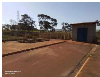
Foto 10 - Vista geral da elevatória.
