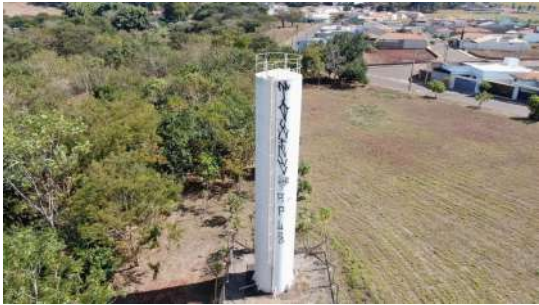
Foto 1 - Vista geral do reservatório.
