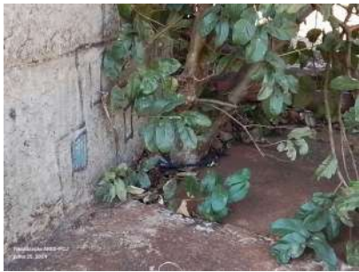
Foto 2 - Retirar goiabeira da estrutura.
