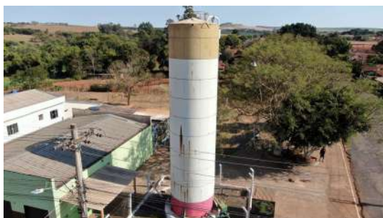
Foto 3 - Vista geral do reservatório.
