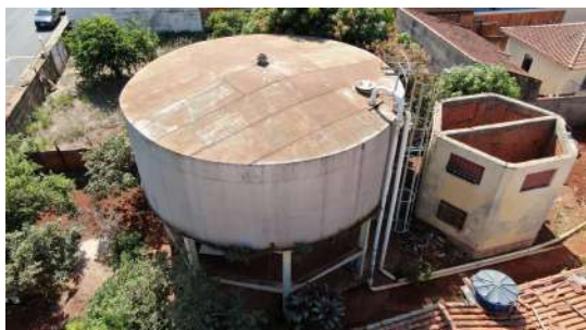
Foto 7 - Vista do reservatório desativado.
