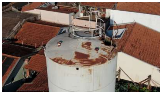
Foto 2 - Guarda-corpo do reservatório.
