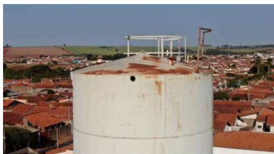
Foto 1 - Extravasor do reservatório.
