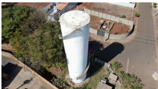
Foto 1 - Tubo extravasor no topo do reservatório.
