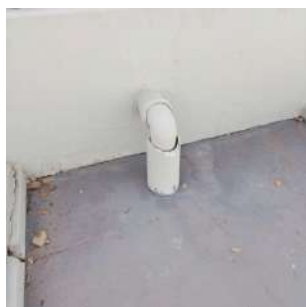
Foto 1 - Extravasor que encaminha água para caixas de passagem.
