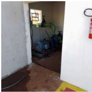
Foto 1 - Acesso para a elevatória.
