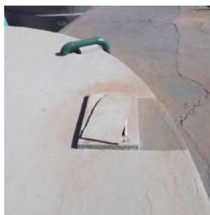
Foto 4 - Tampa de inspeção de concreto.
