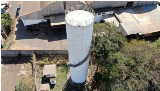
Foto 1 - Vista geral do reservatório.
