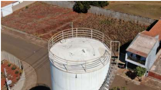
Foto 3 - Guarda-corpo do reservatório.
