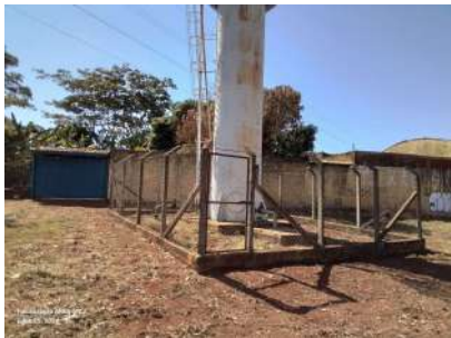
Foto 2 - Vista geral do reservatório.
