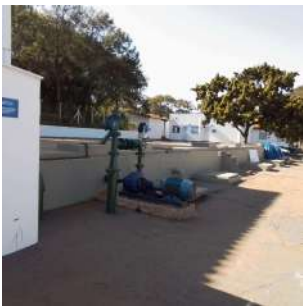
Foto 1 - Vista do reservatório, situado na área da ETA Davi.
