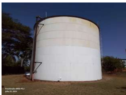
Foto 3 - Vista do reservatório Talamoni I.
