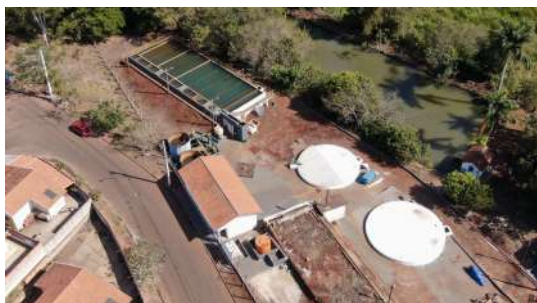
Foto 16 - Vista superior da ETA.
