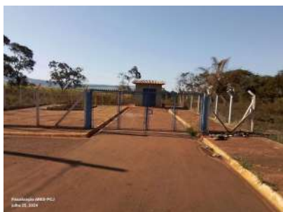
Foto 1 - Portão de acesso.
