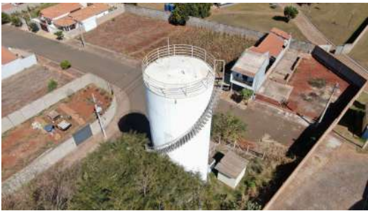
Foto 2 - Guarda-corpo do reservatório.
