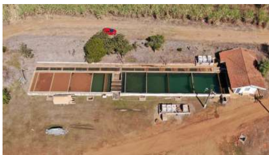
Foto 8 - Vista superior da ETA.
