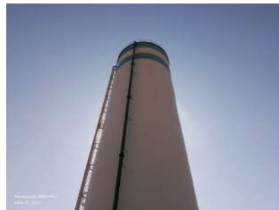
Foto 6 - Vista geral do reservatório.
