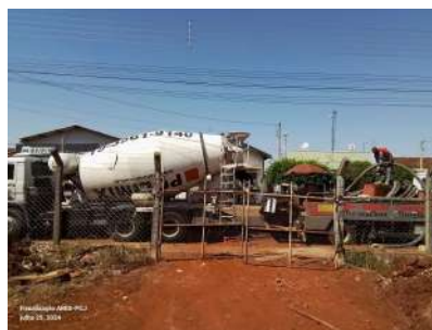
Foto 5 - Equipe de concretagem.
