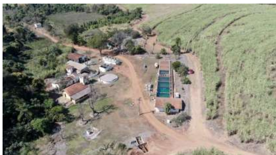
Foto 11 - Vista superior da ETA.
