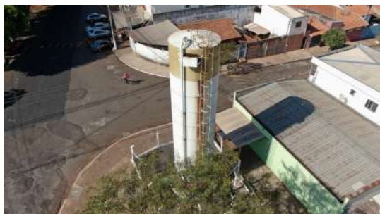
Foto 5 - Vista geral do reservatório.
