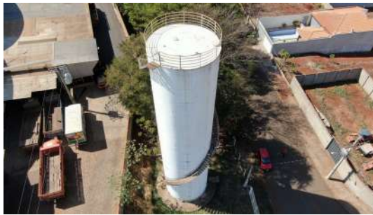
Foto 2 - Vista geral do reservatório.
