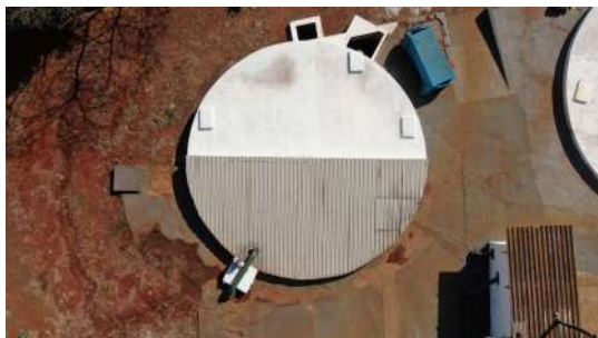
Foto 8 - Vista superior do reservatório da ETA.
