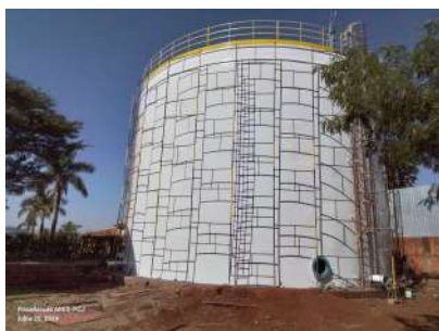
Foto 9 - Vista externa do reservatório com andaimes para reforma.
