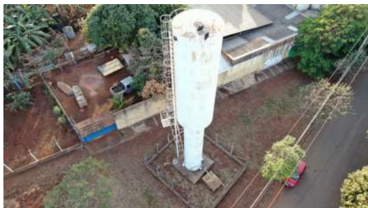
Foto 9 - Vista superior com imagem capturada por drone (28/07/2024).
