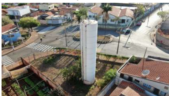
Foto 7 - Vista geral do reservatório.
