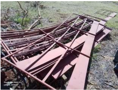
Foto 2 - Guarda-corpos a serem instalados.
