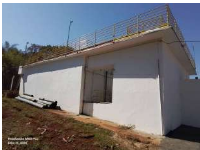
Foto 34 - Lateral da ETA - vista 1.
