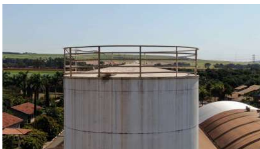
Foto 2 - Tampa de inspeção.
