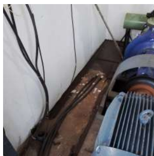
Foto 2 - Canaleta no perímetro da elevatória, para escoar a água de lubrificação.
