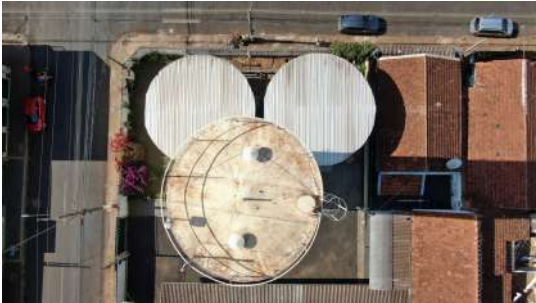
Foto 8 - Vista geral do topo do reservatório.
