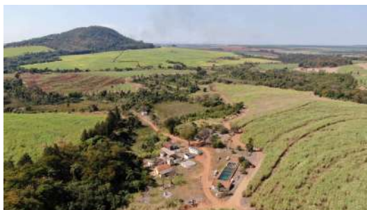
Foto 12 - Vista superior da ETA.
