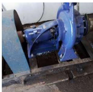
Foto 1 - Lubrificação da gaxeta de uma das bombas.
