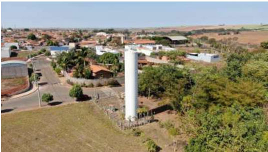
Foto 4 - Vista geral do reservatório.
