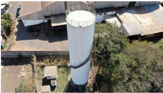
Foto 1 - Guarda-corpo do reservatório.
