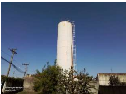
Foto 3 - Vista geral do reservatório.
