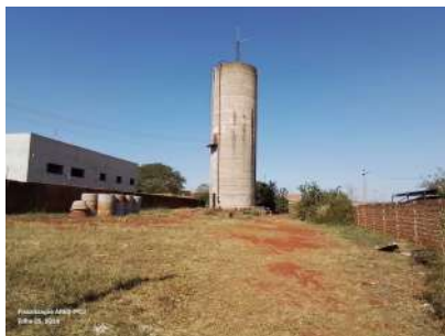
Foto 1 - Vista geral do reservatório.
