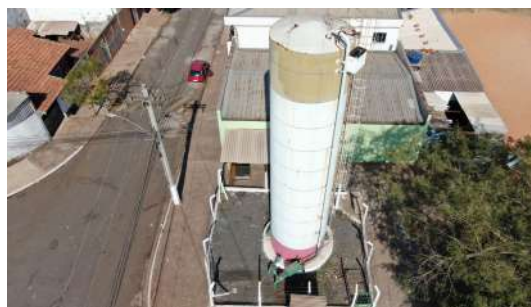
Foto 4 - Vista geral do reservatório.
