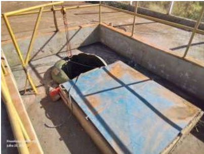
Foto 2 - Vista do poço da elevatória.
