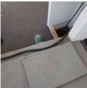
Foto 3 - Tubulação de entrada do reservatório.
