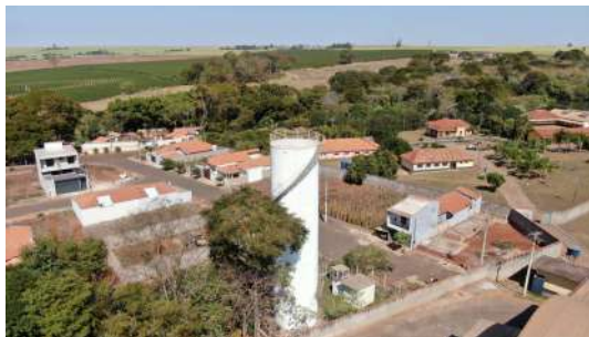
Foto 8 - Vista geral do reservatório.
