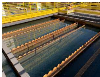
Foto 4 - Vertedores do decantador 1 - vista 2.
