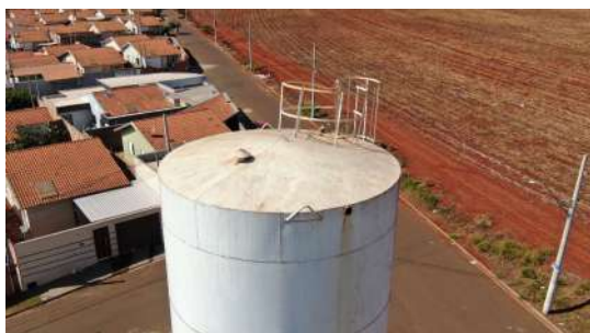
Foto 1 - Extravisor sem tela de proteção.
