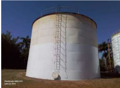
Foto 3 - Guarda-corpo da escada.
