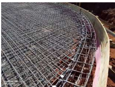
Foto 4 - Armação da nova base aguardando concretagem.
