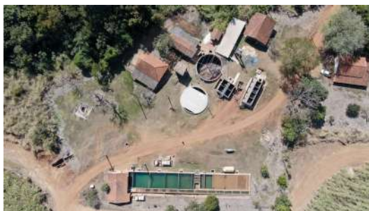
Foto 6 - Vista superior da ETA.
