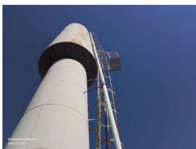
Foto 1 - Guarda-corpo da escada e patamar.
