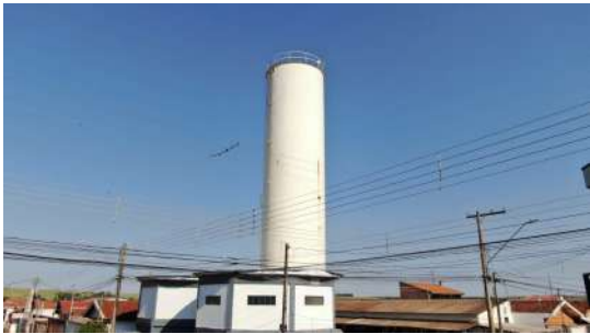
Foto 1 - Vista geral do reservatório.
