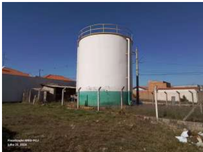
Foto 3 - Vista geral do reservatório.
