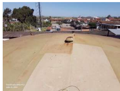
Foto 9 - Vista do topo do reservatório.
