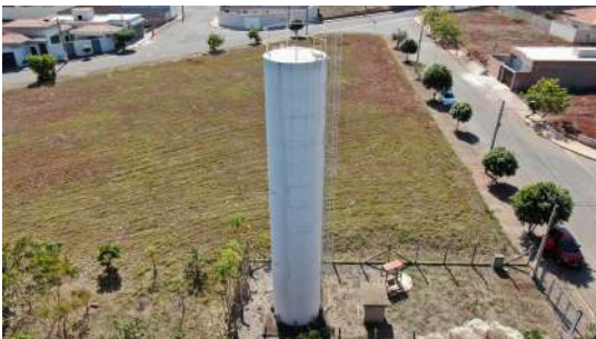
Foto 6 - Vista geral do reservatório.
