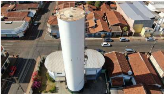
Foto 4 - Vista geral do reservatório.
