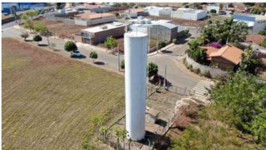
Foto 5 - Vista geral do reservatório.
