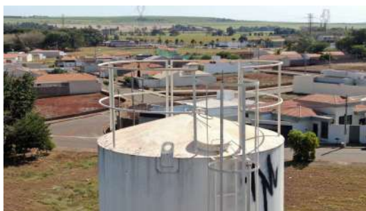
Foto 2 - Tampa de inspeção.
