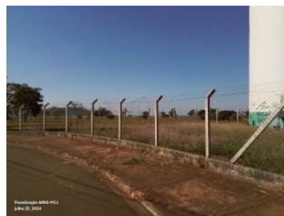
Foto 2 - Vista geral do cercamento.
