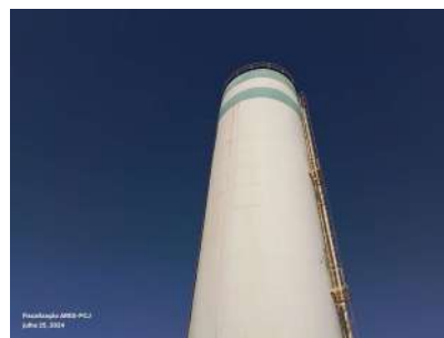
Foto 4 - Vista geral do reservatório.
