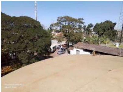
Foto 2 - Vista do almoxarifado.
