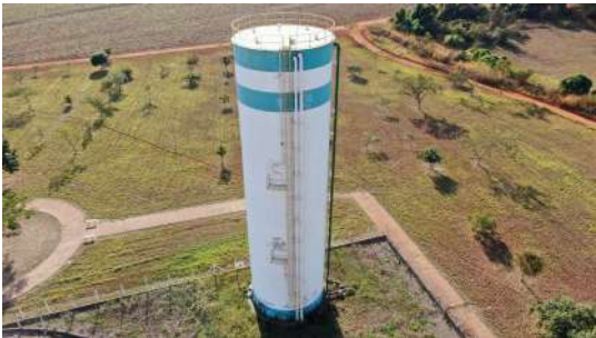
Foto 2 - Guarda-corpo do reservatório.
