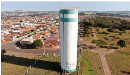
Foto 13 - Vista geral do reservatório.
