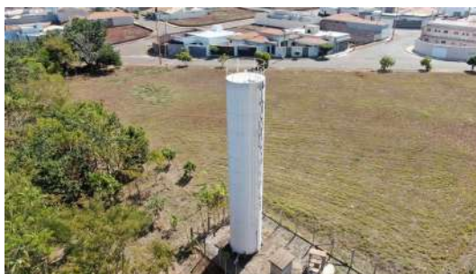
Foto 8 - Vista geral do reservatório.
