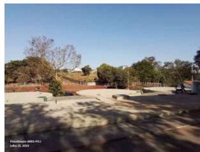
Foto 2 - Vista do alambrado do cercamento.
