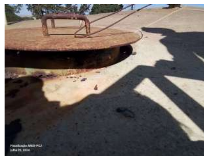
Foto 8 - Tampa de inspeção.
