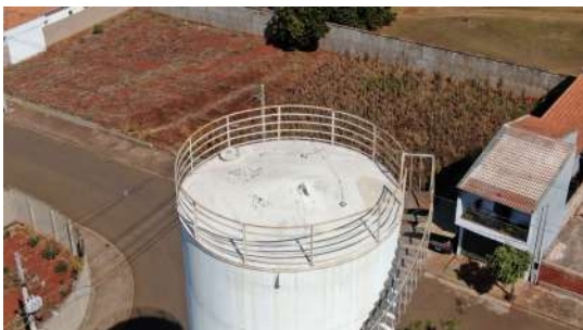
Foto 5 - Vista geral do reservatório.
