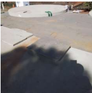
Foto 1 - Tampas de inspeção do reservatório.
