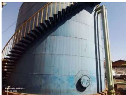
Foto 3 - Vista geral do reservatório.
