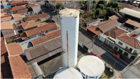
Foto 6 - Vista geral do reservatório.
