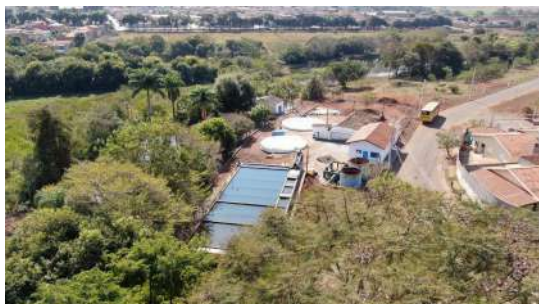
Foto 7 - Vista superior da ETA.
