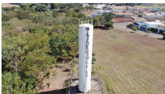
Foto 1 - Guarda-corpo do reservatório.
