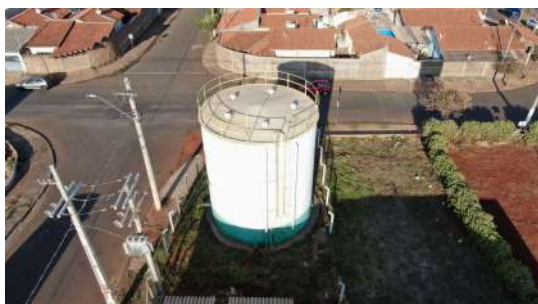
Foto 11 - Vista geral do reservatório.
