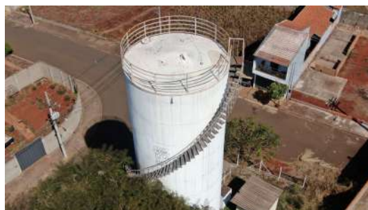
Foto 2 - Tubo extravasor no topo do reservatório.
