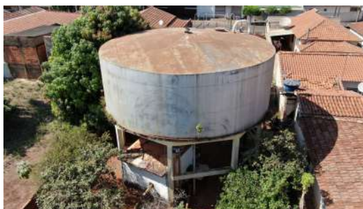
Foto 6 - Vista do reservatório desativado.
