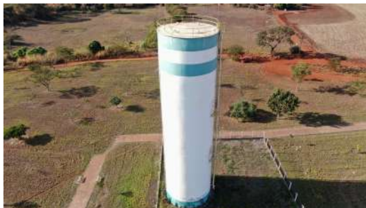
Foto 15 - Vista geral do reservatório.
