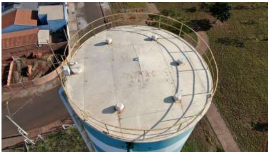
Foto 1 - Tampa de inspeção.
