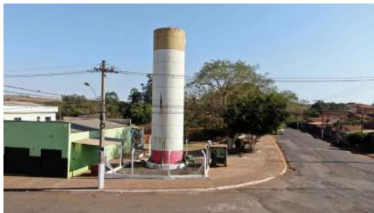
Foto 1 - Vista geral do reservatório.
