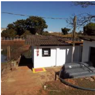
Foto 2 - Vista da elevatória.
