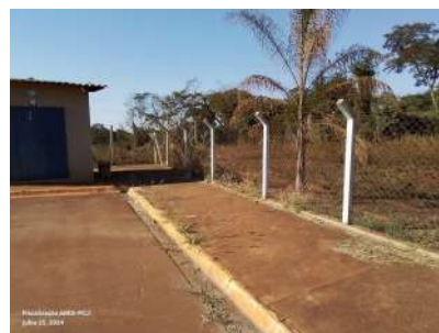
Foto 2 - Cercamento da área.
