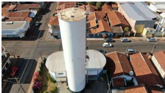
Foto 3 - Vazamento na estrutura metálica.
