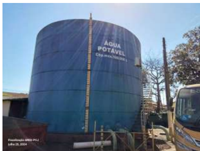
Foto 1 - Vista geral do reservatório.
