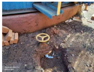
Foto 6 - Vista do dreno de fundo.
