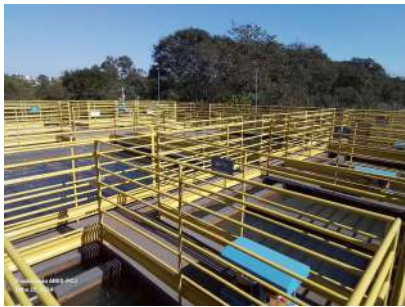
Foto 1 - Guarda-corpos da parte superior da ETA.
