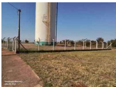
Foto 1 - Vista geral do cercamento.
