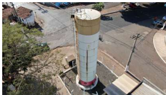
Foto 6 - Vista geral do reservatório.
