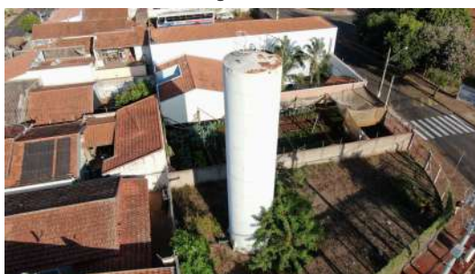
Foto 10 - Vista geral do reservatório.
