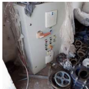
Foto 2 - Painel que será instalado após a ampliação da elevatória.
