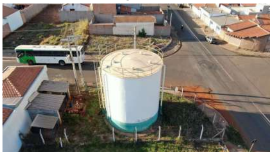
Foto 13 - Vista geral do reservatório.
