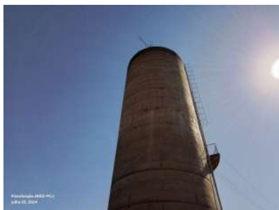
Foto 3 - Vista geral do reservatório.
