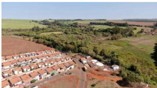
Foto 15 - Vista superior da ETA.
