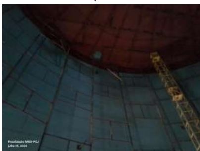
Foto 7 - Vista interna do reservatório com andaimes para reforma - vista tampa de inspeção.
