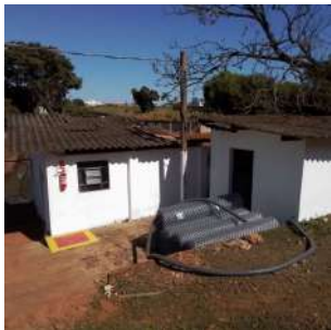
Foto 1 - Visão geral da elevatória. Observa-se alambrado estocado, para complementar o cercamento da área da ETA Davi.
