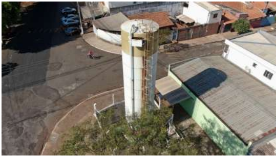
Foto 1 - Guarda-corpo do reservatório.
