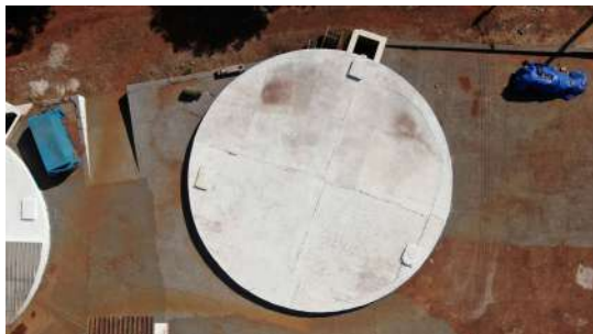
Foto 9 - Vista superior do reservatório da ETA.
