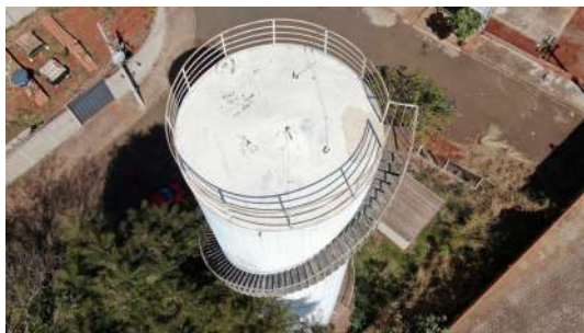
Foto 6 - Vista geral do reservatório.
