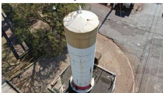
Foto 7 - Vista geral do reservatório.
