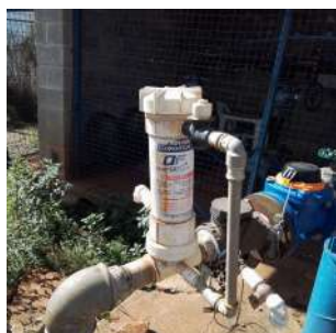
Foto 1 - Sistema de cloração por pastilhas de tricloro.
