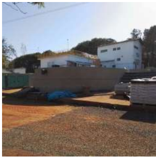
Foto 3 - Reservatórios e ETA Davi ao fundo.
