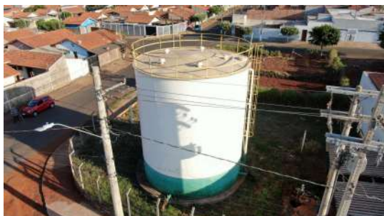
Foto 9 - Vista geral do reservatório.
