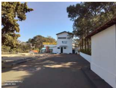
Foto 1 - Vista externa da ETA.
