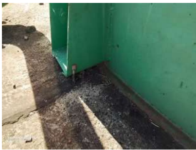
Foto 1 - Aterramento do reservatório.
