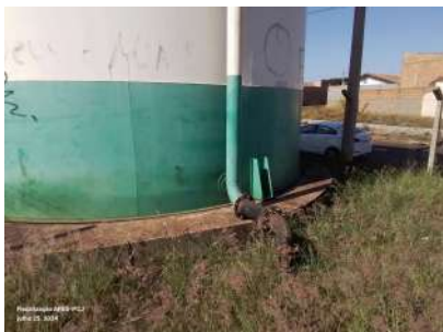
Foto 5 - Vista da entrada dos poços Varotti 2 e 3 (juntos).
