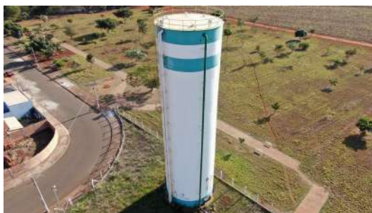
Foto 17 - Vista geral do reservatório.
