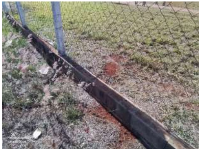
Foto 5 - Abertura 3 no cercamento.
