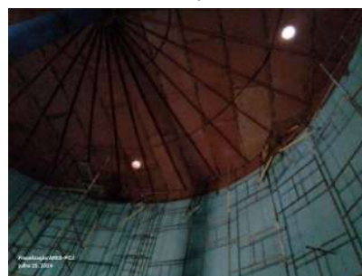
Foto 6 - Vista interna do reservatório com andaimes para reforma.
