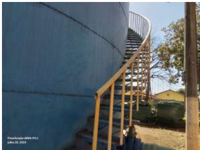
Foto 1 - Escada de acesso à parte superior.
