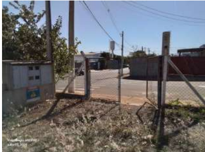
Foto 3 - Portão de acesso.
