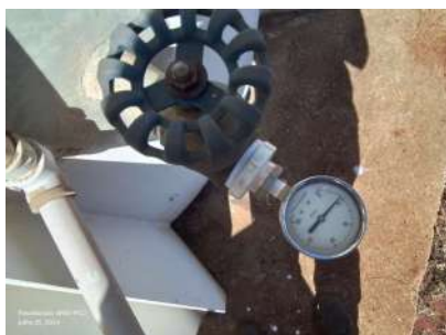
Foto 1 - Manômetro para medição de nível.
