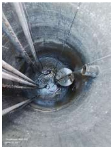
Foto 1 - Cesto sujo e sem manutenção.
