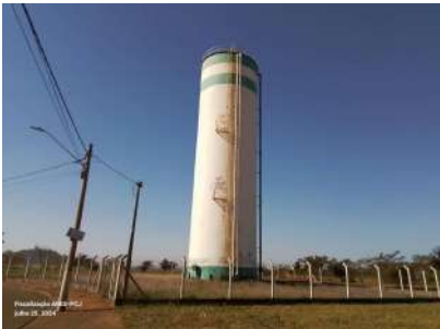
Foto 2 - Vista geral do reservatório.
