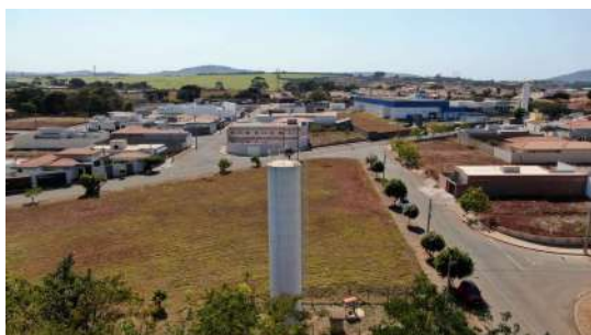
Foto 7 - Vista geral do reservatório.
