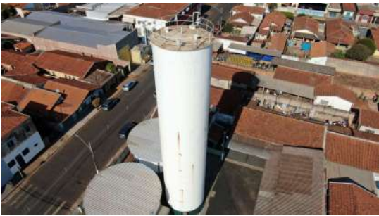
Foto 3 - Vista geral do reservatório.
