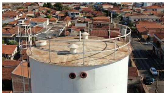
Foto 1 - Tubulação de ventilação.
