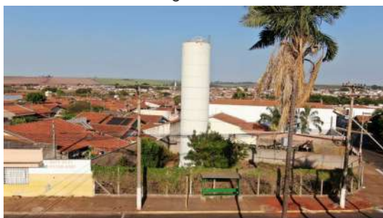
Foto 5 - Vista geral do reservatório.
