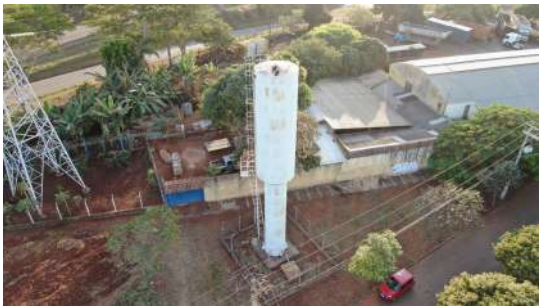
Foto 3 - Estrutura com oxidação.
