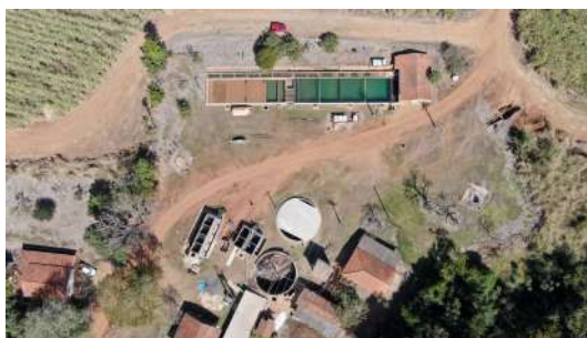
Foto 4 - Vista superior da ETA.
