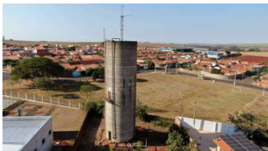
Foto 7 - Vista geral do reservatório.
