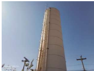
Foto 4 - Vista geral do reservatório.
