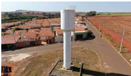
Foto 4 - Vista geral do reservatório.
