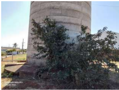
Foto 1 - Retirar goiabeira da estrutura.
