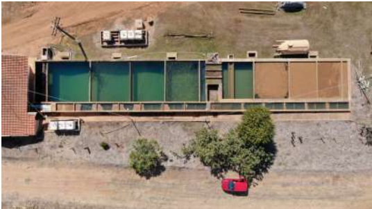
Foto 2 - Vista superior da ETA.
