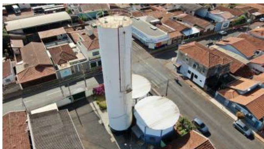
Foto 1 - Guarda-corpo do reservatório.
