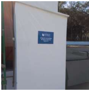
Foto 1 - Placa identificando a elevatória
