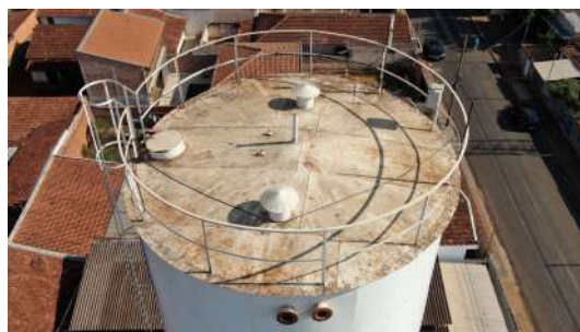
Foto 2 - Tubulação de ventilação.
