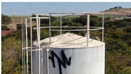
Foto 1 - Tampa de inspeção.
