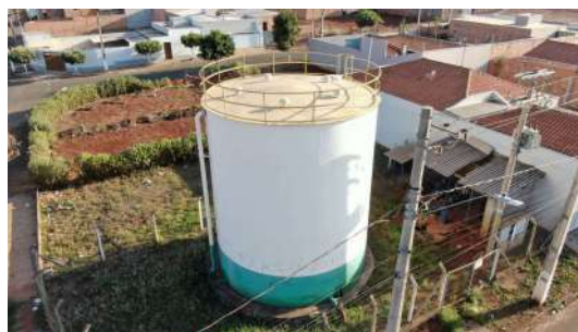
Foto 8 - Vista geral do reservatório.
