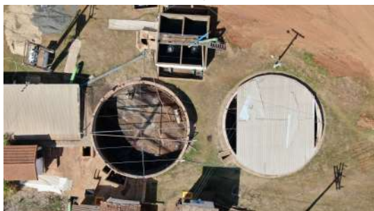
Foto 9 - Vista superior da ETA.
