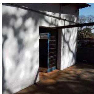
Foto 1 - Porta de acesso à elevatória.
