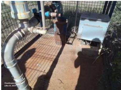
Foto 1 - Laje de proteção.
