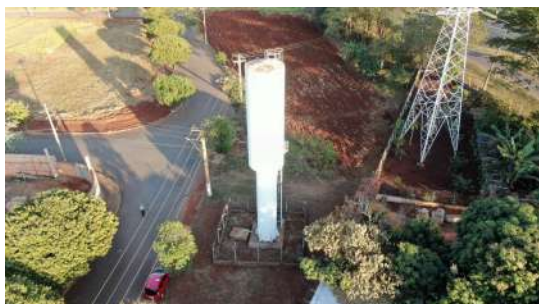
Foto 1 - Abertura do extravasor no topo.
