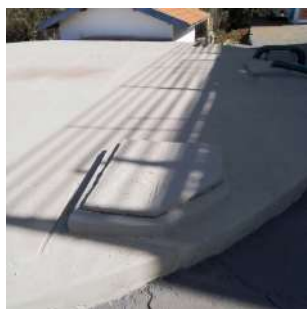
Foto 5 - Tampa de inspeção de concreto.
