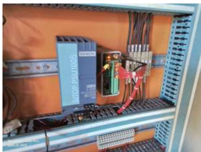
Foto 9 - Telemetria em instalação. Esquerda fonte e direita gprs.
