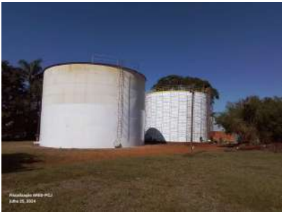
Foto 1 - Reservatórios Talamoni: I à frente, II ao fundo.
