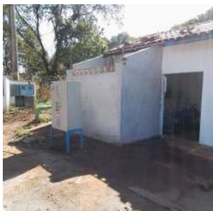
Foto 1 - A concessionária prevê a instalação de porta para segurança da elevatória.
