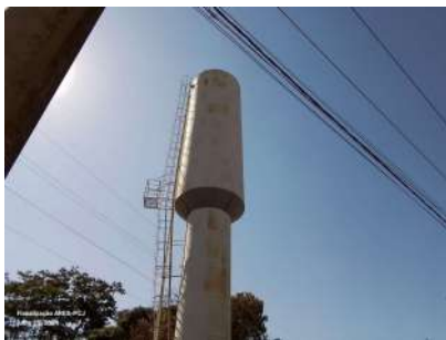
Foto 3 - Vista geral do reservatório.
