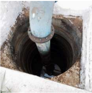
Foto 2 - Poço de sucção.
