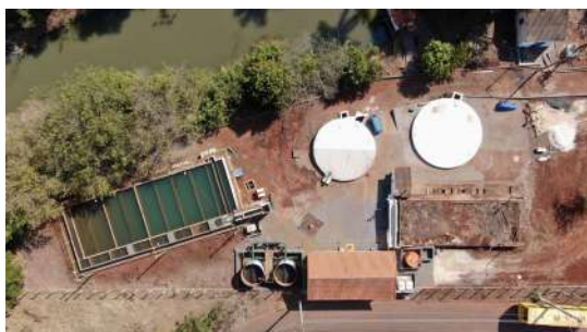
Foto 13 - Vista superior da ETA.
