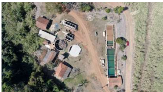
Foto 5 - Vista superior da ETA.
