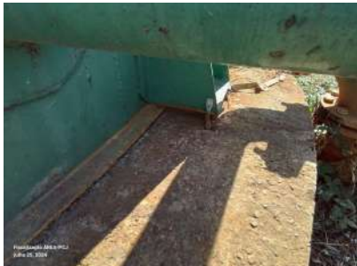
Foto 3 - Aterramento do reservatório.
