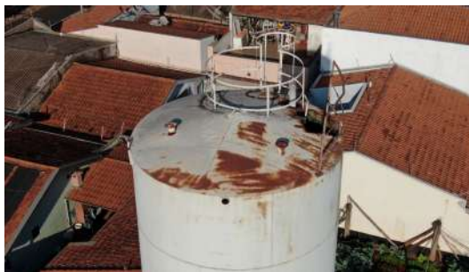
Foto 2 - Tubos de ventilação.
