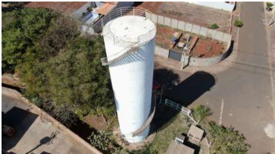
Foto 3 - Vista geral do reservatório.
