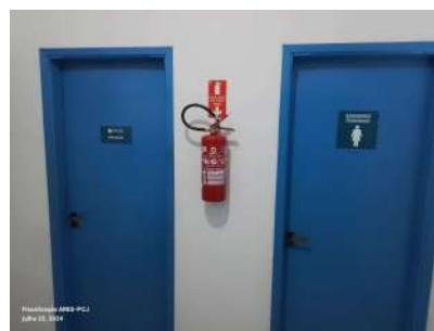
Foto 9 - Espaço para os funcionários e sala de controle de operação.
