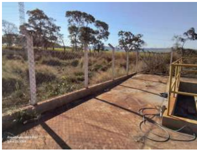
Foto 3 - Cercamento da área.
