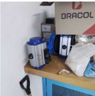
Foto 4 - Válvula que, segundo a concessionária, será instalado na entrada do reservatório blend. Será automatizada, operando conforme o nível.
