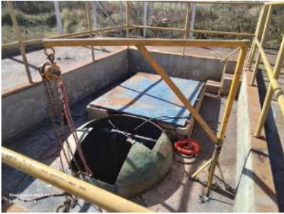
Foto 3 - Vista do poço da elevatória.
