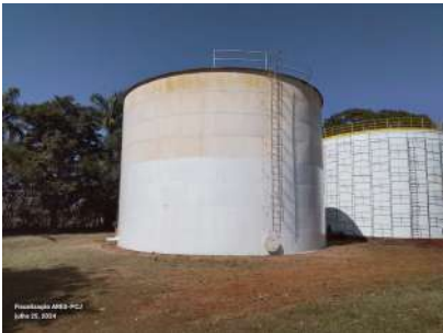
Foto 2 - Vista do reservatório Talamoni I.
