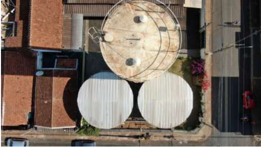
Foto 10 - Vista geral do topo do reservatório.
