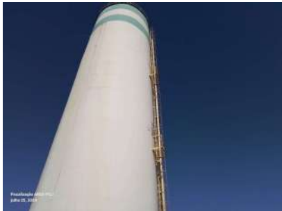
Foto 1 - Escada exterior com guarda-corpo e patamares.
