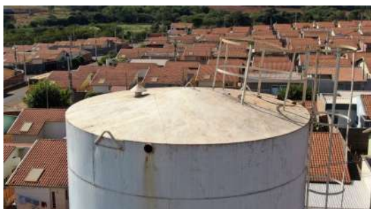
Foto 3 - Extravisor sem tela de proteção.
