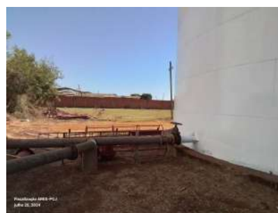
Foto 2 - Muro da lateral 2.
