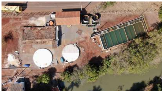
Foto 12 - Vista superior da ETA.
