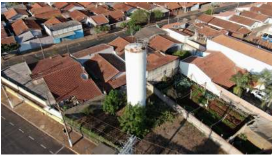
Foto 11 - Vista geral do reservatório.
