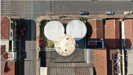
Foto 7 - Vista geral do topo do reservatório.
