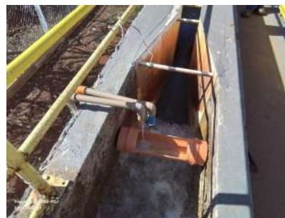
Foto 13 - Aplicação de PAC com diluição em água após calha Parshall.
