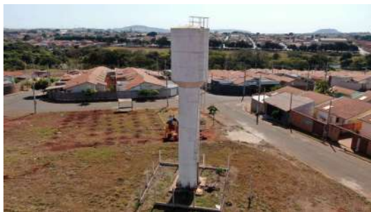
Foto 3 - Vista geral do reservatório.
