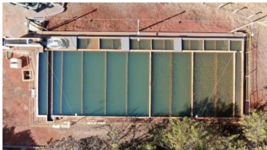
Foto 6 - Vista superior da ETA.
