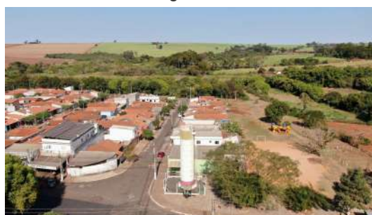
Foto 8 - Vista geral do reservatório.
