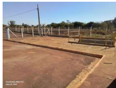
Foto 2 - Acesso para manutenção.
