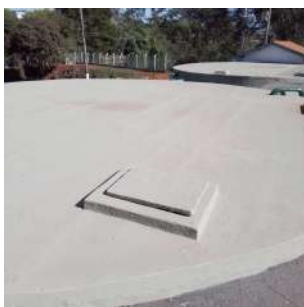
Foto 3 - Tampa de inspeção de concreto.
