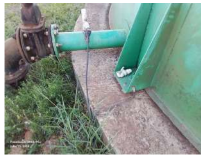
Foto 2 - Aterramento do reservatório.
