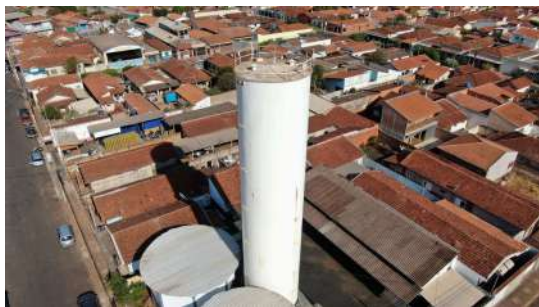
Foto 1 - Vazamento na estrutura metálica.
