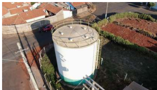
Foto 10 - Vista geral do reservatório.
