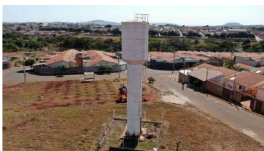
Foto 1 - Guarda-corpo do reservatório.
