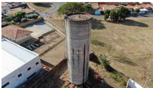
Foto 8 - Vista geral do reservatório.
