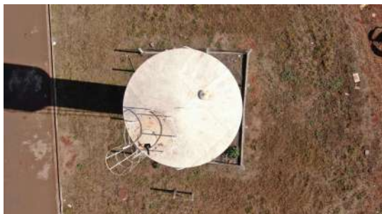
Foto 7 - Vista geral do reservatório.
