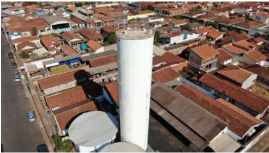
Foto 2 - Vista geral do reservatório.
