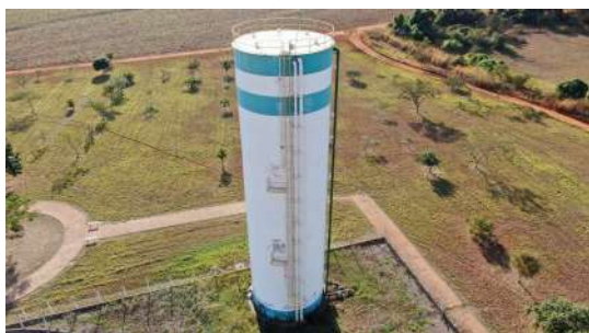
Foto 16 - Vista geral do reservatório.
