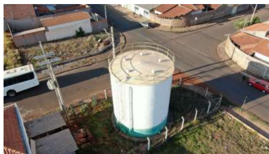
Foto 12 - Vista geral do reservatório.
