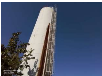
Foto 1 - Escaca com guarda-corpo.
