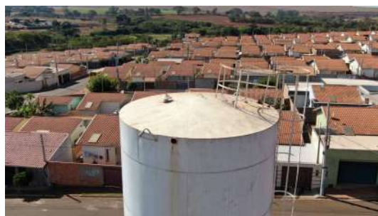
Foto 2 - Extravisor sem tela de proteção.
