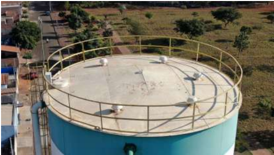
Foto 3 - Guarda-corpo do reservatório.
