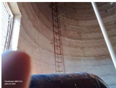
Foto 1 - Escada interior com guarda-corpo.
