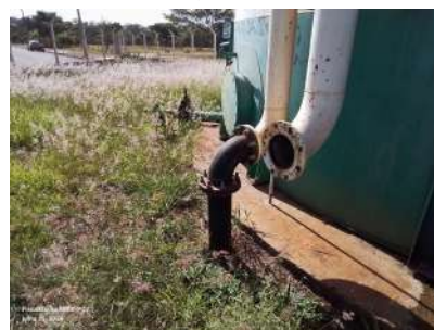
Foto 7 - Entrada proveniente do reservatório Varotti Pulmão.
