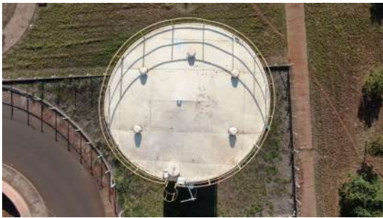
Foto 3 - Tubulação de ventilação.
