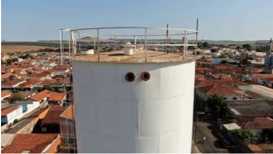
Foto 9 - Vista geral do topo do reservatório.
