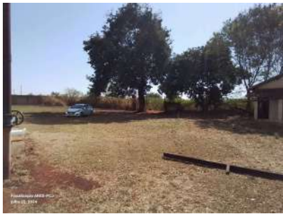
Foto 3 - Falta portão de acesso e consertar cerca próxima.
