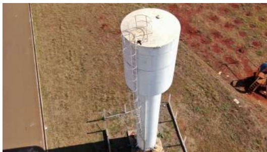
Foto 8 - Vista geral do reservatório.
