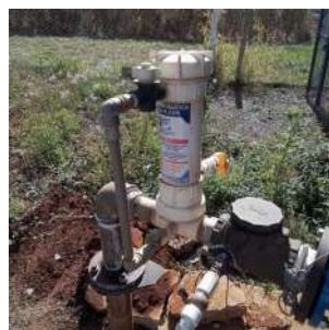
Foto 2 - Sistema de cloração por pastilhas de tricloro.
