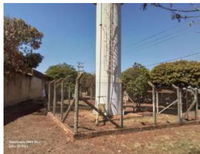
Foto 4 - Vista geral do reservatório.
