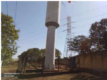
Foto 1 - Vista geral do reservatório.
