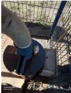
Foto 1 - Tubo de medição de nível do poço.
