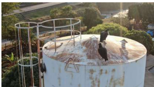
Foto 1 - Tubulação de ventilação.
