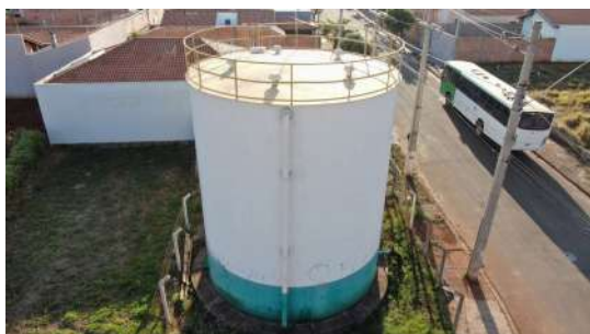
Foto 7 - Vista geral do reservatório.
