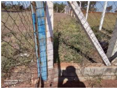
Foto 3 - Abertura 1 junto ao portão de acesso.
