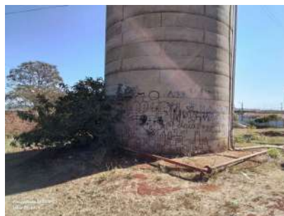
Foto 4 - Vista geral do reservatório.
