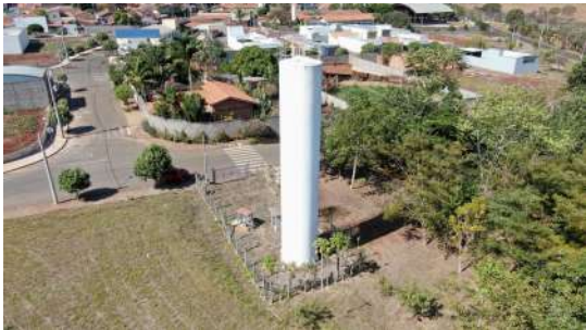
Foto 3 - Vista geral do reservatório.
