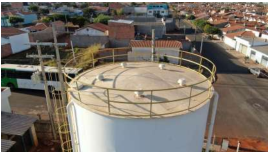
Foto 2 - Guarda-corpo do reservatório.
