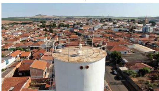
Foto 3 - Guarda-corpo do reservatório.
