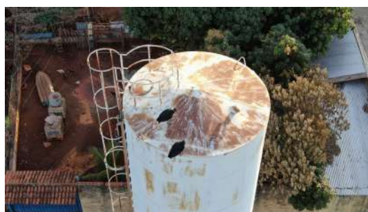
Foto 2 - Guarda-corpo do topo.
