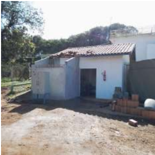
Foto 1 - Visão geral da elevatória. Observa-se que está passando por reforma para ampliação.
