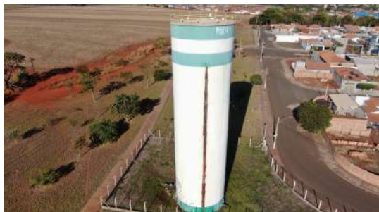
Foto 14 - Vista geral do reservatório.
