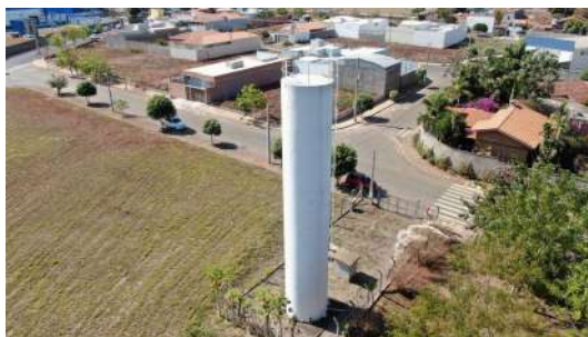
Foto 2 - Extravasor no topo do reservatório.
