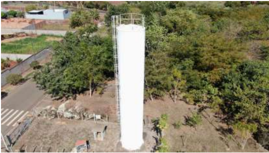
Foto 2 - Vista geral do reservatório.
