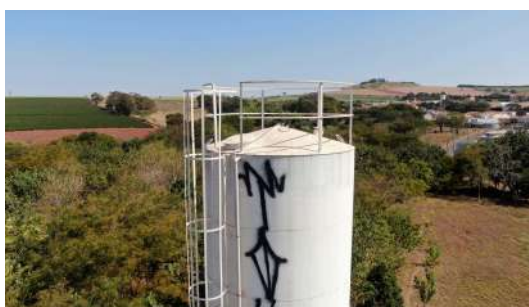
Foto 2 - Guarda-corpo do reservatório.
