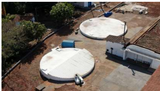
Foto 4 - Vista superior dos reservatórios da ETA.
