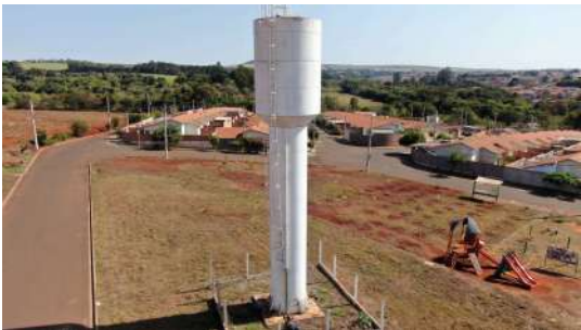
Foto 2 - Vista geral do reservatório.
