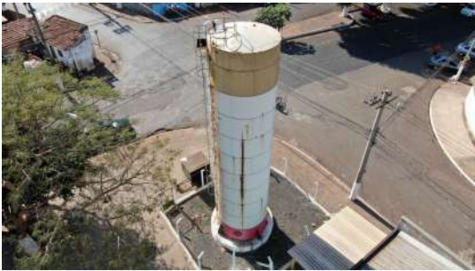
Foto 2 - Guarda-corpo do reservatório.
