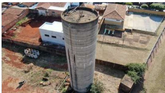
Foto 9 - Vista geral do reservatório.
