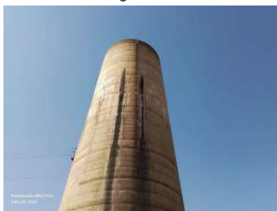
Foto 5 - Vista geral do reservatório.
