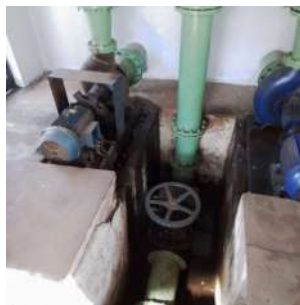
Foto 2 - Observa-se que a água chega a acumular no nível inferior, mas possui tubulação para drenagem.
