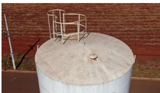
Foto 2 - Guarda-corpo do reservatório.
