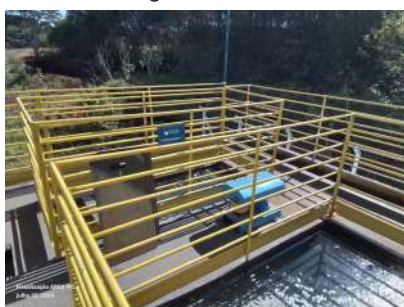
Foto 16 - Vista do floculador 1 (agitação alta).
