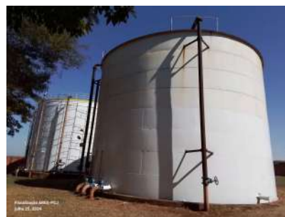
Foto 4 - Vista do reservatório Talamoni I.
