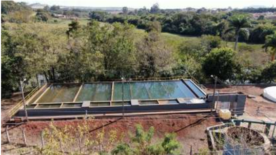
Foto 1 - Vista superior da ETA.
