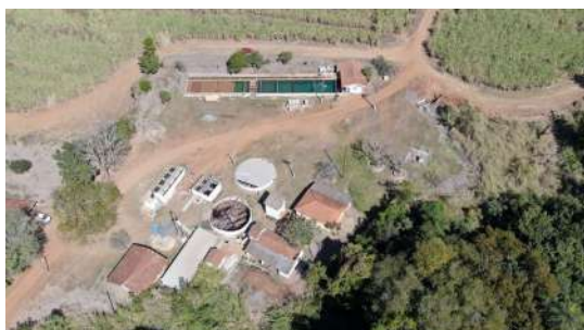
Foto 7 - Vista superior da ETA.
