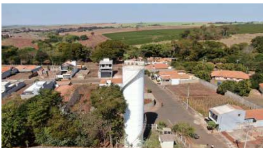
Foto 9 - Vista geral do reservatório.
