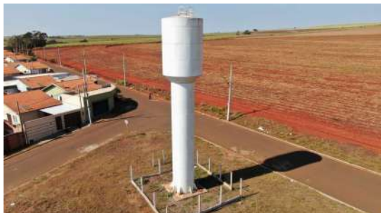
Foto 5 - Vista geral do reservatório.
