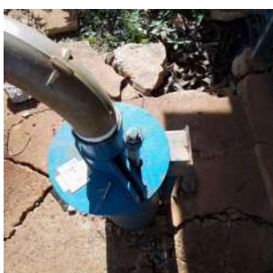
Foto 1 - Tubo para medição do nível do poço.
