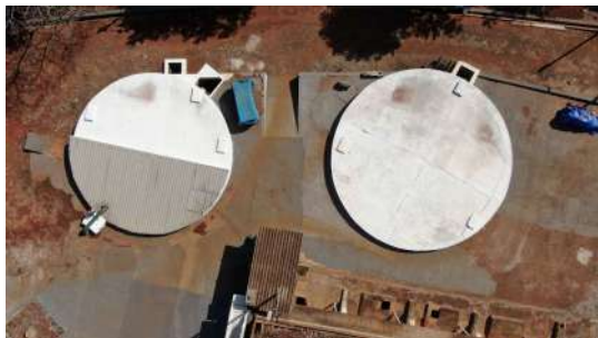
Foto 10 - Vista superior dos reservatórios da ETA.
