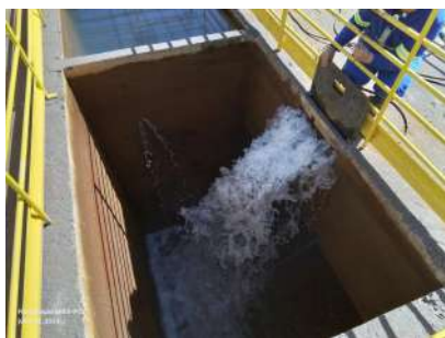
Foto 30 - Reabertura da comporta do filtro 1.
