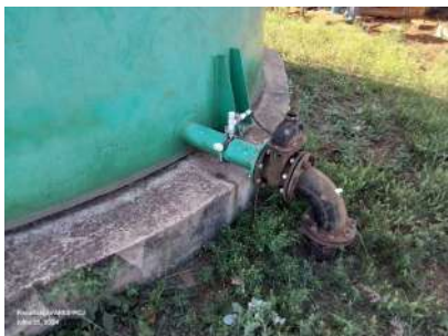
Foto 6 - Vista do dreno de fundo.
