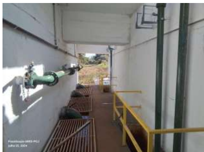
Foto 38 - Vão entre decantadores e filtros.
