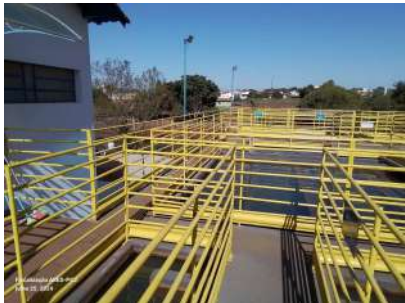
Foto 3 - Guarda-corpos da parte superior da ETA.
