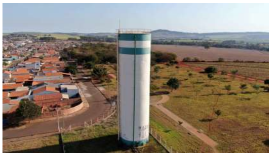
Foto 12 - Vista geral do reservatório.
