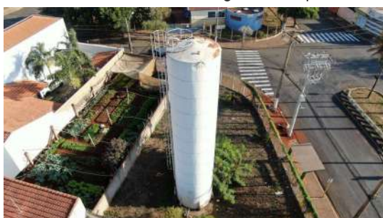
Foto 3 - Guarda-corpo do reservatório.
