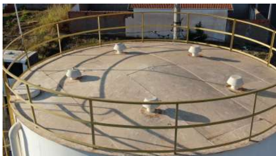
Foto 1 - Tampa de inspeção.
