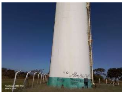
Foto 3 - Vista geral do reservatório.
