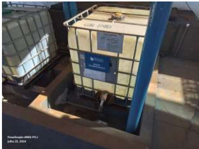
Foto 3 - Baia de detenção e container do ácido fluossilícico.
