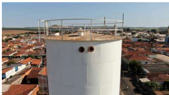
Foto 1 - Extravadores do reservatório.
