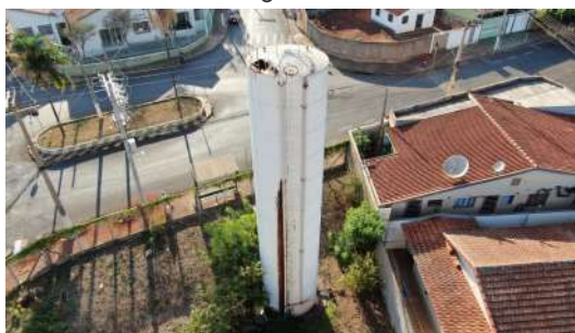
Foto 6 - Vista geral do reservatório.
