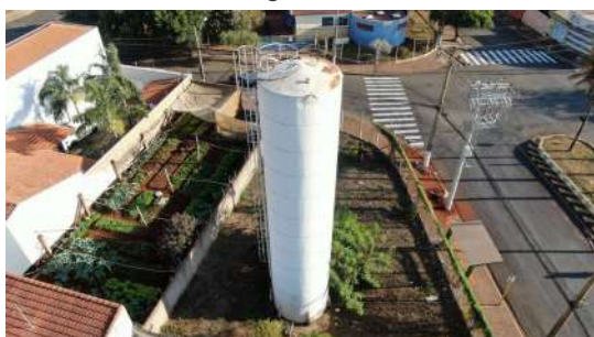
Foto 9 - Vista geral do reservatório.
