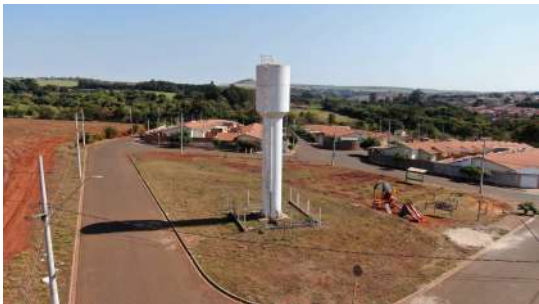
Foto 1 - Vista geral do reservatório.
