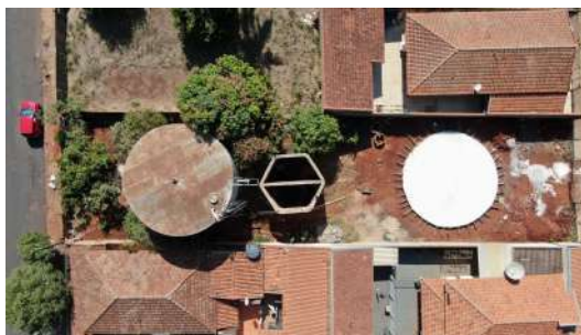
Foto 8 - Imagem capturada pelo drone (28/07/2024) com base já concretada.
