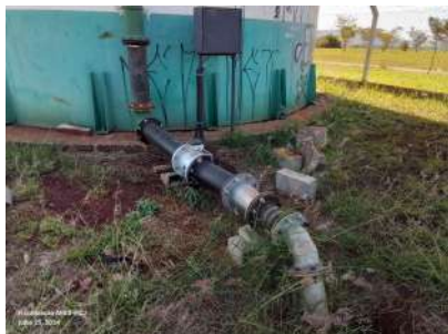
Foto 5 - Entrada proveniente do reservatório ETA Davi Blend.
