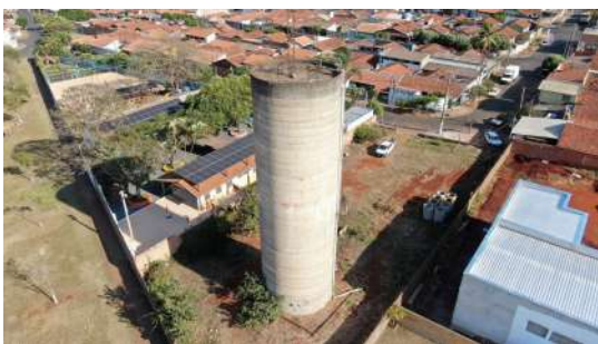
Foto 11 - Vista geral do reservatório.
