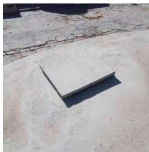
Foto 2 - Tampa de inspeção de concreto.
