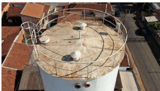
Foto 2 - Tapa de inspeção.
