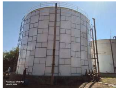
Foto 2 - Vista externa do reservatório com andaimes para reforma.
