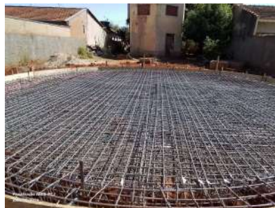
Foto 3 - Armação da nova base aguardando concretagem.
