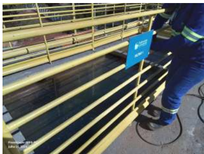
Foto 14 - Manobra de comporta para operação de lavagem do filtro 1.
