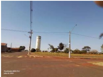
Foto 1 - Vista geral do reservatório.
