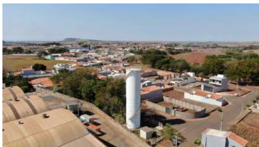
Foto 10 - Vista geral do reservatório.
