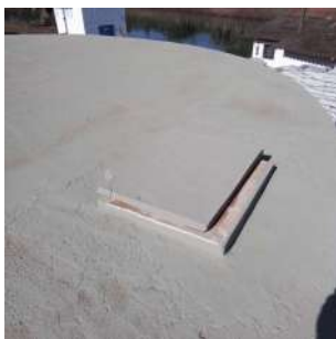
Foto 1 - Tampa de inspeção de concreto.
