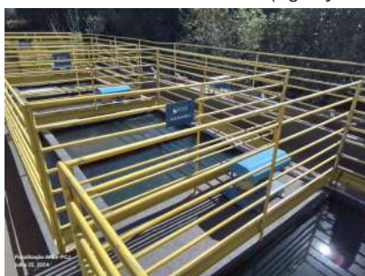
Foto 18 - Vista do floculador 3 (agitação baixa).
