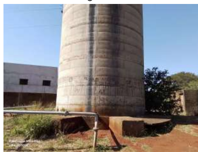
Foto 6 - Vista geral do reservatório.
