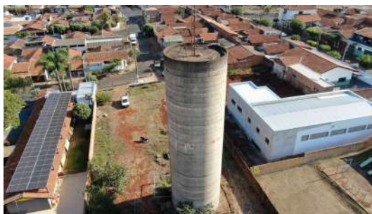
Foto 10 - Vista geral do reservatório.
