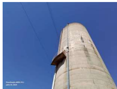
Foto 2 - Escada exterior com guarda-corpo e patamar.
