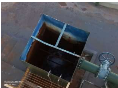
Foto 28 - Caixa de mistura de hipoclorito de sódio e ácido fluossilícico.
