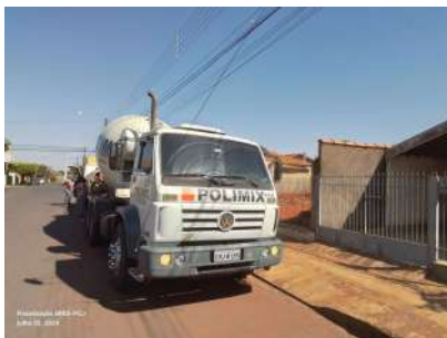
Foto 1 - Caminhão para concretagem da base do novo reservatório.
