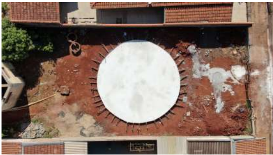
Foto 9 - Imagem capturada pelo drone (28/07/2024) com base já concretada.
