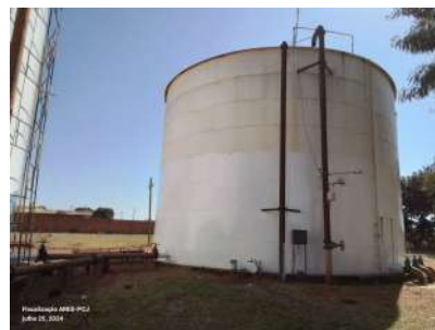
Foto 6 - Vista do reservatório Talamoni I.
