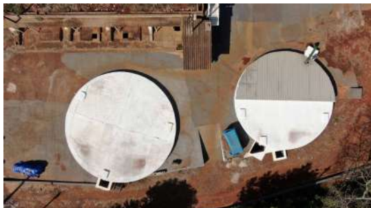
Foto 11 - Vista superior dos reservatórios da ETA.
