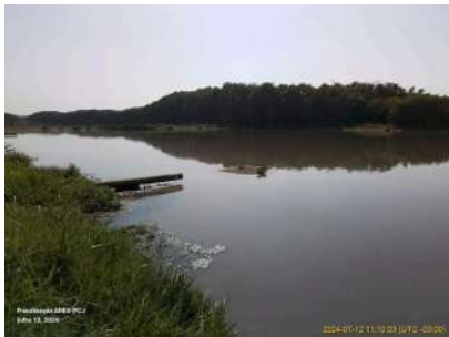
Foto 8 - Acúmulo de lodo na lagoa anaeróbia 2.
