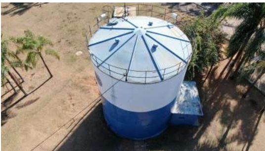
Foto 6 - Vista geral do reservatório - detalhe lateral.
