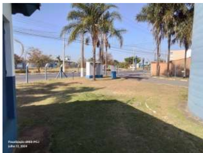
Foto 1 - Vista do cercamento.
