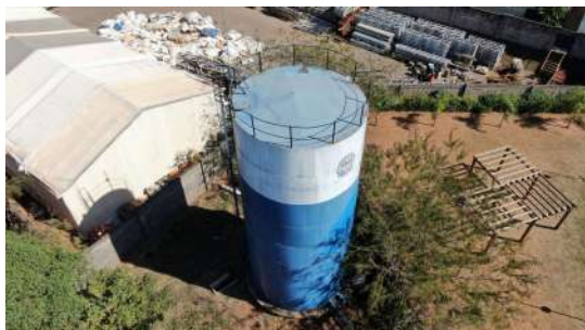
Foto 5 - Vista geral do reservatório.
