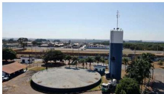
Foto 10 - Vista geral do reservatório.
