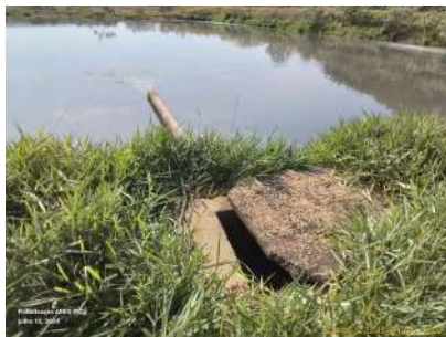
Foto 7 - Fechar as caixas de passagem abertas para limpeza - lagoa anaeróbia 1, entrada 2.
