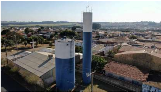
Foto 2 - Guarda-corpo do reservatório.
