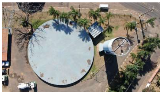
Foto 8 - Vista superior do reservatório.
