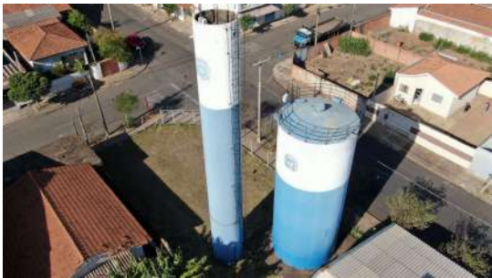
Foto 3 - Vista geral do reservatório.
