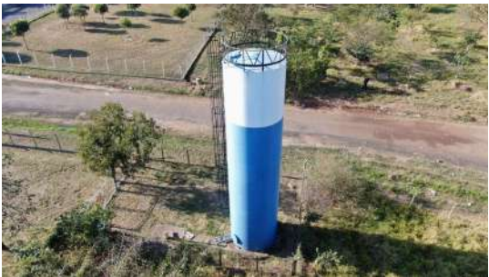
Foto 6 - Vista geral do reservatório.
