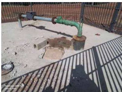
Foto 1 - Laje de proteção do poço.
