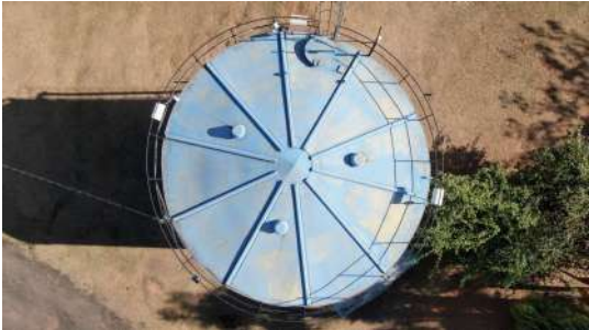
Foto 9 - Vista geral do reservatório - detalhe topo.
