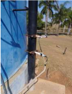
Foto 3 - Ponto de aplicação na linha de recalque.
