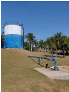
Foto 1 - Vista geral do reservatório.
