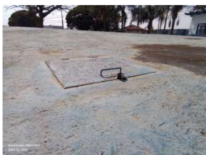
Foto 1 - Tapa de inspeção do reservatório.
