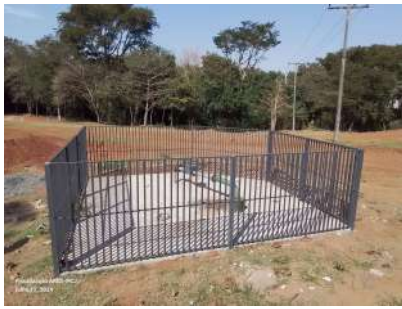
Foto 1 - Vista geral do poço.
