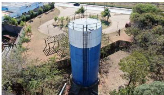
Foto 2 - Condutor de descarga do SPDA.
