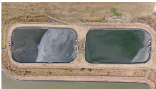
Foto 10 - Vista geral da ETE.
