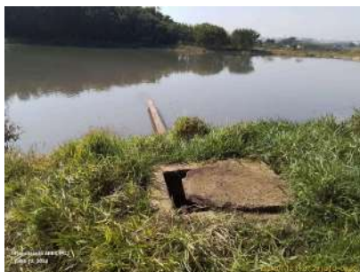
Foto 17 - Fechar as caixas de passagem abertas para limpeza - lagoa anaeróbia 2, entrada 1.
