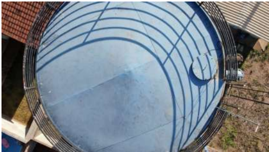
Foto 1 - Tampa de inspeção fechada.
