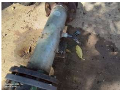
Foto 1 - Tomada de água.
