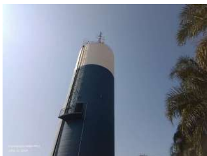
Foto 1 - Guarda-corpo do reservatório.
