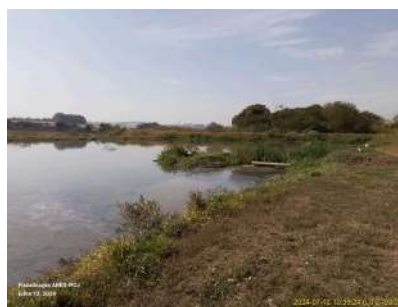
Foto 4 - Realizar o desassoreamento das lagoas da ETE.
