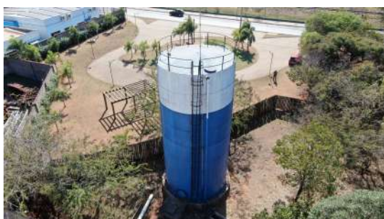
Foto 1 - Guarda-corpo do reservatório.
