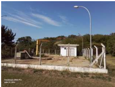
Foto 1 - Vista geral da EEEB.
