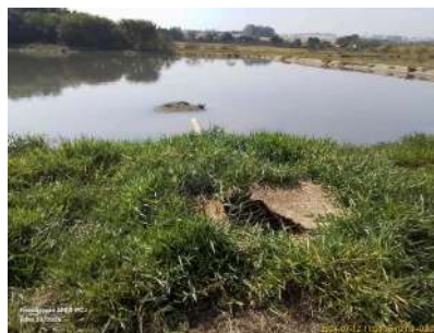
Foto 18 - Fechar as caixas de passagem abertas para limpeza - lagoa anaeróbia 2, entrada 2.
