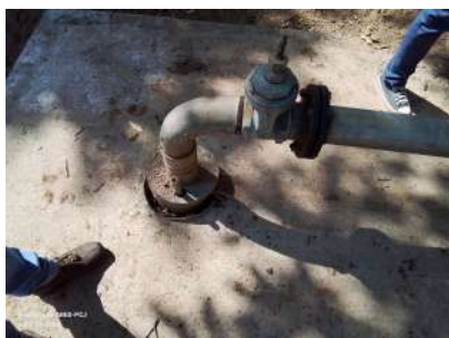
Foto 1 - Laje de proteção.
