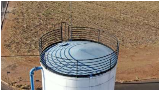
Foto 1 - Topo do reservatório.
