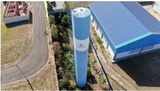
Foto 2 - Tubulação de ventilação no topo.
