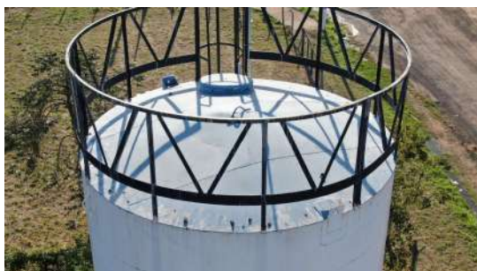
Foto 1 - Tampa de inspeção.
