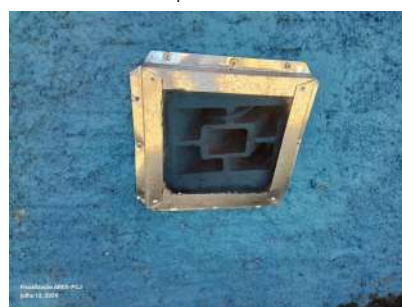
Foto 8 - Respiro do reservatório.
