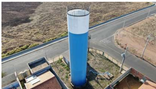
Foto 1 - Vista geral do reservatório.
