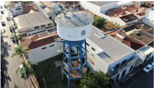
Foto 6 - Vista geral do reservatório.
