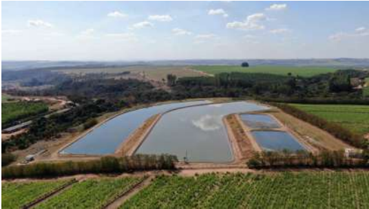
Foto 2 - Vista geral da ETE.
