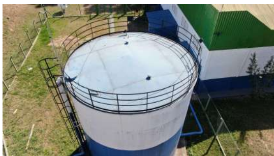
Foto 1 - Guarda-corpo do reservatório.
