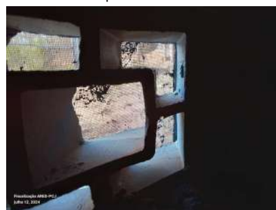
Foto 6 - Respiro do reservatório.
