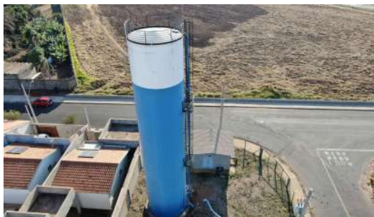
Foto 2 - Vista geral do reservatório.
