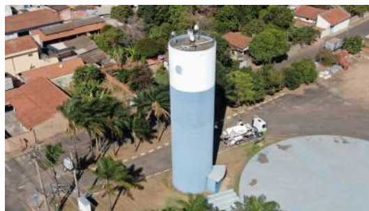
Foto 6 - Vista geral do reservatório.
