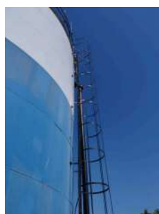
Foto 2 - Guarda-corpo do reservatório.
