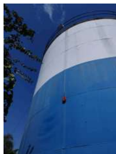
Foto 4 - Guarda-corpo do reservatório.
