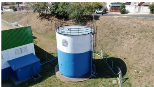
Foto 1 - Medidor de nível do reservatório.
