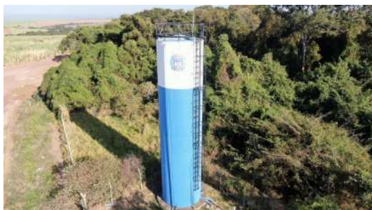
Foto 1 - Guarda-corpo do reservatório.
