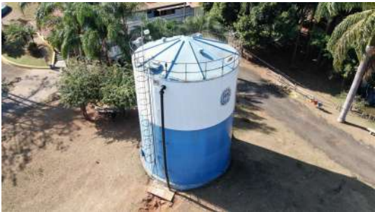
Foto 4 - Vista geral do reservatório - detalhe lateral.
