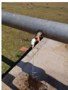
Foto 1 - Tomada de água.
