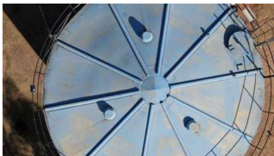
Foto 1 - Três respiros no topo do reservatório.
