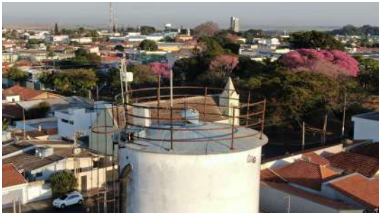
Foto 3 - Guarda-corpo do reservatório.
