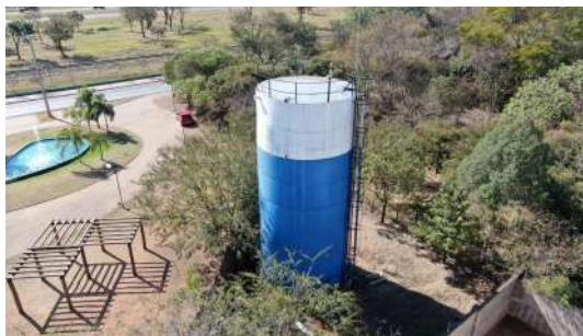
Foto 2 - Vista geral do reservatório.
