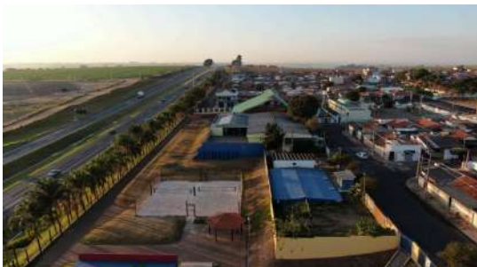
Foto 11 - Vista geral do reservatório.
