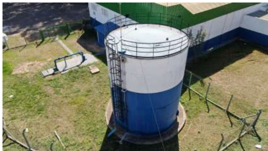
Foto 4 - Vista geral do reservatório.
