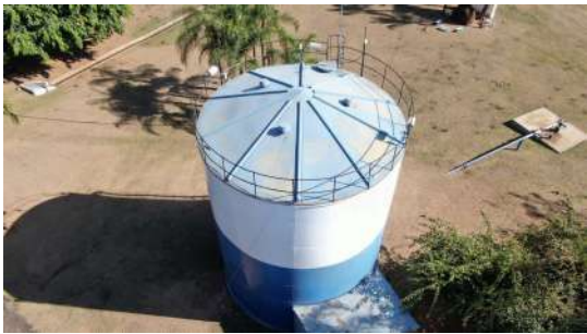
Foto 7 - Vista geral do reservatório - detalhe lateral.
