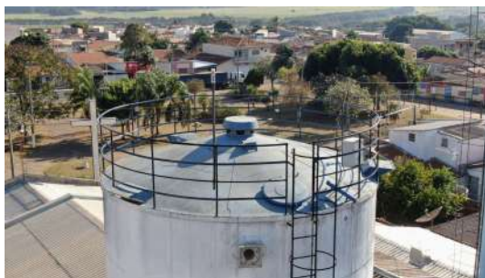
Foto 2 - Tampa de inspeção.
