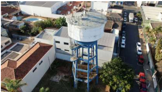
Foto 5 - Vista geral do reservatório.
