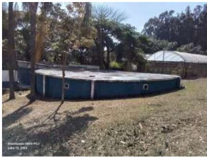
Foto 9 - Vista externa do reservatório.
