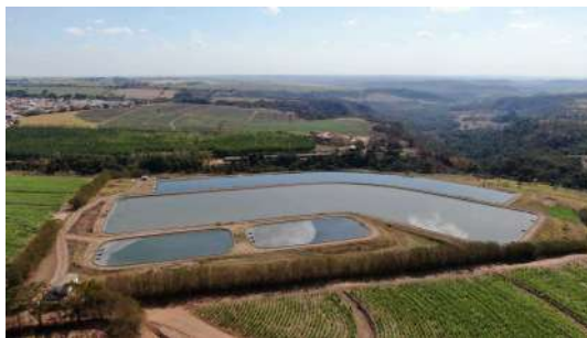
Foto 6 - Vista geral da ETE.
