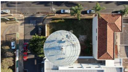
Foto 1 - Tampa de inspeção instalada.
