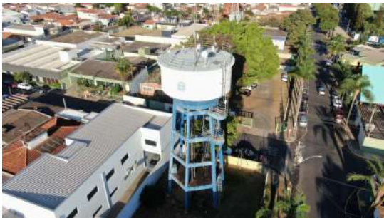
Foto 3 - Vista geral do reservatório.
