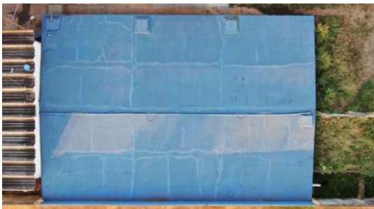
Foto 7 - Vista geral do reservatório.
