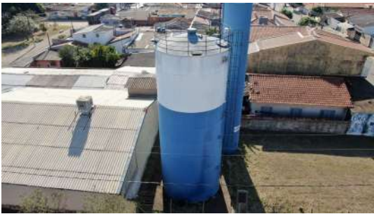
Foto 6 - Vista geral do reservatório.
