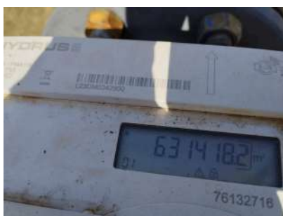
Foto 3 - Macromedidor do poço - registro de medição 2.
