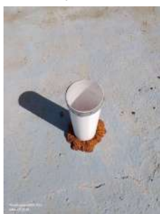
Foto 3 - Tela de proteção nos respiros - detalhe.
