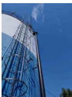
Foto 1 - Guarda-corpo do reservatório.
