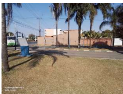
Foto 1 - Vista do cercamento.
