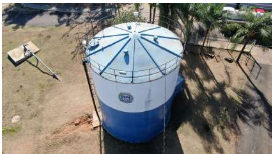
Foto 5 - Vista geral do reservatório - detalhe lateral.
