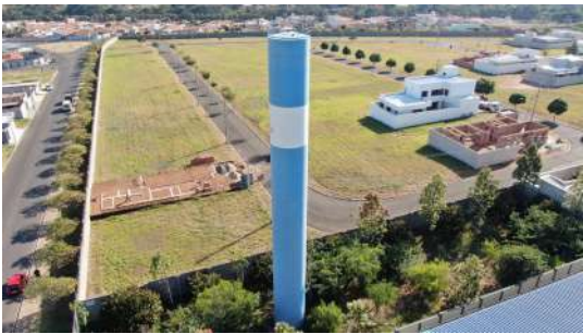
Foto 2 - Vista geral do reservatório.
