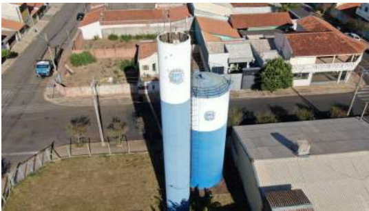
Foto 2 - Vista geral do reservatório.
