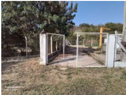
Foto 1 - Portão de acesso.
