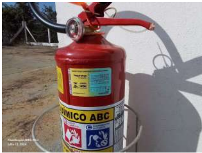
Foto 1 - Validade do extintor.
