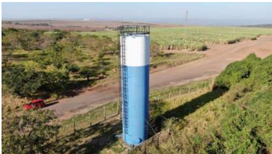
Foto 5 - Vista geral do reservatório.
