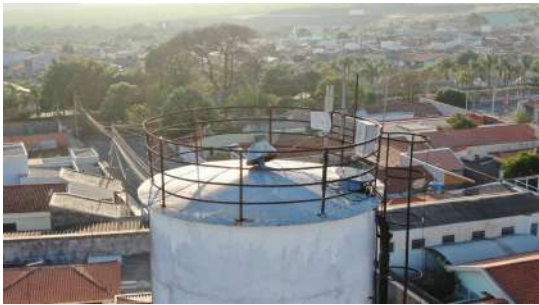
Foto 1 - Guarda-corpo do reservatório - topo.
