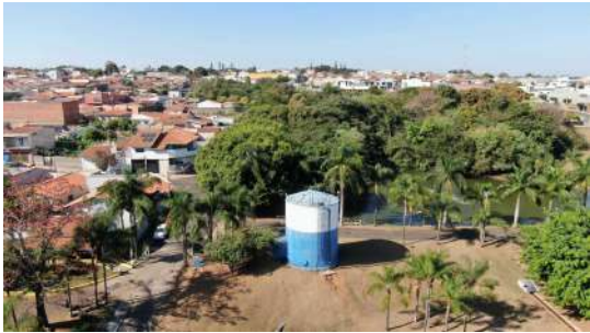
Foto 12 - Vista geral do reservatório.
