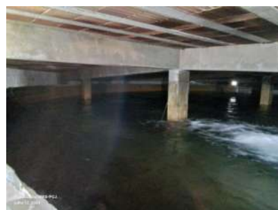
Foto 5 - Vista da parte interna do reservatório.
