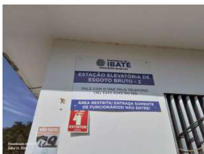
Foto 1 - Placa de identificação.
