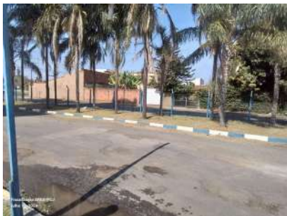
Foto 1 - Vista do cercamento.
