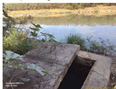
Foto 12 - Fechar as caixas de passagem abertas para limpeza - lagoa anaeróbia 2, saída 2.
