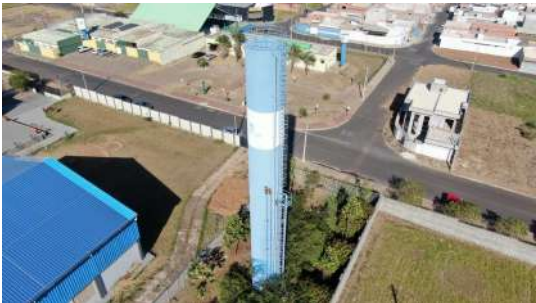
Foto 4 - Vista geral do reservatório.
