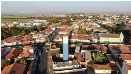
Foto 1 - Vista geral do reservatório.
