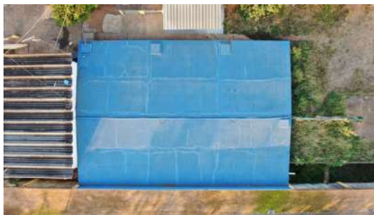
Foto 6 - Vista geral do reservatório.
