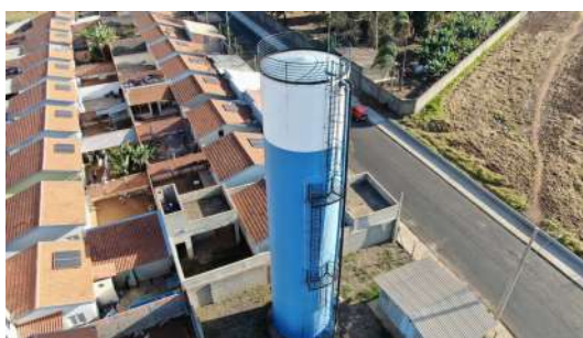
Foto 2 - Guarda-corpo de escada e patamar.
