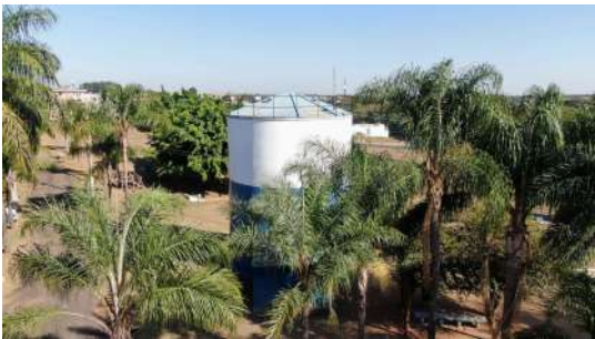
Foto 2 - Vista geral do reservatório - detalhe lateral.
