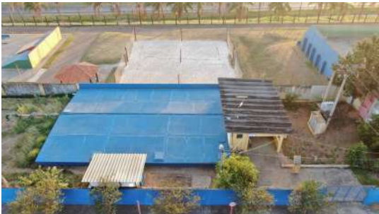
Foto 2 - Vista geral do reservatório.
