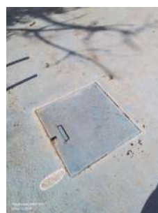
Foto 2 - Tapa de inspeção do reservatório.
