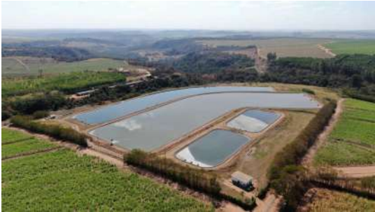
Foto 4 - Vista geral da ETE.
