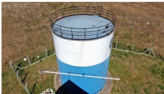
Foto 2 - Vista geral do reservatório.
