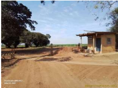
Foto 3 - Guarita e cancela da ETE/Aterro sanitário.
