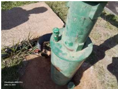
Foto 1 - Tubo de medição de nível do poço.
