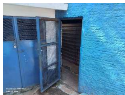
Foto 3 - Vista da porta de acesso ao reservatório.
