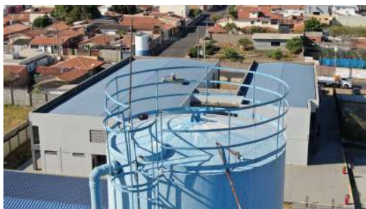
Foto 2 - Tapa de inspeção do reservatório.
