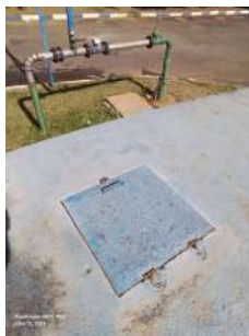
Foto 3 - Tampa de inspeção do reservatório.
