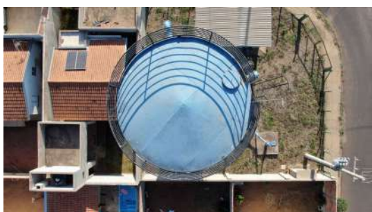
Foto 1 - Guarda-corpo no topo.
