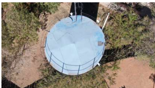
Foto 1 - Tampa de inspeção.
