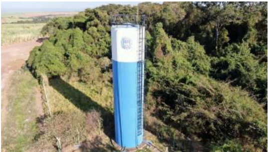
Foto 4 - Vista geral do reservatório.
