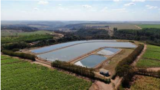
Foto 3 - Vista geral da ETE.
