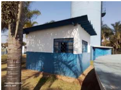
Foto 2 - Vista externa da EEAT.
