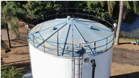
Foto 10 - Vista geral do reservatório - detalhe topo.
