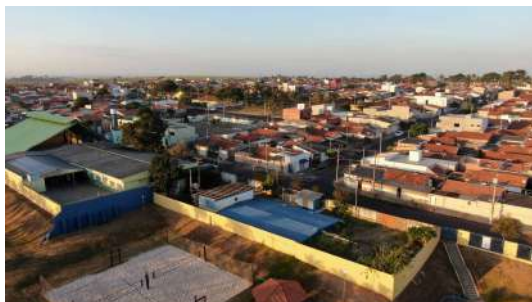
Foto 10 - Vista geral do reservatório.
