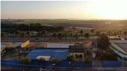
Foto 1 - Vista geral do reservatório.
