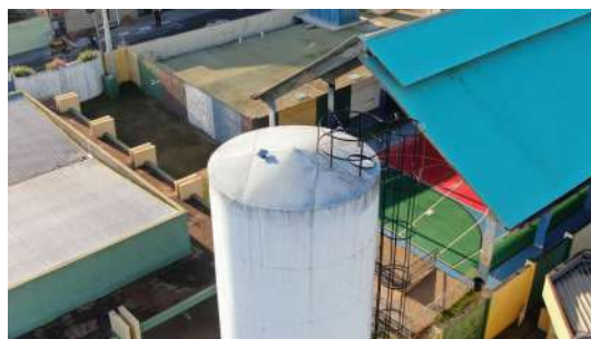
Foto 2 - Vista do guarda-corpo.
