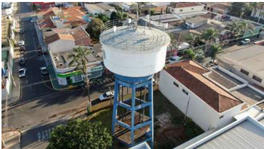
Foto 1 - Vista geral do reservatório.
