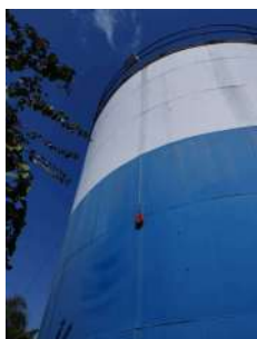
Foto 1 - Medidor de nível.
