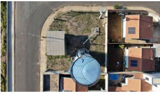
Foto 2 - Captor Franklin no lado esquerdo da escada.
