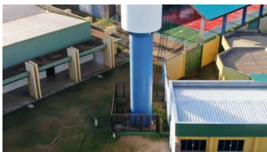
Foto 1 - Cercamento do reservatório.
