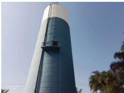
Foto 1 - Medidor de nível externo.
