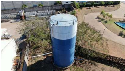
Foto 4 - Vista geral do reservatório.
