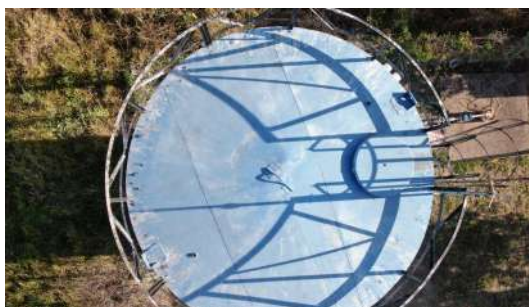
Foto 2 - Tampa de inspeção.
