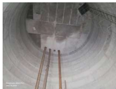
Foto 4 - Vista interna do reservatório.
