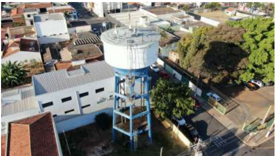
Foto 4 - Vista geral do reservatório.
