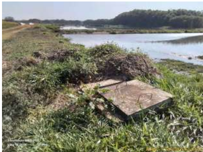
Foto 5 - Monte de material sólido retirado da entrada da lagoa anaeróbia 1.
