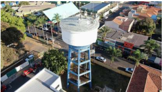
Foto 2 - Vista geral do reservatório.
