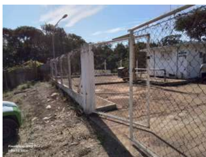
Foto 1 - Portão de acesso.
