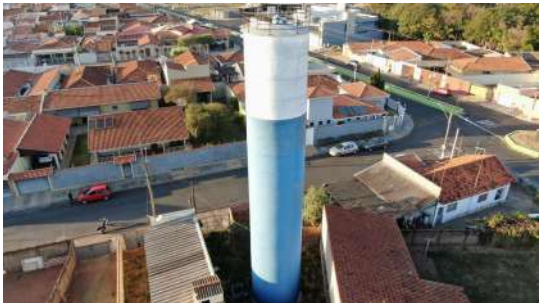
Foto 3 - Vista geral do reservatório.
