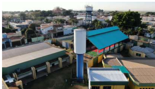
Foto 4 - Vista geral do reservatório.
