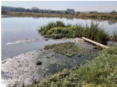
Foto 3 - Acúmulo de lodo na lagoa anaeróbia 1.
