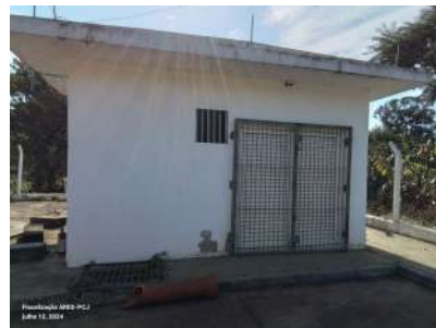
Foto 5 - Vista do abrigo do gerador de energia.
