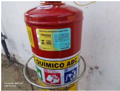
Foto 1 - Validade do extintor.
