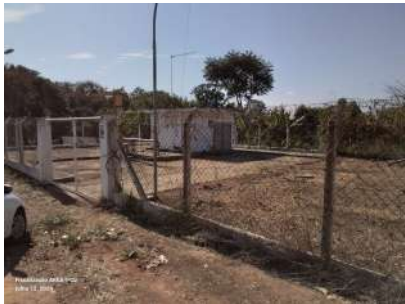
Foto 1 - Vista geral da EEEB.
