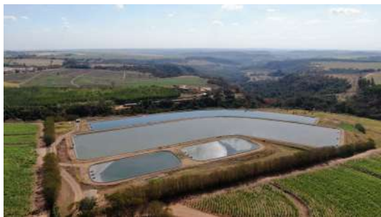
Foto 5 - Vista geral da ETE.
