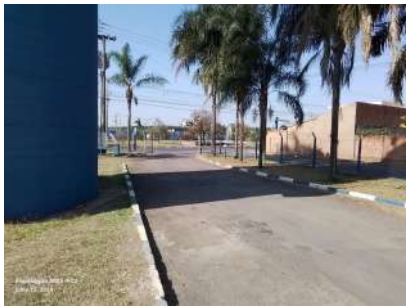
Foto 1 - Vista do cercamento.
