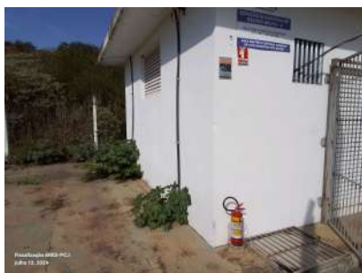
Foto 1 - Extintor de incêndio da EEEB.
