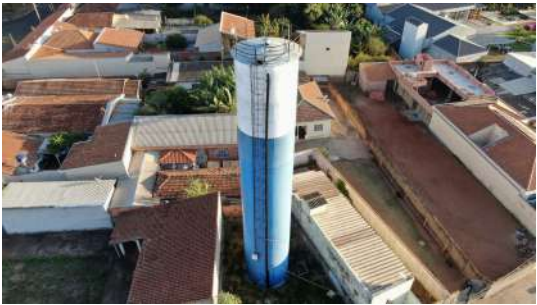
Foto 2 - Guarda-corpo do reservatório.
