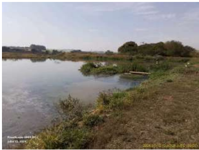
Foto 1 - Acúmulo de lodo na lagoa anaeróbia 1.
