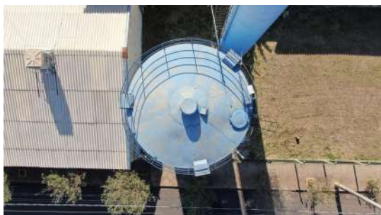
Foto 1 - Tampa de inspeção.
