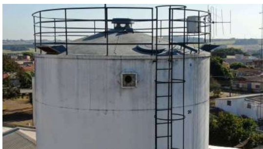
Foto 1 - Tubo extravasor do reservatório.
