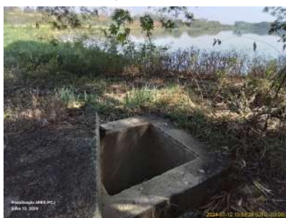
Foto 13 - Fechar as caixas de passagem abertas para limpeza - distribuição para a lagoa facultativa.
