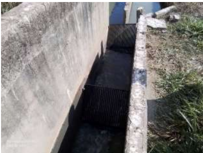
Foto 6 - Gradeamento do preliminar.
