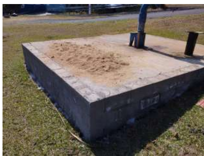
Foto 1 - Laje de proteção.
