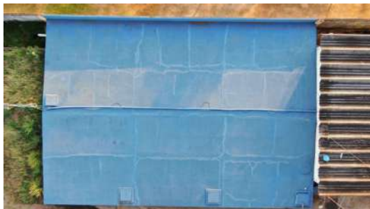
Foto 8 - Vista geral do reservatório.
