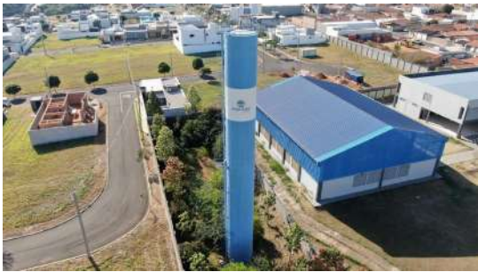
Foto 1 - Vista geral do reservatório.
