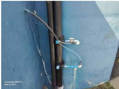
Foto 3 - Aplicação dos produtos na linha de recalque do poço para o reservatório.
