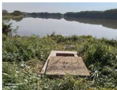
Foto 16 - Fechar as caixas de passagem abertas para limpeza - lagoa facultativa, entrada 2.
