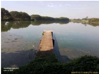
Foto 20 - Saída da lagoa facultativa.
