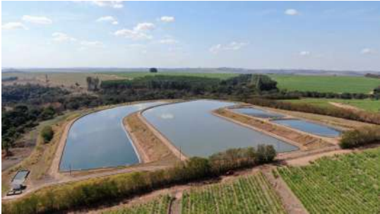
Foto 1 - Vista geral da ETE.
