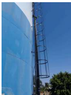
Foto 3 - Guarda-corpo do reservatório.
