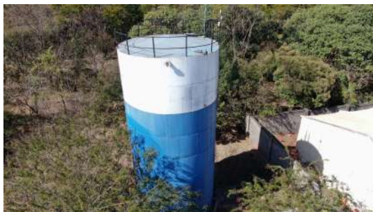
Foto 1 - Vista geral do reservatório.
