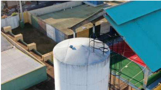
Foto 1 - Tubulação de ventilação no topo.
