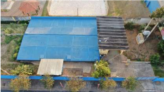
Foto 3 - Vista geral do reservatório.
