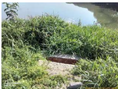
Foto 15 - Fechar as caixas de passagem abertas para limpeza - lagoa facultativa, entrada 1.
