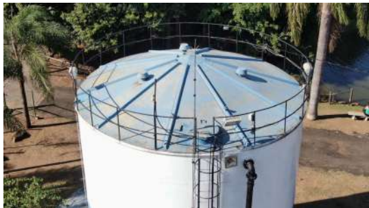
Foto 1 - Tubo extravasor com tela.
