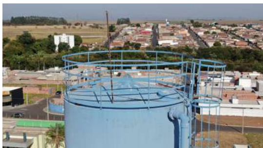
Foto 1 - Tapa de inspeção do reservatório.
