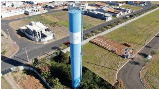
Foto 3 - Vista geral do reservatório.
