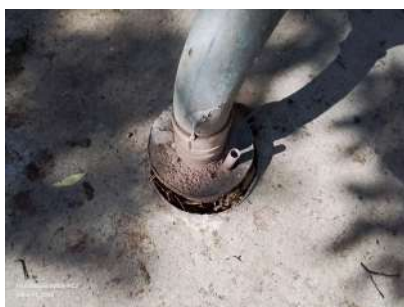
Foto 1 - Tubo de medição de nível.
