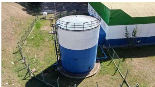
Foto 5 - Vista geral do reservatório.
