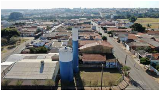
Foto 5 - Vista geral do reservatório.
