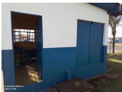
Foto 1 - Vista dos acessos à EEAT.
