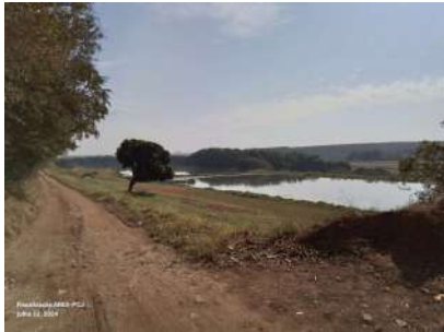
Foto 1 - Vista geral na entrada da ETE.
