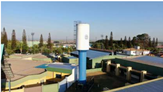
Foto 1 - Vista geral do reservatório.
