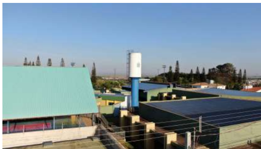
Foto 3 - Vista geral do reservatório.
