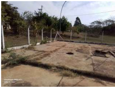
Foto 1 - Vista do cercamento.
