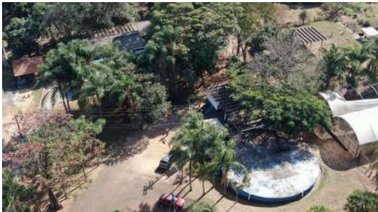
Foto 11 - Vista superior do reservatório.
