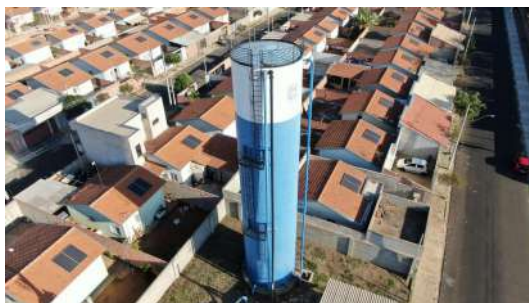
Foto 4 - Vista geral do reservatório.
