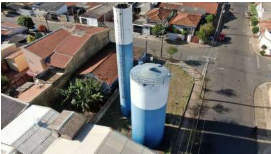
Foto 4 - Vista geral do reservatório.
