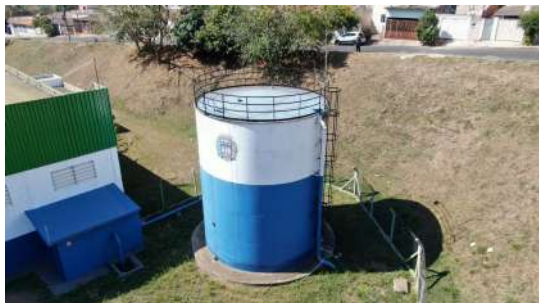
Foto 3 - Vista geral do reservatório.
