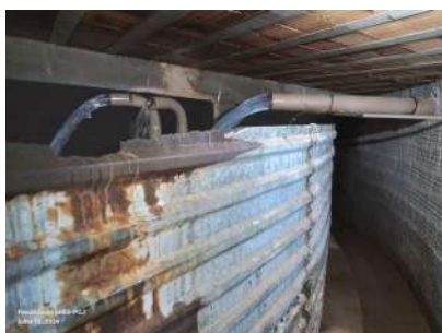
Foto 4 - Vista da parte interna do reservatório - local da dosagem química.
