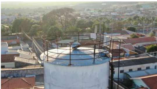
Foto 1 - Tubulação de ventilação.
