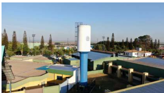
Foto 1 - Vista do guarda-corpo.
