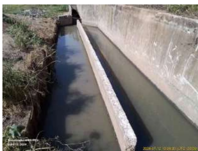
Foto 3 - Instalar comportas nas caixas de areia.
