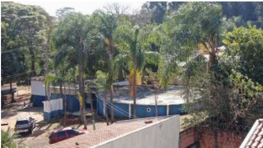
Foto 12 - Vista superior do reservatório.
