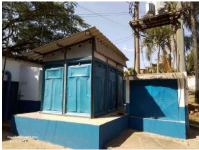
Foto 1 - Abrigo das dosadoras de produto químico.
