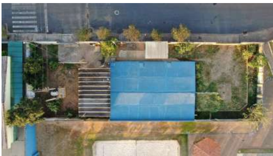
Foto 5 - Vista geral do reservatório.
