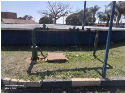
Foto 2 - Vista geral do poço.
