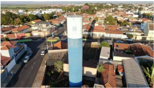
Foto 2 - Vista geral do reservatório.
