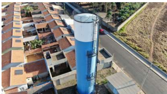
Foto 3 - Vista geral do reservatório.
