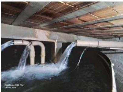
Foto 3 - Local de aplicação dos produtos químicos no reservatório Horta semienterrado.
