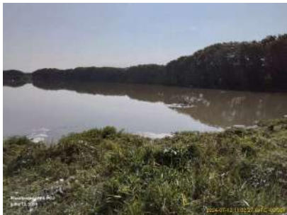
Foto 7 - Acúmulo de lodo na entrada da lagoa facultativa.
