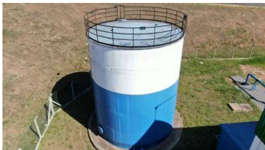
Foto 1 - Vista geral do reservatório.
