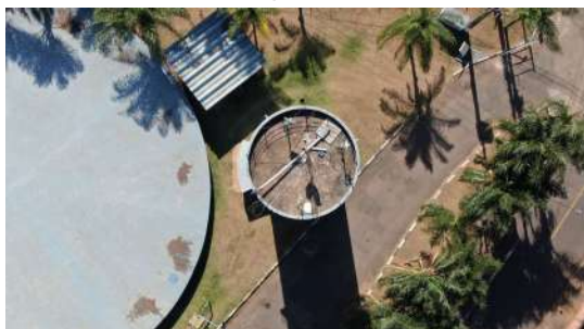
Foto 9 - Vista superior do reservatório.
