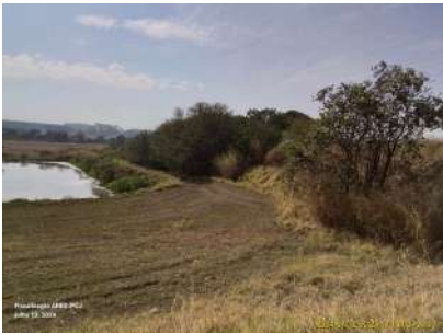
Foto 2 - Vegetação densa na divisa da entrada da ETE.
