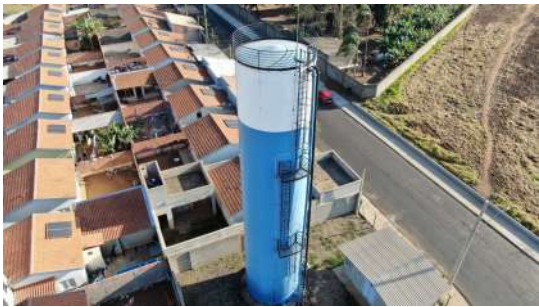
Foto 1 - Descida do condutor do SPDA na lateral esquerda da escada.
