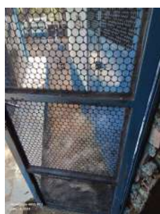
Foto 7 - Porta de acesso ao reservatório.
