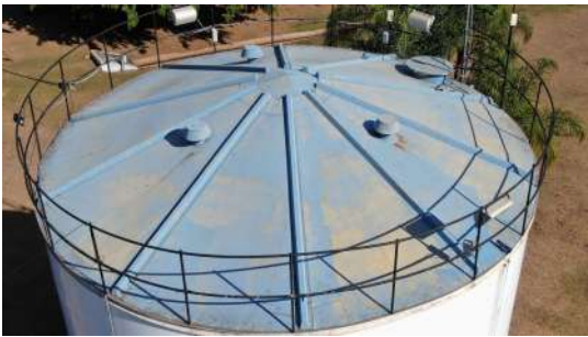
Foto 8 - Vista geral do reservatório - detalhe topo.
