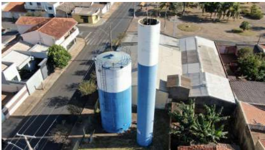
Foto 1 - Vista geral do reservatório.
