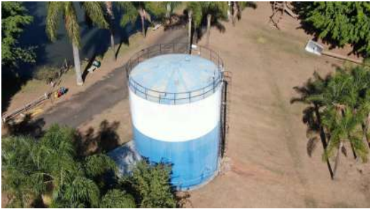
Foto 13 - Vista geral do reservatório.
