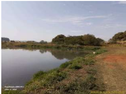
Foto 4 - Acúmulo de lodo na lagoa anaeróbia 1.
