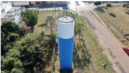
Foto 7 - Vista geral do reservatório.
