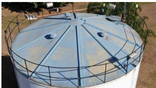
Foto 1 - Tampa de inspeção.
