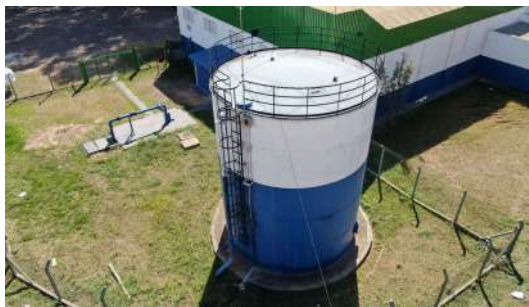
Foto 2 - Condutor de descarga do SPDA.
