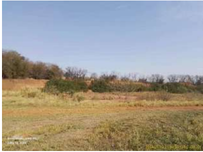
Foto 5 - Talude elevado na lateral esquerda da lagoa facultativa da ETE.
