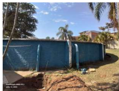
Foto 2 - Vista externa do reservatório.
