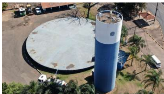
Foto 2 - Guarda-corpo do reservatório.
