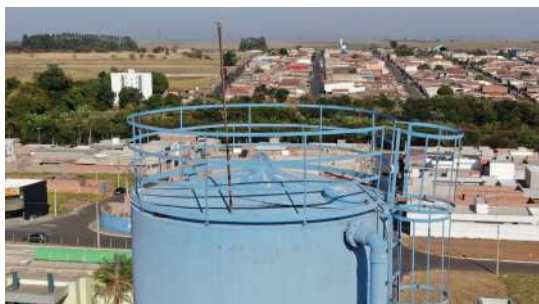
Foto 1 - Tubo extravasor do reservatório - célula superior.
