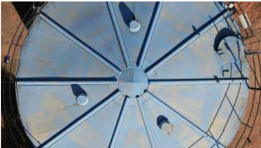
Foto 11 - Vista geral do reservatório - detalhe topo.
