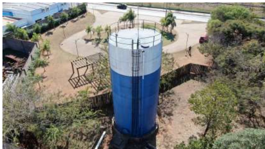
Foto 3 - Vista geral do reservatório.
