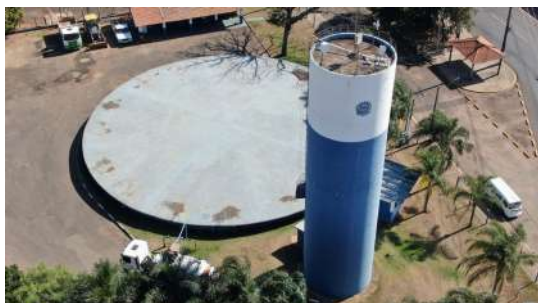
Foto 5 - Vista geral do reservatório.
