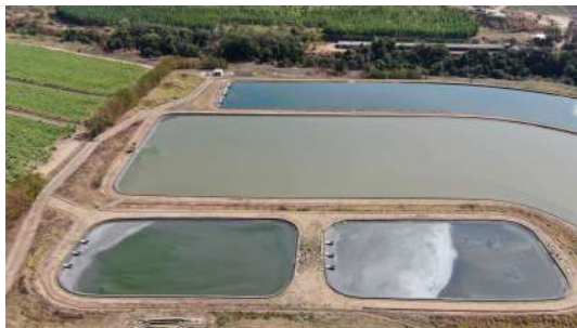
Foto 8 - Vista geral da ETE.
