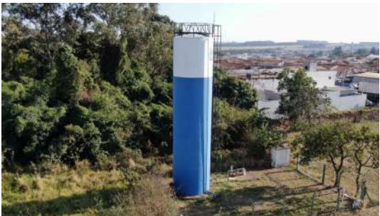
Foto 2 - Vista geral do reservatório.
