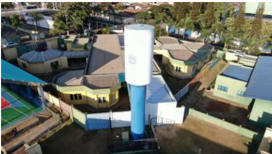
Foto 2 - Vista geral do reservatório.
