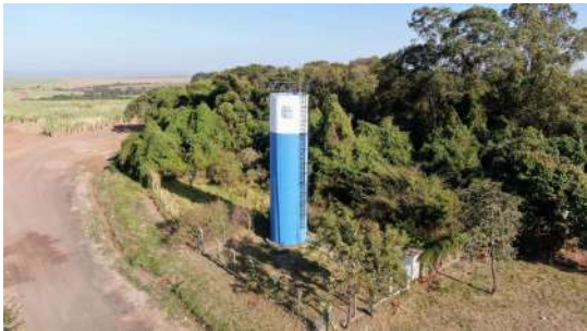
Foto 3 - Vista geral do reservatório.
