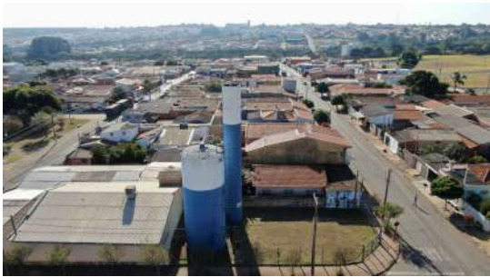
Foto 1 - Guarda-corpo do reservatório.
