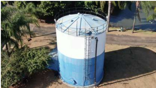
Foto 3 - Vista geral do reservatório - detalhe lateral.
