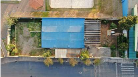
Foto 4 - Vista geral do reservatório.
