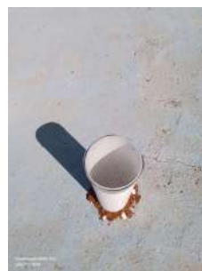
Foto 2 - Tela de proteção nos respiros - detalhe.
