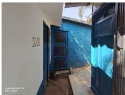
Foto 1 - Vista da porta de acesso ao reservatório.
