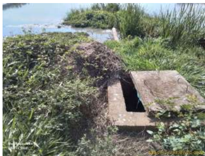
Foto 5 - Fechar as caixas de passagem abertas para limpeza - lagoa anaeróbia 1, entrada 1.
