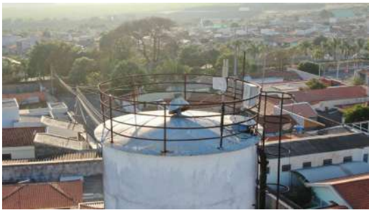
Foto 1 - Ventilação corroída.
