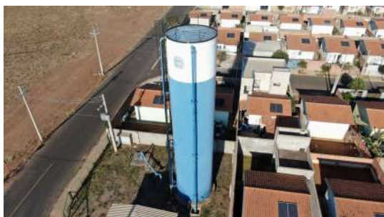
Foto 5 - Vista geral do reservatório.
