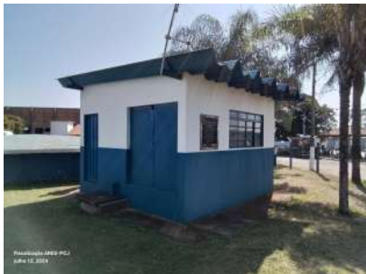
Foto 1 - Vista externa da EEAT.
