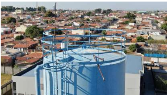
Foto 2 - Guarda-corpo do topo.
