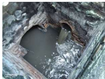
Foto 14 - Cor do efluente na saída da lagoa anaeróbia 2.
