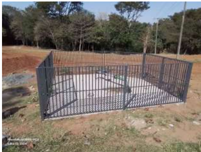
Foto 1 - Vista do cercamento.
