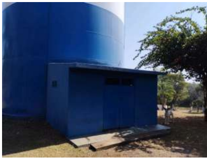
Foto 1 - Casa de química junto ao reservatório Horta apoiado.
