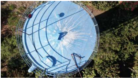
Foto 1 - Tubulação de ventilação no topo.
