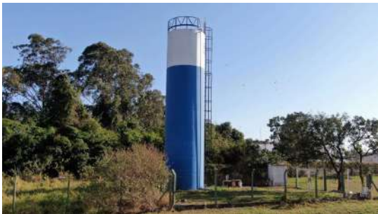
Foto 1 - Vista geral do reservatório.
