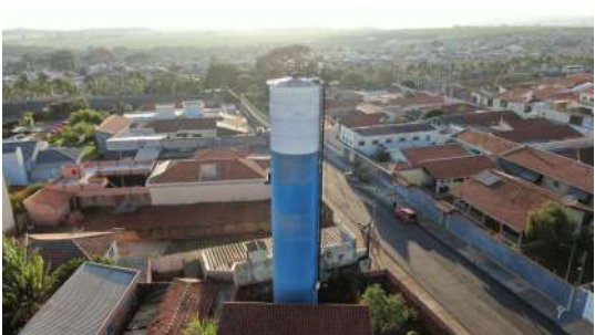
Foto 4 - Vista geral do reservatório.
