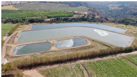
Foto 7 - Vista geral da ETE.
