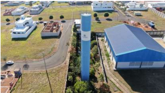
Foto 6 - Vista geral do reservatório.
