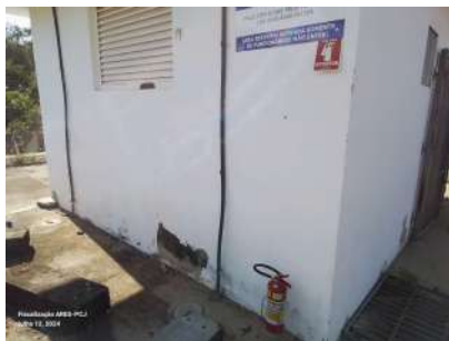
Foto 1 - Extintor de incêndio da EEEB.
