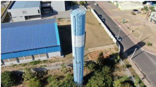
Foto 5 - Vista geral do reservatório.
