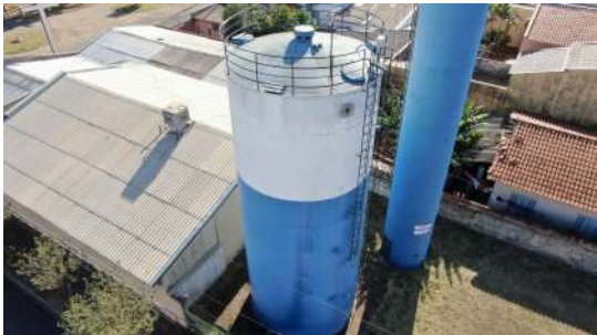
Foto 7 - Vista geral do reservatório.
