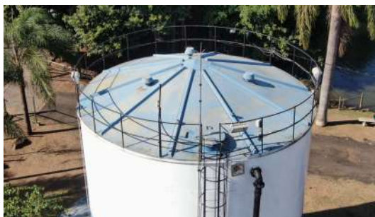
Foto 2 - Tampa de inspeção.
