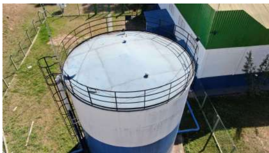
Foto 1 - Tampa de inspeção.
