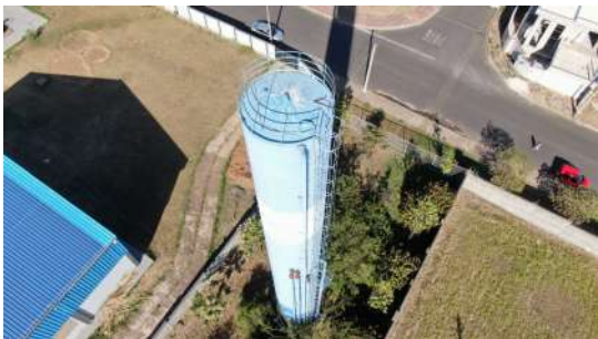
Foto 1 - Guarda-corpo do reservatório.
