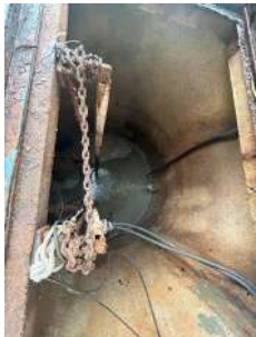
Foto 9 - Poço de sucção
