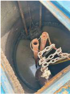
Foto 3 - Poço de sucção
