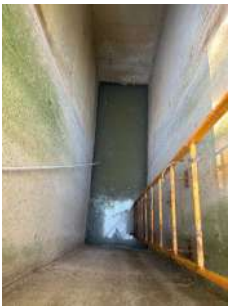
Foto 4 - Poço de gradeamento
