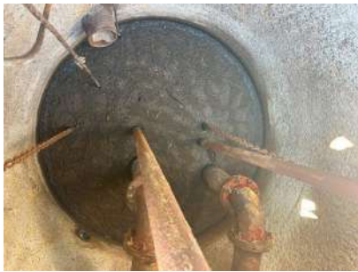
Foto 5 - Detalhe Poço de sucção
