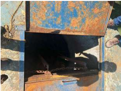
Foto 4 - Poço de sucção
