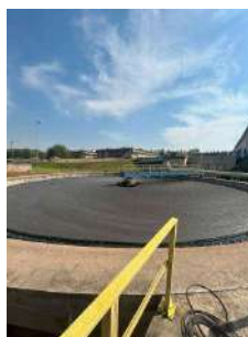
Foto 17 - Vista - Decantador secundário
