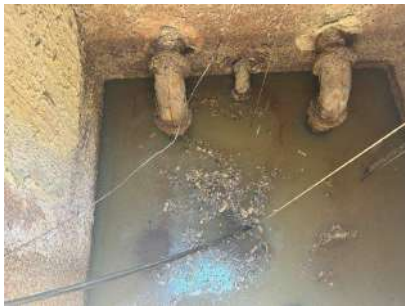
Foto 3 - poço de sucção
