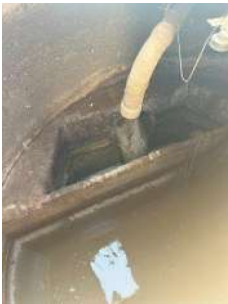
Foto 6 - Entrada de esgoto
