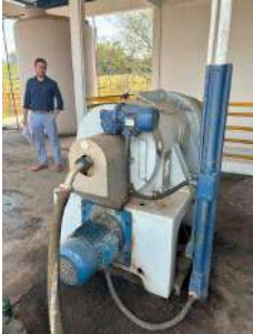
Foto 28 - Centrifugas de lodo
