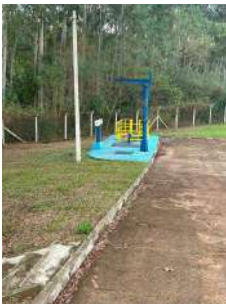
Foto 3 - Vista da elevatória
