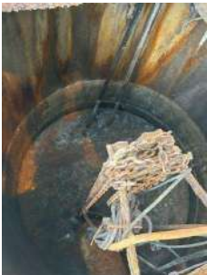
Foto 6 - Poço de sucção
