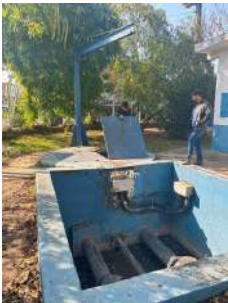
Foto 3 - Vista do barrilete
