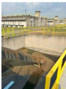
Foto 5 - Esteira de areia aparentemente sem manutenção e com operação precária
