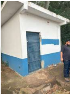
Foto 2 - Casa de bombas
