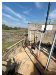
Foto 2 - Bomba de excesso de lodo sem reserva
