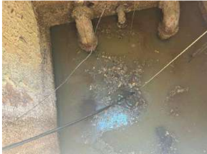
Foto 5 - Poço de sucção
