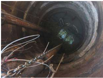
Foto 5 - Poço de sucção
