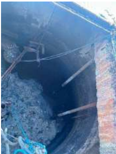
Foto 6 - Poço de sucção
