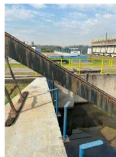
Foto 4 - Esteira de areia aparentemente sem manutenção e com operação precária
