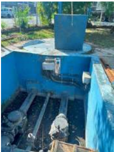
Foto 4 - Vista do barrilete
