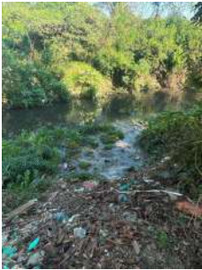
Foto 2 - Provavel descarte de esgoto devido a ausência de manutenção das bombas
