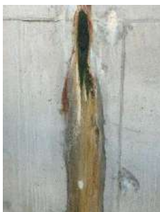
Foto 5 - Vazamento aparente
