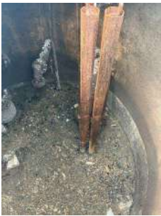
Foto 1 - Poço de sucção cheio
