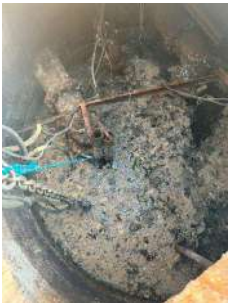
Foto 5 - Poço de sucção
