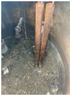
Foto 3 - Poço de Sucção
