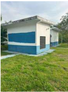
Foto 4 - Vista dos abrigos do painel e gerador
