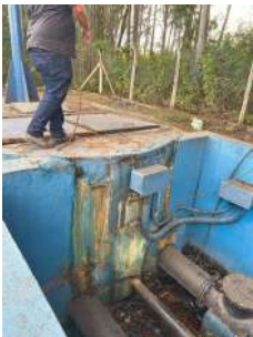
Foto 1 - Paredes do poço
