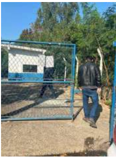
Foto 1 - Fachada da EEBB
