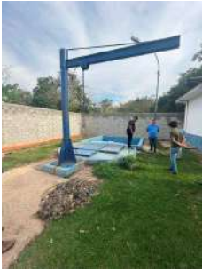
Foto 5 - Vista geral da EEEB
