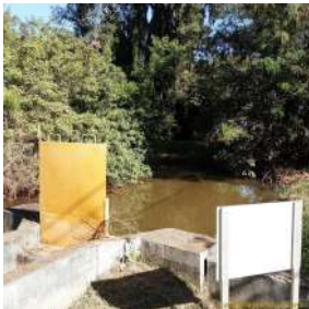
Foto 3 - Tomada d'água da captação Marcelo
