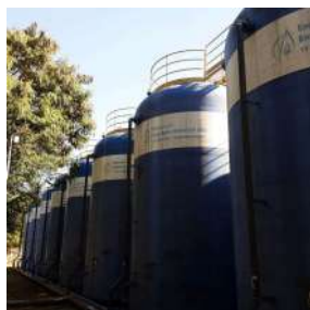
Foto 3 - Guarda-corpo na cobertura dos reatores
