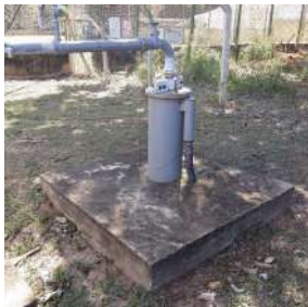
Foto 1 - Laje de proteção sanitária da captação subterrânea
