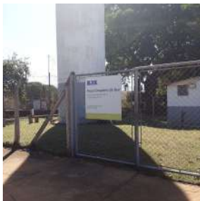
Foto 1 - Placa de identificação da captação subterrânea Cruzeiro do Sul
