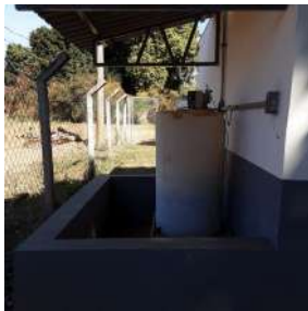
Foto 1 - Tanque de hipoclorito para cloração da água
