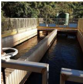
Foto 3 - Guarda-corpo do desarenador
