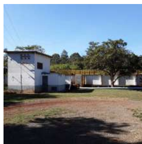
Foto 2 - Aspecto geral da estrutura de entrada de água (antigo filtro) e casa de bombas
