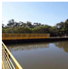
Foto 2 - Detalhamento do guarda-corpo ao redor do antigo filtro (entrada de água da estação elevatória da captação)
