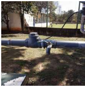
Foto 1 - Tomada d'água para retirada de amostra para análise de água bruta
