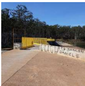
Foto 1 - Guarda-corpo em ponte acima do vertedor da represa
