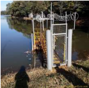
Foto 2 - Estrutura de passagem da água para captação
