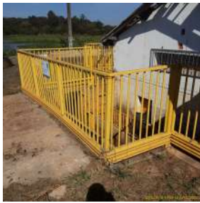
Foto 1 - Guarda-corpo no ponto de coleta de água bruta
