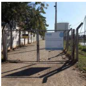
Foto 1 - Cercamento do centro de reservação
