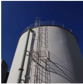
Foto 1 - Escada de acesso e cobertura com guarda-corpo
