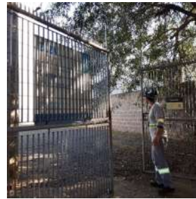
Foto 2 - Portão de acesso à elevatória de água
