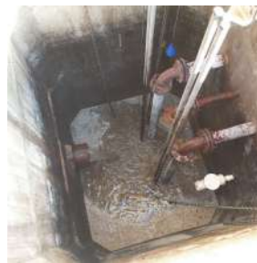
Foto 2 - Entrada do efluente (após passagem pelo gradeamento) e tubulações de sucção
