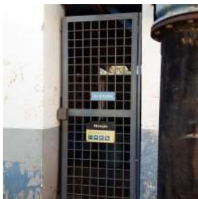
Foto 1 - Portão de acesso à casa de bombas
