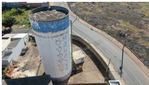
Foto 2 - Aspecto geral do reservatório, via drone, com vista para a estrutura da elevatória de água à direita
