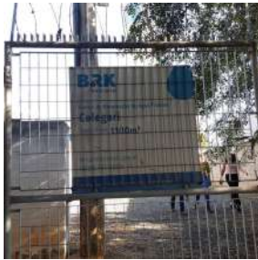
Foto 1 - Portão de acesso à elevatória de água
