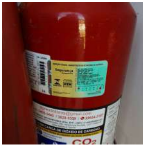
Foto 1 - Inspeção técnica e manutenção realizada em janeiro de 2024
