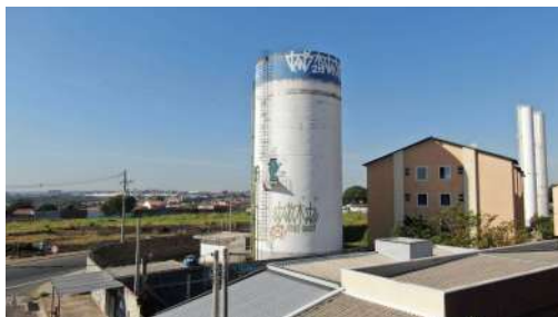
Foto 1 - Aspecto geral do reservatório, via imagem de drone
