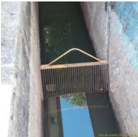
Foto 4 - Gradeamento da tomada d'água
