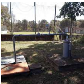
Foto 1 - Aspecto geral da captação subterrânea Cruzeiro do Sul
