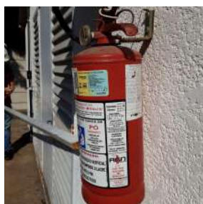
Foto 1 - Conferência periódica mensal realizada em 20/05/24 e inspeção técnica realizada em agosto de 2023.
