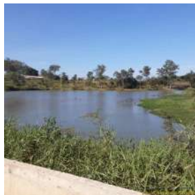
Foto 1 - Aspecto geral da represa
