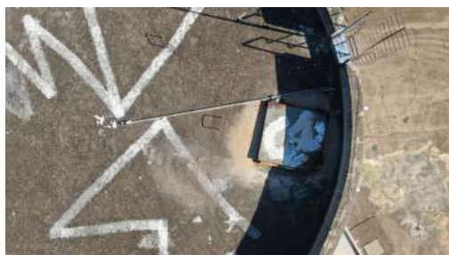
Foto 1 - Tampa de inspeção na cobertura do reservatório
