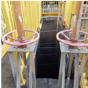
Foto 3 - Gradeamento na tomada d'água
