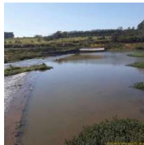
Foto 2 - Aspecto geral da represa
