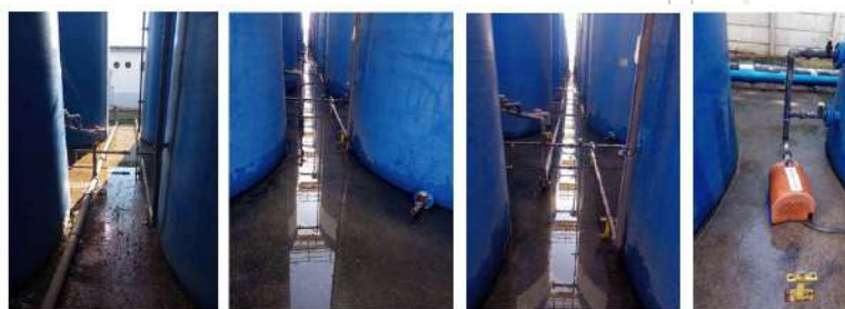
Foto 4 - Chão após limpeza do lodo
