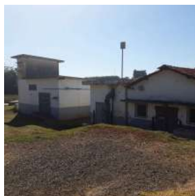
Foto 3 - Casa de bombas da captação Horto I
