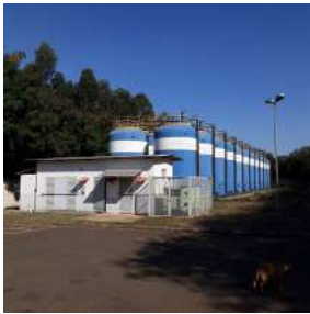
Foto 1 - Aspecto geral da ETE Viva Vista
