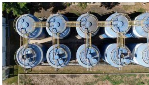
Foto 4 - Imagem aérea feita por drone, com detalhamento dos guarda-corpos dos reatores
