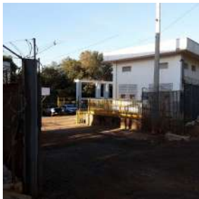
Foto 1 - Portão de acesso à captação
