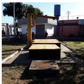
Foto 1 - Estrutura da elevatória de esgoto
