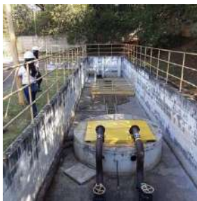
Foto 1 - Aspecto geral da elevatória de esgoto
