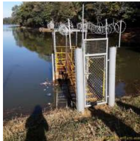
Foto 1 - Estrutura com guarda-corpo
