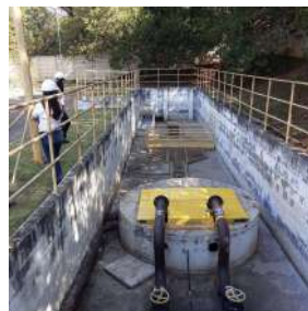
Foto 2 - Detalhamento do guarda-corpo na elevatória de esgoto
