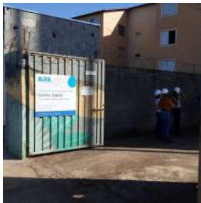
Foto 1 - Portão de acesso à elevatória de água
