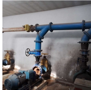
Foto 7 - Conjunto motor-bomba
