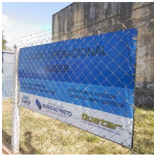
Foto 1 - Placa de identificação da reforma
