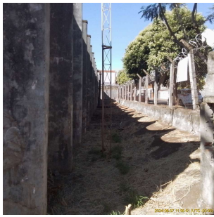
Foto 5 - Cercamento da área
