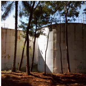
Foto 3 - Vista frontal dos reservatórios
