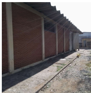
Foto 4 - Vista externa da casa de bombas
