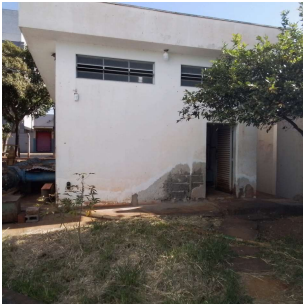
Foto 1 - Vista externa da EEAT Coronel Camisão
