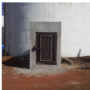
Foto 1 - Vista externa da EEAT Monte Alegre/Hemocentro
