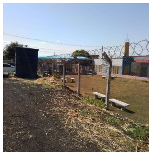
Foto 2 - Cercamento da área
