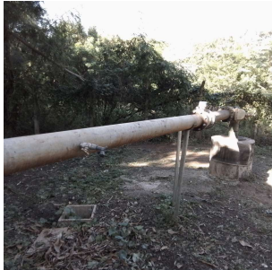
Foto 7 - Laje de proteção do poço
