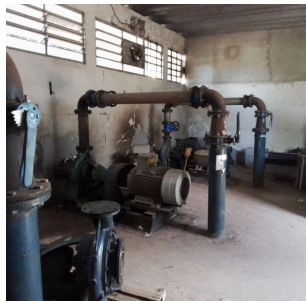
Foto 5 - Conjuntos motor-bomba
