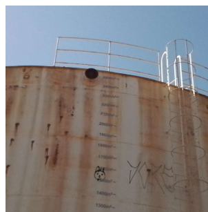
Foto 2 - Guarda-corpo no topo do reservatório
