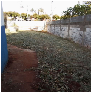
Foto 3 - Vista interna da limpeza de área
