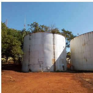
Foto 5 - Vista da limpeza da área dos reservatórios
