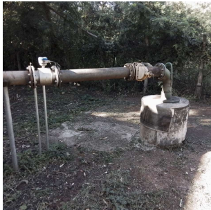
Foto 3 - Cavalete do poço via do café
