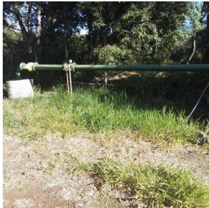
Foto 1 - Vista da área do poço
