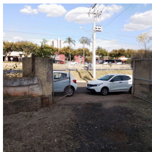
Foto 3 - Portão de acesso
