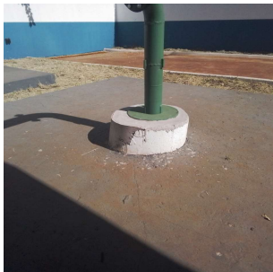
Foto 4 - Laje de proteção do poço
