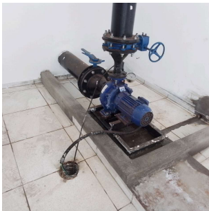
Foto 2 - Conjunto motor-bombas
