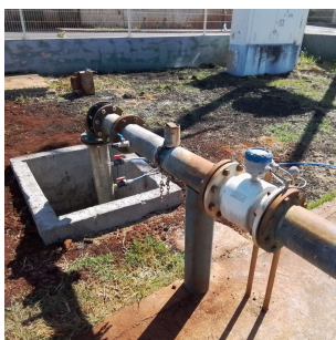
Foto 7 - Tamada para coleta de água bruta
