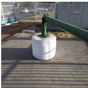
Foto 7 - Laje de proteção do poço
