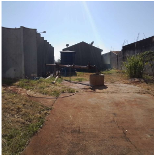
Foto 2 - Vista da limpeza de área
