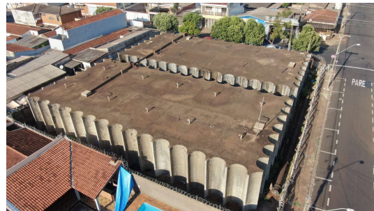
Foto 6 - Vista superior dos reservatórios Maranhão I e II
