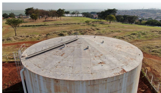
Foto 6 - Vista da cobertura do reservatório
