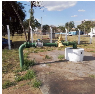
Foto 2 - Cavalete do poço rotatória Amin Calil
