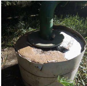
Foto 3 - Tubo de medição de nível
