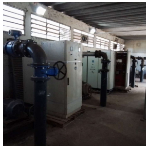
Foto 6 - Vista interna da estação elevatória
