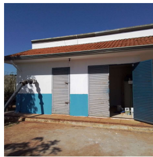
Foto 4 - Vista externa da casa de bombas
