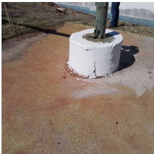
Foto 4 - Laje de proteção do poço Jardim Jamil Seme Cury
