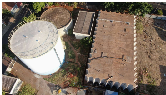
Foto 6 - Vista superior dos reservatórios
