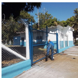
Foto 1 - Cercamento da área
