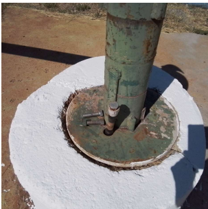
Foto 3 - Tubo de medição de nível do poço Jardim Jamil Seme Cury
