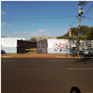
Foto 2 - Vista externa do local
