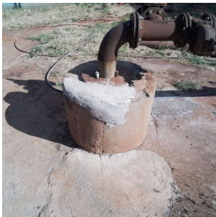
Foto 4 - Laje de proteção do poço
