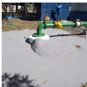
Foto 5 - Laje de proteção do poço Vila Albertina
