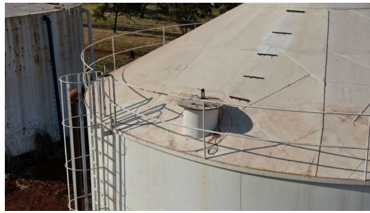
Foto 11 - Vista superior da tampa do reservatório
