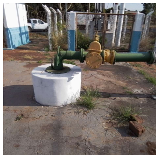
Foto 6 - Laje de proteção
