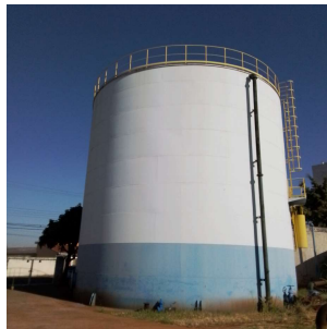
Foto 4 - Reservatório Coronel Camisão
