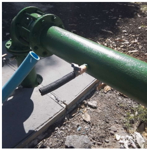
Foto 7 - Tomada para coleta de água briura
