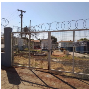
Foto 1 - Portão de acesso
