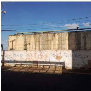
Foto 1 - Vista externa do local
