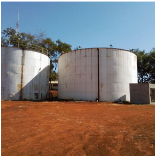
Foto 1 - Reservatórios Monte Alegre I e II
