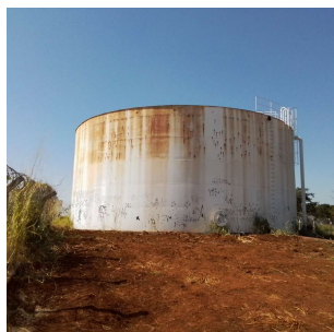
Foto 3 - Vista da área dos reservatórios
