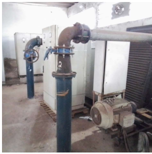
Foto 9 - Montagem da futura EEAT Campos Elísiod que será abastecido pelo poço Ciane III (em perfuração)
