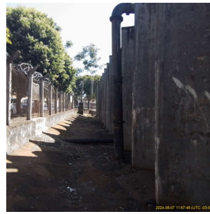
Foto 6 - Cercamento da área
