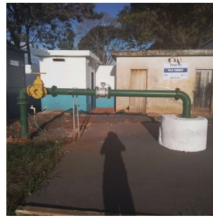
Foto 2 - Cavalete do poço Vila Tibério
