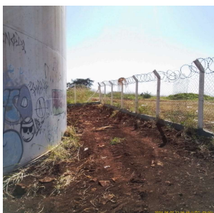
Foto 8 - Vista da limpeza da área dos reservatórios
