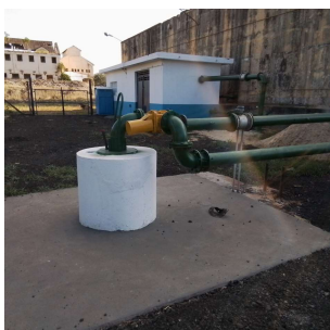
Foto 3 - Laje de proteção
