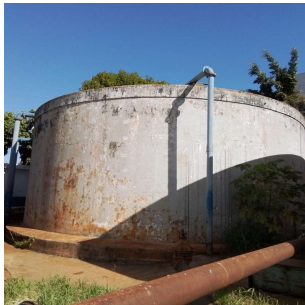
Foto 1 - Reservatório Coronel Camisão - Concreto Circular
