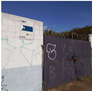
Foto 1 - Portão de acesso
