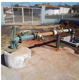
Foto 5 - Laje de proteção do poço Jardim Paiva
