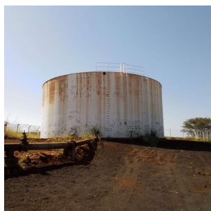
Foto 1 - Reservatório Jardim Jamil Seme Cury II
