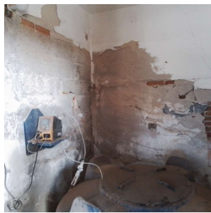
Foto 2 - Casa de dosagem de produtos químicos
