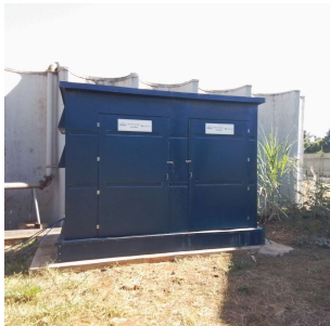
Foto 7 - Montagem da nova casa de dosagem de produtos químicos
