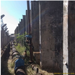
Foto 4 - Vista lateral do reservatório
