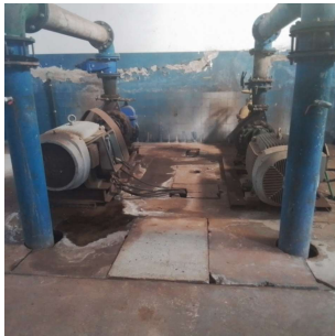
Foto 1 - Conjuntos motor-bombas
