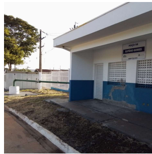
Foto 2 - Vista interna da área do poço
