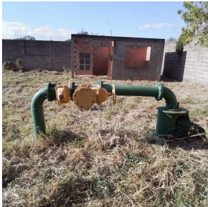
Foto 4 - Cavalete do poço Ciane I
