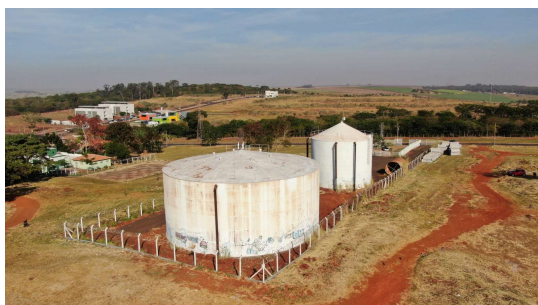
Foto 5 - Vista superior da área dos reservatórios, poço e elevatória
