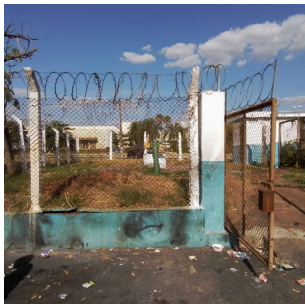
Foto 1 - Vista externa do poço rotatória Amin Calil
