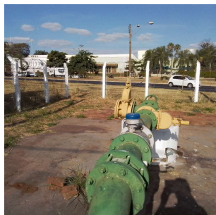
Foto 4 - Vista interna da limpeza da área
