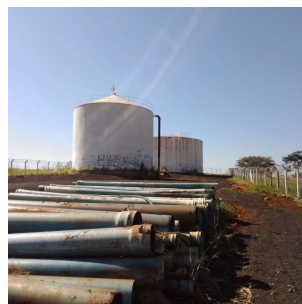
Foto 4 - Vista geral da área dos reservatórios
