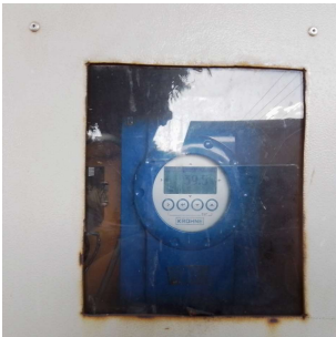
Foto 3 - Display do medidor de vazão do poço Pernambuco
