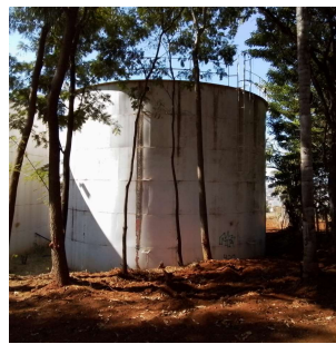
Foto 2 - Reservatório Monte Alegre I
