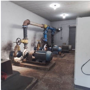
Foto 2 - Vista interna da EEAT Coronel Camisão
