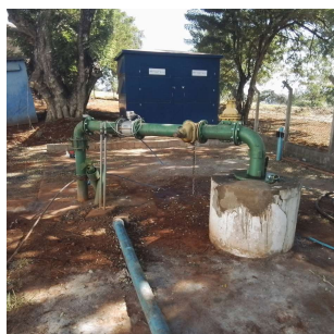
Foto 1 - Cavalete do poço Monte Alegre
