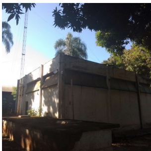
Foto 5 - Vista externa da EEAT Via do Café
