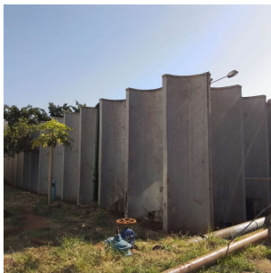
Foto 1 - Reservatório Coronel Camisão
