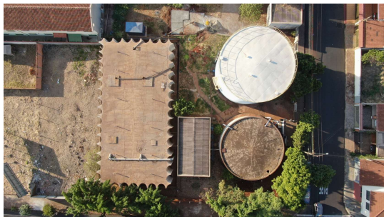
Foto 5 - Vista superior dos reservatórios
