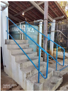
Foto 1 - Escada de acesso à área de operação, com guarda corpo.
