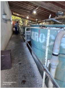
Foto 2 - Guarda corpo da área de operação.
