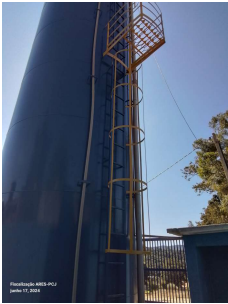
Foto 1 - Escada na base do reservatório.
