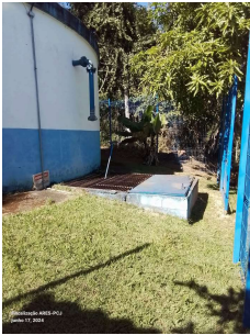
Foto 2 - Vista geral da área do reservatório.
