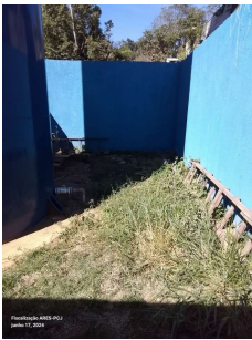
Foto 4 - Vista geral do interior da área do reservatório.
