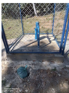
Foto 1 - Laje de concreto no entorno do poço.
