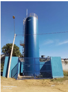
Foto 1 - Vista geral da área do reservatório.
