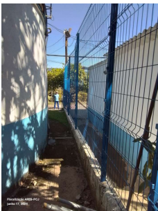
Foto 3 - Cercamento lateral da área do reservatório - à direita se encontram as edificações da ETA Alpes.
