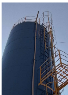
Foto 2 - Escada e guarda corpo no topo do reservatório.
