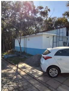
Foto 1 - No centro, a parede do reservatório de apoio no limite com a calçada da via de acesso, o cercamento de alambrado segue à esquerda e à direita.
