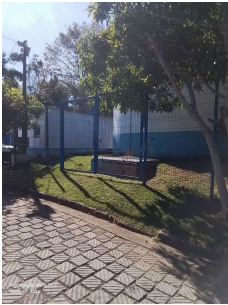
Foto 1 - Portão de acesso à área do reservatório.
