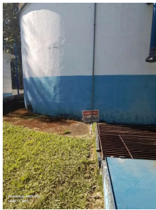
Foto 1 - Placa de identificação em local visível a partir da via de acesso.
