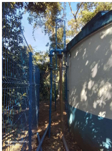
Foto 1 - Escada e guarda corpo em boas condições.
