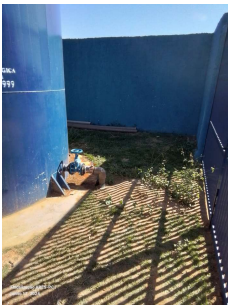
Foto 2 - Vista geral do interior da área do reservatório.
