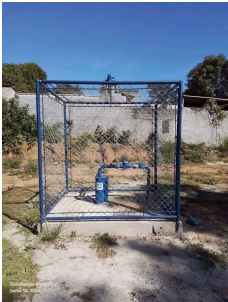
Foto 1 - Cercamento completo da área do poço.
