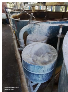
Foto 6 - Cal utilizada para ajuste de pH no processo de floculação/decantação.
