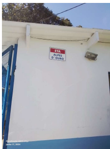
Foto 1 - Placa de identificação da ETA afixada em local de fácil visualização a partir da via de acesso.
