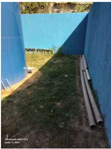
Foto 3 - Vista geral do interior da área do reservatório.
