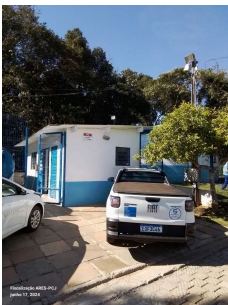
Foto 3 - No centro, a parede do depósito de produtos químicos no limite com a calçada da via de acesso.
