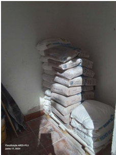
Foto 1 - Sala de armazenamento de cal e sulfato de alumínio - espaço fechado e coberto em boas condições.
