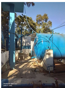
Foto 3 - Fundos do pátio da ETA, à direita, o filtro antigo desativado.
