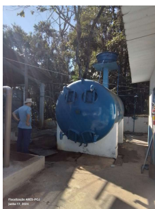
Foto 1 - Vista geral do pátio da ETA, no centro, filtro antigo desativado.
