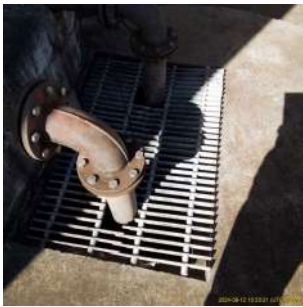
Foto 6 - EEEB do Distrito Industrial em Iracemápolis
