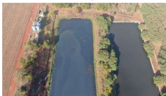
Foto 10 - Vista de drone da ETE de Iracemápolis
