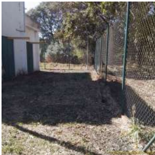
Foto 2 - EEEB do Distrito Industrial em Iracemápolis
