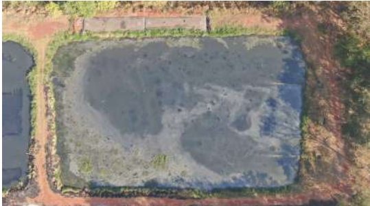
Foto 13 - Vista de drone da ETE de Iracemápolis
