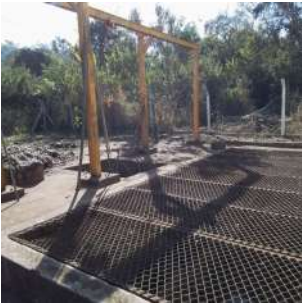
Foto 4 - Elevatória da EEEB Geral de Iracemápolis
