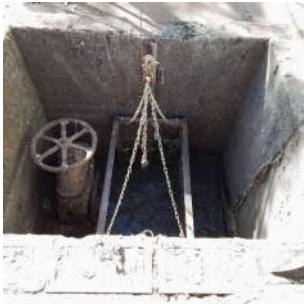
Foto 10 - Gradeamento da EEEB Geral de Iracemápolis
