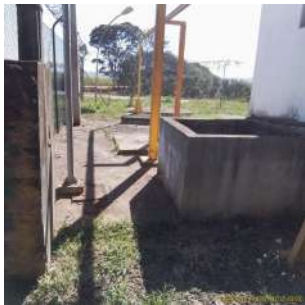
Foto 3 - EEEB do Distrito Industrial em Iracemápolis
