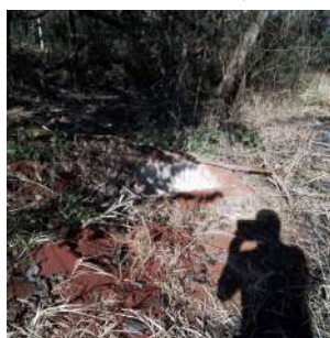
Foto 8 - Saída do efluente tratado da ETE de Iracemápolis
