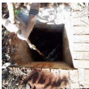
Foto 7 - Saída do efluente tratado da ETE de Iracemápolis
