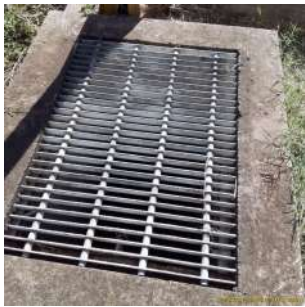
Foto 5 - EEEB do Distrito Industrial em Iracemápolis
