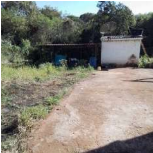
Foto 3 - Vista da EEEB Geral de Iracemápolis
