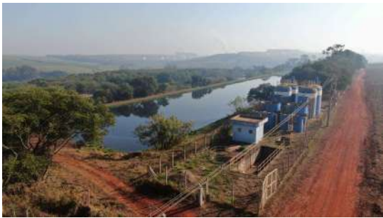
Foto 11 - Vista de drone da ETE de Iracemápolis
