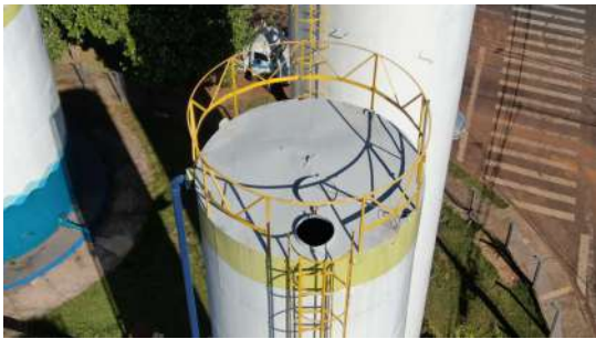
Foto 1 - RES. ETA III ELEVADO AÇO 140 mil L Vila Nogueira - Tampa aberta
