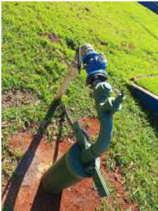
Foto 1 - Poço da ETA III
