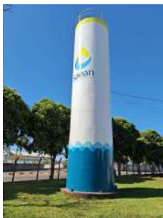
Foto 1 - Visão geral - solo - Reservatório 110 mil litros - Carolina
