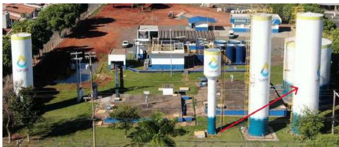
Foto 3 - Localização do Reservatório ETA III 200 mil L - aérea
