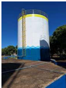
Foto 1 - Res Apoiado 600 mil L ETA III (Caldeirão) - Visão geral - solo
