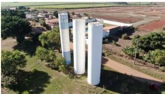
Foto 1 - Reservação Palmeiras - Visão Geral
