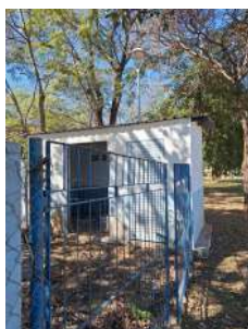
Foto 1 - Ausência de qualquer identificação - POÇO SERINGUEIRA
