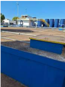
Foto 2 - Tampa de inspeção do reservatório enterrado
