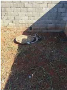
Foto 1 - Condições de acesso EEEB CONQUISTA
