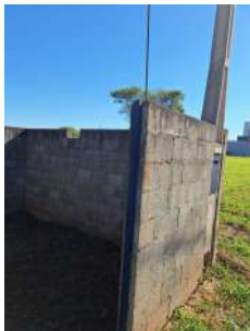
Foto 1 - Cercamento da área - EEEB CONQUISTA
