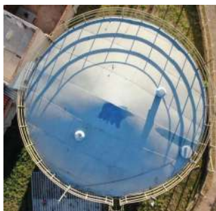
Foto 1 - RESERVATÓRIO NOSSO SONHO - Cobertura - tampa regular
