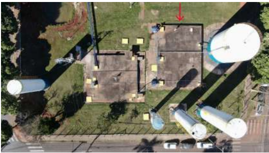
Foto 3 - Indicação do Reservatório - aérea
