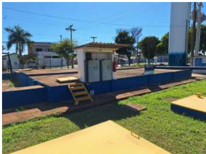
Foto 1 - Local onde se situa o RESERVATÓRIO ENTERRADO CONCRETO INTERLIGADO II - ETA III
