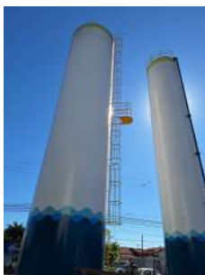
Foto 1 - Escada com guarda-corpos - Reservatório ETA III - 200 mil L
