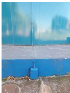
Foto 3 - Res Apoiado 600 mil L ETA III (Caldeirão) - aterramento
