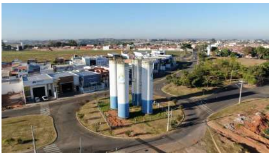
Foto 1 - Reservação Vila Nogueira - Visão geral
