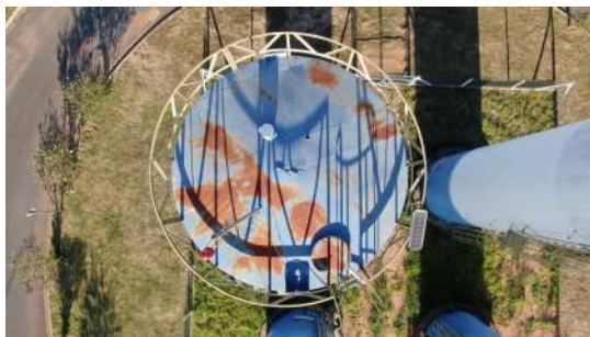
Foto 4 - Reservatório Vila Nogueira - cobertura
