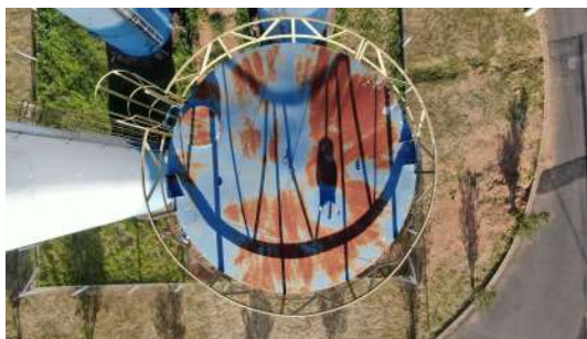
Foto 2 - Reservatório Vila Nogueira - cobertura
