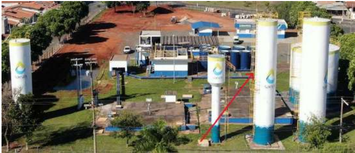
Foto 3 - RES. ETA III ELEVADO AÇO 140 mil L Vila Nogueira - Localização - aérea
