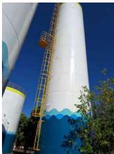
Foto 1 - Reservatório ETA III 200 mil L - visão geral - solo
