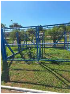
Foto 1 - POÇO LAGOA DOS PÁSSAROS - Visão geral
