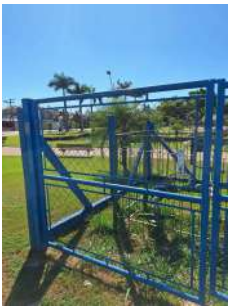
Foto 1 - Área devidamente cercada POÇO LAGOA DOS PÁSSAROS
