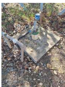
Foto 1 - Laje de concreto - POÇO SERINGUEIRA
