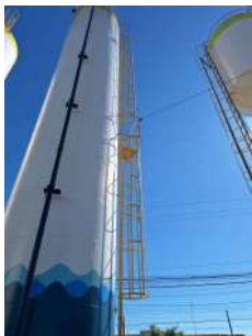
Foto 1 - RES. ETA III ELEVADO AÇO 140 mil L Vila Nogueira - escada com guarda-corpos
