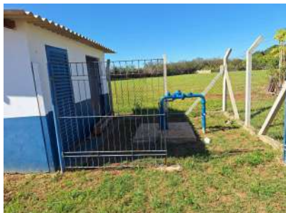
Foto 1 - POÇO ITAMARATY II (JOÃO BOMBO) - Visão geral
