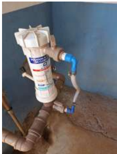
Foto 1 - Cloração e fluoretação por dispositivo compacto
