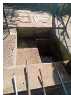
Foto 2 - Rastelos de limpeza da grade e poço de sucção tampado, ao fundo
