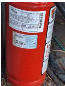
Foto 1 - Etiqueta de controle da manutenção do extintor.
