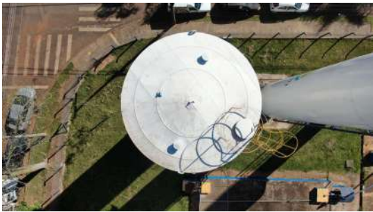
Foto 1 - Reservatório ETA III - 200 mil L - visto de cima - tampa regular
