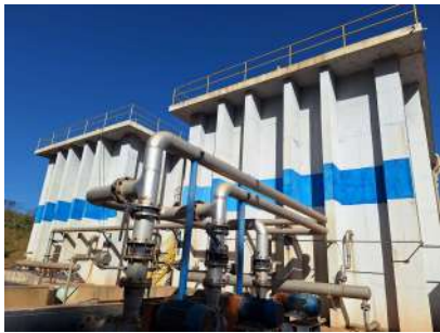
Foto 5 - ETE Sítio Novo - 3 bombas de recalque, 2 em operação. Dois reatores em paralelo
