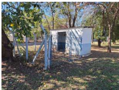
Foto 1 - Cercamento de área - POÇO SERINGUEIRA
