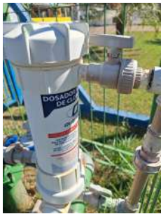
Foto 1 - Cloração e fluoretação com dispositivo portátil
