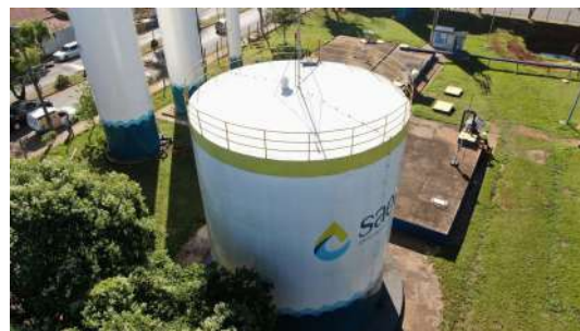
Foto 4 - Res Apoiado 600 mil L ETA III (Caldeirão) - visão geral - aérea
