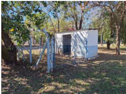
Foto 1 - POÇO SERINGUEIRA - Visão geral
