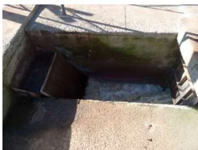
Foto 1 - Local de acesso ao gradeamento grosseiro
