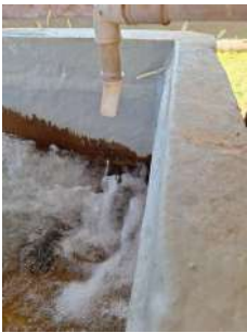
Foto 12 - Detalhes da dosagem dos produtos químicos na região de mistura
