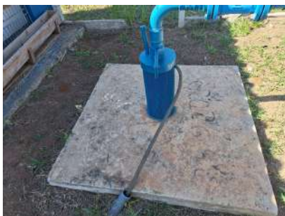
Foto 1 - Laje de concreto - proteção do poço
