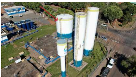
Foto 5 - Res Apoiado 600 mil L ETA III (Caldeirão) - localização
