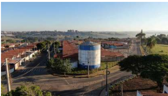
Foto 1 - RESERVATÓRIO NOSSO SONHO - Visão Geral
