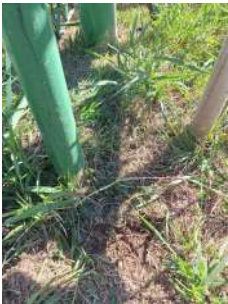
Foto 1 - Ausência de laje de concreto para proteção do poço.
