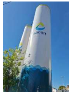
Foto 2 - Reservatório ETA III 200 mil L - detalhe de nova pintura
