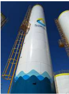
Foto 2 - RES. ETA III ELEVADO AÇO 140 mil L Vila Nogueira - Visão geral - solo - 2
