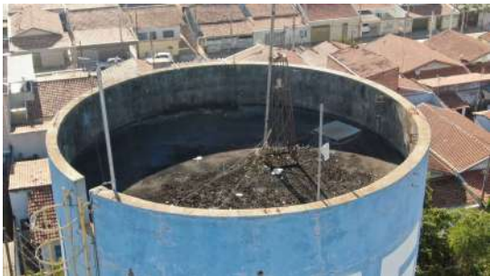
Foto 1 - Reservatório Elevado Coração Criança - cobertura com para-raios e tampa
