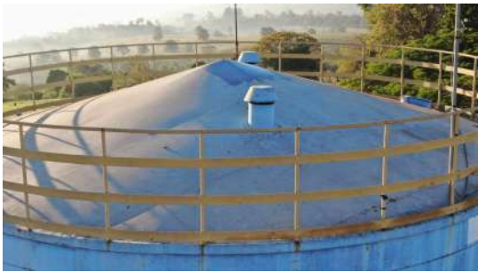
Foto 1 - RESERVATÓRIO NOSSO SONHO - Ventilação
