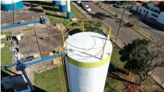
Foto 1 - Reservatório 110 mil litros - Carolina - Cobertura com tampa regular
