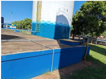
Foto 1 - Aspecto da estrutura de concreto do reservatório enterrado
