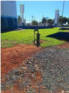
Foto 2 - Local onde se situa o Poço, na ETA III
