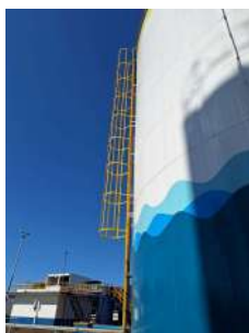
Foto 1 - Res Apoiado 600 mil L ETA III (Caldeirão) - escada com guarda-corpos
