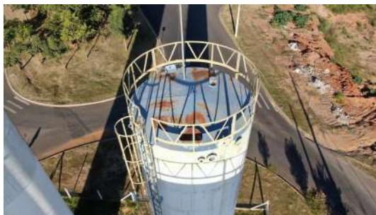
Foto 3 - Reservatório Vila Nogueira - cobertura
