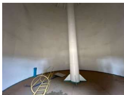
Foto 6 - Vista interna do reservatório
