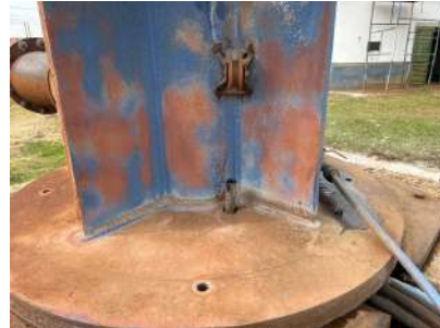
Foto 12 - Tubo de medição de nível
