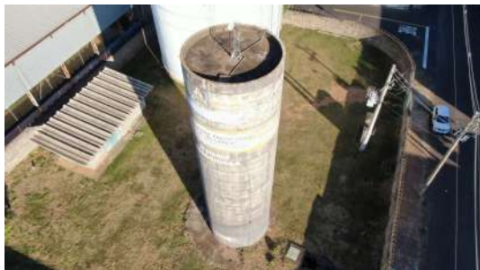
Foto 4 - Vista aérea do reservatório
