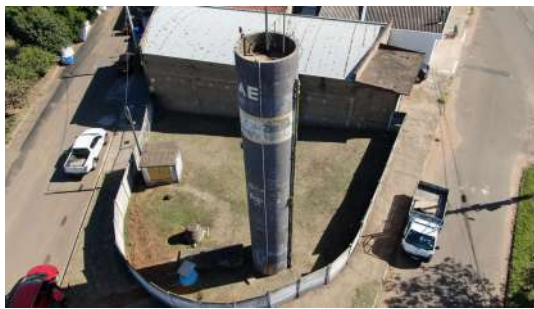
Foto 6 - Vista aérea do reservatório
