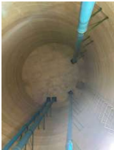
Foto 5 - Vista interna do reservatório
