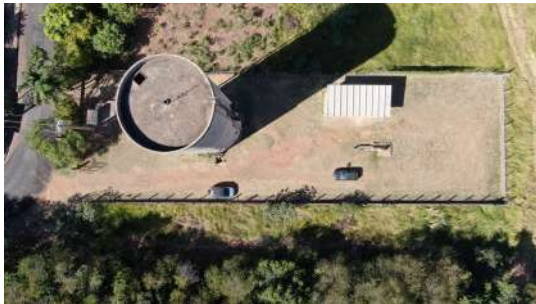
Foto 5 - Vista aérea do reservatório
