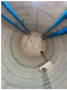
Foto 3 - Vista interna do reservatório
