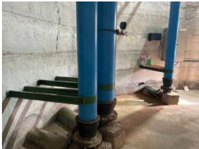
Foto 6 - Vista interna do reservatório
