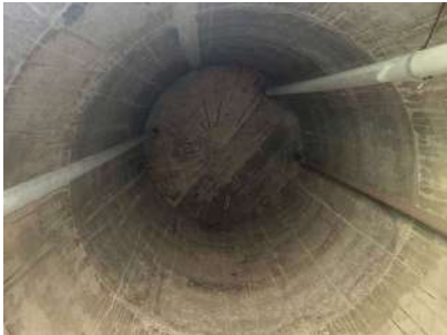
Foto 4 - Vista interna do reservatório
