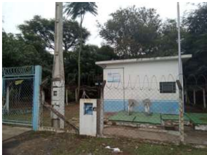
Foto 1 - Vista externa da elevatória
