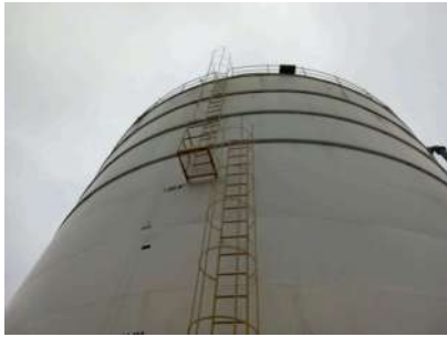
Foto 3 - Escadas e guarda-corpo
