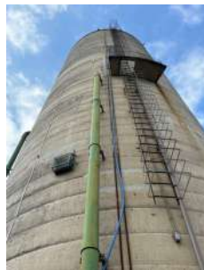
Foto 6 - Dosagem de cloro e flúor direto no reservatório
