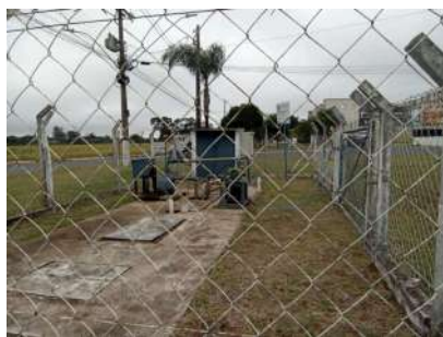
Foto 1 - Vista externa da elevatória
