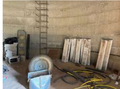
Foto 6 - Vista interna do reservatório
