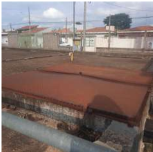
Foto 2 - Tampa do reservatório
