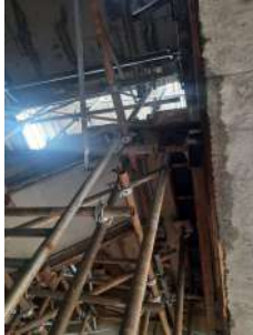
Foto 7 - Vista das obras emergenciais no UASB
