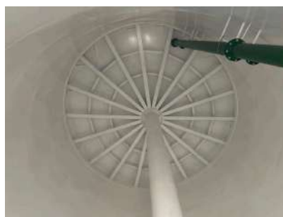
Foto 4 - Vista interna do reservatório
