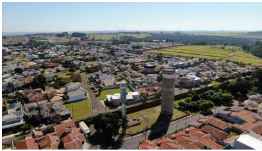
Foto 7 - Vista aérea da área
