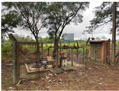
Foto 1 - Placa de identificação e cercamento
