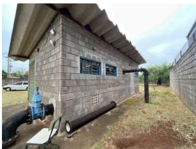
Foto 7 - Vista externa da elevatória
