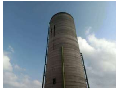
Foto 2 - Vista do reservatório
