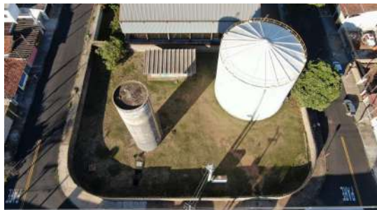
Foto 3 - Vista aérea do reservatório
