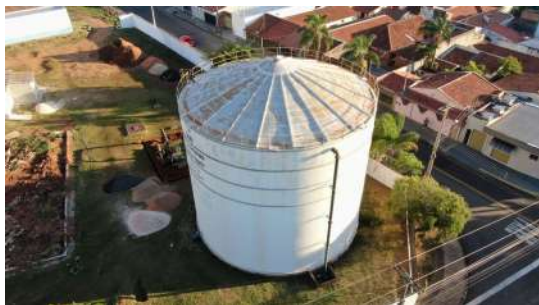
Foto 4 - Vista aérea do reservatório
