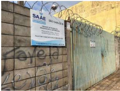
Foto 1 - Placa de identificação e cercamento
