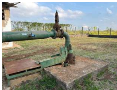
Foto 4 - Torneira para coleta de água bruta e laje de proteção
