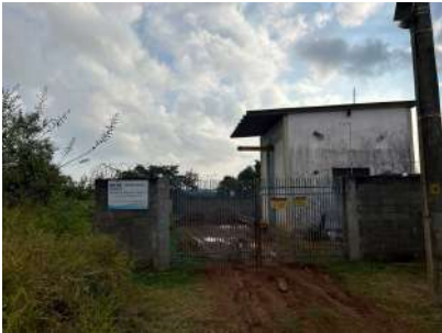
Foto 1 - Placa de identificação e cercamento
