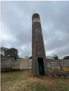
Foto 3 - Vista do reservatório
