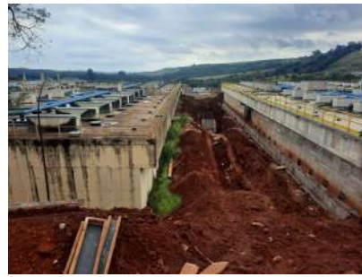
Foto 6 - Vista as obras emergenciais nas tubulações
