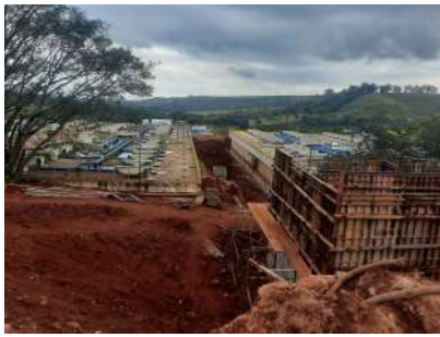
Foto 5 - Vista das obras emergenciais na caixa de distribuição de esgoto
