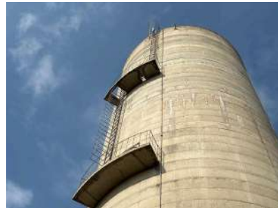
Foto 8 - Escadas e guarda-corpo
