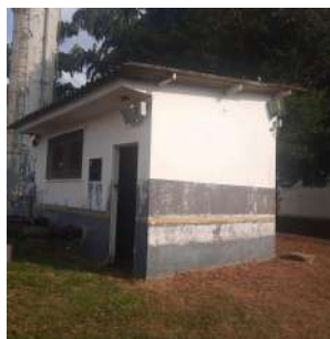
Foto 2 - Edificação da elevatória
