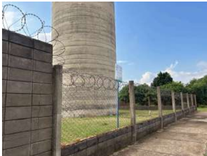
Foto 2 - Cercamento da área
