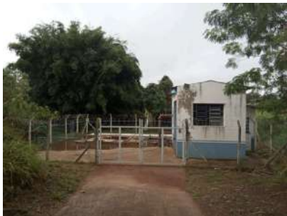
Foto 1 - Vista da elevatória
