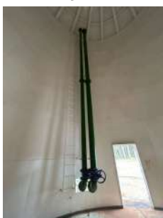
Foto 5 - Vista interna do reservatório
