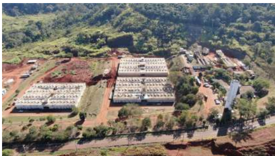
Foto 3 - Vista superior dos reatores UASB fora de operação
