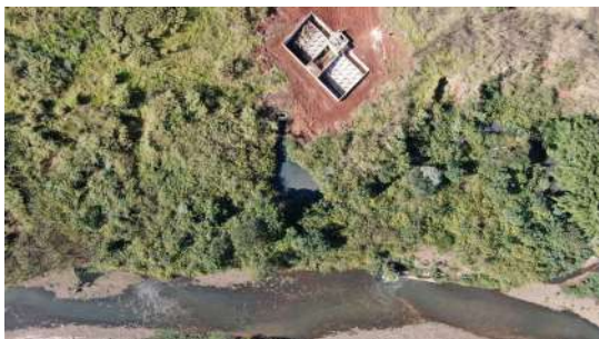
Foto 1 - Bypass na ETE Monjolinho fora de operação
