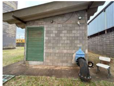
Foto 6 - Vista externa da elevatória
