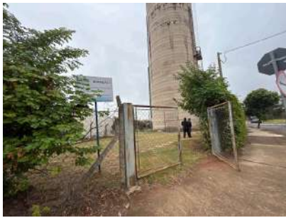
Foto 1 - Placa de identificação e cercamento
