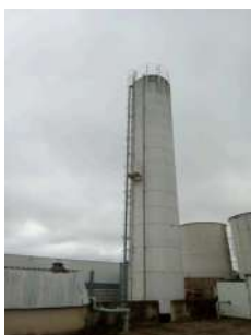
Foto 1 - Vista do reservatório
