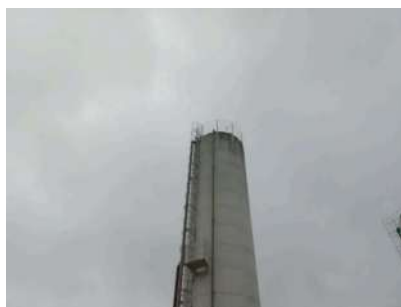
Foto 2 - Vista do reservatório
