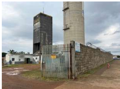
Foto 2 - Cercamento da área
