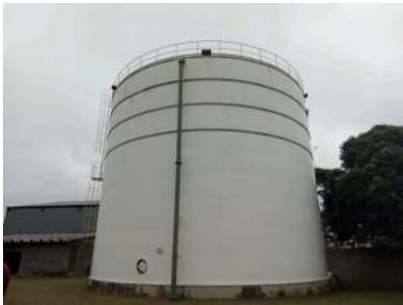
Foto 2 - Vista do reservatório
