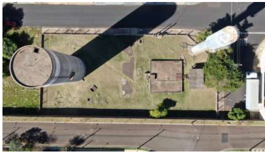
Foto 6 - Vista aérea do reservatório
