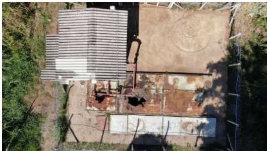
Foto 2 - Ausência de extravasamento na elevatório em 05/06/2024
