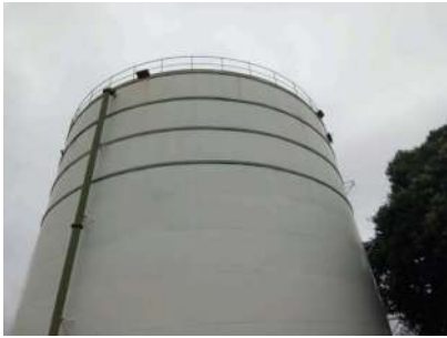
Foto 4 - Vista do reservatório
