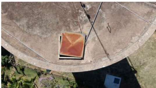
Foto 1 - Tampa do reservatório aberta
