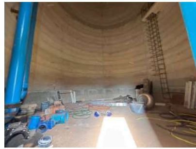
Foto 4 - Vista interna do reservatório
