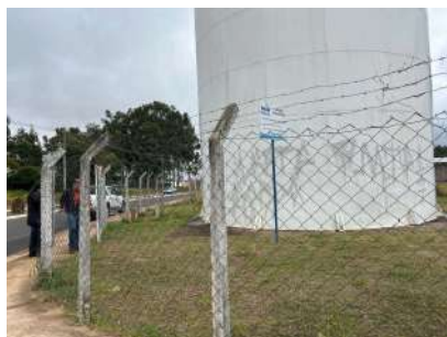
Foto 1 - Placa de identificação e cercamento
