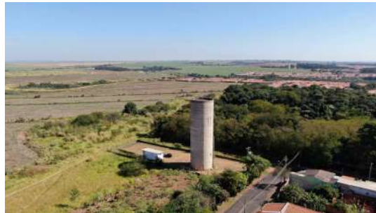
Foto 6 - Vista aérea do reservatório
