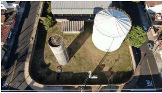
Foto 5 - Vista aérea do reservatório
