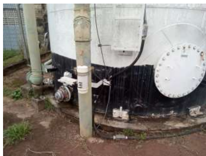
Foto 3 - Cabo de descida e aterramento
