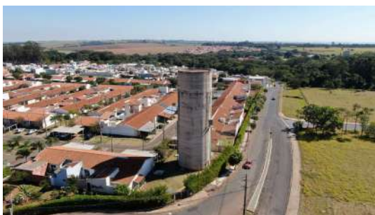
Foto 7 - Vista aérea do reservatório
