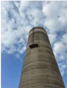
Foto 3 - Escada de acesso
