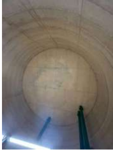
Foto 3 - Vista interna do reservatório
