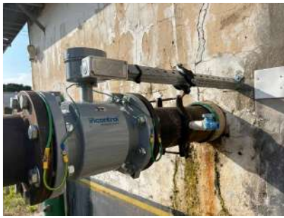
Foto 5 - Macromedidor e torneira de coleta de água bruta
