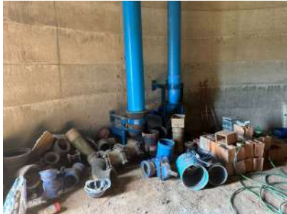
Foto 5 - Vista interna do reservatório
