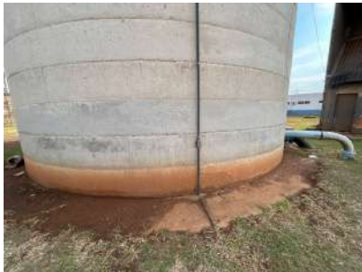
Foto 7 - Subsistema de descida e aterramento
