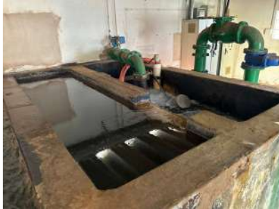
Foto 7 - Tanque com chicanas
