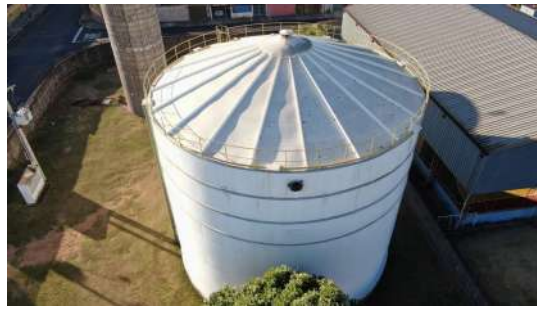
Foto 6 - Vista aérea do reservatório
