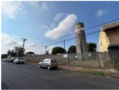
Foto 2 - Vista externa do poço, reservatório e EEAT São Carlos III
