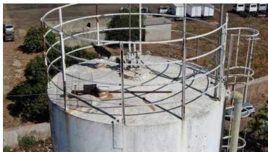
Foto 5 - Vista aérea do reservatório
