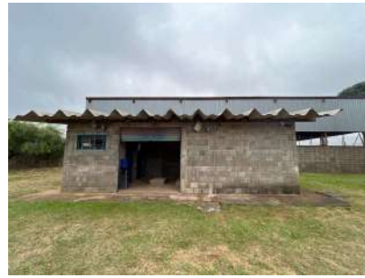
Foto 2 - Vista da elevatória
