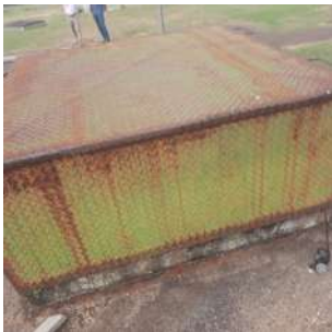
Foto 3 - Acesso ao reservatório
