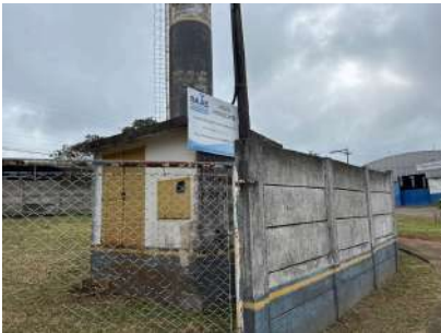
Foto 1 - Placa de identificação e cercamento
