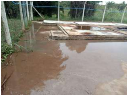
Foto 1 - Extravasamento na elevatória em 28/05/24
