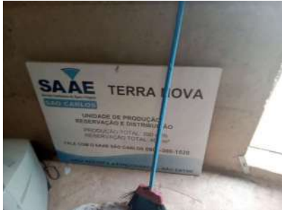
Foto 3 - Placa de identificação armazenada na área interna do reservatório
