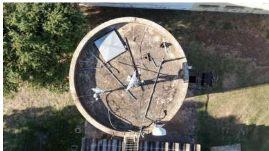
Foto 1 - Vista superior do reservatório São Carlos III, com aberturas
