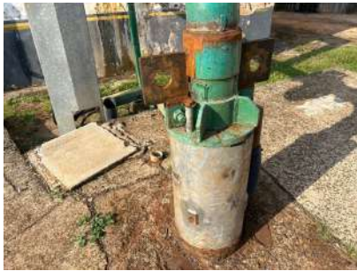
Foto 4 - Tubo de medição de nível
