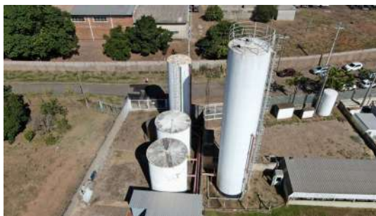
Foto 4 - Vista aérea do reservatório
