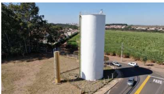
Foto 8 - Vista aérea do reservatório
