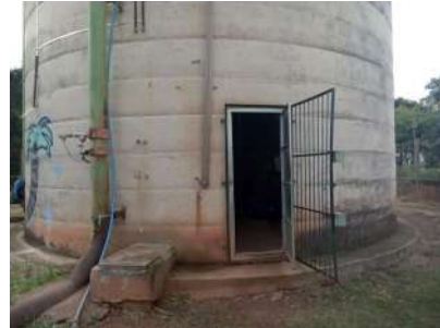
Foto 4 - Entrada da elevatória, sob o reservatório elevado
