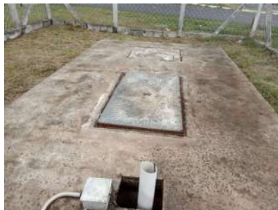
Foto 4 - Tampa de inspeção
