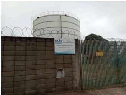
Foto 1 - Placa de identificação e cercamento
