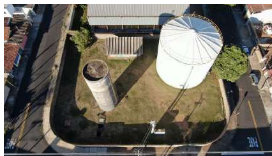
Foto 8 - Vista superior da EEAT e reservatórios Parque Industrial
