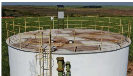
Foto 7 - Vista aérea do reservatório
