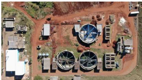
Foto 4 - Vista superior dos flotores fora de operação
