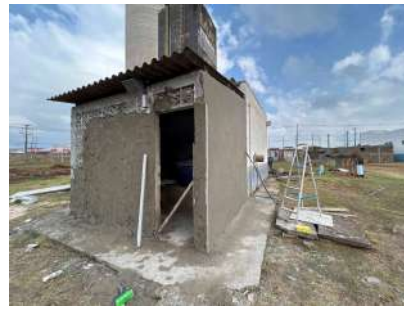
Foto 10 - Casa de química em reforma
