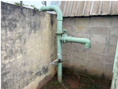
Foto 2 - Torneira de coleta de água bruta
