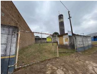
Foto 2 - Cercamento da área
