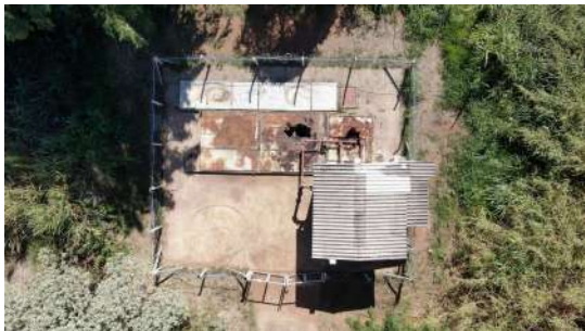
Foto 4 - Vista aérea da EEE
