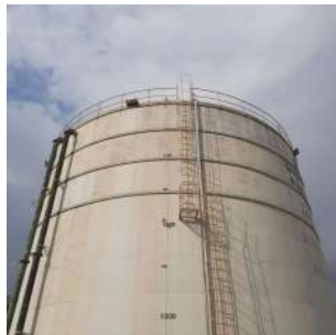
Foto 2 - Vista do reservatório
