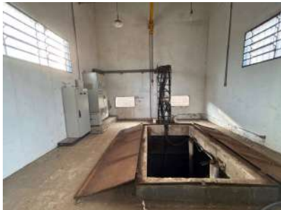
Foto 7 - Vista interna da edificação
