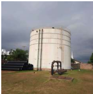
Foto 1 - Vista do reservatório
