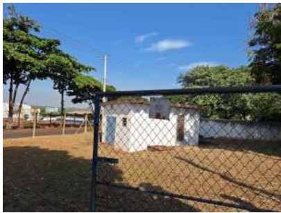
Foto 1 - Não há qualquer identificação na área
