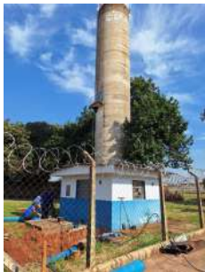
Foto 2 - Reservatório elevado COHAB I
