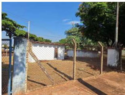
Foto 1 - Entrada da área do reservatório COHAB III
