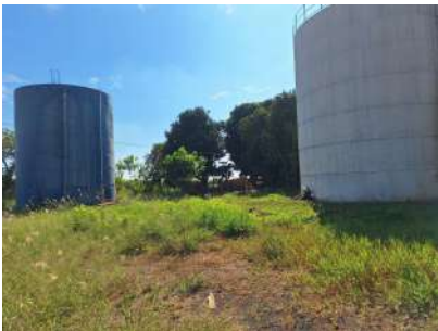
Foto 2 - Vis  o Geral - 2 reservat  rios - Vale do Sol
