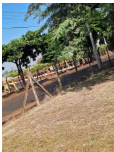
Foto 1 - Cercamento da área
