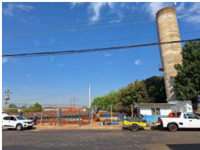
Foto 1 - Visão geral - área de reservação COHAB I
