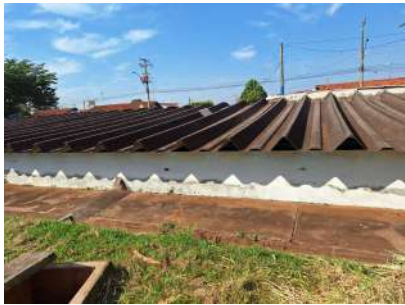
Foto 3 - Reservatório enterrado COHAB I
