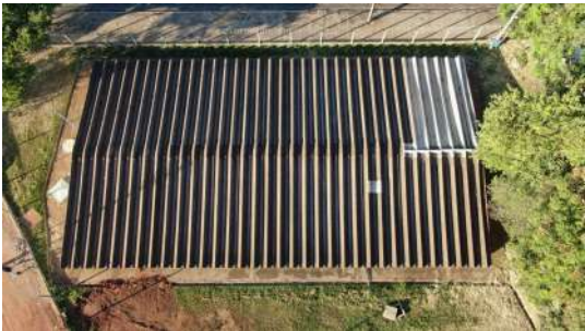
Foto 5 - Visão geral - cobertura do reservatório semi-enterado - COHAB I
