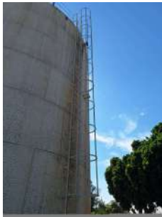
Foto 1 - Guarda-corpos no reservatório branco
