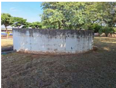
Foto 2 - Reservatório COHAB III
