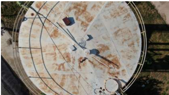
Foto 1 - Cobertura Reservatório R06 - Tampa regular
