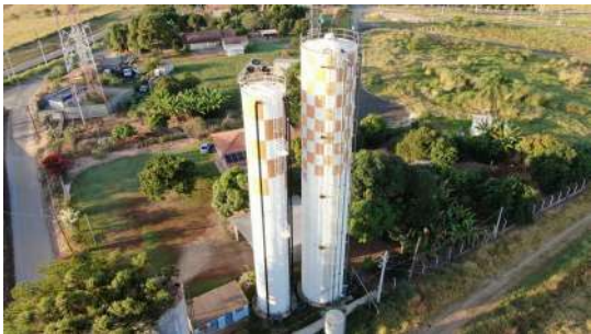
Foto 1 - Visão geral - Reservatórios São Pedro
