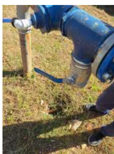
Foto 1 - Derivação do poço
