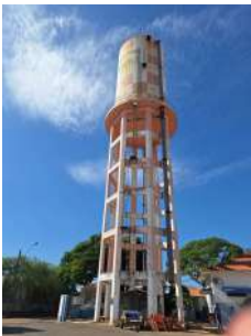
Foto 1 - Visão geral do Reservatório R03 a partir do solo.
