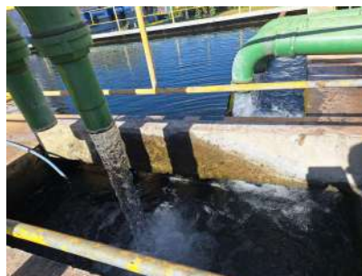
Foto 2 - Chegada de água subterrânea e mistura com oxidante (hipoclorito de sódio)
