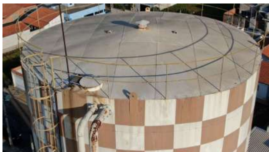
Foto 1 - RES - 25 - Detalhe de tampa
