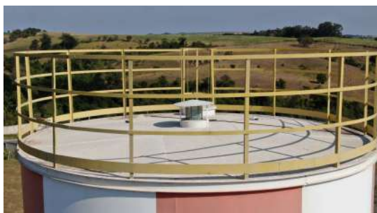
Foto 1 - RES 26 - TERRAS DO FRANCÊS - Tela de proteção
