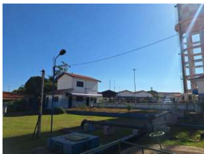
Foto 1 - Visão geral da sede do SAMAE, reservatório enterrado, prédio administrativo, reservatório elevado, unidade de chegada de água de seis poços da cidade
