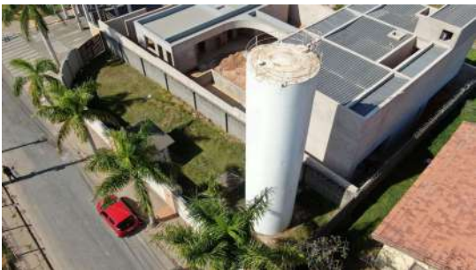
Foto 1 - Visão Geral - Reservatório Moinho Novo
