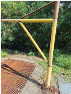
Foto 1 - Trave para acesso retirada de bomba para manutenção
