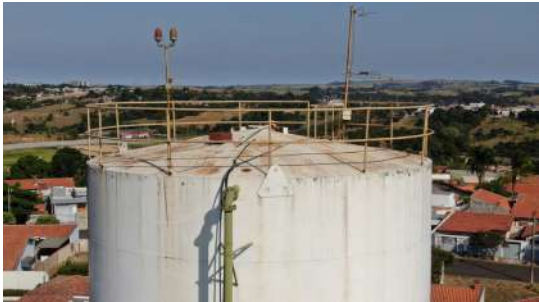
Foto 1 - Rervatório R06 - Cobertura e para-raios
