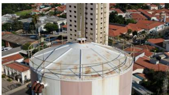
Foto 1 - Ventilação na cobertura - R03
