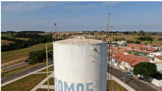
Foto 1 - Cobertura com destaque para extravasor
