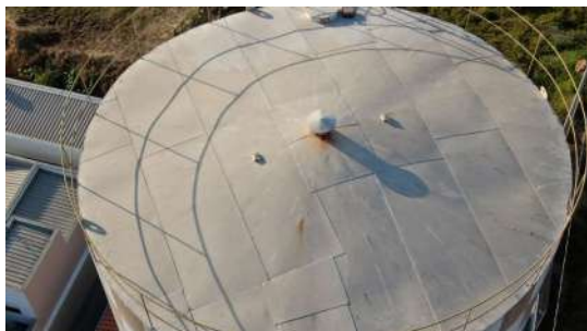
Foto 1 - RES 25 - Cobertura e ventilação
