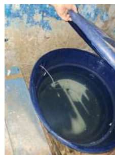
Foto 5 - Tanque com solução de uso de Ortopolifosfato
