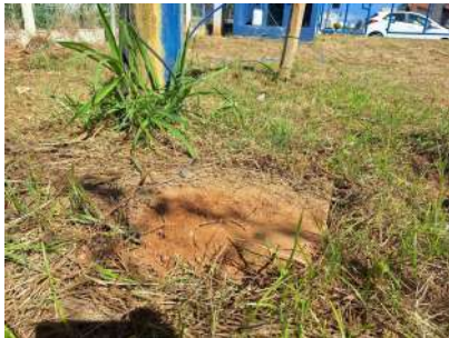
Foto 1 - Laje de concreto, coberta por mato
