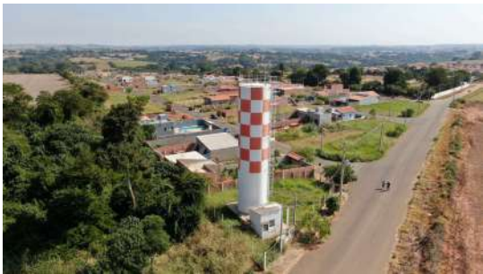
Foto 1 - Visão Geral - Reservatório Jatobá
