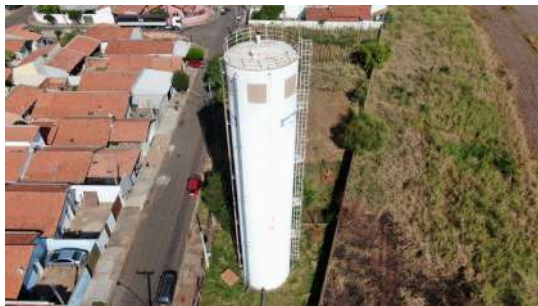
Foto 1 - Visão Geral - R23 - Sistema Santa Maria
