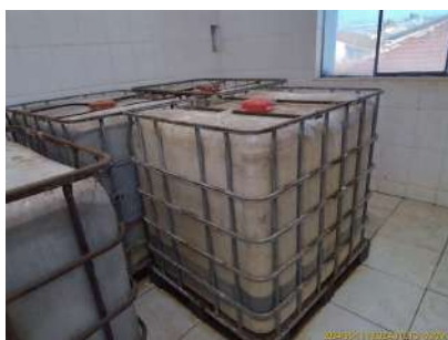
Foto 8 - Tanques de PAC (policloreto de alumínio).
