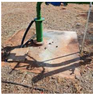
Foto 1 - Situação da laje de proteção do Poço.
