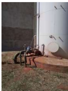
Foto 3 - Saída do reservatório.
