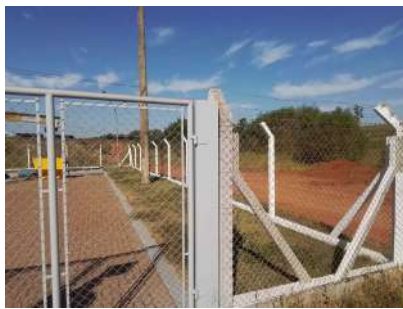
Foto 1 - Cercamento do local.
