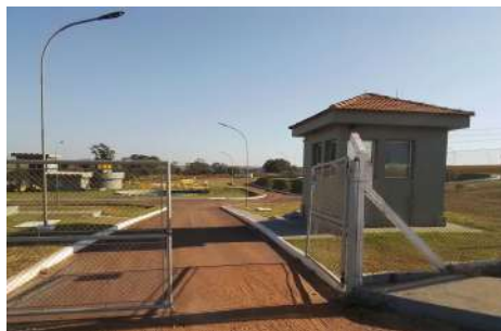
Foto 1 - Detalhe da entrada da ETE.
