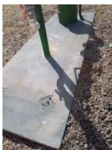
Foto 1 - Detalhe da laje de proteção.
