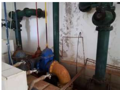
Foto 13 - Barrilete pós-filtração.
