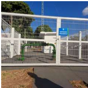
Foto 3 - Vista da entrada da área do Poço.
