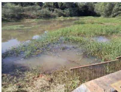
Foto 6 - Reservatório de água junto à captação.
