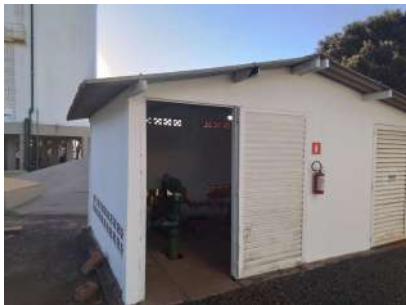
Foto 1 - Fachada da EEA.
