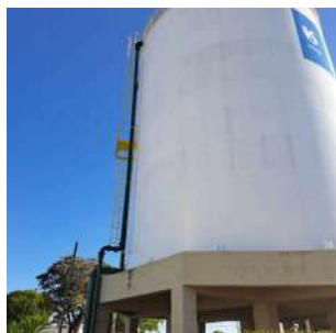
Foto 3 - Vista geral do reservatório.
