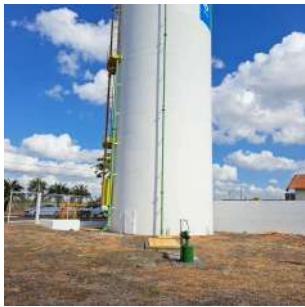
Foto 5 - Vista do reservatório elevado e do Poço P-90.
