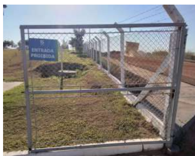
Foto 1 - Há uma placa de restrição de acesso junto ao portão, mas não há identificação do local junto ao portão. É necessário incluir identificação junto à entrada do local.
