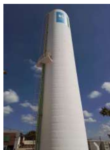
Foto 4 - Lateral do reservatório.
