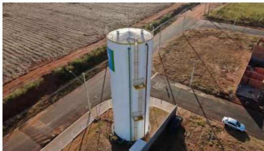
Foto 2 - Detalhe da haste no topo do reservatório.
