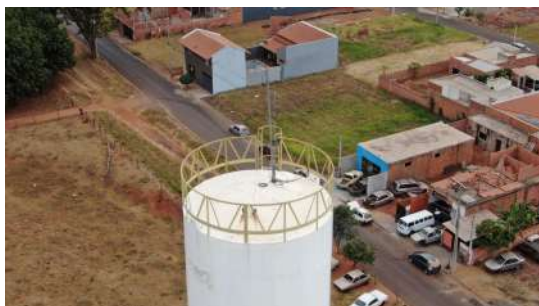
Foto 5 - Topo do reservatório.
