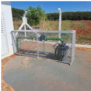
Foto 3 - Vista geral do Poço.
