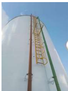
Foto 1 - Vazamento identificado próximo ao reservatório. De acordo com o Prestador, trata-se de uma bomba que bombeia água da rede para o reservatório.
