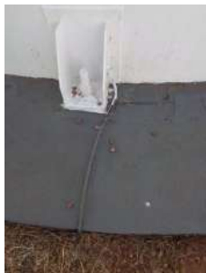
Foto 1 - Detalhe do condutor que liga o reservatório diretamente ao solo.
