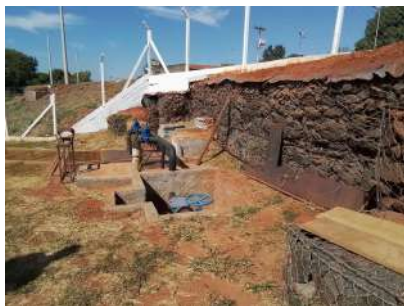
Foto 12 - Vista geral do muro de gabião.
