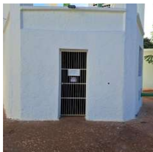
Foto 6 - Vista da entrada da EEAT.
