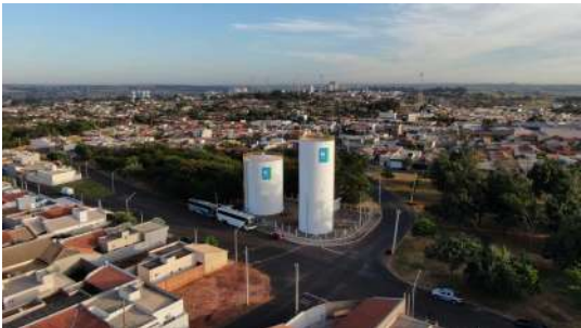
Foto 6 - Vista aérea dos reservatórios apoiado (esquerda) e elevado de concreto (direita).
