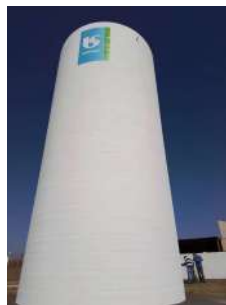
Foto 2 - Fachada do reservatório.
