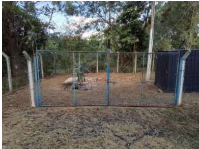
Foto 1 - Cercamento do Poço P52.
