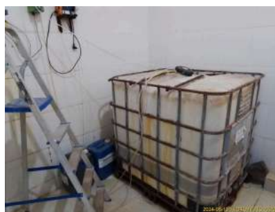
Foto 8 - Tanques de PAC (policloreto de alumínio).
