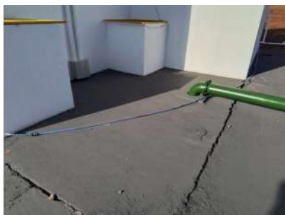
Foto 3 - A água captada pelo Poço Profundo 2 é enviada a um pequeno reservatório junto ao poço para posterior bombeamento pela Elevatória no local.
