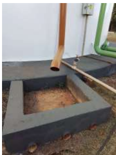
Foto 1 - Detalhe do extravasor e local de deságue.
