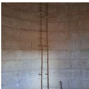
Foto 1 - Escada vertical interna do reservatório com guarda-corpo.
