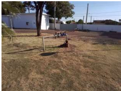
Foto 1 - Vista geral do Poço P60.
