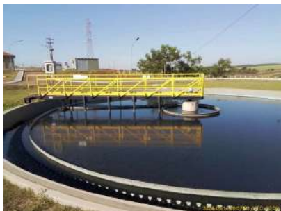
Foto 20 - Vista da plataforma rotativa sobre o decantador.
