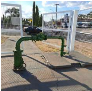
Foto 4 - Vista geral do Poço P-47.
