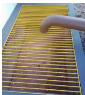
Foto 2 - Local de deságue do extravasor.
