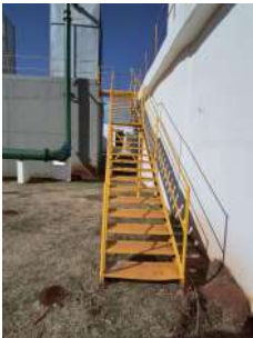
Foto 1 - Escada para acesso ao topo do reservatório.
