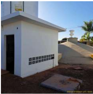
Foto 10 - Vista externa da EEAT e do reservatório semienterrado de 1.000m³ da ETA.
