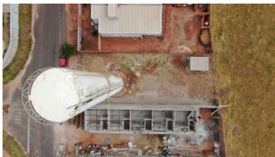
Foto 1 - Topo do reservatório.
