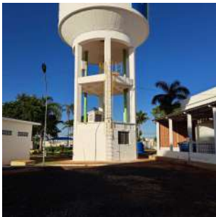
Foto 2 - Vista geral do reservatório elevado e da EEAT em sua base.
