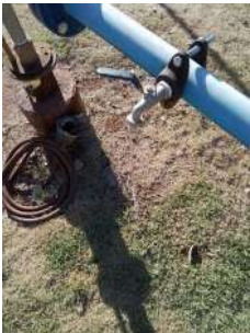
Foto 2 - Registro para coleta de água bruta - aberto.
