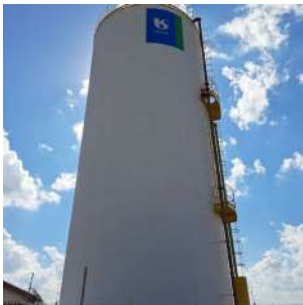
Foto 2 - Vista do reservatório elevado.
