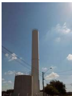
Foto 3 - Vista afastada do reservatório.
