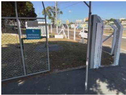
Foto 1 - Cercamento do local.
