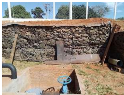
Foto 11 - Muro de gabião junto à captação.
