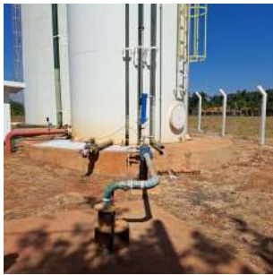
Foto 2 - Vista geral do Poço P-81.
