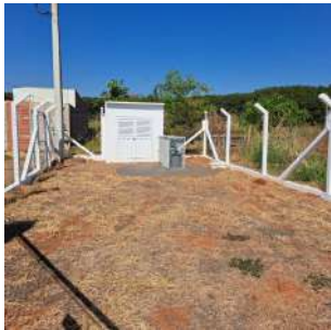
Foto 2 - Vista geral da área do Poço.
