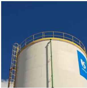
Foto 4 - Haste de captação de descargas elétricas.
