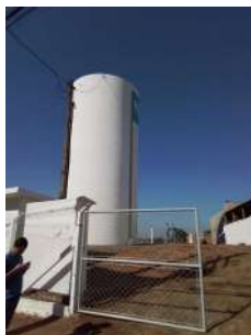
Foto 1 - Vista geral do reservatório.
