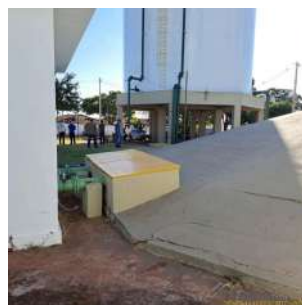
Foto 6 - Vista de parte da cobertura do reservatório e tubulações de sucção da EEAT Jd. Toledo.
