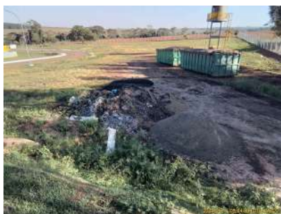
Foto 1 - Acúmulo de rejeitos próximo ao tratamento preliminar.
