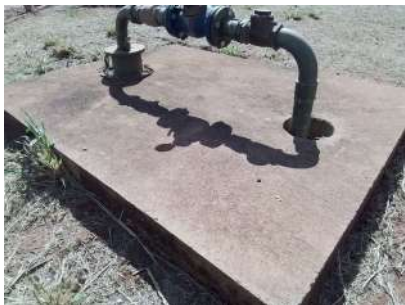
Foto 1 - Detalhe da laje de proteção.
