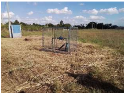
Foto 1 - Vista geral do Poço P83.
