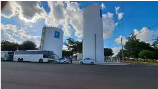
Foto 2 - Vista dos dois reservatórios Viva Olímpia: o elevado de concreto (direita) e o apoiado metálico (esquerda).
