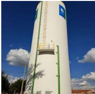
Foto 5 - Reservatório elevado de concreto.
