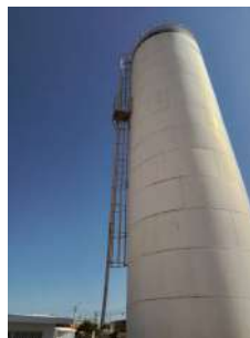
Foto 2 - Lateral do reservatório.
