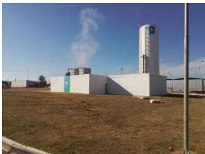
Foto 1 - Vista geral do reservatório.
