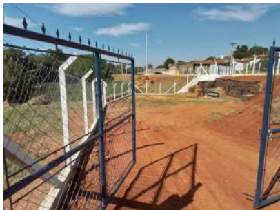
Foto 2 - Portão da captação.
