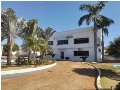
Foto 1 - Vista geral da entrada da ETA.
