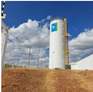
Foto 1 - Vista geral da área e reservatório Cidade de Lisboa ao fundo.
