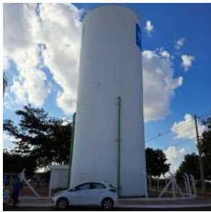
Foto 3 - Reservatório elevado de concreto.
