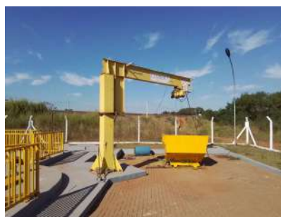
Foto 4 - Detalhe do suporte para içamento da caçamba.
