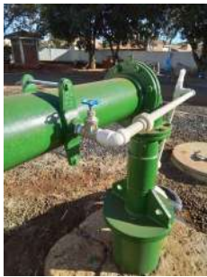
Foto 1 - Detalhe da instalação anteriormente à instalação da tomada de água para coleta de água bruta.
