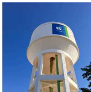
Foto 4 - Vista geral do reservatório elevado.
