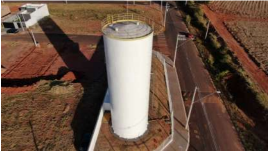
Foto 4 - Vista aérea do reservatório.
