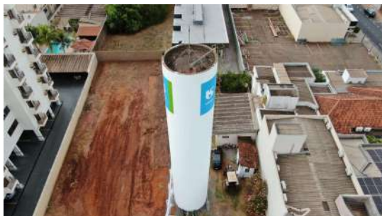
Foto 1 - Detalhe do topo do reservatório.
