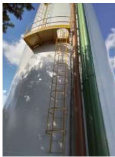
Foto 1 - Guarda-corpos do reservatório.
