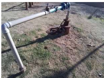
Foto 1 - Detalhe da base do poço.
