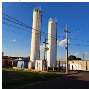
Foto 3 - Vista geral dos reservatórios elevados.
