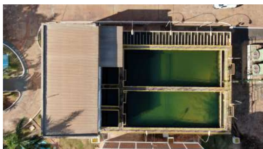
Foto 27 - Vista aérea das etapas de tratamento da ETA.
