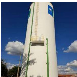
Foto 3 - Escada vertical externa e cobertura do reservatório com guarda-corpo.
