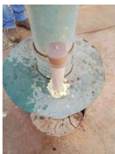
Foto 1 - Tubo de medição de nível.
