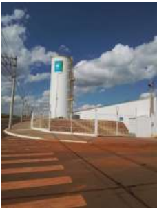
Foto 1 - Vista afastada do reservatório.
