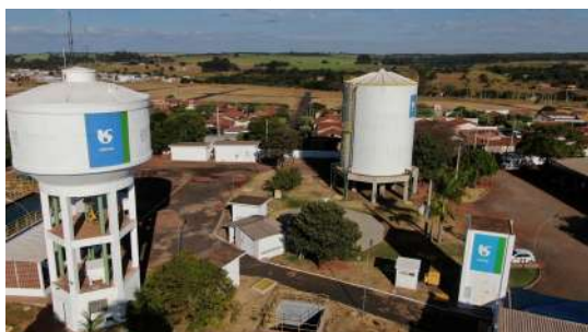
Foto 5 - Vista aérea dos reservatórios elevados (metálico e de concreto).
