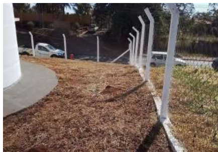
Foto 1 - Cercamento do local
