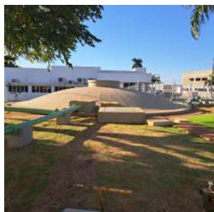
Foto 1 - Vista da cobertura do reservatório.
