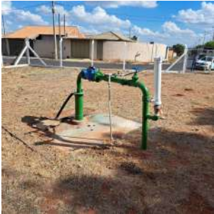
Foto 4 - Vista geral do Poço.
