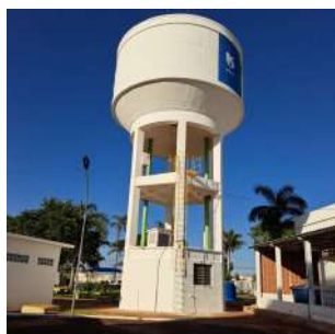
Foto 3 - Vista geral do reservatório elevado e da EEAT em sua base.
