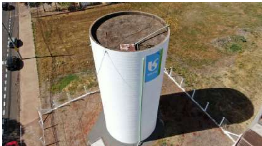
Foto 3 - Vista aérea do reservatório.
