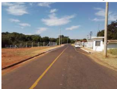
Foto 18 - Vista geral do local. À esquerda, a captação e à direita os painéis elétricos.
