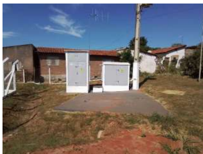
Foto 16 - Painéis fora do abrigo.
