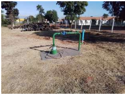
Foto 1 - Vista geral do Poço P67.
