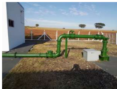
Foto 2 - Detalhe do cavalete do Poço Profundo 2.
