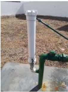
Foto 1 - Aplicação de cloro e flúor por pastilha.
