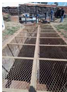
Foto 7 - Fluxo da água captada (bombas submersas ao fundo).
