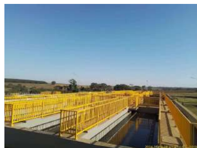
Foto 11 - Vista geral dos tanques de lodo ativado.
