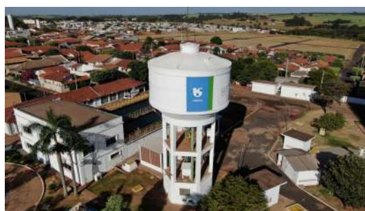
Foto 7 - Vista aérea do reservatório elevado.
