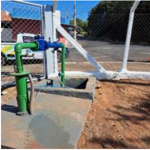
Foto 3 - Vista geral da área do Poço P32.
