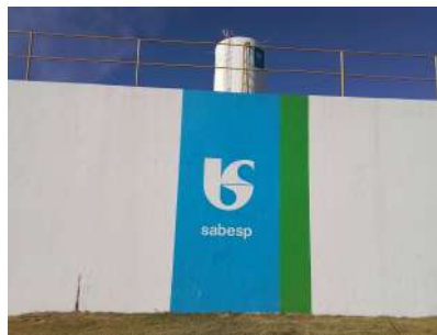
Foto 2 - Logo da SABESP na fachada do reservatório.
