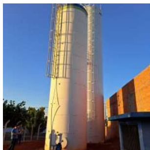
Foto 1 - Reservatório elevado de 100m³ (frente).
