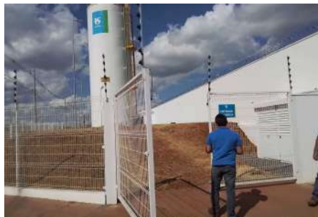
Foto 1 - Cercamento do local.
