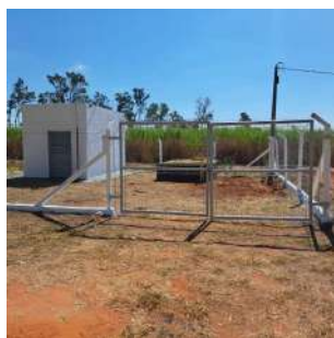
Foto 1 - Vista externa da EEE.
