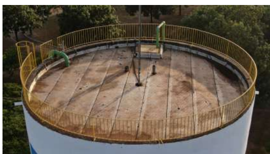
Foto 1 - Vista aérea da cobertura do reservatório, com destaque para a tubulação no centro da cobertura
