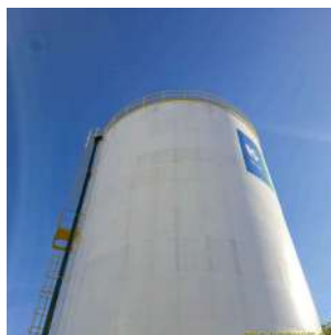
Foto 4 - Vista geral do reservatório.
