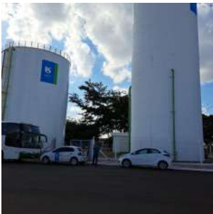
Foto 1 - Vista dos dois reservatórios Viva Olímpia: o elevado de concreto (direita) e o apoiado metálico (esquerda).
