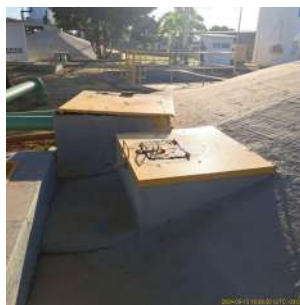
Foto 2 - Situação das tampas de inspeção próximas à chegada de água da ETA.
