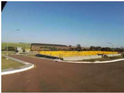
Foto 1 - Vista geral 1 da ETE.
