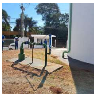
Foto 3 - Vista geral do Poço P68.
