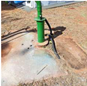
Foto 3 - Situação da laje de proteção do Poço.
