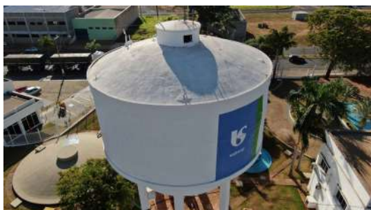
Foto 1 - Detalhe da estrutura no topo da laje do reservatório elevado.
