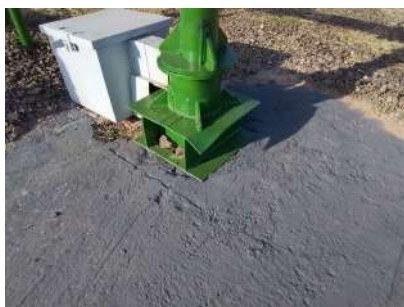
Foto 1 - Detalhe da laje de proteção.
