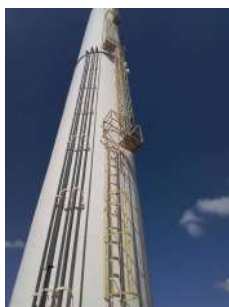
Foto 1 - Guarda-corpos do reservatório.
