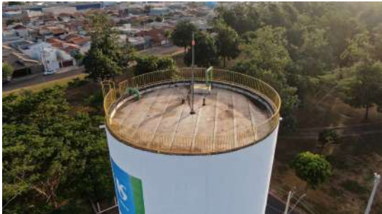
Foto 1 - Detalhe da haste do para-raios.
