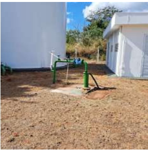
Foto 2 - Vista geral da área do Poço.
