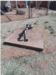
Foto 1 - Vista geral do Poço P80.
