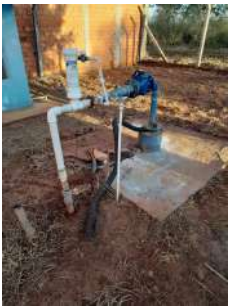
Foto 1 - Vista geral do Poço P71.
