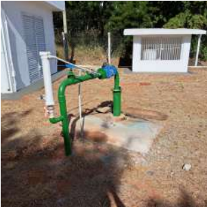
Foto 3 - Vista geral do Poço.
