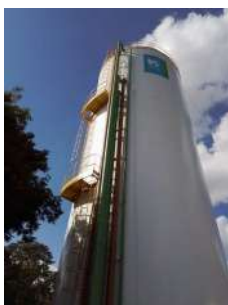
Foto 3 - Vista lateral do reservatório.
