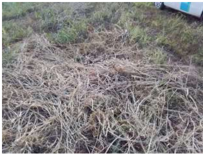
Foto 1 - Detalhe do acúmulo de vegetação roçada junto ao Poço P83.
