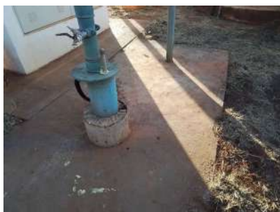
Foto 1 - Detalhe da laje de proteção.
