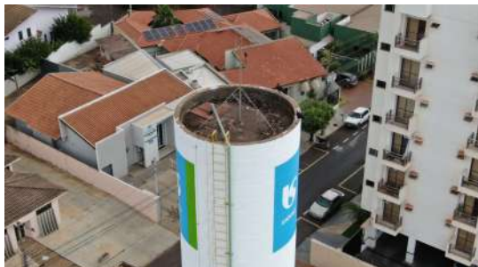
Foto 5 - Vista aérea do reservatório.
