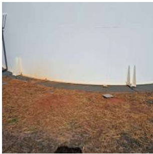
Foto 1 - Aterramento da estrutura metálica do reservatório.
