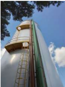
Foto 1 - Descida do extravasor.
