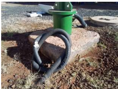
Foto 1 - Detalhe da laje de proteção.
