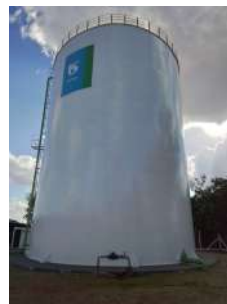
Foto 5 - Vista geral do reservatório Viva Olímpia Apoiado, próximo ao Poço P72.
