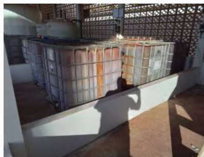
Foto 4 - Detalhe das baias de contenção.
