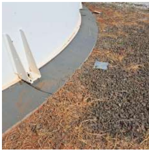
Foto 2 - Aterramento da estrutura metálica do reservatório.
