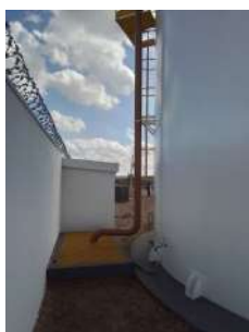
Foto 1 - Extravasor na lateral do reservatório.
