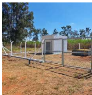
Foto 2 - Vista externa da EEE.
