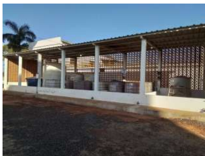
Foto 3 - Estocagem de produtos químicos em área externa, próxima aos reservatórios semienterrados.
