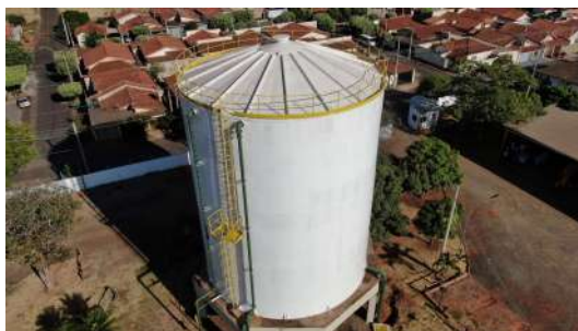
Foto 7 - Vista aérea do reservatório.
