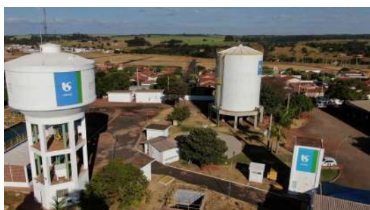
Foto 6 - Vista aérea do reservatório elevado.
