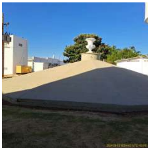
Foto 1 - Vista geral da cobertura do reservatório.
