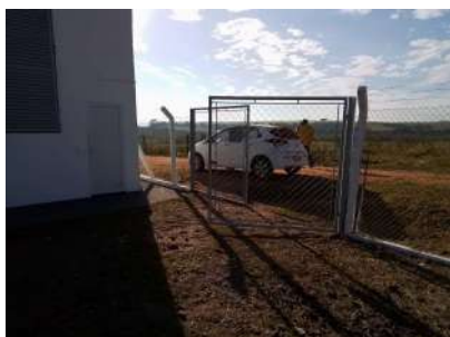
Foto 1 - Detalhe 1 do cercamento.
