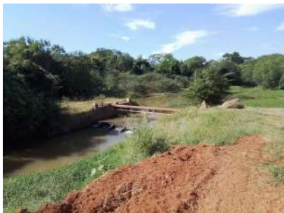
Foto 3 - Vista da reservação junto à captação.
