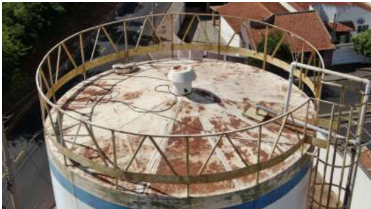
Foto 1 - Detalhe da tubulação de ventilação (chaminé) no topo do reservatório.
