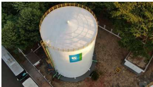
Foto 6 - Vista aérea do reservatório.
