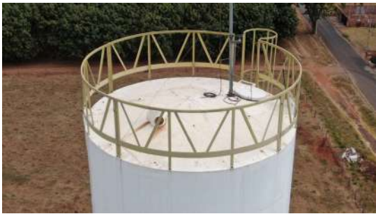
Foto 1 - Ventilação no topo do reservatório.
