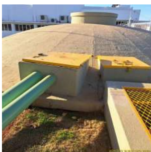
Foto 3 - Situação das tampas de inspeção próximas à chegada de água da ETA.
