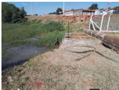
Foto 4 - Tomada de água com gradeamento à esquerda.
