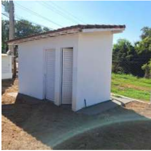
Foto 4 - Vista do abrigo do painel elétrico e de comando do Poço P32.
