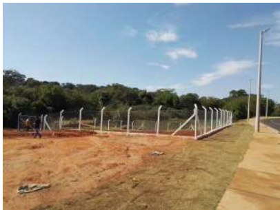
Foto 1 - Vista geral da captação.
