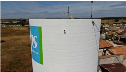
Foto 2 - Detalhe do extravador.
