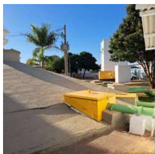
Foto 5 - Vista geral da cobertura do reservatório e caixas de inspeção.
