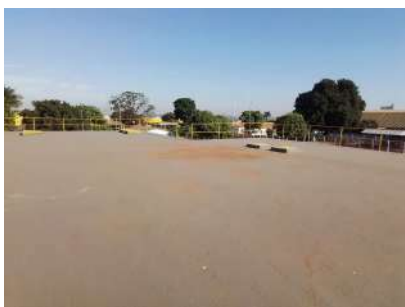
Foto 3 - Topo do reservatório.
