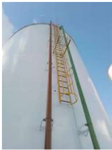
Foto 1 - Escada com guarda-corpo.
