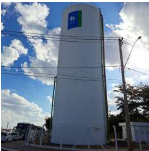
Foto 4 - Reservatório elevado de concreto.
