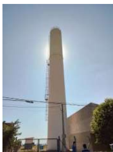
Foto 1 - Vista geral do reservatório.
