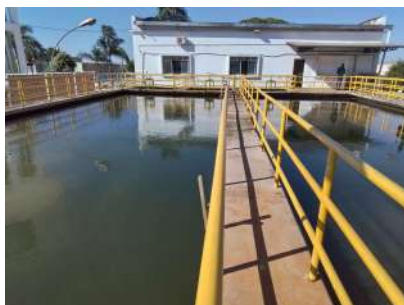
Foto 5 - Vista dos decantadores.
