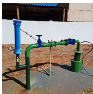
Foto 4 - Vista geral do Poço P68.
