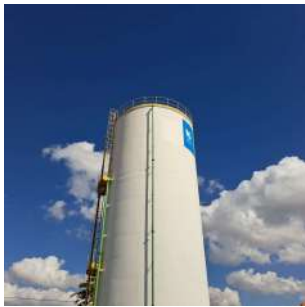
Foto 3 - Haste de captação de descargas elétricas.
