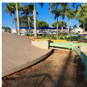
Foto 5 - Vista da cobertura do reservatório e das tubulações de abastecimento.
