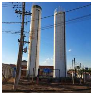
Foto 2 - Vista geral dos reservatórios elevados.
