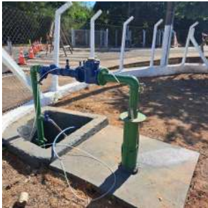
Foto 2 - Vista geral da área do Poço P32.
