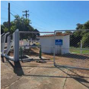
Foto 1 - Vista geral da área do Poço P32.
