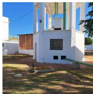
Foto 5 - Vista geral do reservatório elevado e da EEAT em sua base.
