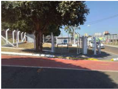
Foto 1 - Vista geral do Poço P2.
