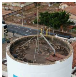
Foto 2 - Detalhe do topo do reservatório.
