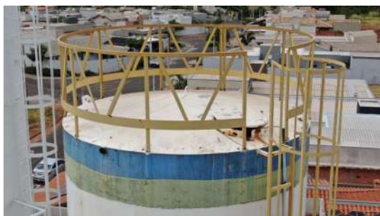
Foto 1 - Situação da base da tampa de inspeção.
