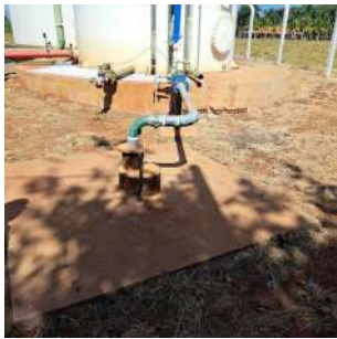
Foto 1 - Vista geral do Poço P-81.
