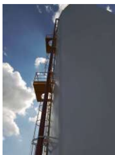
Foto 1 - Detalhe do guarda-corpo.
