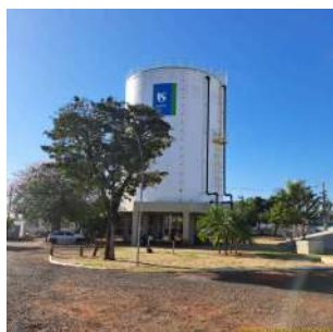
Foto 1 - Vista geral do reservatório.
