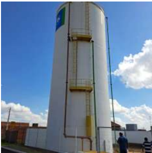
Foto 3 - Vista do reservatório elevado.
