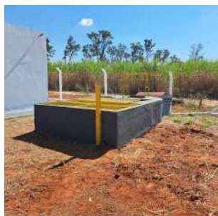
Foto 3 - Poços de chegada do esgoto e das bombas de recalque.
