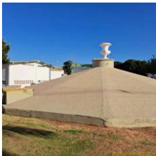
Foto 3 - Vista geral da cobertura do reservatório.
