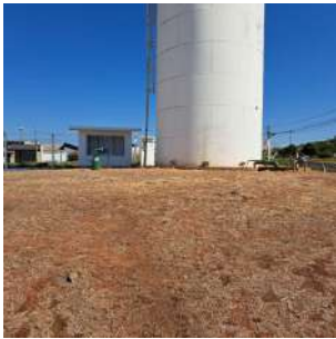
Foto 2 - Vista do reservatório elevado e do Poço P54.
