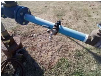
Foto 1 - Registro para coleta de água bruta - fechado.
