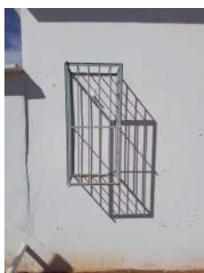
Foto 1 - Detalhe do local previsto para o extintor de incêndio.
