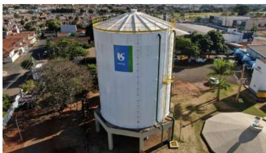
Foto 6 - Vista aérea do reservatório.
