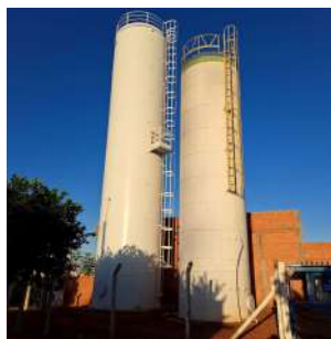
Foto 2 - Vista dos dois reservatórios elevados Alto Cote Gil, sendo o da esquerda (menor altura) o que está em operação.
