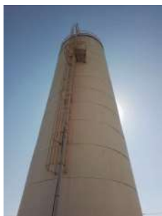
Foto 1 - Detalhe do guarda-corpos do reservatório.
