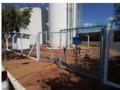
Foto 1 - Cercamento do local
