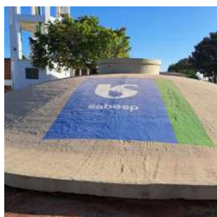
Foto 3 - Vista da cobertura do reservatório.
