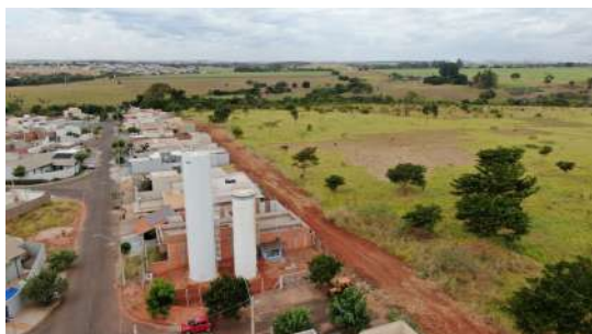
Foto 3 - Vista aérea dos dois reservatórios elevados, sendo o de 100m³ (menor altura) o objeto desta ficha.
