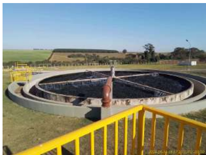
Foto 16 - Vista geral do filtro 2.
