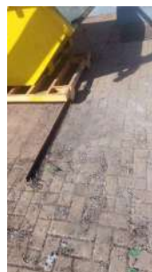
Foto 4 - Chão da EEEF próximo à caçamba e após limpeza - imagem cedida pelo Prestador.
