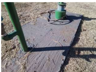
Foto 1 - Detalhe da laje de proteção.
