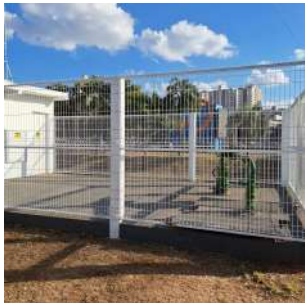
Foto 2 - Vista externa da área do Poço.
