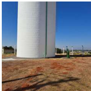
Foto 1 - Vista geral do reservatório Tropical e do Poço P68.
