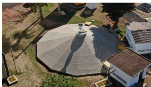
Foto 8 - Vista aérea do reservatório.
