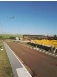
Foto 2 - Vista geral 2 da ETE.
