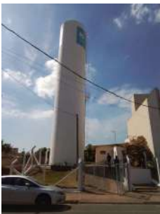
Foto 2 - Vista geral do reservatório.
