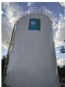
Foto 1 - Vista do reservatório.
