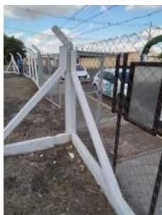
Foto 1 - Cercamento do local.
