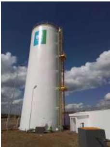
Foto 2 - Vista geral do reservatório.
