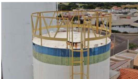
Foto 2 - Situação da base da tampa de inspeção.
