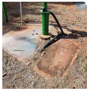
Foto 2 - Situação da laje de proteção do Poço.
