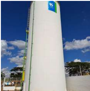
Foto 4 - Vista do reservatório elevado.
