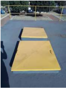
Foto 1 - Detalhe das tampas de inspeção.
