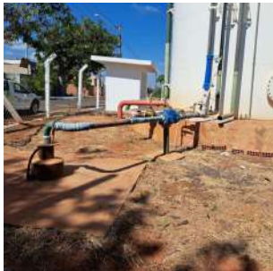
Foto 3 - Vista geral do Poço P-81.
