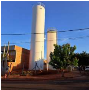
Foto 2 - Vista geral dos dois reservatório elevados Alto Cote Gil, sendo o da esquerda (frente) o objeto desta ficha.
