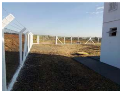
Foto 2 - Detalhe 2 do cercamento.
