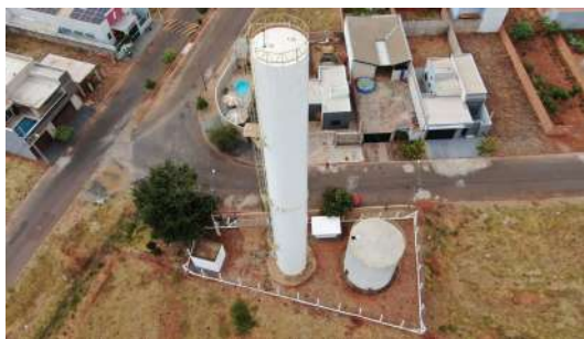
Foto 4 - Vista aérea do reservatório.
