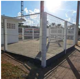
Foto 1 - Vista externa da área do Poço.
