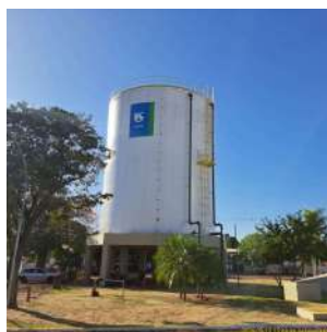
Foto 2 - Vista geral do reservatório.
