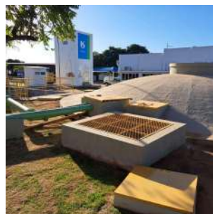
Foto 2 - Vista da cobertura do reservatório e das tubulações de abastecimento.
