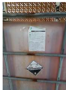
Foto 5 - Tanque de ácido fluossilícico.
