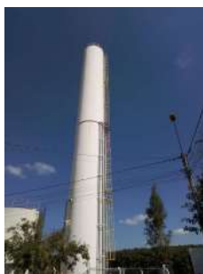
Foto 1 - Vista geral do reservatório.
