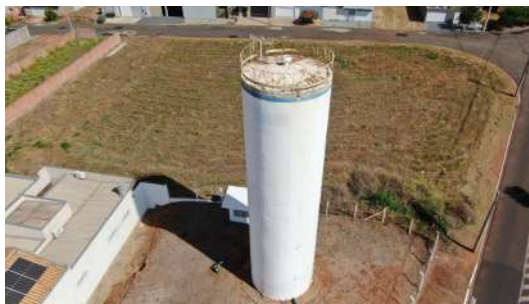
Foto 4 - Vista aérea do reservatório.
