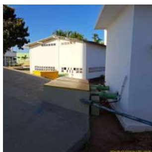
Foto 7 - Vista de parte da cobertura do reservatório e tubulações de sucção da EEAT Jd. Toledo.
