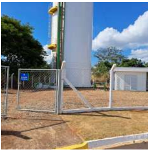
Foto 1 - Vista geral da área: Poço P-82 e, ao fundo, Reservatório Vida Nova Olímpia.
