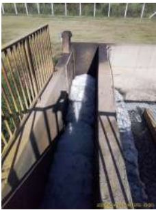
Foto 23 - Chegada do efluente para desinfecção.
