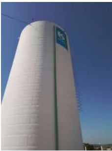
Foto 1 - Extravador próximo ao logo da SABESP.
