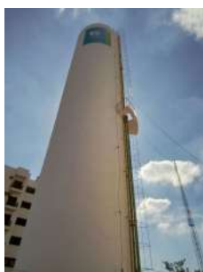
Foto 1 - Condutor de descida.
