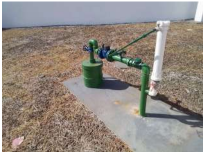
Foto 1 - Vista geral do Poço P90.
