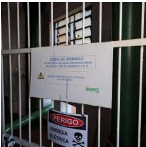
Foto 1 - Placa de identificação da área. Recomenda-se, contudo, que seja realizada com o padrão de identificação do prestador atual.
