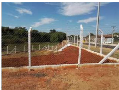
Foto 1 - Cercamento do local.
