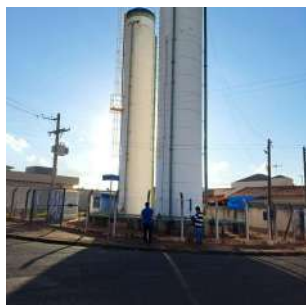
Foto 1 - Vista geral dos reservatórios elevados.
