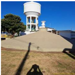
Foto 2 - Vista geral do reservatório semienterrado e do elevado de concreto (ao fundo).
