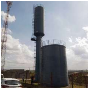
Foto 1 - Vista dos reservatórios apoiado e elevado Paranoá
