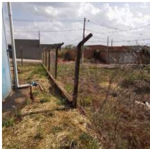
Foto 3 - Aberturas na cerca.
