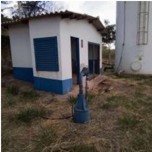
Foto 3 - Abrigo de produtos químicos, poço e reservatório.
