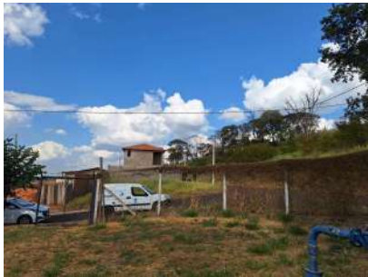
Foto 1 - Cercamento da área - Reservatório Campanário
