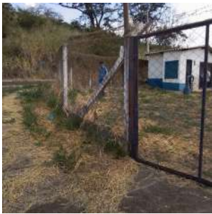
Foto 2 - Portão e cercamento.
