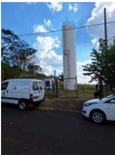
Foto 1 - Visão geral - Reservatório Campanário
