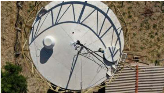
Foto 1 - Chaminés de ventilação na cobertura do reservatório.
