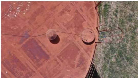
Foto 1 - Chaminé de ventilação na cobertura do reservatório.
