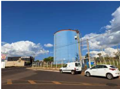
Foto 1 - Visão Geral - Reservatório Santa Clara.
