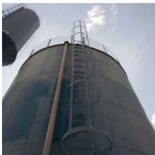
Foto 1 - Escada do reservatório apoiado.
