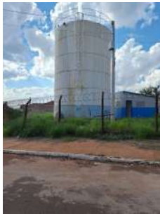
Foto 1 - Visão geral - Reservatório Parque das Amoreiras
