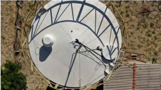
Foto 1 - Tampa de inspeção em boas condições.
