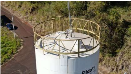
Foto 3 - Guarda-corpo na cobertura do reservatório.
