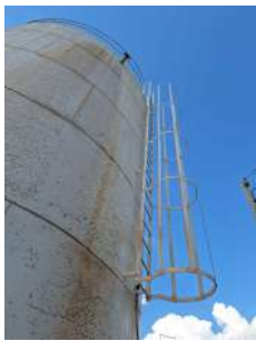
Foto 1 - Escada com guarda-corpos
