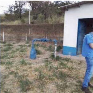
Foto 4 - Vista do poço.
