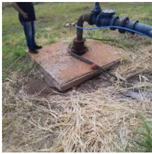
Foto 1 - Laje de concreto.
