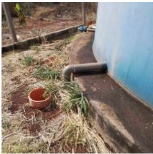
Foto 2 - Tubulação de saída do reservatório apoiado.
