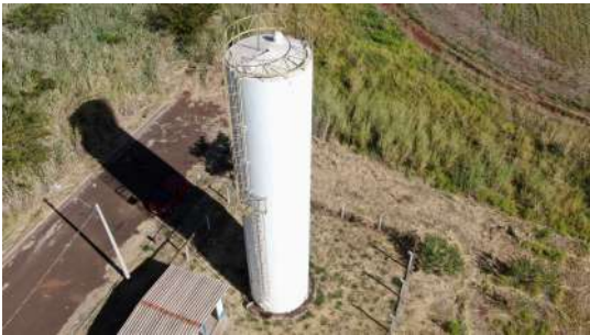
Foto 2 - Vista aérea da escada do reservatório.
