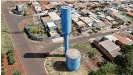
Foto 3 - Foto aérea dos reservatórios Paranoá obtida com auxílio de drone.
