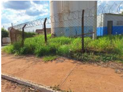
Foto 1 - Cercamento com alambrado - Reservatório Parque das Amoreiras
