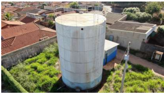
Foto 2 - Escada com guarda-corpos
