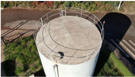
Foto 3 - Guarda-corpo na cobertura.
