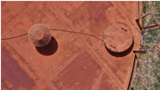
Foto 1 - Tampa de inspeção em boas condições.
