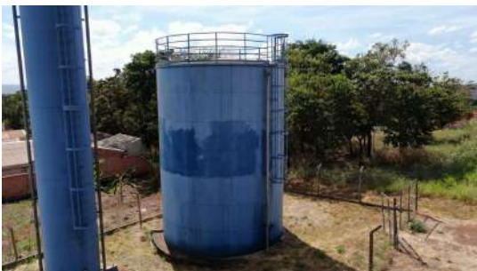
Foto 2 - Escada e guarda-corpo do reservatório apoiado.
