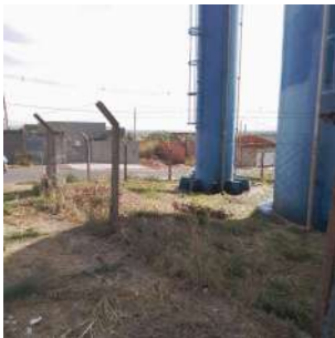
Foto 2 - Cercamento da área.
