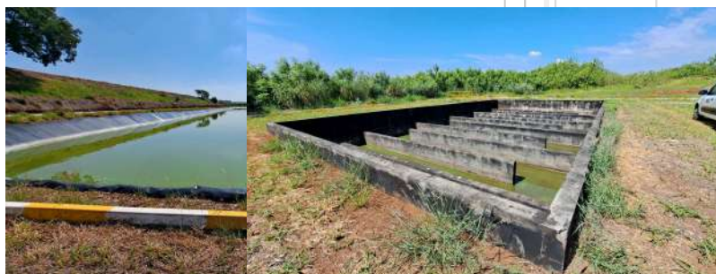
Foto 8 - Vista de parte de uma das lagoas da ETE.
