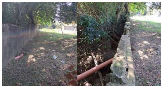
Foto 1 - Tubulação de esgoto próxima ao
