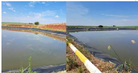
Foto 5 - Vista de parte de uma das lagoas de chegada do esgoto (anaeróbias).
