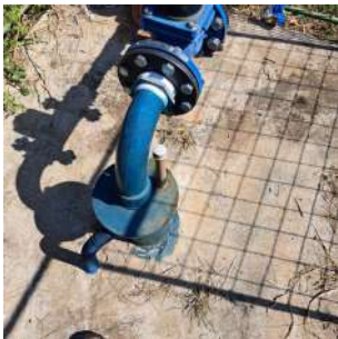
Foto 1 - Tubo para medição de nível.
