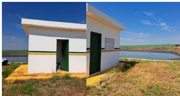
Foto 3 - Abrigo operacional da ETE.
