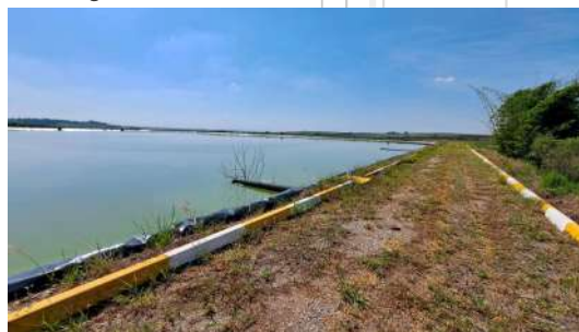
Foto 7 - Vista de parte de uma das lagoas da ETE.
