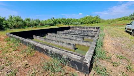
Foto 9 - Sistema de chicanas para desinfecção do efluente tratado.
