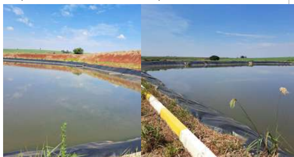
Foto 5 - Vista de parte de uma das lagoas de chegada do esgoto (anaeróbias).
