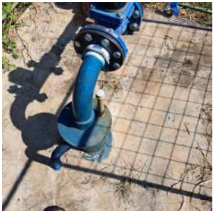
Foto 1 - Tubo para medição de nível.
