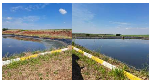
Foto 1 - Vista de parte de uma das lagoas de chegada do esgoto (anaeróbias).
