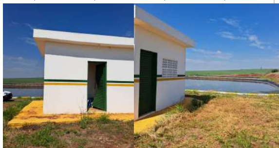
Foto 3 - Abrigo operacional da ETE.
