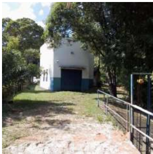
Foto 5 - Vista da casa de bombas a partir da tomada d'água.
