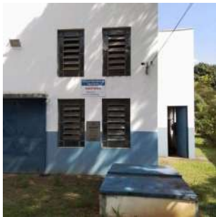
Foto 1 - Entrada da casa de bombas.
