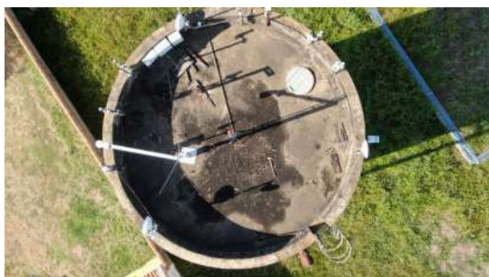
Foto 1 - Tampa de inspeção na cobertura do reservatório.
