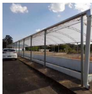
Foto 2 - Estufas para secagem de lodo.
