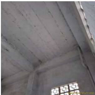
Foto 2 - Laje do reservatório.
