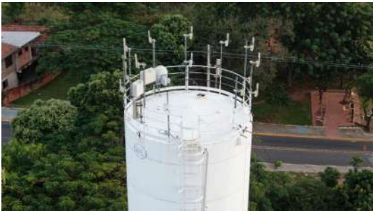
Foto 1 - Escada e guarda-corpo.
