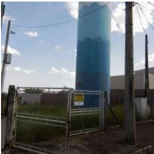
Foto 1 - Vista do reservatório.
