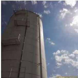
Foto 3 - Descida do extravasor
