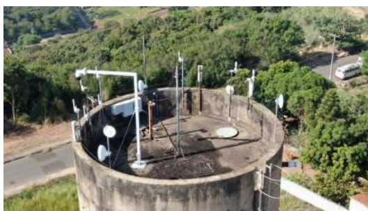
Foto 4 - Para raio do reservatório.
