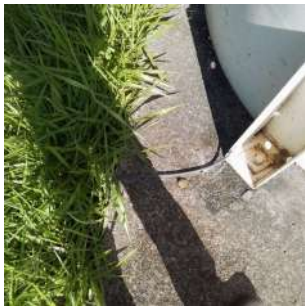
Foto 1 - Aterramento do reservatório.
