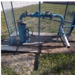
Foto 1 - Laje de concreto.
