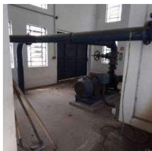
Foto 1 - Espaço e acesso adequado para manutenção.
