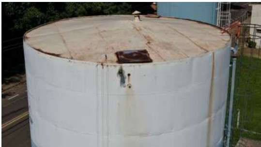
Foto 1 - Cobertura do reservatório inferior.
