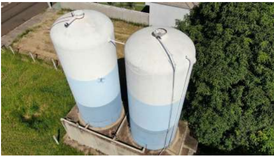
Foto 1 - Tubo extravasor do reservatório à direita.
