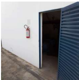
Foto 4 - Entrada da elevatória.
