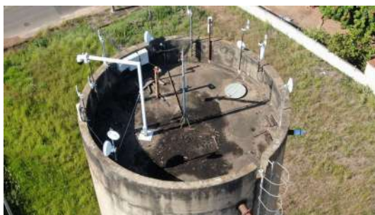
Foto 2 - Tampa de inspeção do reservatório em boas condições.
