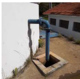
Foto 1 - Extravasador do reservatório.
