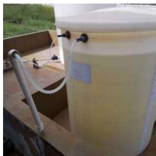
Foto 3 - Armazenamento de produto para desinfecção (cloração).
