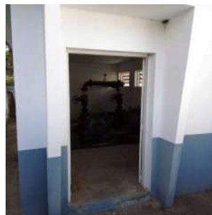
Foto 5 - Elevatória que encaminha água tratada pela ETA II para o centro de reservação Alpes das Águas.
