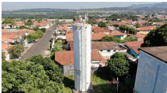
Foto 1 - Escada com guarda-corpo e plataforma de descanso.
