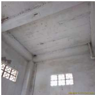
Foto 3 - Laje de apoio do reservatório.
