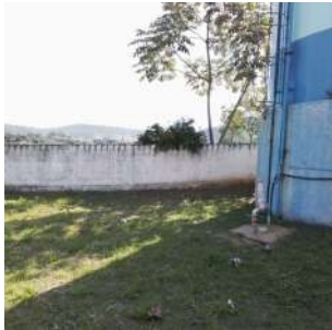
Foto 1 - Muro no perímetro do terreno.
