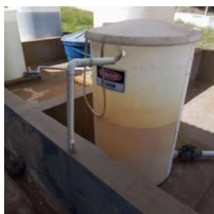
Foto 1 - Tanque para dosagem de flúor (ácido fluossilícico).
