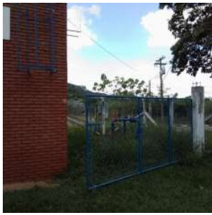
Foto 1 - Captação subterrânea ao lado do reservatório Santana I
