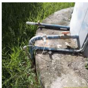
Foto 5 - Ponto de aplicação de flúor.
