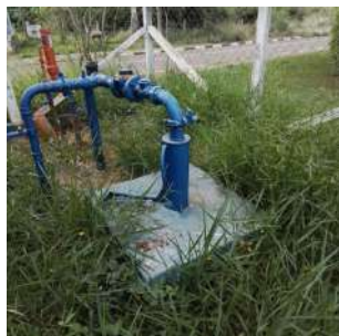
Foto 1 - Laje de proteção.
