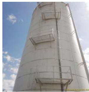
Foto 2 - Escada, guarda-corpo e plataformas de descanso.
