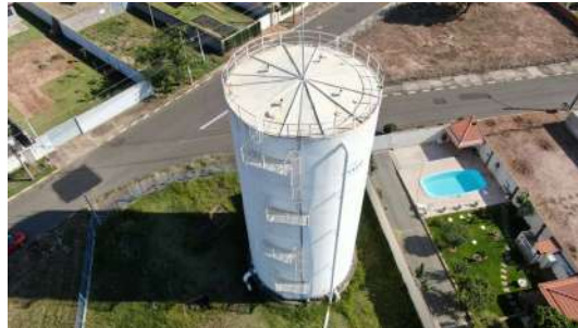
Foto 4 - Descida do tubo extravasor vista em imagem aérea, obtida por drone.
