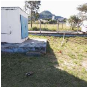
Foto 2 - Cercamento da área.
