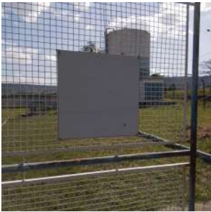
Foto 1 - Placa desgastada, devendo ser substituída ou atualizada.
