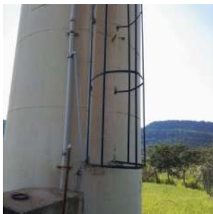
Foto 1 - Escada com guarda-corpo.
