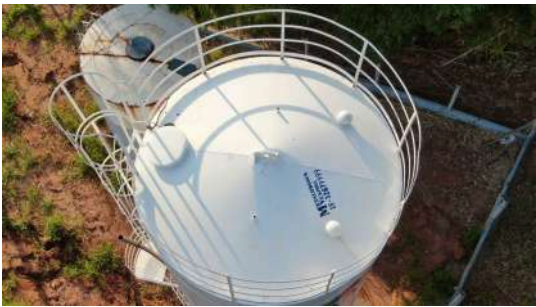
Foto 2 - Guarda-corpo na cobertura.
