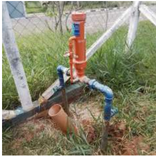
Foto 2 - Sistema de cloração com pastilhas de tricloro.
