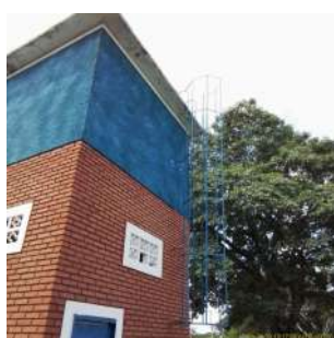
Foto 1 - Escada de acesso para manutenção.
