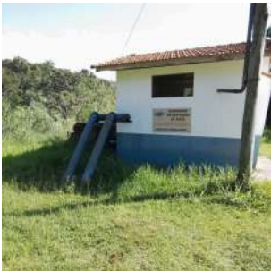
Foto 1 - Vista da casa de bombas.
