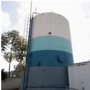
Foto 1 - Vista do reservatório.
