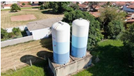
Foto 1 - Vista do reservatório obtida com auxílio de drone.
