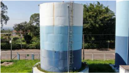
Foto 1 - Escada do reservatório inferior.
