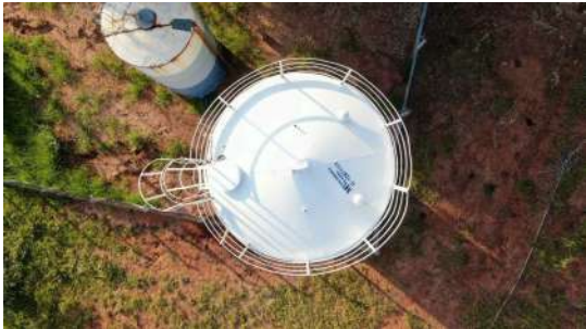
Foto 1 - Tampa em boas condições.
