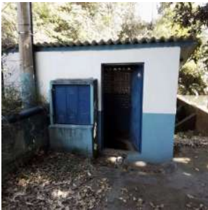
Foto 1 - Casa de bombas.
