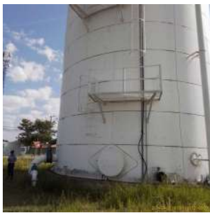
Foto 1 - Escada de acesso para manutenção com guarda-corpo e plataformas de descanso.
