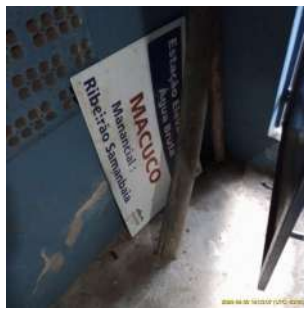
Foto 1 - Placa sem a devida instalação.
