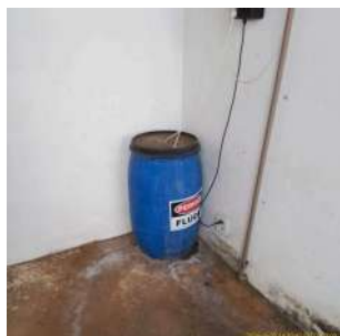
Foto 3 - Bombona para armazenamento de flúor.
