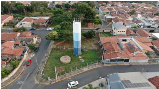
Foto 1 - Foto aérea do Reservatório Horto Florestal, obtida com auxílio de drone.
