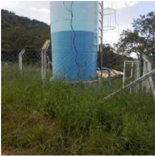
Foto 1 - Mato alto na área do reservatório, dificultando o acesso.
