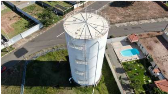
Foto 3 - Escada vista a partir de imagem capturada por drone. Guarda-corpo na cobertura do reservatório.
