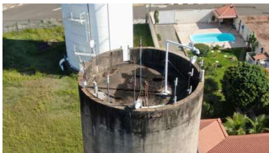
Foto 3 - Foto aérea do reservatório.
