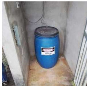
Foto 3 - Bombona para armazenamento de flúor.
