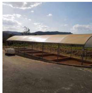
Foto 3 - Estufas para secagem de lodo, após tratamento.
