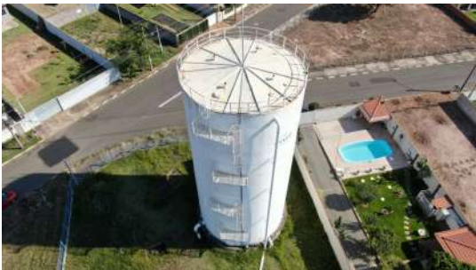
Foto 3 - Imagem aérea do reservatório obtida com drone.
