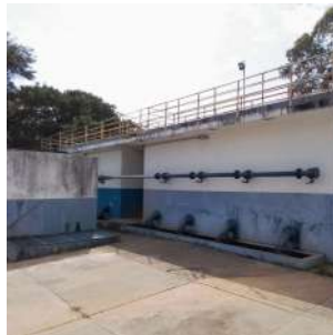
Foto 8 - Vista de ETA II.
