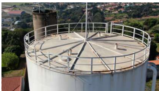
Foto 1 - Cobertura do reservatório metálico.
