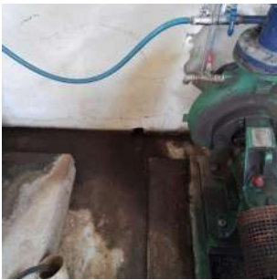
Foto 1 - Abertura para drenagem de água de lubrificação.
