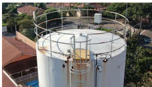
Foto 2 - Extravasores ao lado da escada.
