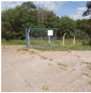
Foto 1 - Portão de acesso à ETA II.
