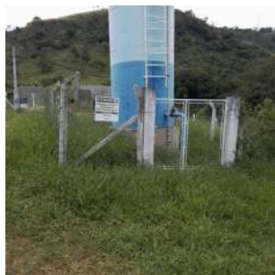
Foto 1 - Cercamento da área.
