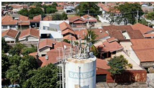
Foto 2 - Guarda-corpo na cobertura do reservatório.
