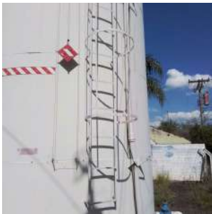
Foto 2 - Escada com guarda-corpo.
