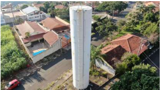
Foto 4 - Vista da escada em imagem obtida com drone.
