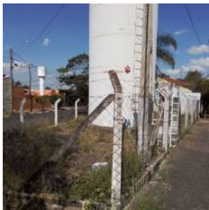
Foto 1 - Cercamento da área.
