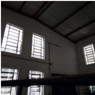
Foto 2 - Casa de bombas.
