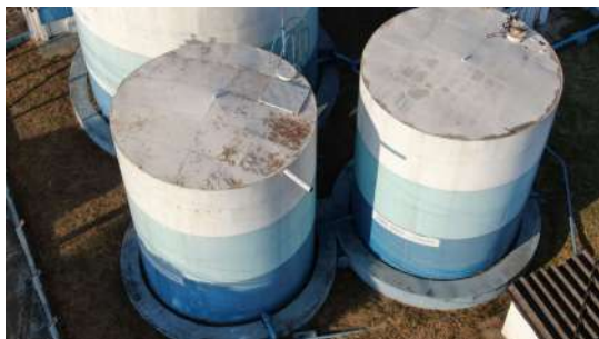
Foto 1 - Tubo extravasor em um dos reservatórios.
