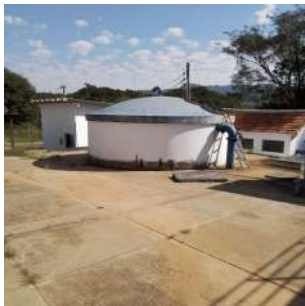
Foto 1 - Vista do reservatório, situado dentro da área da ETA II.
