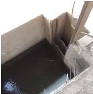
Foto 2 - Tomada de água da captação.
