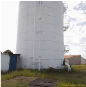
Foto 1 - Reservatório Jardim das Colinas 1 - metálico
