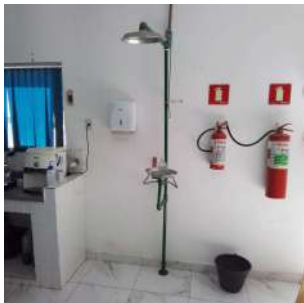
Foto 1 - Chuveiro de emergência também no laboratório.
