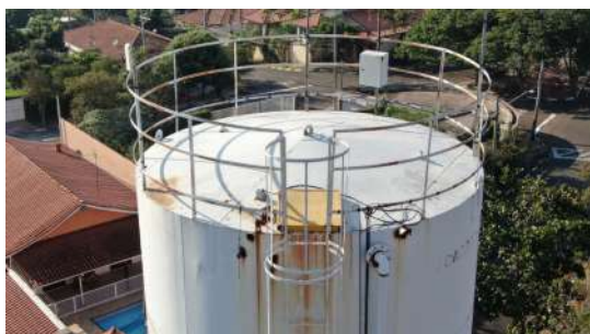
Foto 1 - Tampa de inspeção em boas condições.
