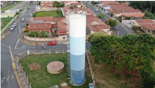
Foto 2 - Escada de acesso para manutenção.
