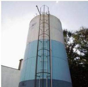
Foto 1 - Escada de acesso para manutenção.
