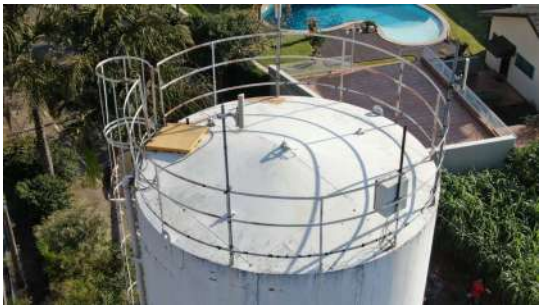
Foto 3 - Guarda-corpo na cobertura do reservatório.
