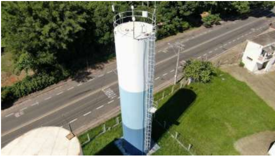
Foto 3 - Escada do reservatório superior.
