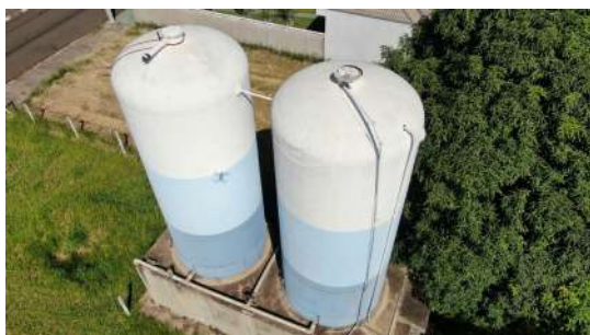
Foto 1 - Tampas de inspeção dos reservatórios
