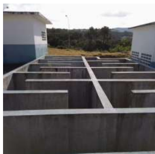
Foto 4 - Chicanas antes do lançamento do efluente final (ainda inoperantes)
