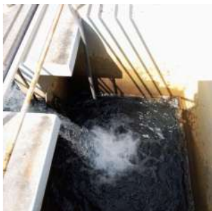
Foto 5 - Vertedor de água tratada.
