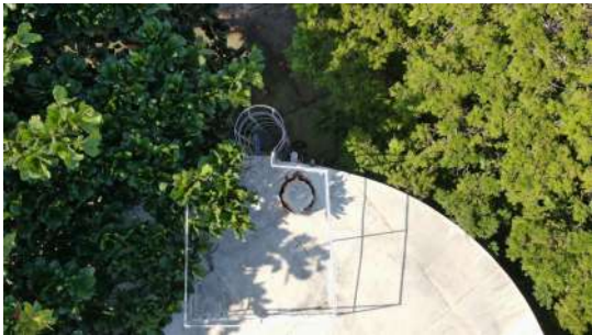
Foto 1 - Guarda-corpo na cobertura do reservatório.
