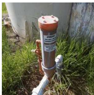
Foto 1 - Cloração por pastilhas (tricloro)
