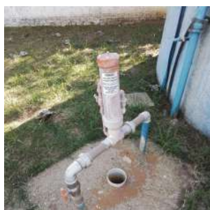
Foto 1 - Cloração por pastilhas (tricloro)
