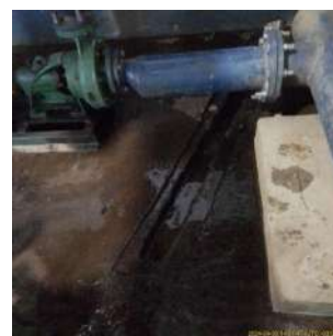
Foto 2 - Canaleta para escoamento da água de lubrificação.
