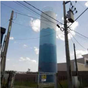
Foto 2 - Vista do reservatório.
