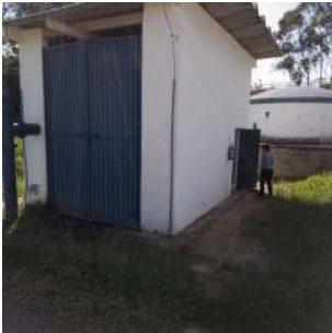
Foto 1 - EEAT que encaminha água tratada pela ETA II para o centro de reservação Jardim da Colina.
