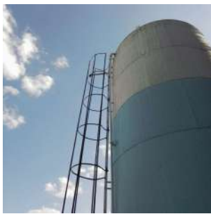
Foto 3 - Vista do reservatório Jardim Itália.
