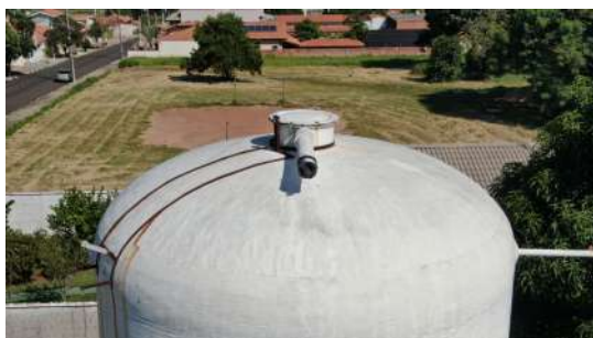
Foto 1 - Tubulação com tela de proteção.
