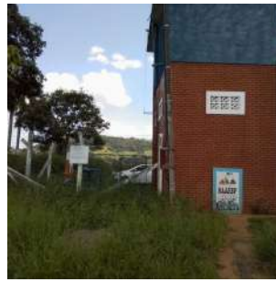
Foto 2 - Vista do poço e reservatório
