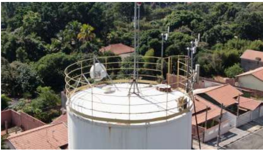
Foto 1 - Cobertura do reservatório, contendo chaminé de ventilação.
