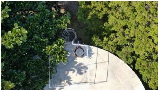
Foto 1 - Tampa em boas condições.
