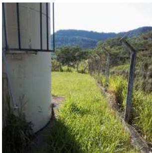
Foto 1 - Cercamento da área.
