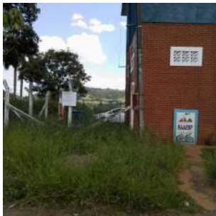
Foto 1 - Cercamento ao redor do poço.
