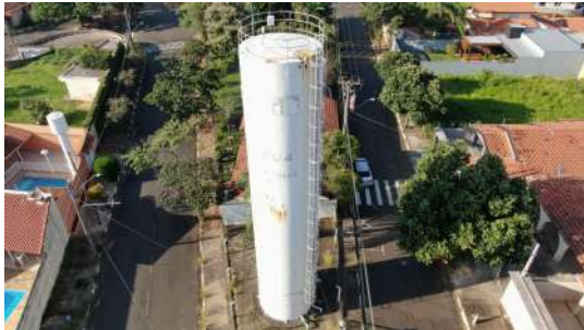
Foto 4 - Imagem aérea do reservatório obtida com drone.
