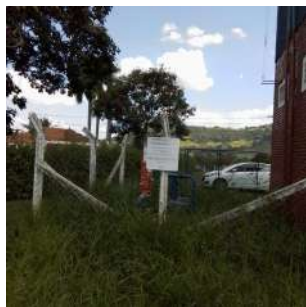
Foto 1 - Placa de identificação do poço e reservatório.
