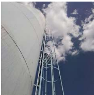
Foto 2 - Escada com guarda-corpo.
