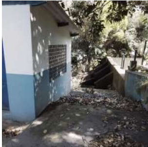
Foto 7 - Casa de bombas e barragem.
