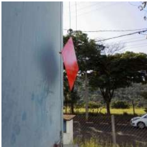
Foto 2 - Contrapeso para medição do nível.
