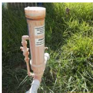
Foto 1 - Cloração com pastilhas (triclóro)
