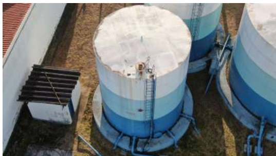
Foto 2 - Escadas com guarda-corpo nos reservatórios.
