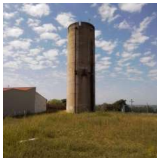
Foto 1 - Vista do reservatório.
