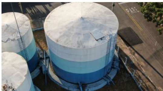
Foto 1 - Tampa de inspeção em boas condições.
