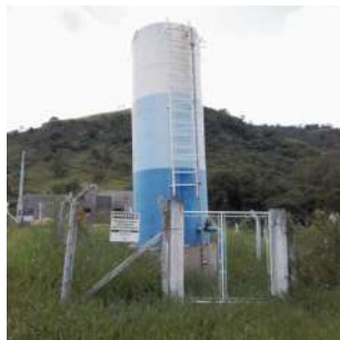
Foto 1 - Vista do reservatório Santana 2.
