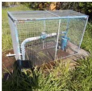
Foto 1 - Laje de concreto.
