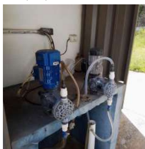
Foto 6 - Dosagem de PAC.
