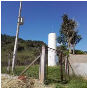
Foto 1 - Vista do reservatório.
