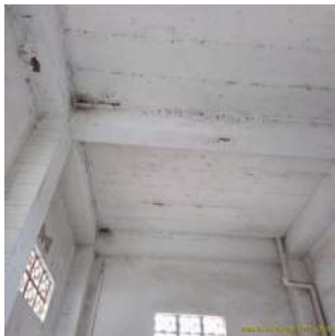
Foto 1 - Laje de apoio do reservatório.
