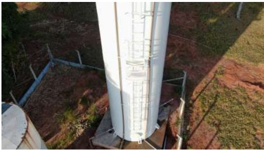
Foto 1 - Escada com guarda-corpo.
