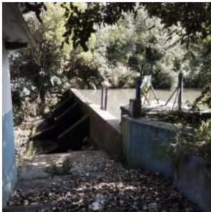
Foto 2 - Barragem da captação
