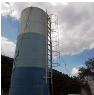
Foto 1 - Escada para manutenção.
