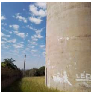
Foto 1 - Descida do SPDA para aterramento.
