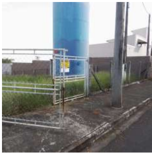
Foto 1 - Cercamento e portão.
