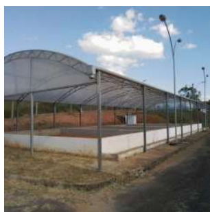
Foto 1 - Estufas para secagem de lodo, após tratamento.
