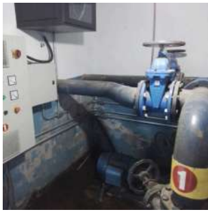
Foto 5 - Tubulação de recalque.
