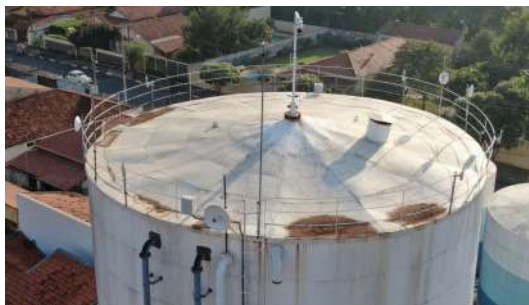
Foto 2 - Tubo extravasor no reservatório maior.
