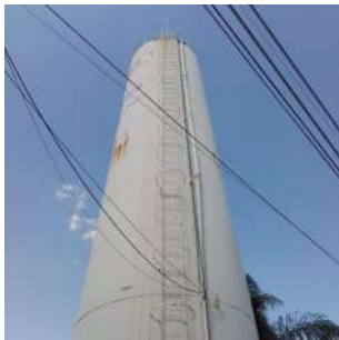
Foto 1 - Escada de acesso para manutenção.
