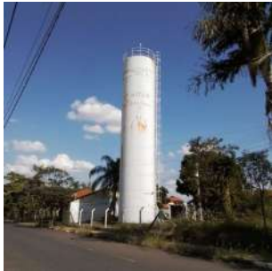
Foto 1 - Vista do reservatório
