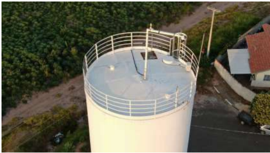
Foto 1 - Guarda-corpo na cobertura do reservatório.
