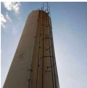
Foto 2 - Escada de acesso para manutenção.
