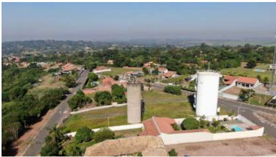
Foto 4 - Reservatórios Jardim das Cachoeiras, vistos a partir de imagem aérea.
