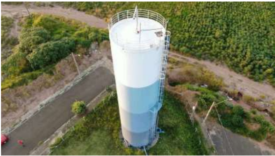
Foto 2 - Escada de acesso para manutenção, com guarda-corpo de plataforma de descanso.
