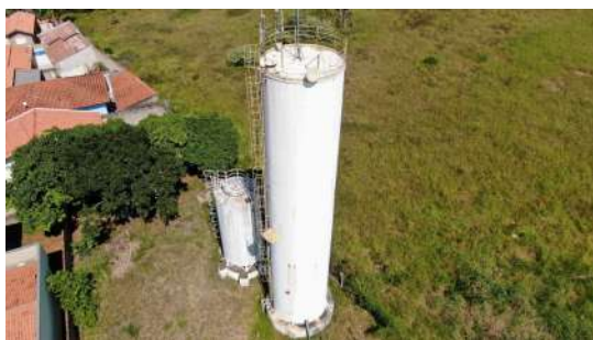
Foto 1 - Escada e guarda-corpo.
