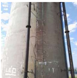
Foto 1 - Escada de acesso para manutenção.
