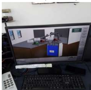
Foto 11 - Monitoramento do poço de sucção e controle das bombas a partir do Centro de Controle e Operação do SAAESP (CCO)
