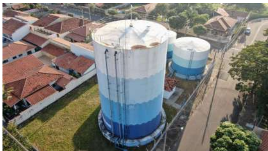
Foto 1 - Escada de acesso para manutenção e guarda-corpo no reservatório superior.
