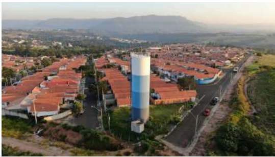
Foto 1 - Reservatório em imagem obtida com auxílio de drone.
