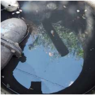
Foto 3 - Poço de sucção
