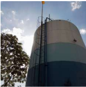
Foto 1 - Escada de acesso para manutenção.
