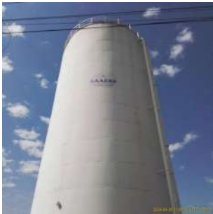
Foto 2 - Vista do reservatório.
