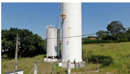
Foto 1 - Cercamento da área.
