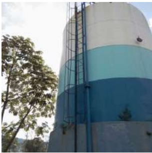
Foto 2 - Escada e guarda-corpo.
