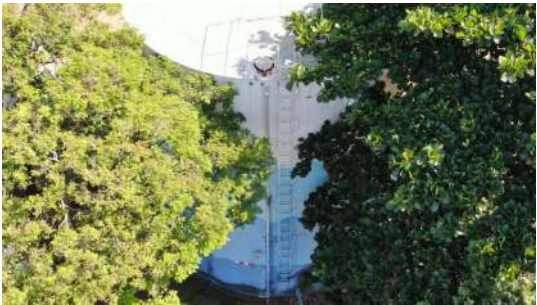
Foto 2 - Escada de acesso para manutenção.
