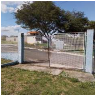
Foto 2 - Portão de acesso à área do poço e reservatório.
