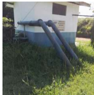
Foto 10 - Tubulação de recalque.
