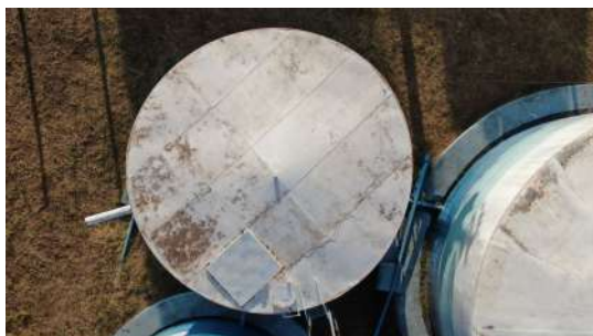
Foto 2 - Tampa de inspeção.
