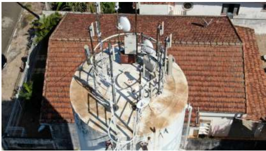
Foto 1 - Tampa de inspeção em boas condições.
