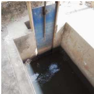
Foto 3 - Tomada de água.
