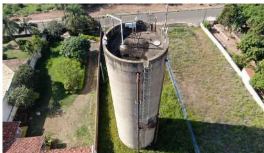
Foto 4 - Tubulação de alimentação do reservatório.
