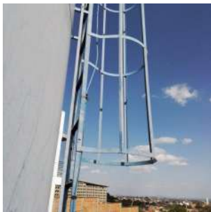
Foto 1 - Escada de acesso para manutenção.
