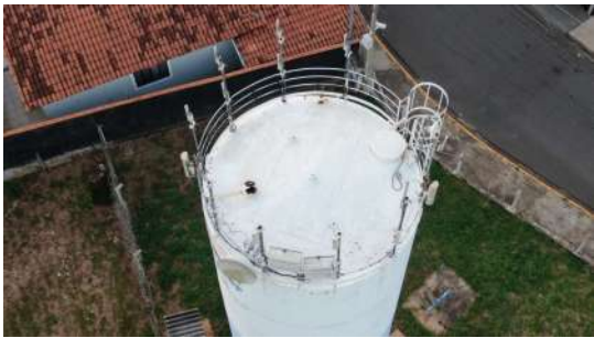
Foto 1 - Tampa em boas condições.
