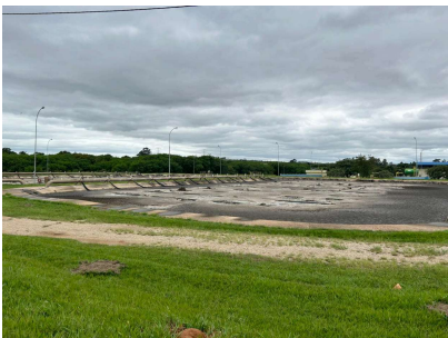
Foto 6 - Tanques de aeração
