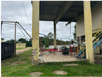
Foto 5 - Desidratação de lodo
