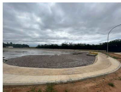
Foto 6 - Tanque de aeração
