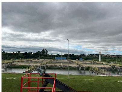
Foto 9 - Vista dos tanques de aeração
