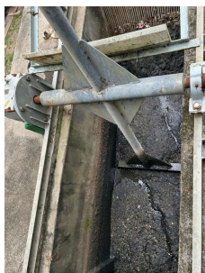
Foto 1 - Gradeamento sem limpeza
