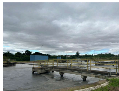
Foto 12 - Tanque de aeração em operação
