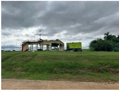
Foto 2 - Vista do canal de entrada
