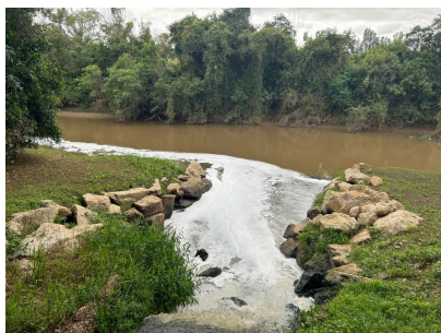
Foto 15 - Lançamento final de esgoto tratado
