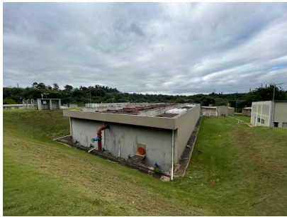
Foto 1 - Vista geral da ETE
