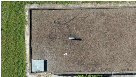
Foto 1 - Tampa reservatório apoiado
