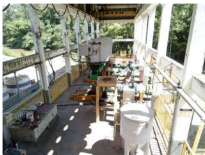
Foto 7 - Vista geral interna da casa de bombas
