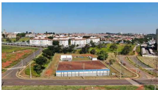
Foto 1 - Área da elevatória e do reservatório
