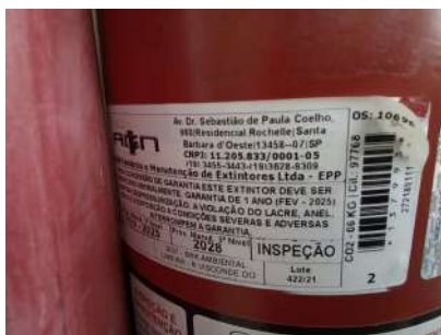
Foto 1 - Extintor de incêndio, dentro do prazo de validade
