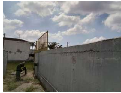
Foto 2 - Vista lateral do reservatório
