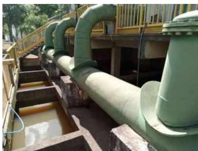
Foto 5 - Poço de sucção
