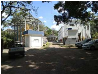
Foto 2 - Estruturas na área de entrada da Captação
