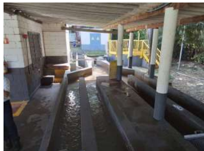
Foto 7 - Vista geral da elevatória
