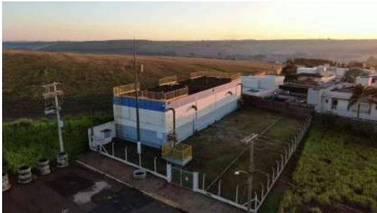
Foto 1 - Área do reservatório
