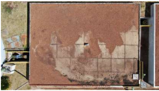
Foto 1 - Vista superior com tampa de inspeção
