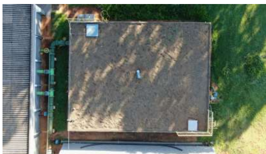
Foto 2 - Reservatório com tampa de inspeção
