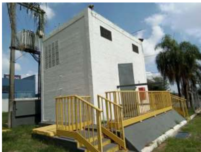
Foto 2 - Abrigo do gerador
