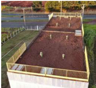
Foto 1 - Guarda-corpo no reservatório
