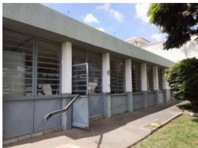
Foto 1 - Vista externa da casa de bombas EEAT Limeirense
