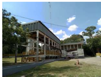
Foto 12 - Vista geral externa da casa de bombas
