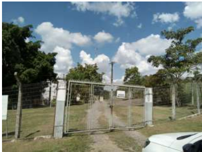
Foto 1 - Vista externa da EEAB São Lucas
