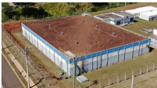
Foto 1 - Reservatórios com guarda-corpo
