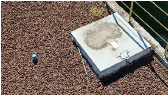
Foto 1 - Tampa de inspeção
