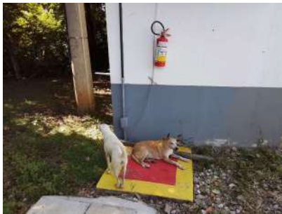
Foto 1 - Extintor de incêndio
