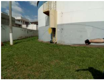
Foto 1 - Escada de acesso, com guarda-corpos
