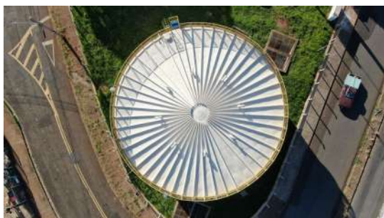
Foto 1 - Reservatório com tampa de inspeção
