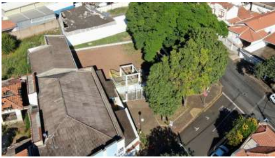
Foto 1 - Área da elevatória e do reservatório
