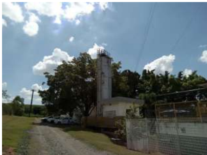
Foto 3 - RHO - Reservatório Hidropneumático
