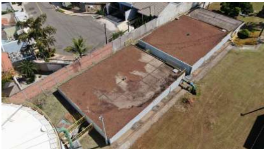
Foto 1 - Vista superior do reservatório com tubulação de ventilação
