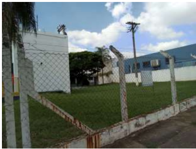
Foto 5 - Cercamento da área
