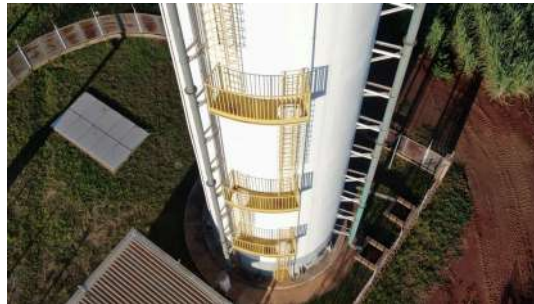
Foto 2 - Escada e guarda-corpo
