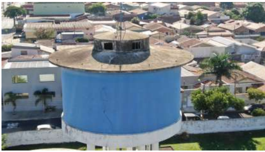
Foto 1 - Cabo de descida rompido
