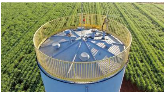
Foto 1 - Tampa de inspeção
