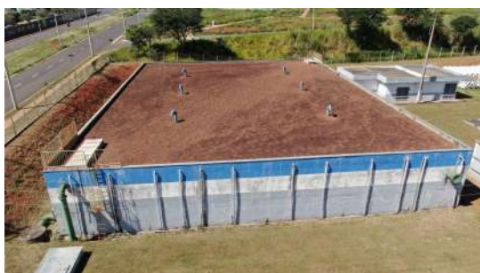
Foto 1 - Reservatório com tampa de inspeção
