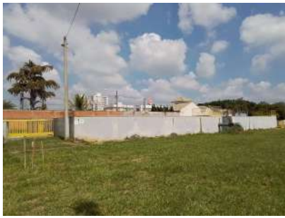
Foto 1 - Reservatório Limeirense semienterrado I
