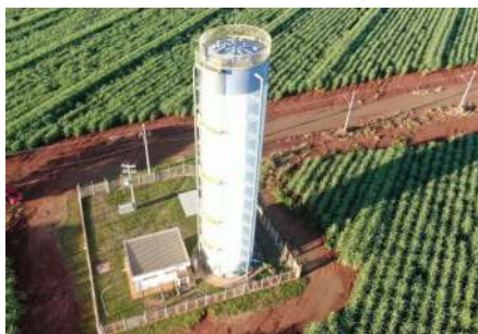
Foto 1 - Área em bom estado de conservação
