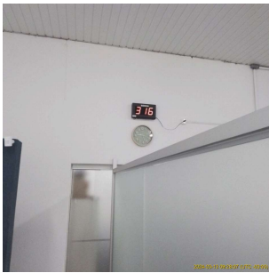
Foto 2 - Pannel de Senhas
