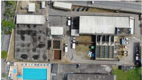
Foto 2 - Vista geral da ETA Leste (à direita) e do Reservatório (à esquerda).
