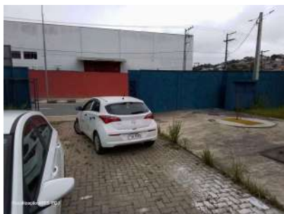
Foto 1 - Acesso à EEE.
