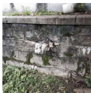
Foto 4 - Fachada próxima à EEA RB 1-I.
