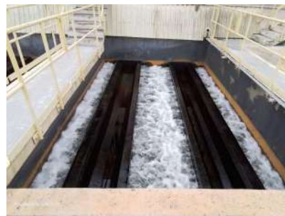
Foto 14 - Aeração da camada filtrante durante o processo de retrolavagem.
