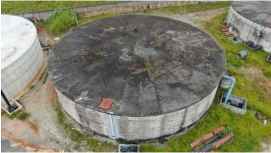
Foto 6 - Presença de tubulação de ventilação no reservatório II.
