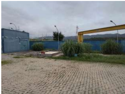
Foto 2 - Vista geral da elevatória.
