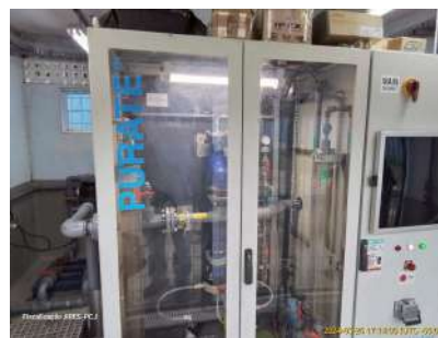
Foto 12 - Sistema produtor de hidróxido de cloro.
