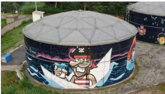
Foto 3 - Detalhe do topo do reservatório.
