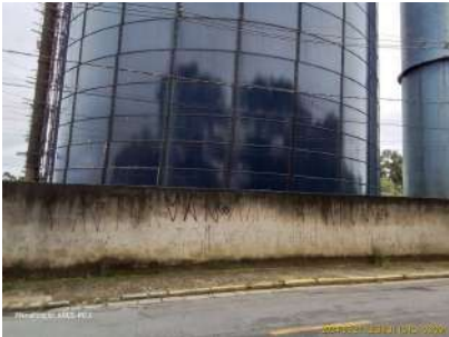
Foto 2 - Vista da parte inferior do reservatório.
