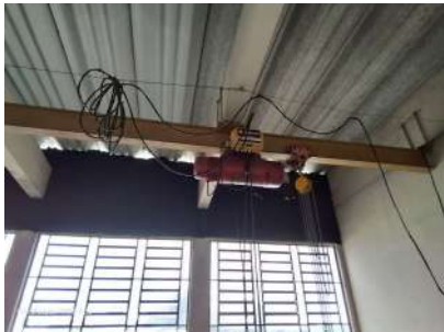
Foto 8 - Detalhe do suporte para içamento.
