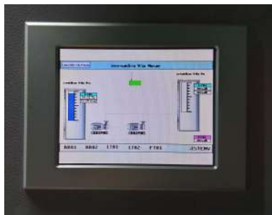
Foto 8 - Detalhe da telemetria evidenciando o volume do reservatório Moraes preenchido com água e o reservatório Pomar vazio (desativado).
