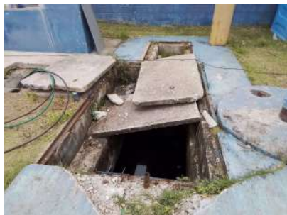
Foto 3 - Chegada do esgoto bruto.
