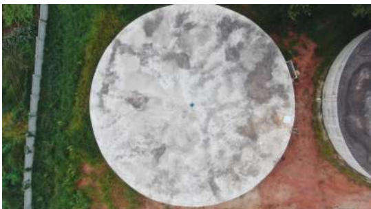
Foto 5 - Topo do reservatório III.
