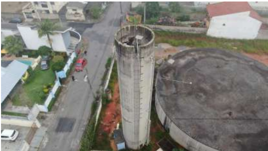
Foto 4 - Vista geral do reservatório I.
