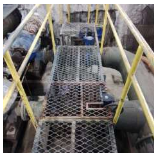
Foto 8 - Acesso às bombas.
