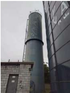
Foto 1 - Vista geral do reservatório Pomar, ao lado do reservatório Moraes.
