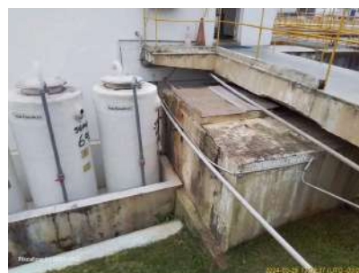
Foto 39 - Tanques de ácido fluossilícico.
