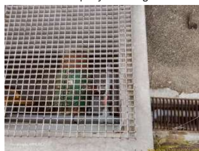
Foto 4 - Drenar a água pluvial acumulada nas duas caixas de inspeção das adutoras.
