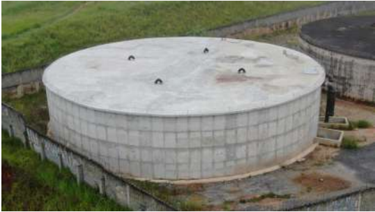
Foto 5 - Presença de tubulação de ventilação no reservatório I.
