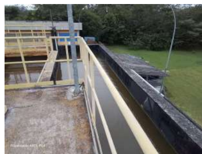
Foto 8 - Canal de interligação dos floculadores e decantadores.
