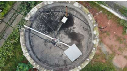
Foto 3 - Topo do reservatório Vila Suissa I.
