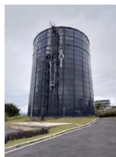
Foto 2 - Vista geral 2 do reservatório Jundiapéba.
