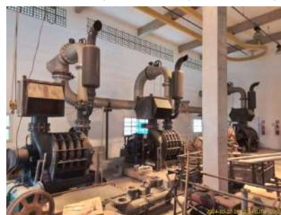
Foto 23 - Casa de Sopradores.
