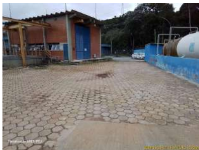
Foto 1 - Via de acesso à captação.
