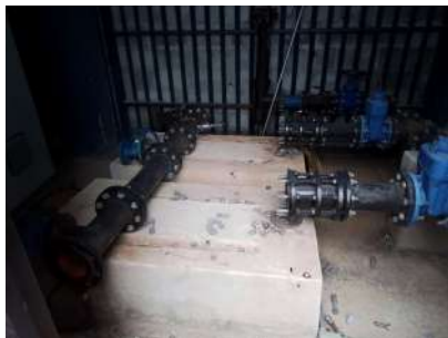
Foto 6 - Local onde ficavam as bombas da elevatória.
