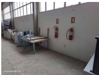
Foto 3 - Extintores na sala de produtos químicos.
