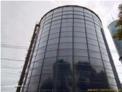
Foto 1 - Vista da parte superior do reservatório.
