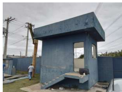
Foto 2 - Detalhe da guarita.
