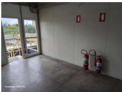
Foto 1 - Extintores na sala de operação.
