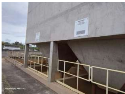
Foto 1 - Abaixo tanque de homogeneização. Acima tanques de adensamento de lodo.
