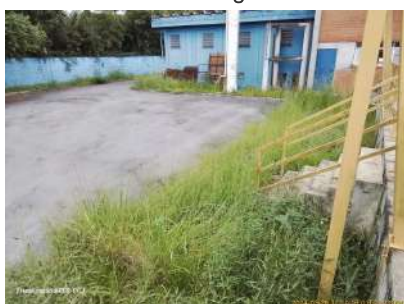
Foto 3 - Roçar o mato no interior da captação.
