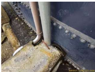
Foto 1 - Aterramento dos tubos de condução de cabamentos.
