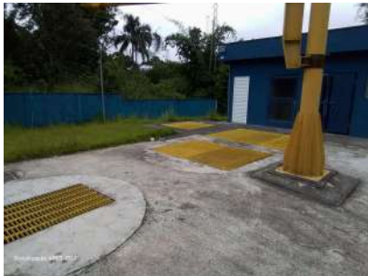
Foto 2 - Vista externa da EEE.
