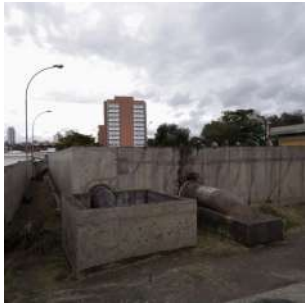
Foto 1 - Vista da fachada próxima ao tanque de lodo.
