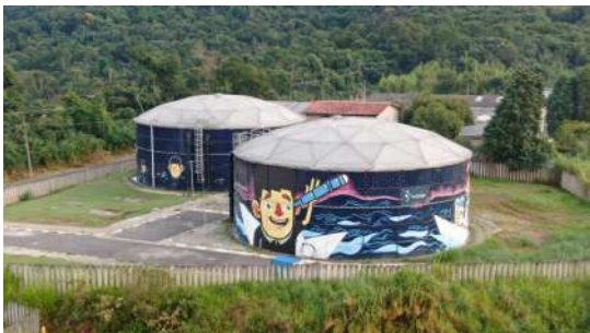
Foto 1 - Vista geral 1 dos reservatórios Oroxó.
