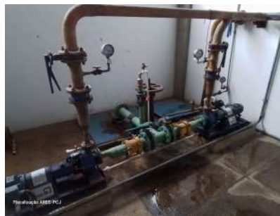
Foto 28 - EEA para o reservatório interno de retrolavagem.
