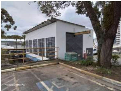
Foto 2 - Fachada da EEA, sem qualquer identificação do local.
