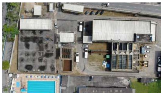
Foto 42 - Vista superior da ETA Leste.
