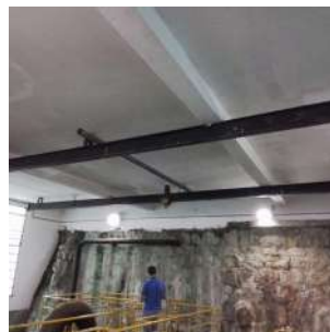
Foto 2 - Detalhe 2 do suporte para içamento.
