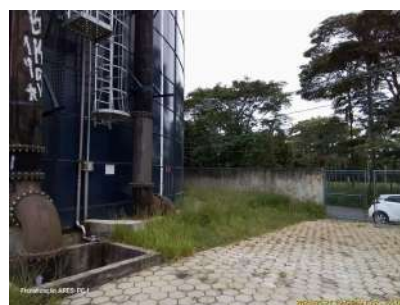
Foto 2 - Portão de acesso ao reservatório.
