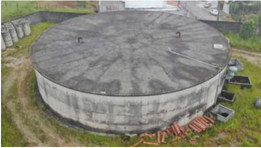
Foto 7 - Presença de tubulação de ventilação no reservatório III.
