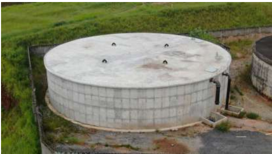
Foto 2 - Vista geral do reservatório I.
