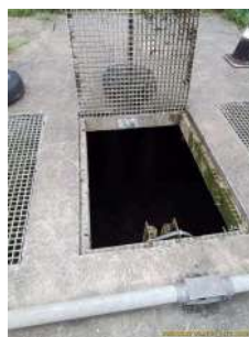
Foto 33 - Saída da recirculação próxima aos decantadores.
