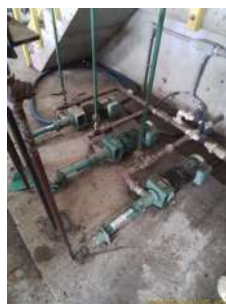
Foto 43 - Bombeamento de polímero para as mesas adensadoras.
