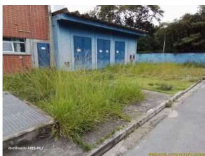
Foto 5 - Roçar o mato no interior da captação.
