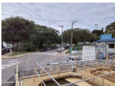
Foto 3 - Caixa de chegada da adutora.
