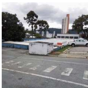
Foto 1 - Vista geral do reservatório semienterrado.
