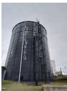
Foto 1 - Vista geral 1 do reservatório Jundiapéba.
