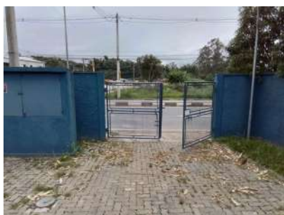
Foto 1 - Detalhe do portão
