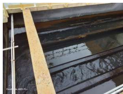
Foto 18 - Fim do processo de retrolavagem do filtro.
