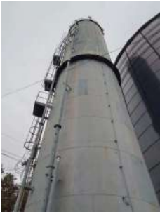
Foto 3 - Detalhe do guarda corpo e extravasor do reservatório Pomar.
