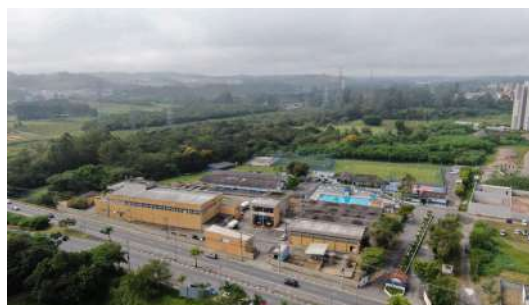
Foto 41 - Vista aérea e afastada da ETA Leste.
