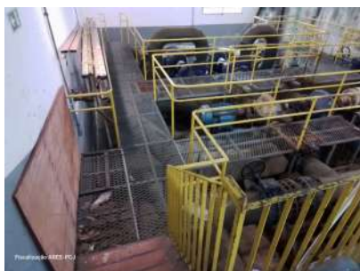
Foto 1 - Passarelas de acesso.
