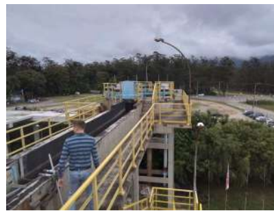
Foto 2 - Vista da chegada, gradeamento ao fundo. No local, há três gradeamentos, sendo que dois atuam continuamente e o terceiro é acionado quando os outros estão em manutenção.
