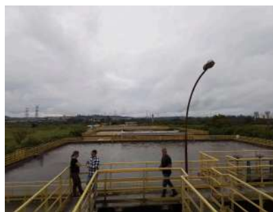
Foto 11 - Vista dos tanques de aeração.
