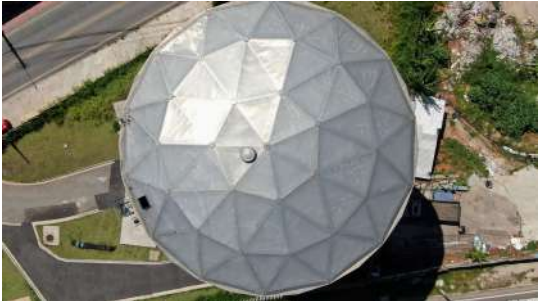
Foto 9 - Topo do reservatório.
