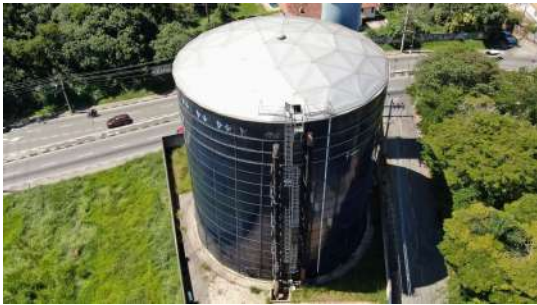
Foto 1 - Vista afastada do reservatório com a tampa de inspeção aberta.
