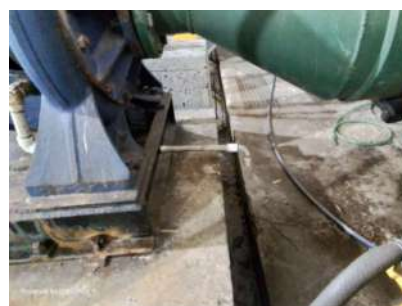
Foto 2 - Detalhe 2 da canaleta de drenagem das gaxetas.
