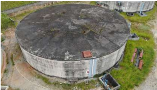
Foto 3 - Vista geral do reservatório II.
