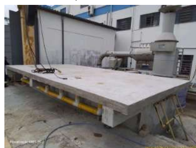
Foto 41 - Novo local externo para instalação dos cilindros de gás cloro.
