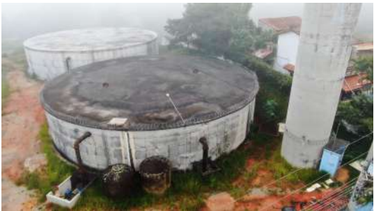
Foto 2 - Vista geral do reservatório II.
