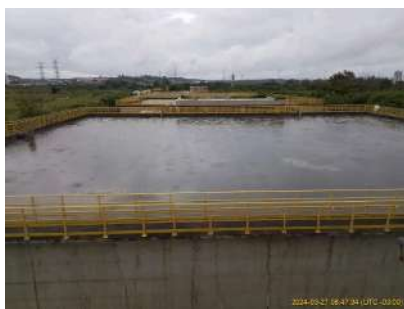
Foto 17 - Tanque 1 (próximo) e 2 (ao fundo) de aeração.
