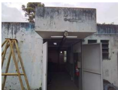
Foto 1 - Fachada da EEA, sem qualquer identificação do local.
