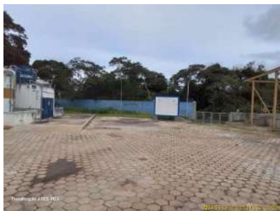
Foto 1 - Muro de proteção no fundo da captação e portão de acesso ao manancial.
