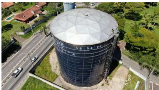
Foto 6 - Vista isométrica do reservatório.
