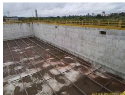
Foto 30 - Detalhe da lateral do tanque em construção.
