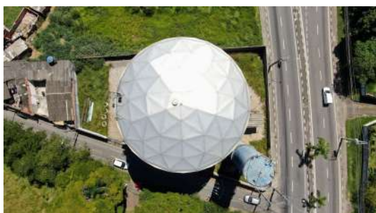
Foto 8 - Topo do reservatório Moraes.
