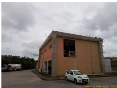
Foto 40 - Casa de secagem de lodo.
