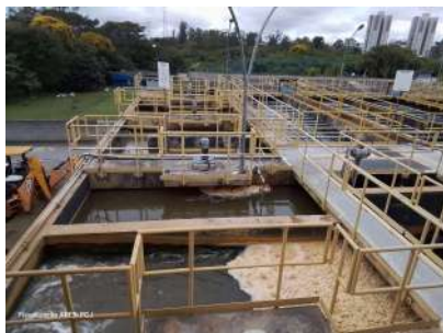
Foto 5 - Vista do sistema de floculação.
