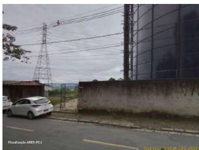
Foto 3 - Portão de caesso de muro do reservatório.
