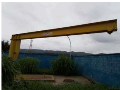
Foto 1 - Detalhe do suporte para içamento das bombas.
