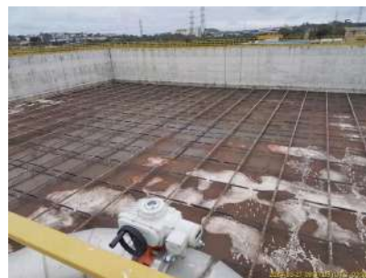
Foto 29 - Detalhe do tanque em construção.
