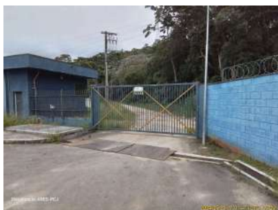
Foto 1 - Portão de acesso à captação.
