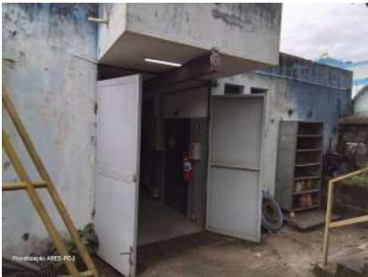
Foto 1 - Fachada do booster, sem qualquer identificação do local.
