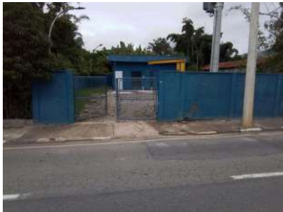
Foto 1 - Fachada da elevatória de esgoto bruto. Detalhe para a ausência de identificação.
