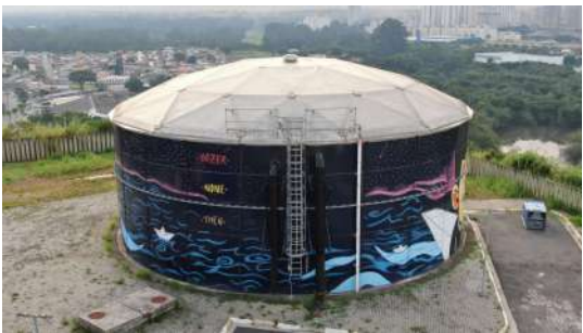
Foto 4 - Detalhe do guarda-corpo.
