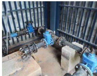
Foto 7 - Local onde ficavam as bombas da elevatória.
