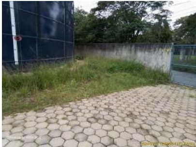
Foto 1 - Mato alto no entorno do reservatório.
