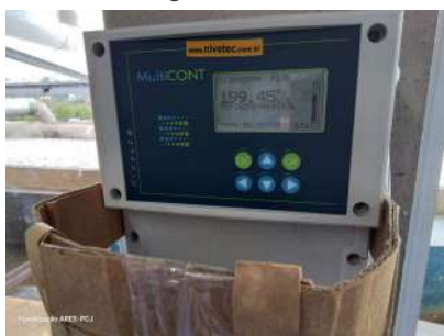
Foto 3 - Medidor de vazão de chegada.
