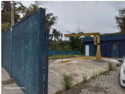
Foto 1 - Vista do acesso à EEE.
