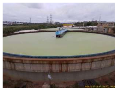
Foto 32 - Decantador 1 (próximo) e 2 (ao fundo).
