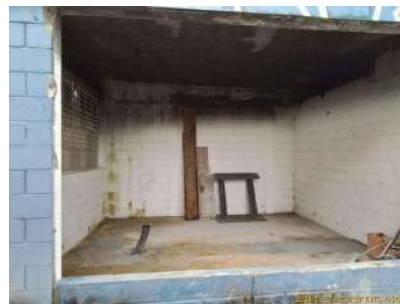
Foto 11 - Local de possível instalação de gerador.
