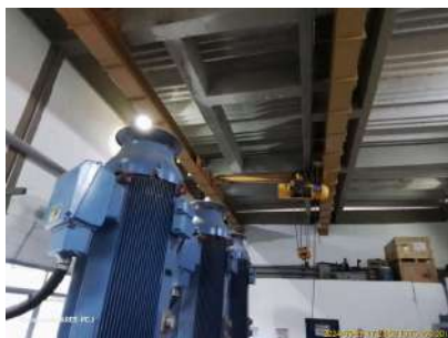
Foto 21 - Sistema de içamento dos equipamentos.
