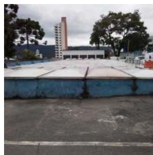
Foto 2 - Vista lateral do reservatório.
