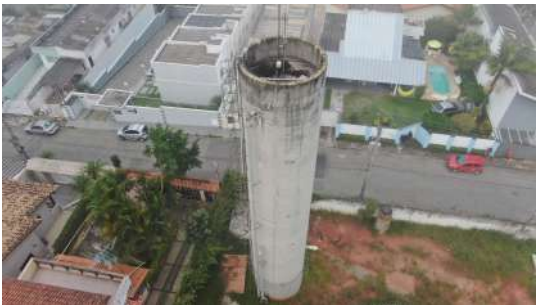
Foto 2 - Detalhe do extravasor.
