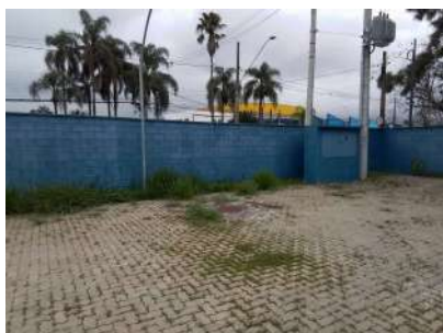
Foto 1 - Detalhe do muro em torno da estação elevatória de esgoto bruto.
