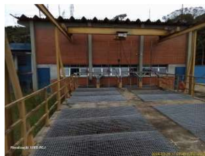
Foto 6 - Canal de adução com casa de bombas ao fundo.
