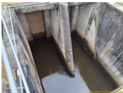
Foto 3 - Acesso da água aos canais de peneiramento.
