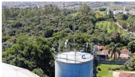
Foto 10 - Detalhe do topo do reservatório.
