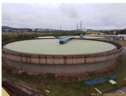
Foto 31 - Decantador com alga. De acordo com o prestador, se deve a recente paralisação e pouco acúmulo de lodo.
