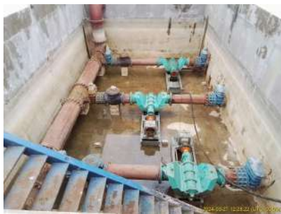
Foto 5 - Local em que as bombas estavam instaladas.
