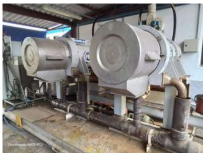
Foto 26 - Centrifugas de lodo.
