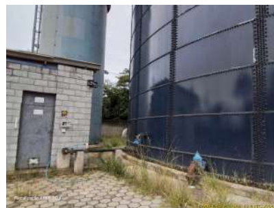
Foto 5 - Vista lateral do reservatório.
