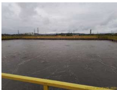
Foto 26 - Tanque de aeração 2.
