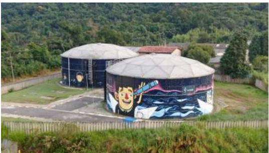
Foto 2 - Vista geral 2 dos reservatórios Oroxó.
