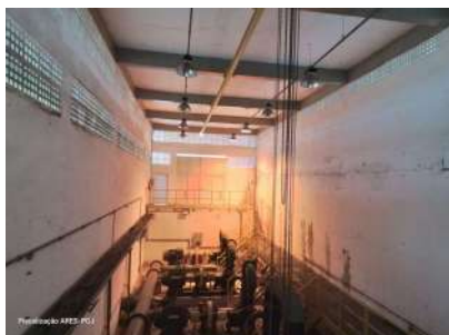
Foto 1 - Porta de acesso ao fundo com a viga de içamento no teto.
