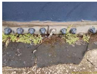
Foto 2 - Aterramento do reservatório.
