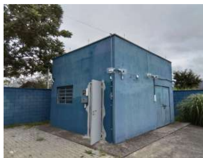
Foto 4 - Abrigo da elevatória.
