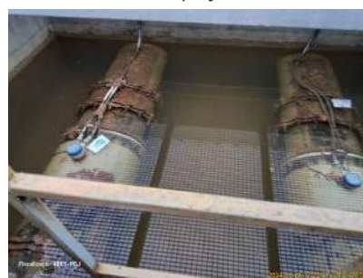
Foto 6 - Drenar a água pluvial acumulada nas duas caixas de inspeção das adutoras.
