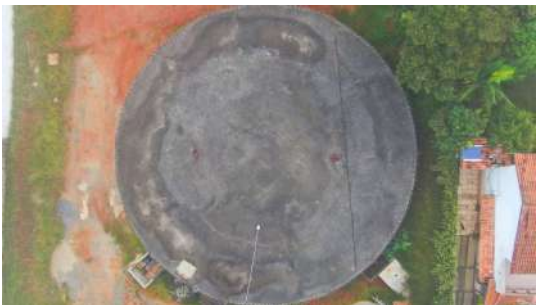
Foto 4 - Topo do reservatório II.
