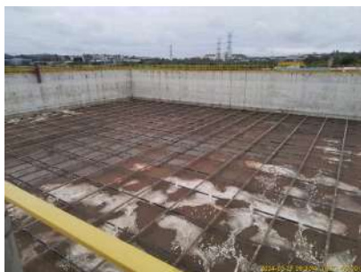
Foto 28 - Construção de novo tanque de aeração, entre tanque 2 e decantador 1.
