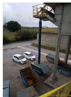
Foto 18 - Detalhe das caçambas para retirada de material retido no gradeamento grosseiro.
