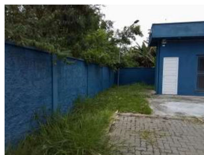
Foto 2 - Detalhe do muro que contorna a EEEB.
