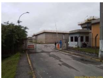
Foto 1 - Detalhe do portão de acesso.
