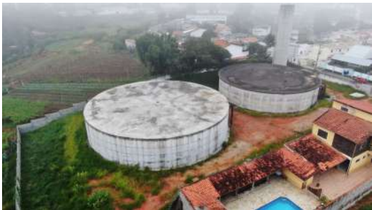
Foto 1 - Vista geral dos reservatórios Vila Suissa.
