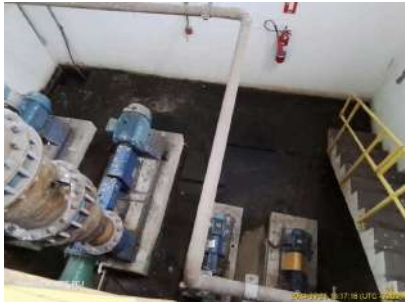
Foto 1 - Providenciar a limpeza de área.
