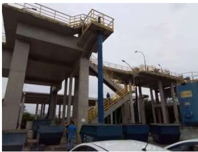
Foto 1 - Chegada do esgoto bruto.
