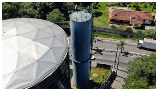
Foto 9 - Vista aérea do reservatório.
