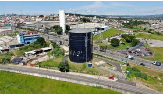
Foto 8 - Vista geral afastada do reservatório.
