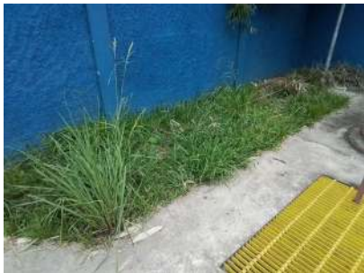
Foto 1 - A EEEB possui pontos de mato alto. É necessário podar a vegetação para que não comprometa a operação adequada no local.
