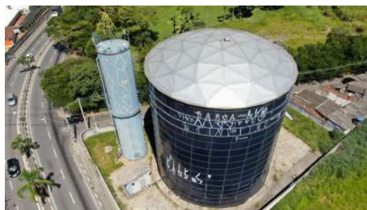
Foto 7 - Vista geral dos reservatórios Moraes (à direita) e Pomar (desativado, à esquerda).
