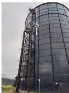
Foto 3 - Vista geral 3 do reservatório Jundiapéba.
