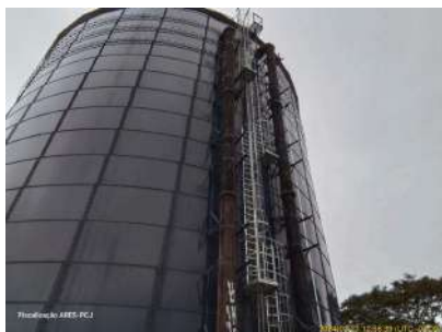
Foto 1 - Guarda-corpo do reservatório.
