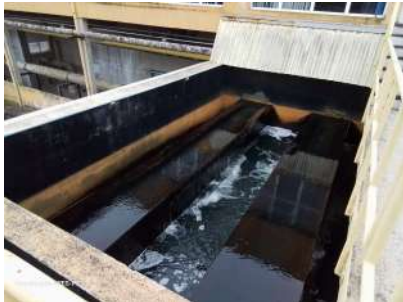
Foto 11 - Reabaicamento do nível para o processo de retrolavagem.
