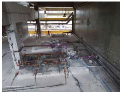
Foto 30 - Tampa ao fundo: início do tanque de contato e aplicação do gás cloro.
