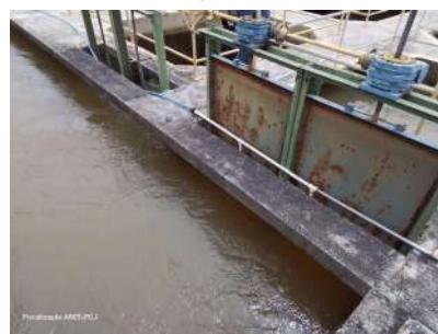
Foto 12 - Saída da floculação com adição de polímero não iônico 0,5%.
