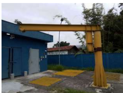
Foto 1 - Detalhe do suporte para içamento das bombas.
