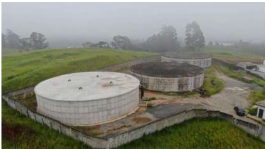
Foto 1 - Vista geral dos três reservatórios.
