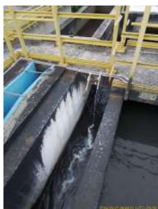
Foto 15 - Aplicação de hidróxido de cálcio após as caixas de areia.
