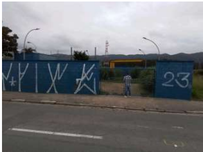
Foto 1 - Detalhe da fachada da EEEB.
