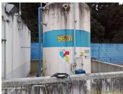
Foto 11 - Tanque de reagente Purate para produzir hidróxido de cloro.
