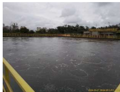
Foto 20 - Tanque de aeração 2.
