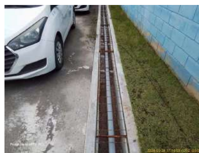
Foto 15 - Tubulação com hidróxido de cloro para dosagem na adutora.
