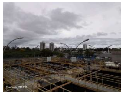
Foto 6 - Vista dos decantadores e filtros.
