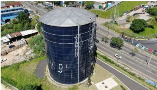
Foto 7 - Vista geral do reservatório.
