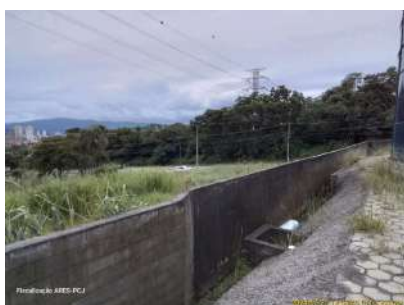
Foto 1 - Muro de proteção do reservatório.
