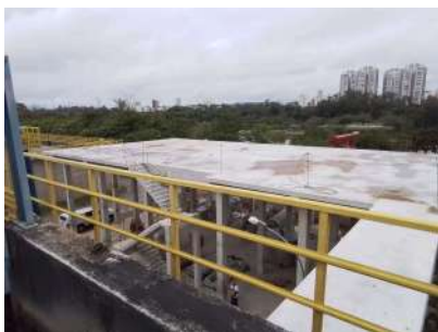
Foto 5 - Expansão da chegada de esgoto bruto, ao lado da estrutura operante.
