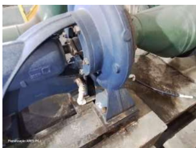
Foto 1 - Detalhe 1 da canaleta de drenagem das gaxetas.
