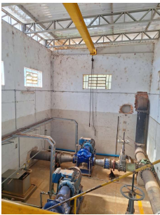
Foto 1 - Trave com corrente para erguer as bombas
