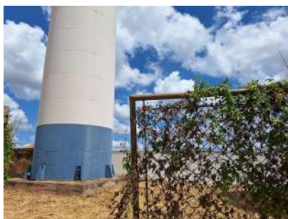
Foto 1 - Entrada da área do reservatório, sem qualquer tipo de identificação.
