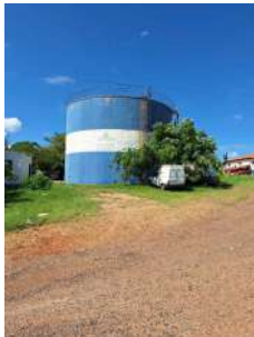
Foto 1 - Visão geral - Reservatório apoiado metálico
