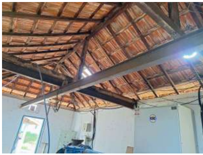
Foto 1 - Trave para auxílio da manutenção da Estação Elevatória
