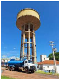
Foto 1 - Reservatório Elevado - visão geral. Abastecimento de caminhão pipa
