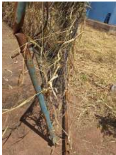
Foto 1 - portão quebrado e mato na grade
