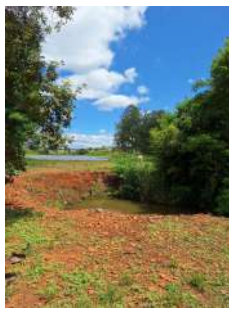
Foto 1 - Vista - represa de captação
