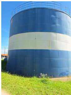
Foto 4 - Descida do cabo de aterramento do para-raios
