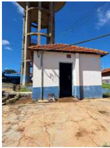
Foto 1 - Casa de bombas (EEA RES. ELEVADO) e de controle elétrico.
