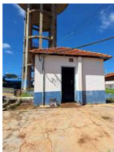
Foto 3 - Casa de bombas - visão externa
