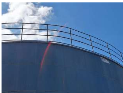
Foto 1 - Guarda-corpos no topo do reservatório
