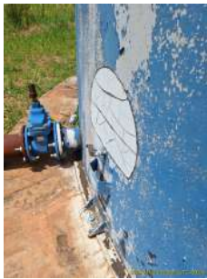
Foto 1 - Local onde havia manômetro na base do reservatório
