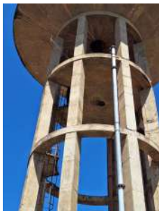
Foto 2 - Guarda-corpos da escada para o reservatório elevado
