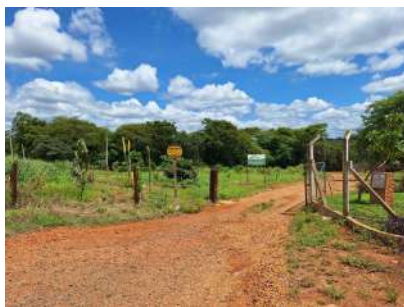
Foto 1 - Entrada da área da captação, ausência de identificação
