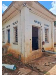
Foto 4 - Entrada da casa de bombas - represa da arrependida
