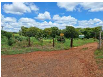
Foto 1 - Entrada da área da captação com cercamento
