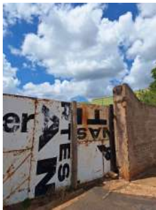
Foto 1 - Lote de entrada do Booster - não há qualquer tipo de identificação
