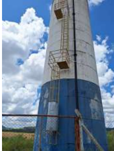
Foto 1 - Visão geral - Reservatório Flórida
