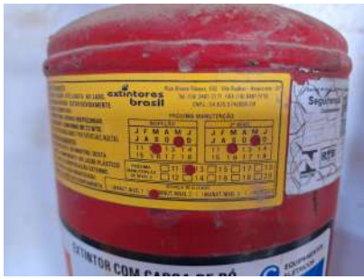
Foto 1 - Extintor de incêndio com validade expirada
