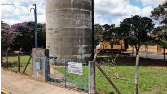
Foto 7 - Vista por drone do Reservatório Iracema em Iracemápolis
