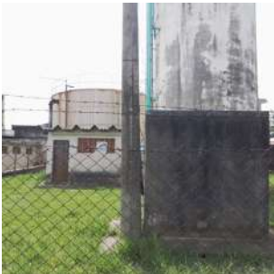
Foto 1 - Cercamento do reservatório Ometto Pavan em Iracemápolis
