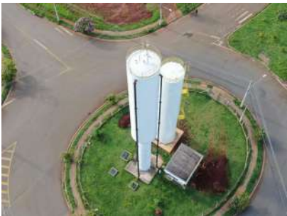
Foto 2 - Vista por drone do reservatório Campo Verde em Iracemápolis
