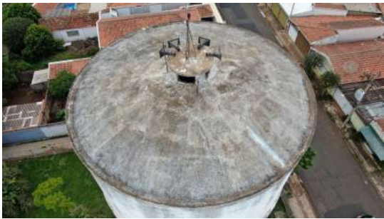
Foto 1 - Vista por drone do reservatório Centro em Iracemápolis
