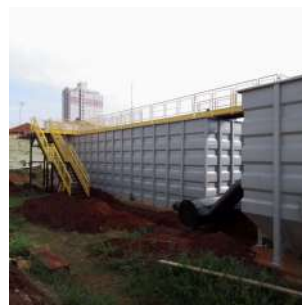
Foto 6 - Construção da ETA Compacta de Iracemápolis
