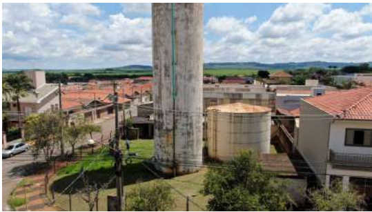
Foto 1 - Vista por drone dos reservatórios Ometto Pavan em Iracemápolis
