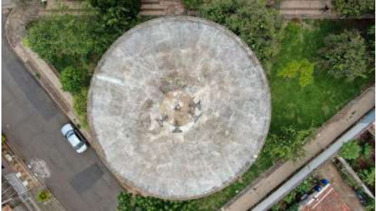
Foto 6 - Vista por drone do reservatório Centro em Iracemápolis
