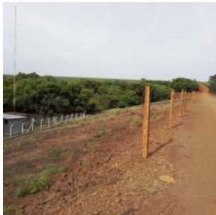
Foto 4 - Vista da Captação Boa vista
