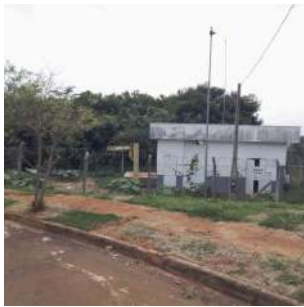
Foto 1 - Estação elevatória de efluente bruto Campos Verde em Iracemápolis
