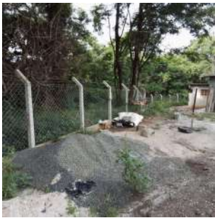
Foto 2 - Interior da Estação Elevatória de água bruta da Captação Boa Vista
