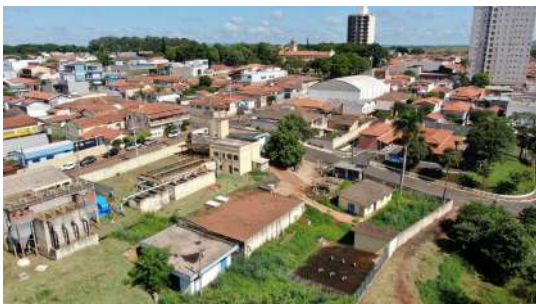
Foto 1 - Vista por drone da ETA de Iracemápolis
