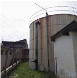
Foto 3 - Reservatório apoiado Ometto Pavan em Iracemápolis
