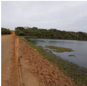
Foto 7 - Vista da Captação Boa vista
