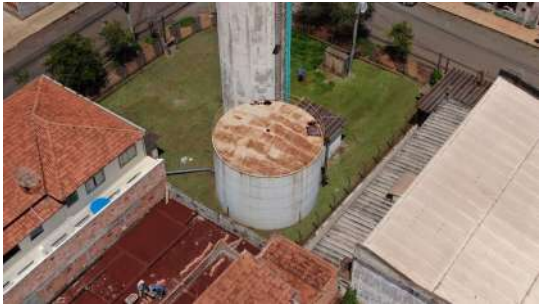
Foto 7 - Vista por drone do Reservatório apoiado Ometto Pavan em Iracemápolis
