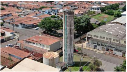
Foto 2 - Vista por drone do reservatório do Ometto Pavan elevado em Iracemápolis
