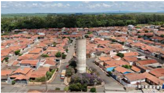
Foto 1 - Vista por drone do Reservatório Iracema em Iracemápolis
