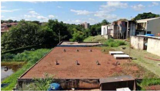
Foto 1 - Reservatório enterrado da ETA em Iracemápolis
