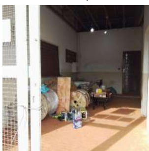
Foto 7 - Construção da ETA Compacta de Iracemápolis
