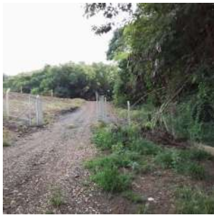
Foto 1 - Entrada da Estação Elevatória de água bruta da Captação Boa Vista
