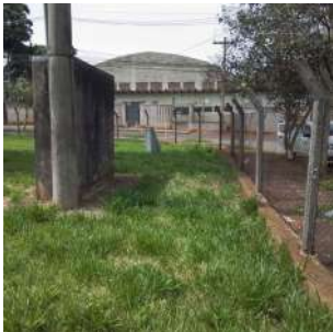
Foto 2 - Cercamento do reservatório Ometto Pavan em Iracemápolis
