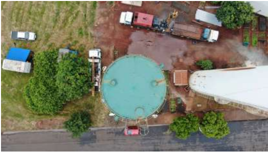
Foto 2 - Vista por drone dos Reservatórios Cidade Nova II em Iracemápolis
