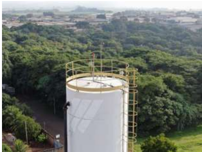
Foto 1 - Guarda-corpo do reservatório Campo Verde de Iracemápolis
