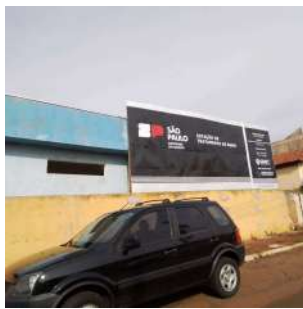
Foto 1 - Construção da ETA Compacta de Iracemápolis
