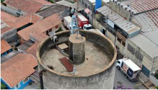
Foto 6 - Vista por drone do Reservatório Iracema em Iracemápolis
