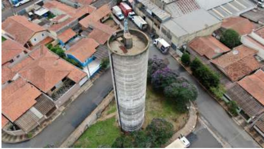
Foto 5 - Vista por drone do Reservatório Iracema em Iracemápolis
