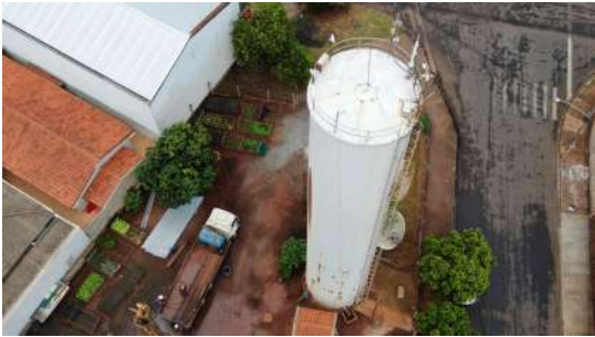
Foto 1 - Vista por drone dos Reservatórios Cidade Nova II em Iracemápolis
