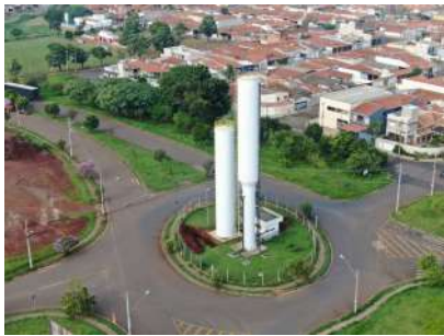
Foto 7 - Vista por drone do Reservatório Campo Verde em Iracemápolis
