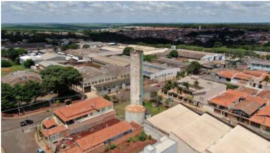
Foto 8 - Vista por drone do Reservatório apoiado Ometto Pavan em Iracemápolis
