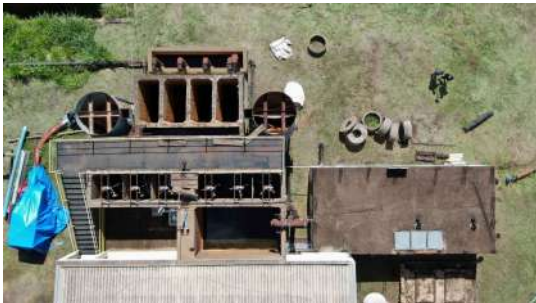
Foto 15 - Vista por drone da ETA de Iracemápolis
