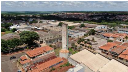
Foto 3 - Vista por drone do reservatório do Ometto Pavan elevado em Iracemápolis
