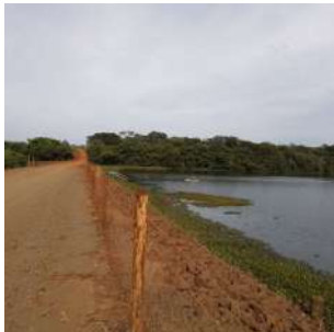
Foto 5 - Vista da Captação Boa vista
