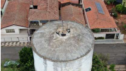
Foto 5 - Vista por drone do reservatório Centro em Iracemápolis
