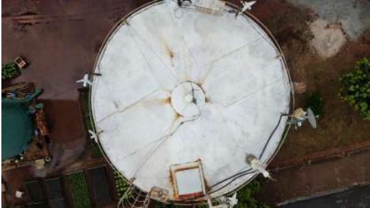
Foto 3 - Vista por drone dos Reservatórios Cidade Nova II em Iracemápolis
