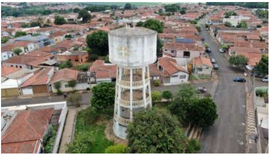
Foto 2 - Vista por drone do reservatório Centro em Iracemápolis
