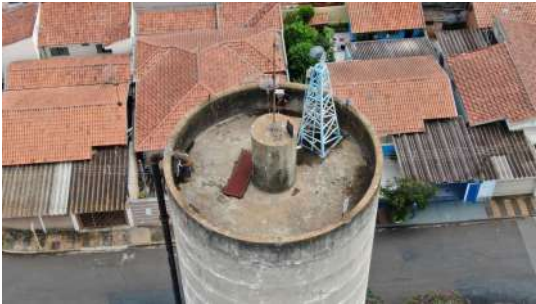
Foto 4 - Vista por drone do Reservatório Iracema em Iracemápolis
