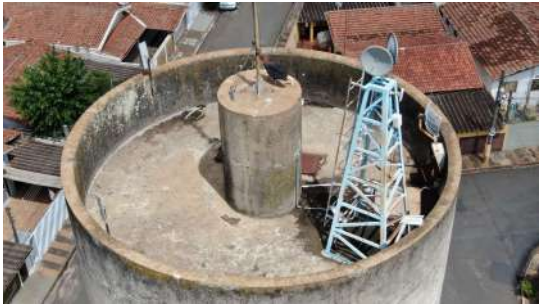
Foto 3 - Vista por drone do Reservatório Iracema em Iracemápolis
