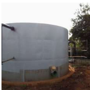
Foto 9 - Construção da ETA Compacta de Iracemápolis
