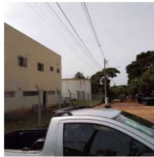
Foto 2 - Entrada da ETA de Iracemápolis
