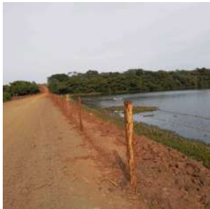
Foto 6 - Vista da Captação Boa vista
