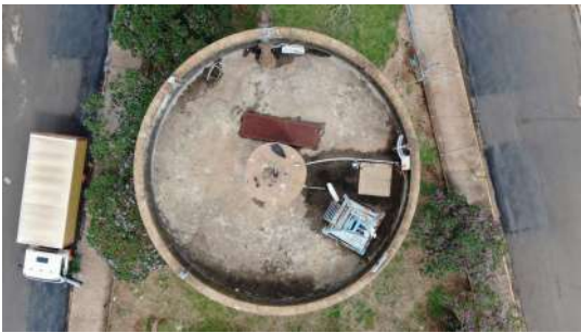
Foto 2 - Vista por drone do Reservatório Iracema em Iracemápolis
