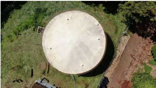
Foto 2 - Reservatório Apoiado da ETA de Iracemápolis
