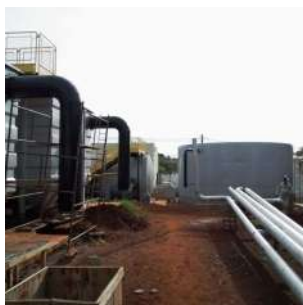
Foto 5 - Construção da ETA Compacta de Iracemápolis
