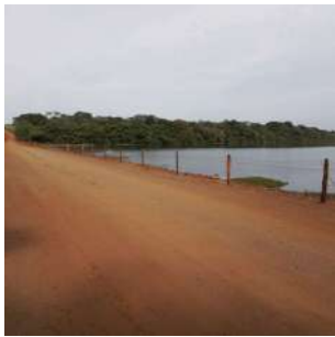
Foto 1 - Vista da Captação Boa vista
