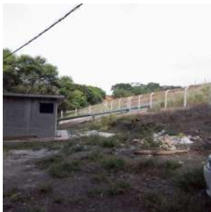
Foto 3 - Interior da Estação Elevatória de água bruta da Captação Boa Vista
