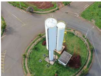
Foto 6 - Vista por drone do Reservatório Campo Verde em Iracemápolis
