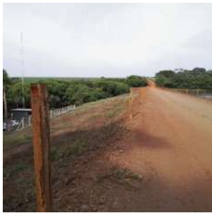
Foto 2 - Vista da Captação Boa vista
