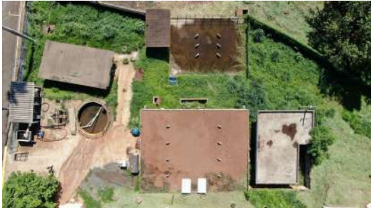
Foto 13 - Vista por drone da ETA de Iracemápolis
