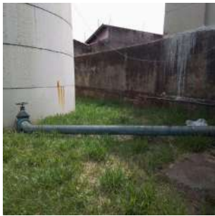
Foto 5 - Reservatório apoiado Ometto Pavan em Iracemápolis
