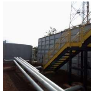
Foto 4 - Construção da ETA Compacta de Iracemápolis
