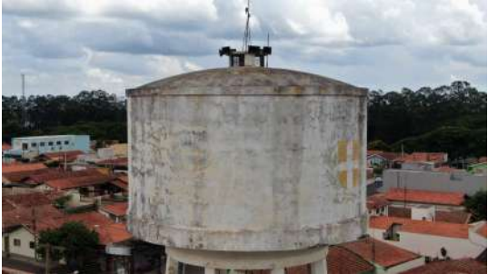
Foto 4 - Vista por drone do reservatório Centro em Iracemápolis
