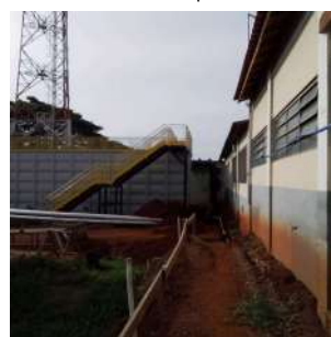
Foto 8 - Construção da ETA Compacta de Iracemápolis
