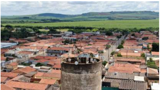
Foto 6 - Vista por drone do reservatório do Ometto Pavan elevado em Iracemápolis
