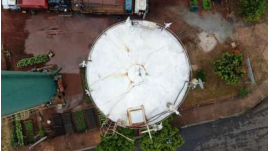
Foto 4 - Vista por drone dos Reservatórios Cidade Nova II em Iracemápolis
