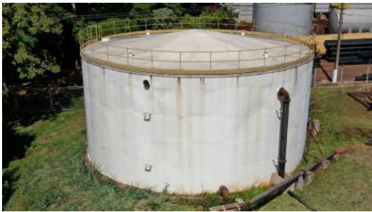
Foto 3 - Reservatório Apoiado da ETA de Iracemápolis
