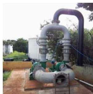
Foto 10 - Construção da ETA Compacta de Iracemápolis
