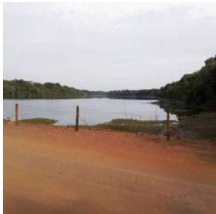
Foto 3 - Vista da Captação Boa vista
