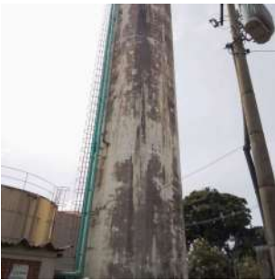
Foto 2 - Guarda-corpos do reservatório do Ometto Pavan elevado em Iracemápolis
