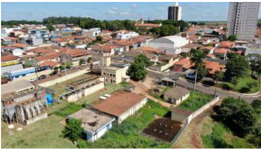
Foto 2 - Reservatório enterrado da ETA em Iracemápolis
