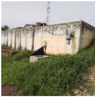
Foto 11 - Vista interna da ETA de Iracemápolis
