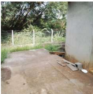
Foto 4 - Interior da Estação Elevatória de água bruta da Captação Boa Vista
