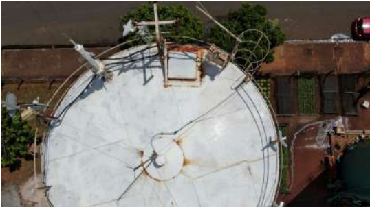
Foto 1 - Tampa de inspeção dos Reservatórios Cidade Nova II em Iracemápolis
