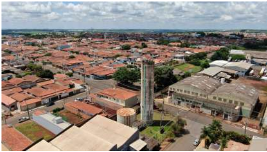
Foto 1 - Vista por drone do reservatório do Ometto Pavan elevado em Iracemápolis
