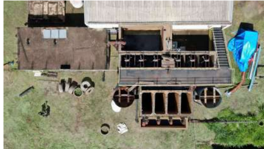
Foto 14 - Vista por drone da ETA de Iracemápolis
