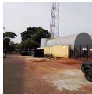
Foto 2 - Construção da ETA Compacta de Iracemápolis
