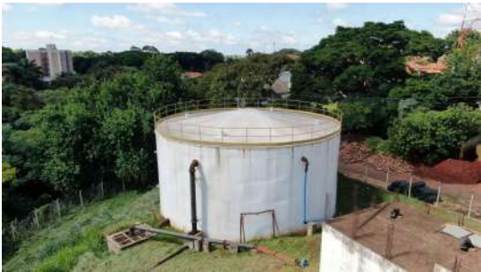
Foto 1 - Reservatório Apoiado da ETA de Iracemápolis
