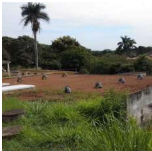
Foto 1 - Reservatório enterrado da ETA em Iracemápolis
