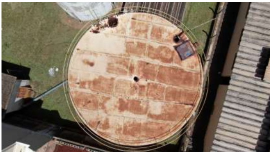
Foto 1 - Vista superior por drone do Reservatório apoiado Ometto Pavan em Iracemápolis
