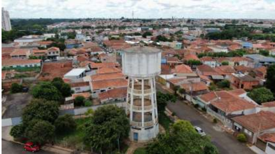
Foto 3 - Vista por drone do reservatório Centro em Iracemápolis
