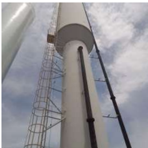
Foto 4 - Guarda-corpo do Reservatório Campo Verde em Iracemápolis
