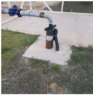
Foto 1 - Laje de proteção.
