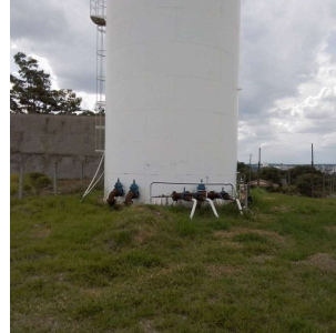
Foto 2 - Vista do reservatório.
