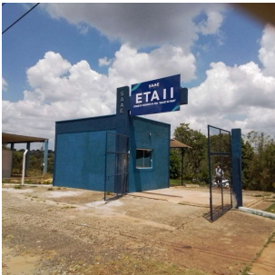
Foto 1 - Acesso à ETA.
