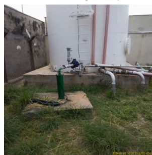
Foto 4 - Vista geral do poço.
