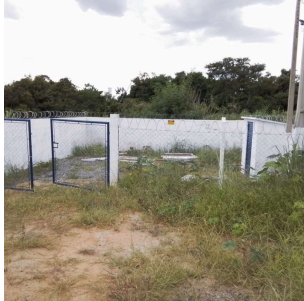
Foto 1 - Vista externa da EEE.
