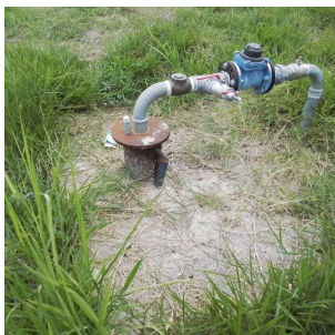
Foto 1 - Laje de proteção.
