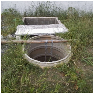
Foto 1 - Corrente da bomba em estrutura provisória.
