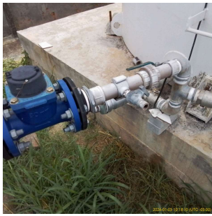
Foto 1 - Tomada de água.
