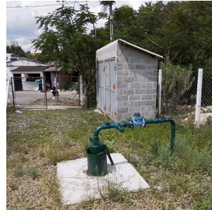
Foto 4 - Vista geral do poço.
