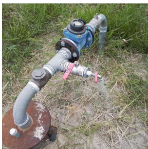
Foto 1 - Tomada de água.
