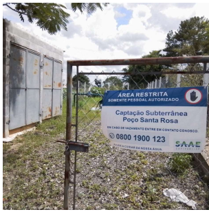
Foto 1 - Vista externa do poço.
