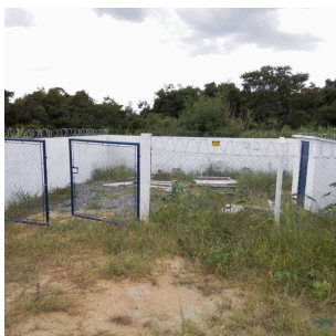
Foto 1 - Cerca da EEEB.
