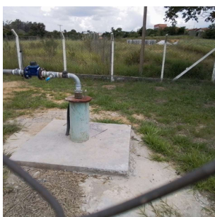
Foto 1 - Laje de proteção.
