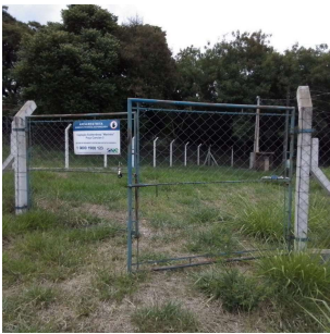
Foto 1 - Vista externa do poço.
