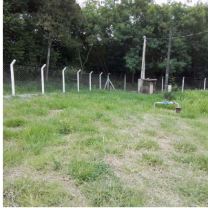
Foto 1 - Cerca do poço.
