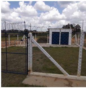
Foto 3 - Vista geral do poço.
