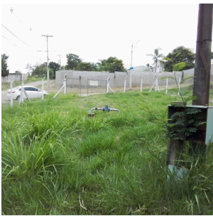
Foto 3 - Vista geral do poço.
