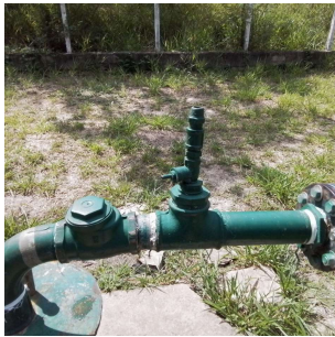
Foto 1 - Tomada de água.
