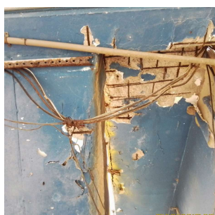
Foto 1 - Armação da estrutura exposta.
