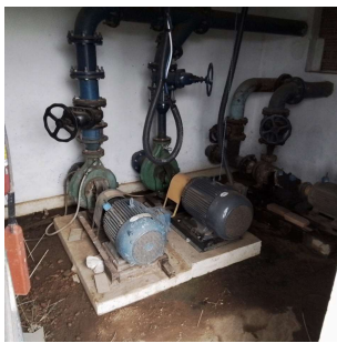
Foto 5 - Nova base de concreto da EEAT da ETA.
