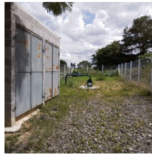
Foto 2 - Vista geral do poço.
