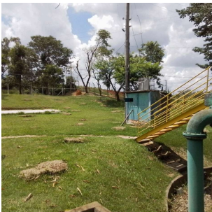
Foto 3 - Entrada de energia da ETA.
