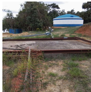
Foto 12 - Vista do novo reservatório da ETA. Finalizado a instalação hidráulica.
