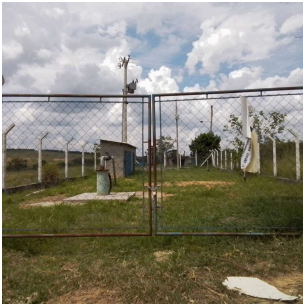
Foto 1 - Vista geral do poço.
