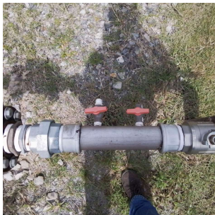
Foto 1 - Tomada de água.
