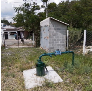
Foto 3 - Vista geral do poço.
