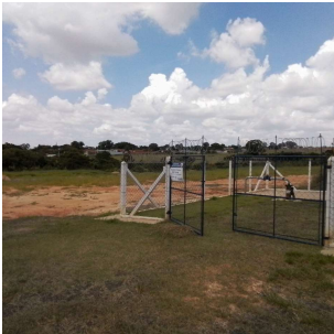
Foto 1 - Vista externa do poço.
