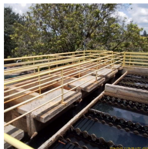
Foto 2 - Vista dos guarda-corpos na passarela dos filtros.
