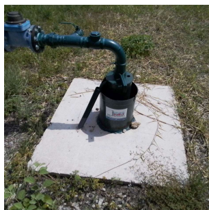
Foto 1 - Laje de proteção.
