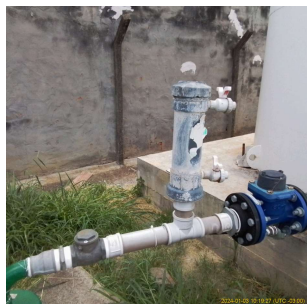
Foto 1 - Sistema de dosagem química por pastilha.
