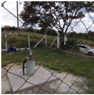
Foto 1 - Cerca do poço.
