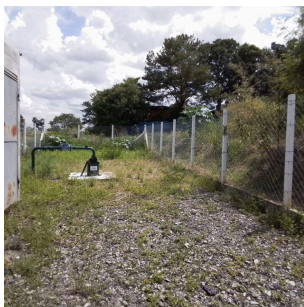
Foto 1 - Cerca do poço.
