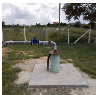
Foto 1 - Tomada de água.
