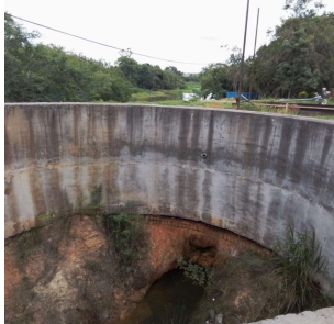
Foto 9 - Tanque do futuro tratamento de lodo.
