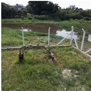
Foto 1 - Tomada de água.
