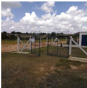
Foto 1 - Cerca do poço.
