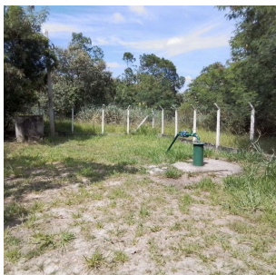
Foto 1 - Área do poço.
