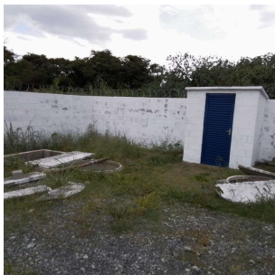
Foto 5 - Vista geral da EEE.
