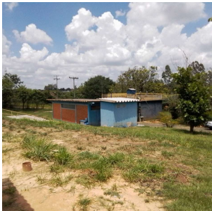
Foto 2 - Vista da ETA.
