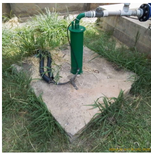
Foto 1 - Laje de proteção.
