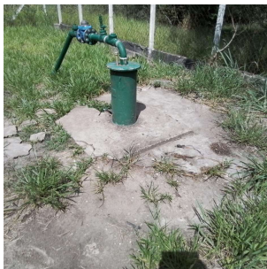
Foto 1 - Laje de proteção.
