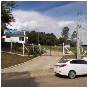
Foto 1 - Vista externa da ETE.
