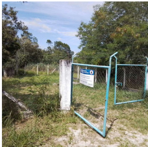
Foto 1 - Vista geral do poço.
