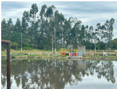
Foto 1 - Sistema de tratamento de lodo
