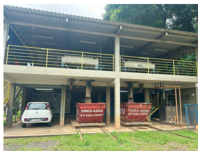
Foto 26 - Tratamento de lodo
