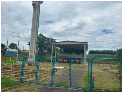
Foto 2 - Tratamento de lodo desativado
