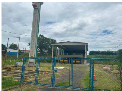
Foto 3 - Unidade de tratamento de lodo
