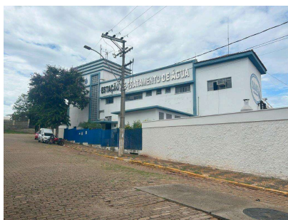
Foto 1 - Fachada da ETA
