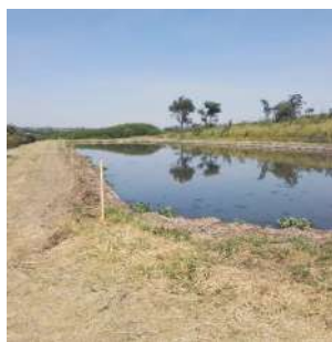
Foto 2 - Cercamento sem a corda protetora (lagoa da cota superior).
