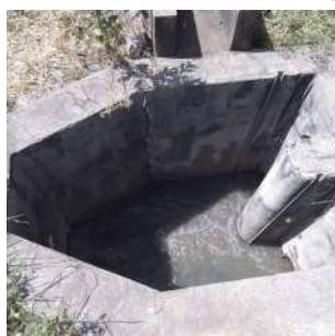
Foto 7 - Poço junto à chegada de esgoto bruto.
