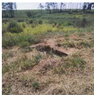
Foto 1 - Local com risco de queda.
