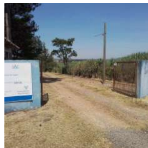
Foto 2 - Portão de acesso à ETE.
