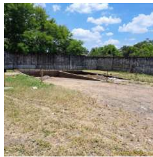
Foto 10 - Leito de secagem do material retido no gradeamento.
