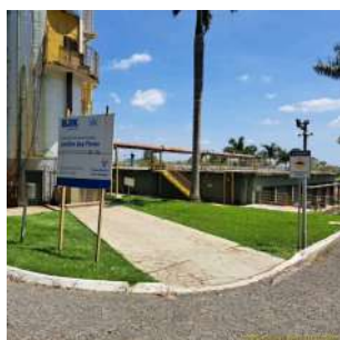
Foto 1 - Placa de identificação da área (à frente) e reatores UASB ao fundo.
