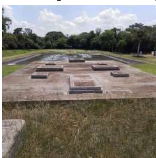
Foto 12 - Reatores UASB, anteriores às lagoas.
