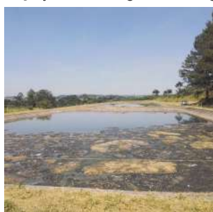
Foto 9 - Detalhe da lagoa anaeróbica.
