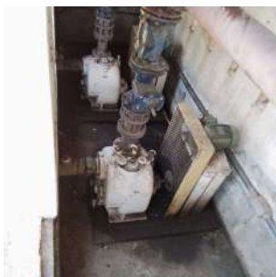
Foto 1 - Acesso às bombas.
