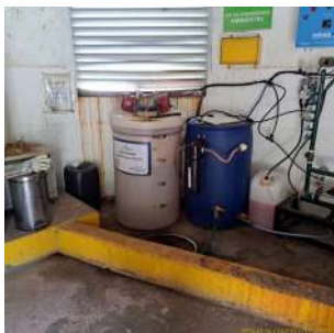
Foto 3 - Bombas dosadoras do catalisador metabólico.
