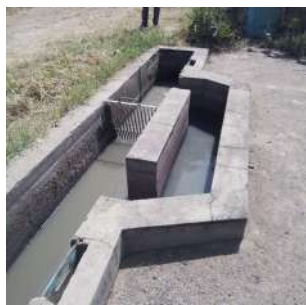
Foto 3 - Detalhe 2 do gradeamento grosseiro.
