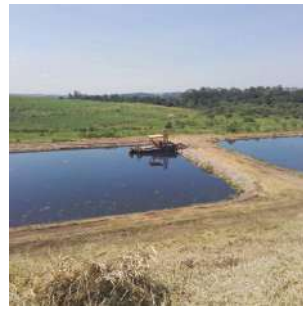
Foto 12 - Maquinário usado na manutenção das lagoas.
