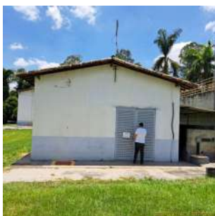
Foto 17 - Abrigo dos conjuntos motobomba de recirculação do lodo do processo.
