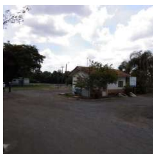
Foto 1 - Vista geral da ETE Palmeiras.
