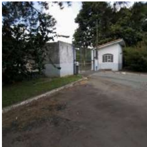
Foto 1 - Portão de acesso.
