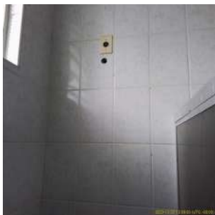
Foto 1 - Não há chuveiro na casa de apoio.
