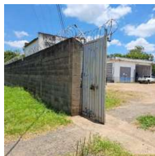
Foto 2 - Vista externa da EEE.
