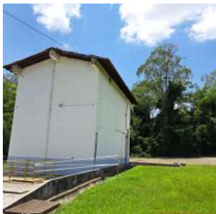
Foto 14 - Prédio das bombas centrífugas de lodo e das caçambas de descarte.
