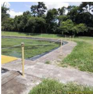
Foto 1 - A lagoa dispõe de proteção em seu entorno, mas em um dos trechos (próximo à saída do efluente tratado) não há a corda inferior.
