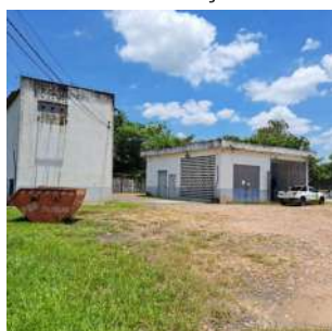
Foto 3 - Vista da casa de bombas da elevatória.
