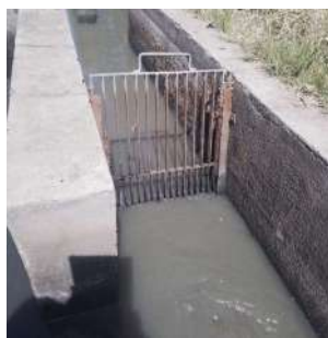
Foto 2 - Detalhe 1 do gradeamento grosseiro.
