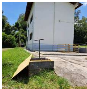
Foto 11 - Caixa de registro de tubulação de água potável próxima ao abrigo das centrífugas de lodo.
