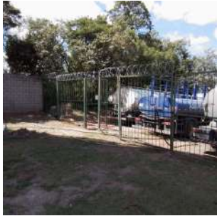
Foto 3 - Acesso ao reservatório.
