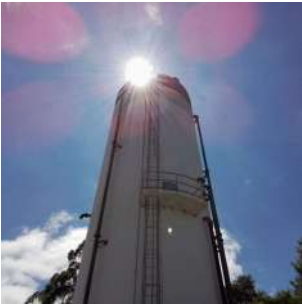
Foto 2 - Vista geral do reservatório.
