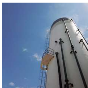
Foto 1 - Guarda-corpo do reservatório.
