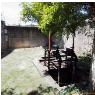
Foto 1 - Muro no entorno da EEEB.
