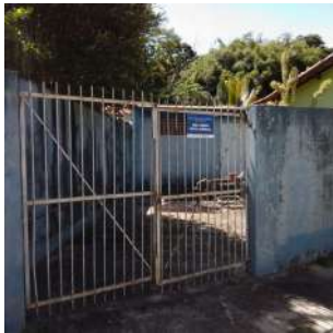
Foto 1 - Vista geral da EEB.
