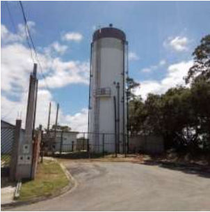
Foto 4 - Vista geral do reservatório.
