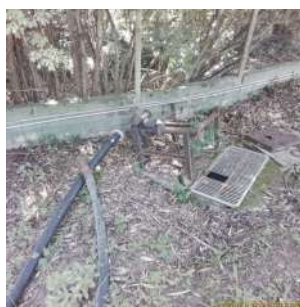
Foto 4 - Estrutura para drenar o poço.
