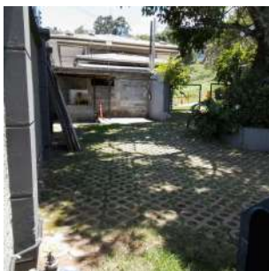
Foto 1 - Acesso à EEAT.
