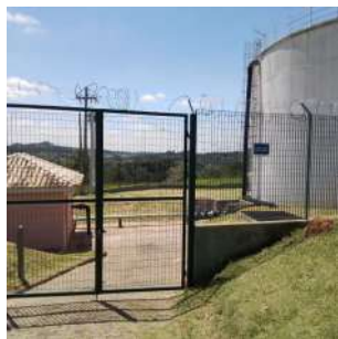
Foto 1 - Vista externa da EEAT.
