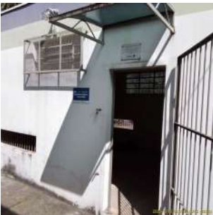
Foto 2 - Vista externa da EEAT.
