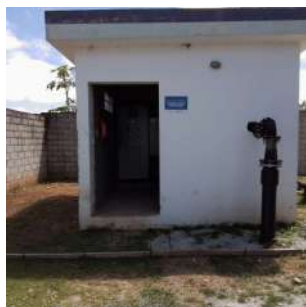
Foto 1 - Acesso à EEAT.
