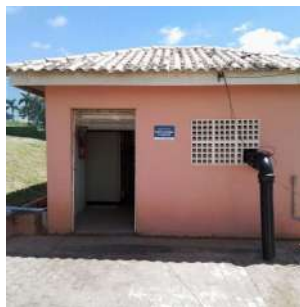
Foto 2 - Vista geral da EEAT.
