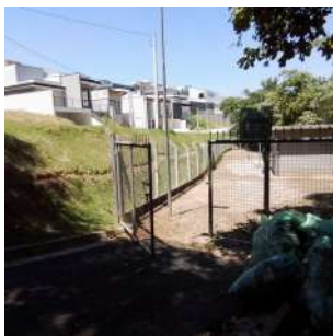
Foto 1 - Cerca da EEEB.
