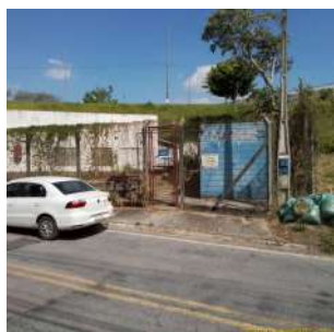
Foto 1 - Cerca da EEEB.
