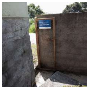
Foto 1 - Acesso à EEEB.
