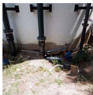
Foto 2 - Tubo extravasor do reservatório.
