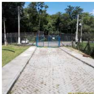
Foto 1 - Acesso à EEEB.
