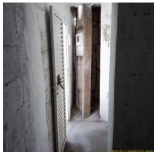
Foto 1 - Acesso à EEAT.
