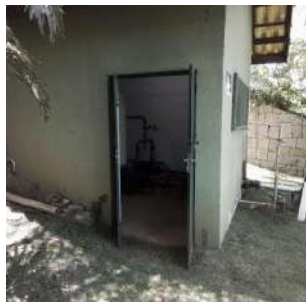
Foto 1 - Acesso à EEAT.
