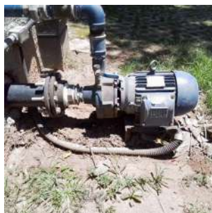
Foto 1 - Bomba com selo mecânico.
