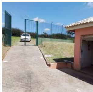
Foto 1 - Acesso à EEAT.
