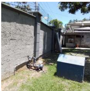
Foto 1 - Muro da EEAT/condomínio.
