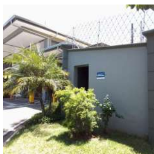
Foto 1 - Vista do acesso aos painéis elétricos da EEAT.
