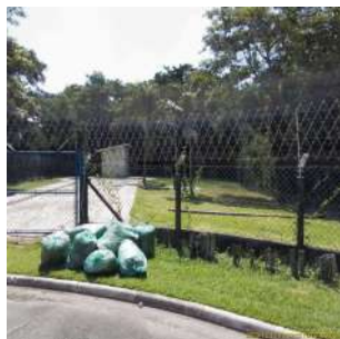
Foto 1 - Vista geral da EEEB.
