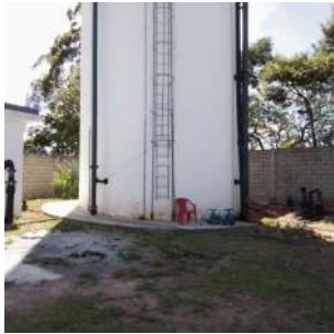
Foto 1 - Vista geral do reservatório.
