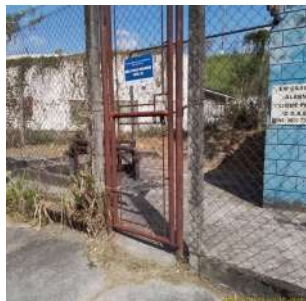
Foto 1 - Acesso à EEEB.
