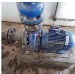
Foto 1 - Bomba com selo mecânico.
