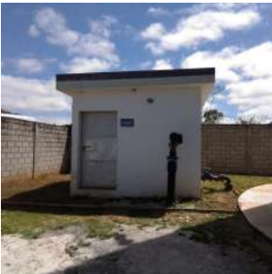
Foto 2 - Vista geral da EEAT.
