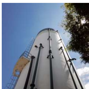
Foto 1 - Tubo extravasor do reservatório.
