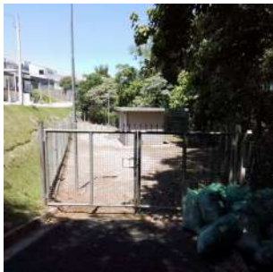
Foto 1 - Vista geral da EEEB.
