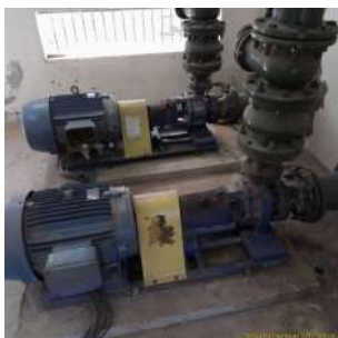
Foto 1 - Bomba com selo mecânico.
