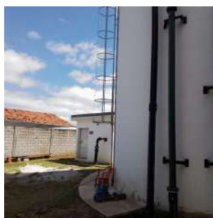
Foto 2 - Guarda-corpo do reservatório.
