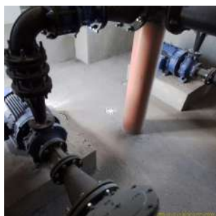
Foto 1 - Bomba com selo mecânico.
