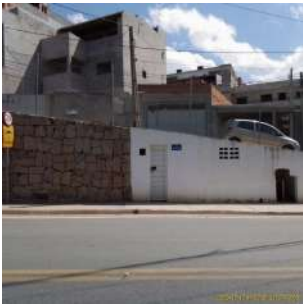
Foto 3 - Vista externa da EEAT.
