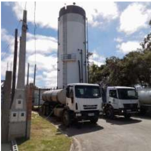
Foto 1 - Vista do acesso à EEAT.
