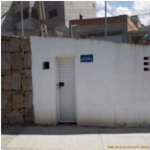
Foto 1 - Vista externa da EEAT.
