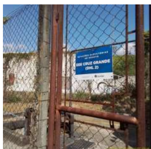
Foto 1 - Placa de indentificação.
