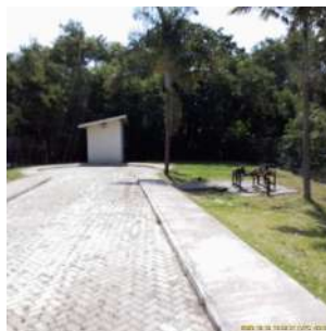
Foto 2 - Vista geral da EEEB.
