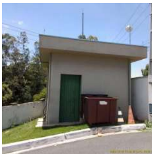
Foto 1 - Muro no entorno da EEAT.
