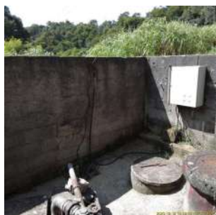
Foto 1 - Muro no entorno da EEEB.
