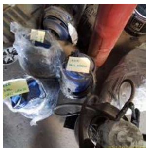
Foto 2 - Bomba reserva guardada no almoxarifado.
