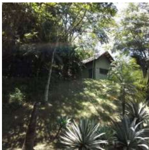
Foto 1 - Vista externa da EEAT.
