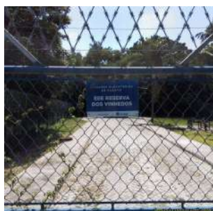
Foto 1 - Placa de indentificação.
