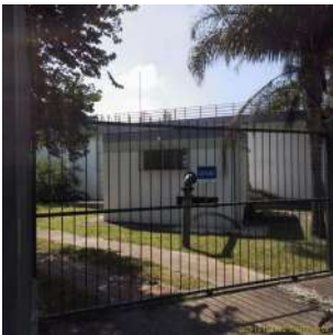
Foto 1 - Vista externa da EEAT.
