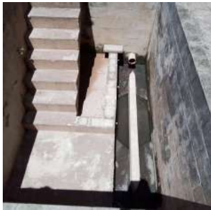
Foto 4 - Vista da caixa de areia.
