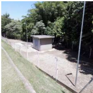
Foto 2 - Vista geral da EEEB.
