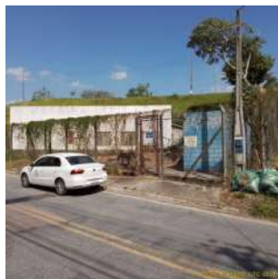
Foto 1 - Vista geral da EEEB.
