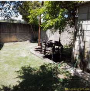
Foto 2 - Vista geral da EEB.
