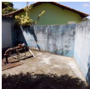
Foto 1 - Muro no entorno da EEEB.
