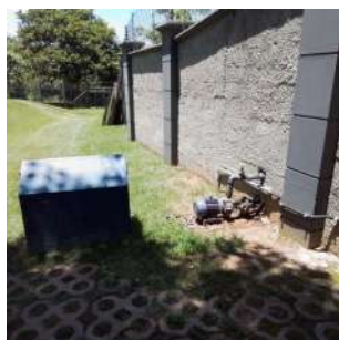
Foto 4 - Vista geral da EEAT.
