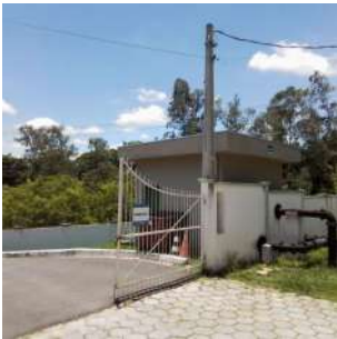
Foto 1 - Vista externa da EEAT.
