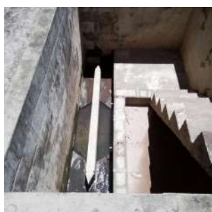
Foto 1 - Tratamento preliminar sem gradeamento.
