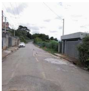
Foto 2 - Vista geral da EEEB.
