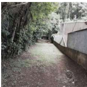
Foto 1 - Via de acesso à EEAB.
