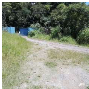
Foto 2 - Portão de acesso à elevatória.
