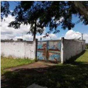
Foto 1 - Vista externa do reservatório.
