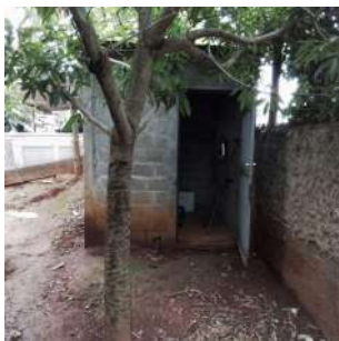
Foto 3 - Vista geral da EEA.
