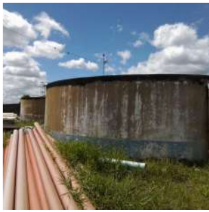
Foto 5 - Vista interna do reservatório.
