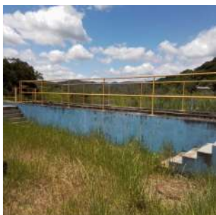
Foto 7 - Vista do tratamento preliminar da água bruta.
