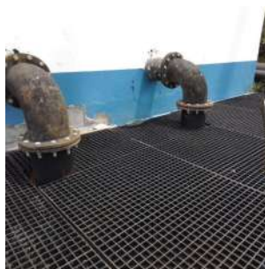
Foto 6 - Poço de sucção da elevatória nova.
