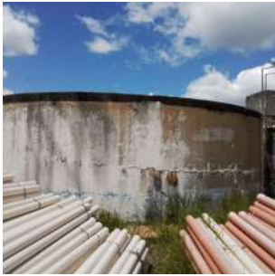
Foto 4 - Vista interna do reservatório.
