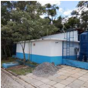
Foto 2 - Vista geral do reservatório.
