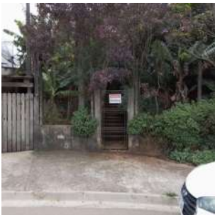
Foto 1 - Vista do acesso à EEA.
