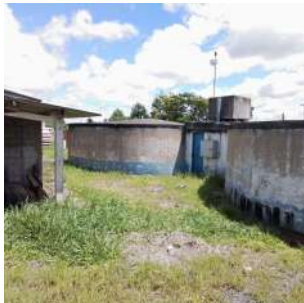
Foto 7 - Vista interna do reservatório.
