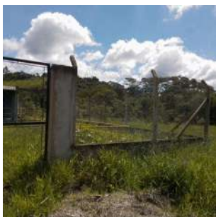
Foto 1 - Cerca da EEEB.
