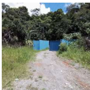
Foto 1 - Portão de acesso à captação.
