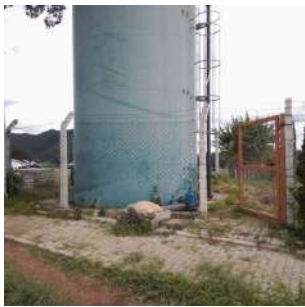
Foto 1 - Vista geral do reservatório.
