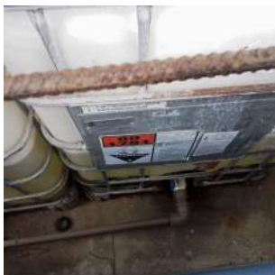
Foto 3 - Armazenamento de produtos químicos.
