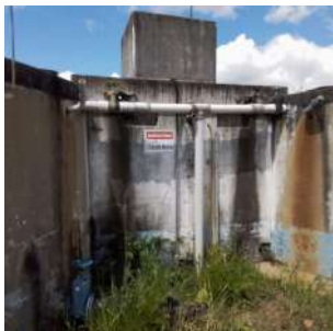
Foto 1 - Placa de identificação do reservatório.
