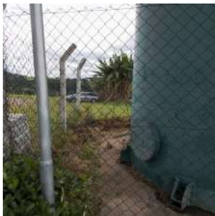
Foto 2 - Cerca do reservatório.
