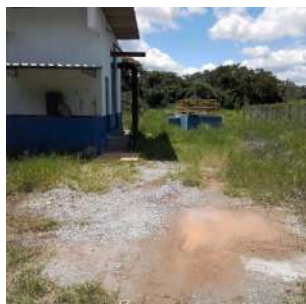
Foto 1 - Via de acesso à elevatória.
