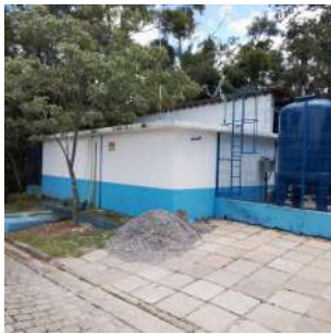
Foto 1 - Cerca da ETA Alpes. Interior de condomínio.
