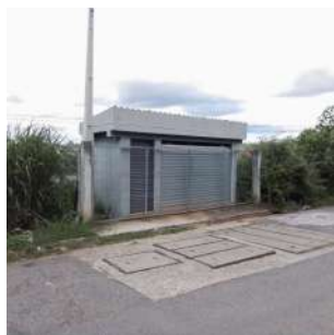
Foto 1 - Vista geral da EEEB.
