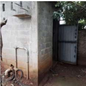
Foto 2 - Vista geral da EEA.
