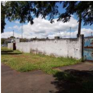
Foto 2 - Vista externa do reservatório.
