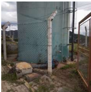
Foto 1 - Cerca do reservatório.
