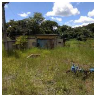
Foto 8 - Vista da EEAB antiga.
