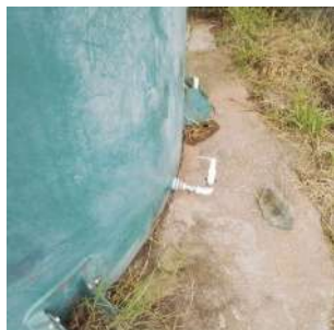
Foto 1 - Plug da mangueira de controle de nível.
