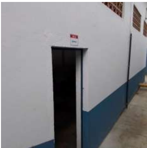
Foto 1 - Vista externa do abrigo das EEAT.
