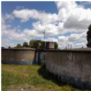
Foto 1 - Tubulação de ventilação no topo dos reservatórios.
