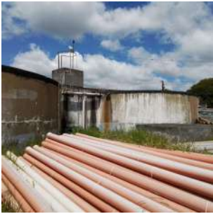
Foto 3 - Vista interna do reservatório.
