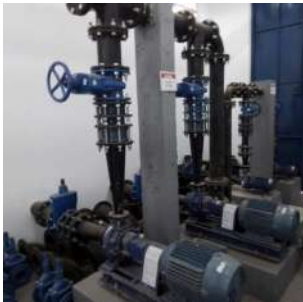
Foto 4 - EEAT Alpes DOuro (aguardando execução da adutora)
