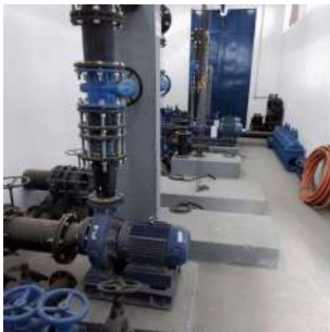
Foto 2 - Vista interna do abrigo das EEAT.
