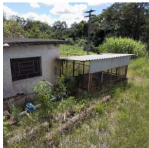
Foto 12 - Vista da EEAB antiga.
