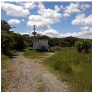
Foto 1 - Vista geral da captação.
