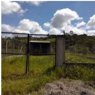
Foto 2 - Vista geral da EEEB.
