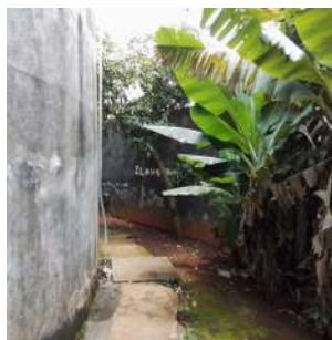
Foto 2 - Muro no entorno da EEA.
