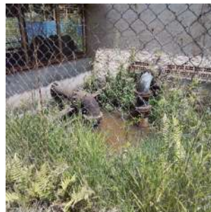
Foto 13 - Poço de sucção da EEAB antiga.
