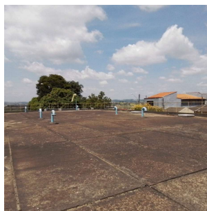
Foto 4 - Vista do Reservatório apoiado da ETA Cerejeiras do Saae Atibaia.
