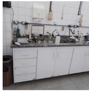
Foto 2 - Laboratório da ETA Cerejeiras do Saae Atibaia.
