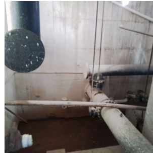
Foto 4 - Vista da ETA Cerejeiras do Saae Atibaia.
