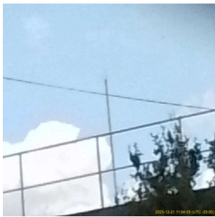
Foto 1 - Para-raios do reservatório do Alvinópolis do Saae Atibaia.
