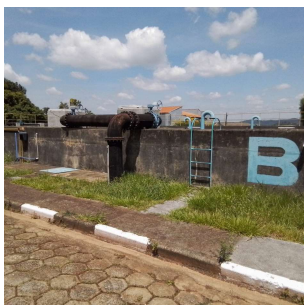
Foto 1 - Vista do Reservatório apoiado da ETA Cerejeiras do Saae Atibaia.
