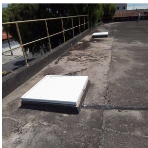
Foto 3 - Tampas de inspeção do Reservatório apoiado da ETA Cerejeiras do Saae Atibaia.
