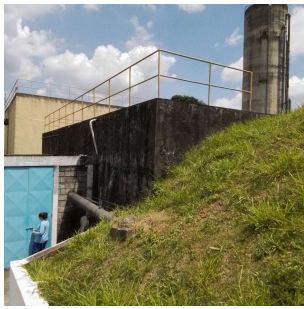
Foto 3 - Vista do Reservatório Zona alta do Saae Atibaia.
