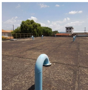
Foto 2 - Vista do Reservatório apoiado da ETA Cerejeiras do Saae Atibaia.
