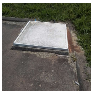
Foto 1 - Tampa de inspeção do Reservatório Zona alta do Saae Atibaia.
