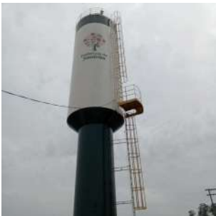
Foto 1 - Reservatório Morada do Sol - escada com guarda corpos
