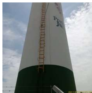
Foto 2 - Escada com guarda corpos - Reservatório Campo
