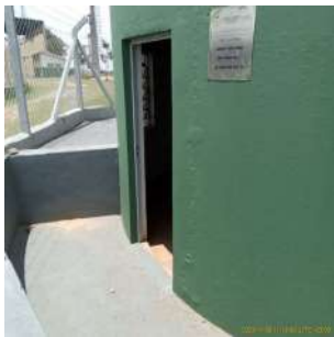
Foto 2 - Porta aberta - Reservatório Campo
