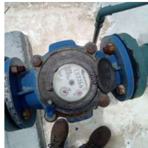
Foto 5 - Macromedidor Poço Campo I
