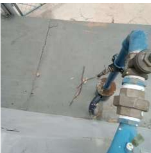
Foto 4 - Local de perfuração do Poço e torneira para tomada de água bruta
