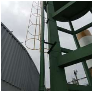
Foto 5 - Escada com guarda corpos e cabo de descida do para-raios
