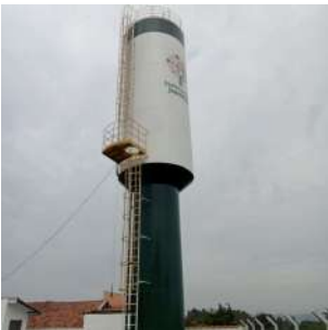
Foto 2 - Reservatório Morada do Sol - nível
