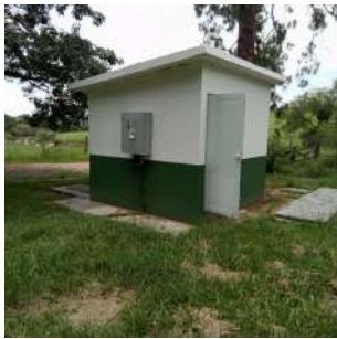
Foto 1 - Abrigo da EEEB Baggio - Porta fica aberta para evitar concentração de gases
