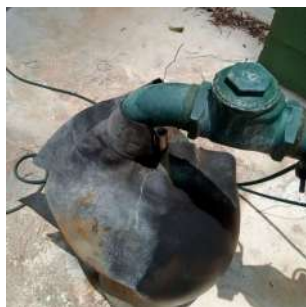
Foto 5 - Estrutura improvisada para proteção do Poço NBaggio
