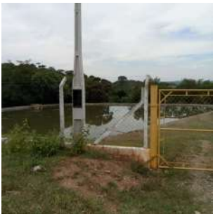
Foto 1 - Cercamento e entrada da ETE Ipiranga
