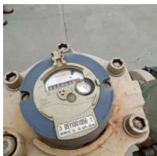
Foto 5 - Macro medidor - Poço Juma
