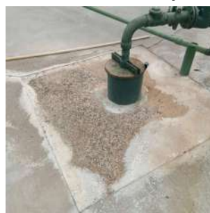
Foto 8 - Laje de proteção - Poço Morada do Sol
