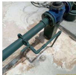
Foto 7 - Registro para coleta de água antes do tratamento
