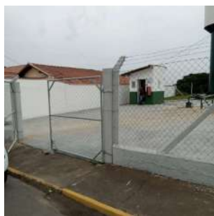
Foto 1 - Portão de entrada e cercamento - Poço Morada do Sol
