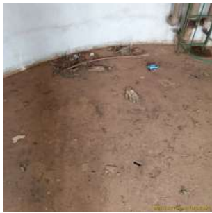
Foto 8 - Vestígios de presença inadequada na instalação - Reservatório Campo
