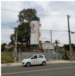
Foto 1 - Visão geral - Reservatório Villagio Vila Verde
