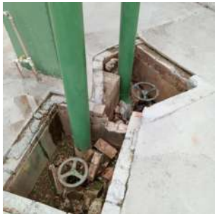
Foto 4 - Saída para distribuição - Reservatório Juma
