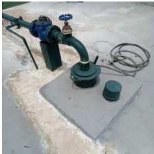
Foto 3 - Local perfuração do Poço Campo I - Laje de proteção
