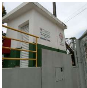
Foto 12 - Visão geral - Poço Villagio Vila Verde - identificação sobre a Casa de Química
