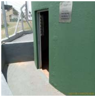
Foto 9 - Porta aberta - Reservatório Campo
