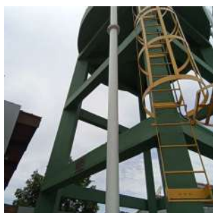
Foto 3 - Escada com guarda corpos - Reservatório Baggio
