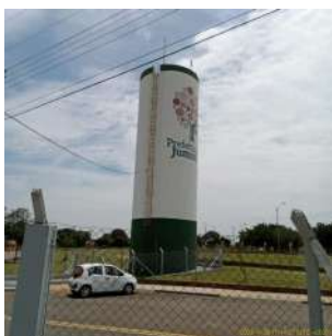
Foto 1 - Visão Geral do Reservatório Campo
