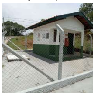
Foto 13 - Visão geral - casa de química - Poço Campo II
