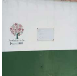
Foto 2 - Placa de identificação apagada - Poço Campo I
