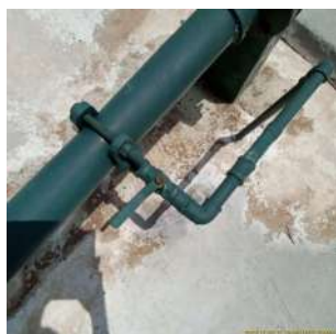
Foto 1 - A coleta é feita na Casa de Química, após abertura deste registro
