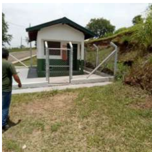
Foto 5 - Casa de química - Poço Campo II
