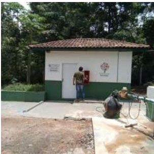
Foto 1 - Visão geral - Casa de Química e local de perfuração - Poço Baggio
