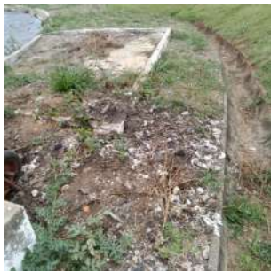
Foto 1 - Disposição inadequada dos resíduos de gradeamento ao chão
