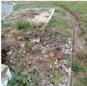
Foto 7 - Disposição Inadequada de Resíduos - ETE Ipiranga
