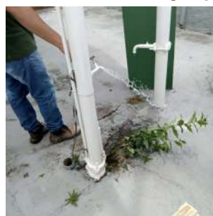
Foto 4 - Ponto de amostragem - Reservatório Baggio
