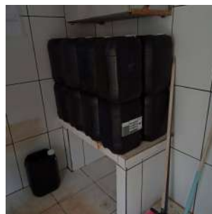
Foto 10 - Armazenamento de produtos químicos - Poço Campo II
