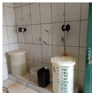
Foto 8 - Soluções de uso e bombas injetoras - Poço Campo II
