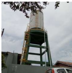
Foto 1 - Visão Geral - Reservatório Baggio
